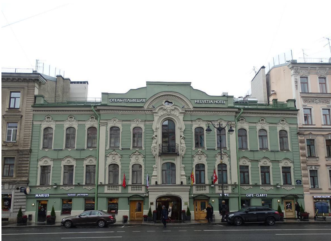
Илл. 02. Выявленный объект культурного наследия «Особняк (Петрова)». Лицевой фасад. Съемка 22.12.2022 г. Трушковский В.Э.
