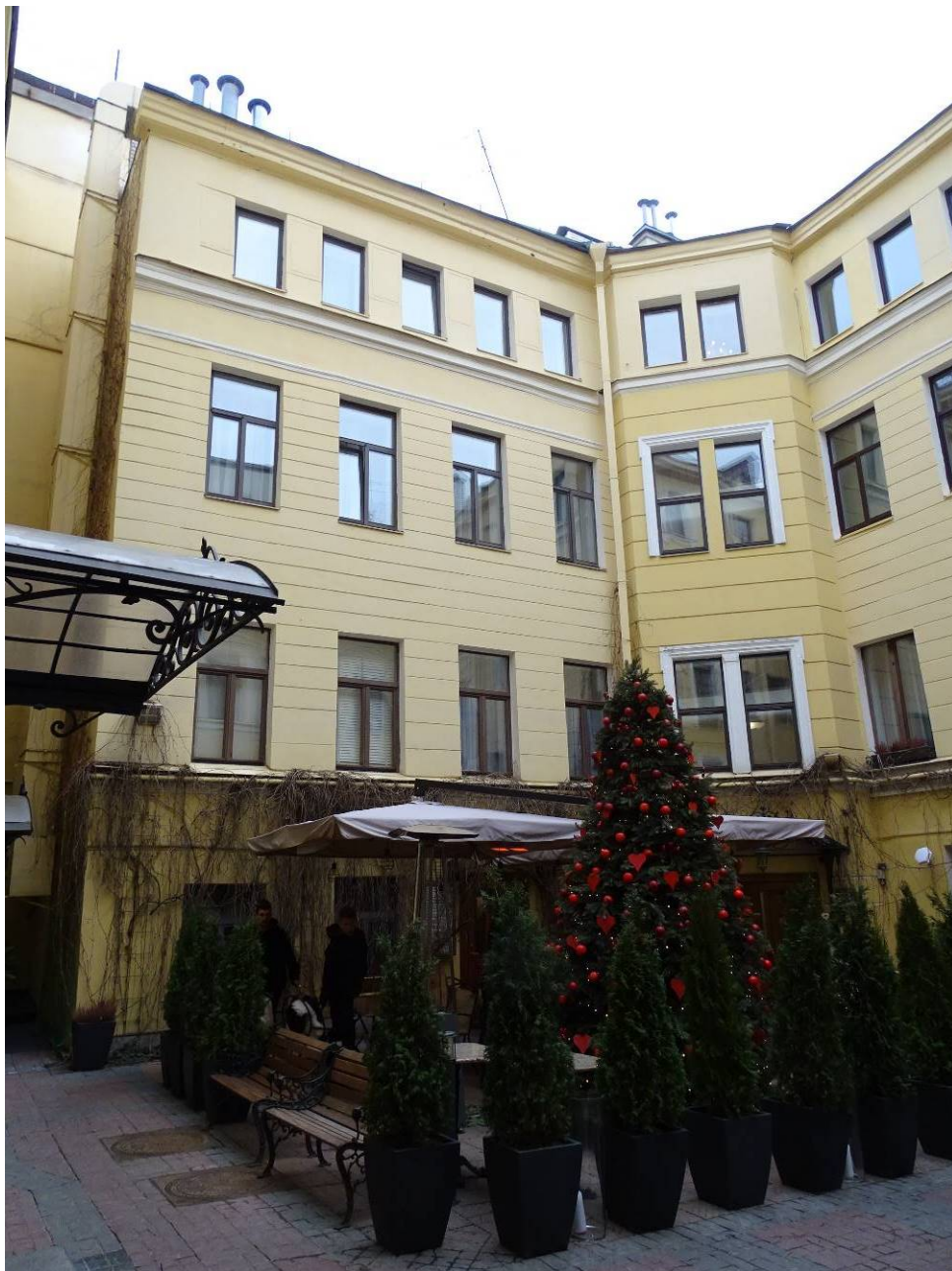
Илл. 06. Выявленный объект культурного наследия «Особняк (Петрова)». Внутренний двор. Северная часть лицевого корпуса. Съемка 22.12.2022 г. Трушковский В.Э.
