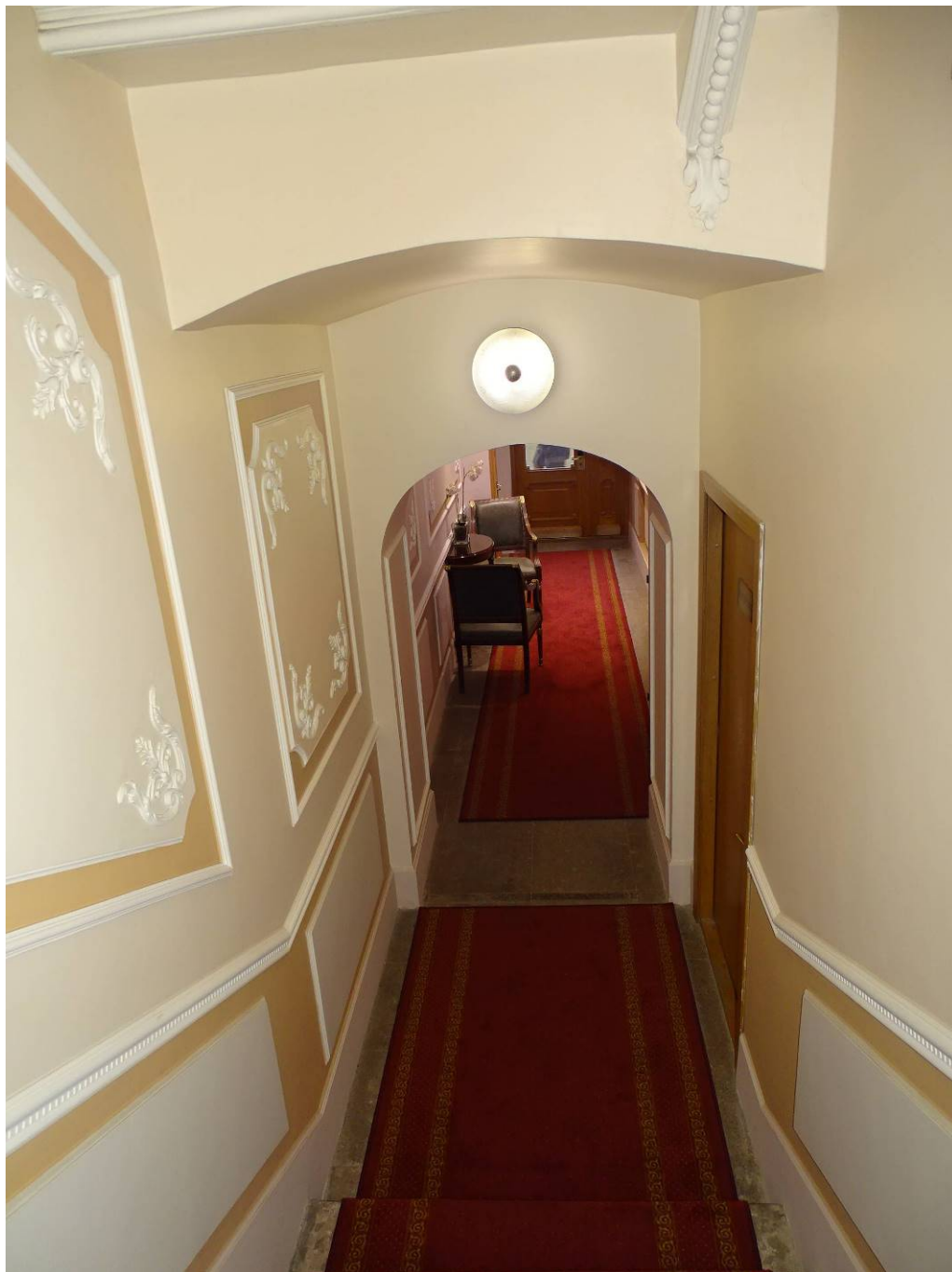
Илл. 05. Парадная лестница. Вид с междуэтажной площадки. Съемка 22.12.2022 г. Трушковский В.Э.
