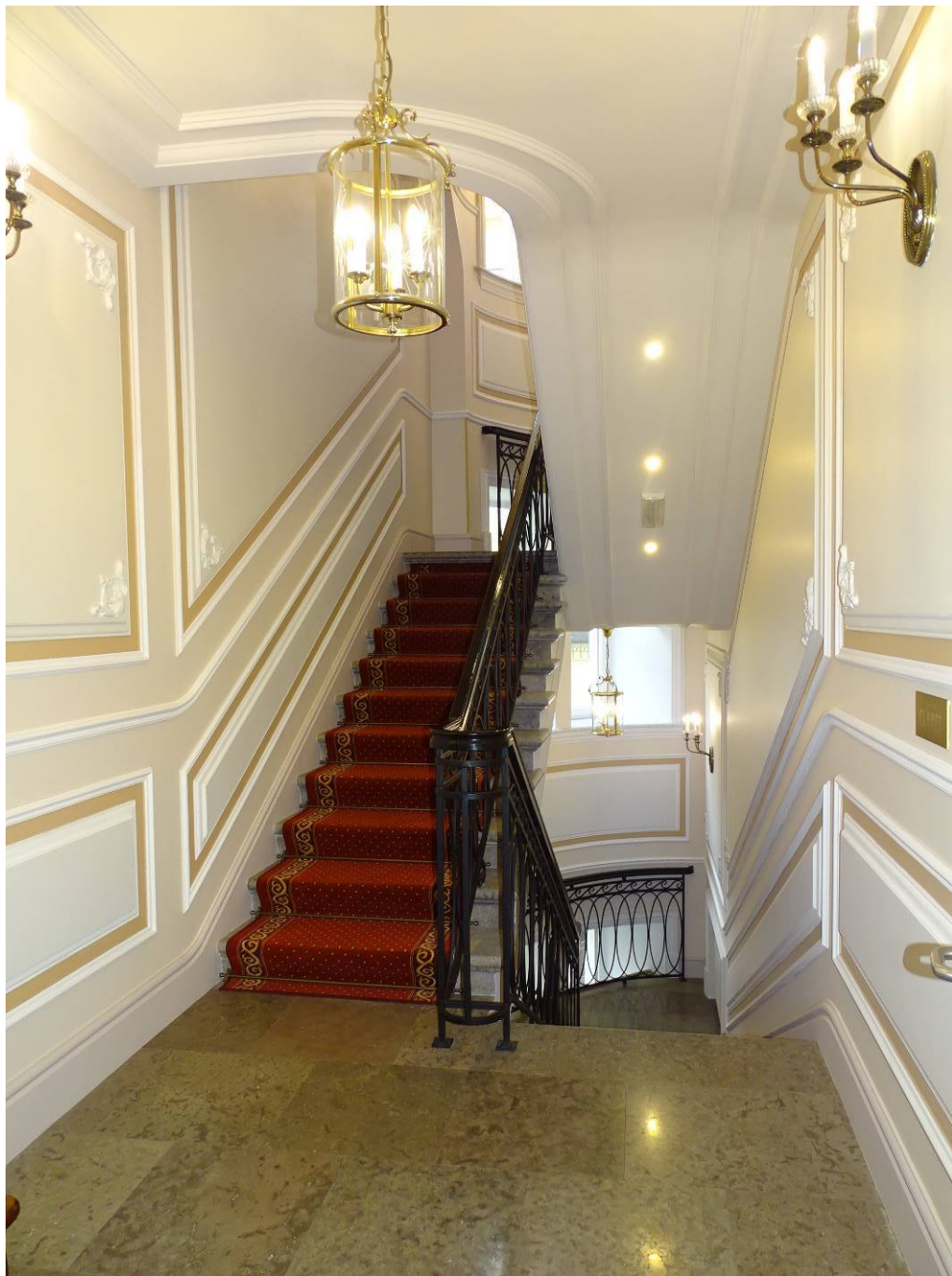
Илл. 01. Северная лестница. 3-й этаж. Съемка 22.12.2022 г. Трушковский В.Э.
