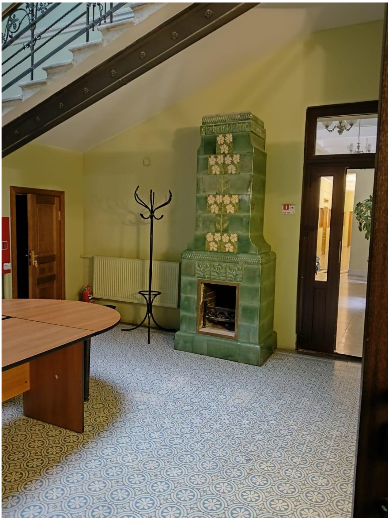
Фото 11. Объект культурного наследия федерального значения «Дом Форостовского П.П.», Санкт-Петербург, 4 линия В.О., дом 9 литера А. Помещение 1-Н (29). Холл у лестницы. Камин – средистенный, двухъярусный, облицованный гладким и рельефным поливным изразцом изумрудно-зеленого цвета; нижний ярус на цоколе; топочный проем прямоугольный, в латунном обрамлении, таган черного металла, топка выложена кирпичом; над топкой – рельефный растительный орнамент в стиле модерн; верхний ярус
