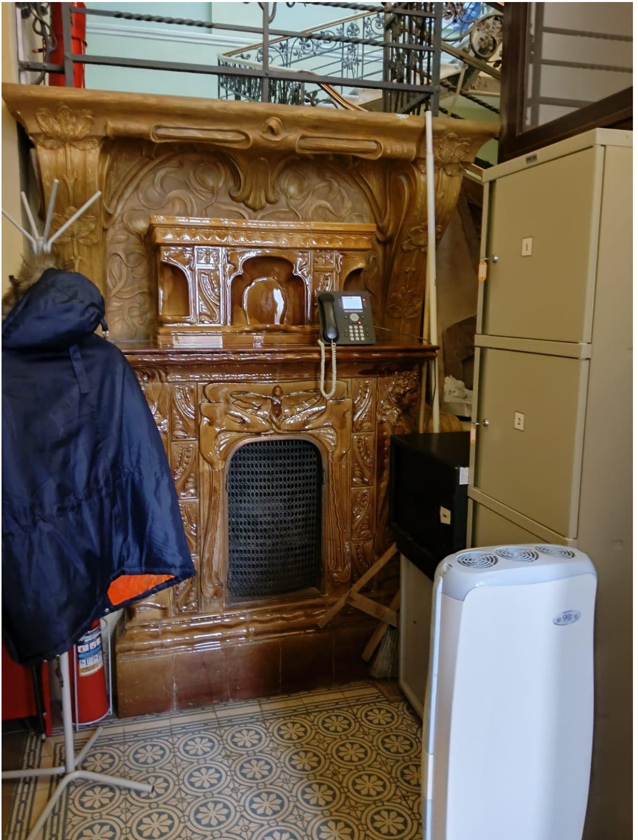
Фото 10. Объект культурного наследия федерального значения «Дом Форостовского П.П.», Санкт-Петербург, 4 линия В.О., дом 9 литера А. Помещение 1-Н (27). Камин средистенный, двухъярусный, на высоком цоколе, облицован поливным рельефным изразцом коричневатого-горчичного цвета с орнаментом в стиле модерн; портал камина фланкирован гермами с женскими головками; по центру над топкой изображение крылатой женской полуфигуры в обрамлении линейного орнамента (удар бича) и
