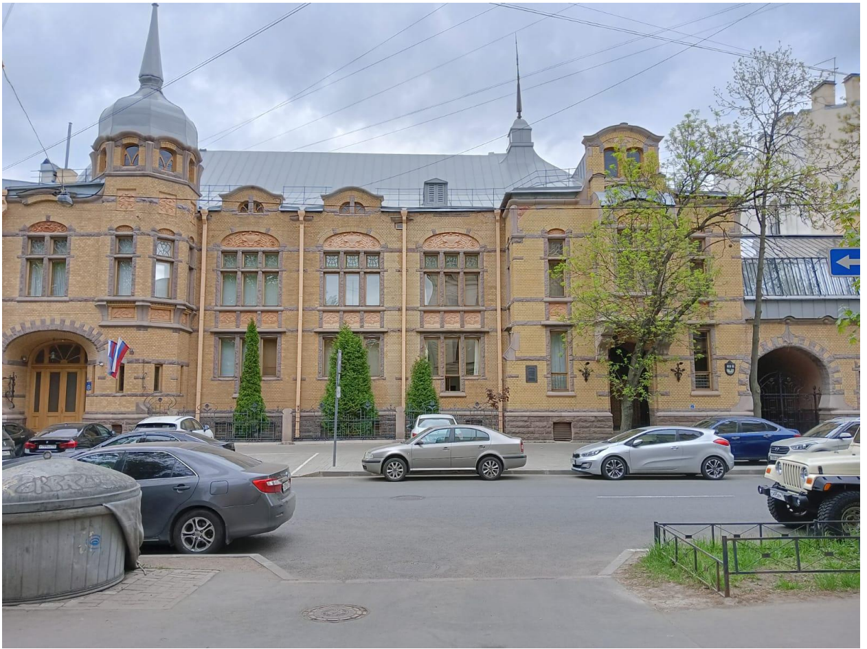
Фото 1. Объект культурного наследия федерального значения «Дом Форостовского П.П.», Санкт-Петербург, 4 линия В.О., дом 9 литера А. Лицевой (юго-западный) фасад главного дома.
