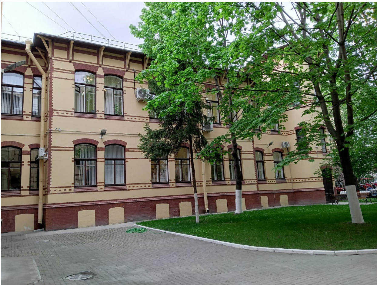
Фото 7. Объект культурного наследия федерального значения «Дом Форостовского П.П.», Санкт-Петербург, 4 линия В.О., дом 9 литера А. Фасад юго-восточный (северного двора) флигеля 1 (детского).
