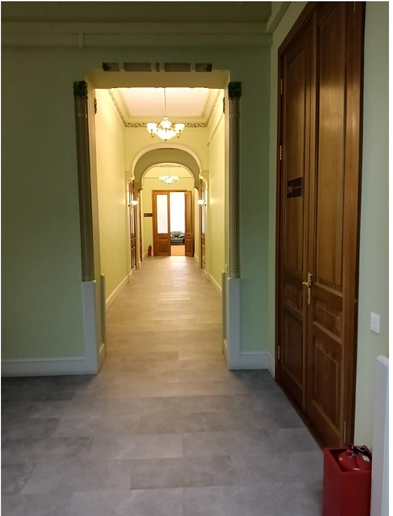
Фото 13. Объект культурного наследия федерального значения «Дом Форостовского П.П.», Санкт-Петербург, 4 линия В.О., дом 9 литера А. Помещение 1-Н (пом.б\н). Вид с площадки второго этажа лестницы. Позднее напольное покрытие.
