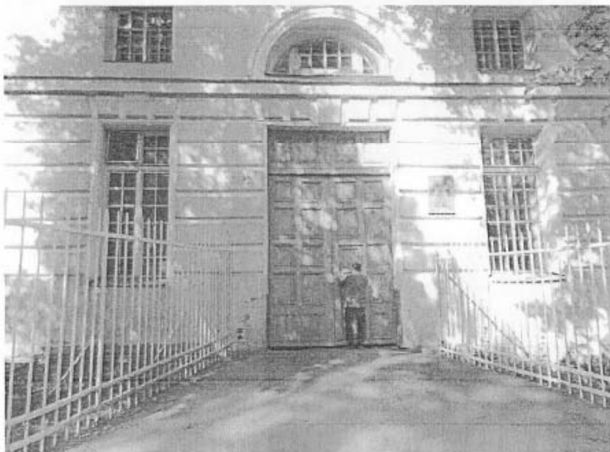
1. Фрагмент восточного фасада
