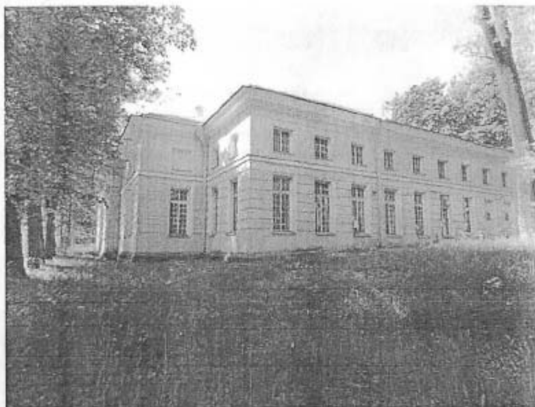
2. Вид со стороны северного фасада.
