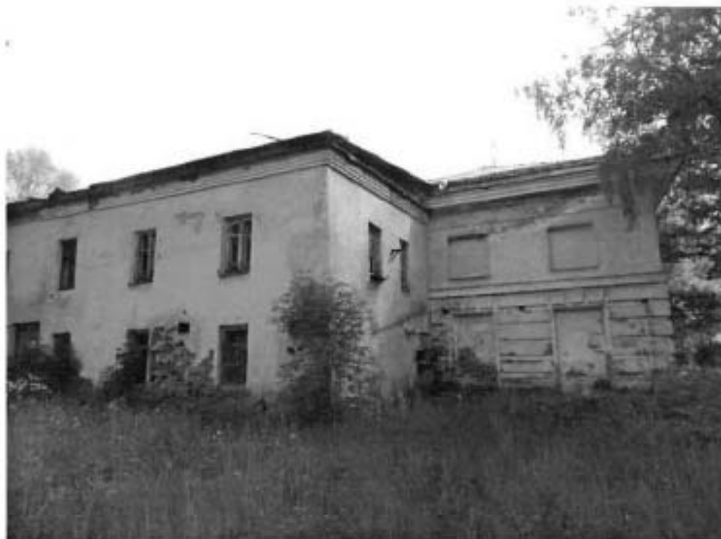
4. Вид со стороны западного фасада.
