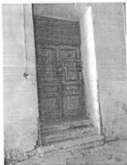
6. Деревянное заполнение воротного проезда.
