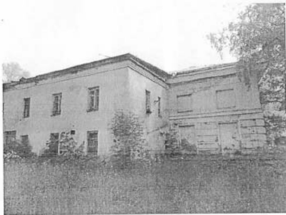
4. Вид со стороны западного фасада.
