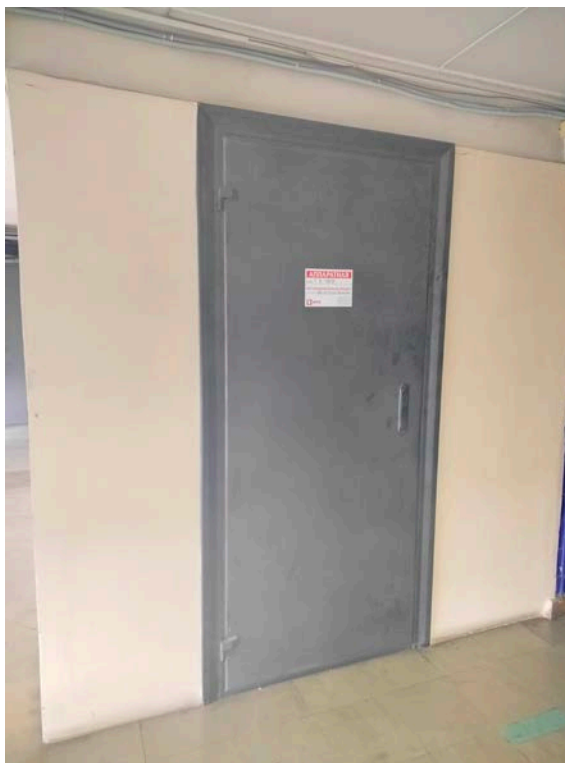
Фото 12. Интерьер объекта культурного наследия регионального значения «Главное здание Ветеринарного института (Хирургический музей)», входящего в состав объекта культурного наследия регионального значения «Здания Императорской Медико-хирургической академии», вход в 39Н
