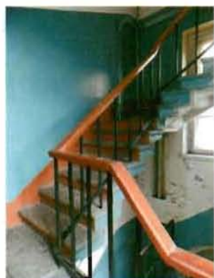
5, 6. Внутренняя лестница ЛК1.
