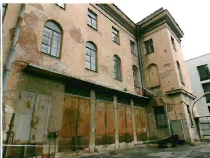
4. Общий вид дворового фасада здания.
