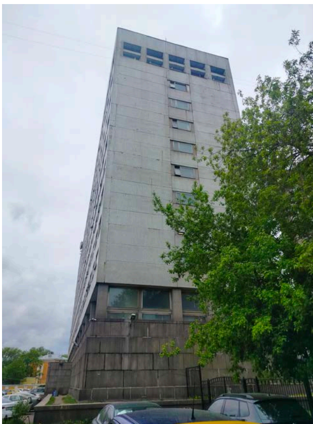
Фото 5. Лицевой фасад объекта культурного наследия регионального значения «Главное здание Ветеринарного института (Хирургический музей)», входящего в состав объекта культурного наследия регионального значения «Здания Императорской Медико-хирургической академии»
