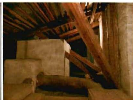
7. Общий вид чердака.
