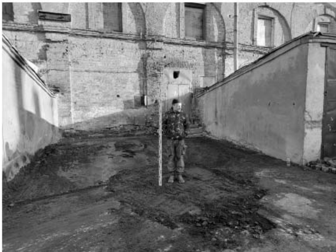
Илл. 43. Санкт-Петербург, Евгеньевская ул., д. 2, лит. А. Шурф 1. Рекультивация. Вид с С. Для масштаба использована рейка 2 м.
