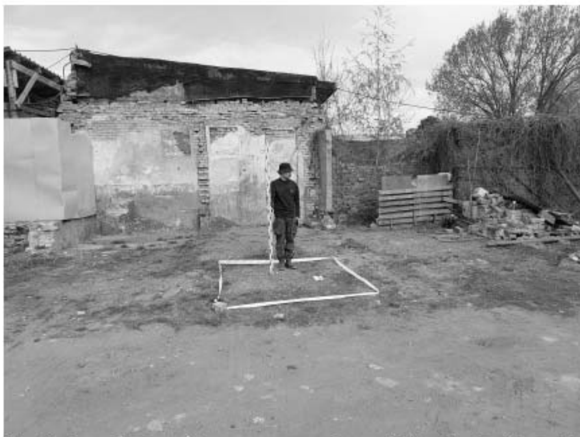
Илл. 44. Санкт-Петербург, Евгеньевская ул., д. 2, лит. А. Шурф 2. Общий вид с Ю до начала работ. Для масштаба использована рейка 2 м.
