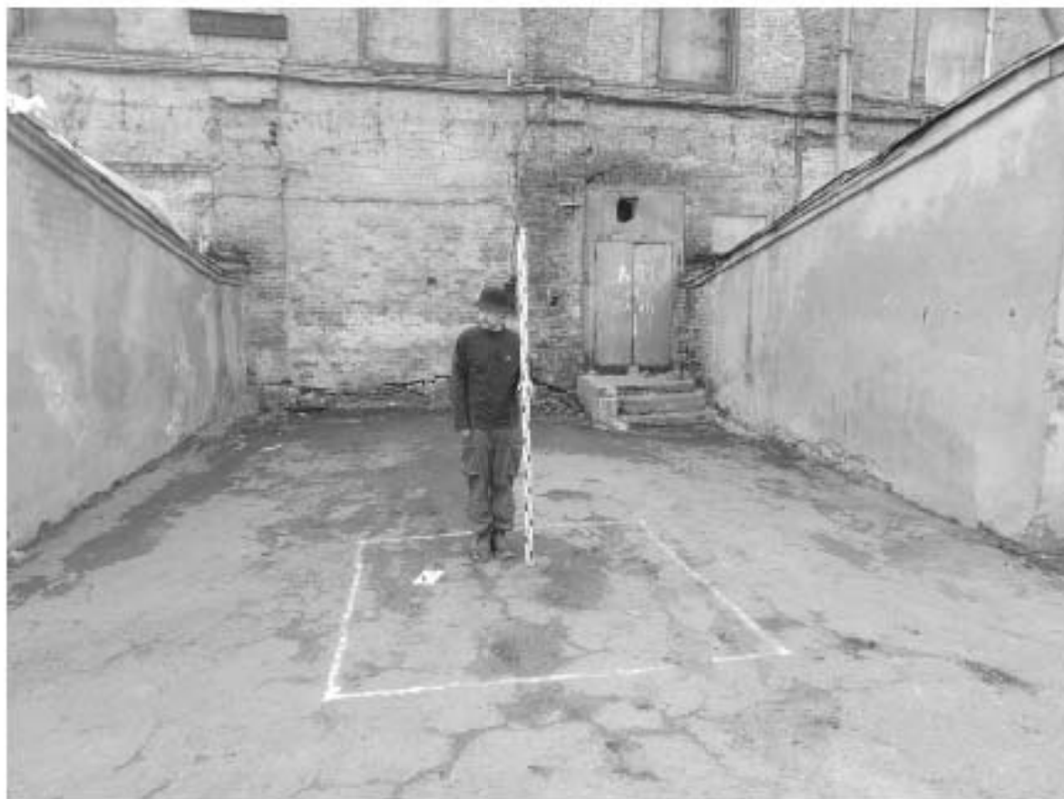
Илл. 25. Санкт-Петербург, Евгеньевская ул., д. 2, лит. А. Шурф 1. Общий вид с С до начала работ. Для масштаба использована рейка длиной 2 м.
