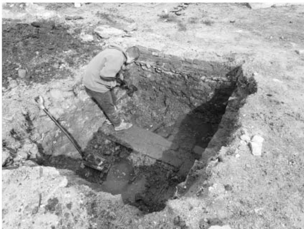
Илл. 46. Санкт-Петербург, Евгеньевская ул., д. 2, лит. А. Шурф 2. Рабочий момент. Общий вид шурфа на уровне известковой фундаментной кладки. Вид с СЗ.
