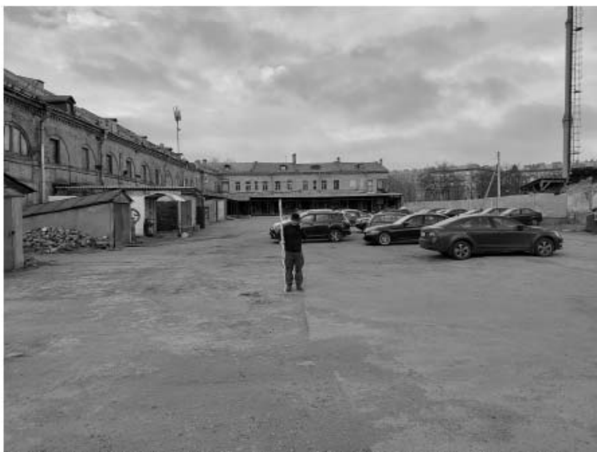
Илл. 22. Санкт-Петербург, Евгеньевская ул., д. 2, лит. Б. Точка фотофиксации 2. Общий вид на обследуемый участок с В. Для масштаба использована рейка длиной 2 м.
