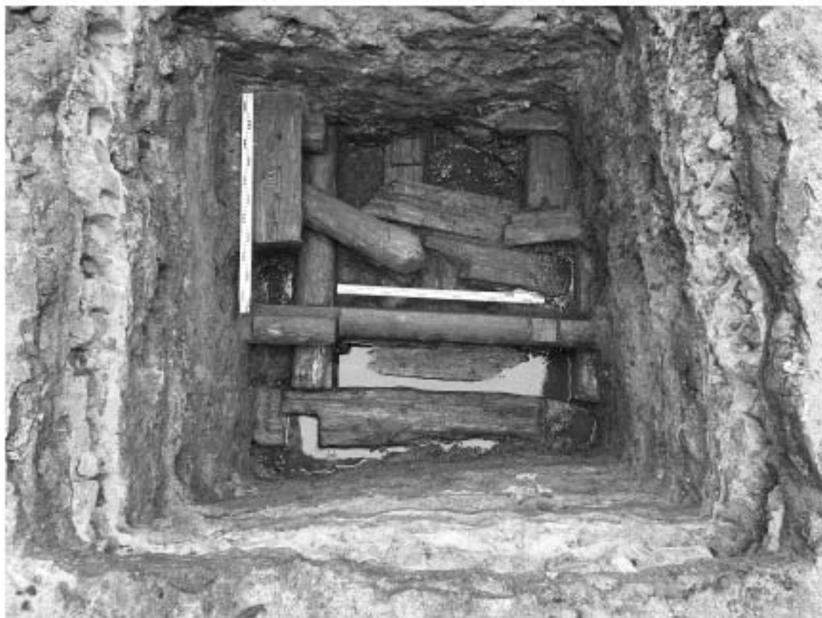
Илл. 31. Санкт-Петербург, Евгеньевская ул., д. 2, лит. А. Шурф 1. Вид с Ю на уровне демонтированной деревянной конструкции.
