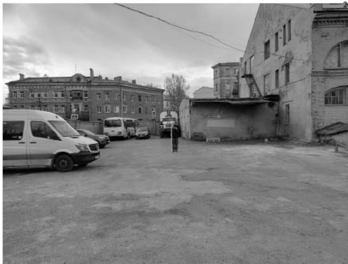
Илл. 23. Санкт-Петербург, Евгеньевская ул., д. 2, лит. А. Точка фотофиксации 3. Общий вид на обследуемый участок с С. Для масштаба использована рейка длиной 2 м.
