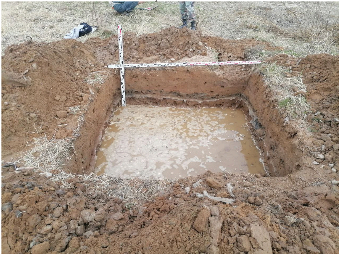
Рис. 38 Санкт-Петербург, пос. Шушары, Колпинское шоссе, участок 168 (квартал II)» (кадастровый номер: 78:42:0018304:19566) Шурф 2. Фиксация по уровню грунтовых вод. Вид на восток.
