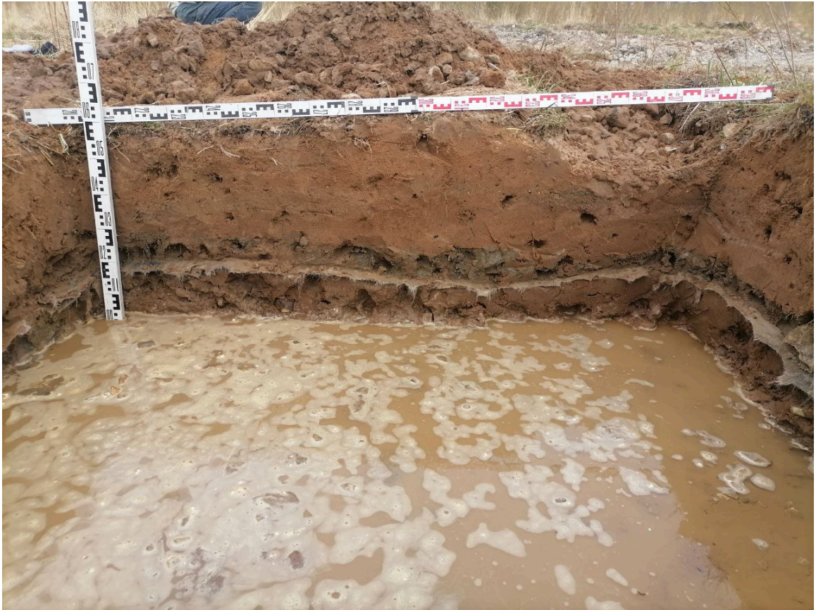
Рис. 39 Санкт-Петербург, пос. Шушары, Колпинское шоссе, участок 168 (квартал II)» (кадастровый номер: 78:42:0018304:19566) Шурф 2. Фиксация по уровню грунтовых вод. Восточная стенка.
