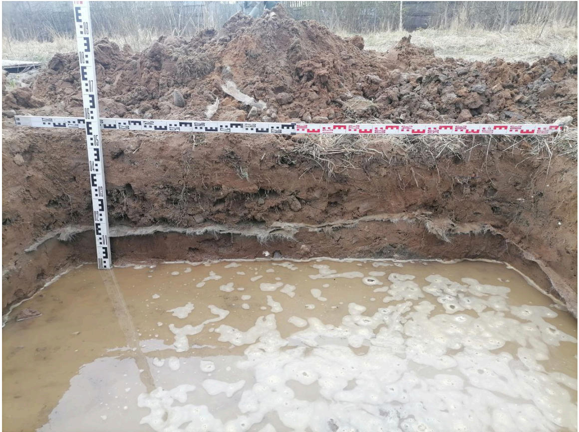
Рис. 43 Санкт-Петербург, пос. Шушары, Колпинское шоссе, участок 168 (квартал II)» (кадастровый номер: 78:42:0018304:19566) Шурф 2. Фиксация по уровню грунтовых вод. Западная стенка.
