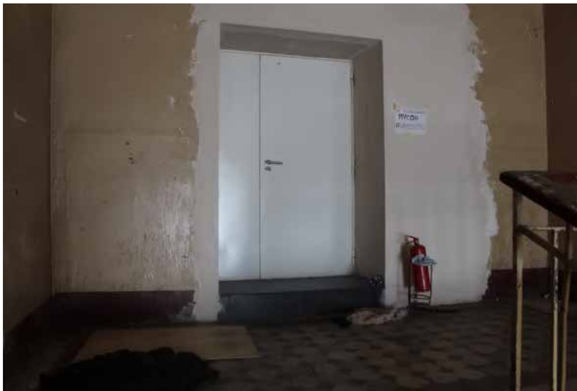
79. Фрагмент интерьера четвертого этажа
