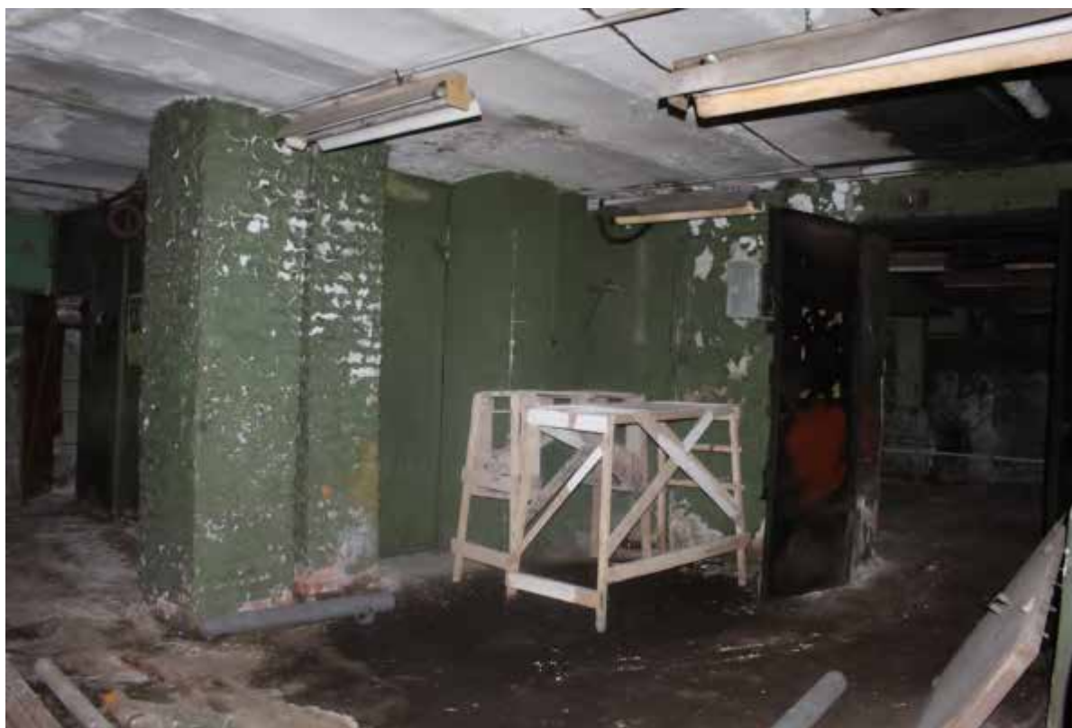
44. Фрагмент интеръера подвала
