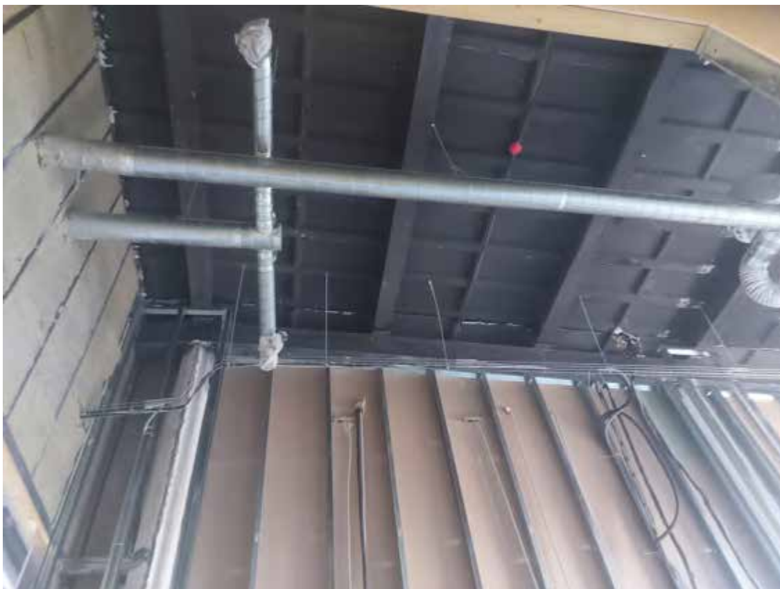
89. Перекрытия четвертого этажа
