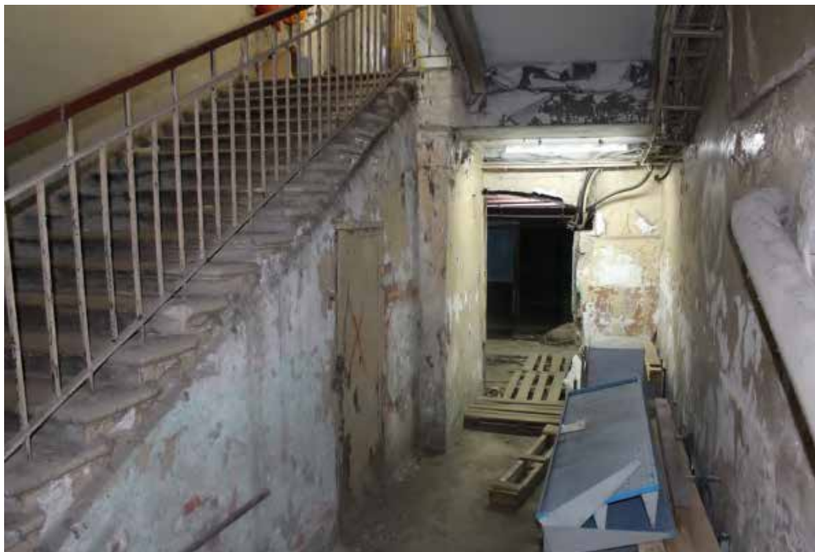
42. Фрагмент интеръера подвала
