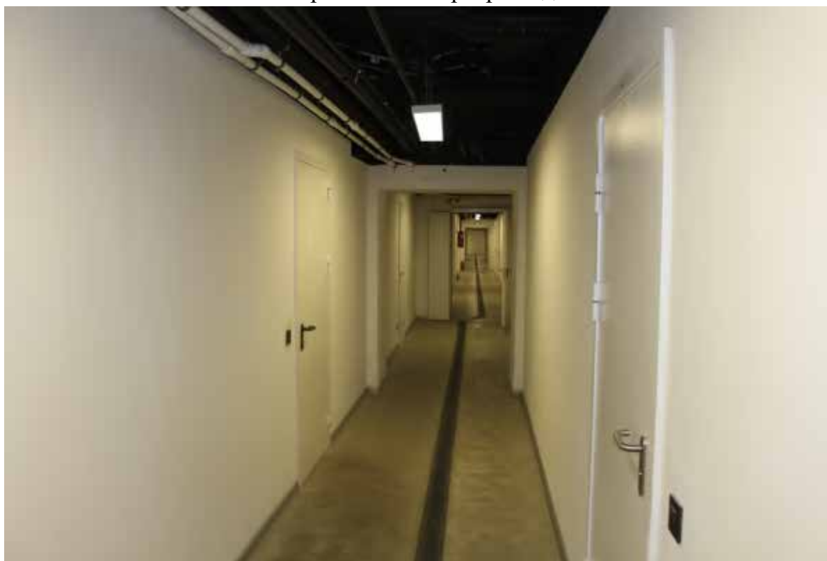
45. Фрагмент интеръера подвала
