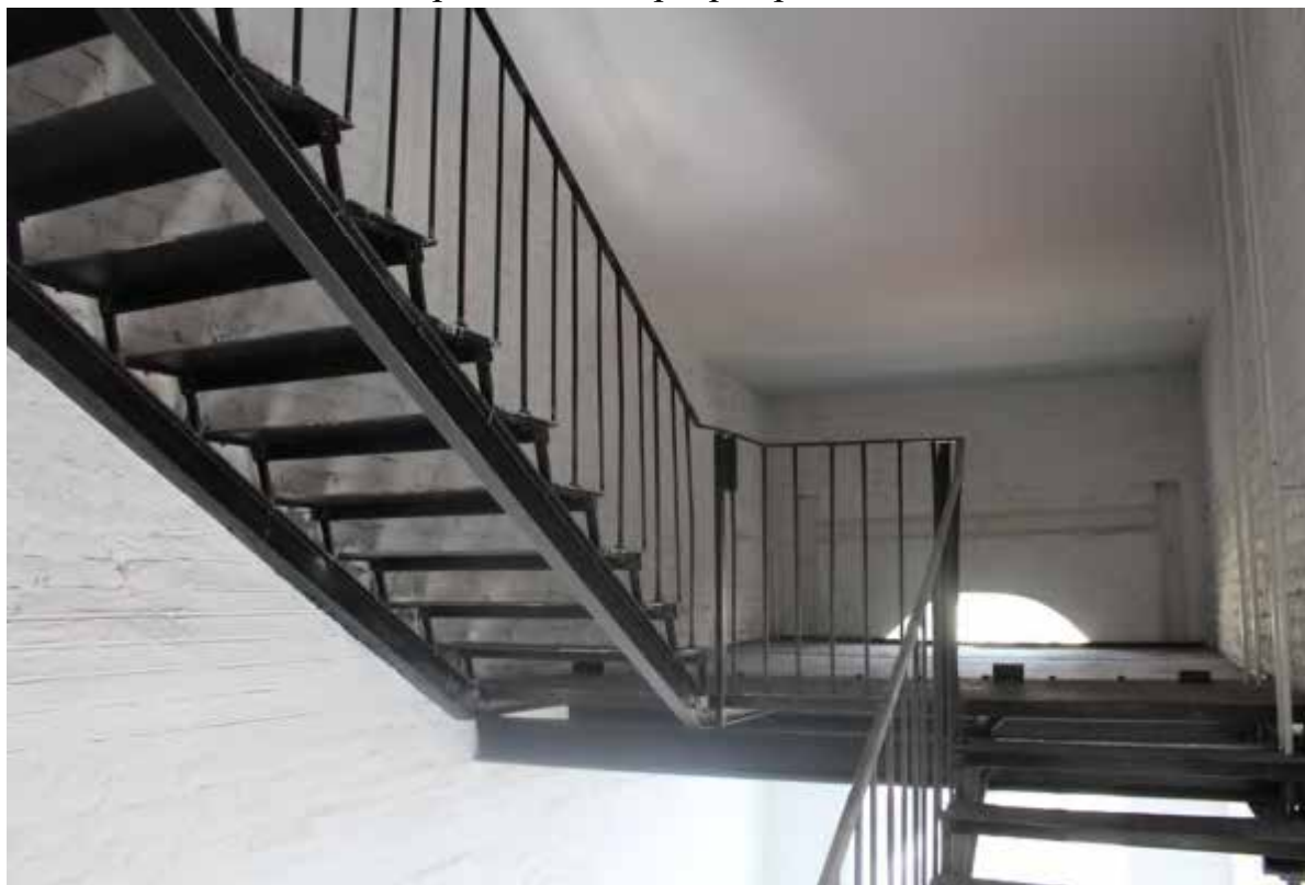
76. Фрагмент интерьера четвертого этажа
