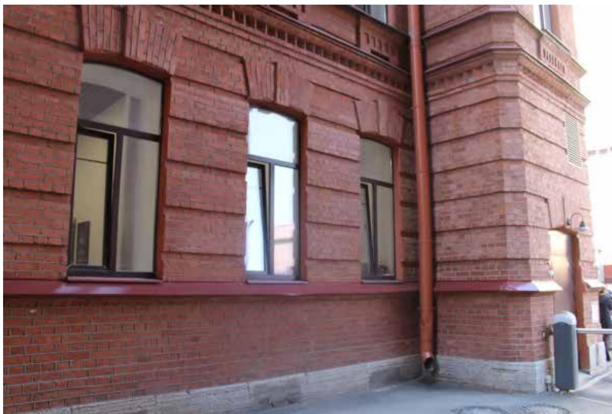
8. Фрагмент дворового фасада
