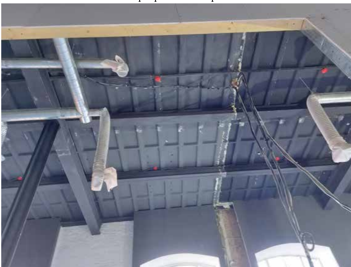
90. Перекрытия четвертого этажа
