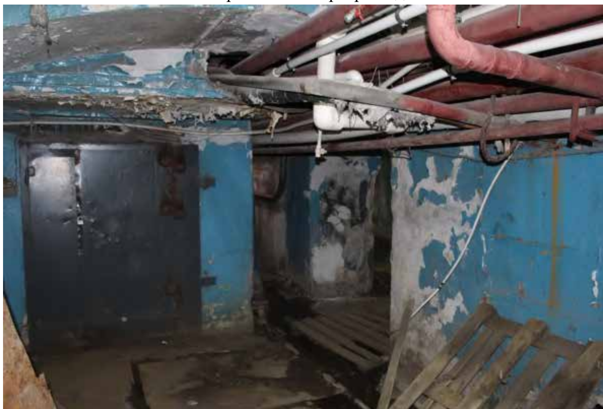
43. Фрагмент интеръера подвала
