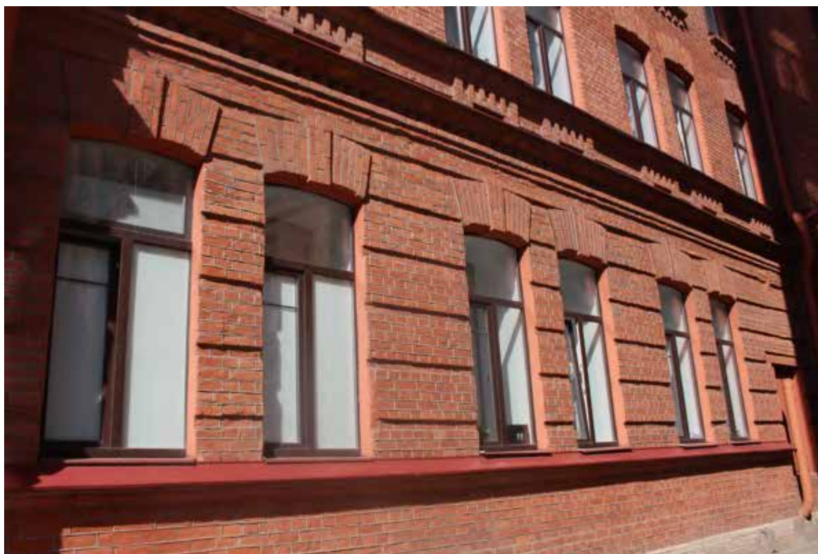
12. Фрагмент дворового фасада
