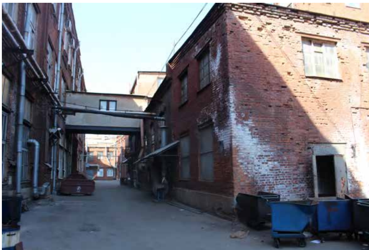
4. Фрагмент фасада поздней пристройки
