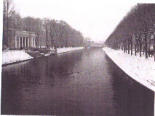
4. Вид с моста Михайловского (1-го Садового) по течению реки. Видна часть из участка набережной от моста Михайловского (1-го Садового) до 2-го Садового моста (правый берег)
