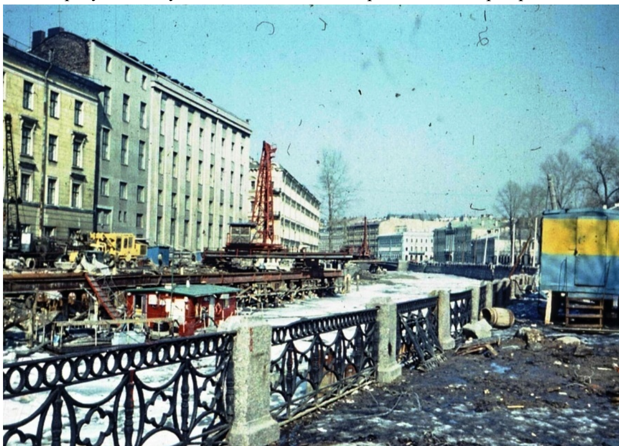
11. Ремонт набережной Мойки. 1989 г. // pastvu URL: https://pastvu.com/ ;
