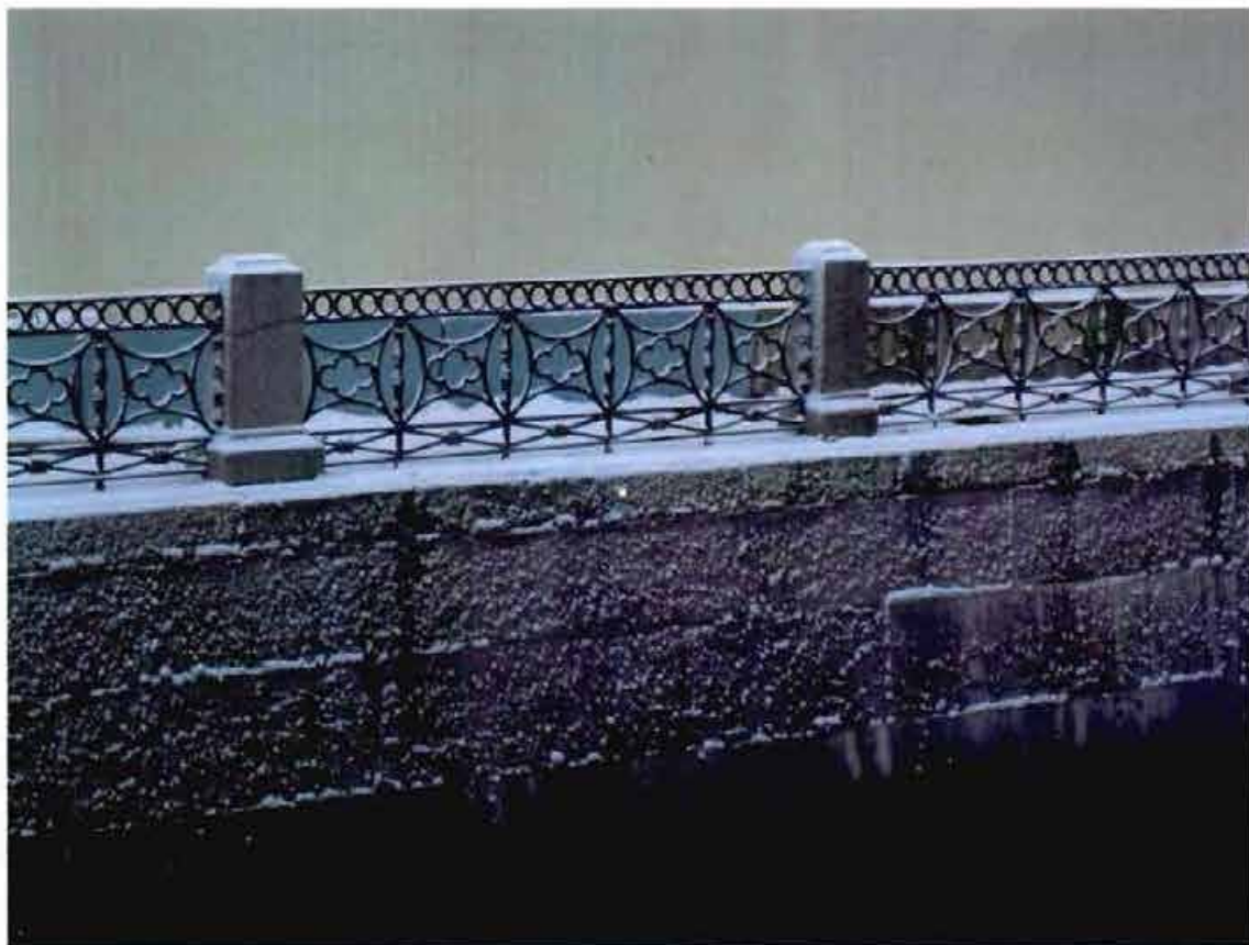
6. Ограждение набережной. Левобережная стенка
