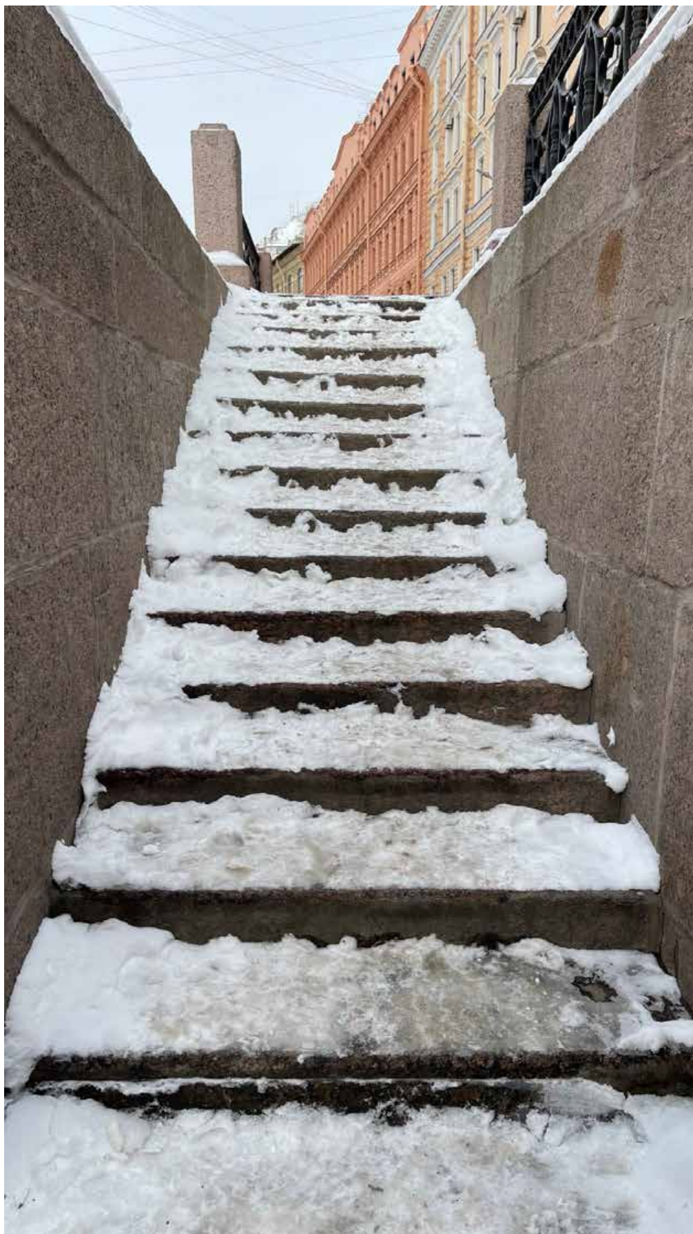
6. Вид на спуск 24 по адресу Наб. реки Мойки, дом 44;
