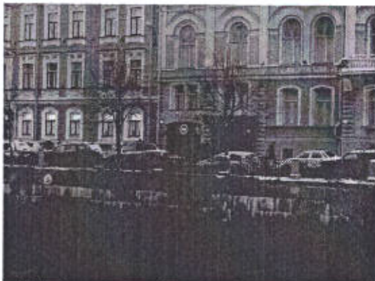
12. Приобережный участок набережной между Красным и Сенным мостами
