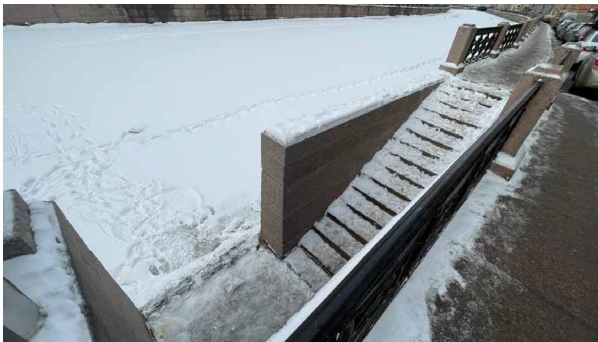
4. Вид на спуск 24 по адресу Наб. реки Мойки, дом 44;
