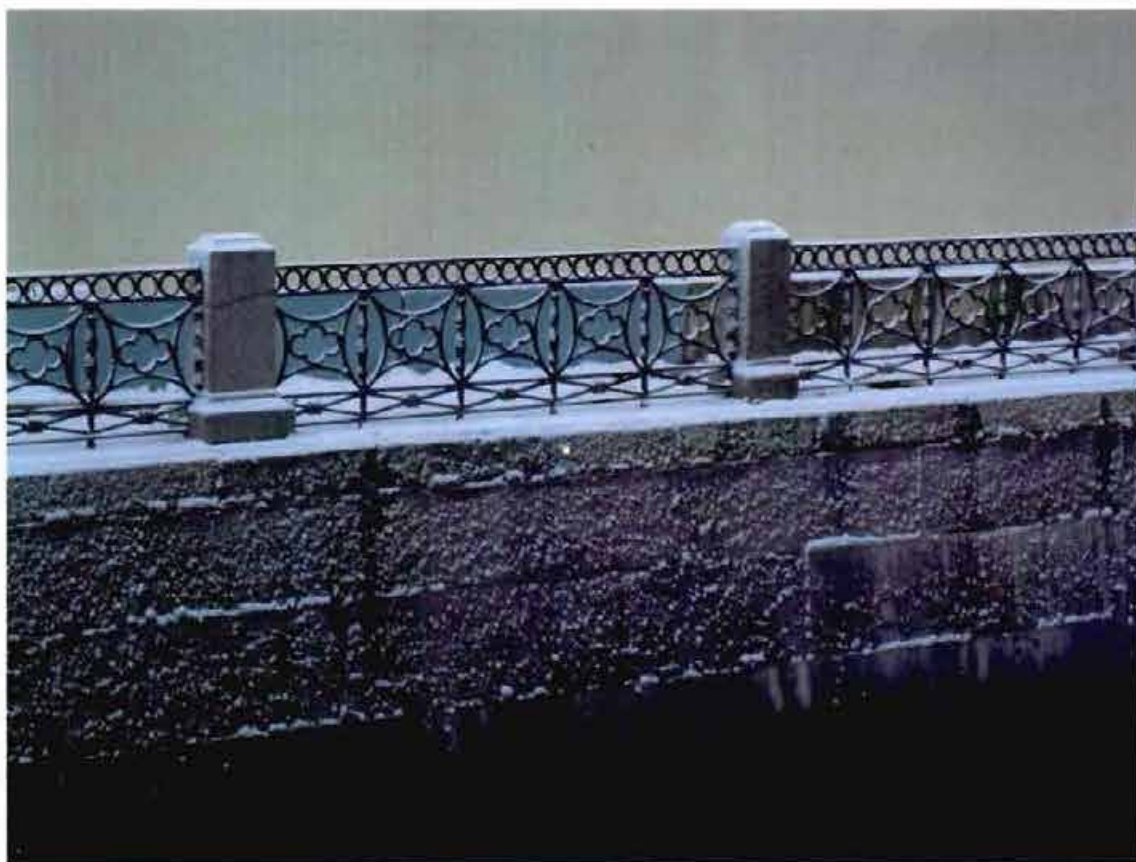
6. Ограждение набережной. Левобережная стенка
