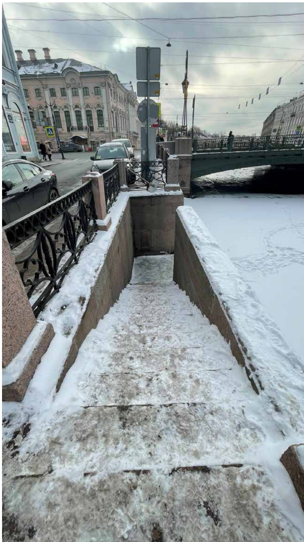
5. Вид на спуск 24 по адресу Наб. реки Мойки, дом 44;
