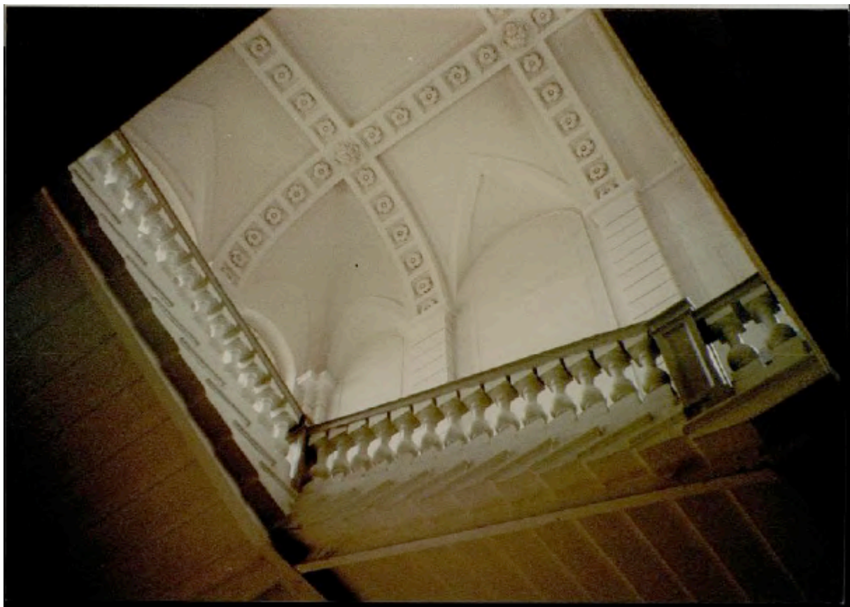
Илл. 74. Парадная лестница западного корпуса. Паспорт КГИОП 2002 г.
