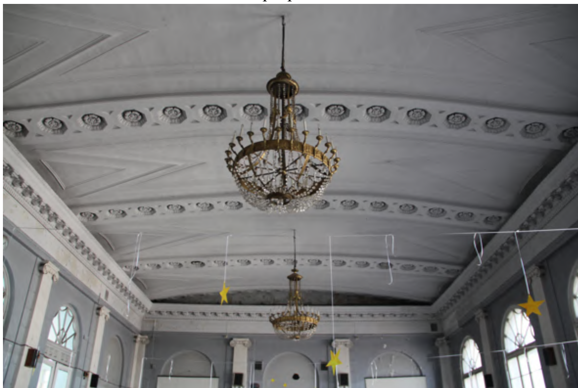
17. Потолок актового зала
