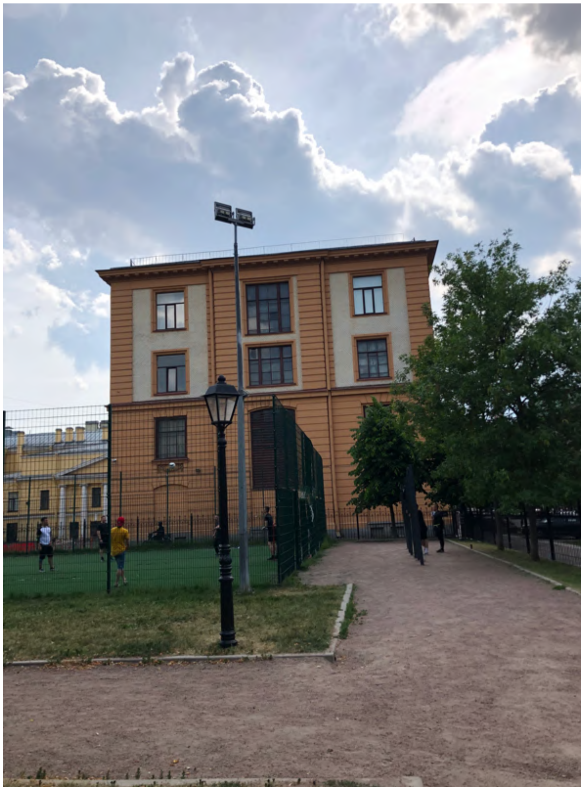
3. Вид на торцевой фасад корпуса по Соляному переулку
