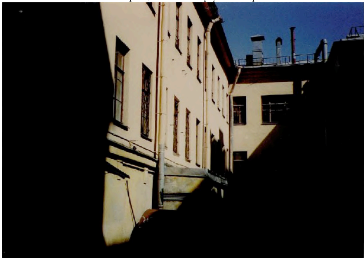
Илл. 59. Фасады со стороны южного двора восточного и среднего корпусов. Паспорт КГИОП 2002 г.
