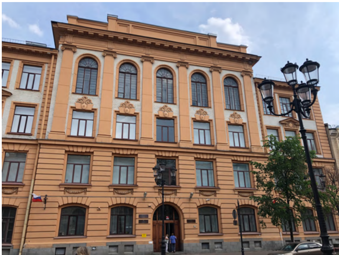
1. Фрагмент фасада по Соляному переулку
