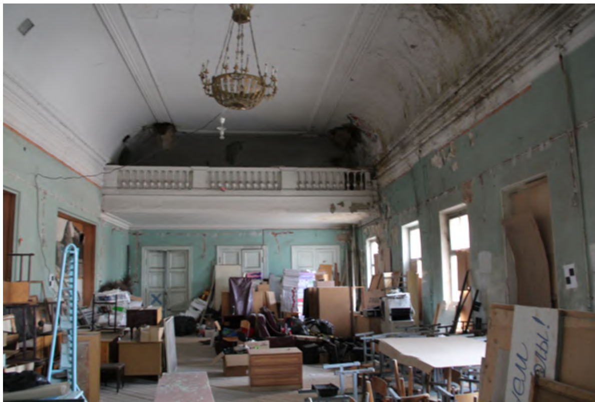
163. Интерьер второго этажа
