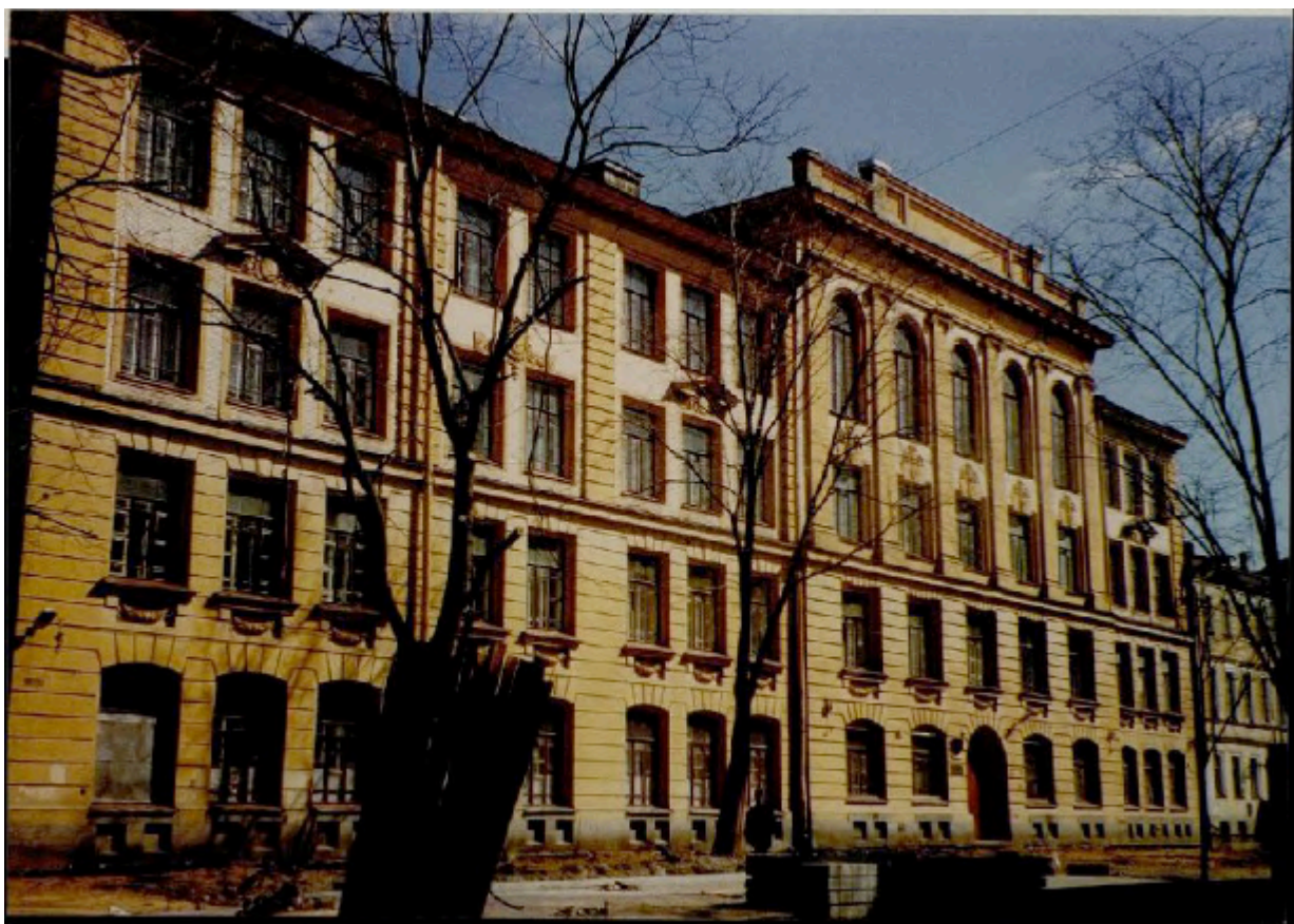
Илл. 60. Западный фасад западного корпуса. Паспорт КГИОП 2002 г.
