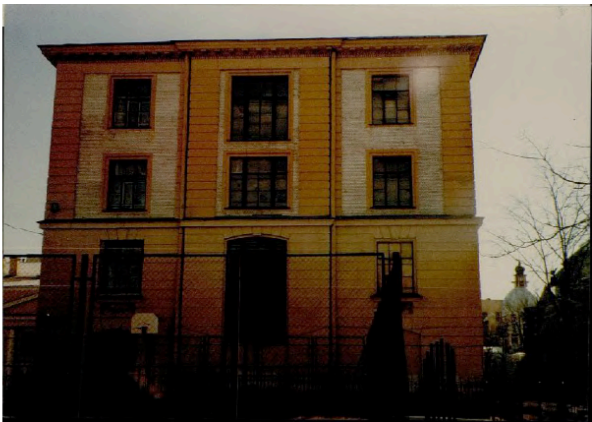
Илл. 62. Северный фасад западного корпуса. Паспорт КГИОП 2002 г.
