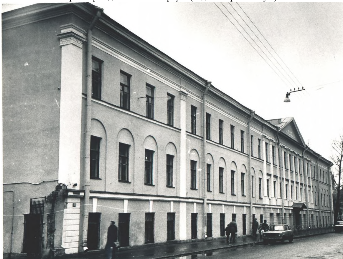
Илл. 49. Восточный фасад восточного корпуса (со стороны Гагаринской ул.). 1990-е гг.
