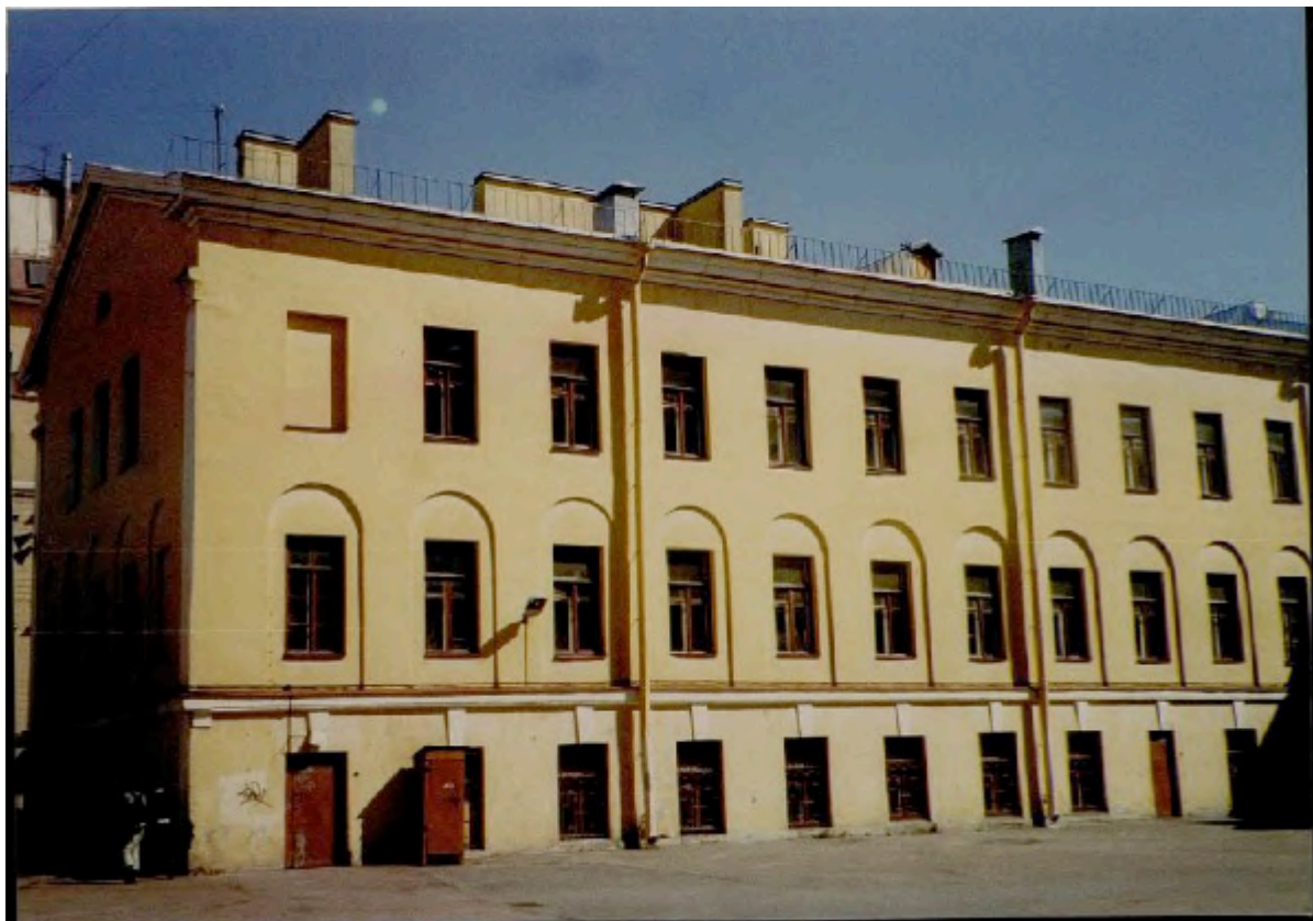
Илл. 56. Западный фасад северной части восточного корпуса. Паспорт КГИОП 2002 г.
