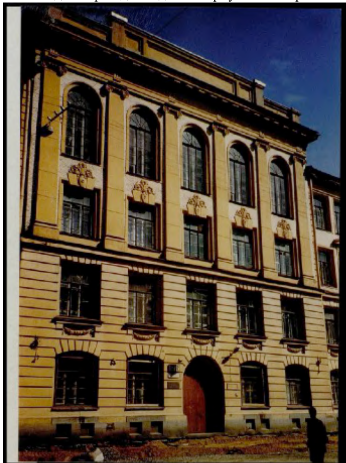
Илл. 61. Фрагмент западного фасада западного корпуса. Паспорт КГИОП 2002 г.
