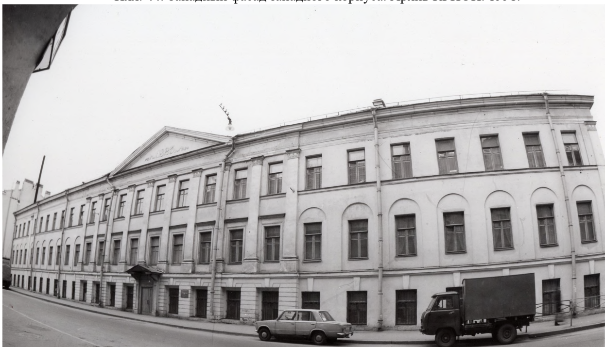
Илл. 45. Восточный фасад восточного корпуса. Архив КГИОП. 1991.
