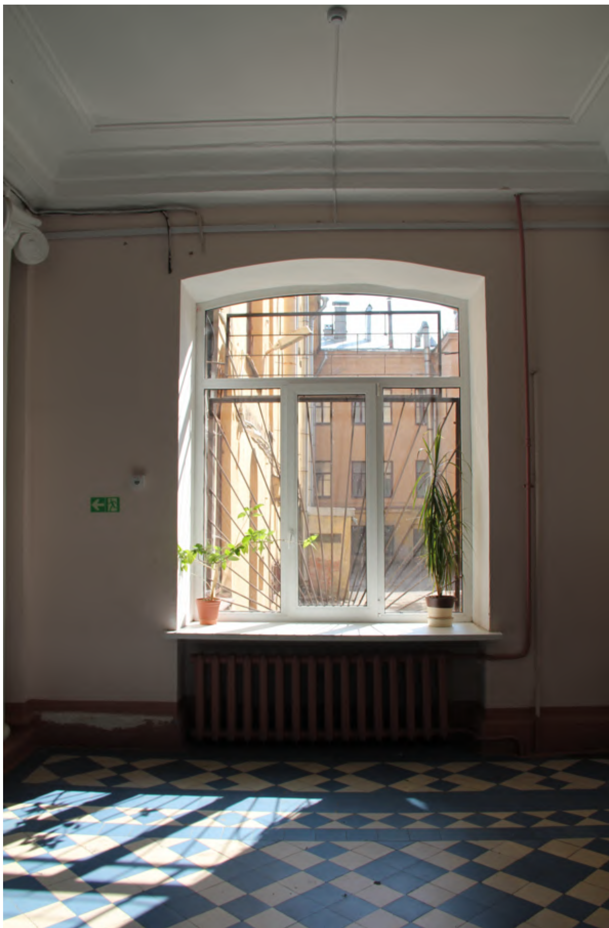
25. Заполнение оконного проема в вестибюле
