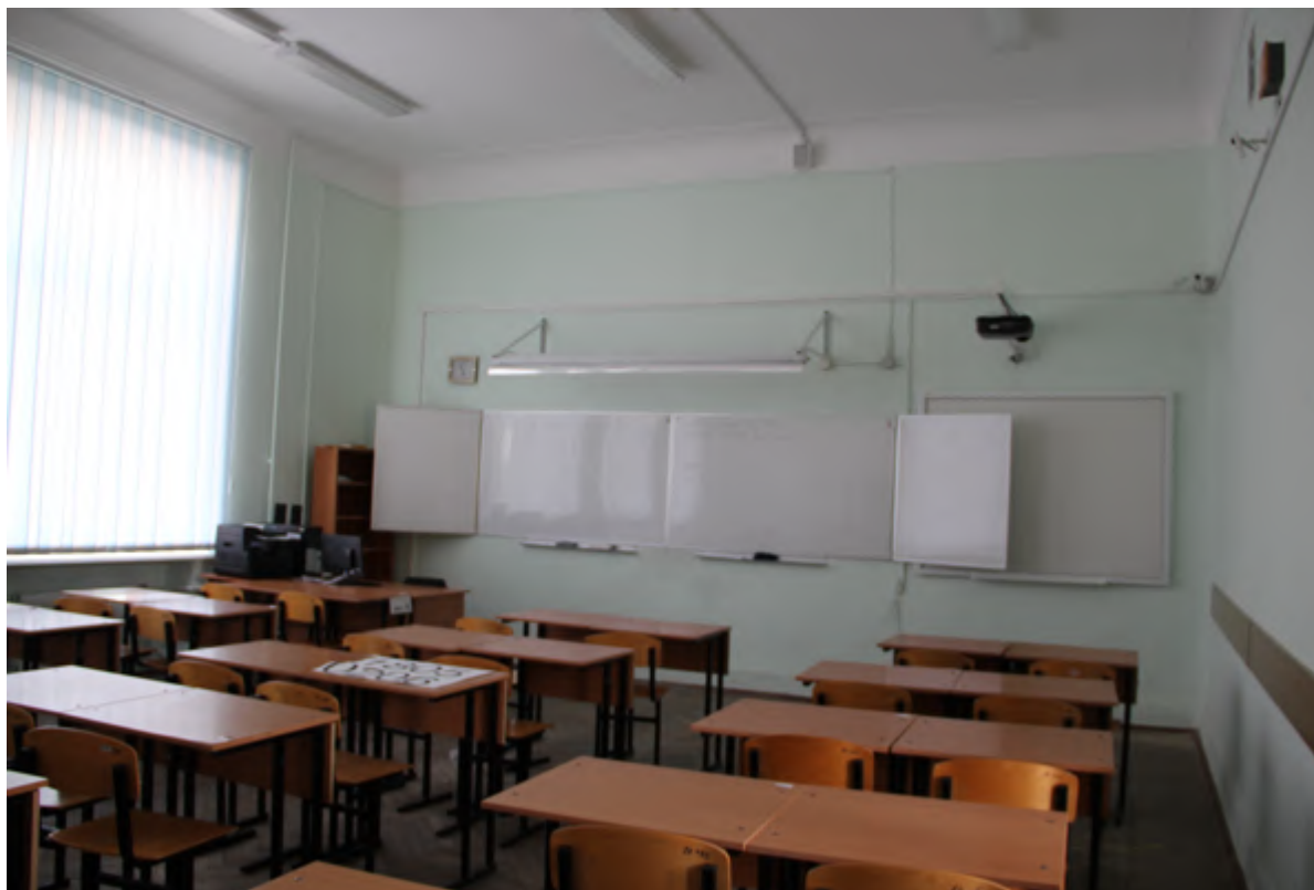
97. Интерьер второго этажа
