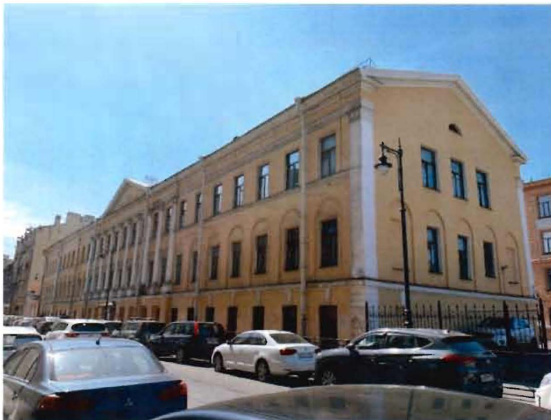
33, 34. Фрагмент лицевого фасада по Гагаринской улице
