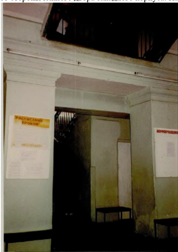
Илл. 65. Вестибюль главного входа восточного корпуса. Паспорт КГИОП 2002 г.
