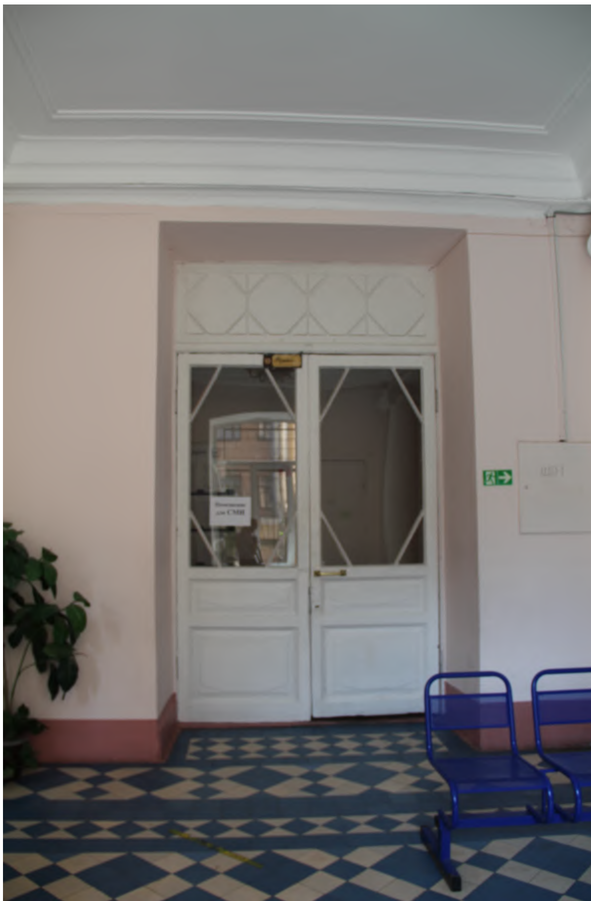
24. Заполнение дверного проема в вестибюле
