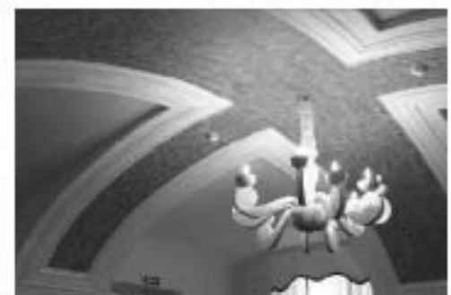
соединенный свод с расщепками по углам (помещения 1-Н (42, 47, 56, 62);
