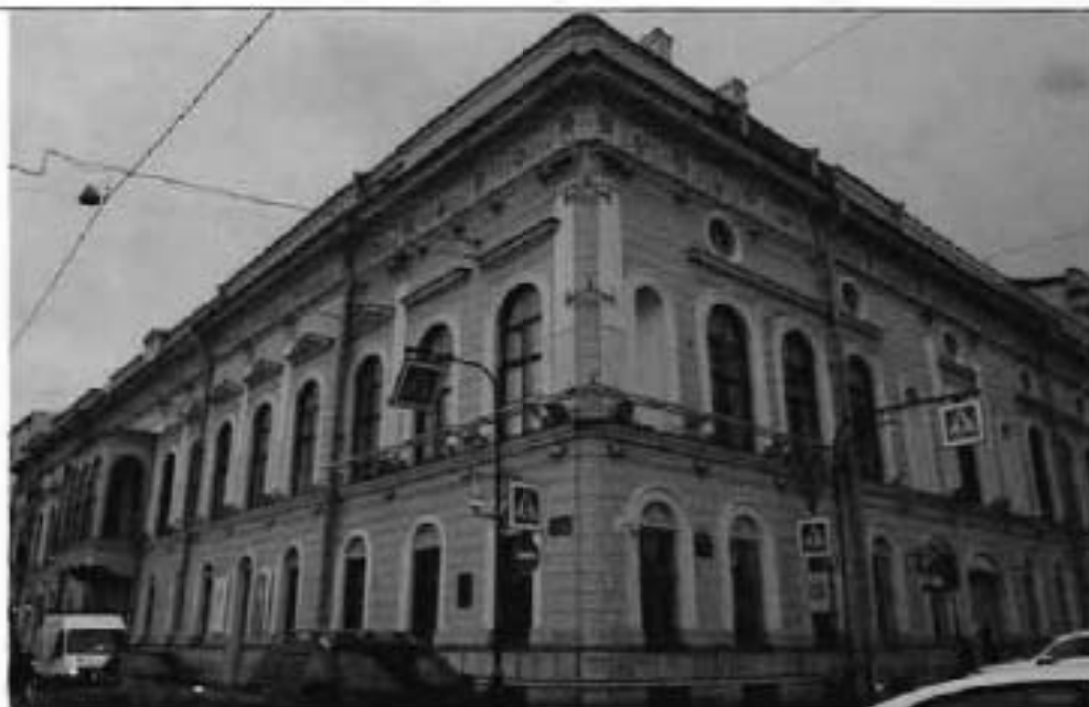
1. Общий вид здания (пересечение наб. р. Фонтанки и Итальянской ул.)
