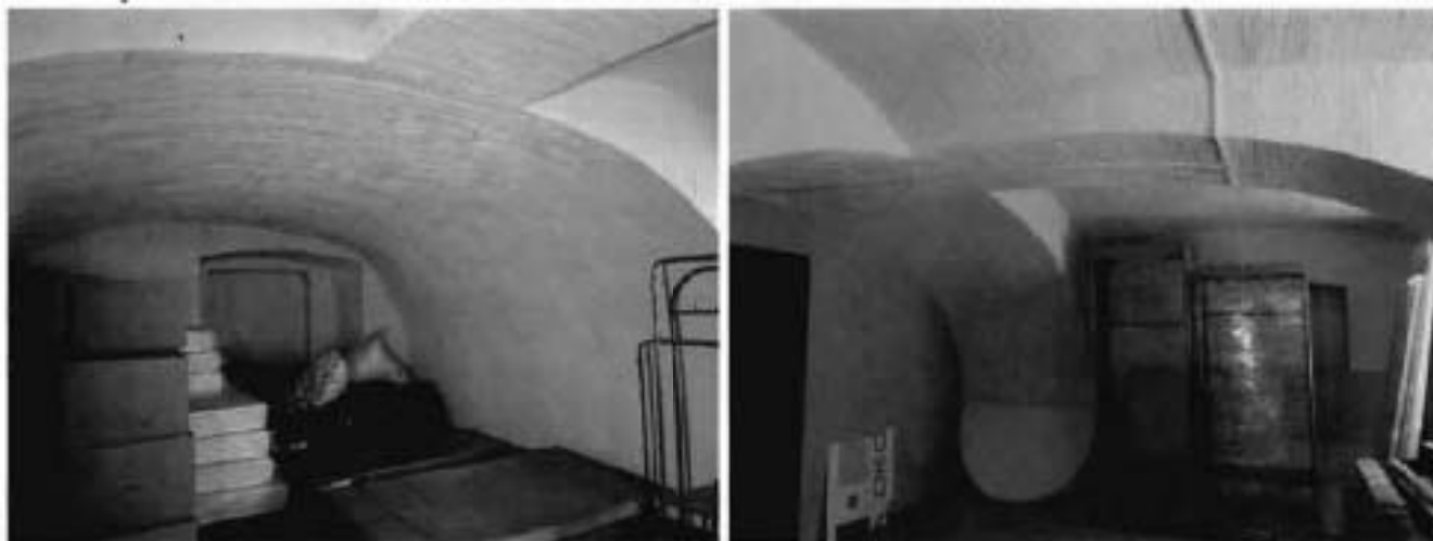
14, 15. Своды в помещениях 1 этажа главного дома объекта культурного наследия по наб. реки Фонтанки.
