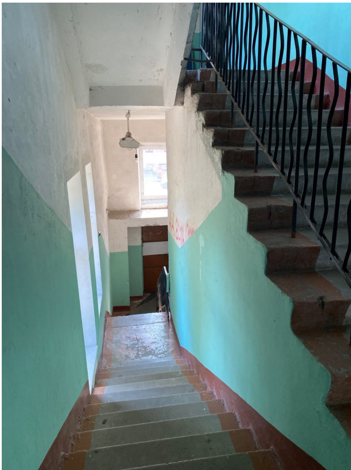
106. Западная лестница объекта культурного наследия в уровне 1-го этажа
