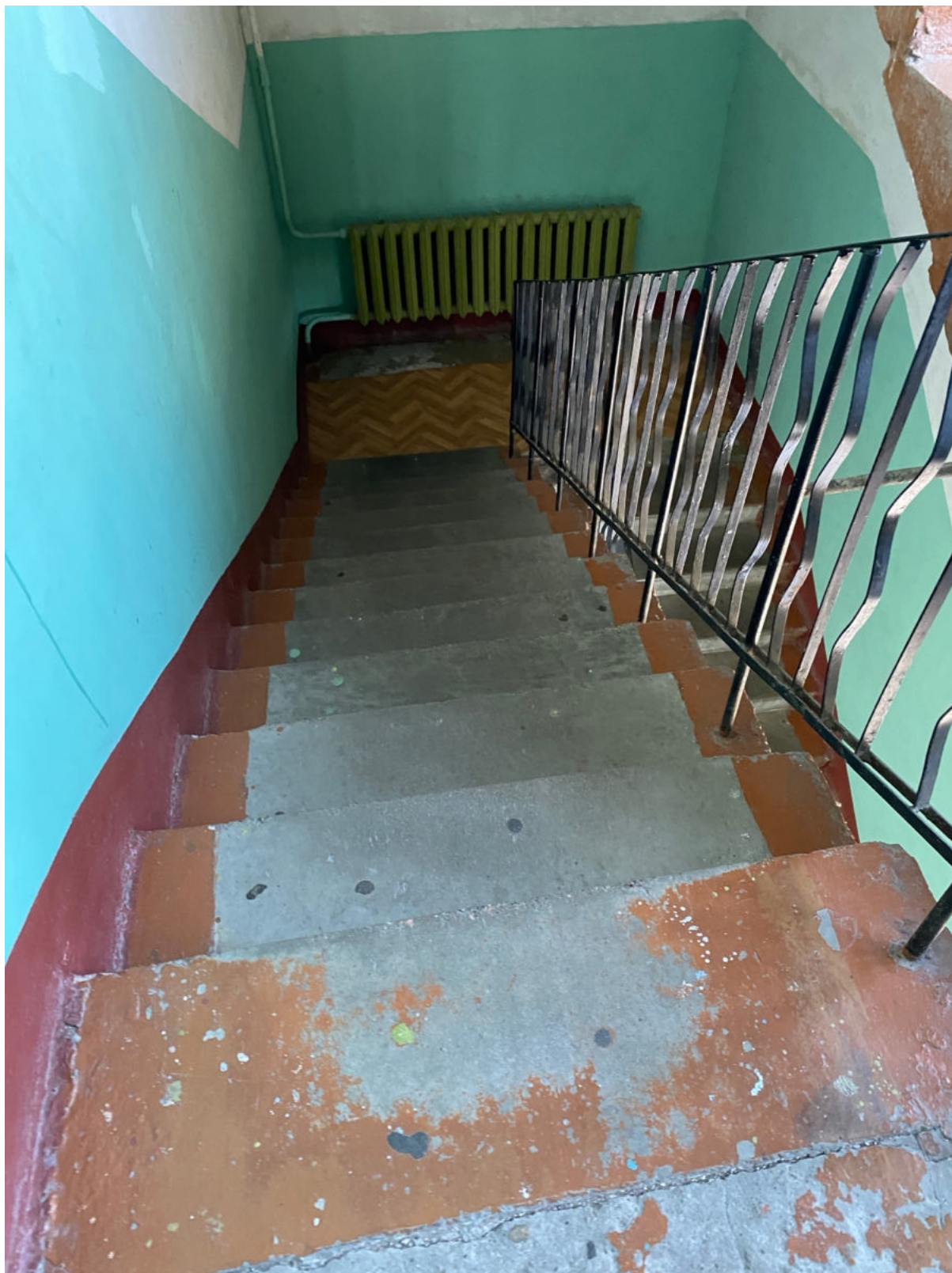
103. Западная лестница объекта культурного наследия в уровне 3-го этажа
