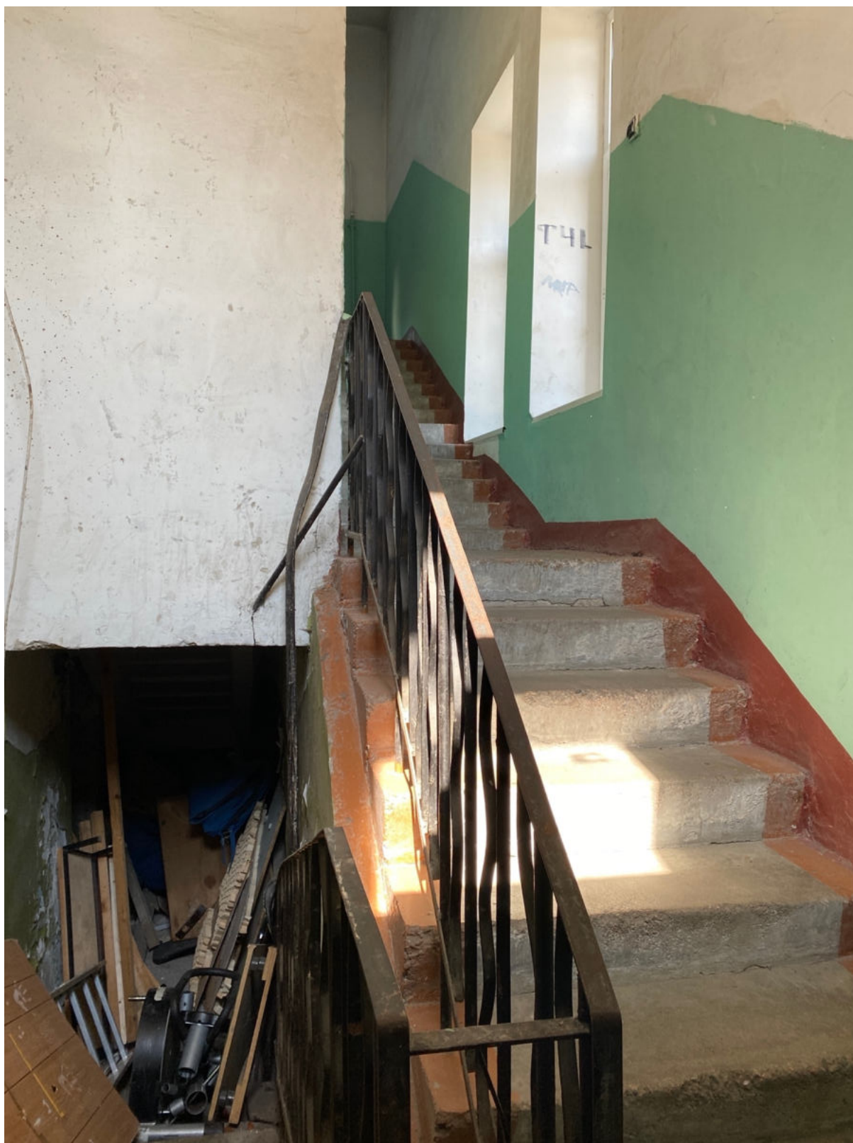
110. Западная лестница объекта культурного наследия в уровне 1-го этажа
