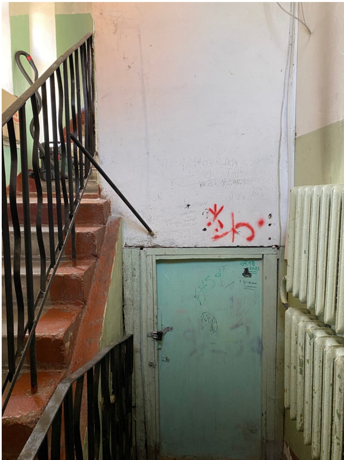
72. Восточная лестница объекта культурного наследия в уровне 1-го этажа
