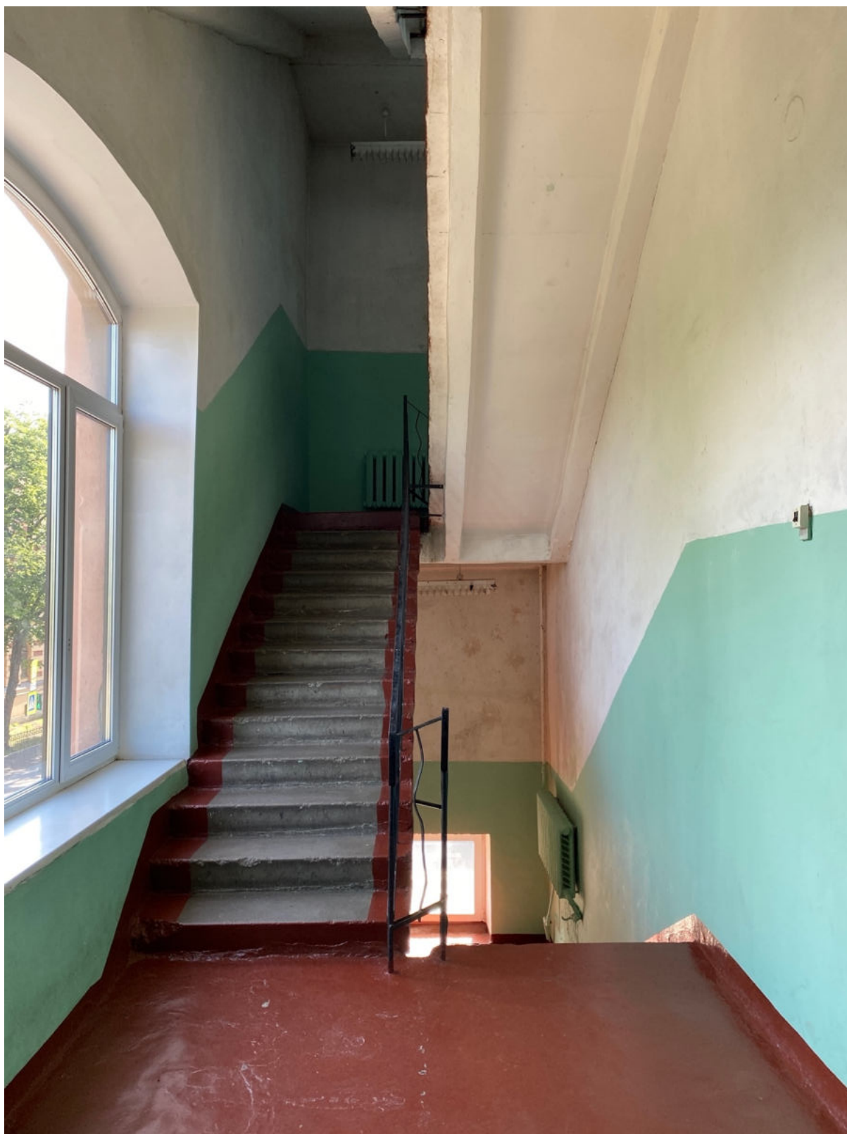
66. Восточная лестница объекта культурного наследия в уровне 2-го этажа
