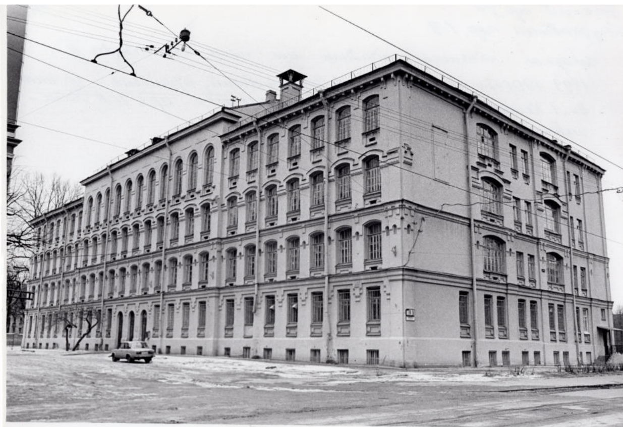
58. Школа № 166. Юго-западный (лицевой) и юго-восточный (торцевой) фасады. 1990 г. Архив КГИОП.
