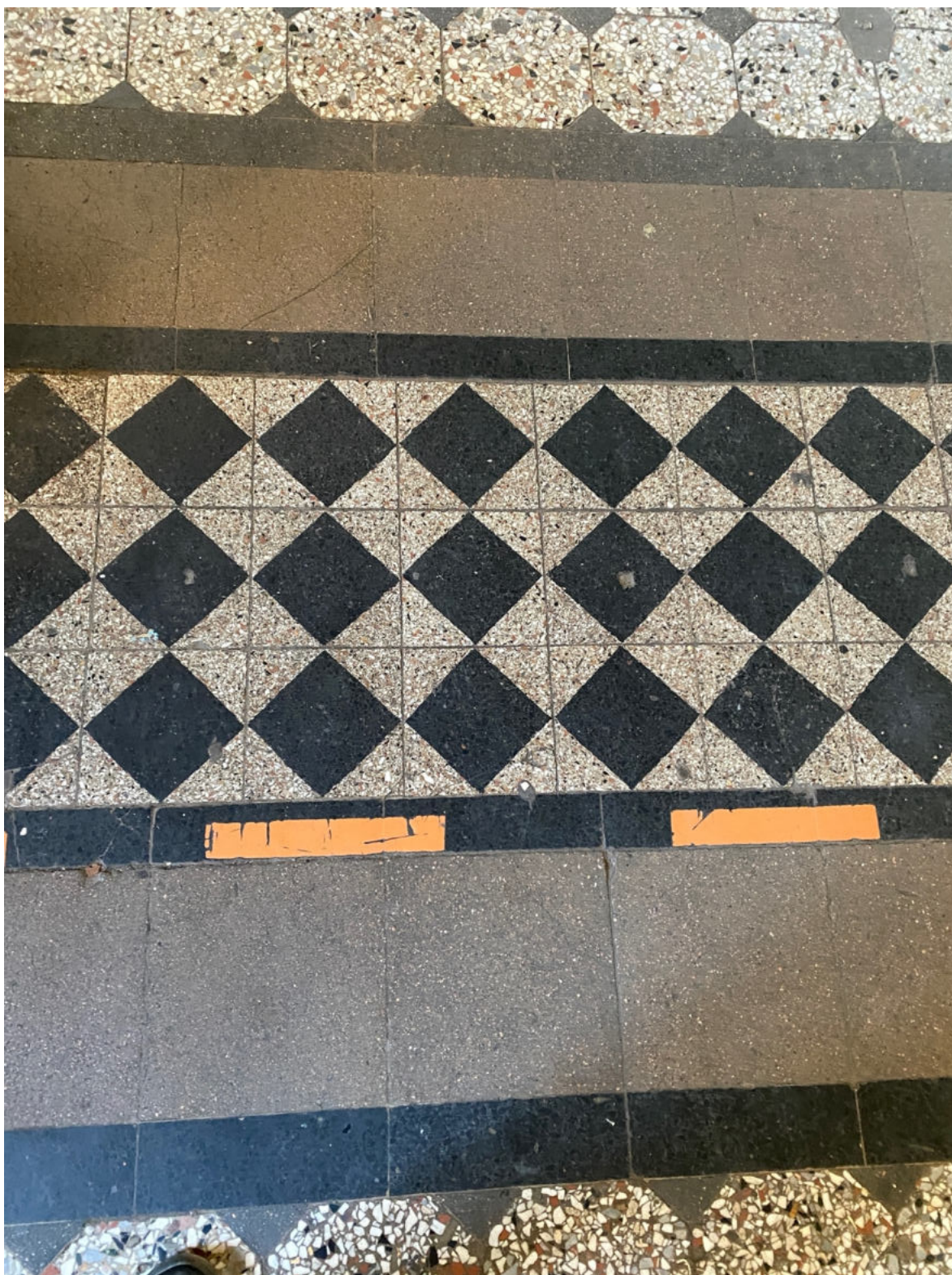
54. Плитка в коридоре 1-го этажа объекта культурного наследия
