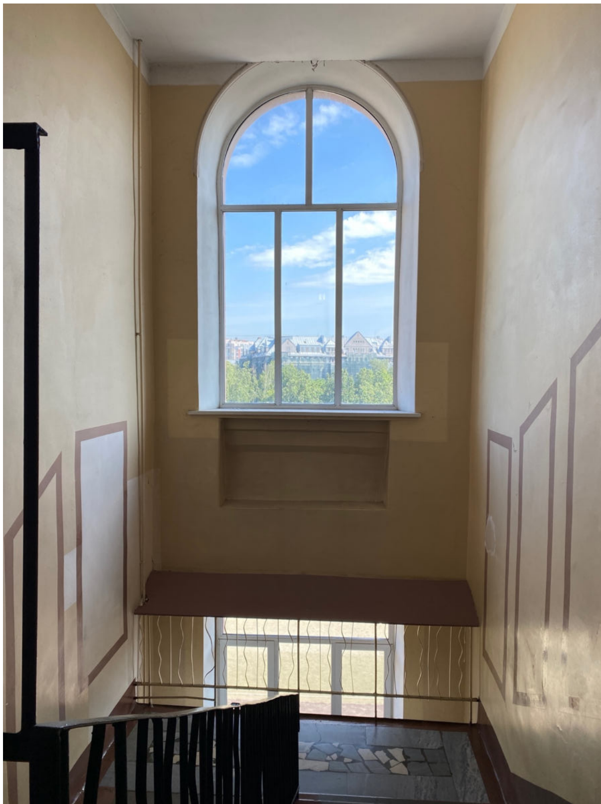
87. Центральная лестница объекта культурного наследия в уровне 4-го этажа
