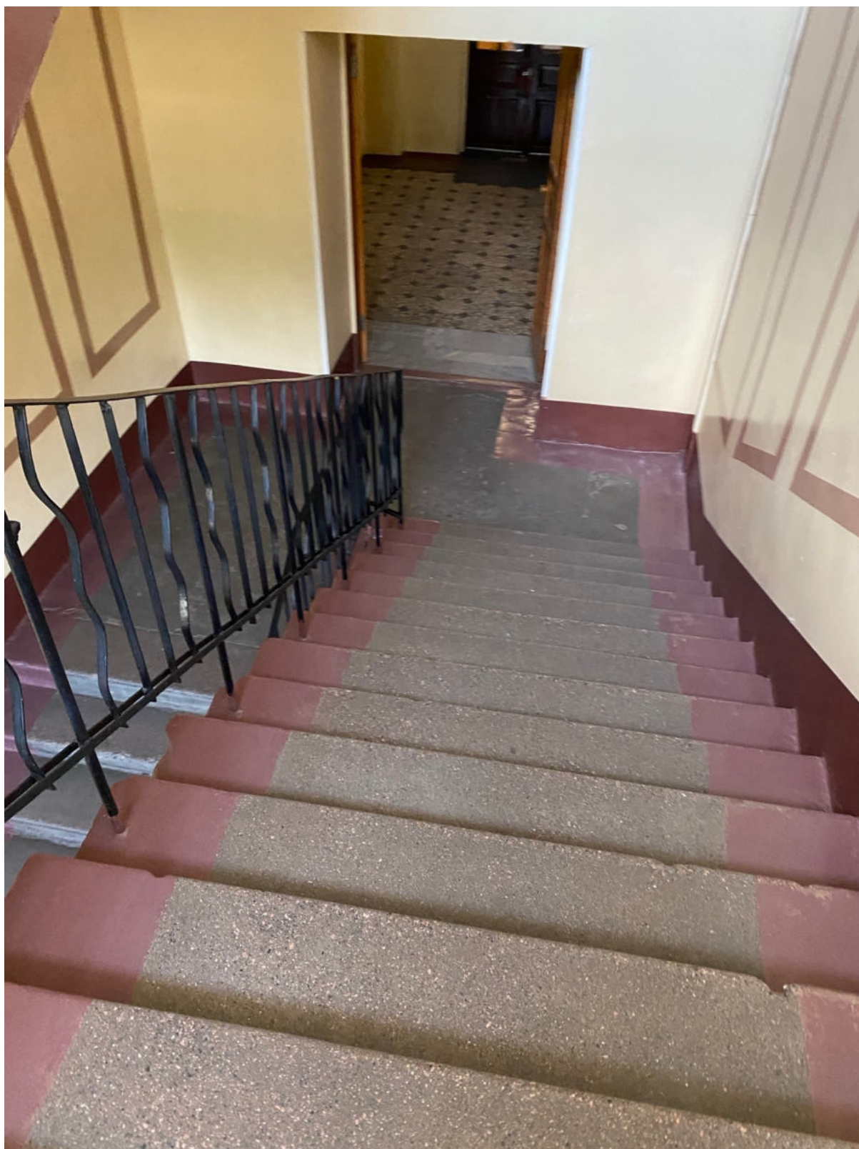
80. Центральная лестница объекта культурного наследия в уровне 1-го этажа
