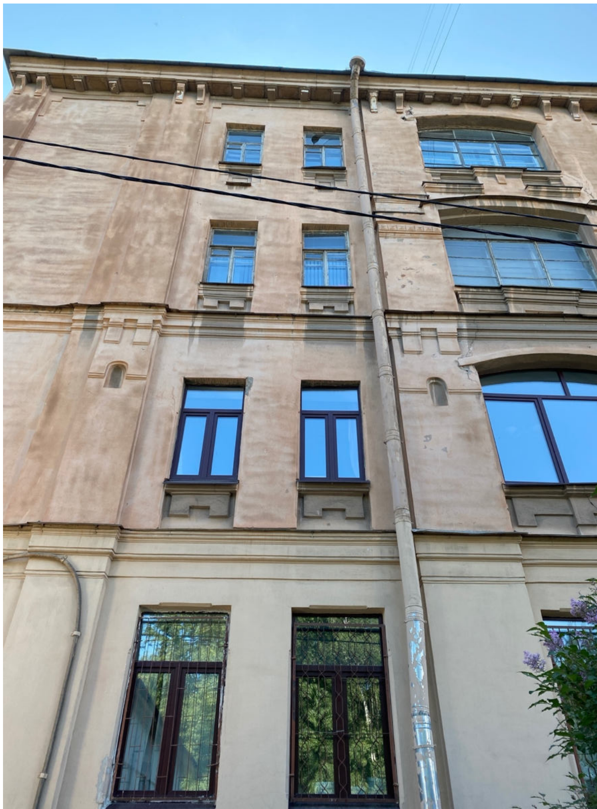
4. Фрагмент западного фасада объекта культурного наследия
