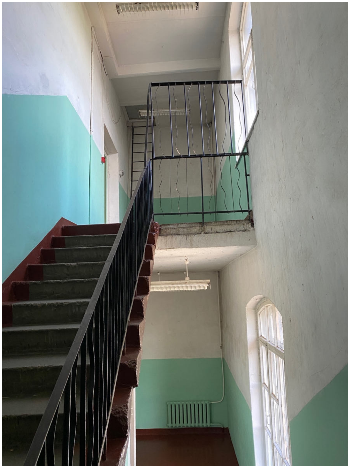
76. Восточная лестница объекта культурного наследия в уровне 4-го этажа
