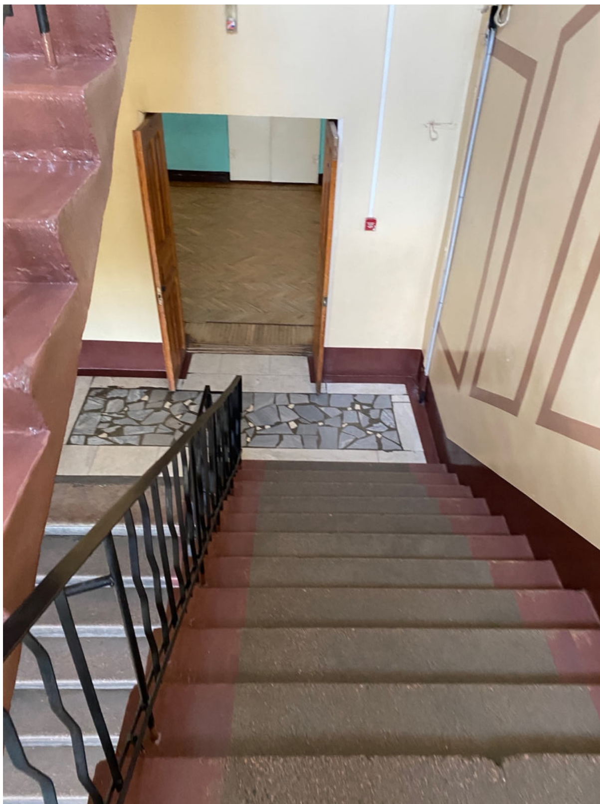
82. Центральная лестница объекта культурного наследия в уровне 2-го этажа
