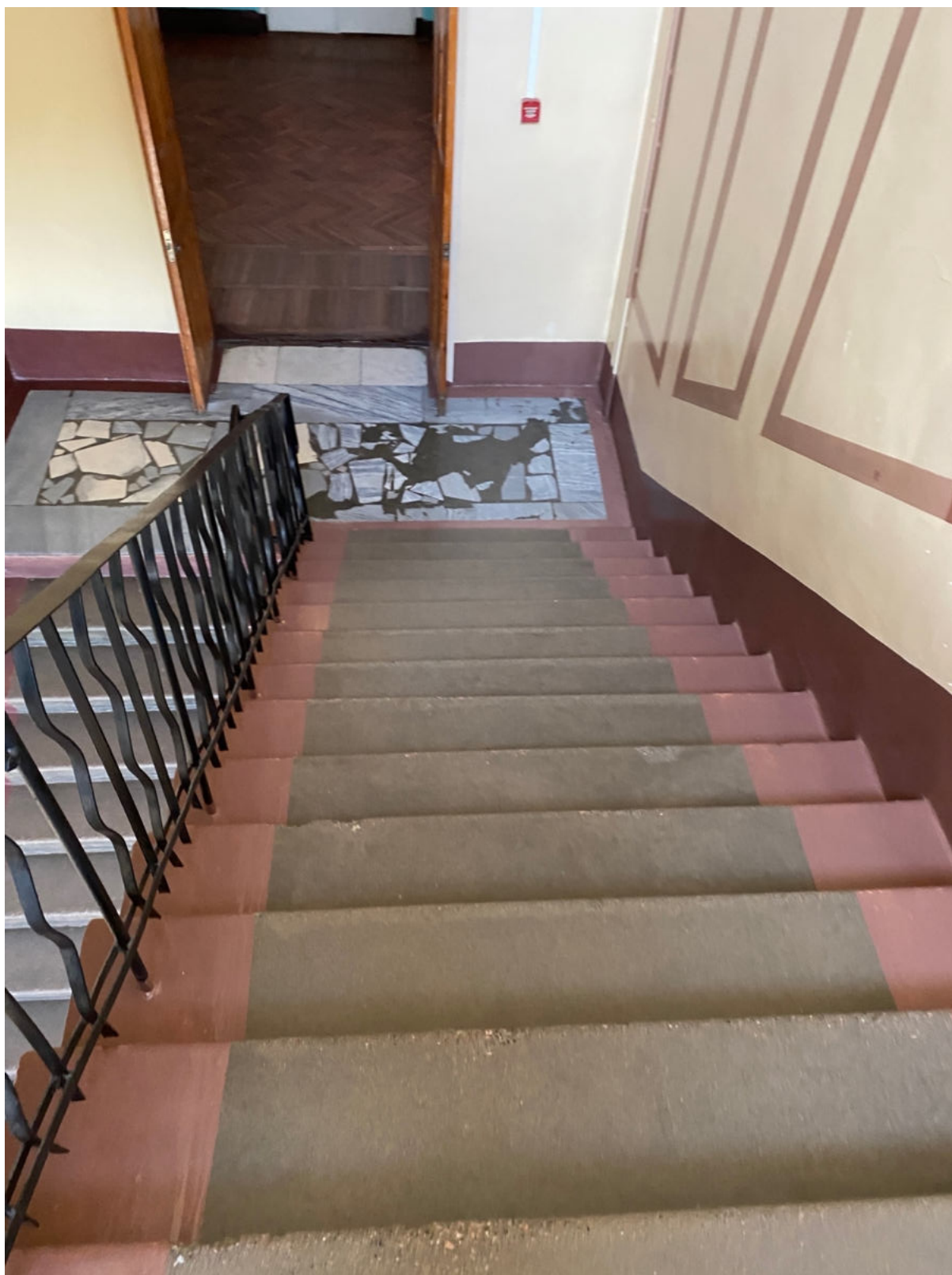
84. Центральная лестница объекта культурного наследия в уровне 3-го этажа
