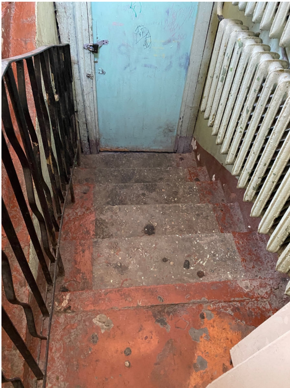
71. Восточная лестница объекта культурного наследия в уровне 1-го этажа
