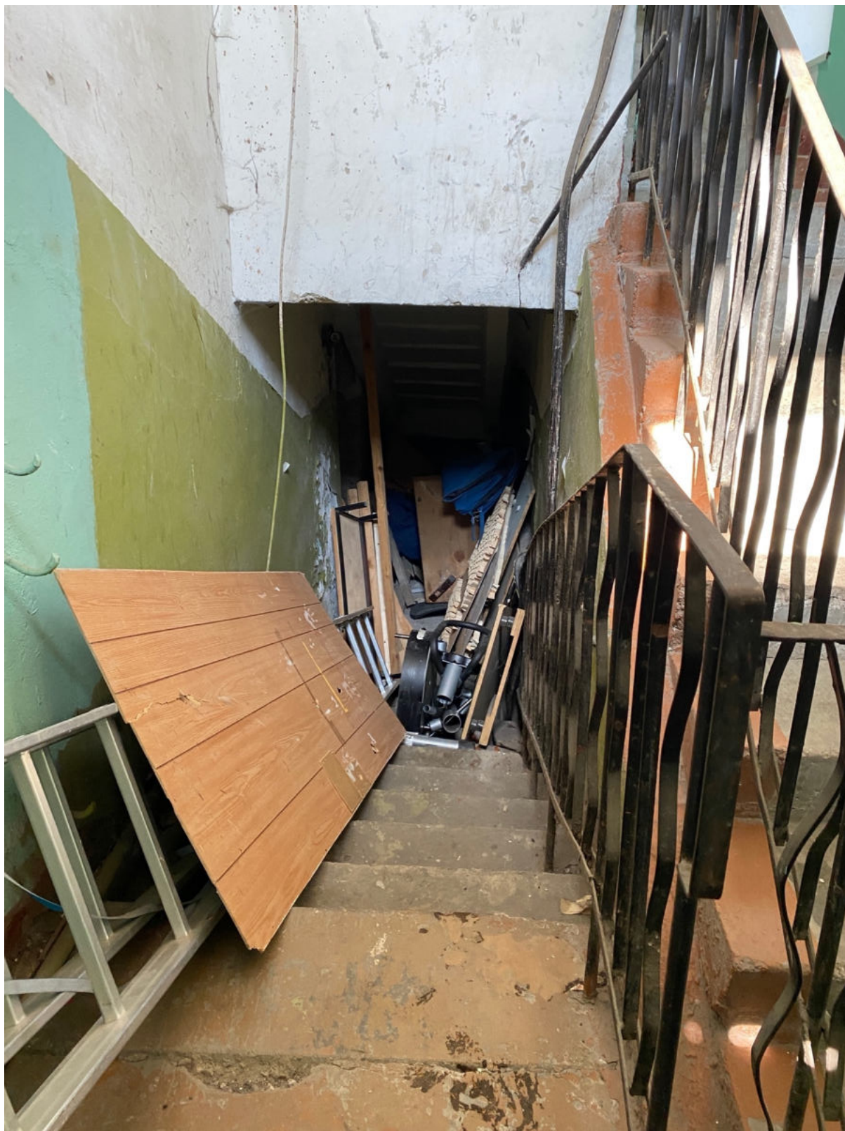
109. Западная лестница объекта культурного наследия в уровне 1-го этажа
