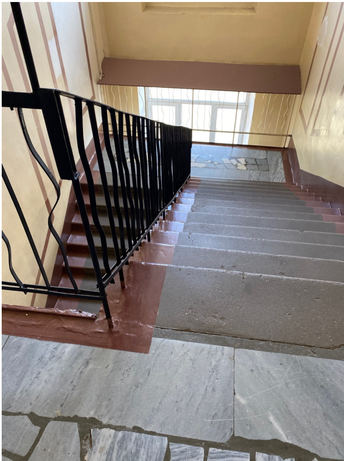
86. Центральная лестница объекта культурного наследия в уровне 4-го этажа
