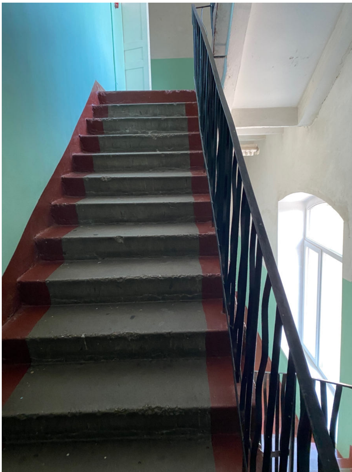
74. Восточная лестница объекта культурного наследия в уровне 3-го этажа
