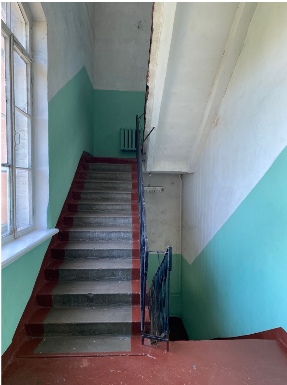
75. Восточная лестница объекта культурного наследия в уровне 4-го этажа
