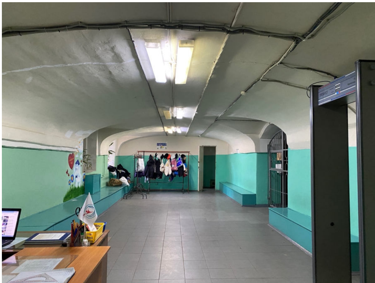
40. Помещение цокольного этажа объекта культурного наследия
