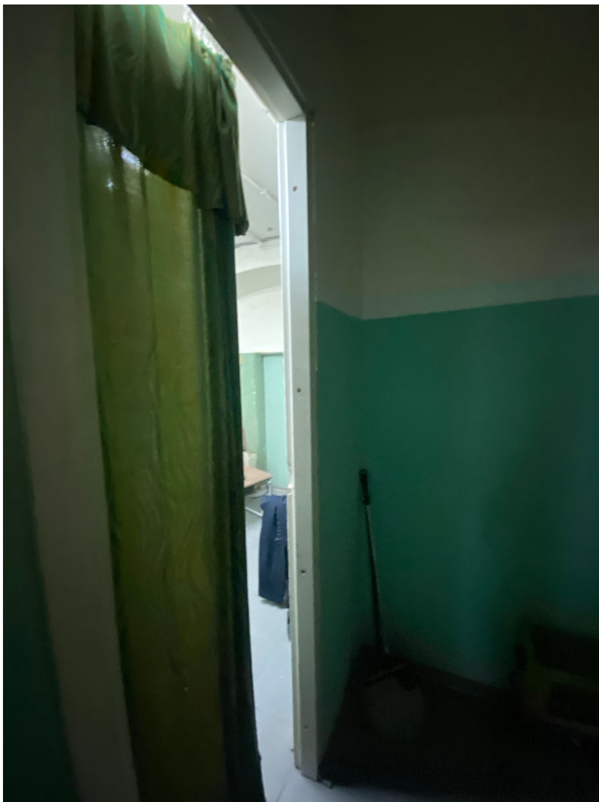
36. Помещение цокольного этажа объекта культурного наследия
