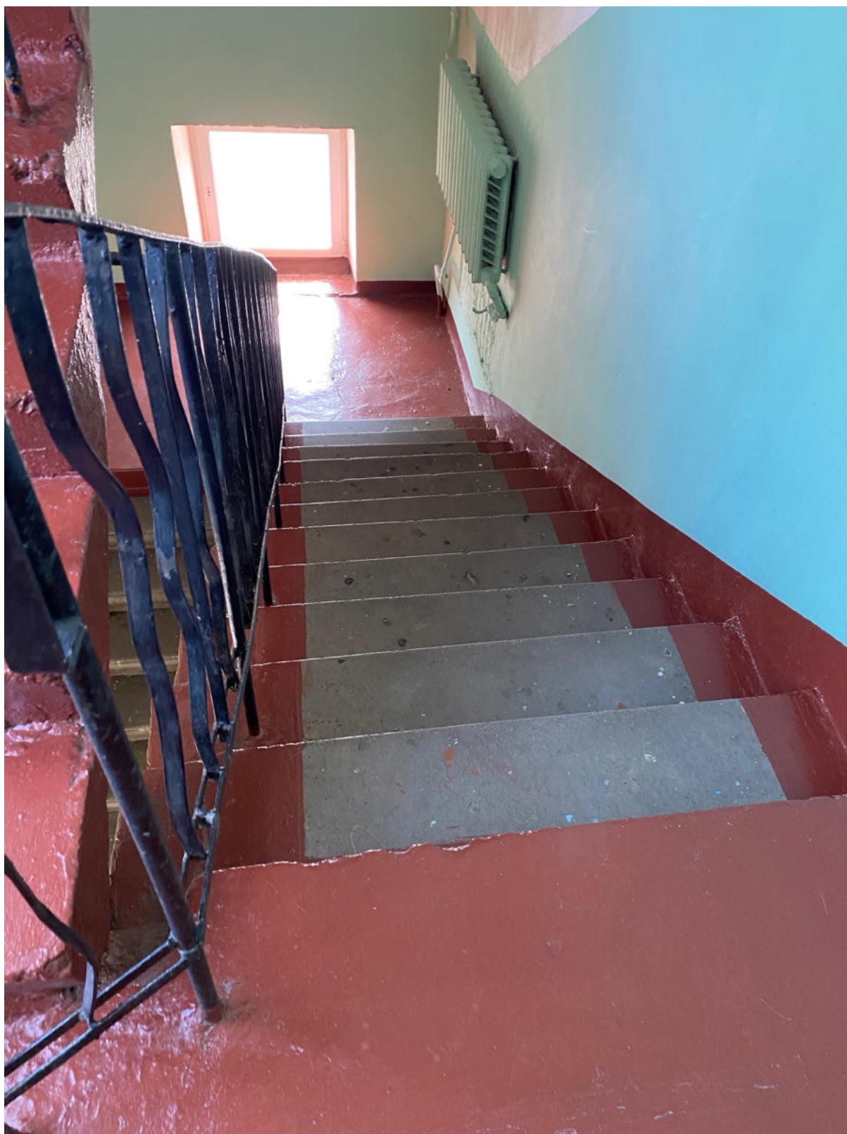
67. Восточная лестница объекта культурного наследия в уровне 2-го этажа
