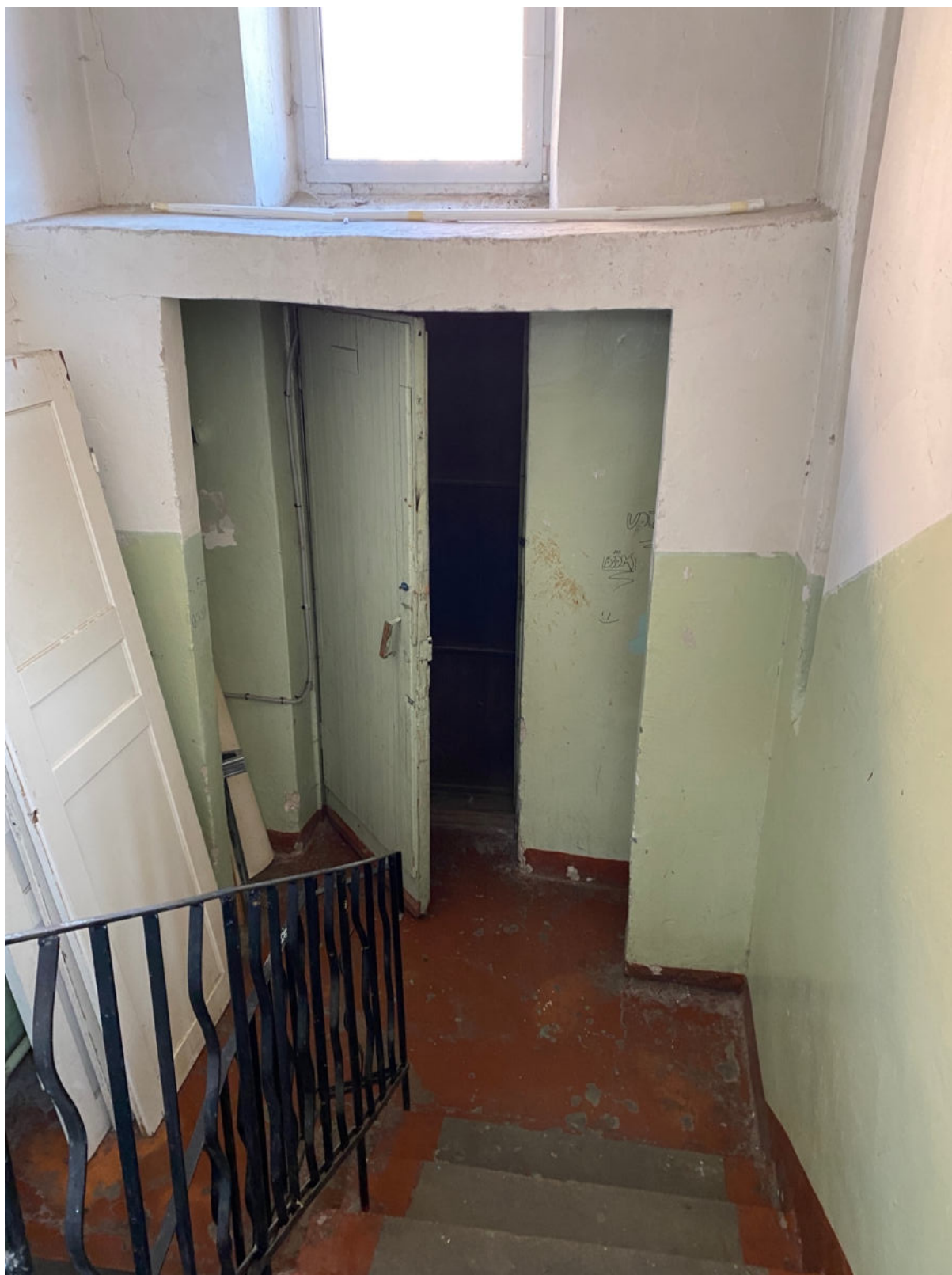
69. Восточная лестница объекта культурного наследия в уровне 1-го этажа
