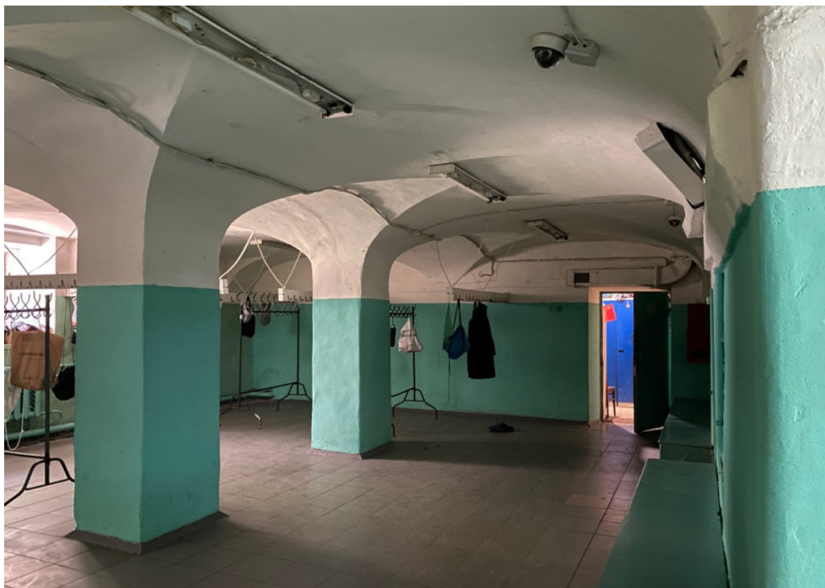
33. Помещение цокольного этажа объекта культурного наследия
