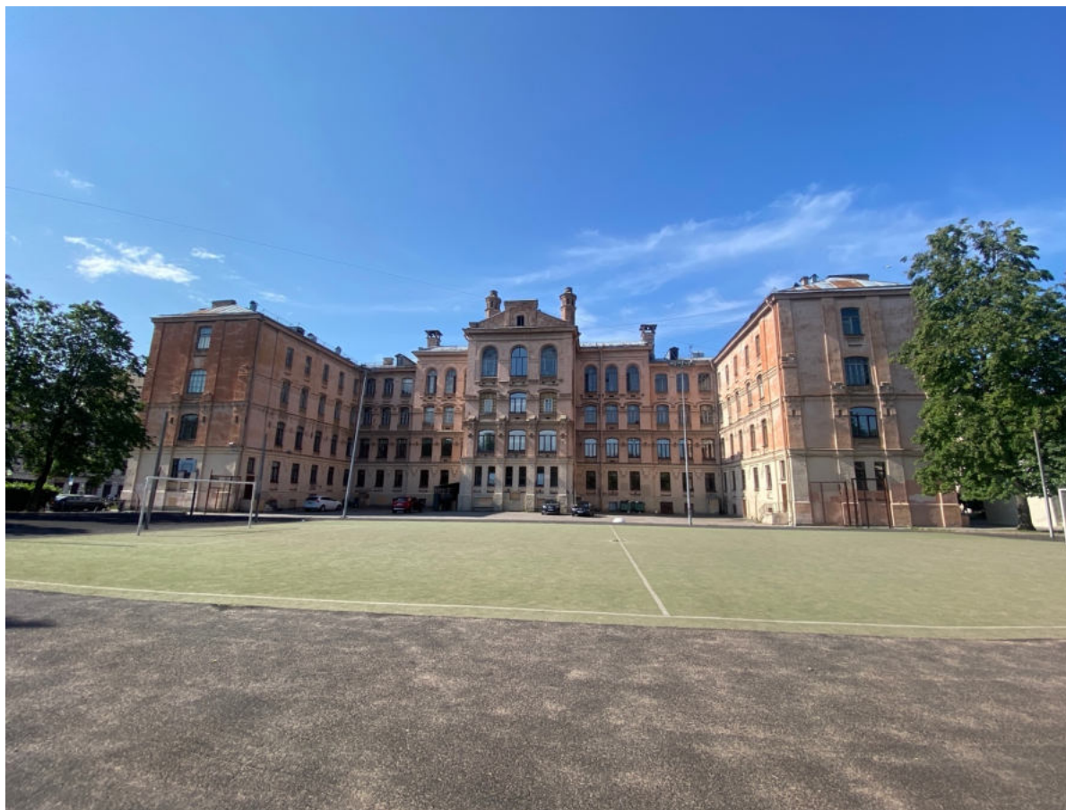
7. Общий вид северного фасада объекта культурного наследия
