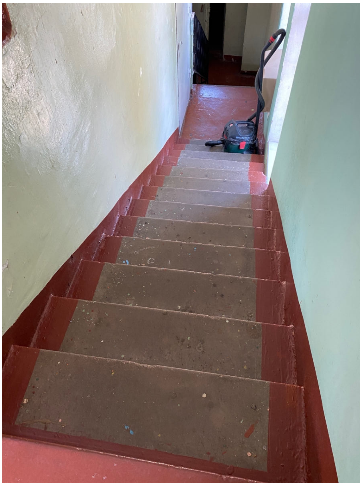
68. Восточная лестница объекта культурного наследия в уровне 1-го этажа
