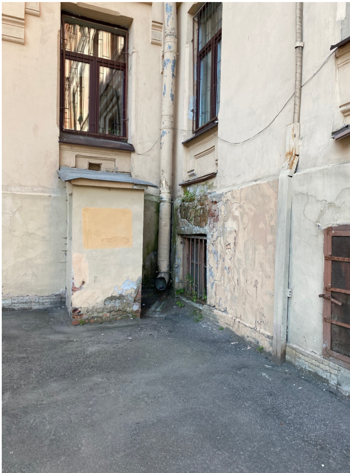
11. Фрагмент северного фасада объекта культурного наследия
