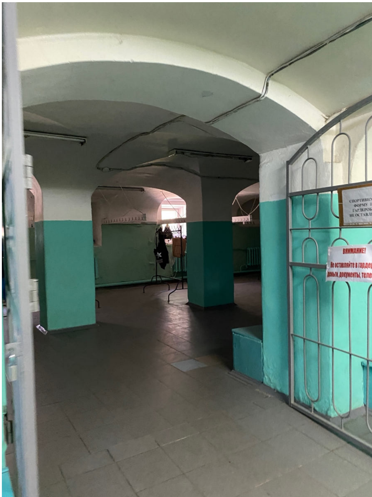
34. Помещение цокольного этажа объекта культурного наследия
