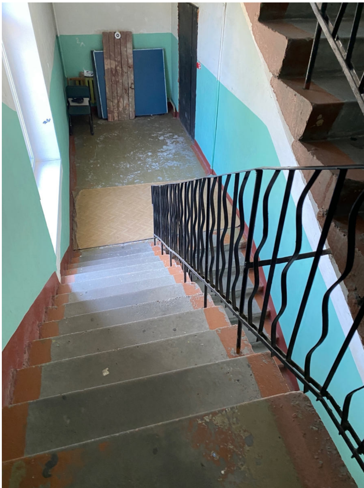
104. Западная лестница объекта культурного наследия в уровне 2-го этажа
