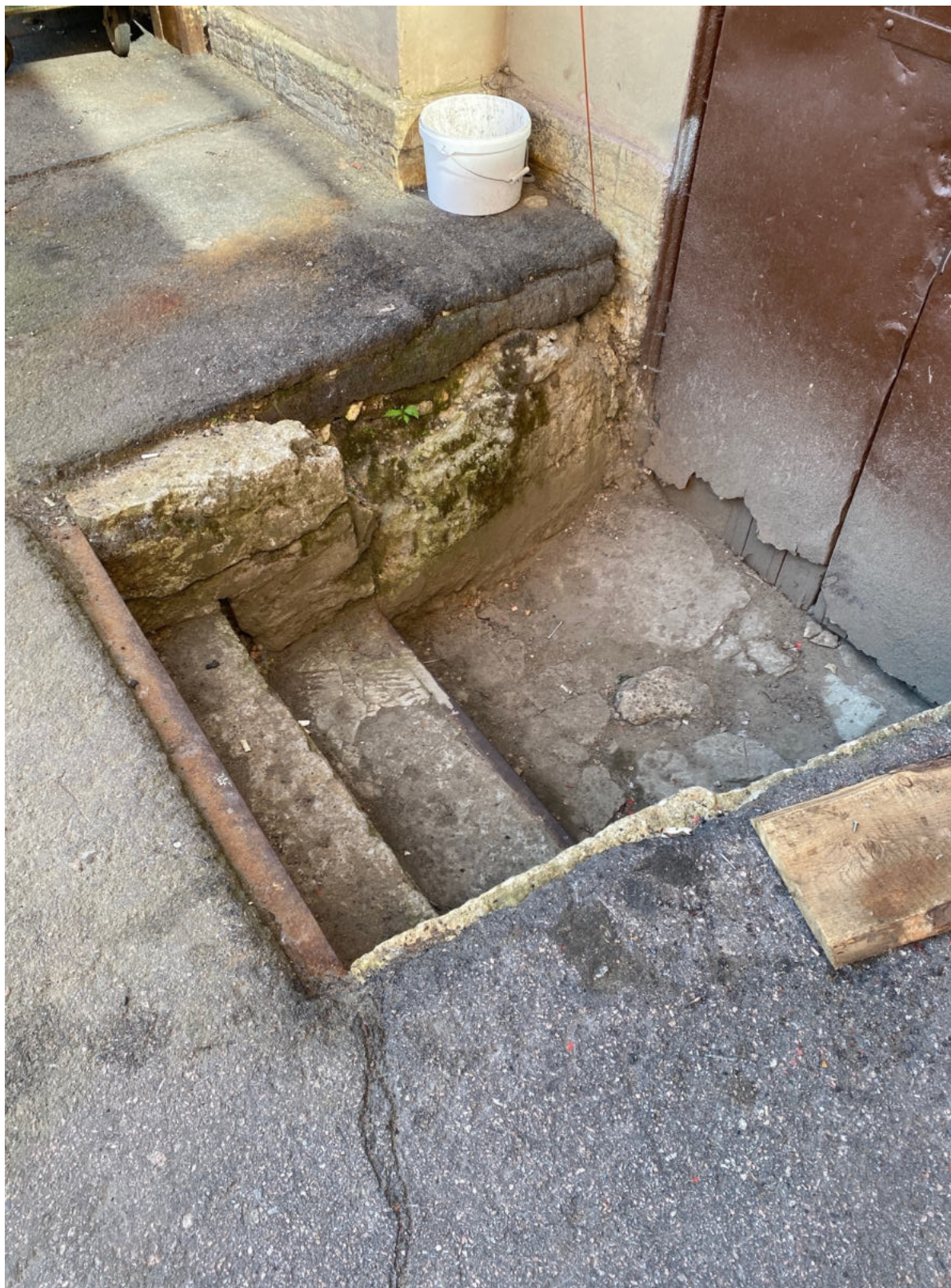
10. Фрагмент северного фасада объекта культурного наследия
