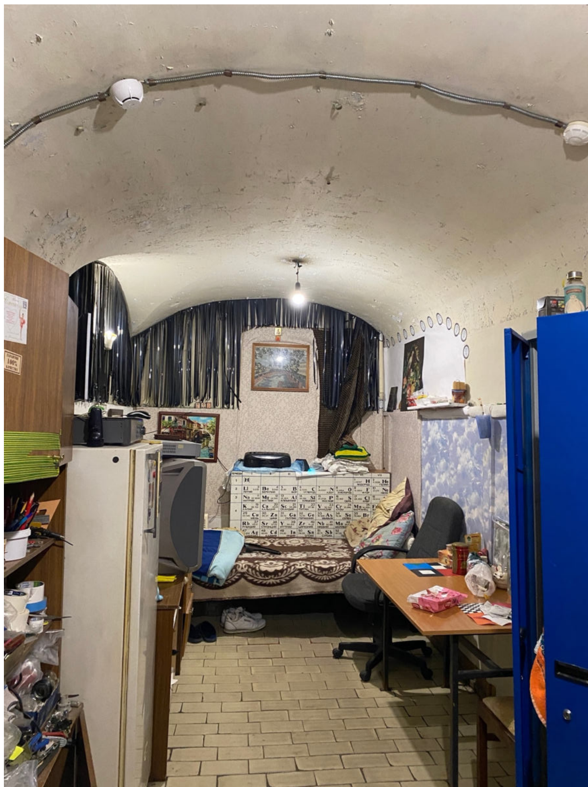
31. Помещение цокольного этажа объекта культурного наследия
