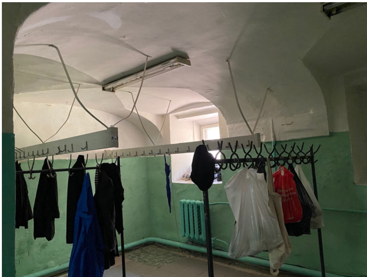
32. Помещение цокольного этажа объекта культурного наследия
