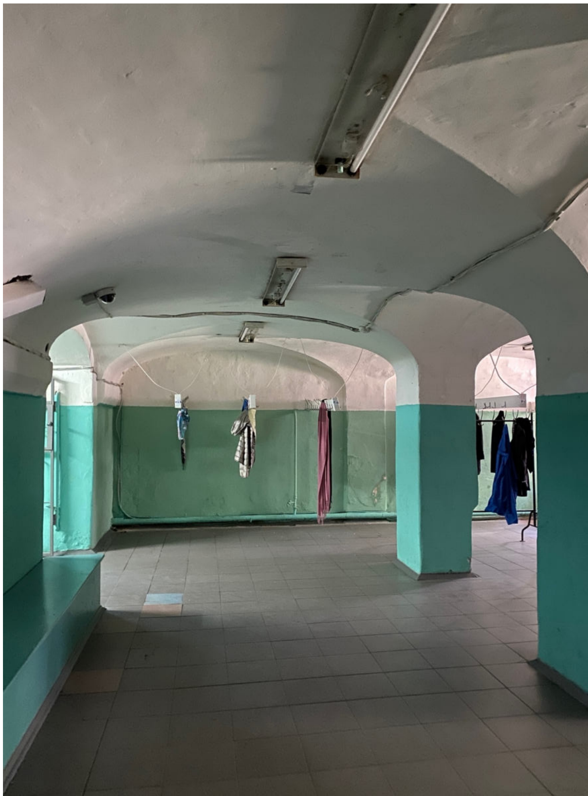
29. Помещение цокольного этажа объекта культурного наследия
