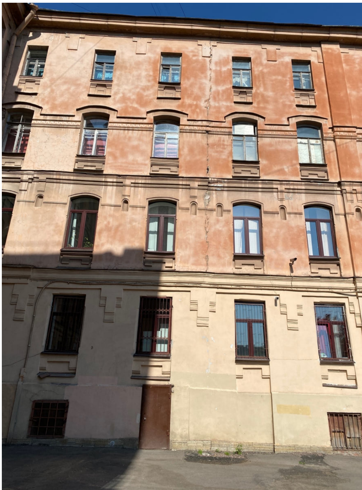
8. Фрагмент северного фасада объекта культурного наследия
