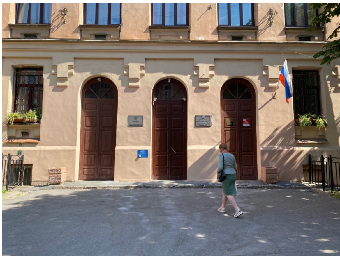
23. Входная группа южного фасада объекта культурного наследия
