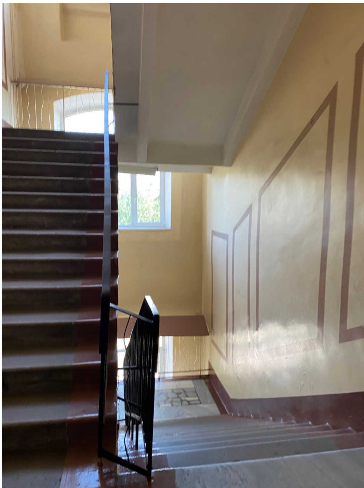
83. Центральная лестница объекта культурного наследия в уровне 3-го этажа
