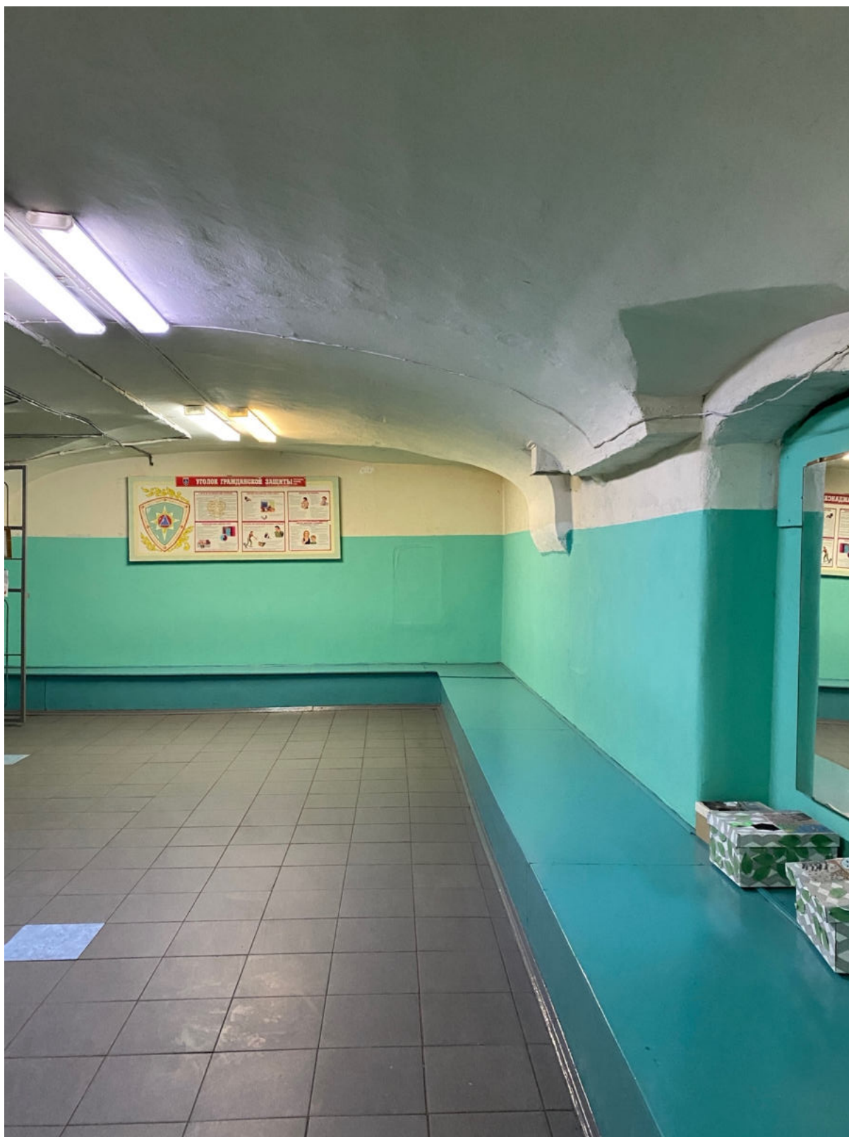
41. Помещение цокольного этажа объекта культурного наследия
