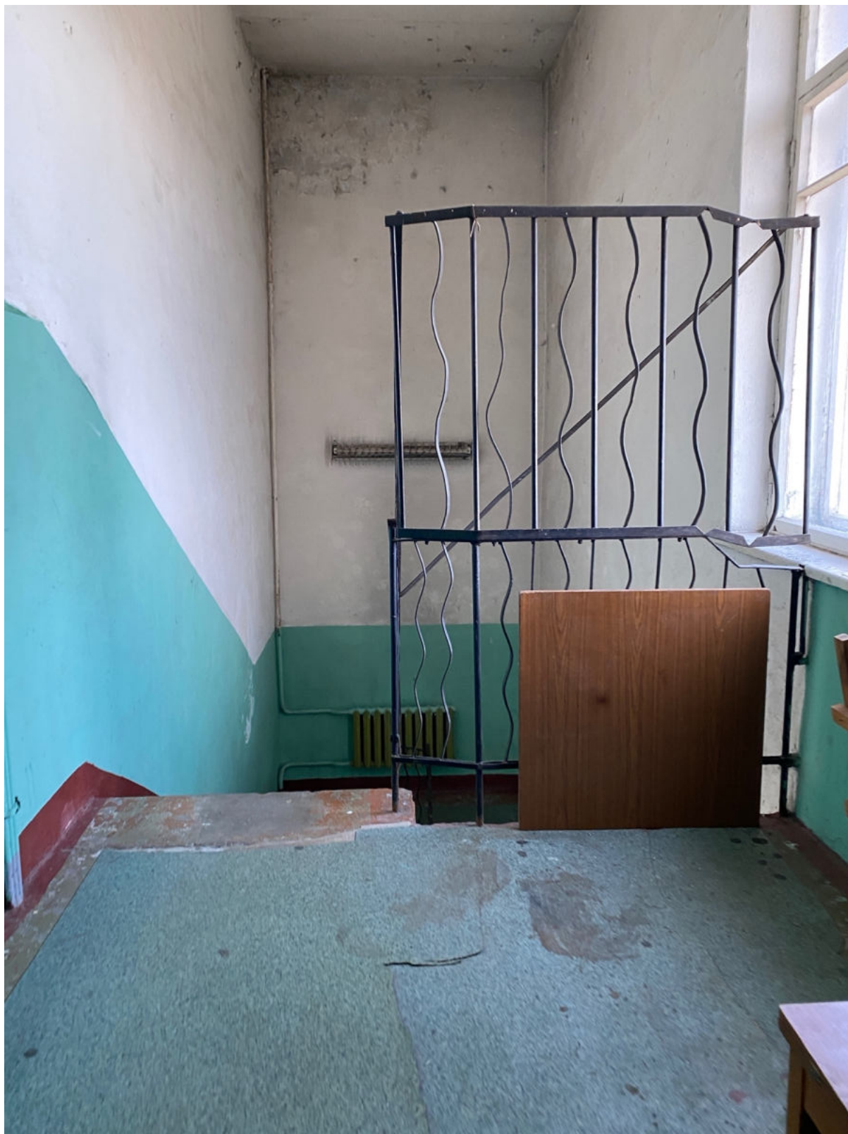
101. Западная лестница объекта культурного наследия в уровне 4-го этажа
