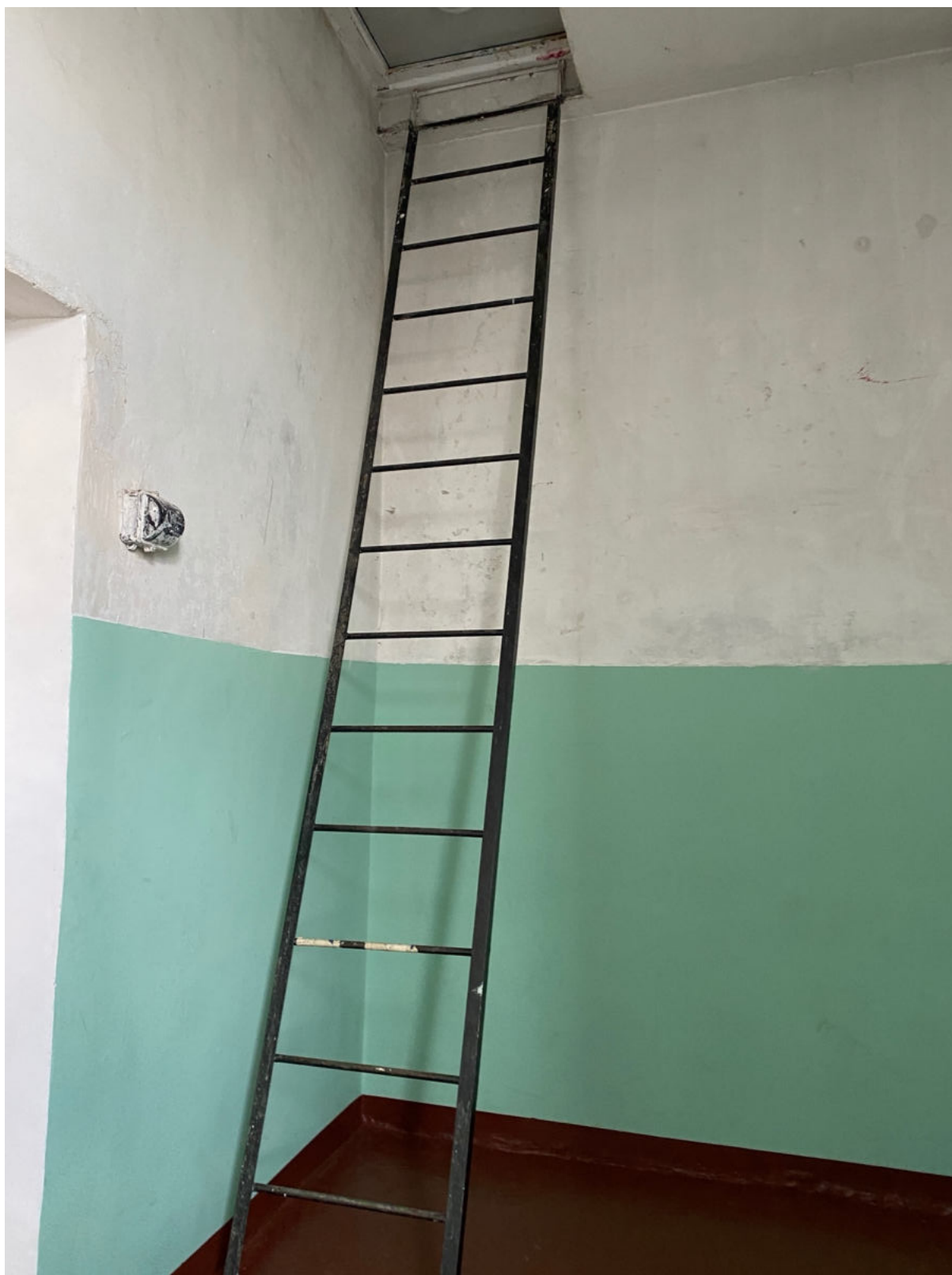
78. Восточная лестница объекта культурного наследия в уровне 4-го этажа
