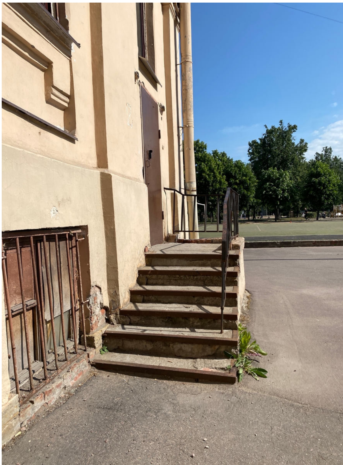
12. Фрагмент северного фасада объекта культурного наследия
