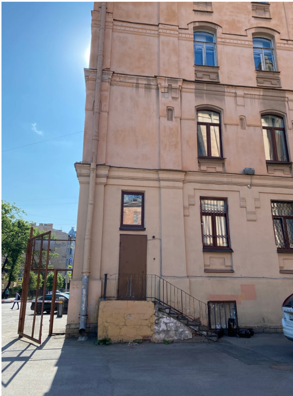
13. Фрагмент северного фасада объекта культурного наследия
