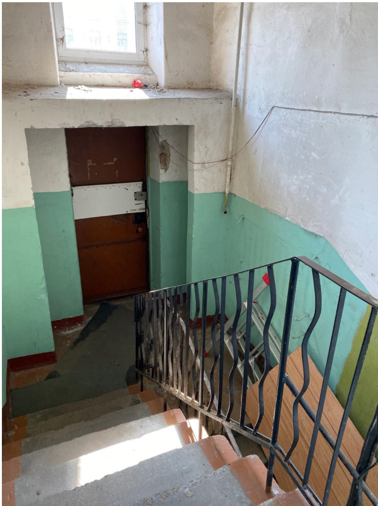
107. Западная лестница объекта культурного наследия в уровне 1-го этажа
