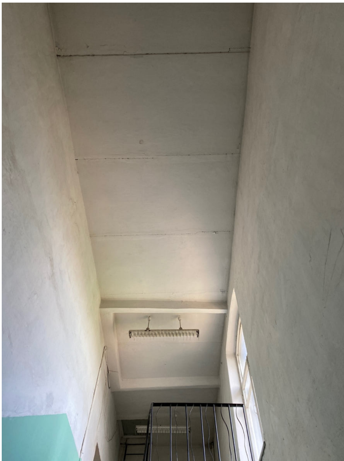
77. Восточная лестница объекта культурного наследия в уровне 4-го этажа
