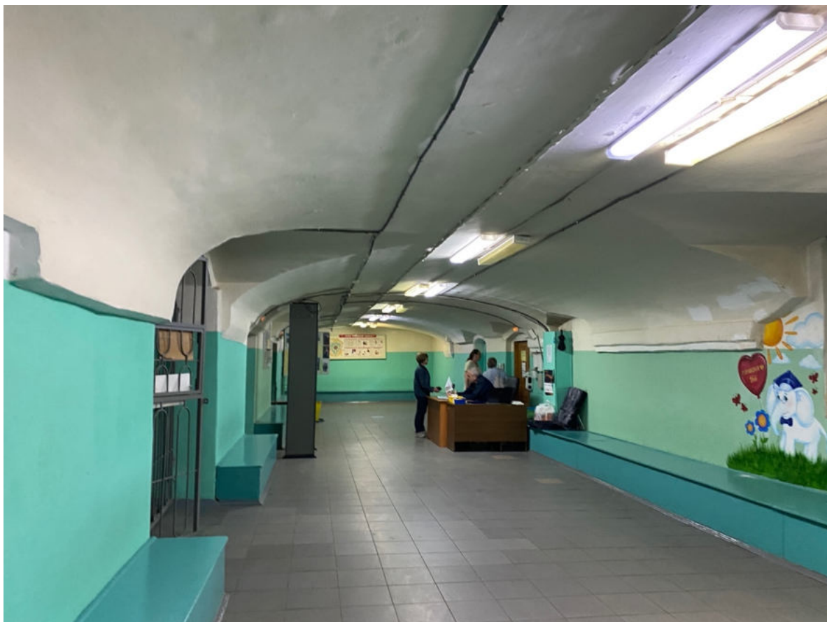
35. Помещение цокольного этажа объекта культурного наследия
