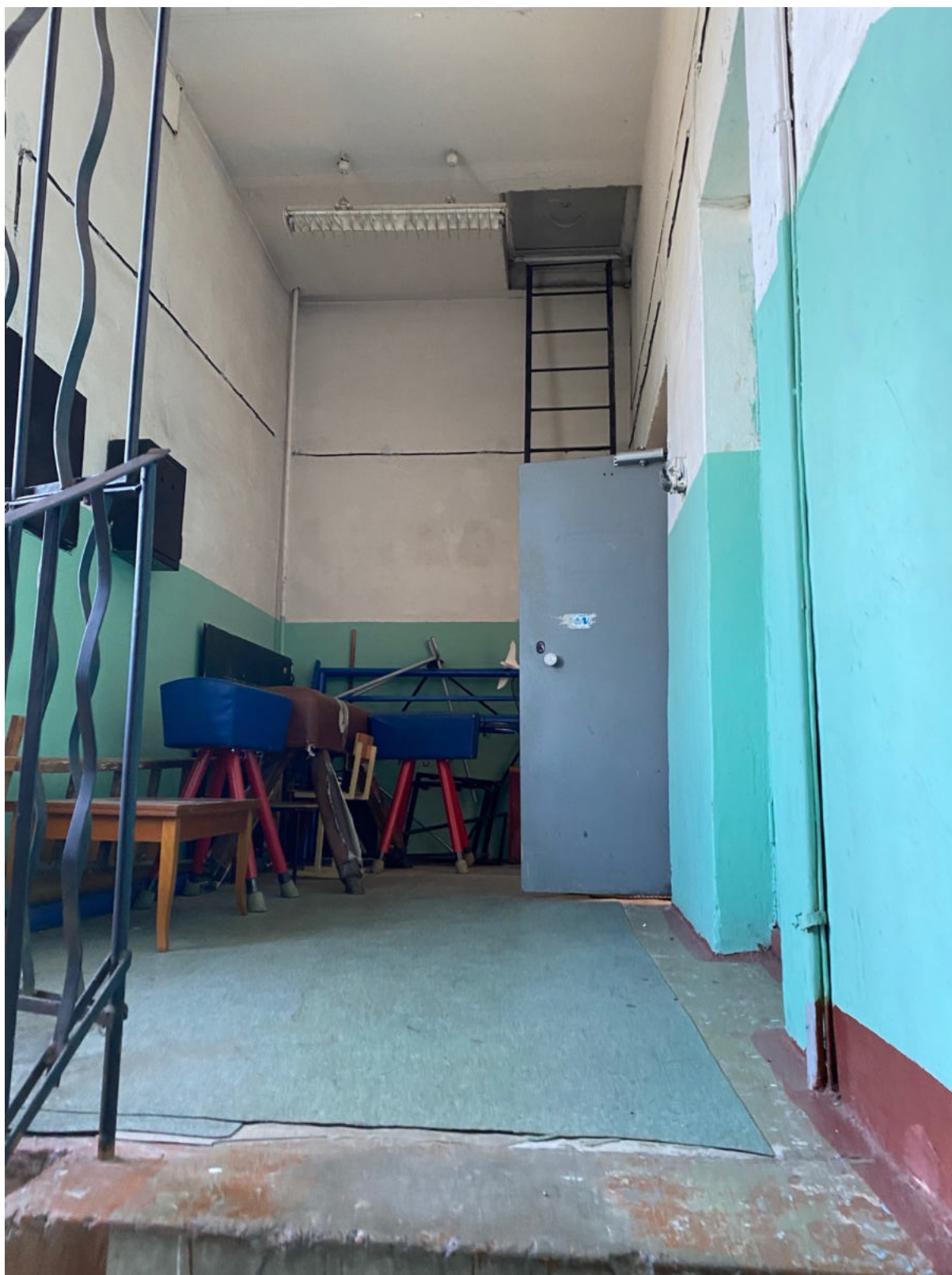
111. Западная лестница объекта культурного наследия в уровне 4-го этажа
