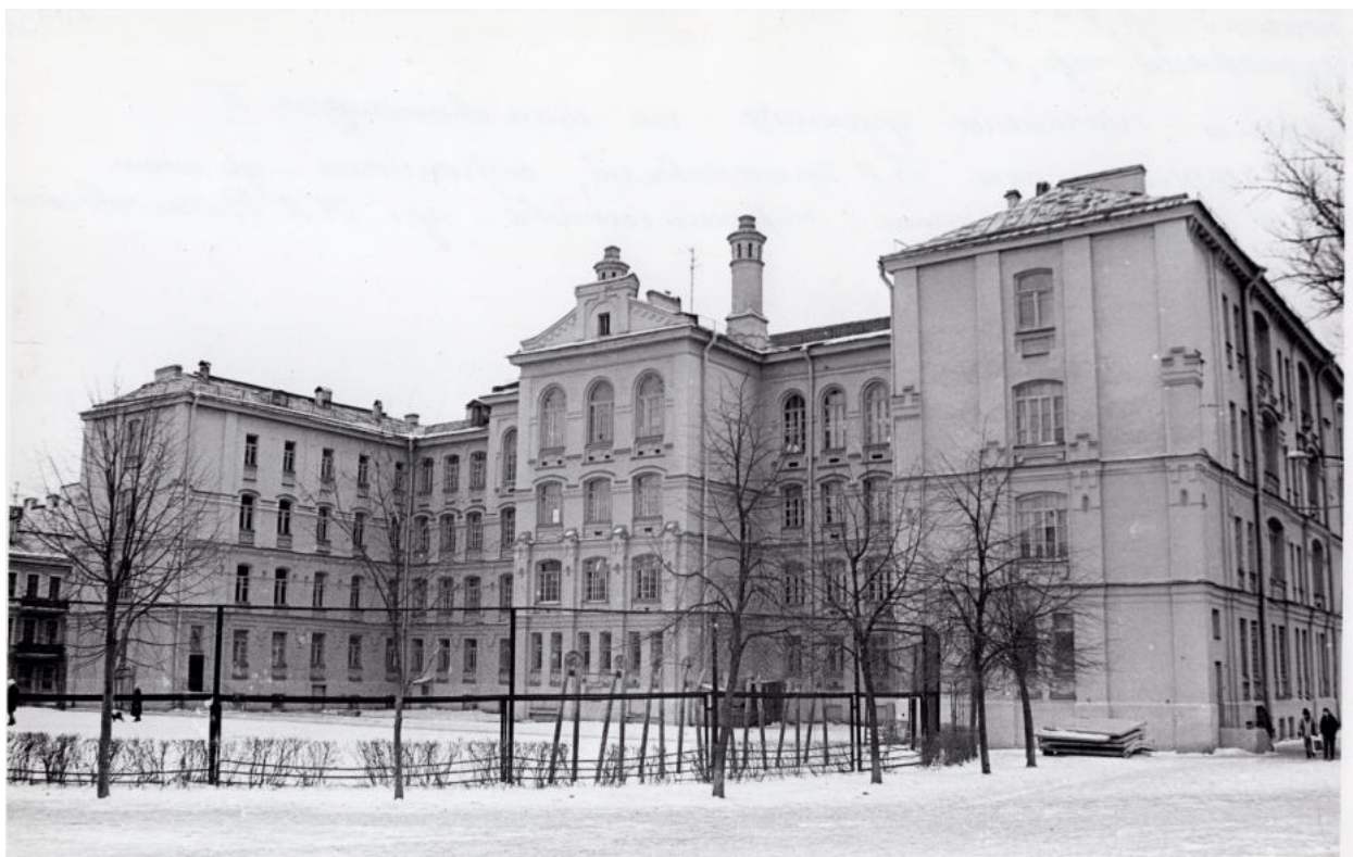
57. Школа № 166. Северо-восточный и северо-западный (торцевой) фасады. 1990 г. Архив КГИОП.
