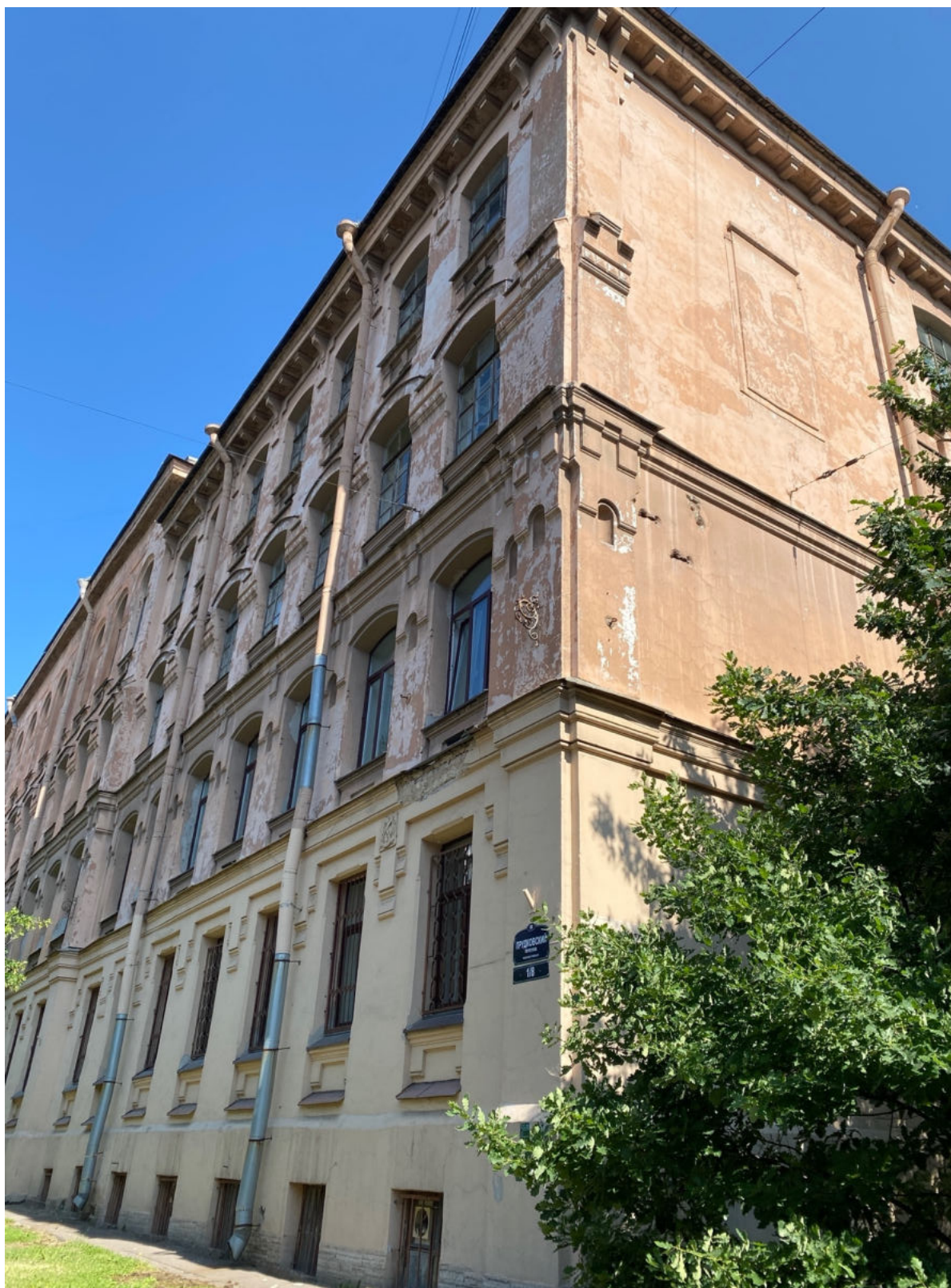
18. Фрагмент южного и восточного фасадов объекта культурного наследия
