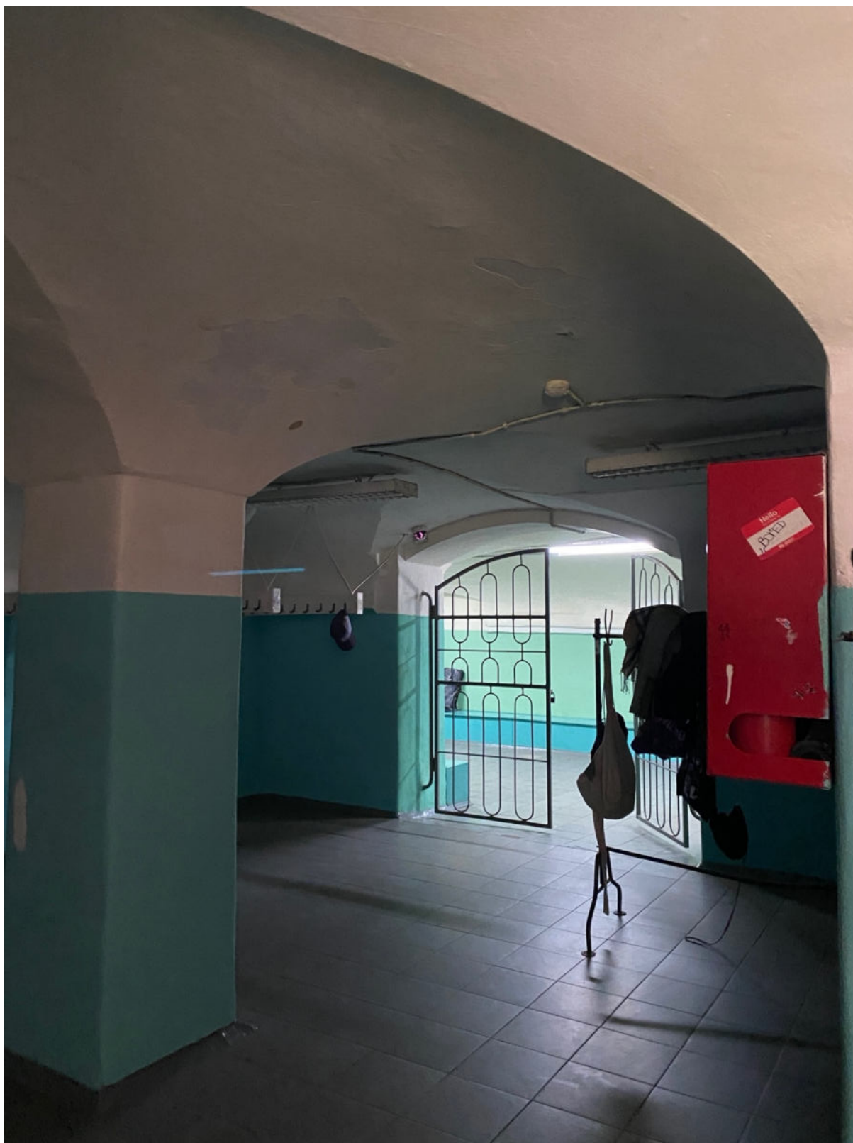
38. Помещение цокольного этажа объекта культурного наследия
