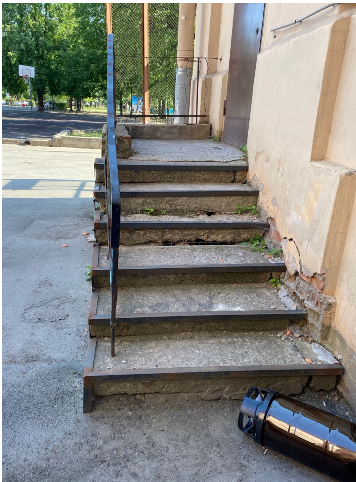
14. Фрагмент северного фасада объекта культурного наследия
