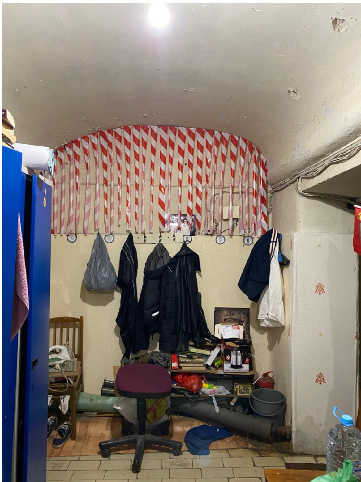
30. Помещение цокольного этажа объекта культурного наследия
