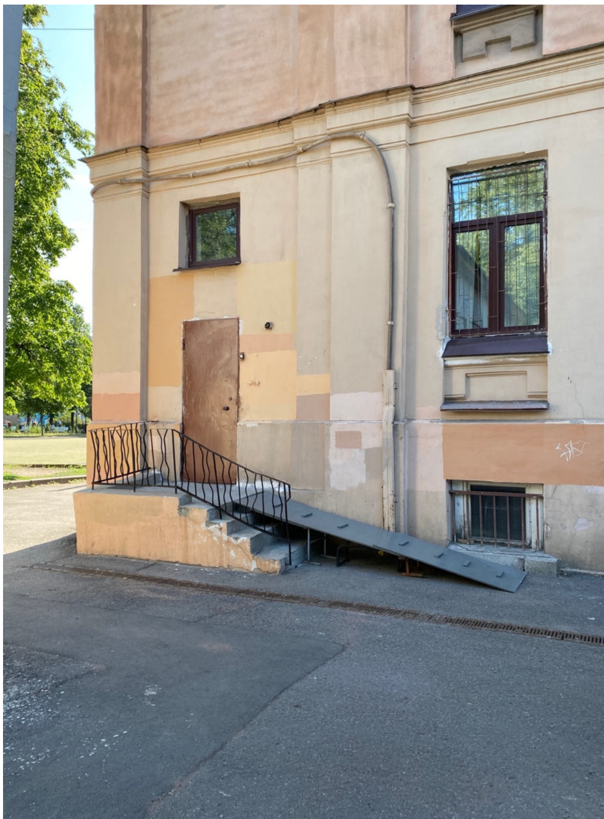
3. Фрагмент западного фасада объекта культурного наследия
