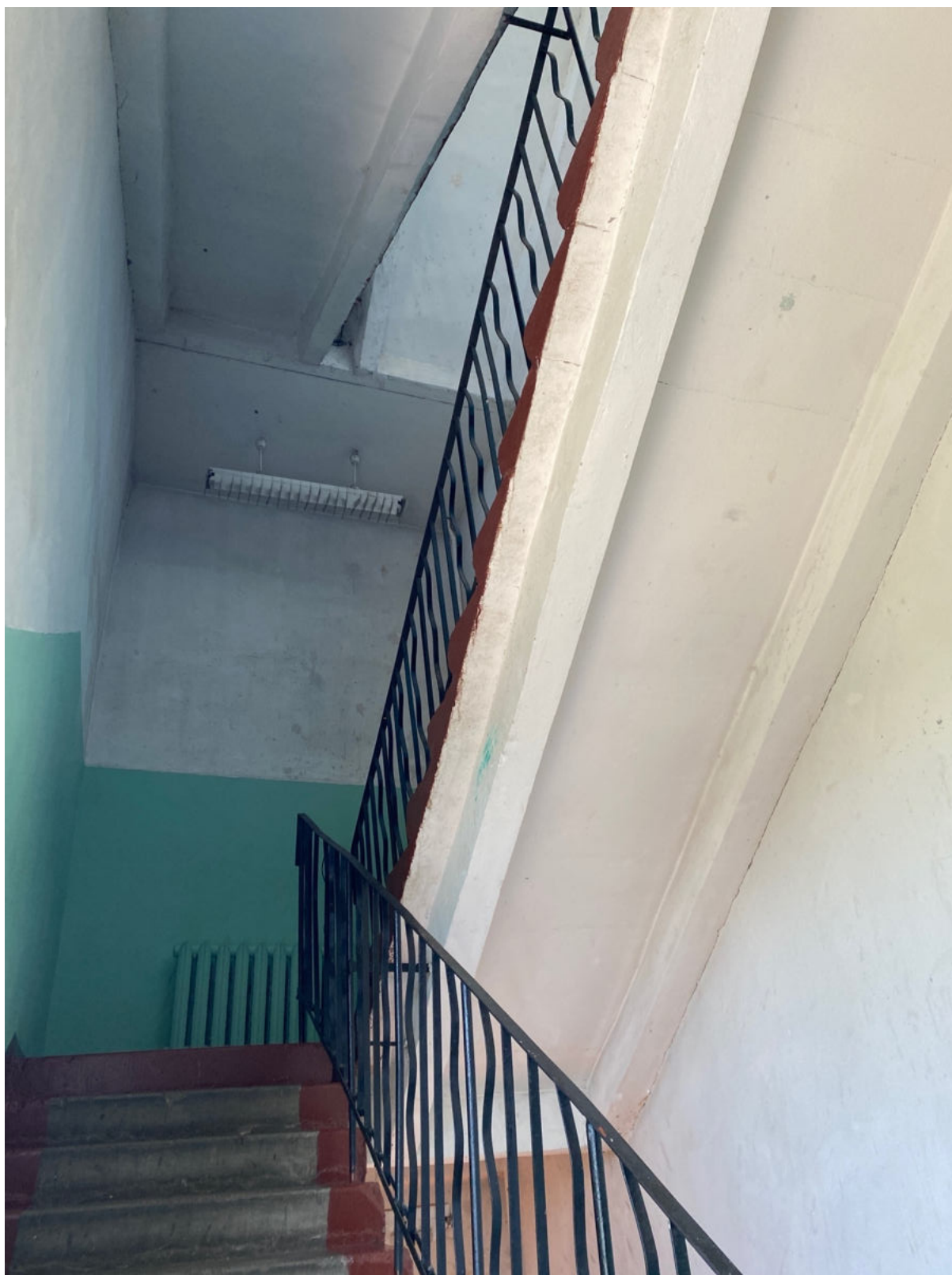
73. Восточная лестница объекта культурного наследия в уровне 3-го этажа
