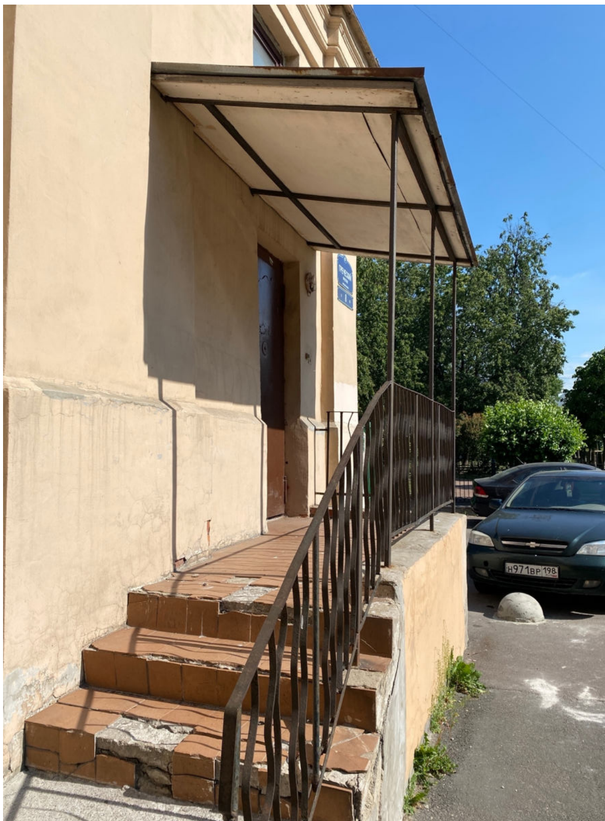
17. Фрагмент восточного фасада объекта культурного наследия
