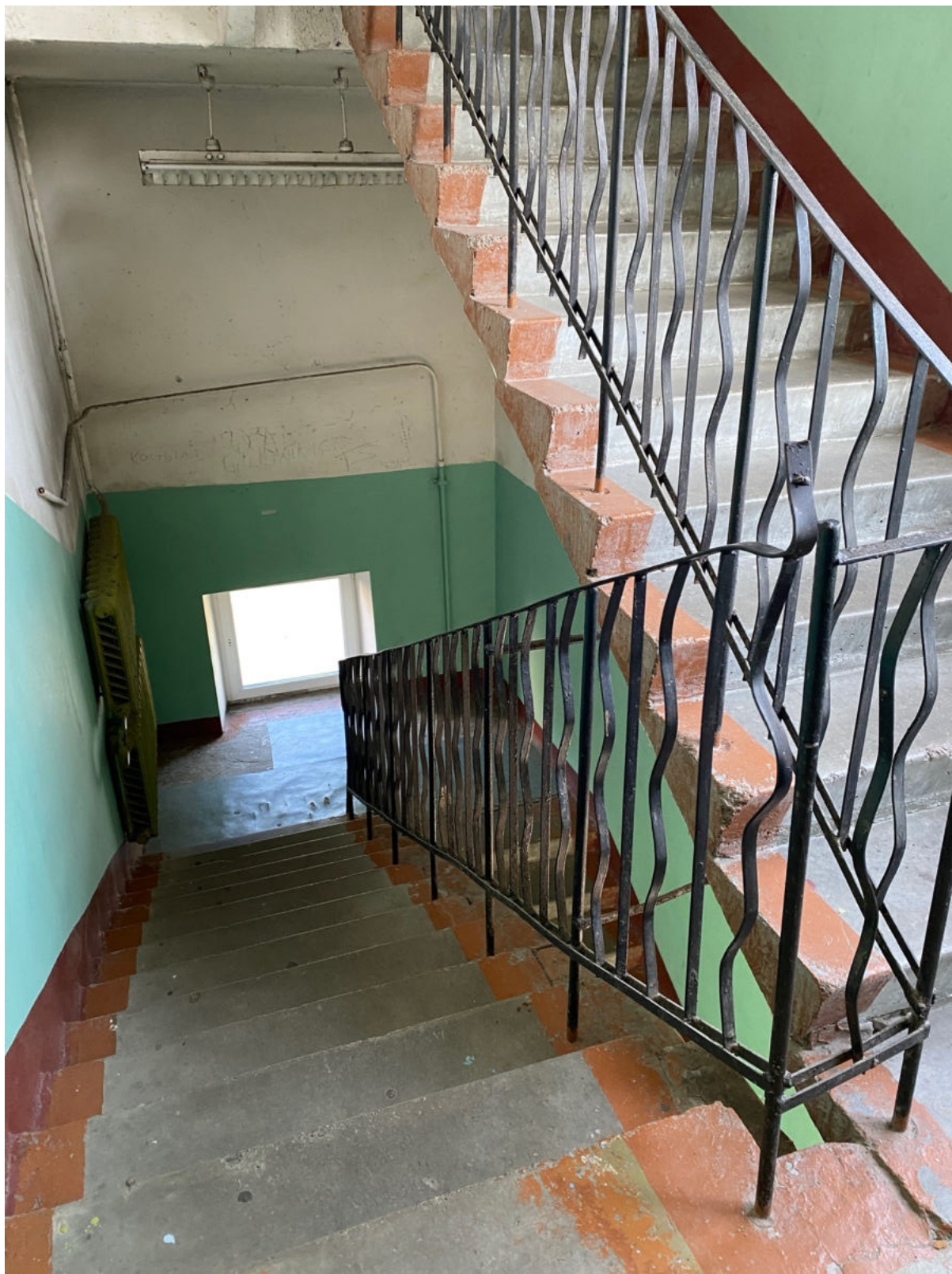
105. Западная лестница объекта культурного наследия в уровне 2-го этажа
