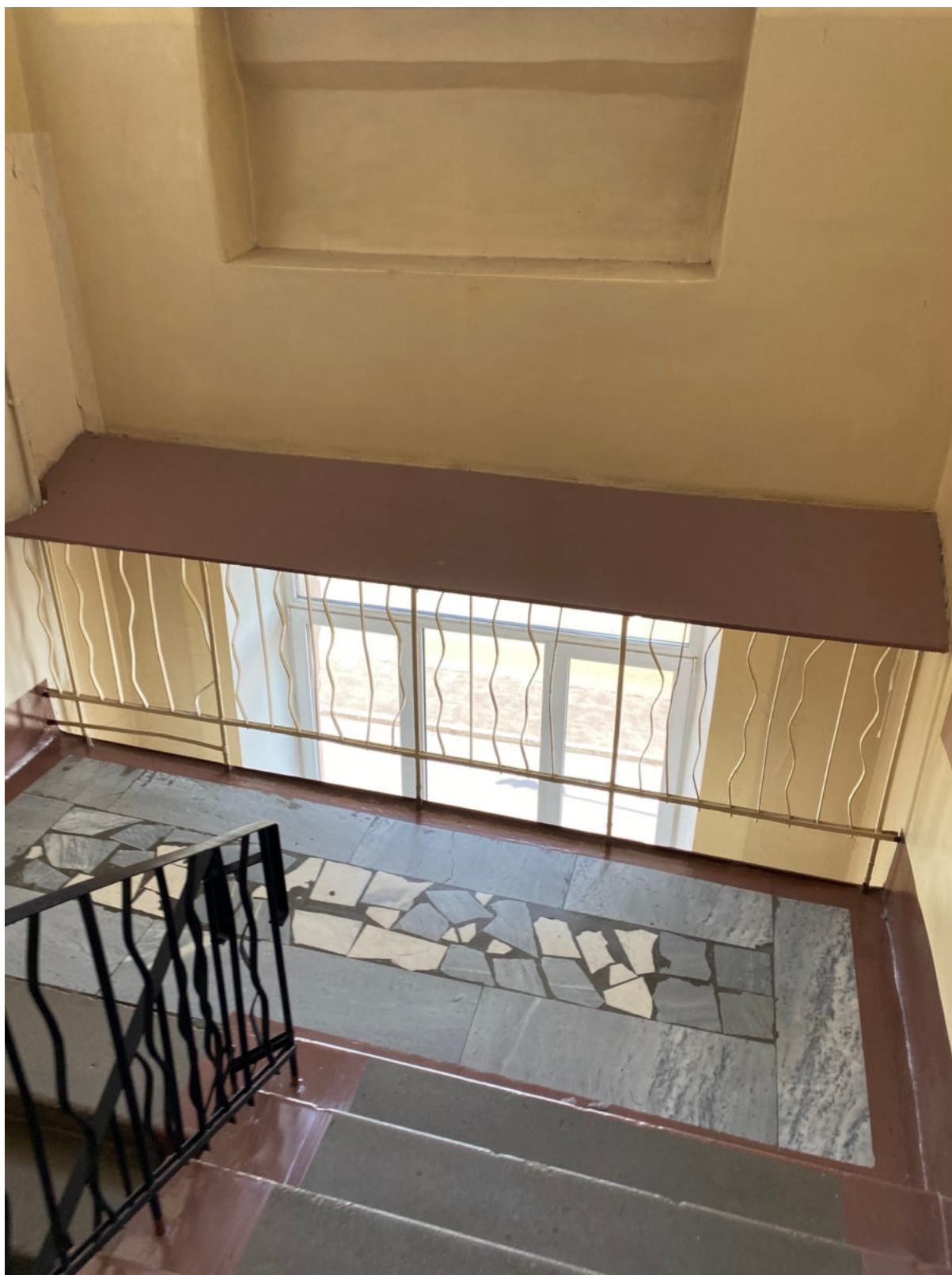
85. Центральная лестница объекта культурного наследия в уровне 3-го этажа
