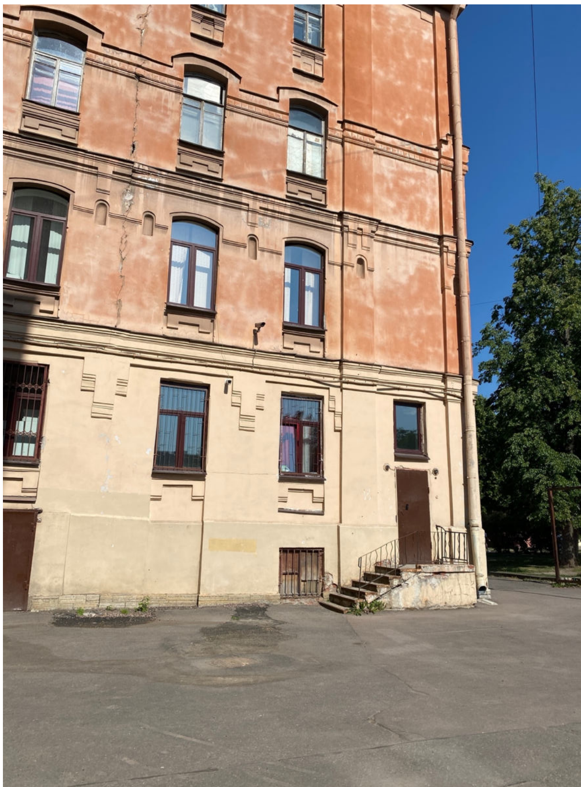
9. Фрагмент северного фасада объекта культурного наследия
