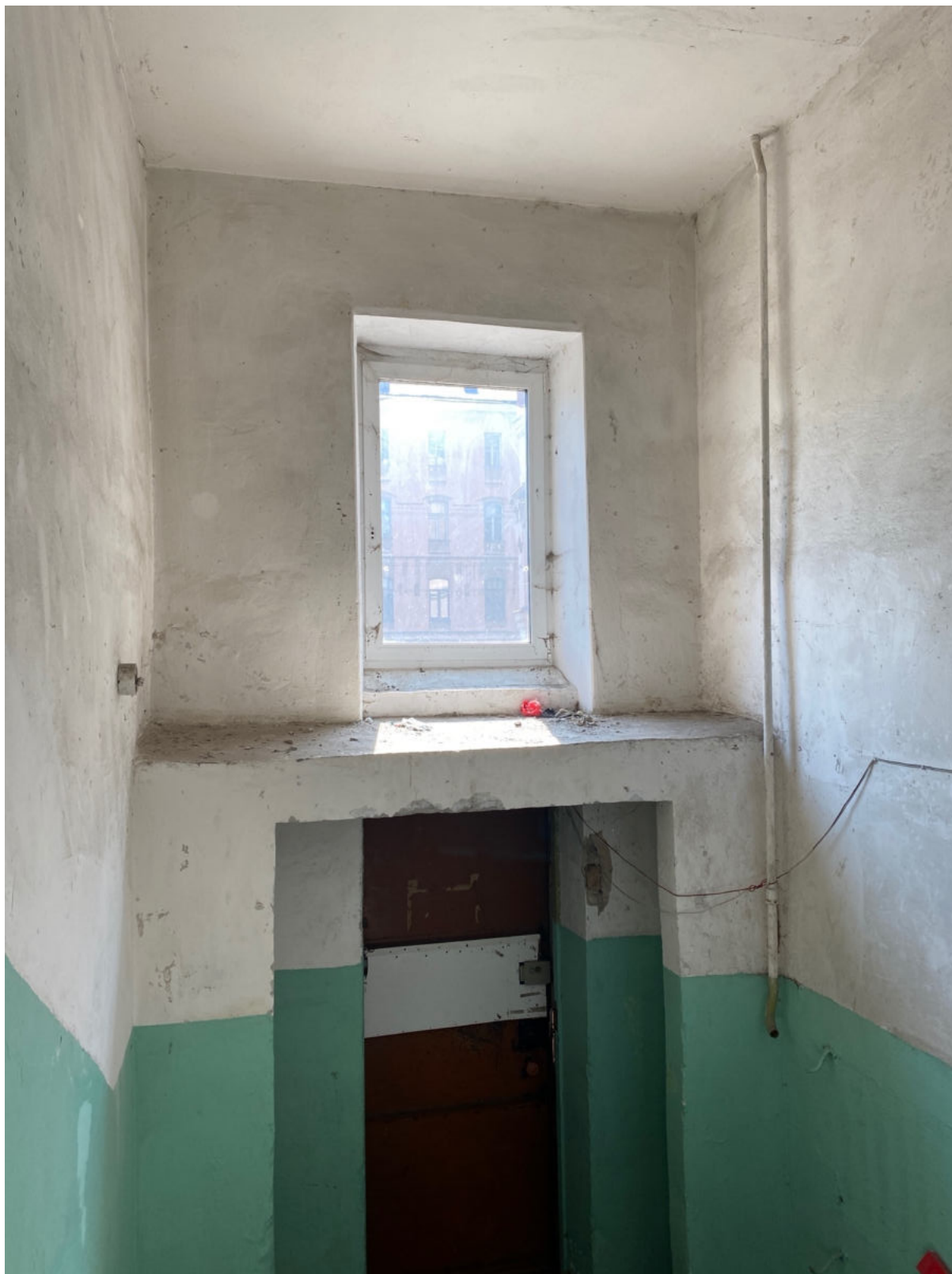
108. Западная лестница объекта культурного наследия в уровне 1-го этажа
