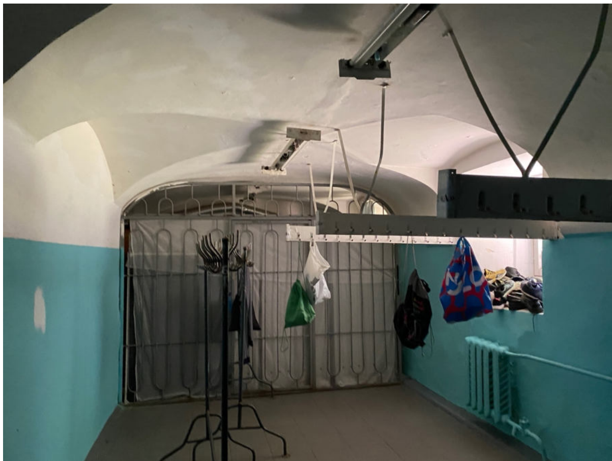
39. Помещение цокольного этажа объекта культурного наследия
