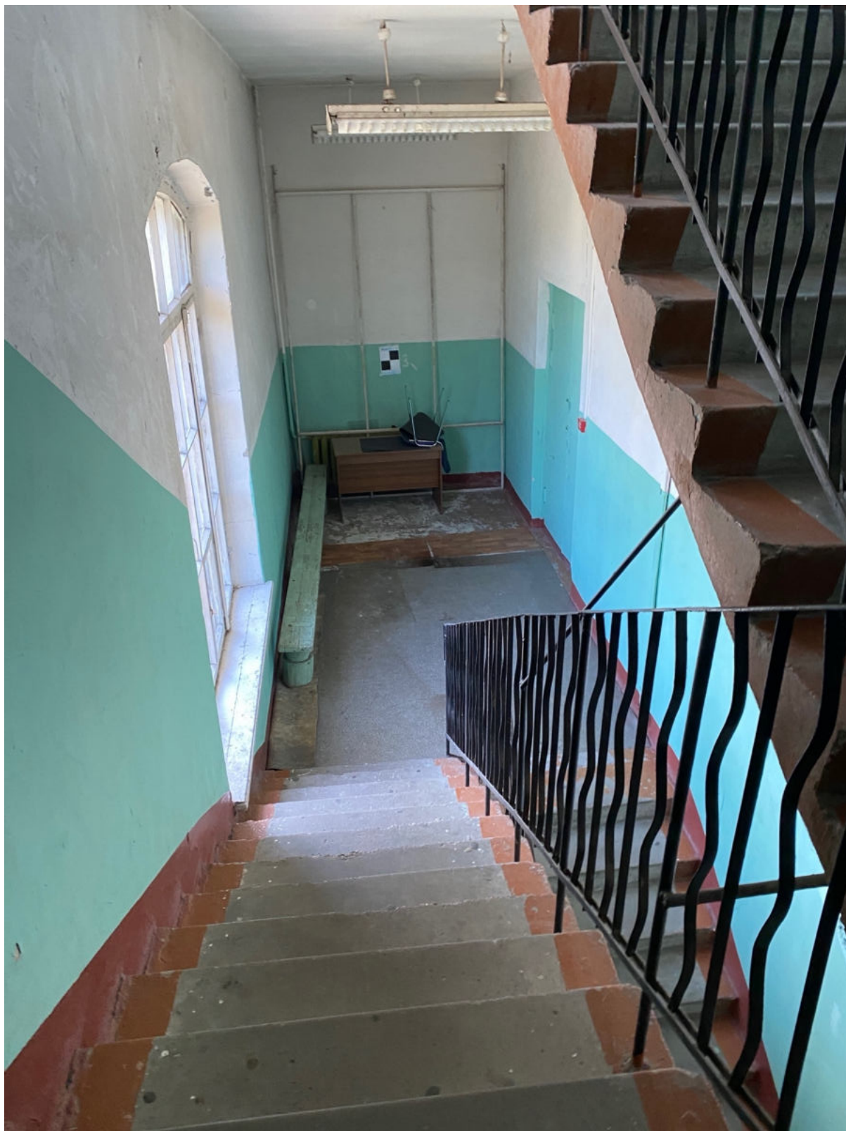
102. Западная лестница объекта культурного наследия в уровне 3-го этажа
