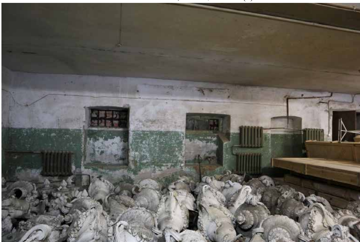
Фото 1.24. 1 этаж, помещение 1Н (1).
