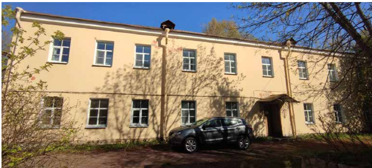
Фото 1. Западный фасад здания, фрагмент.
