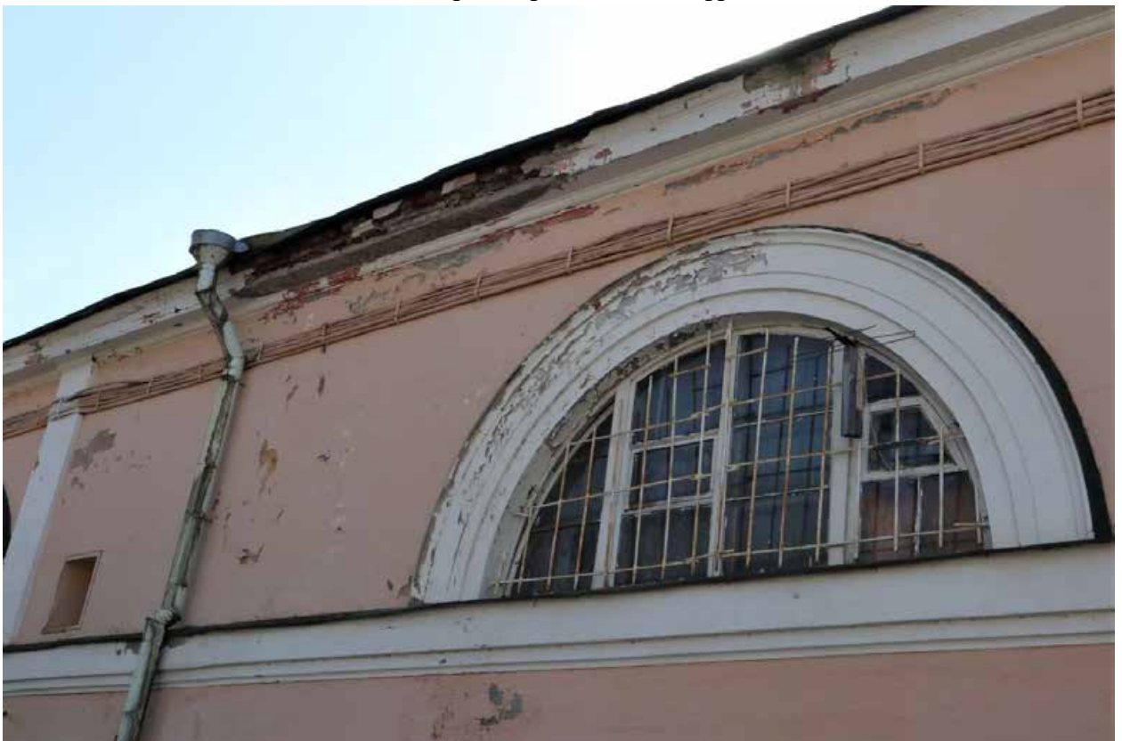
Фото 10. Северный фасад здания, фрагмент.
