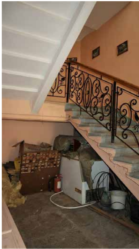
Фото 1.15. 1 этаж, лестница, помещение 2Н (1).
