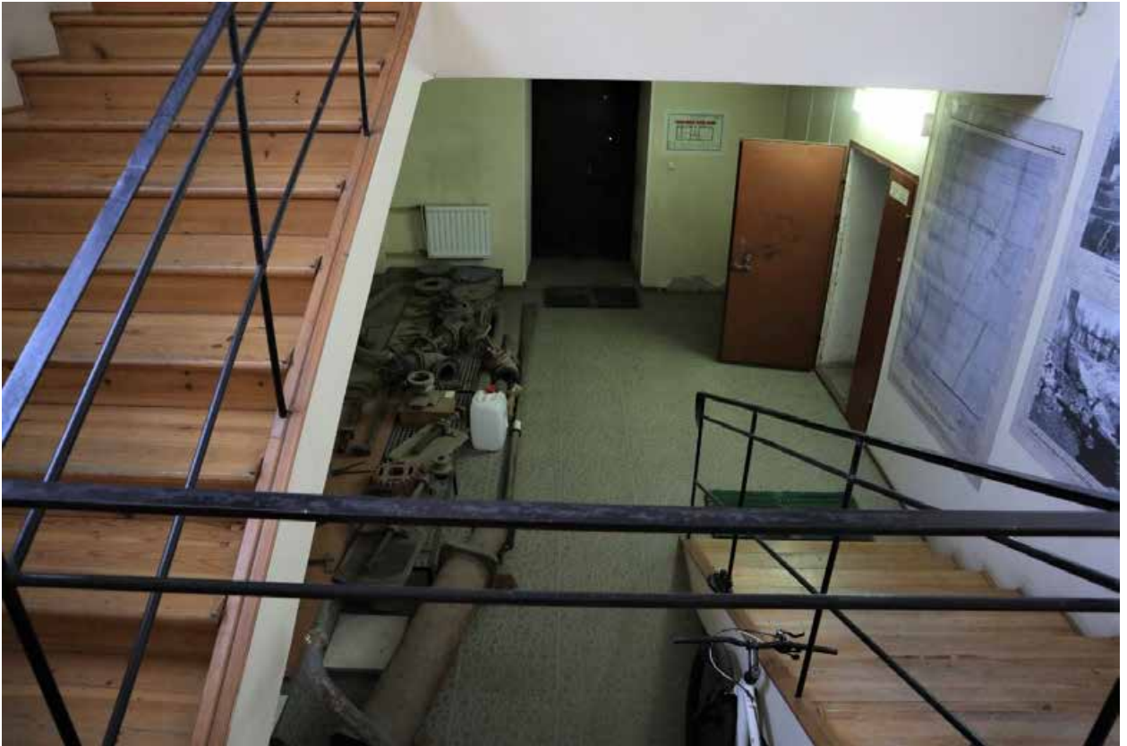
Фото 1.15. 1 этаж, лестница в западной части здания, помещение 1Н (1).
