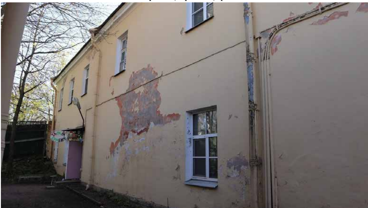
Фото 10. Восточный фасад здания, фрагмент.
