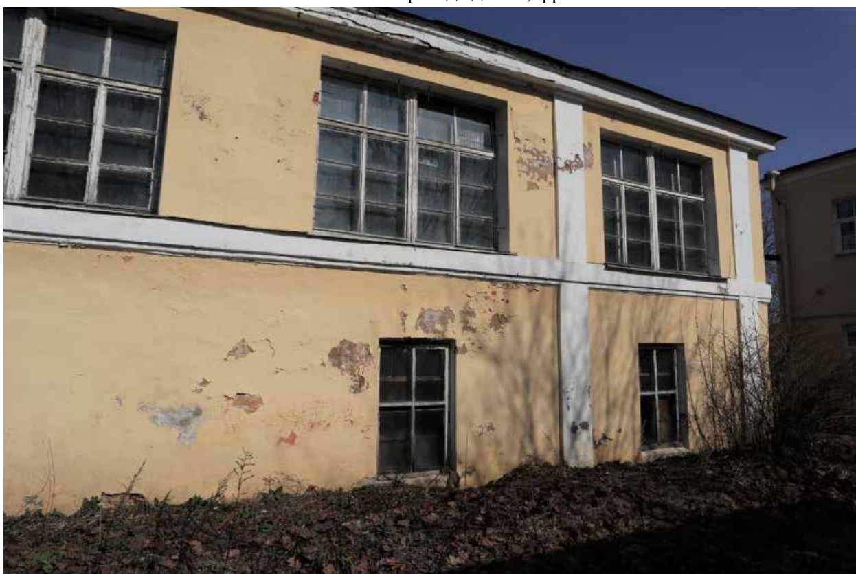
Фото 24. Южный фасад здания, фрагмент.
