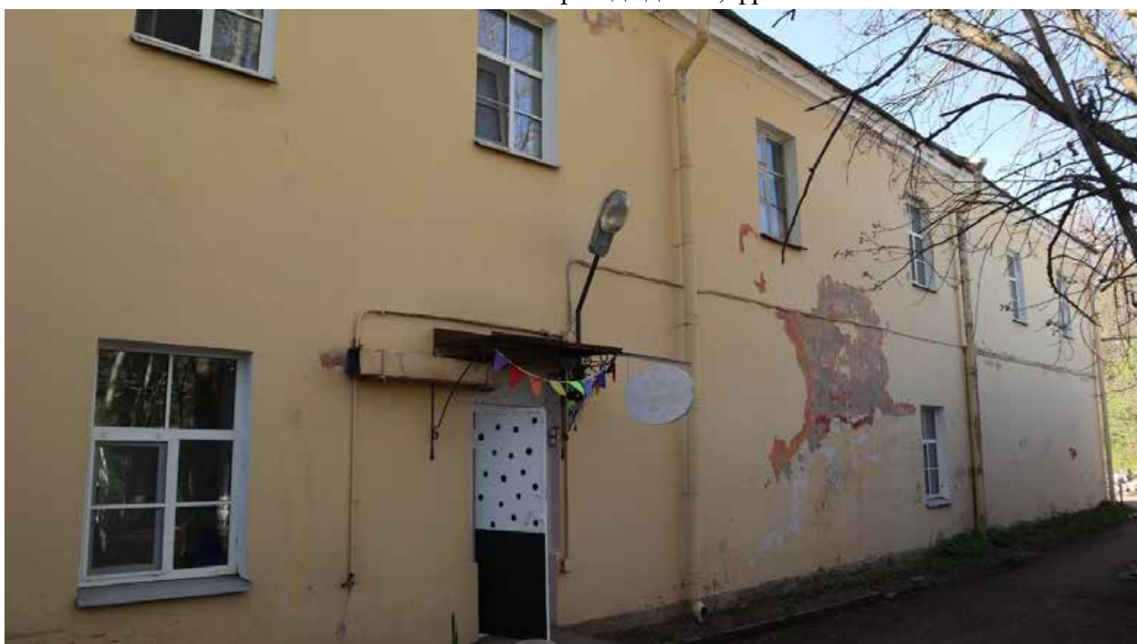
Фото 12. Восточный фасад здания, фрагмент.
