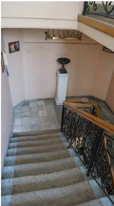
Фото 2.2. 2 этаж, лестница, помещение 2Н (3).
