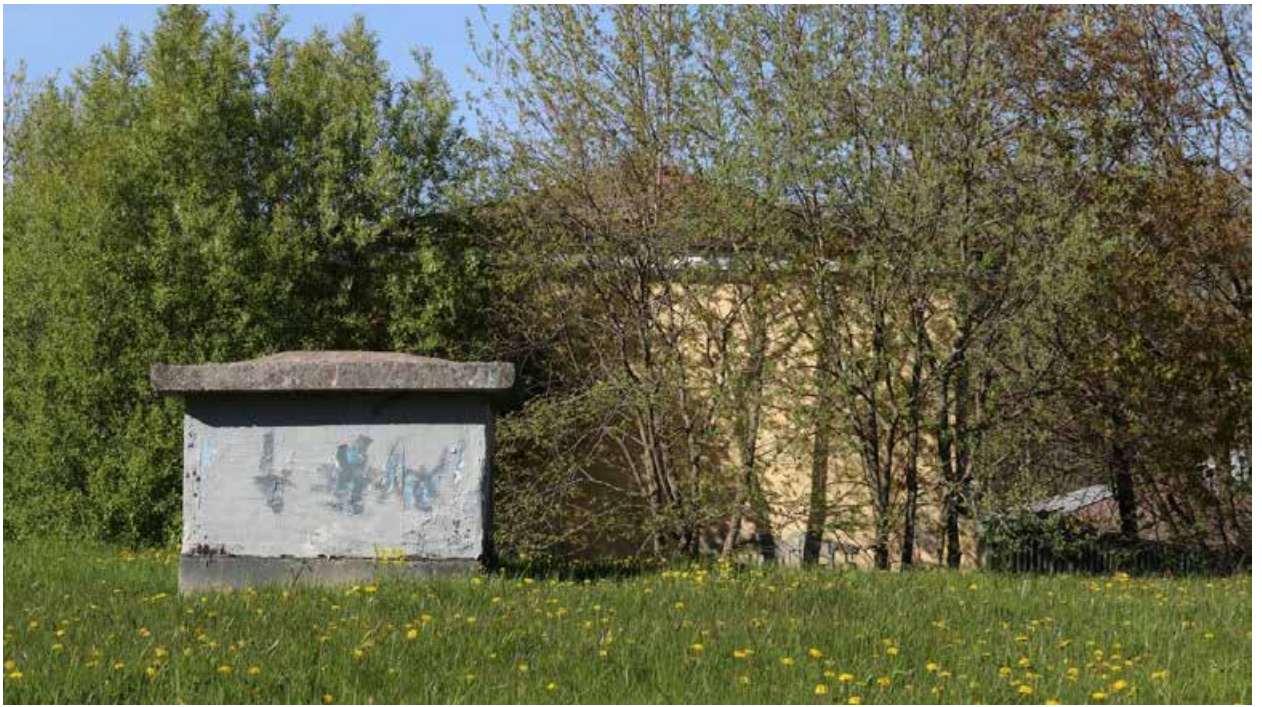
Фото 15. Южный (торцевой) фасад здания.
