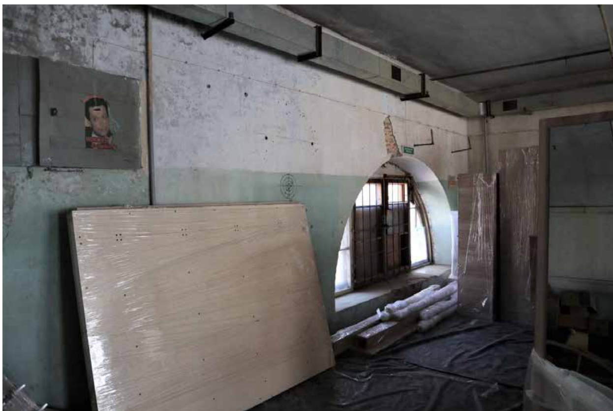
Фото 2.25. 2 этаж, помещение 1Н (12).
