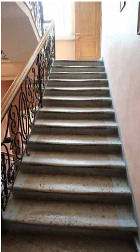
Фото 2.1. 2 этаж, лестница, помещение 2Н (3).
