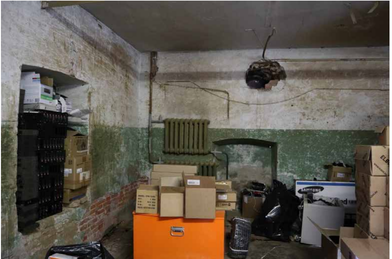
Фото 1.17. 1 этаж, помещение 1Н (1).
