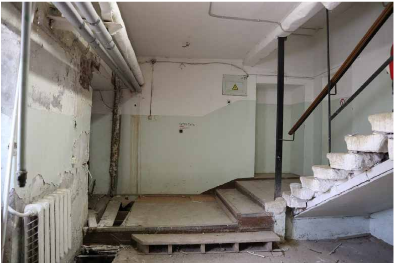
Фото 1.35. 1 этаж, лестница в центральной части здания, помещение 1Н (4).
