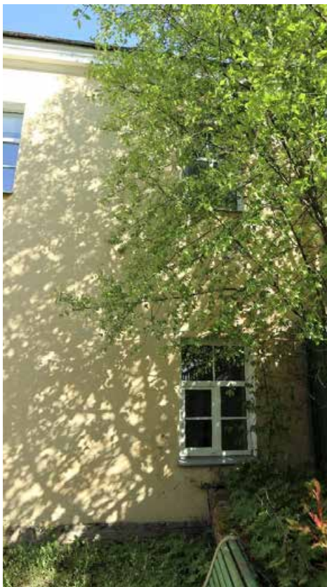
Фото 5. Западный фасад здания, фрагмент.
