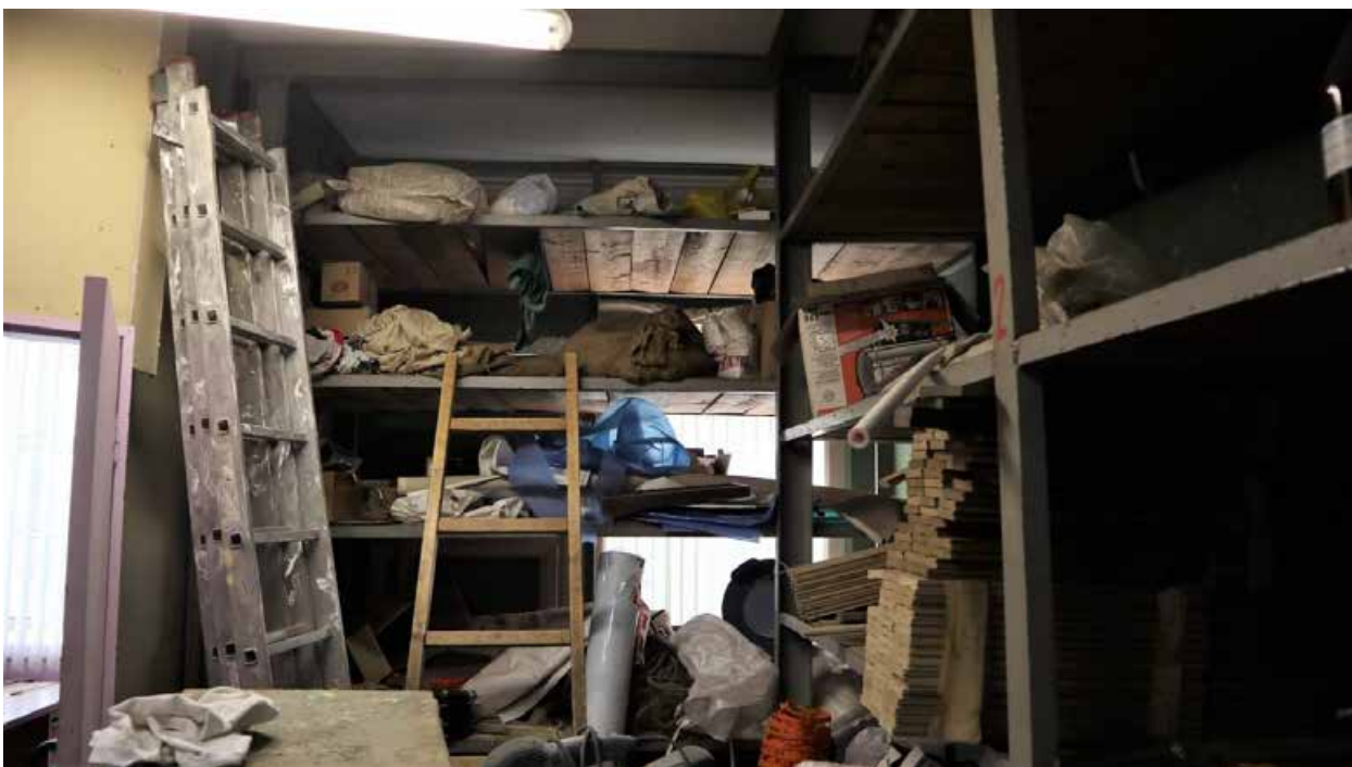
Фото 1.21. 1 этаж, помещение 2Н (2).
