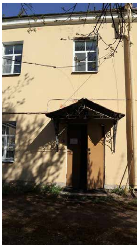
Фото 2. Западный фасад здания, фрагмент.
