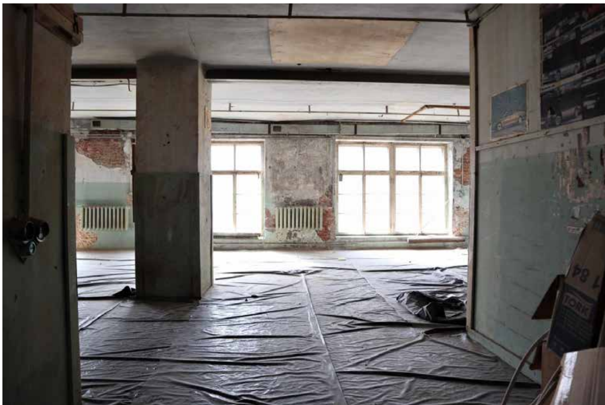
Фото 2.27. 2 этаж, помещение 1Н (12).
