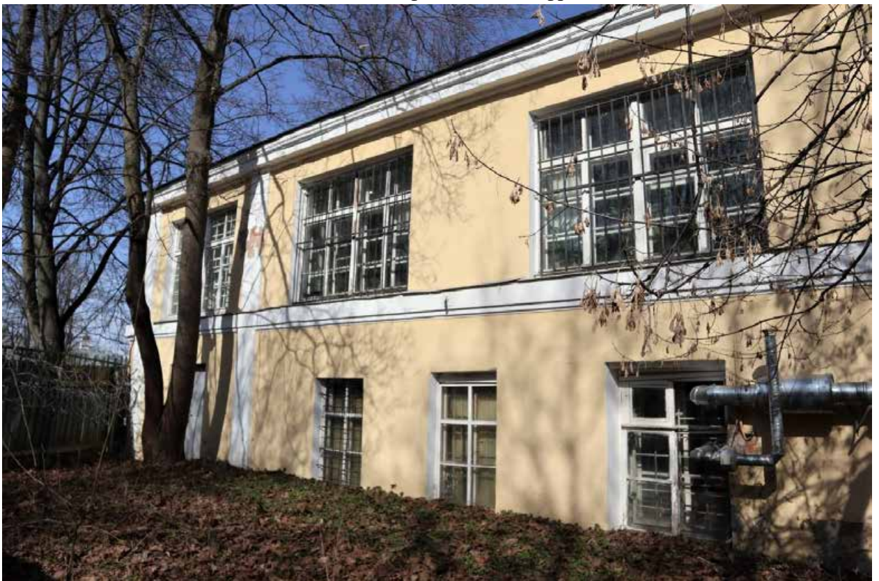
Фото 22. Южный фасад здания, фрагмент.
