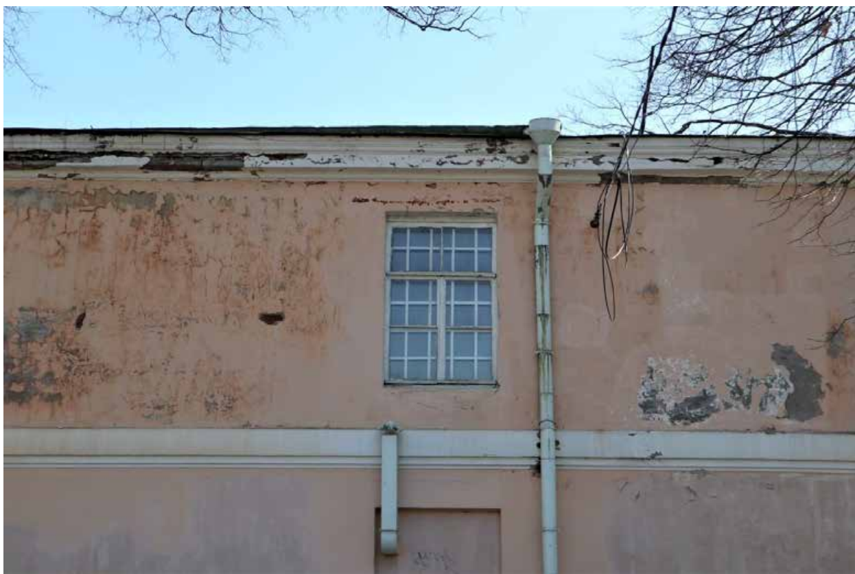
Фото 13. Западный (торцевой) фасад здания, оконный проем второго этажа.
