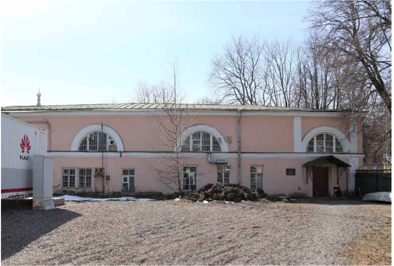
Фото 1. Северный фасад здания, фрагмент.
