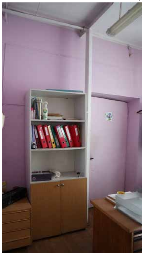
Фото 1.20. 1 этаж, помещение 2Н (2).
