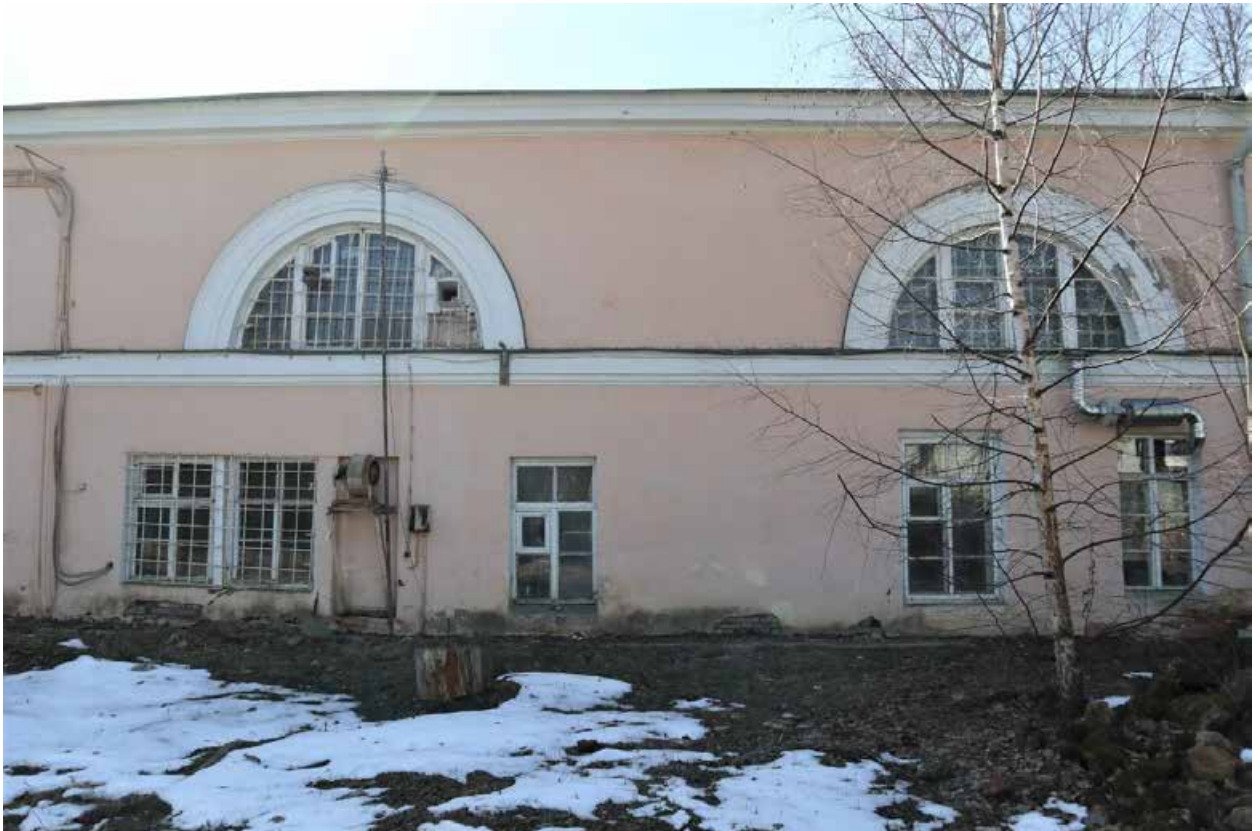
Фото 4. Северный фасад здания, фрагмент.
