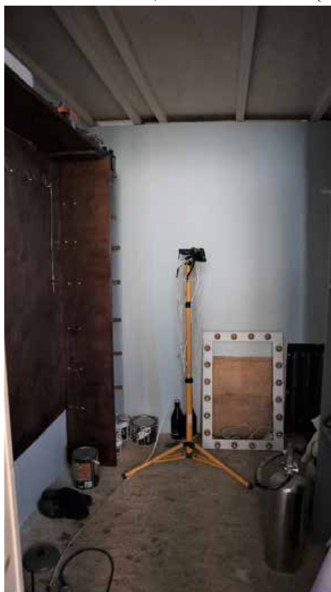
Фото 1.4. 1 этаж, помещение 3Н (2).
