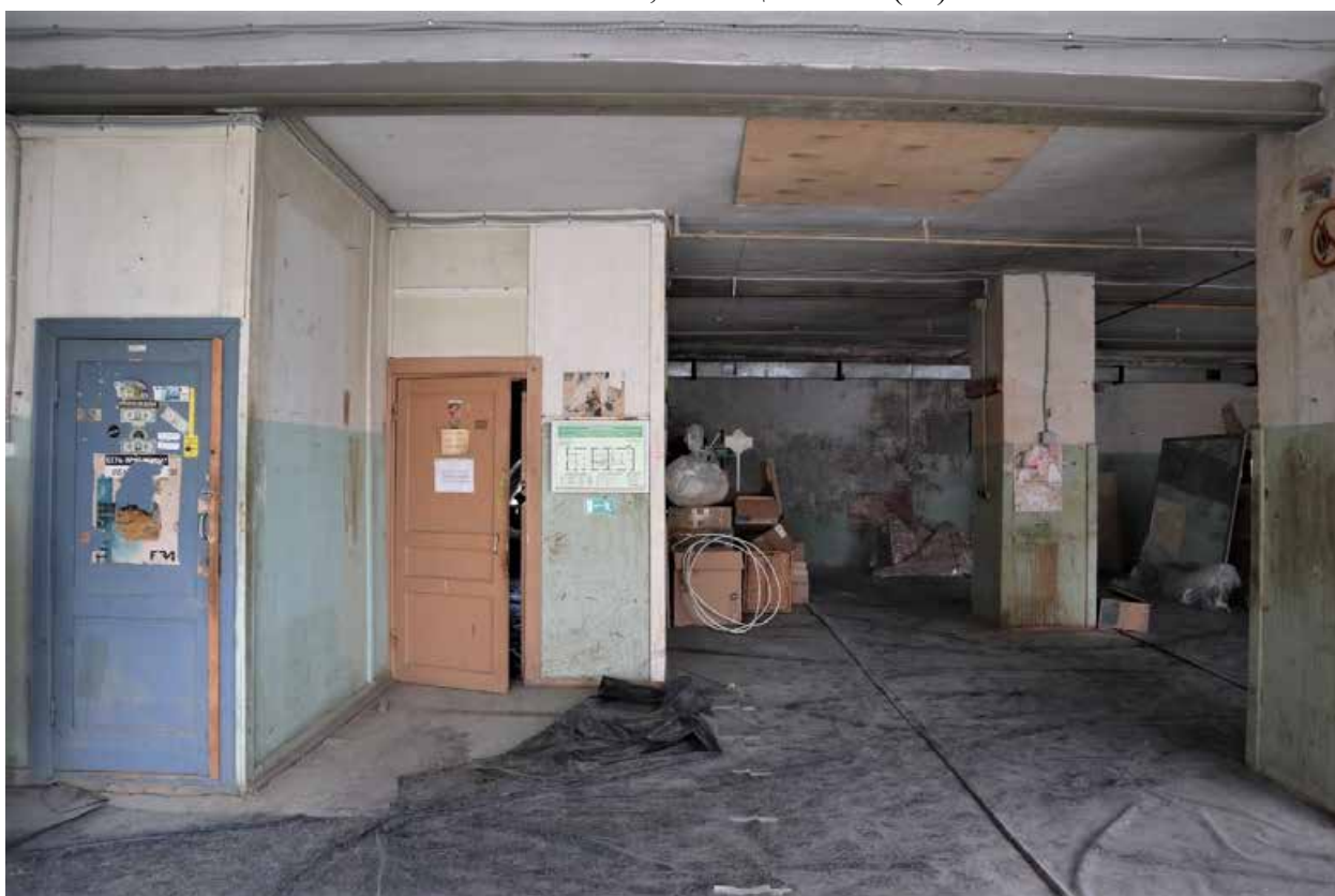
Фото 2.22. 2 этаж, помещение 1Н (12).
