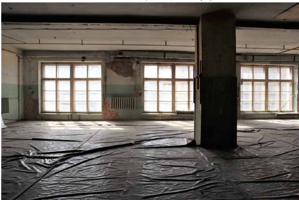
Фото 2.26. 2 этаж, помещение 1Н (12).
