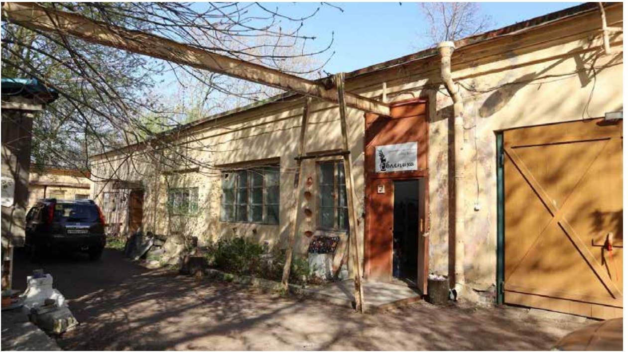
Фото 11. Юго-западная и западная части фасада.
