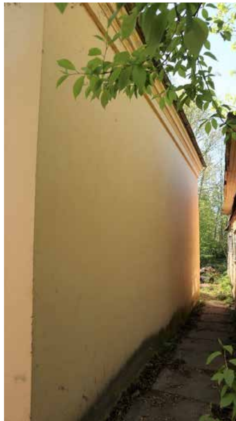
Фото 8. Северный (торцевой) фасад здания.
