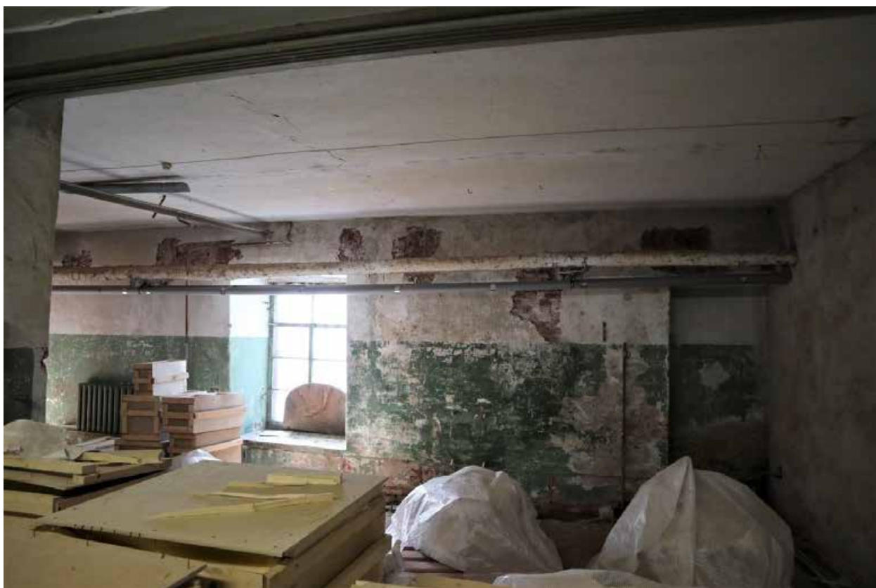
Фото 1.23. 1 этаж, помещение 1Н (1).
