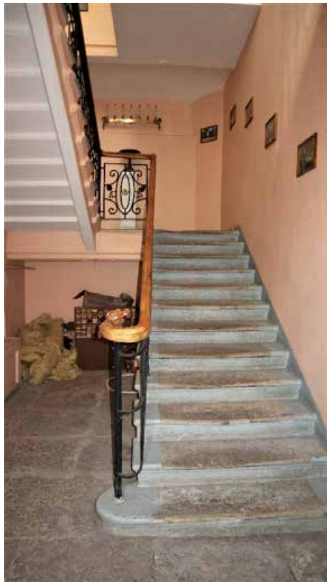
Фото 1.14. 1 этаж, лестница, помещение 2Н (1).
