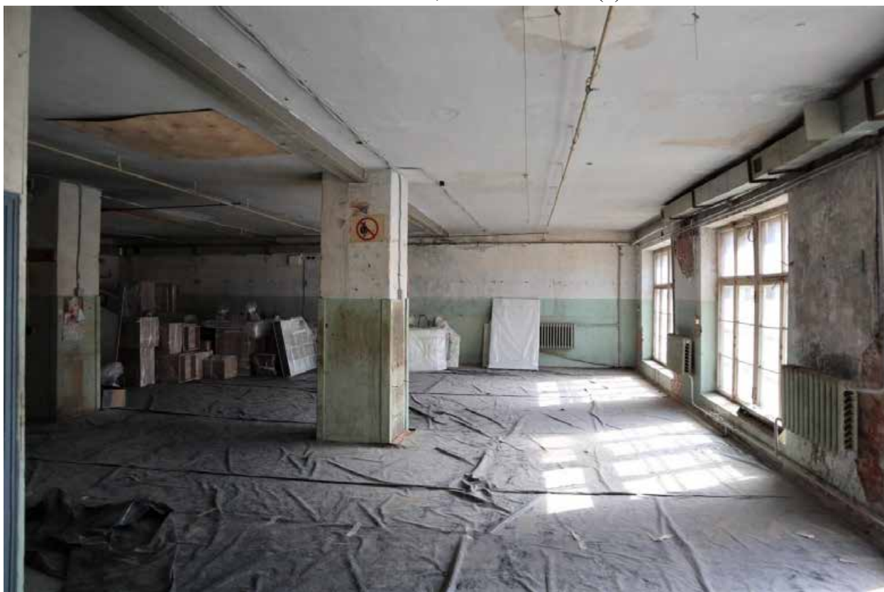
Фото 2.20. 2 этаж, помещение 1Н (12).
