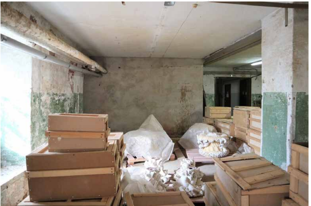
Фото 1.20. 1 этаж, помещение 1Н (1).
