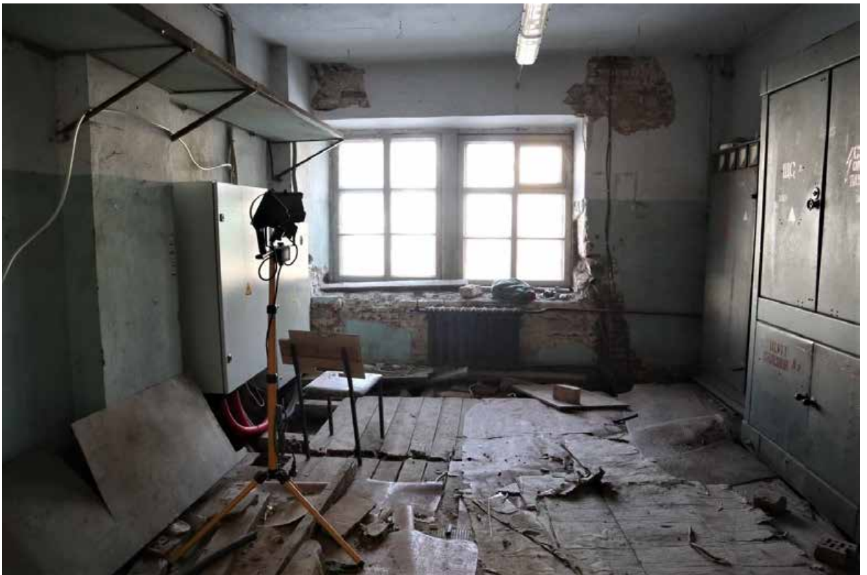
Фото 1.27. 1 этаж, помещение 1Н (3).
