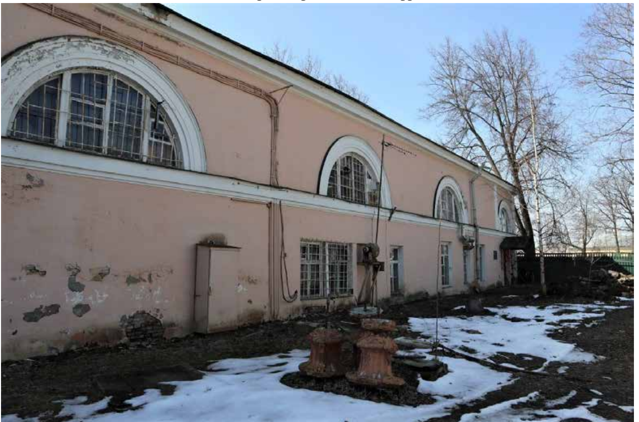
Фото 6. Северный фасад здания, фрагмент.
