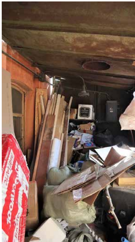
Фото 1.18. 1 этаж, помещение 1Н*.
