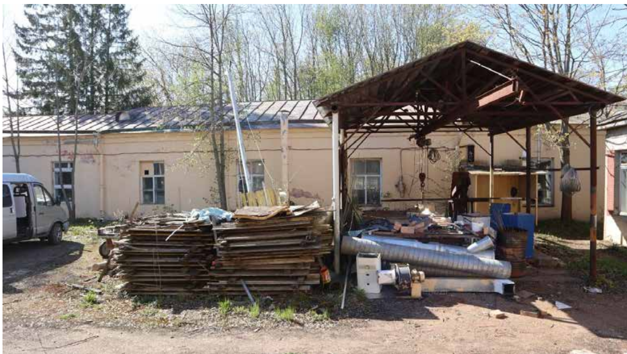
Фото 5. Северо-восточная часть фасада.
