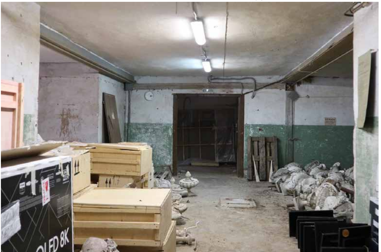
Фото 1.18. 1 этаж, помещение 1Н (1).
