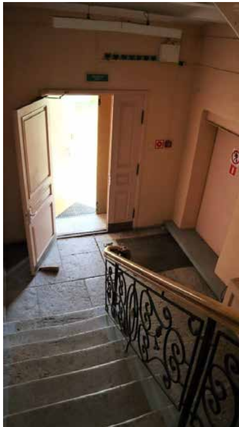
Фото 1.16. 1 этаж, лестница, помещение 2Н (1).
