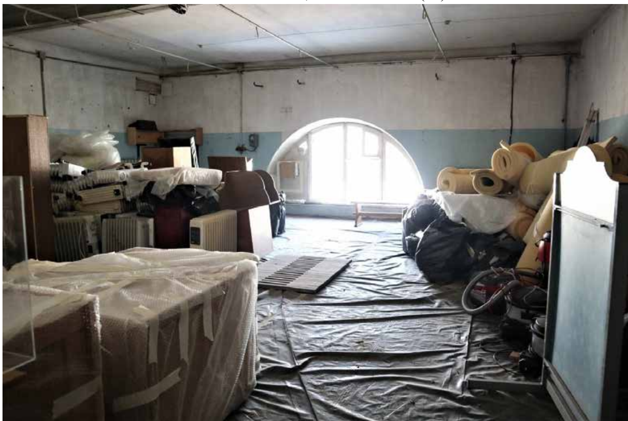
Фото 2.32. 2 этаж, помещение 1Н (9).
