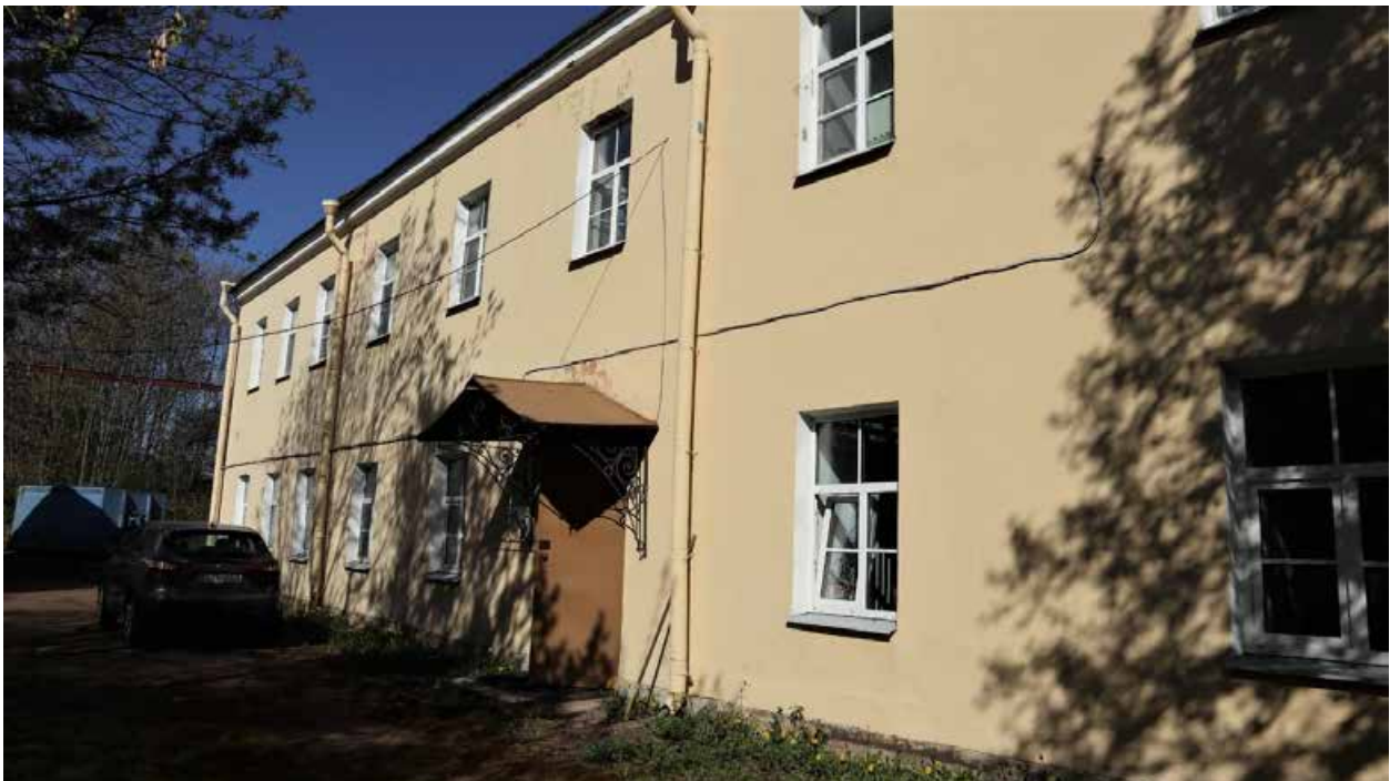
Фото 4. Западный фасад здания, фрагмент.
