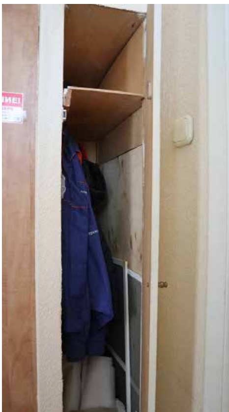
Фото 2.15. 2 этаж, помещение 2Н (11).
