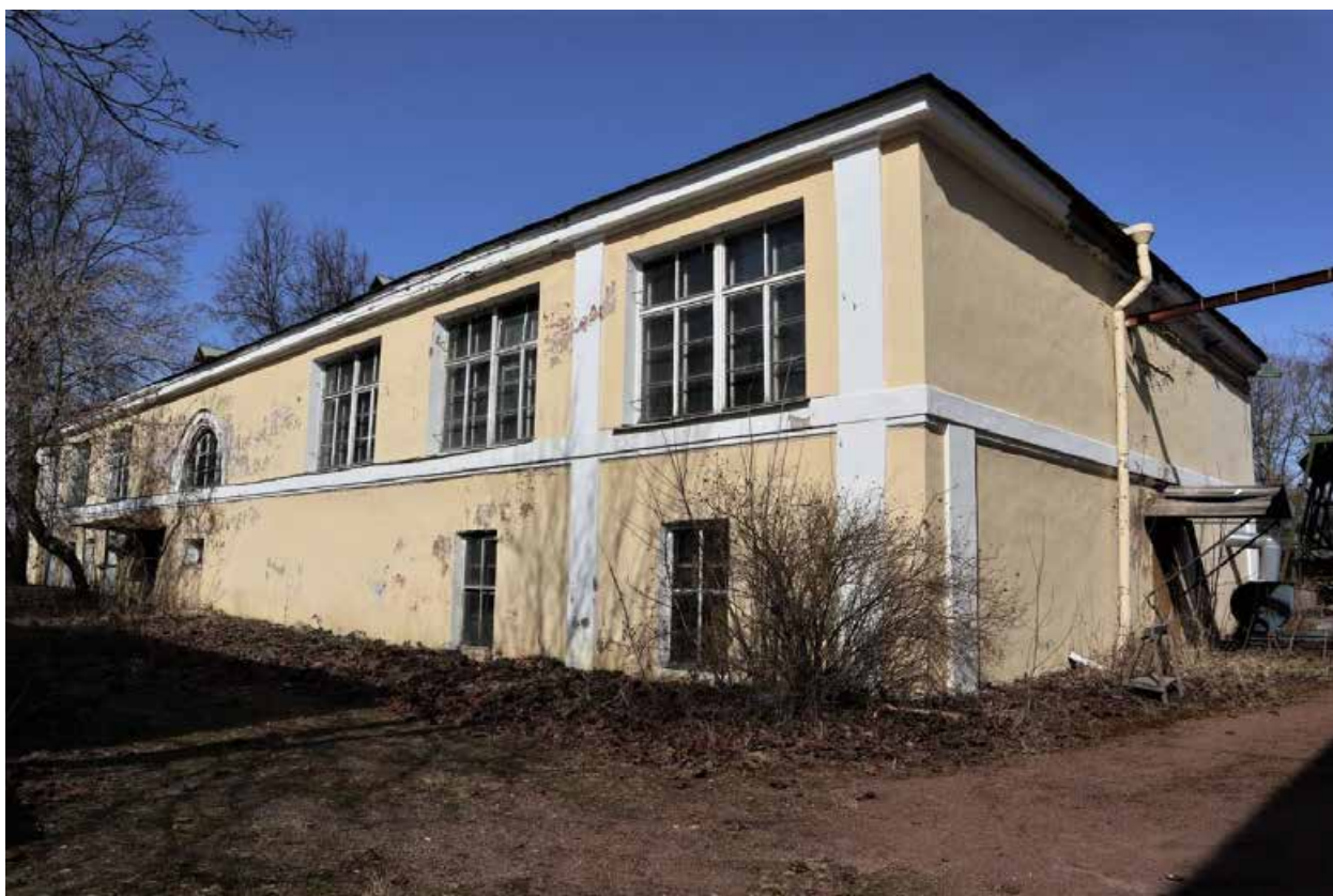
Фото 19. Восточный (торцевой) и южный фасады.
