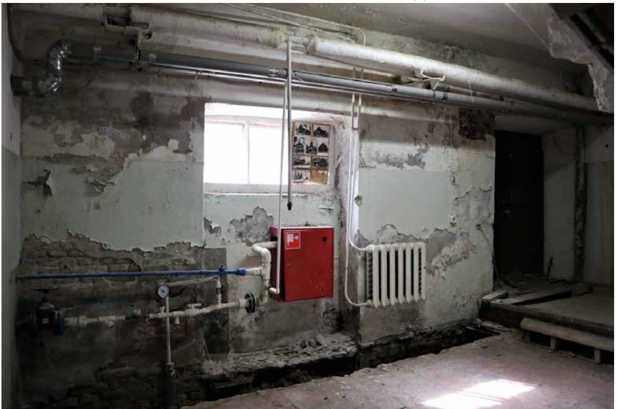
Фото 1.34. 1 этаж, помещение 1Н (4).
