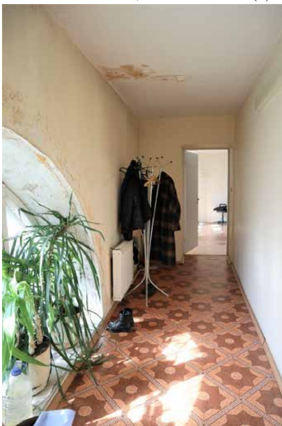
Фото 2.14. 2 этаж, помещение 3Н (9).
