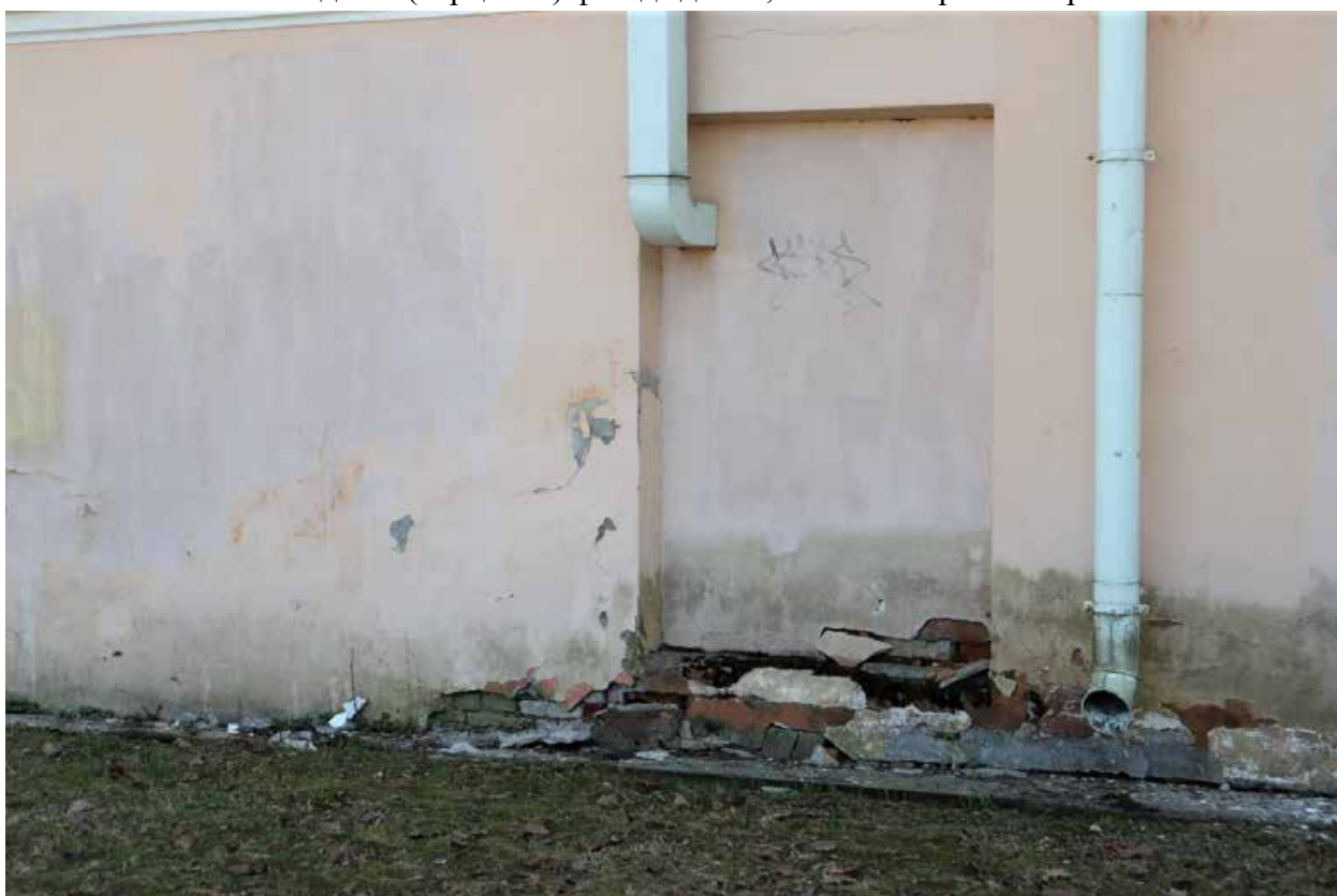
Фото 14. Западный (торцевой) фасад здания, фрагмент.
