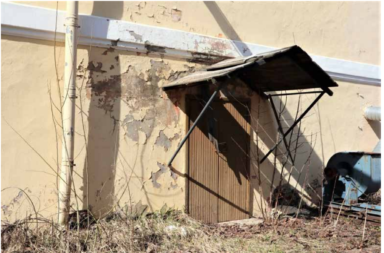
Фото 18. Восточный (торцевой) фасад здания, фрагмент.
