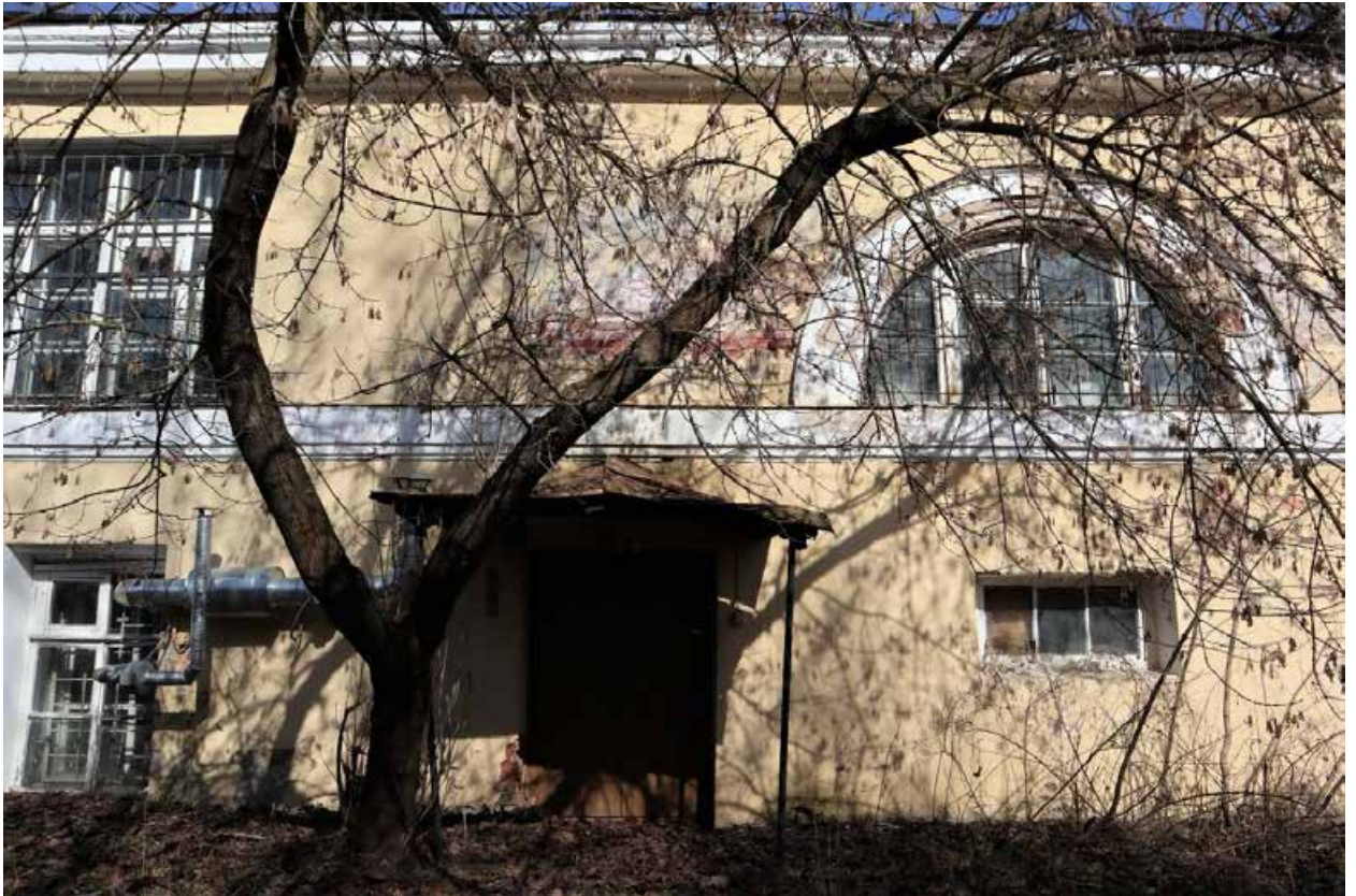
Фото 21. Южный фасад здания, фрагмент.
