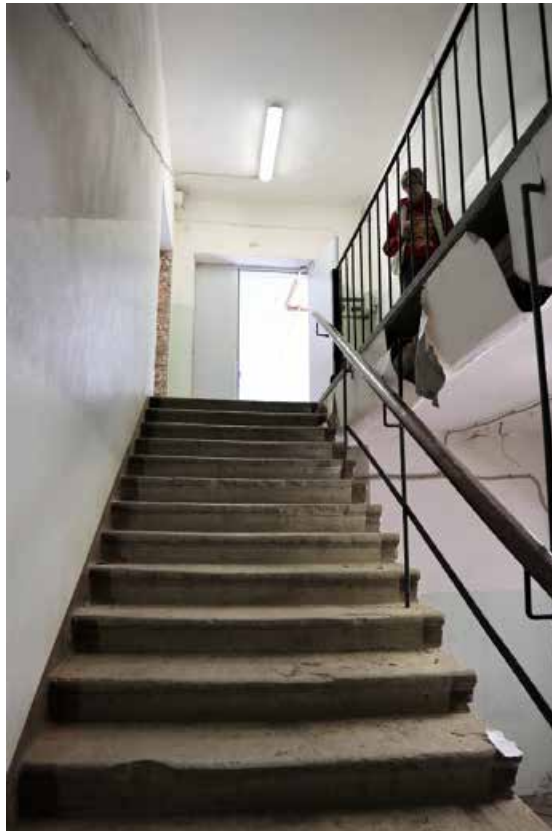
Фото 2.16. 2 этаж, лестница в центральной части здания, помещение 1Н (8).
