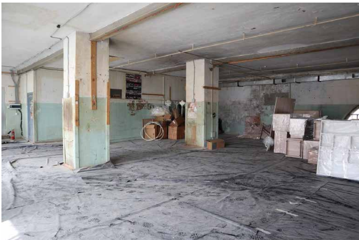
Фото 2.23. 2 этаж, помещение 1Н (12).
