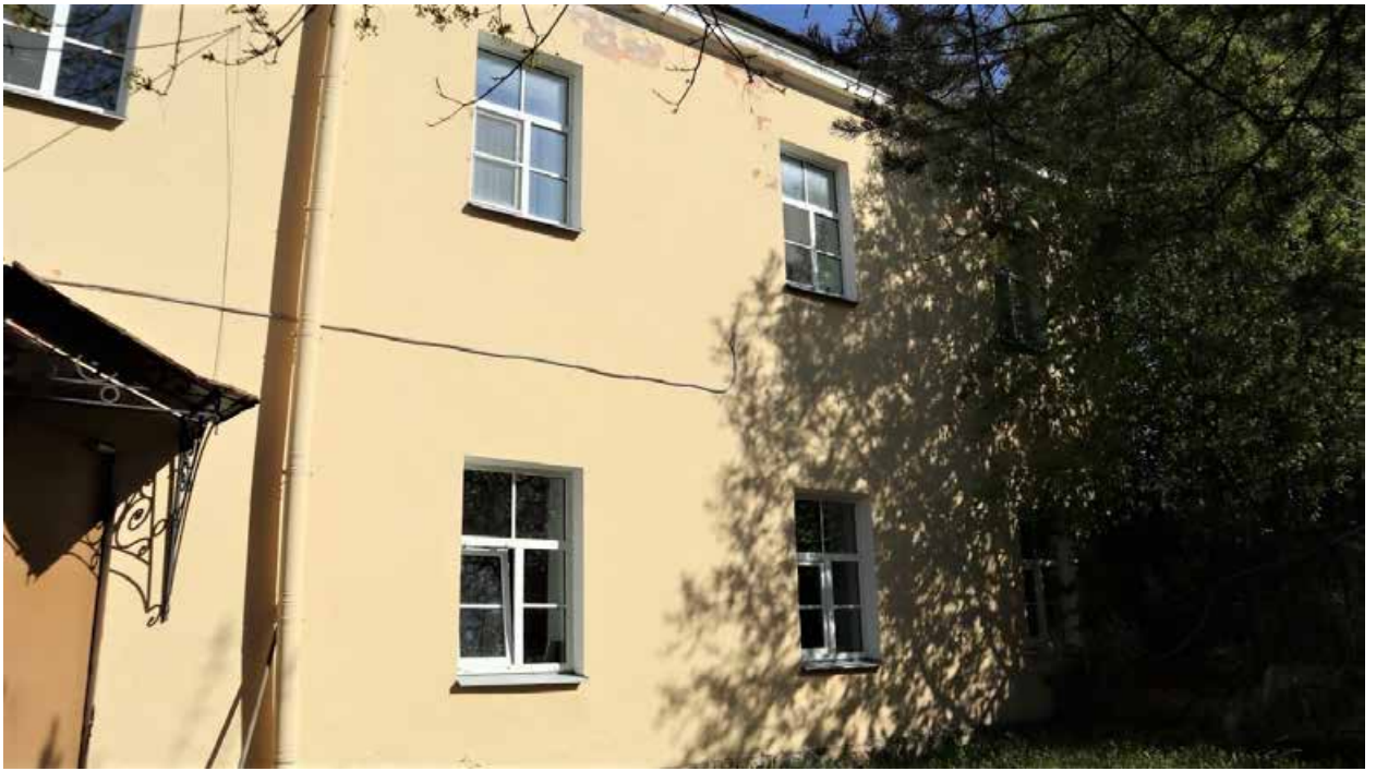
Фото 3. Западный фасад здания, фрагмент
