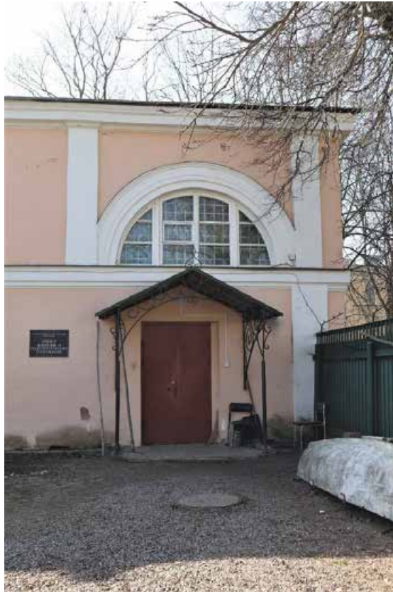
Фото 3. Северный фасад здания, фрагмент.
