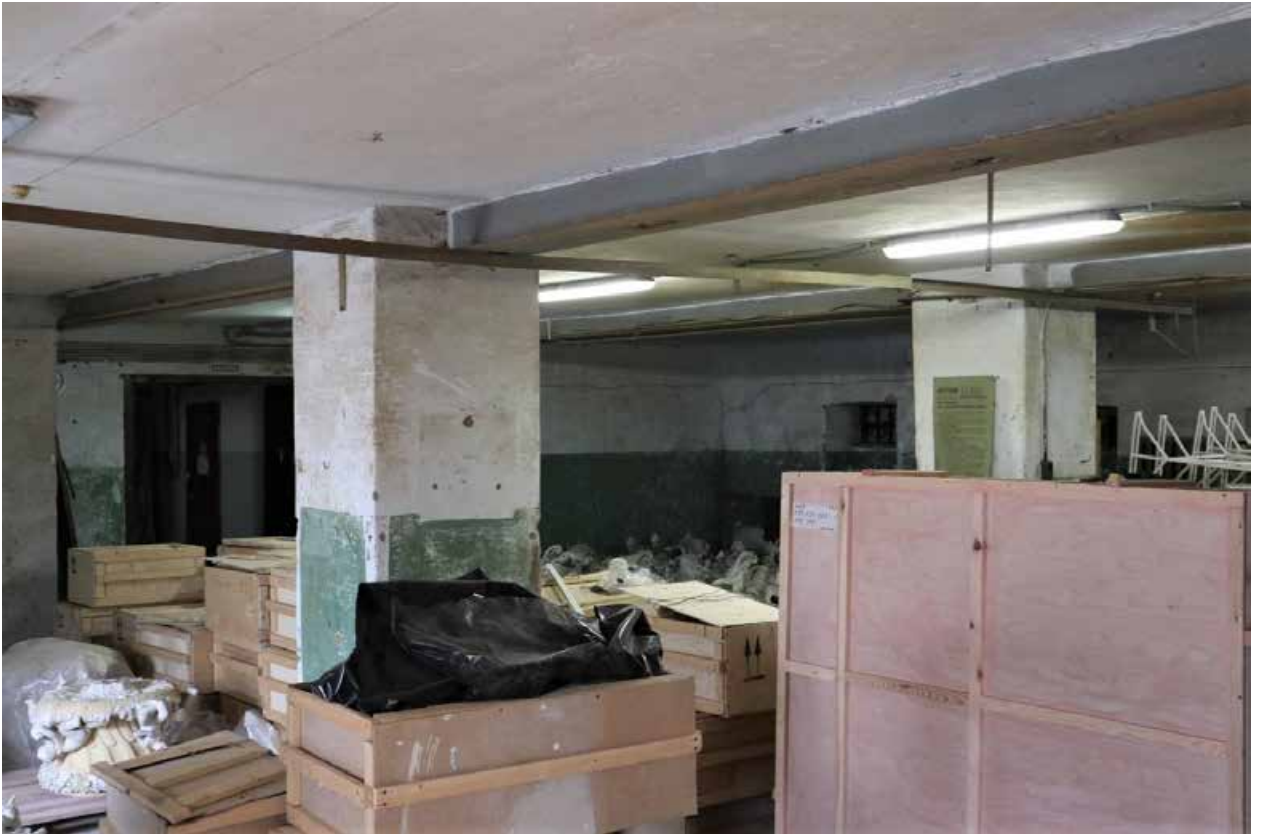
Фото 1.19. 1 этаж, помещение 1Н (1).
