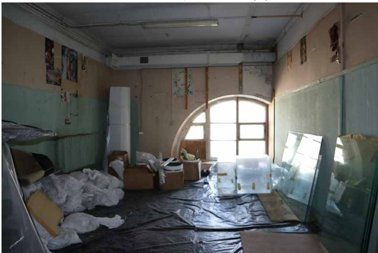
Фото 2.28. 2 этаж, помещение 1Н (11).
