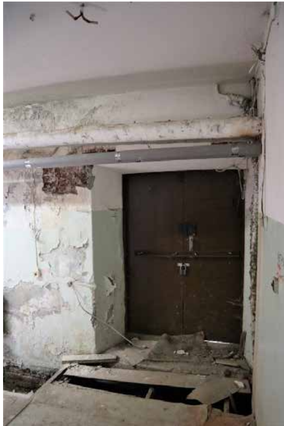
Фото 1.38. 1 этаж, помещение 1Н (4).
