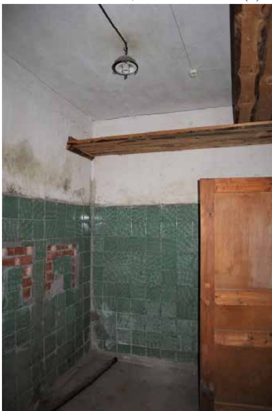
Фото 1.30. 1 этаж, помещение 1Н (5).
