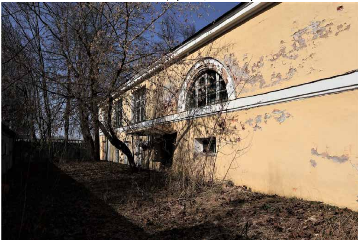
Фото 20. Южный фасад здания, фрагмент.
