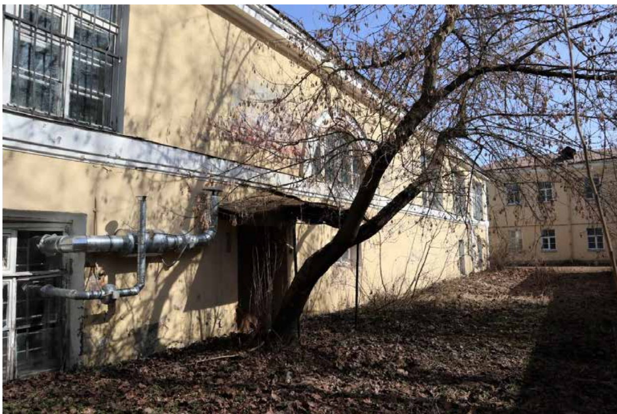
Фото 23. Южный фасад здания, фрагмент.
