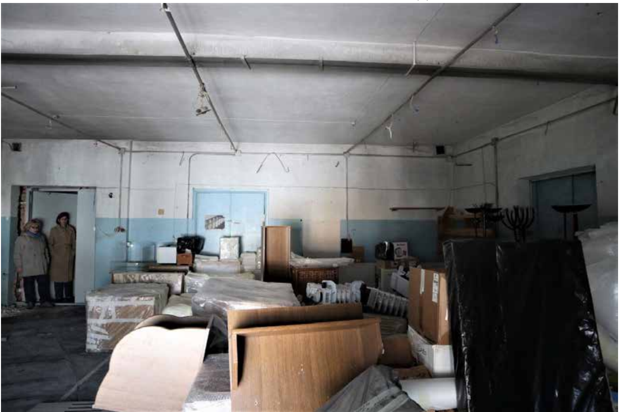
Фото 2.34. 2 этаж, помещение 1Н (9).
