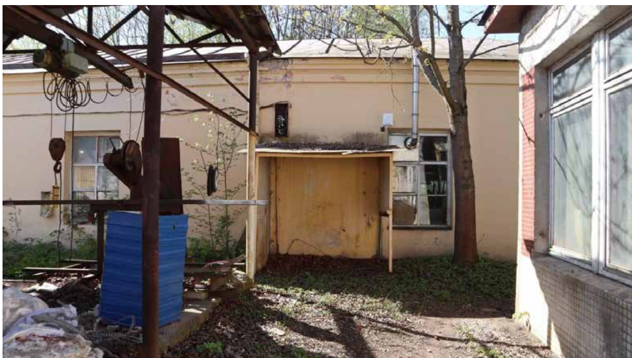
Фото 6. Северо-восточная часть фасада.
