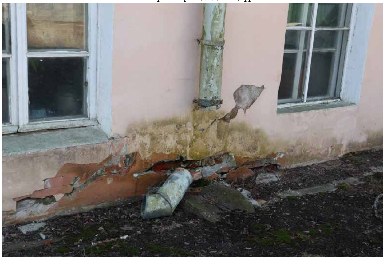
Фото 8. Северный фасад здания, фрагмент.
