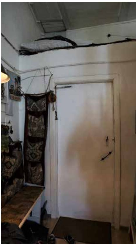
Фото 1.15. 1 этаж, помещение 4Н (1).
