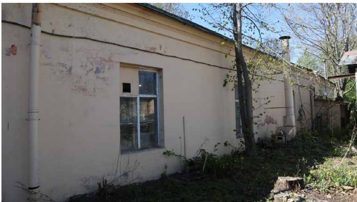
Фото 10. Восточная часть фасада.
