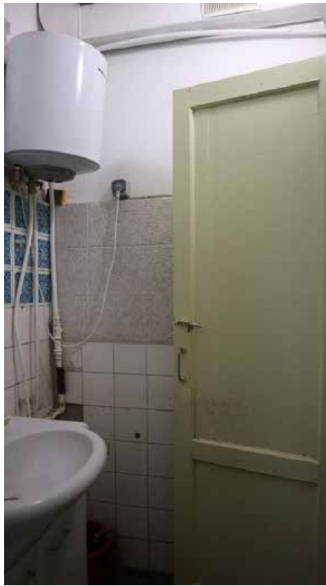
Фото 1.17. 1 этаж, помещение 4Н (3).
