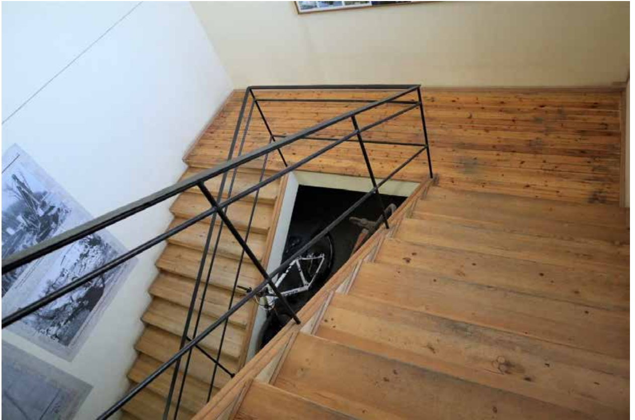
Фото 2.15. 2 этаж, лестница в западной части здания, помещение 3Н (6).
