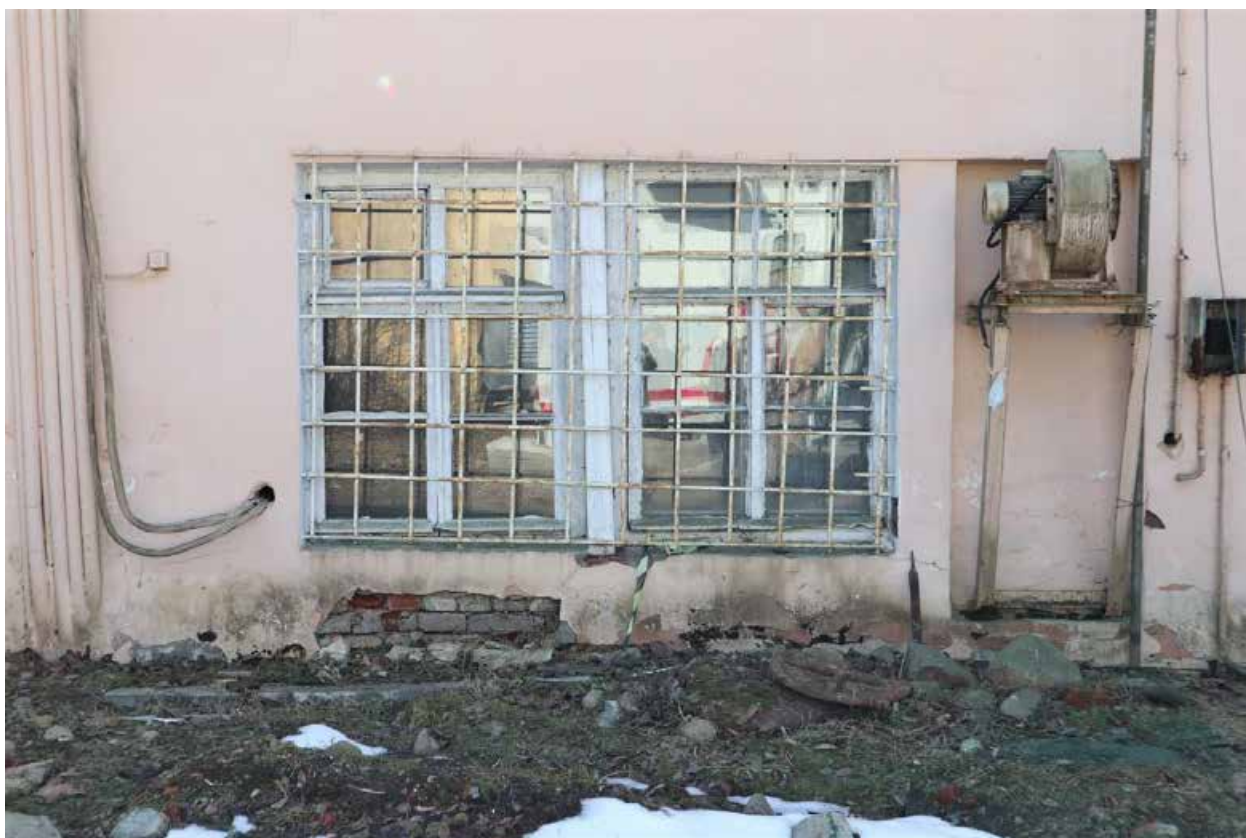
Фото 7. Северный фасад здания, фрагмент.
