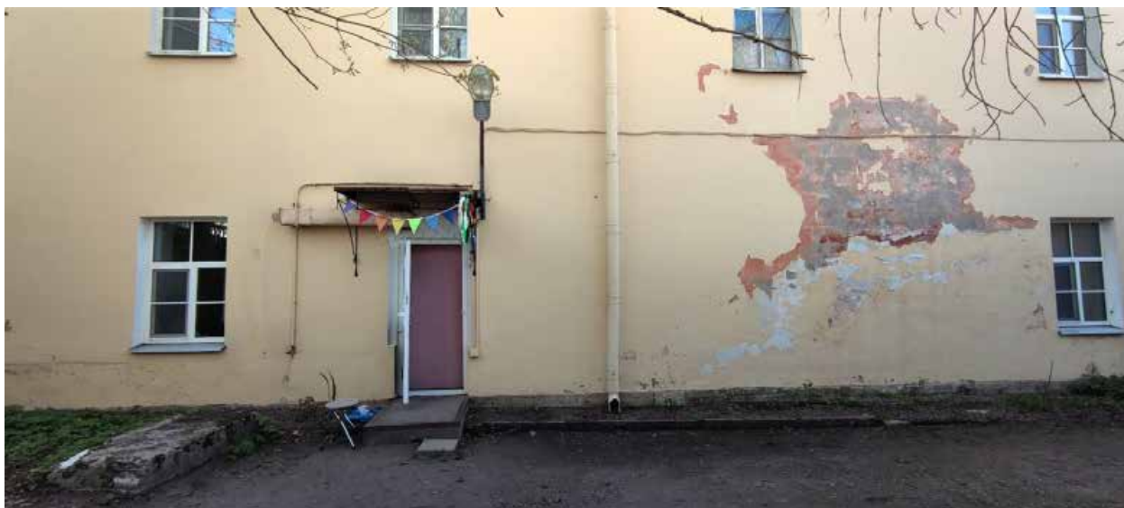
Фото 13. Восточный фасад здания, фрагмент.
