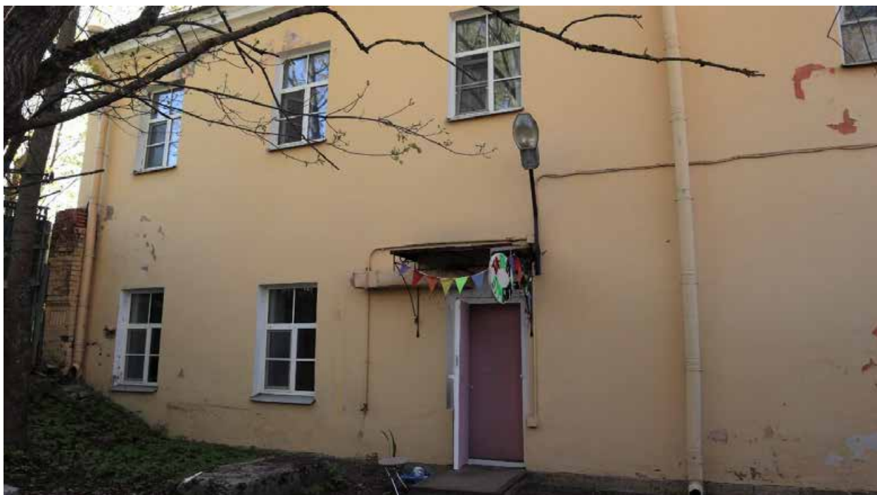
Фото 11. Восточный фасад здания, фрагмент.
