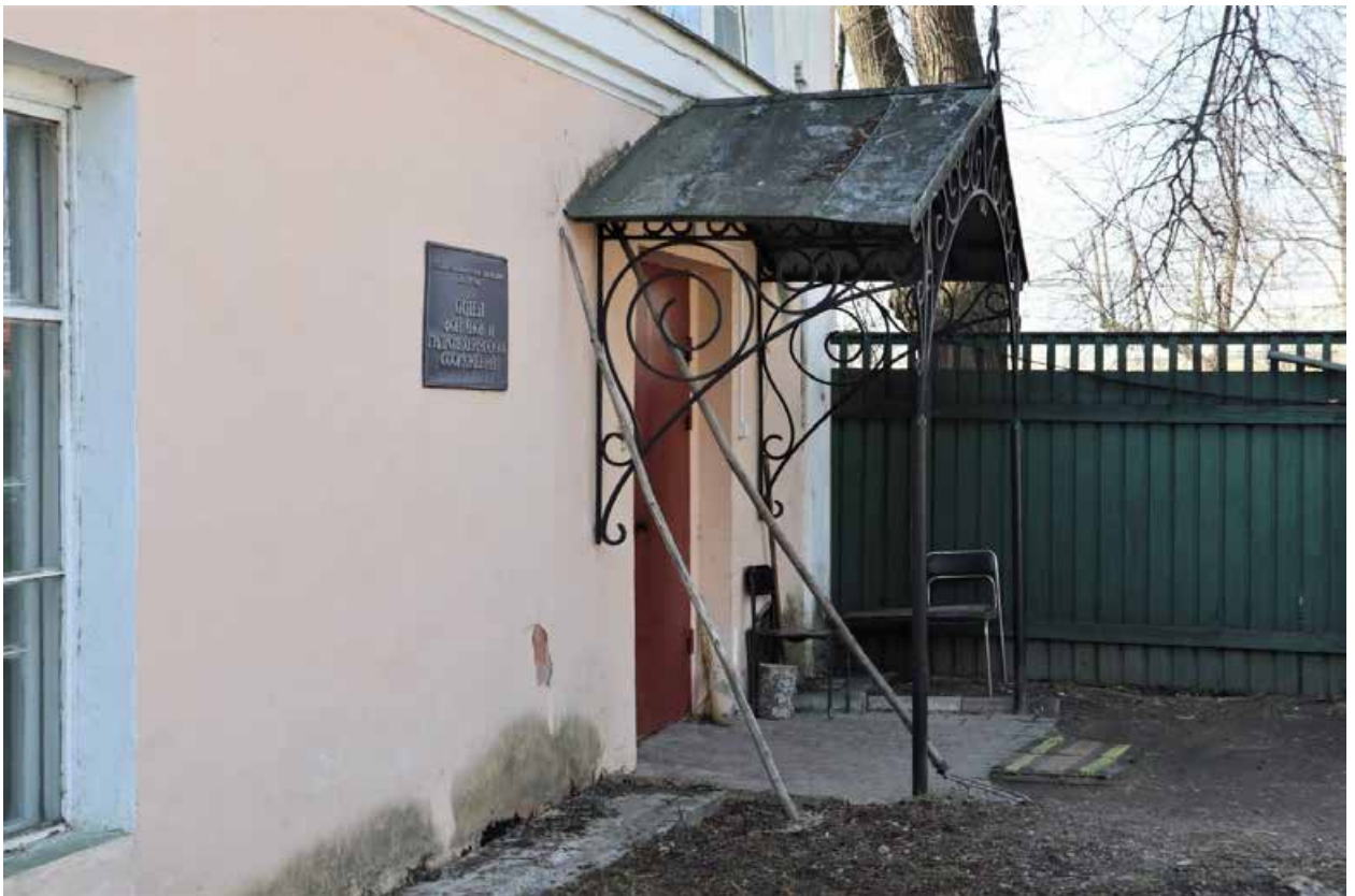
Фото 9. Северный фасад здания, фрагмент.
