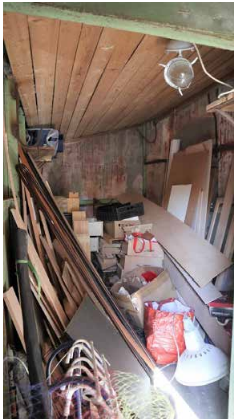
Фото 1.19. 1 этаж, помещение 1Н*.
