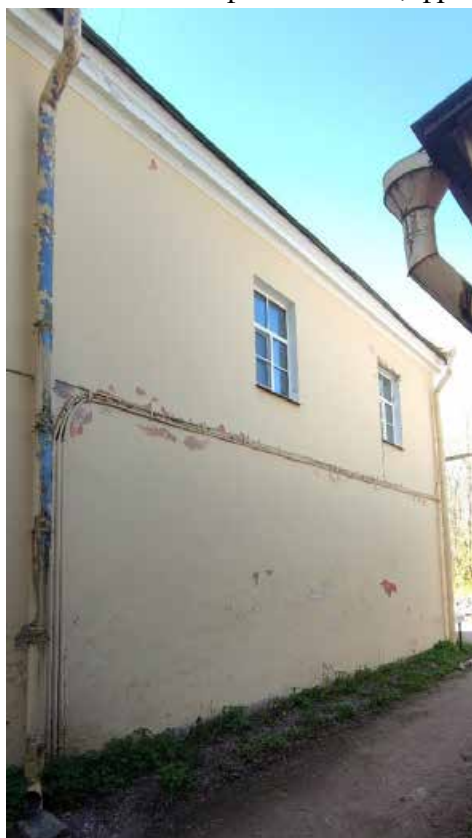
Фото 14. Восточный фасад здания, фрагмент.
