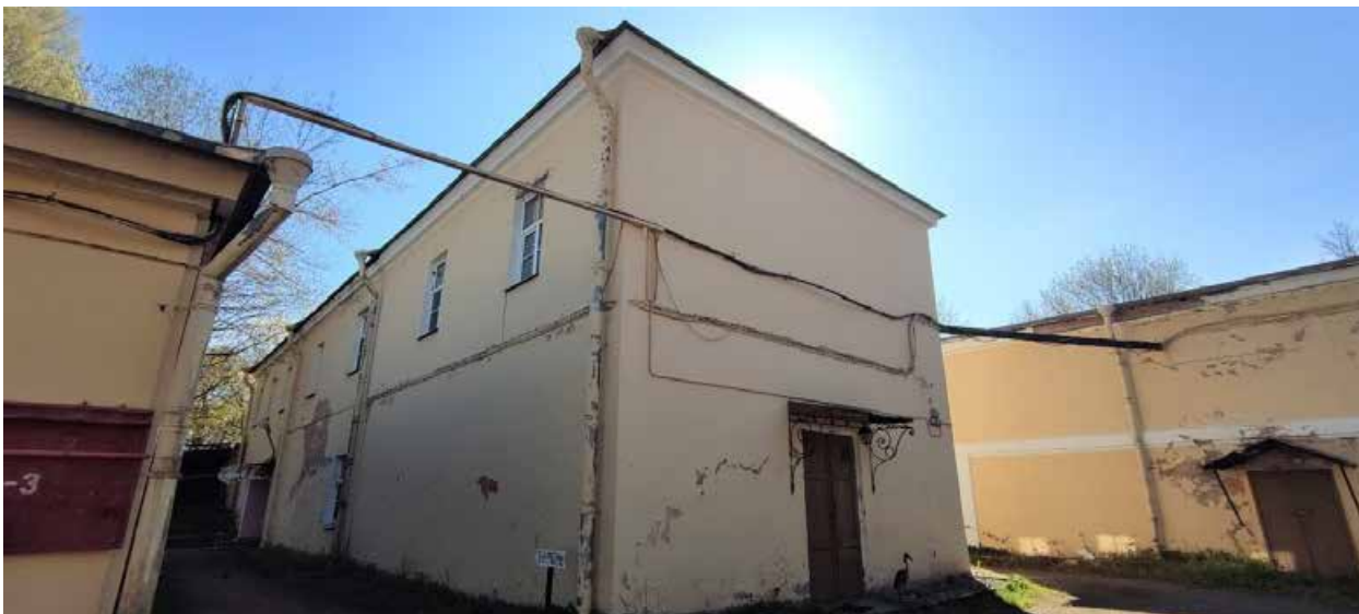
Фото 9. Северный (торцевой) фасад здания.
