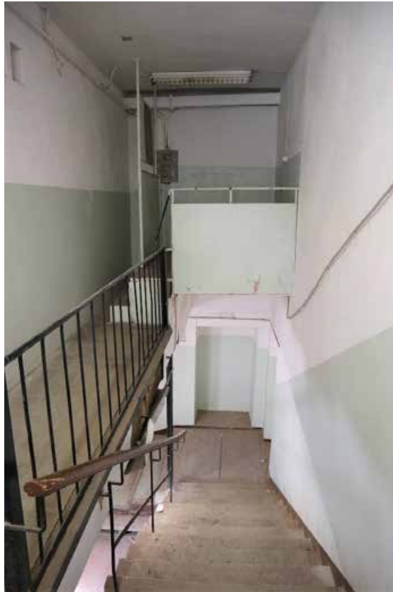
Фото 2.17. 2 этаж, лестница в центральной части здания, помещение 1Н (8).
