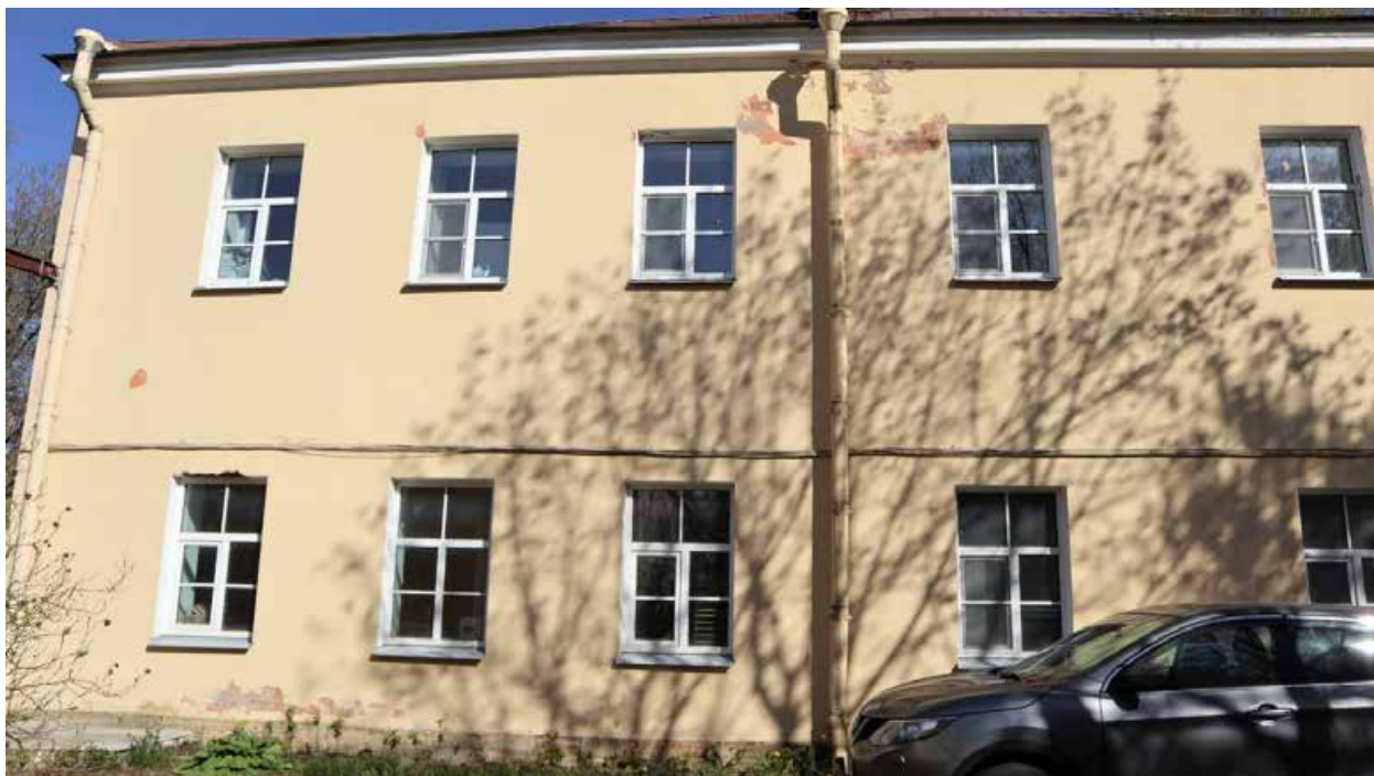
Фото 6. Западный фасад здания, фрагмент.
