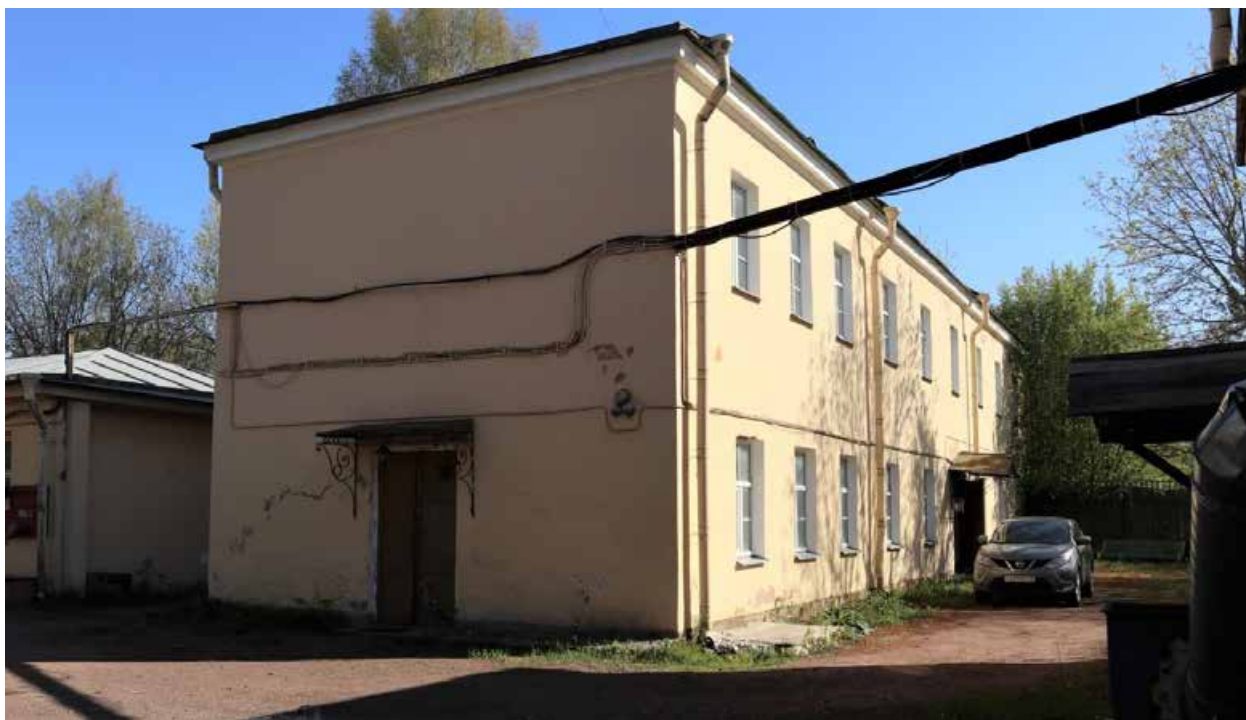
Фото 7. Северный (торцевой) фасад здания.
