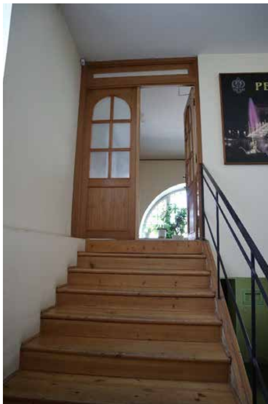
Фото 2.1. 2 этаж, лестница в западной части здания, помещение 3Н (6).
