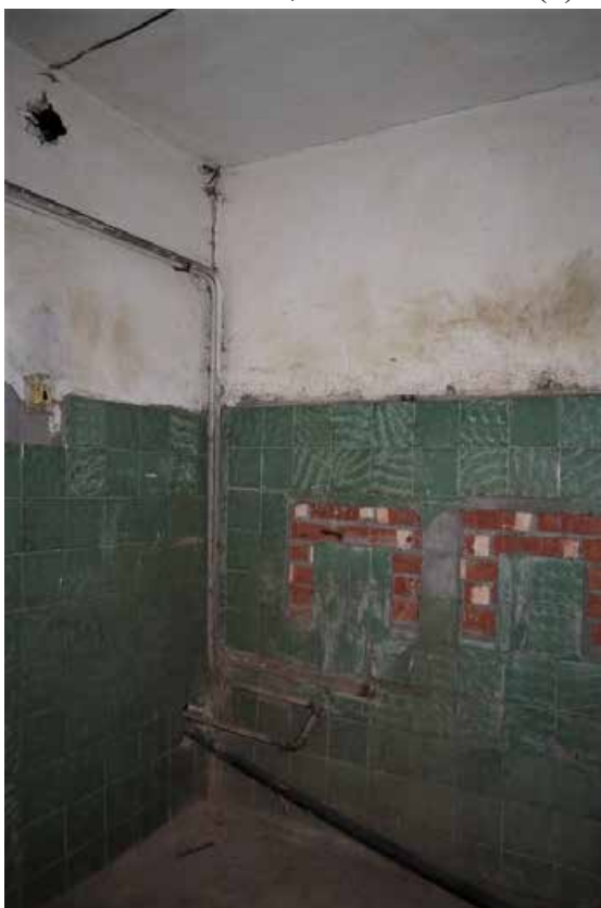
Фото 1.32. 1 этаж, помещение 1Н (5).
