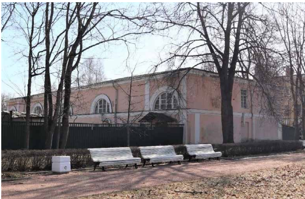
Фото 11. Западный (торцевой) фасад здания.
