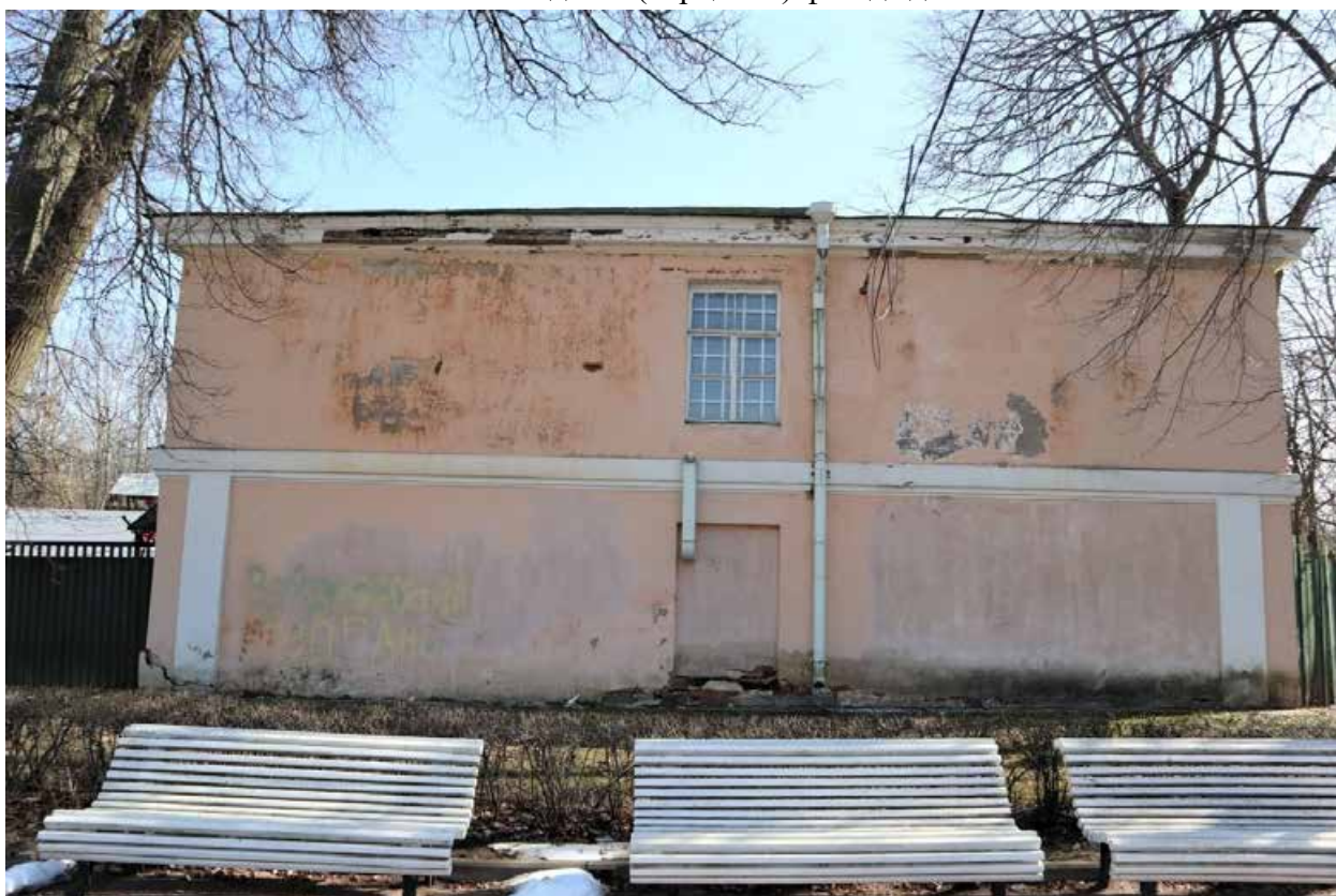
Фото 12. Западный (торцевой) фасад здания.
