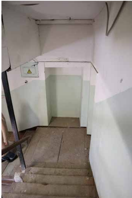
Фото 2.18. 2 этаж, лестница в центральной части здания, помещение 1Н (8).
