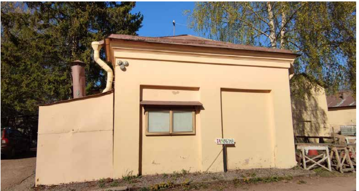
Фото 2. Южный (торцевой) фасад здания.
