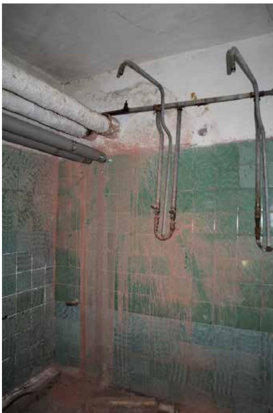
Фото 1.31. 1 этаж, помещение 1Н (6).
