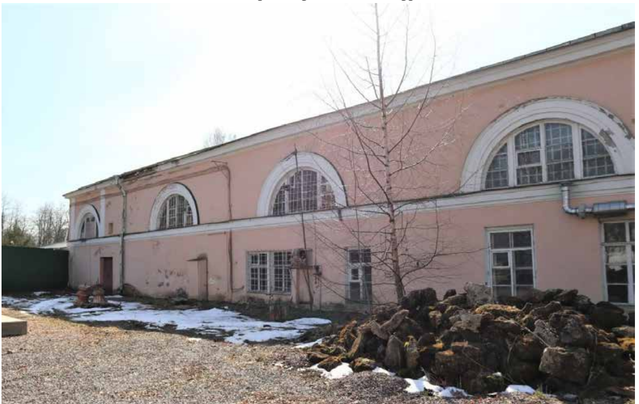
Фото 2. Северный фасад здания, фрагмент.
