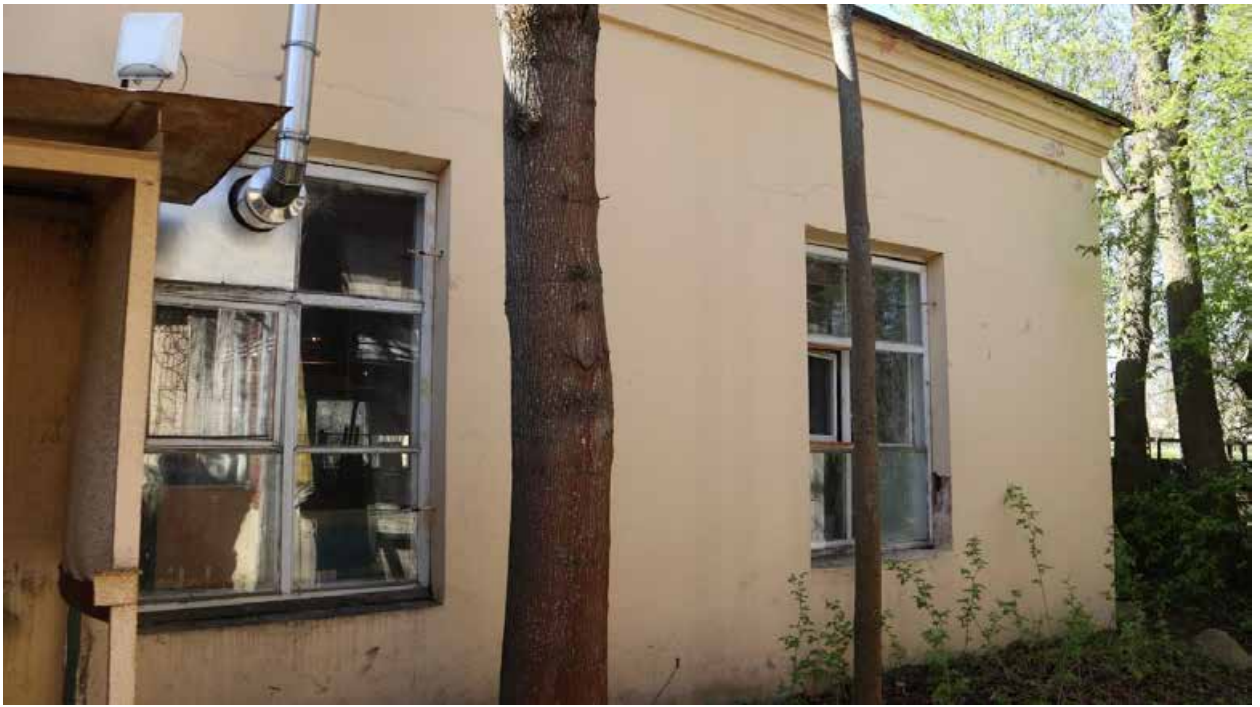
Фото 7. Северо-восточная часть фасада.
