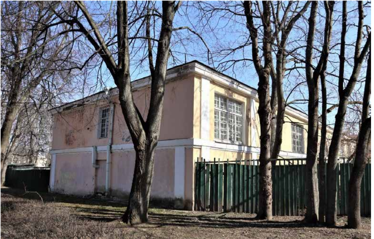
Фото 15. Западный (торцевой) фасад здания.
