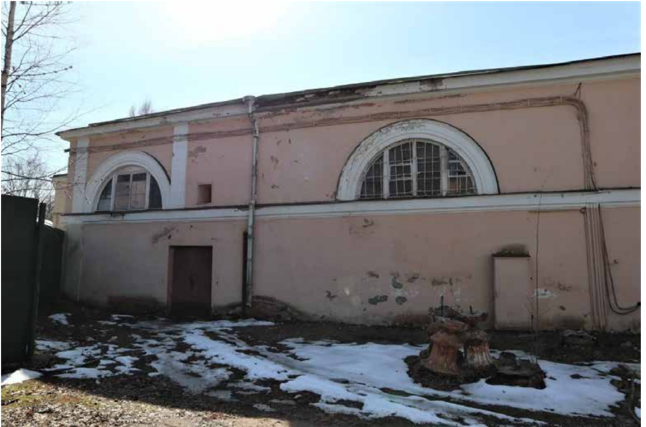
Фото 5. Северный фасад здания, фрагмент.
