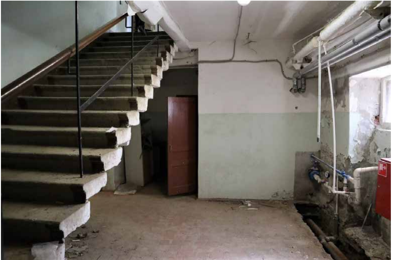
Фото 1.37. 1 этаж, лестница в центральной части здания, помещение 1Н (4).
