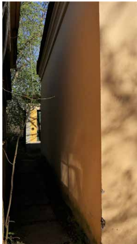
Фото 16. Северный (торцевой) фасад.
