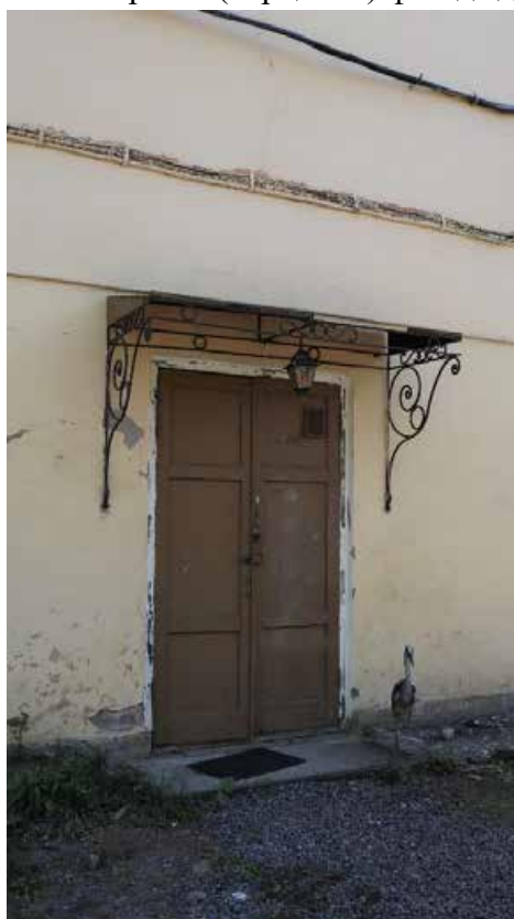
Фото 8. Северный (торцевой) фасад здания, фрагмент.
