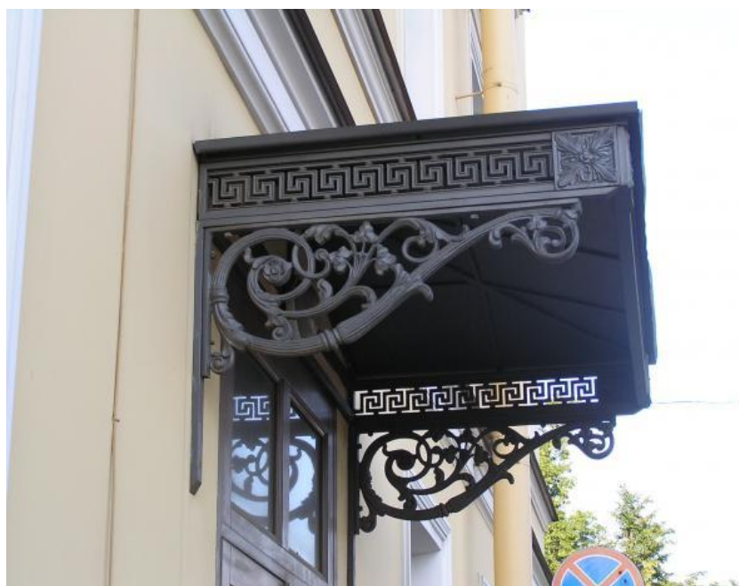
70. Бывший Николаевский дом призрения престарелых и увечных граждан Санкт-Петербургского купеческого общества. Крыльцо со стороны Расстанной улицы. Козырек. Фотография. Март 2013. www.citywalls.ru .
