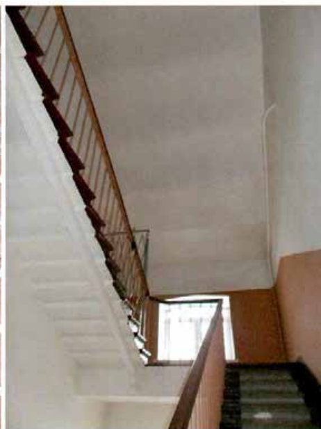
17. Лазарет (лестница 8-ЛК, перекрытия)
