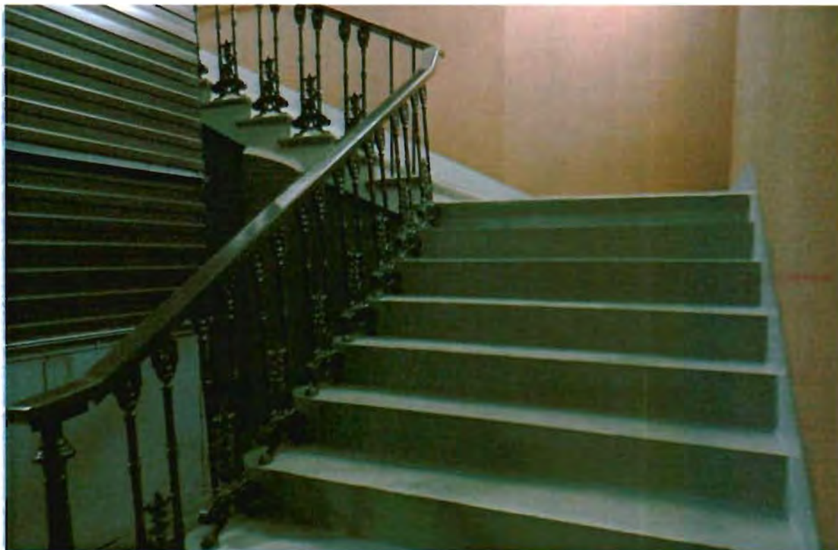
9. Историческая межэтажная лестница (корпус № 2).
