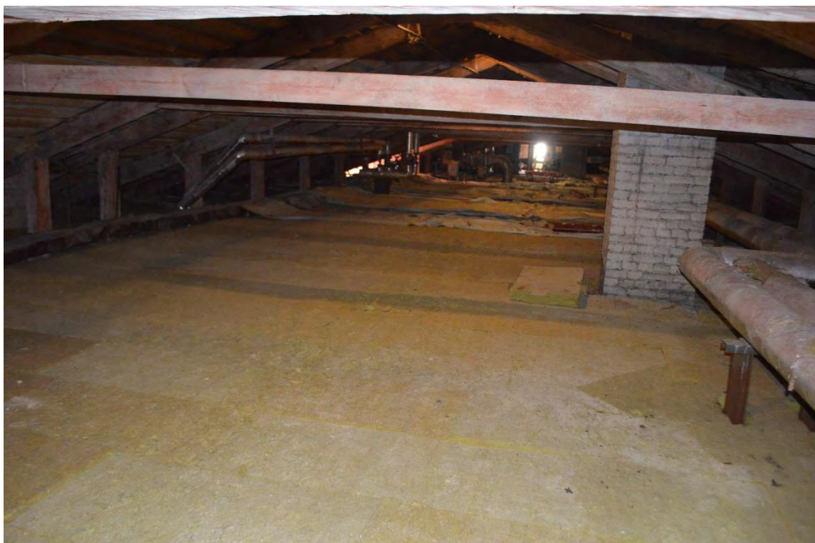
Фото 14. ОКН федерального значения «Монетный двор». Корпус № 5. Чердак. Стропильная система. Общий вид. Съёмка 24.11.2022 г.
