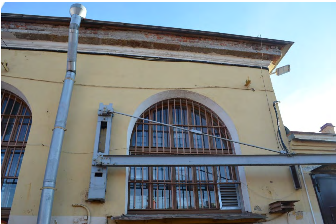
Фото 2. ОКН федерального значения «Монетный двор». Корпус № 5. Фасады. Фрагмент. Съёмка 24.11.2022 г.
