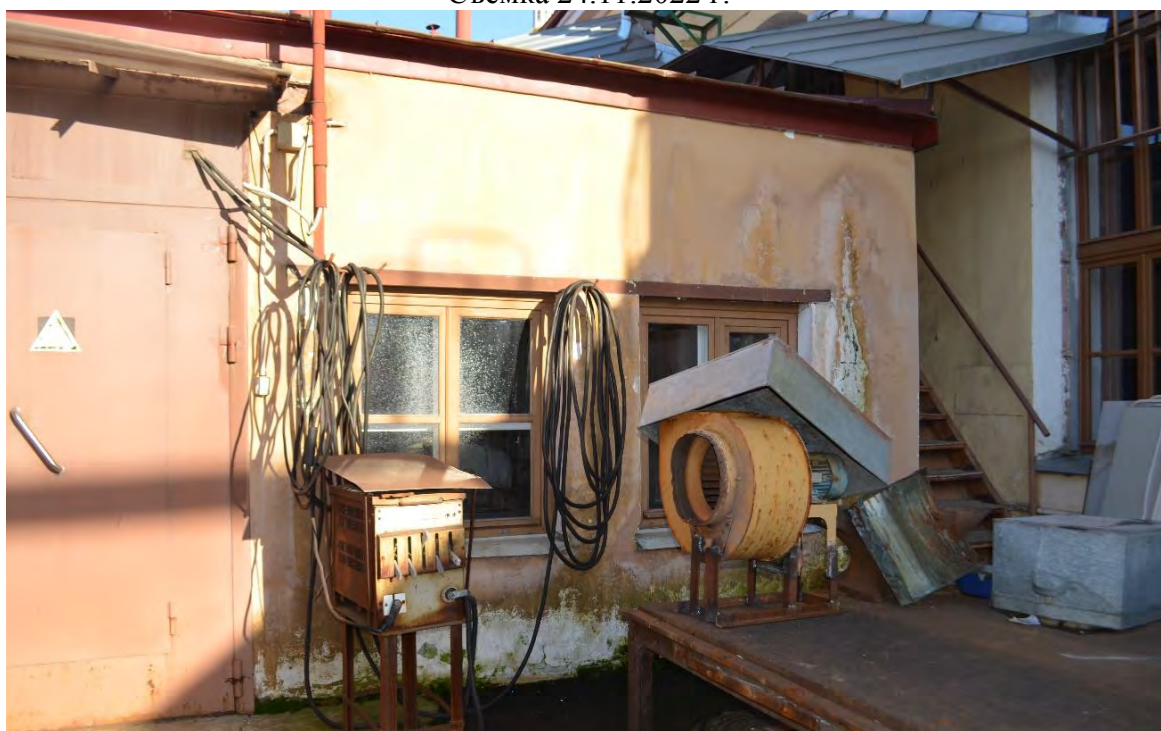
Фото 3. ОКН федерального значения «Монетный двор». Корпус № 5. Фасады. Фрагмент. Съёмка 24.11.2022 г.
