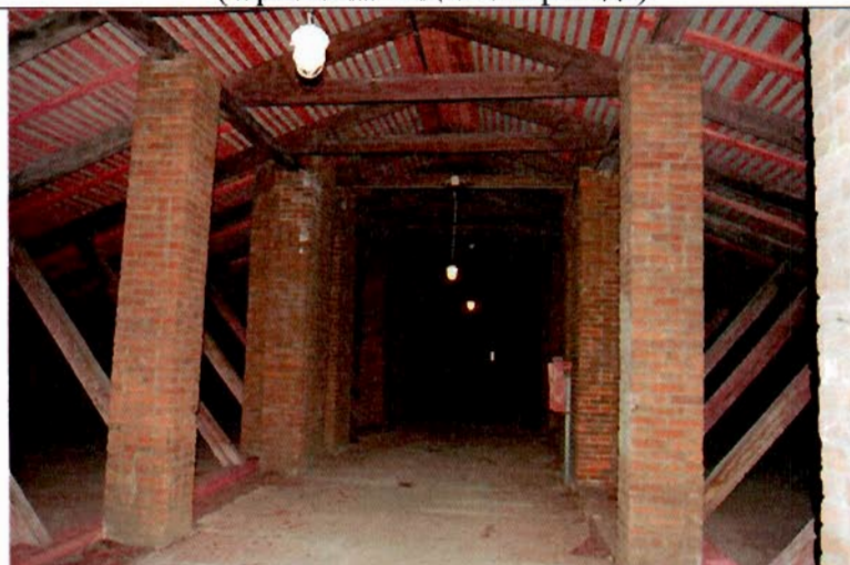
14. Объект культурного наследия регионального значения "Казарма для строевых рот с двумя воротами" (наб. кан. Грибоедова, дом 133, лит. Б) (Фрагмент интерьера в уровне чердака)
