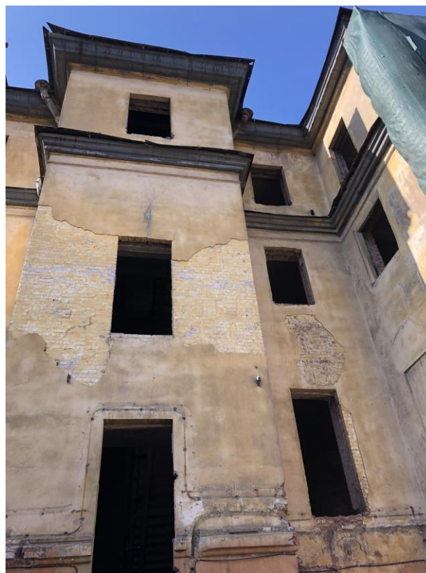
Фото 8. Дворовый фасад исследуемого здания.
