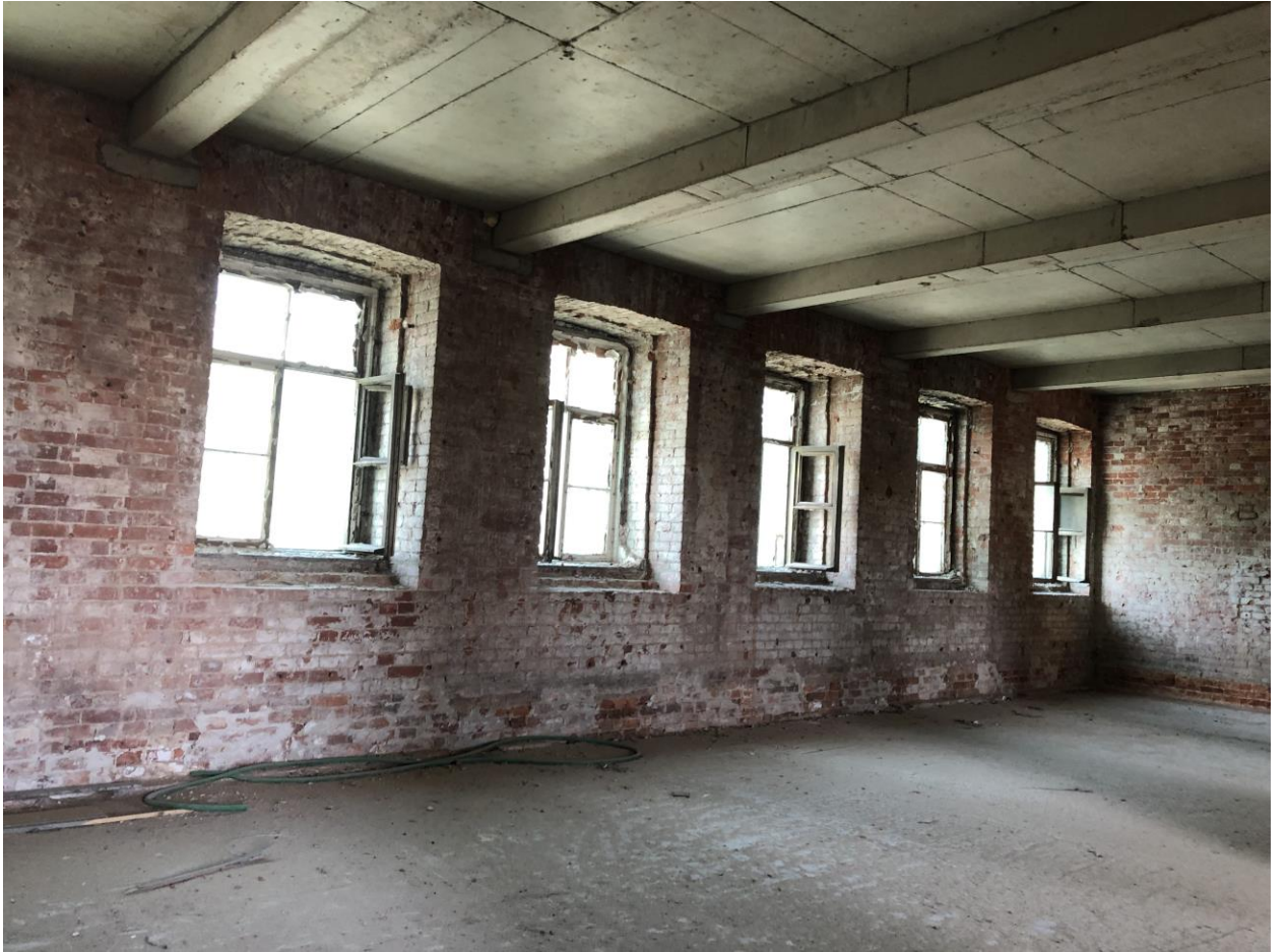
Фото 9. Помещения 3-го этажа.
