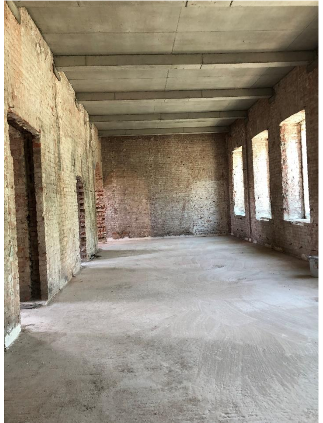
Фото 4. Помещения 2-го этажа.
