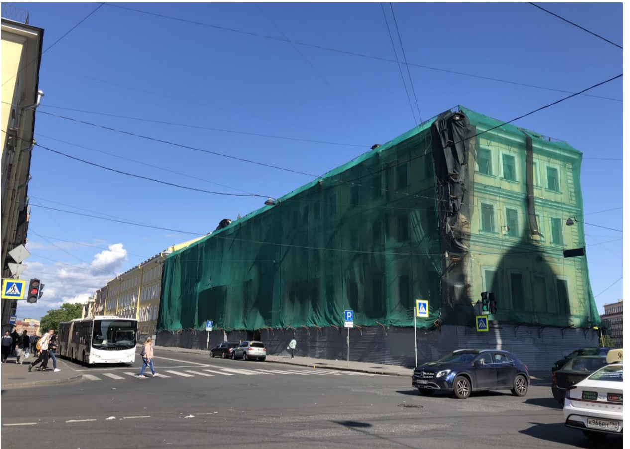
Фото 4. Вид на западный угол исследуемого здания.
