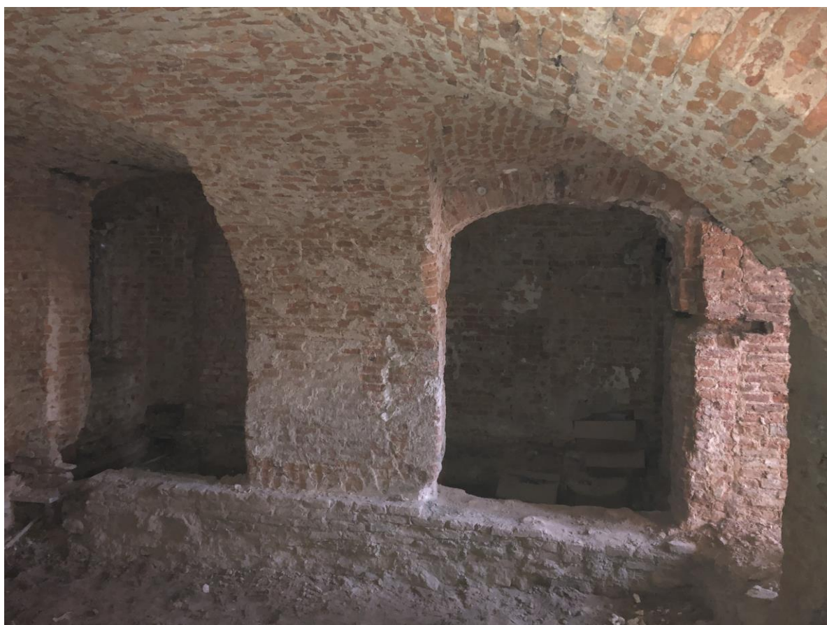
Фото 2. Помещения 1-го (цокольного) этажа.
