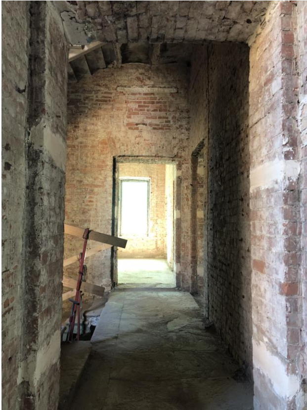
Фото 5. Помещения 2-го этажа.
