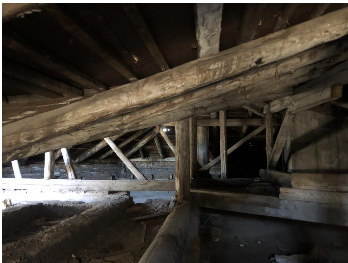
Фото 14. Вид на чердачное помещение.
