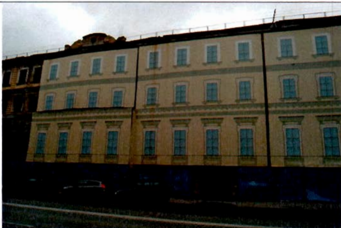
1. Объект культурного наследия регионального значения "Штаб и обер-офицерский дом" (пр. Римского-Корсакова, дом 22, лит. В) (Фрагмент лицевого фасада)
