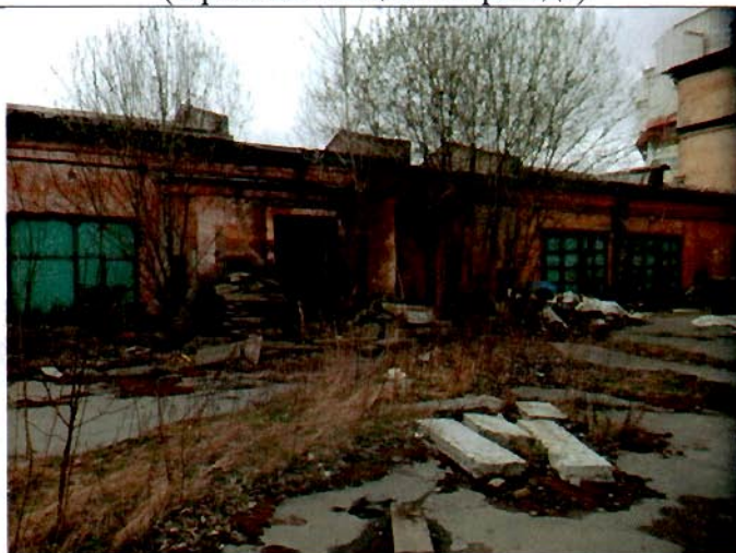
12. Объект культурного наследия регионального значения "Служебный корпус" (пр. Римского-Корсакова, дом 22, лит. Г) (Фрагмент дворового фасада)
