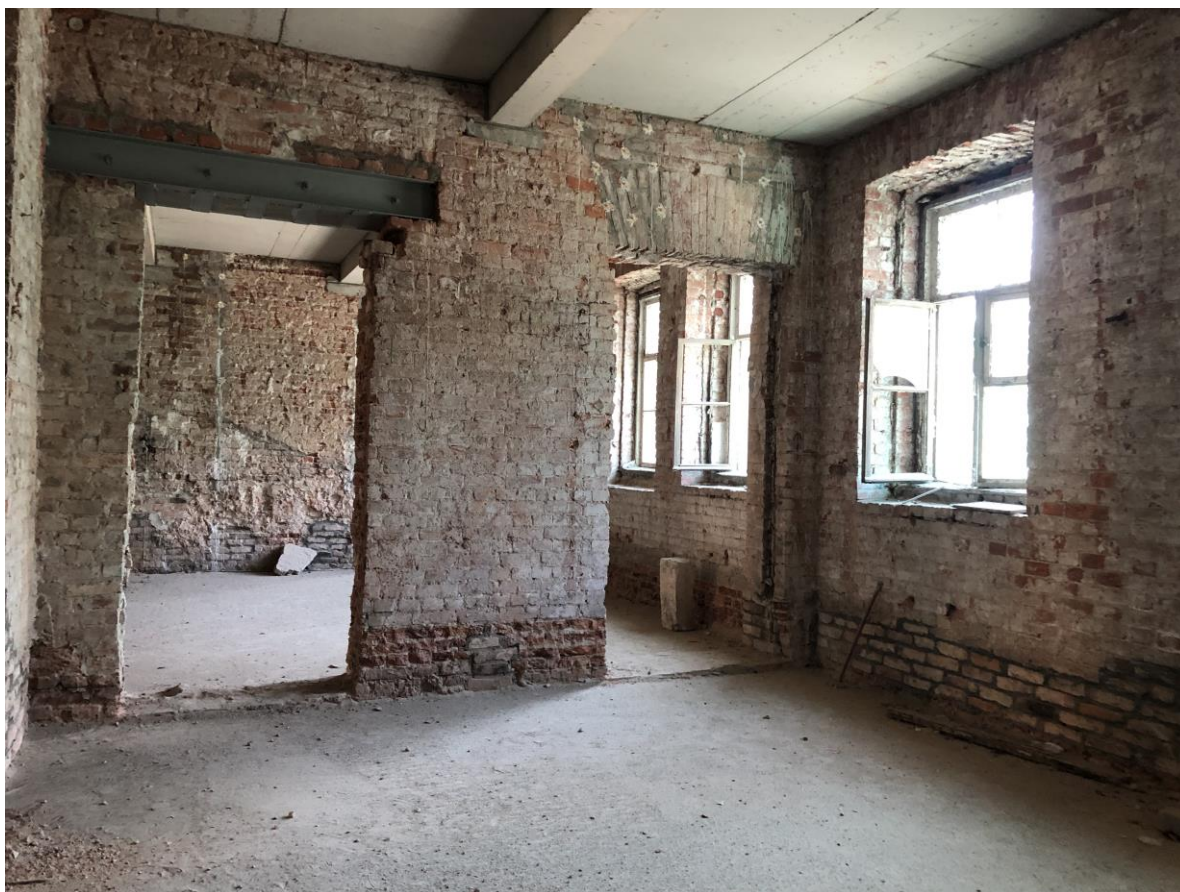
Фото 11. Помещения 4-го этажа.
