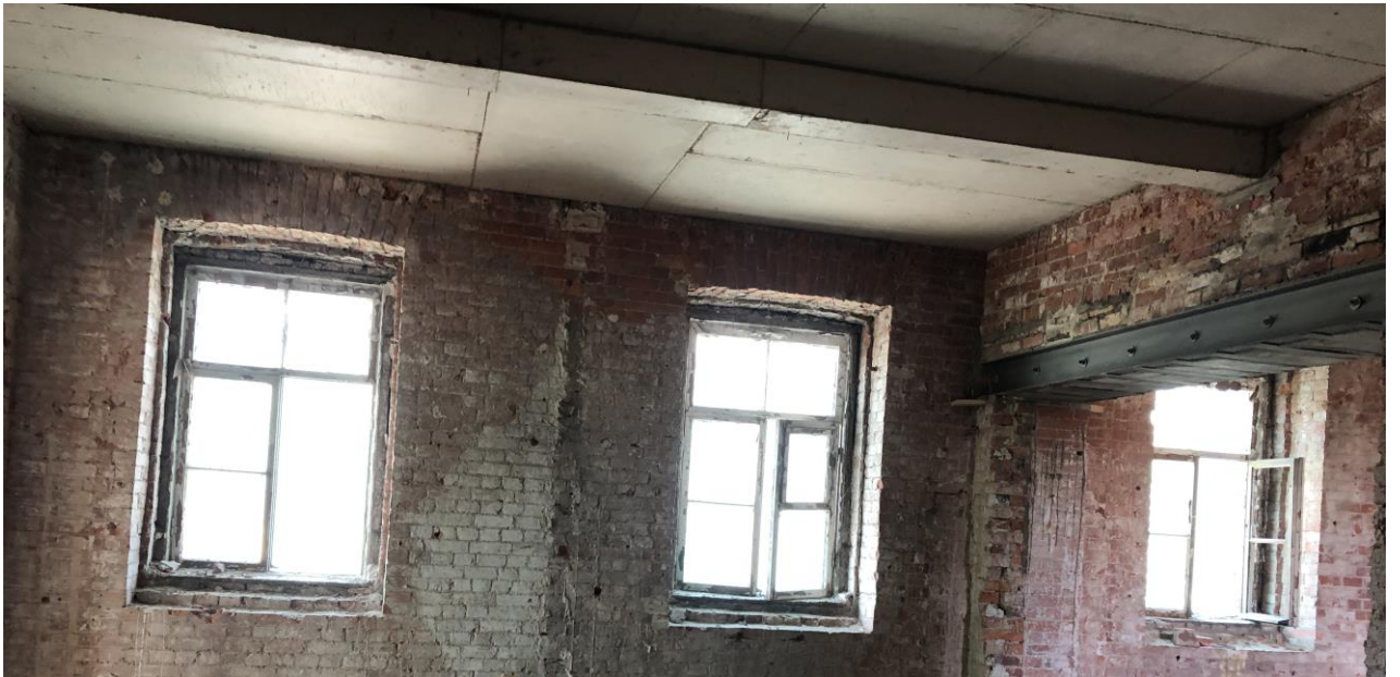
Фото 8. Помещения 3-го этажа.
