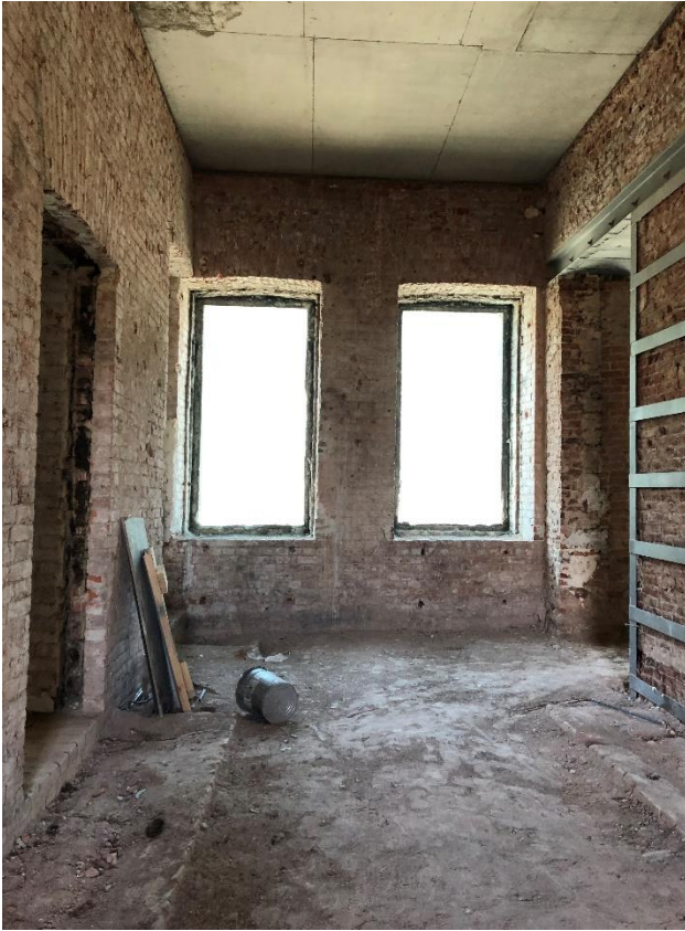
Фото 3. Помещения 2-го этажа.
