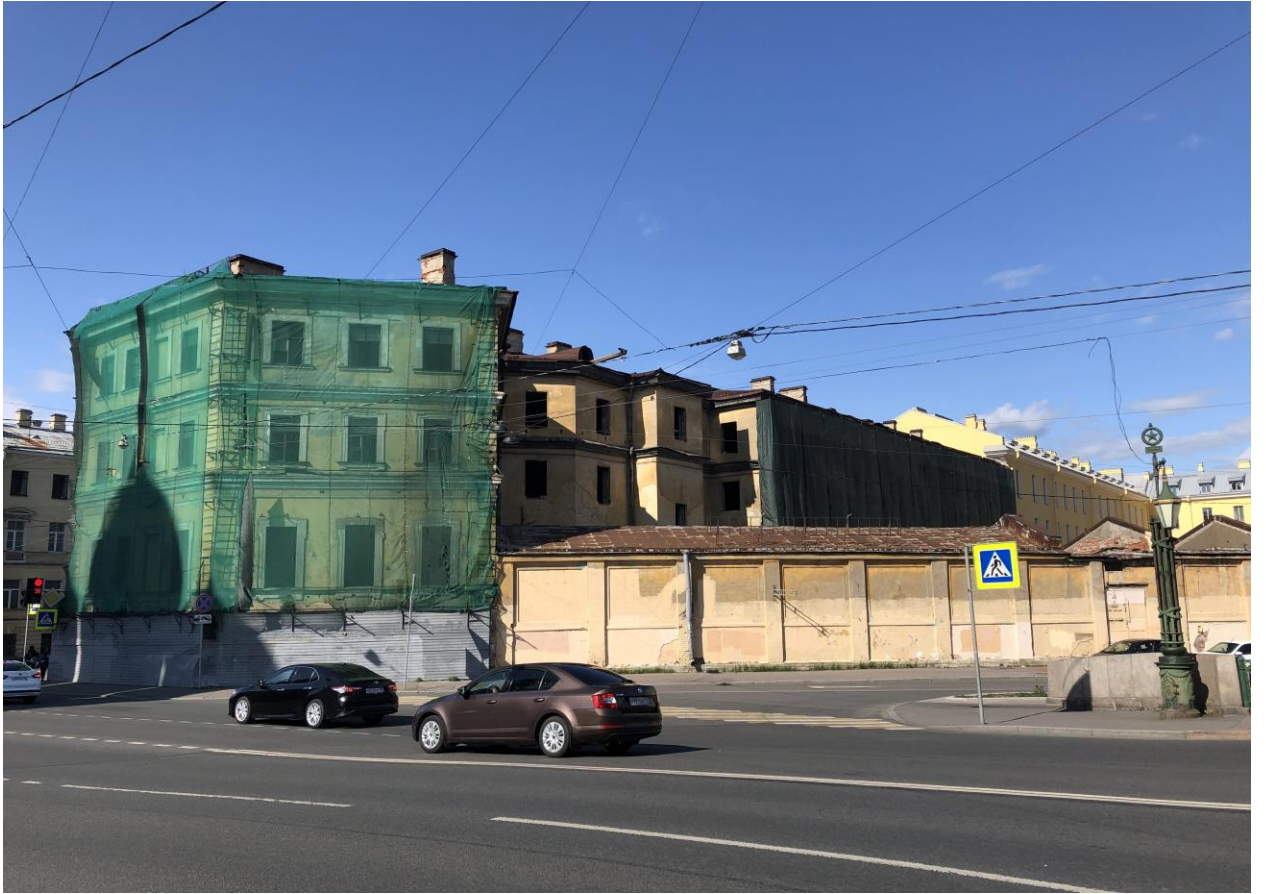
Фото 3. Вид на юго-западную часть исследуемого здания.
