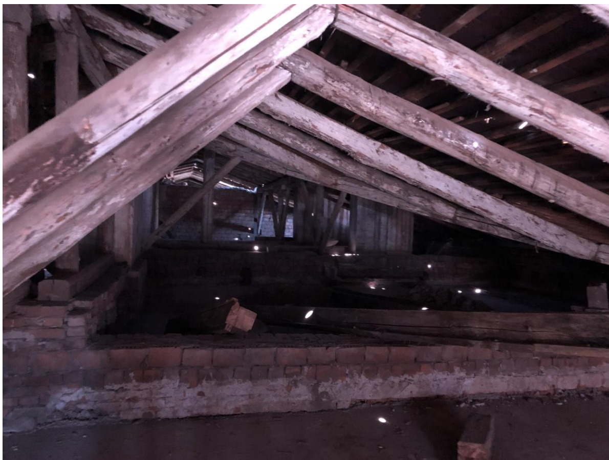
Фото 13. Вид на чердачное помещение.
