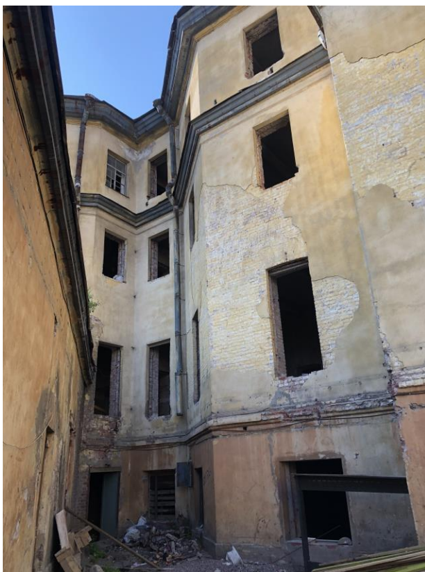
Фото 7. Дворовый фасад исследуемого здания.
