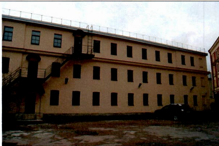
7. Объект культурного наследия регионального значения "Казарма для холостых нижних чинов с двумя дворовыми флигелями" (пр. Римского-Корсакова, дом 22, лит. В, Д) (Фрагмент дворового фасада)
