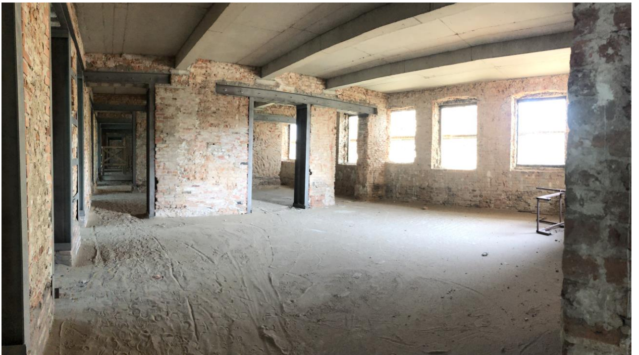
Фото 10. Помещения 3-го этажа.
