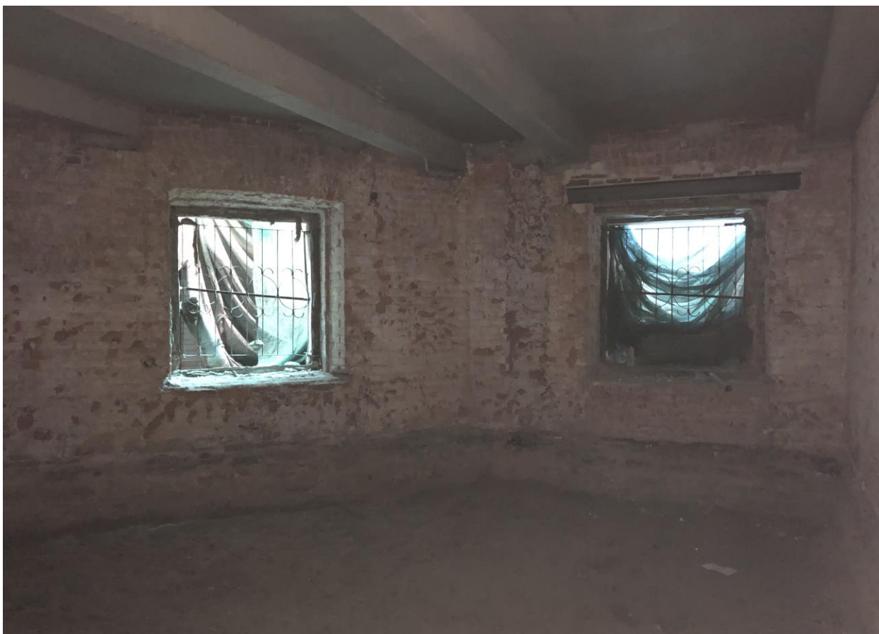
Фото 1. Помещения 1-го(цокольного) этажа.
