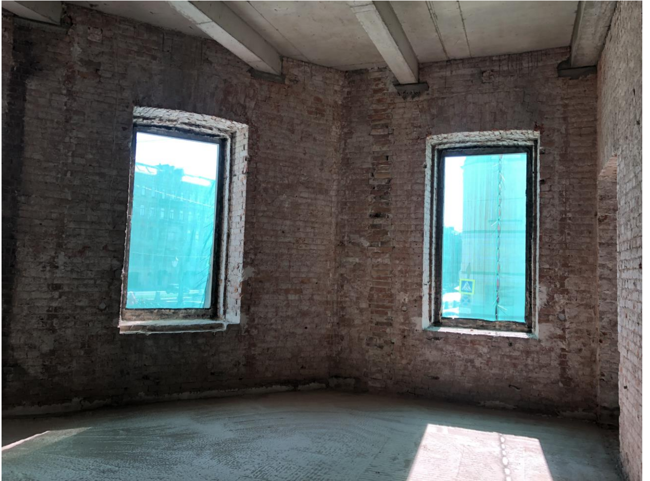
Фото 7. Помещения 2-го этажа.
