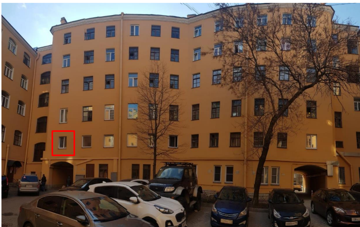
1. Юго-восточный дворовый фасад объекта культурного наследия регионального значения «Дом по 2-ой Советской ул. с дворовым флигелем», расположенного по адресу: г. Санкт-Петербург, 2-ая Советская ул., 27/2, литера А, входящего в состав объекта культурного наследия регионального значения «Дом Галунова И.В.». 04.05.2022
