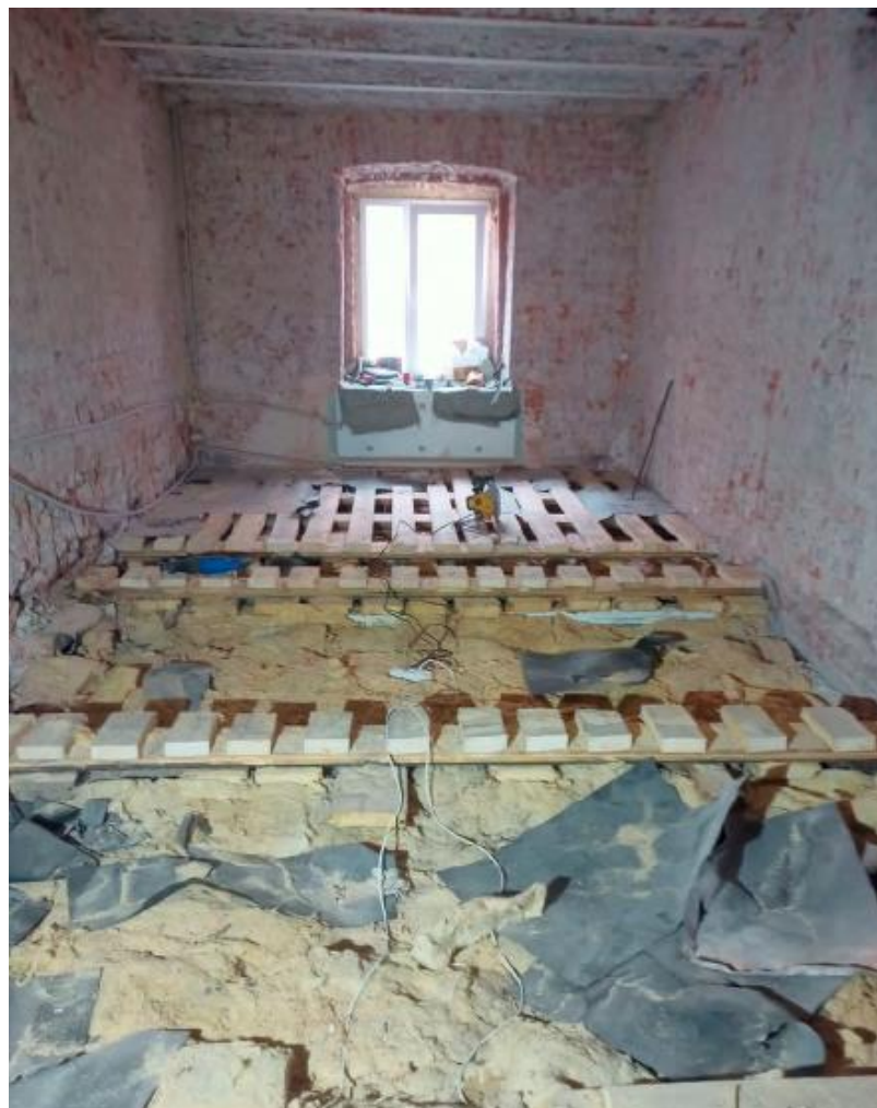
6. Помещение №4 кв. №48-49 объекта культурного наследия регионального значения «Дом по 2-ой Советской ул. с дворовым флигелем», расположенного по адресу: г. Санкт-Петербург, 2-ая Советская ул., 27/2, литера А. 04.05.2022
