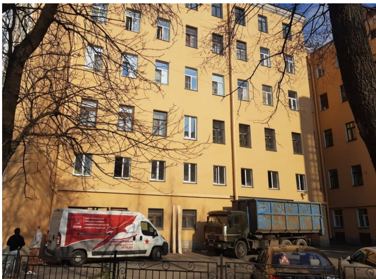
2. Юго-западный дворовый фасад объекта культурного наследия регионального значения «Дом по 2-ой Советской ул. с дворовым флигелем», расположенного по адресу: г. Санкт-Петербург, 2-ая Советская ул., 27/2, литера А, входящего в состав объекта культурного наследия регионального значения «Дом Галунова И.В.».
