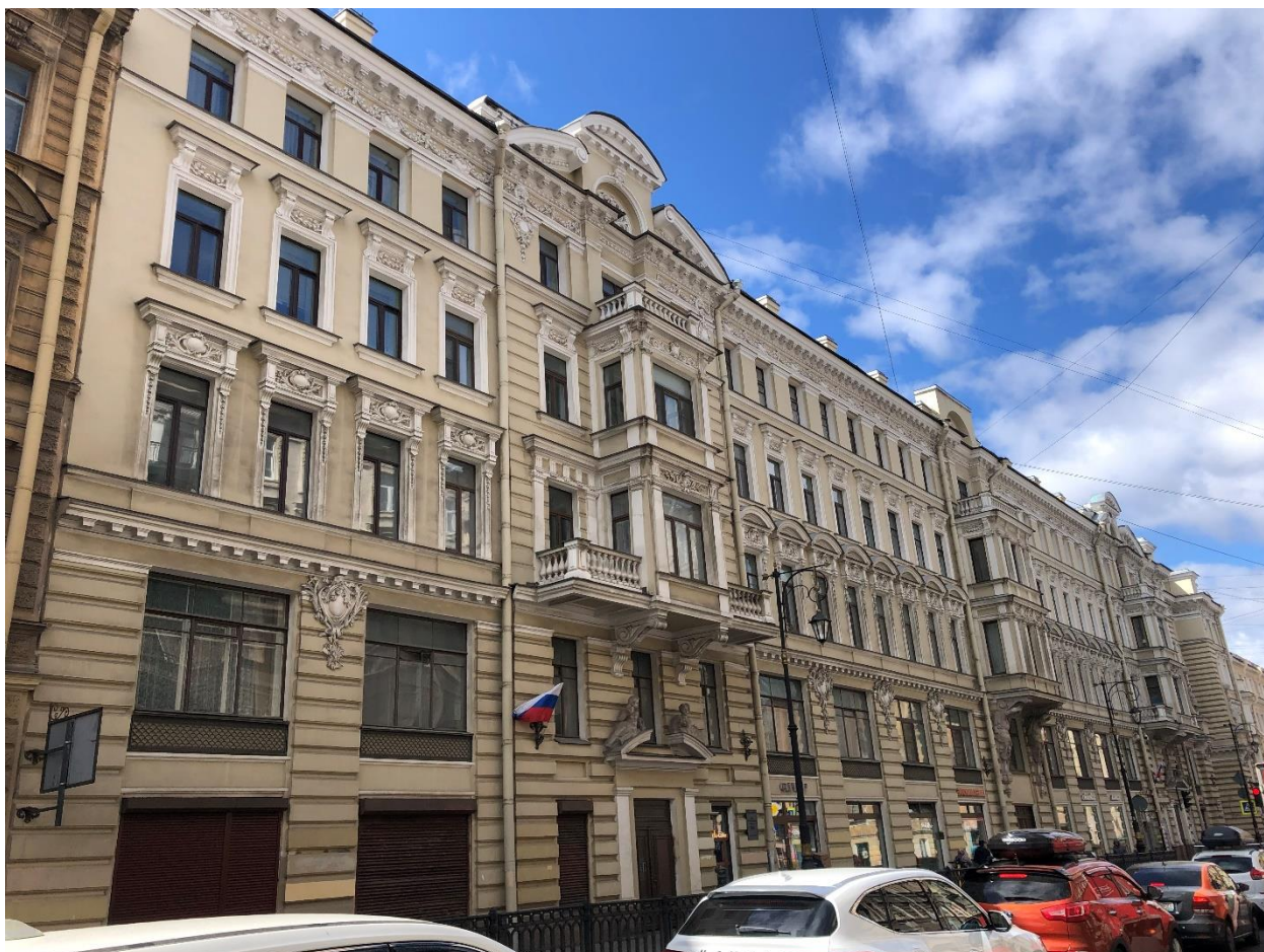
Фото 2. Вид на лицевой фасад дома № 13-15 по ул. Пестеля.
