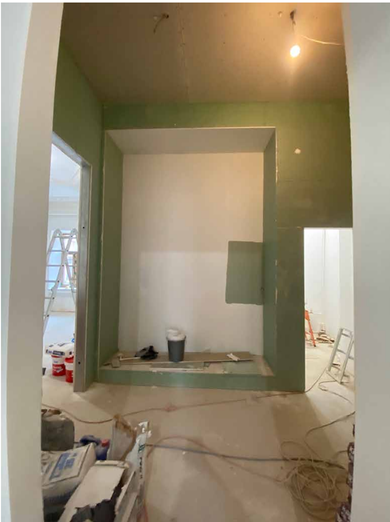
Фото 30. Вид на помещение квартиры № 45 объекта культурного наследия.
