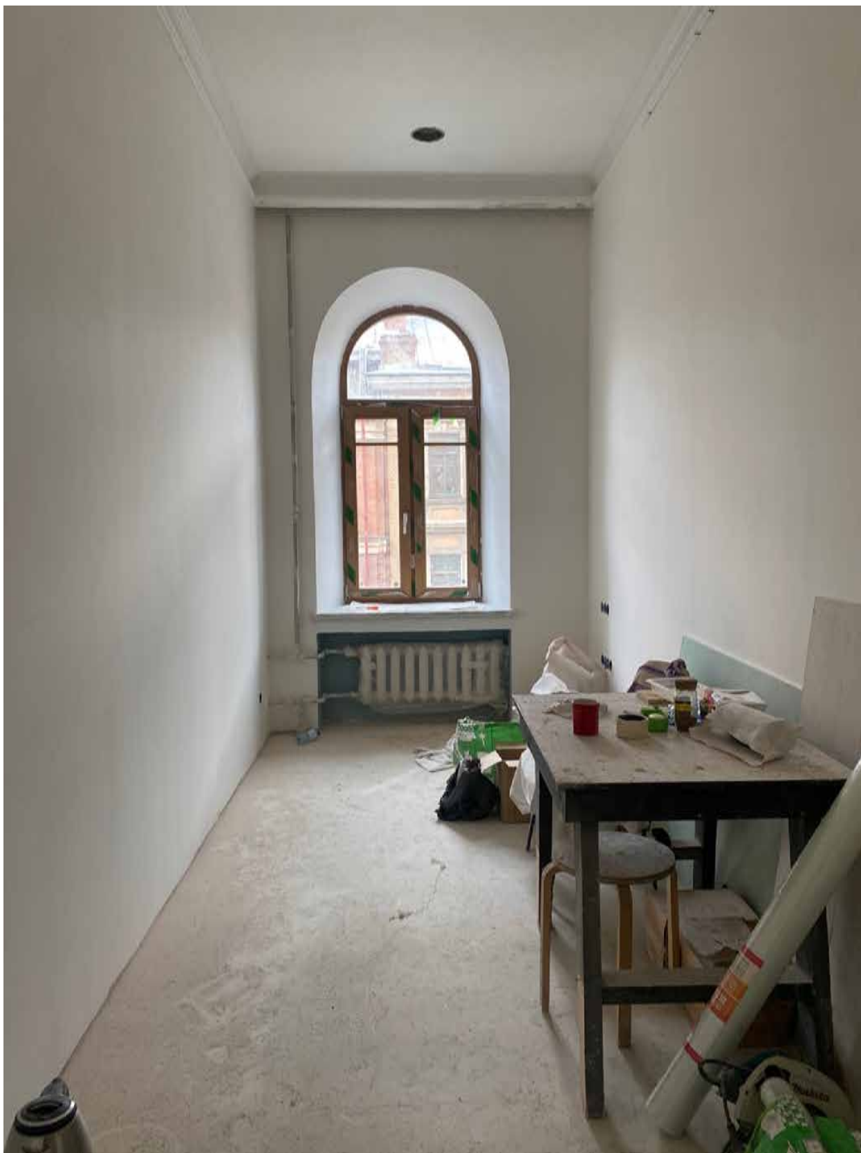
Фото 56. Вид на помещение квартиры № 45 объекта культурного наследия.
