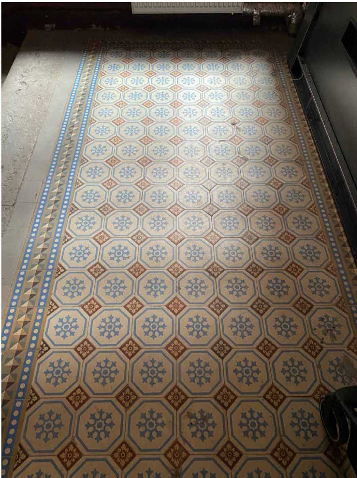
Фото 19. Вид на напольное покрытие лестничной площадки объекта культурного наследия.
