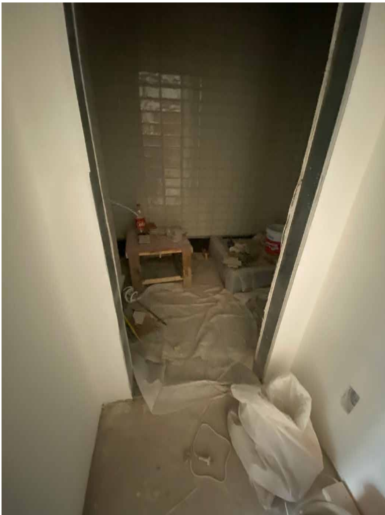
Фото 48. Вид на помещение квартиры № 45 объекта культурного наследия.
