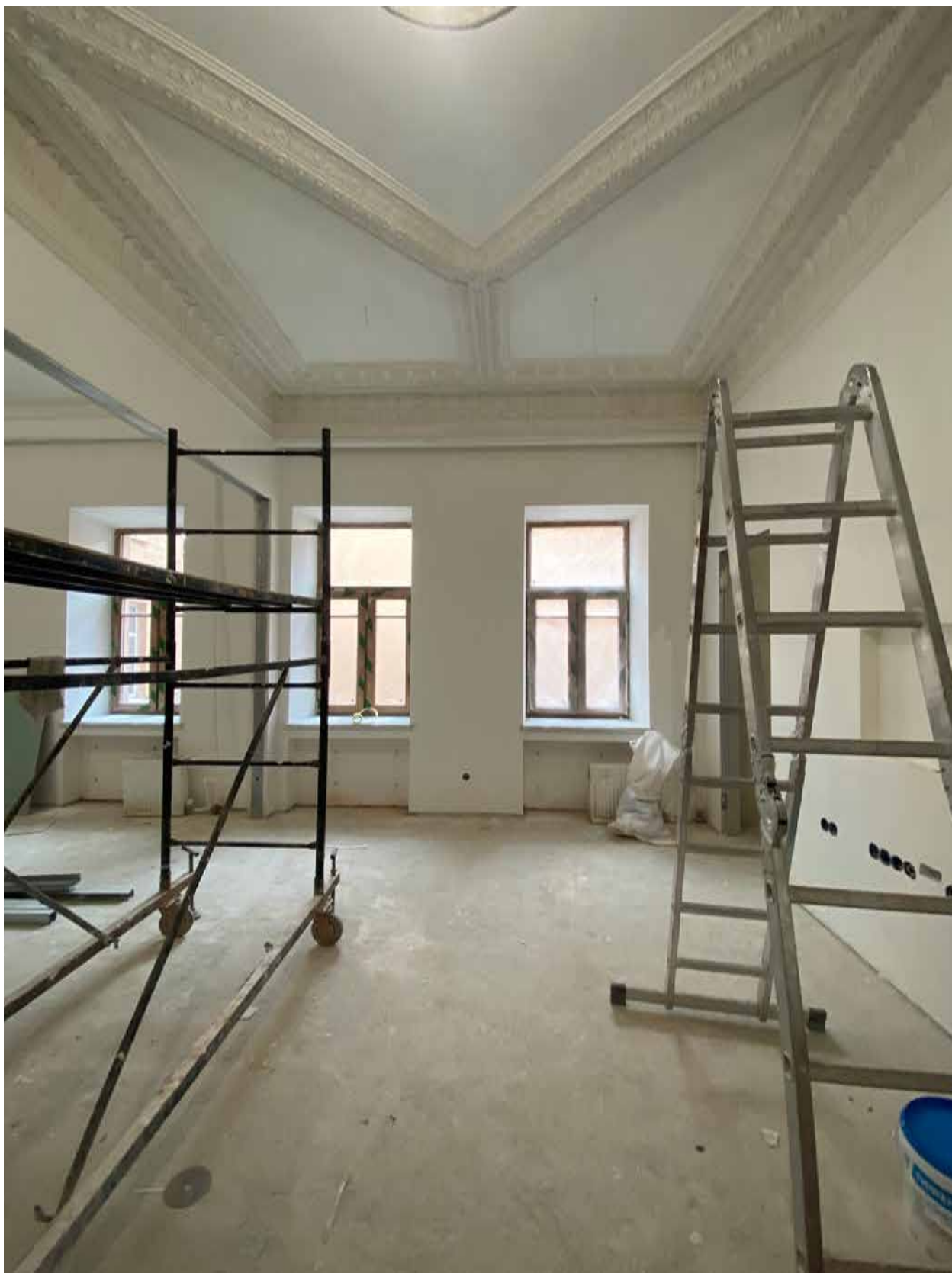
Фото 34. Вид на помещение квартиры № 45 объекта культурного наследия.
