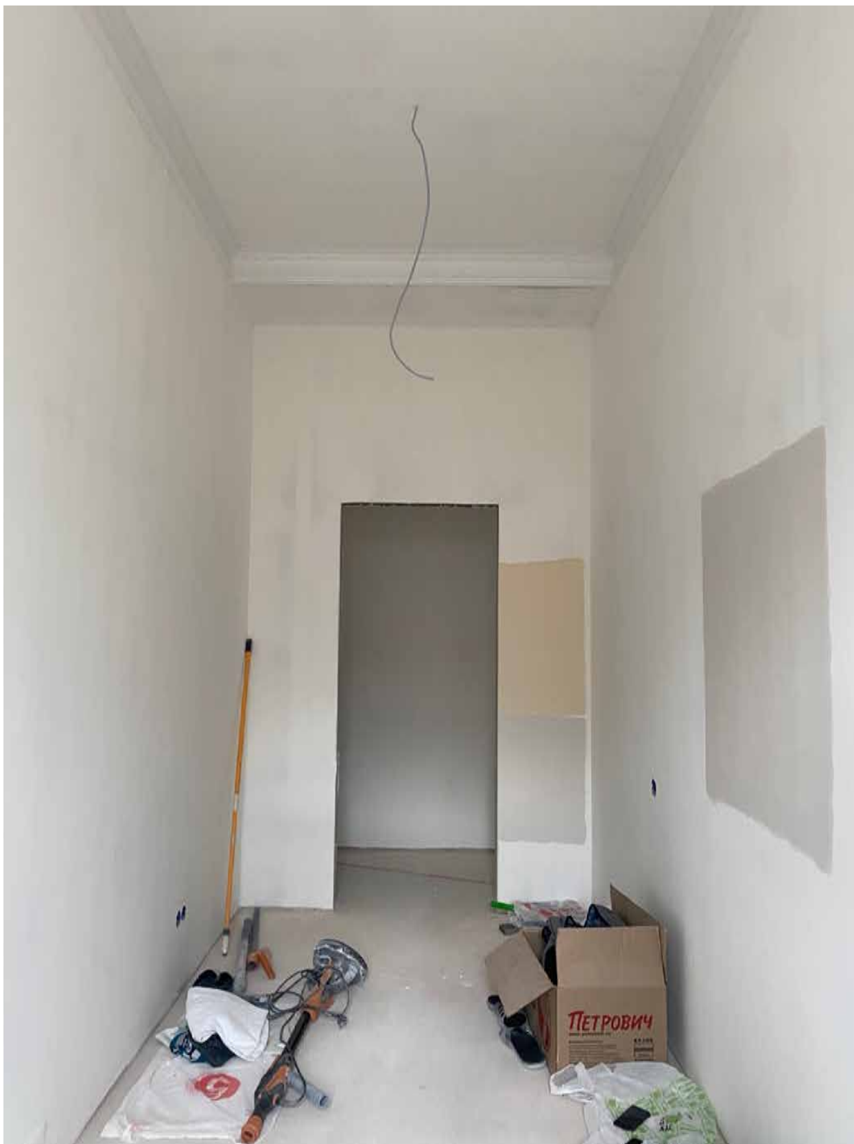
Фото 61. Вид на помещение квартиры № 45 объекта культурного наследия.
