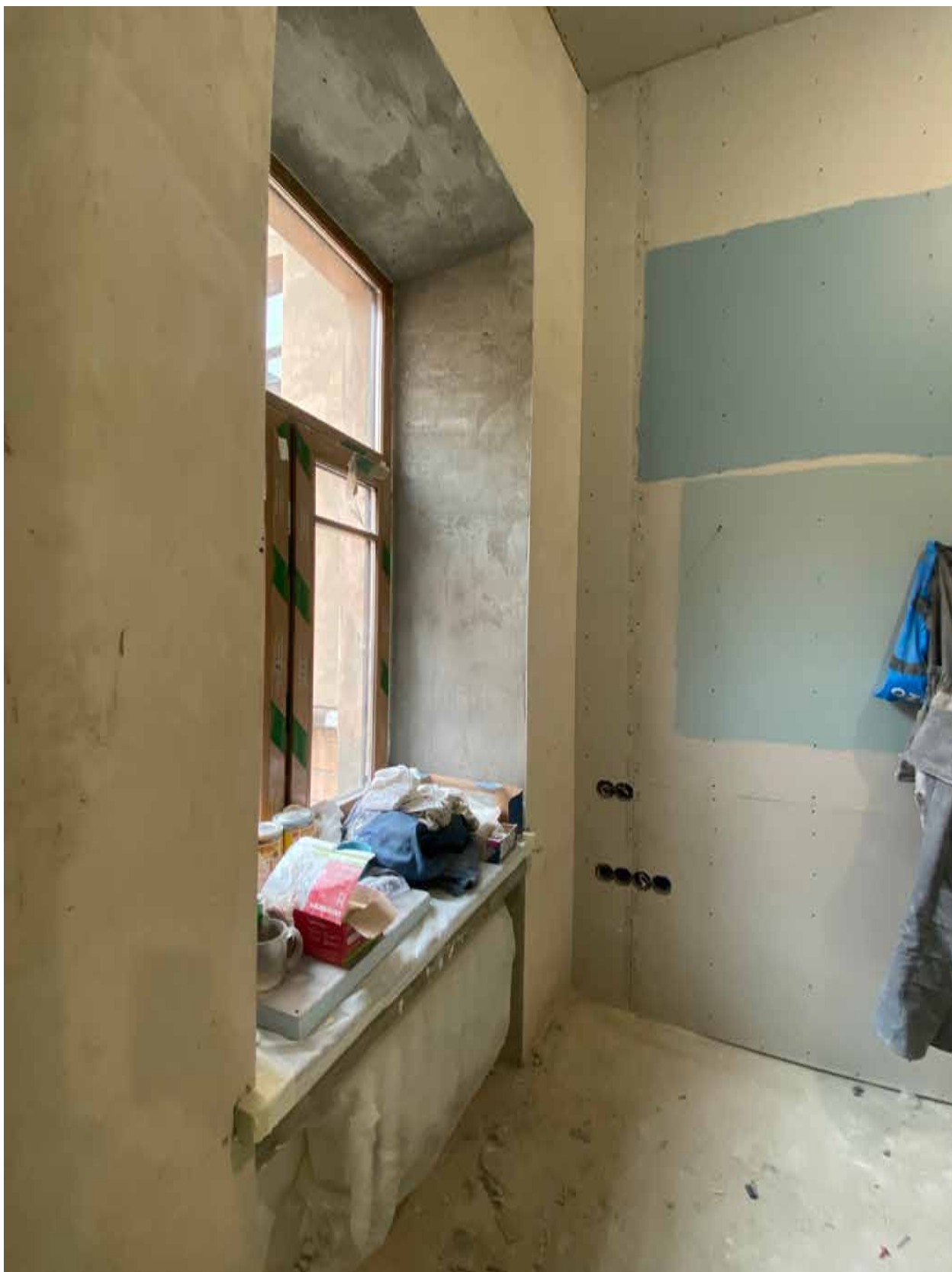
Фото 36. Вид на помещение квартиры № 45 объекта культурного наследия.
