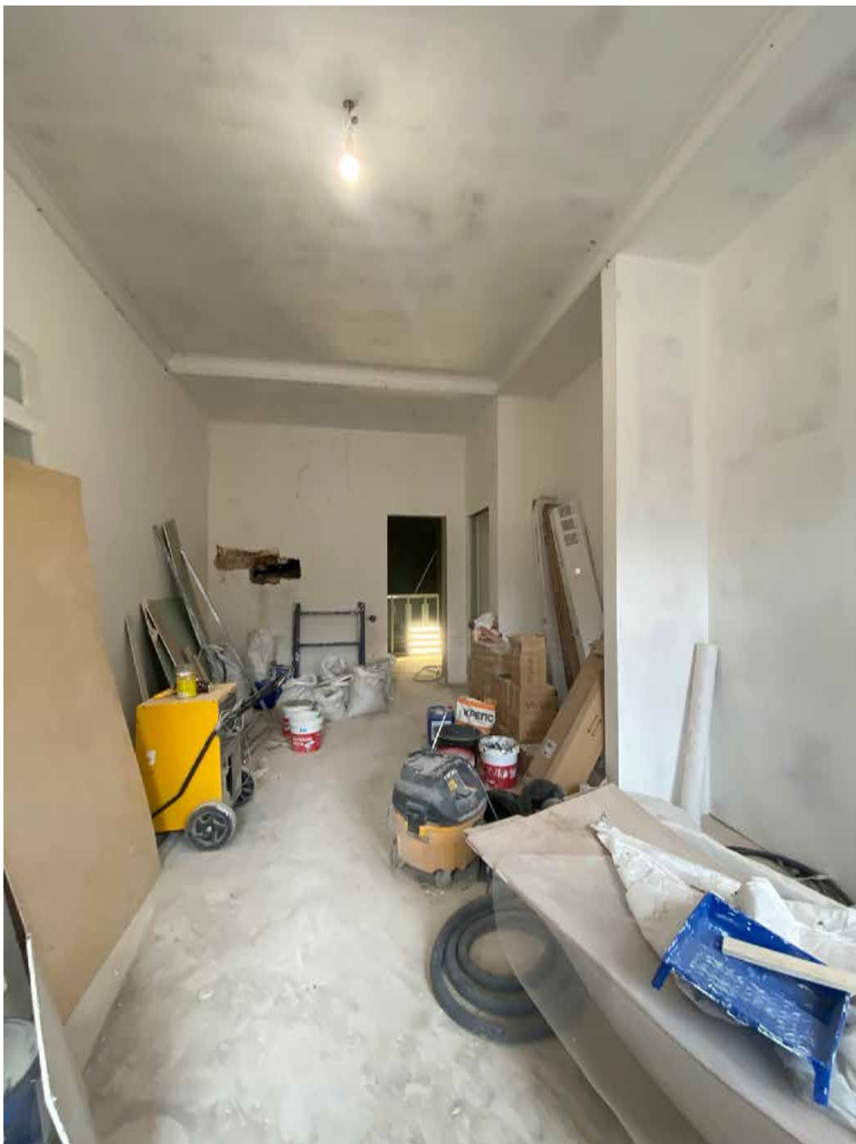
Фото 55. Вид на помещение квартиры № 45 объекта культурного наследия.
