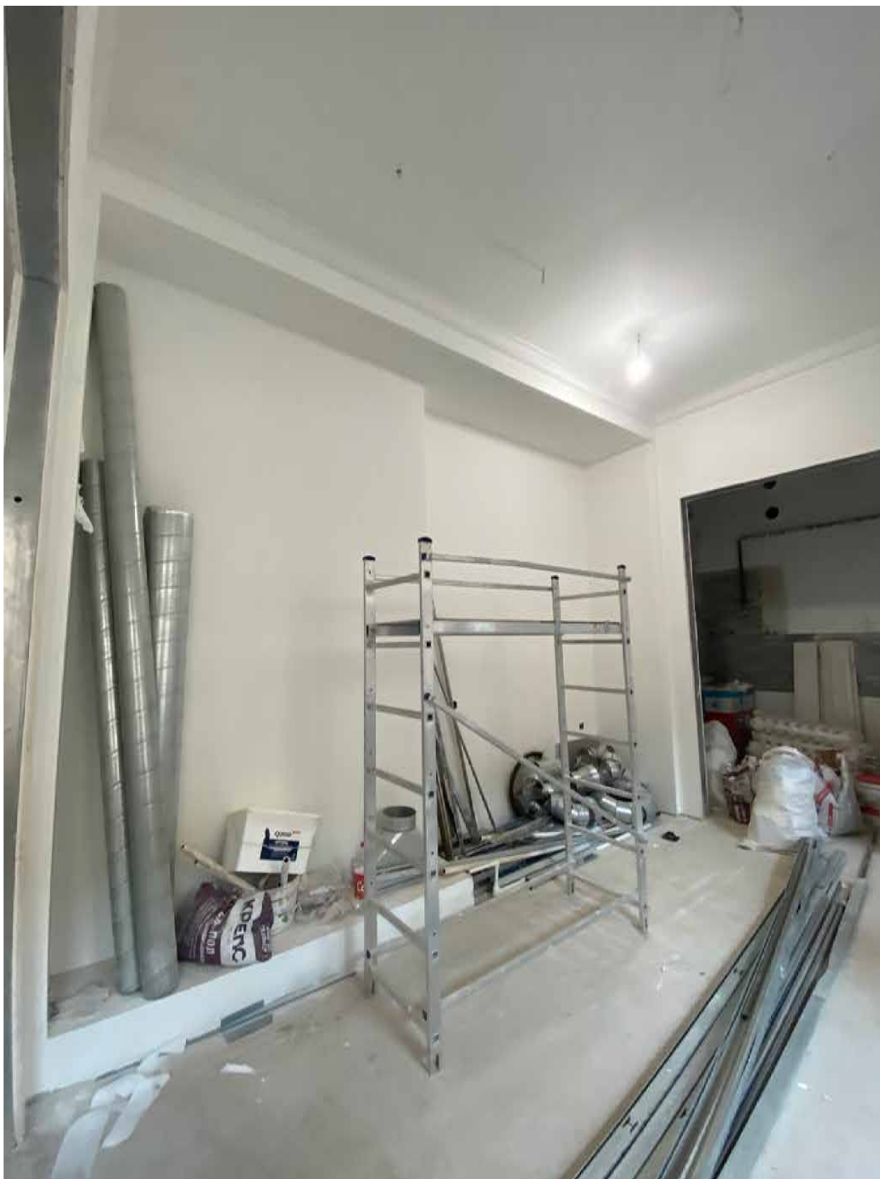
Фото 42. Вид на помещение квартиры № 45 объекта культурного наследия.
