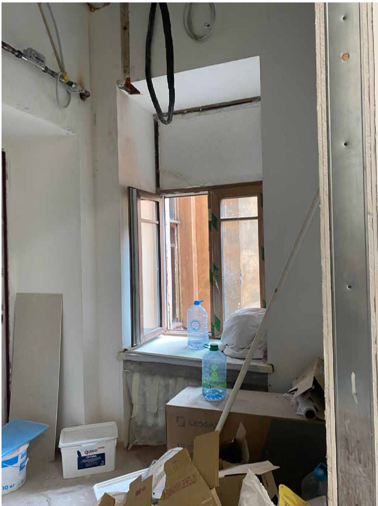
Фото 43. Вид на помещение квартиры № 45 объекта культурного наследия.
