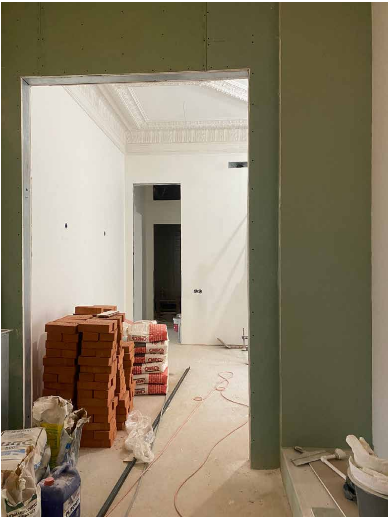
Фото 24. Вид на помещение квартиры № 45 объекта культурного наследия.
