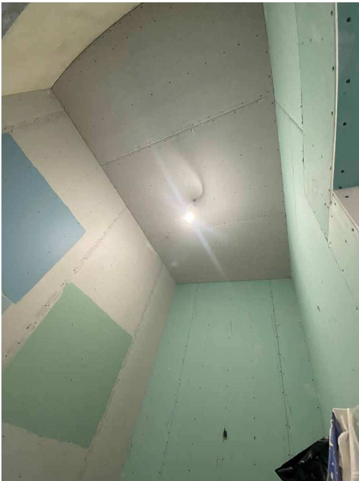
Фото 37. Вид на помещение квартиры № 45 объекта культурного наследия.
