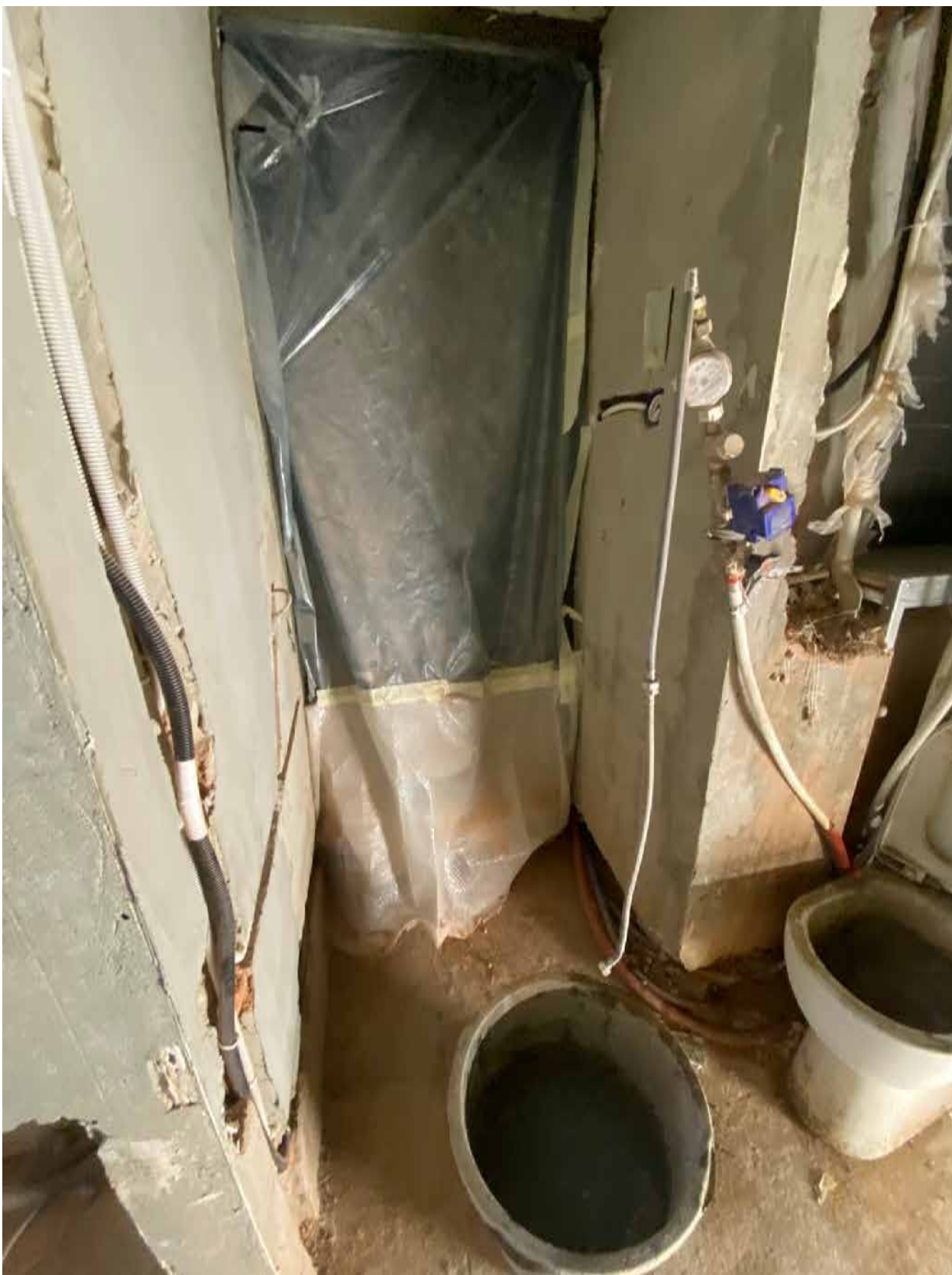
Фото 53. Вид на помещение квартиры № 45 объекта культурного наследия.
