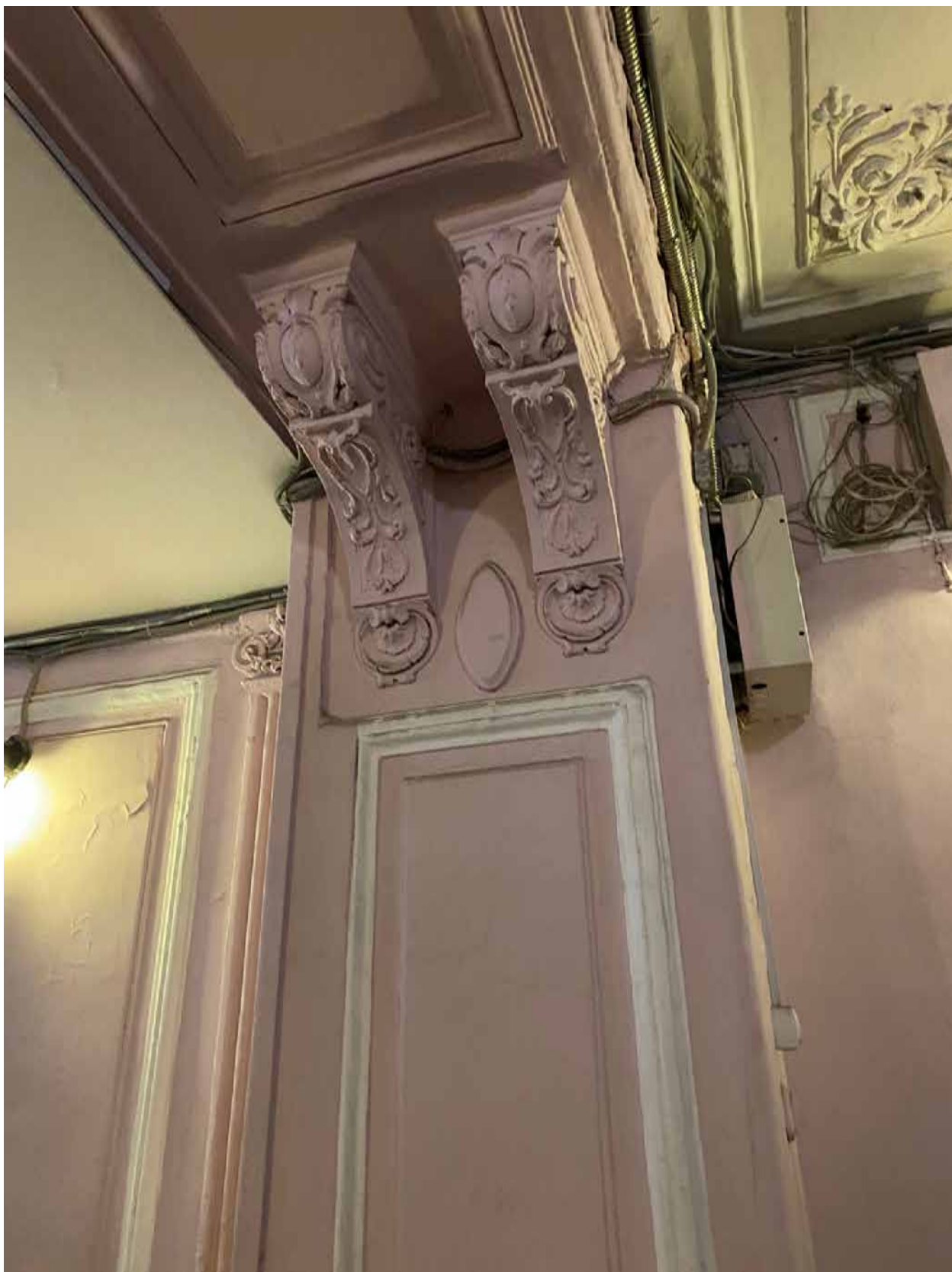
Фото 13. Интерьер парадной объекта культурного наследия.
