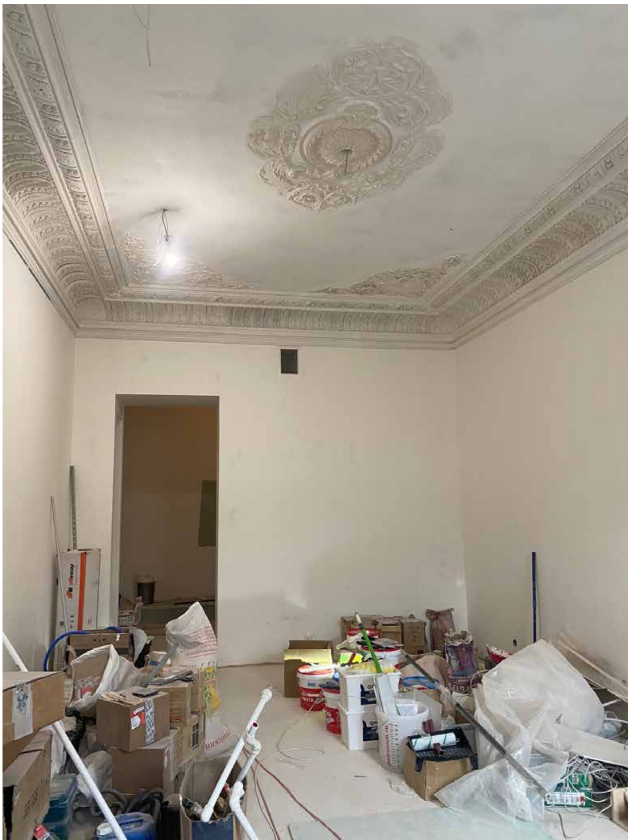
Фото 29. Вид на помещение квартиры № 45 объекта культурного наследия.
