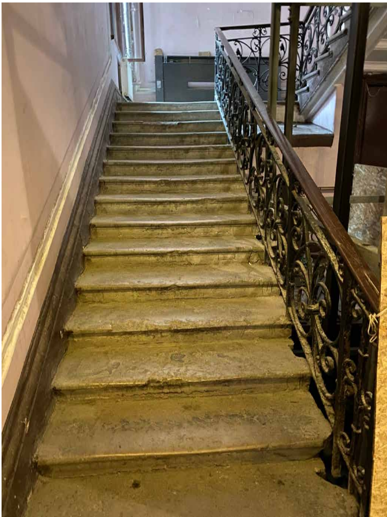
Фото 15. Вид на лестницу, ведущую в квартиру № 45, объекта культурного наследия.
