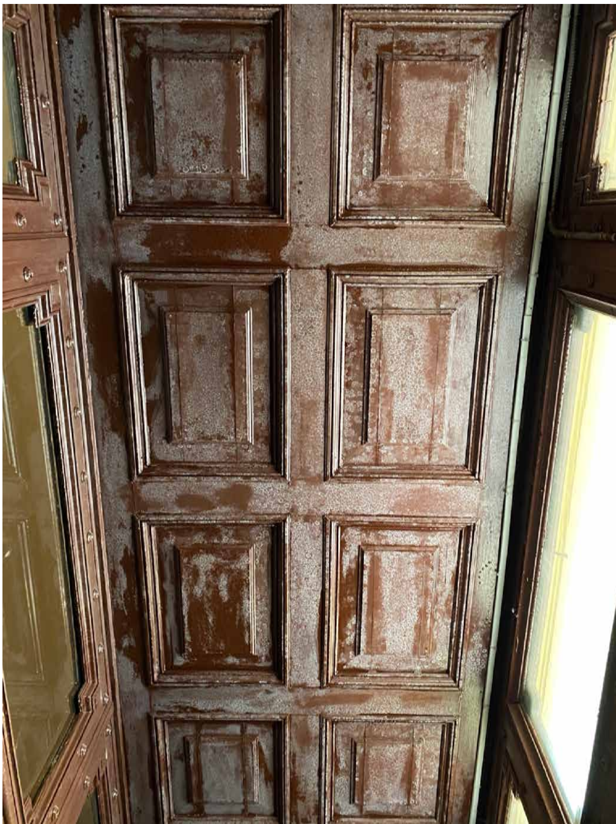
Фото 9. Потолок тамбура объекта культурного наследия.
