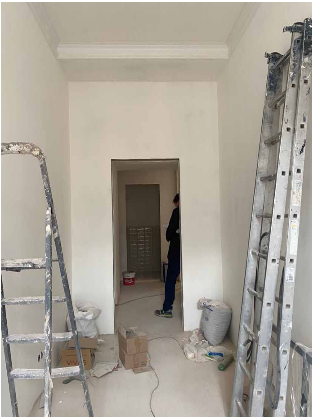
Фото 59. Вид на помещение квартиры № 45 объекта культурного наследия.
