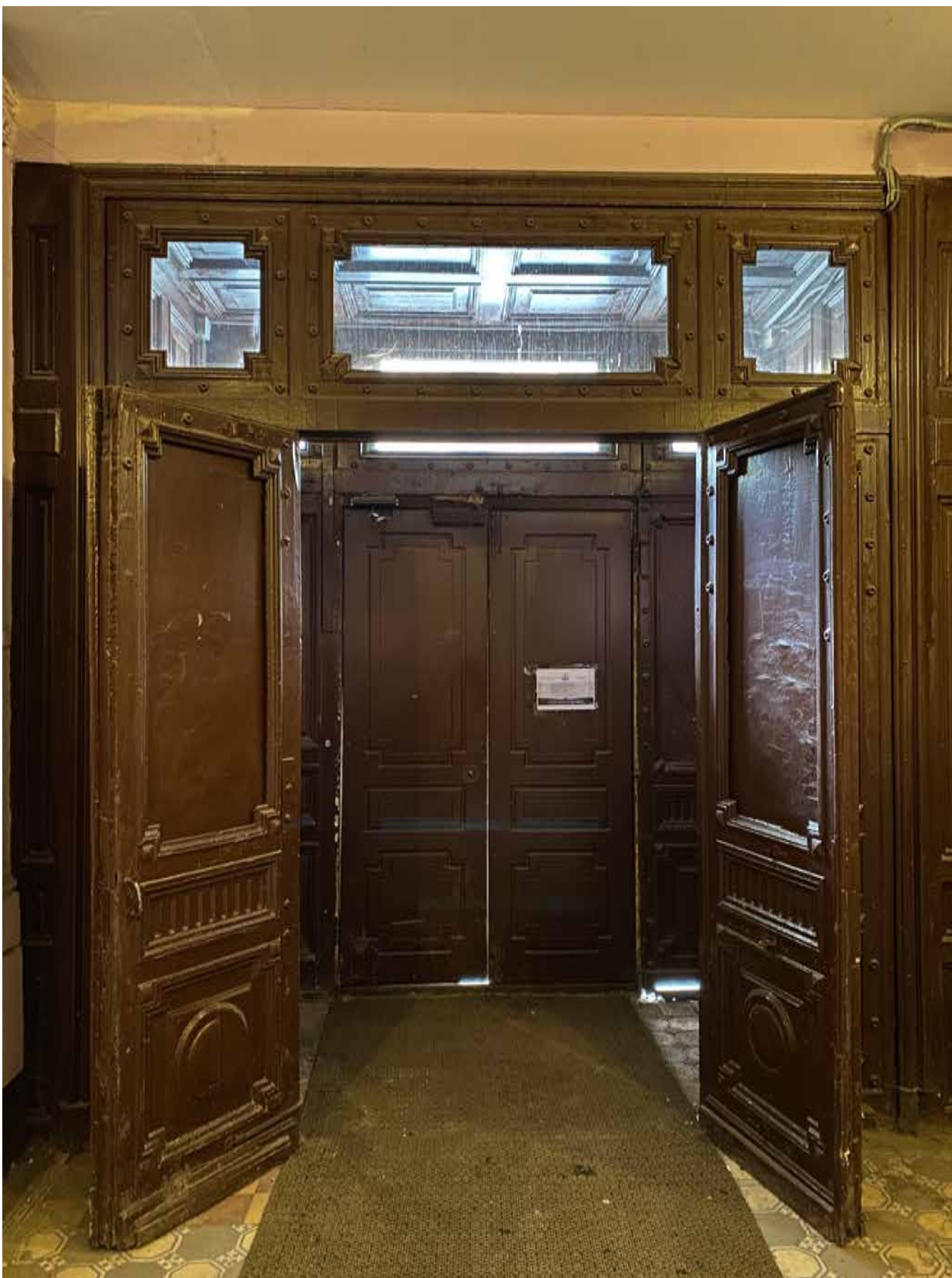
Фото 10. Дверные заполнения парадной объекта культурного наследия.
