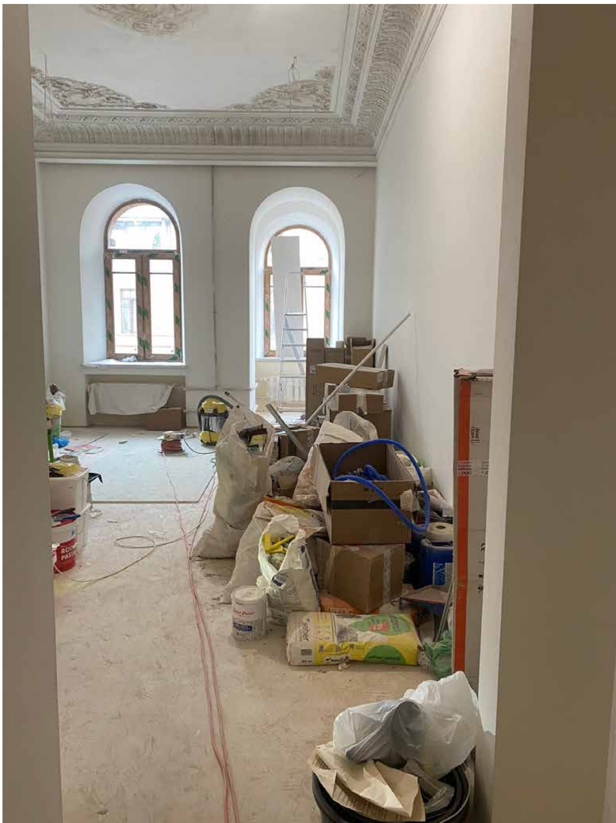
Фото 26. Вид на помещение квартиры № 45 объекта культурного наследия.
