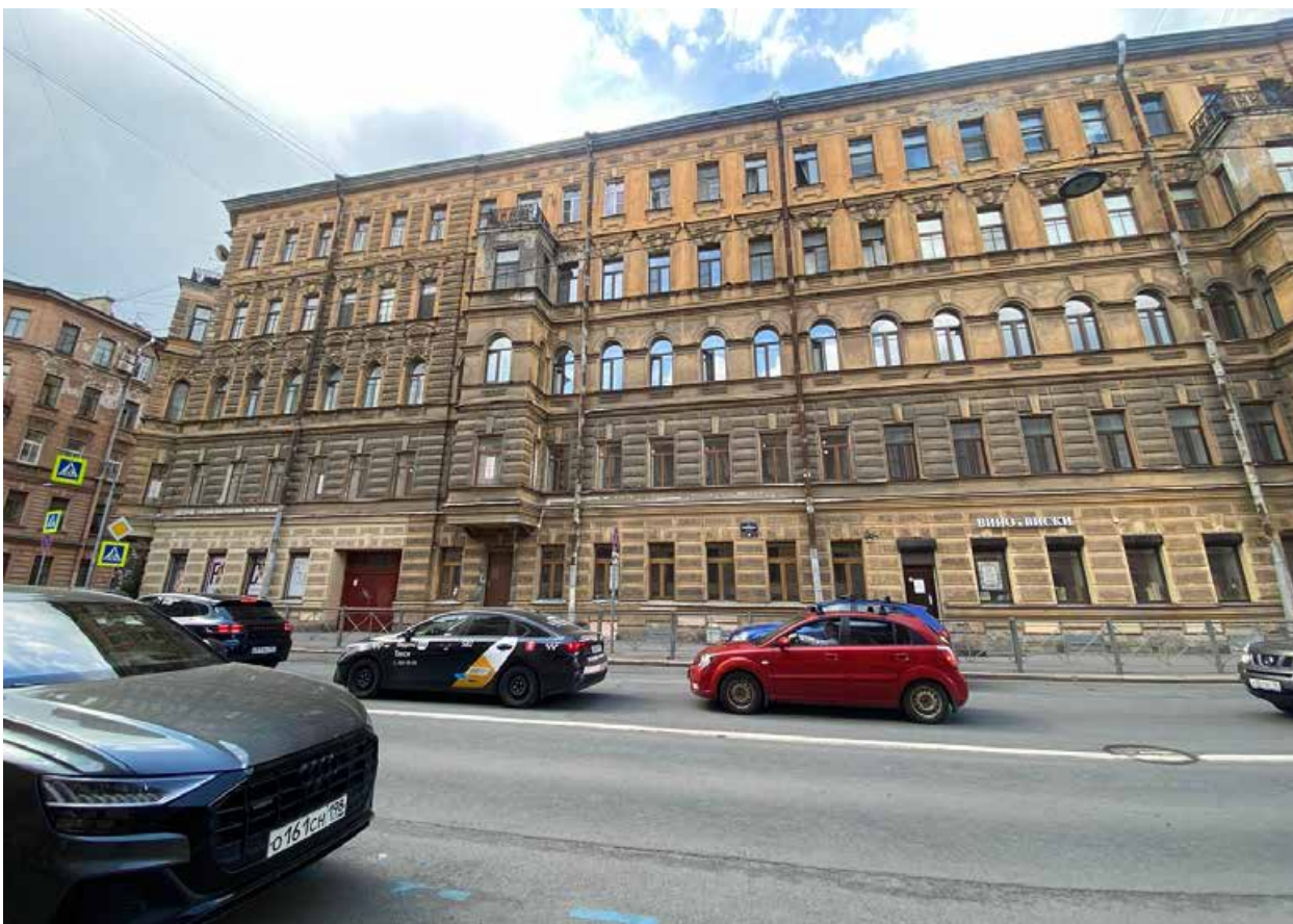
Фото 5. Общий вид фасада объекта культурного наследия по улице Радищева.
