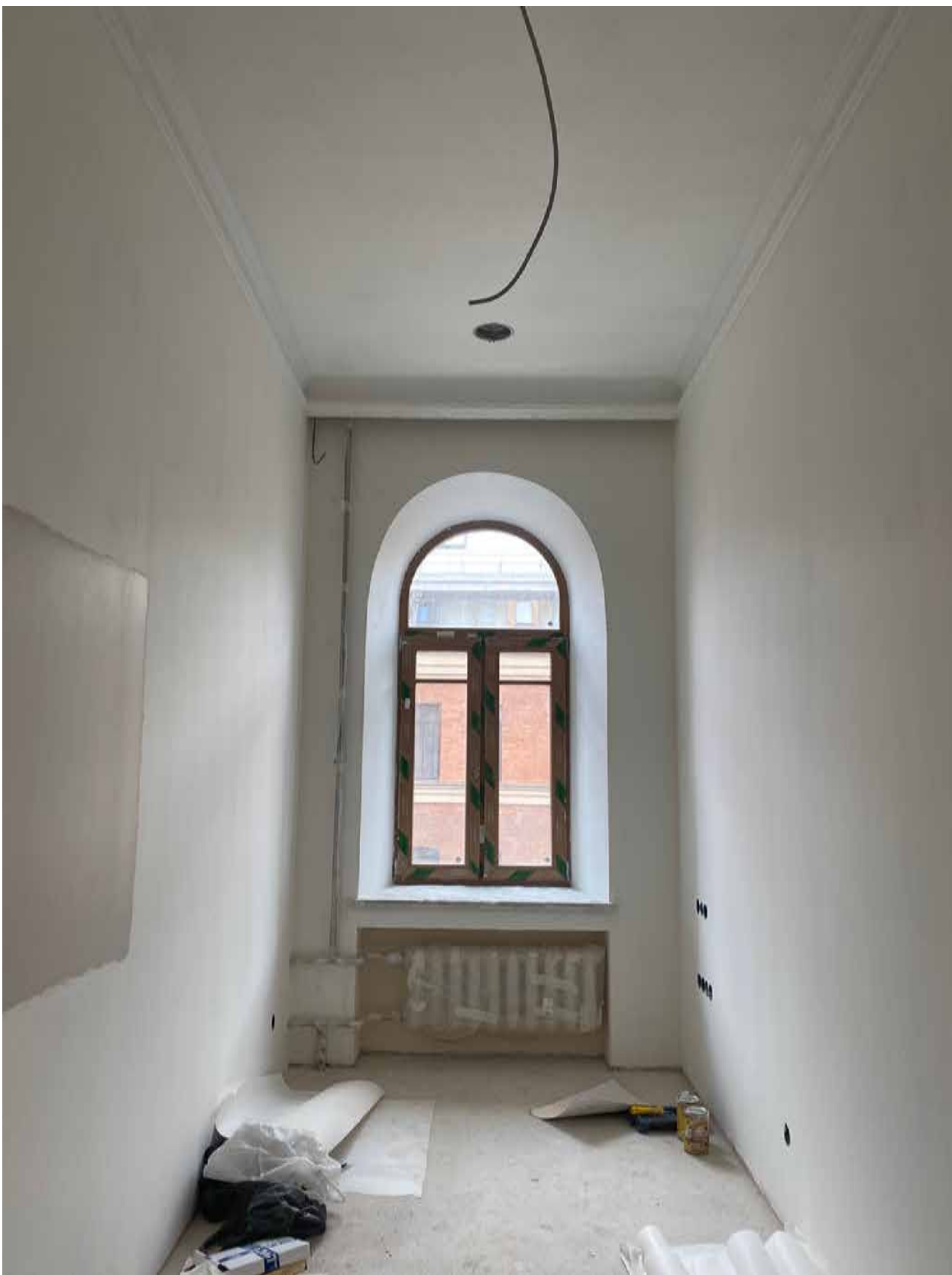
Фото 60. Вид на помещение квартиры № 45 объекта культурного наследия.
