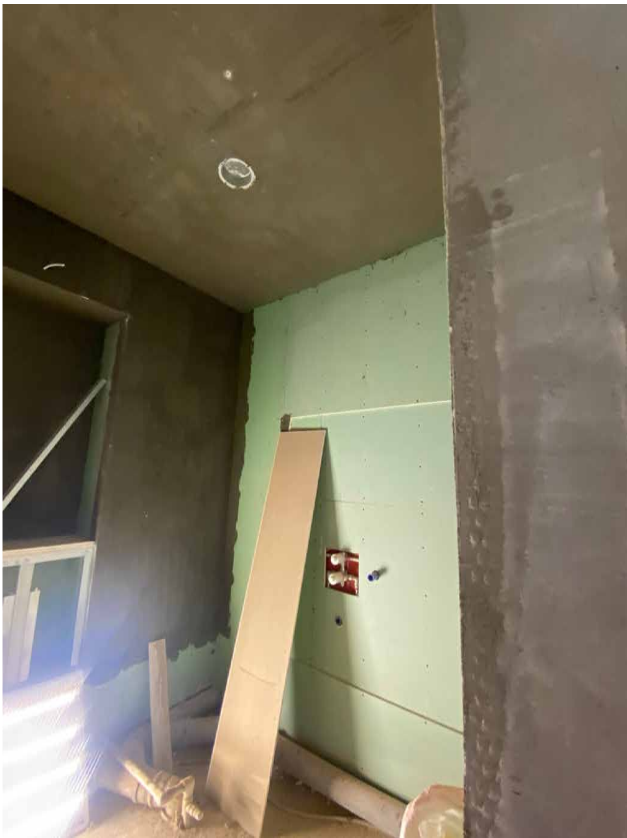
Фото 52. Вид на помещение квартиры № 45 объекта культурного наследия.
