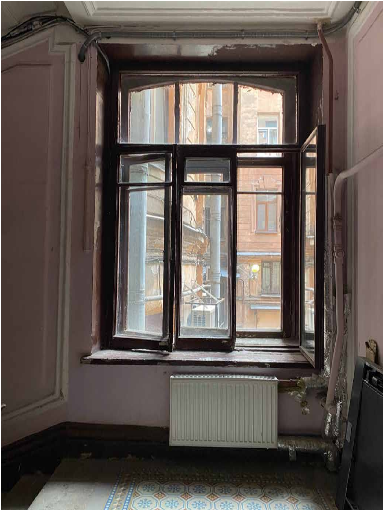
Фото 18. Вид на оконное заполнение лестницы, ведущей в квартиру № 45 объекта культурного наследия.
