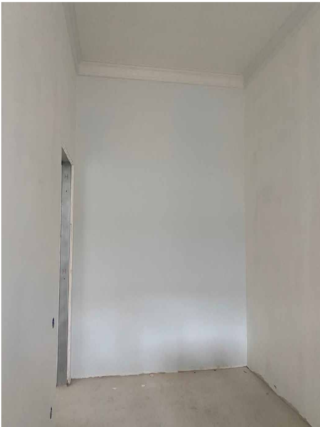
Фото 63. Вид на помещение квартиры № 45 объекта культурного наследия.
