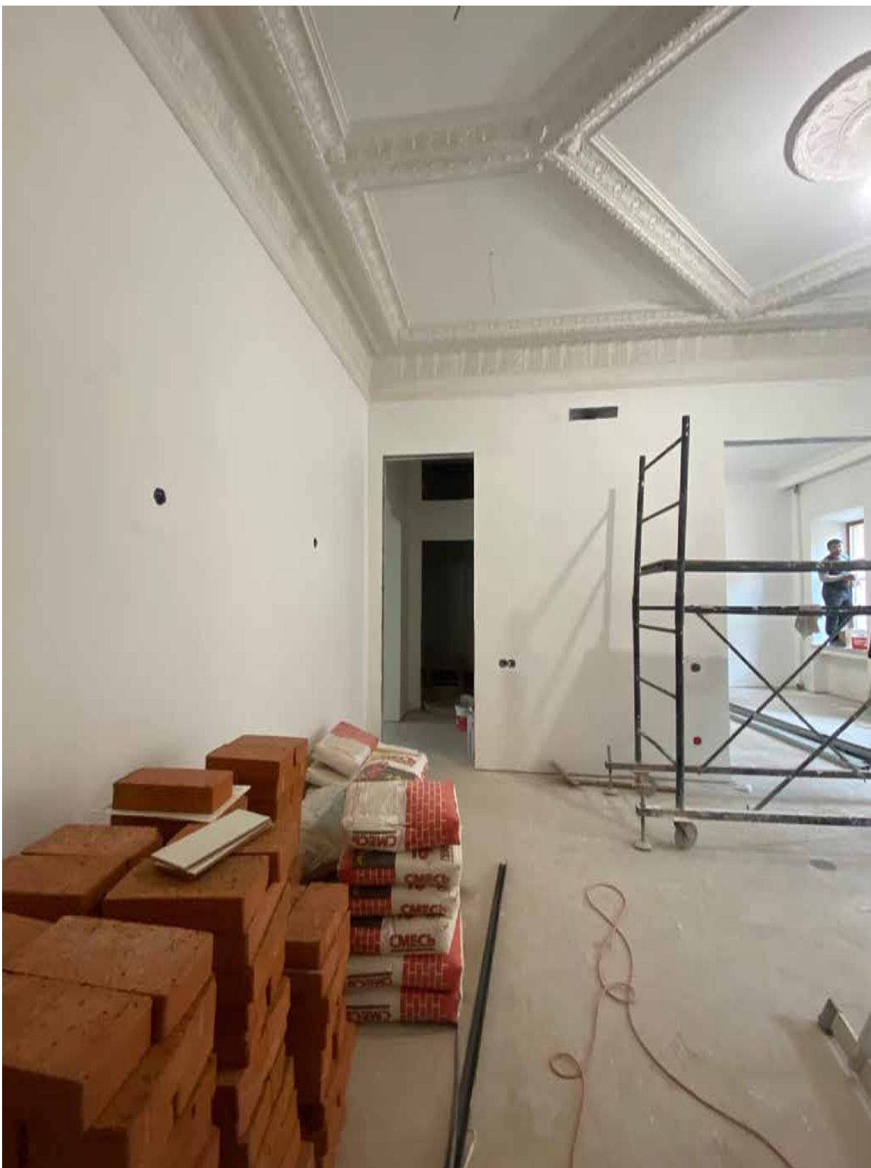
Фото 33. Вид на помещение квартиры № 45 объекта культурного наследия.
