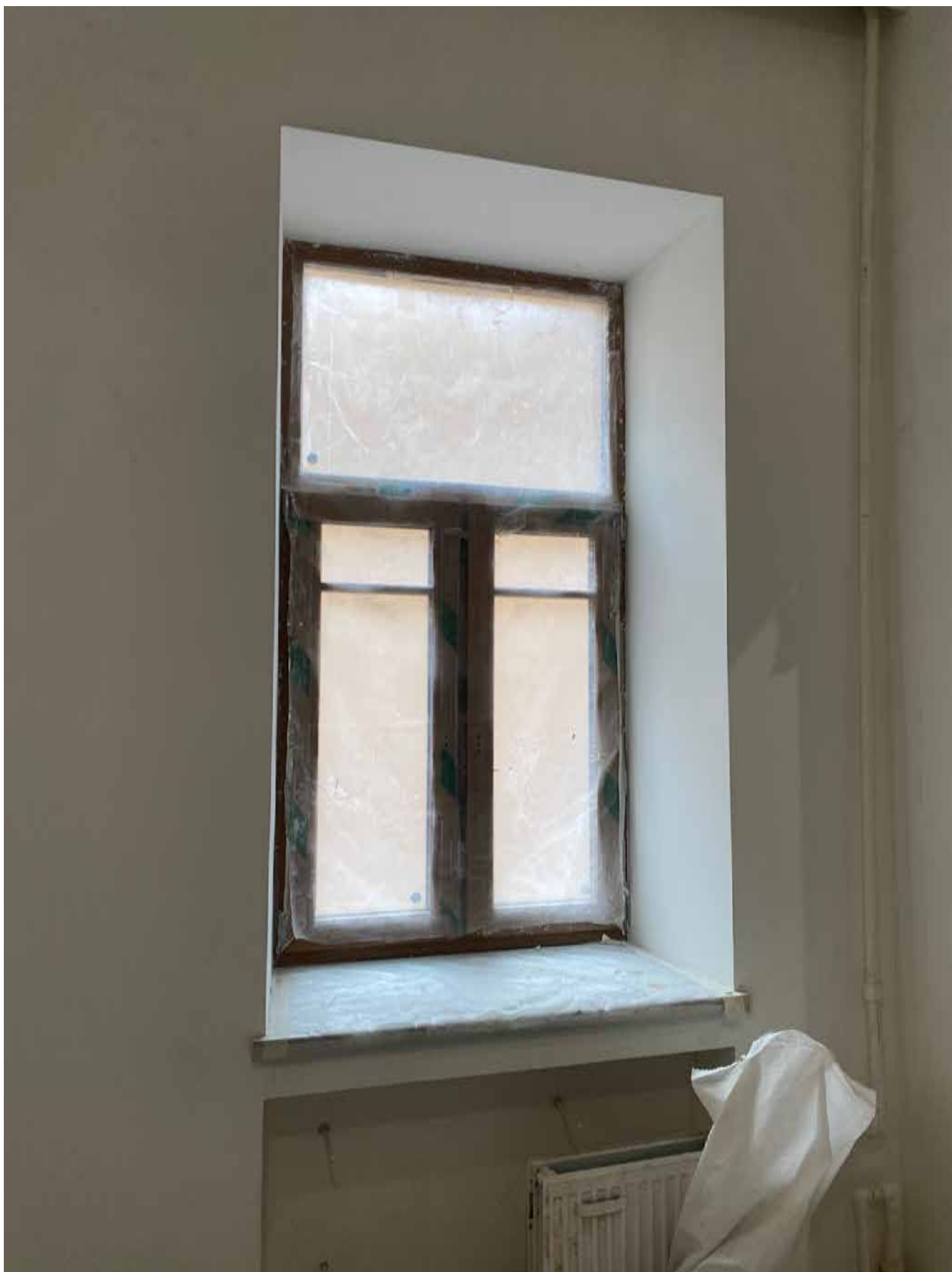
Фото 35. Вид на оконное заполнение помещения квартиры № 45 объекта культурного наследия.
