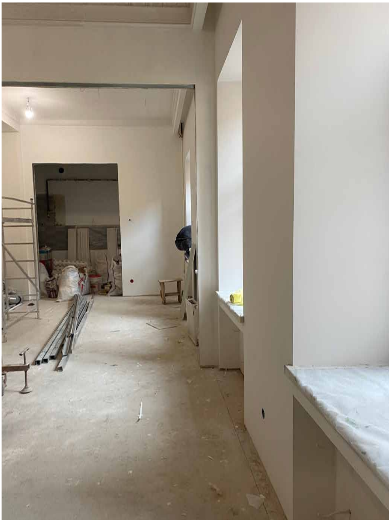
Фото 40. Вид на помещение квартиры № 45 объекта культурного наследия.
