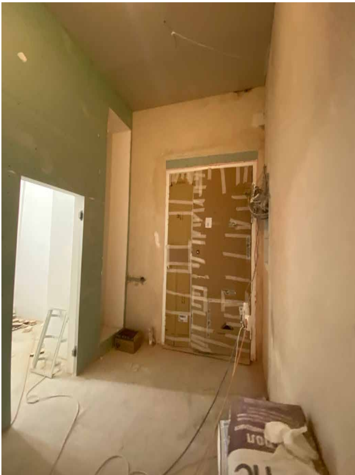
Фото 31. Вид на помещение квартиры № 45 объекта культурного наследия.
