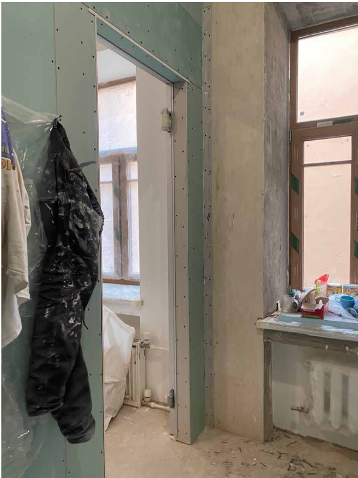
Фото 39. Вид на помещение квартиры № 45 объекта культурного наследия.
