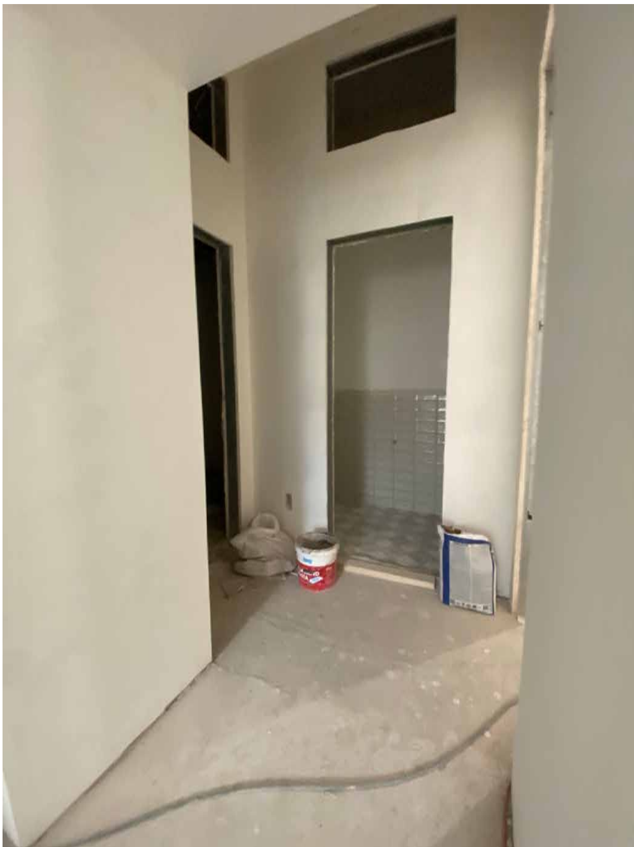
Фото 65. Вид на помещение квартиры № 45 объекта культурного наследия.
