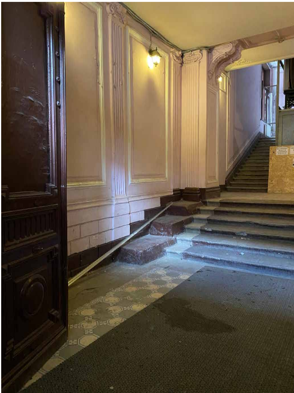
Фото 12. Интерьер парадной объекта культурного наследия.
