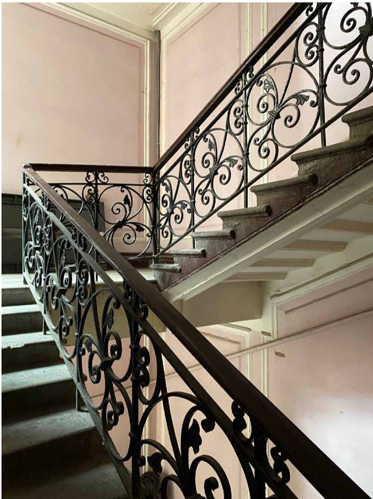
Фото 20. Вид на лестницу, ведущую в квартиру № 45, объекта культурного наследия.
