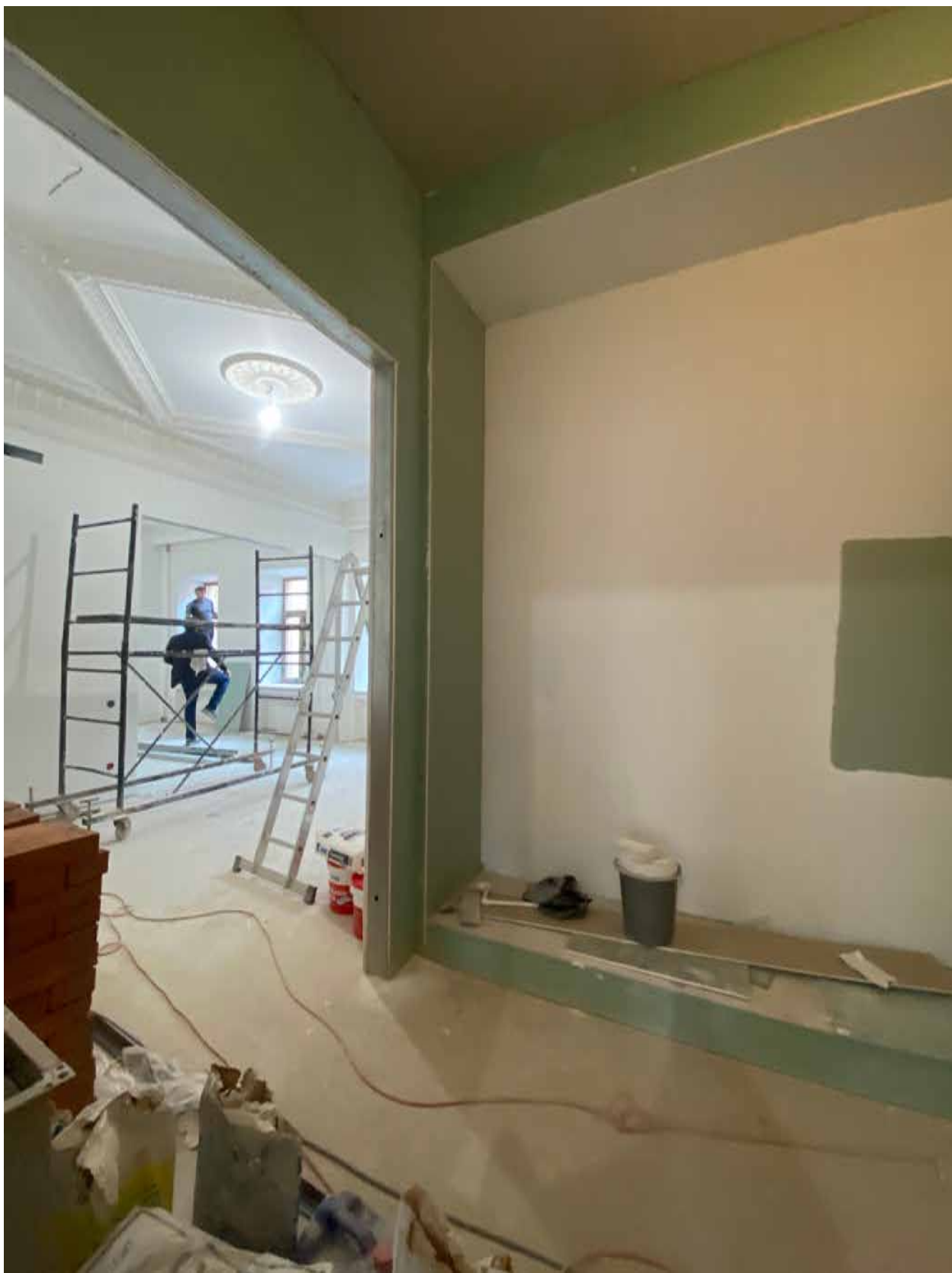
Фото 32. Вид на помещение квартиры № 45 объекта культурного наследия.
