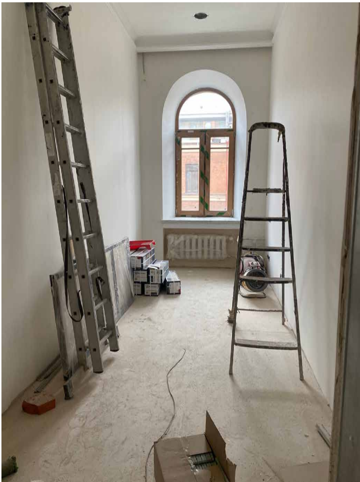
Фото 58. Вид на помещение квартиры № 45 объекта культурного наследия.
