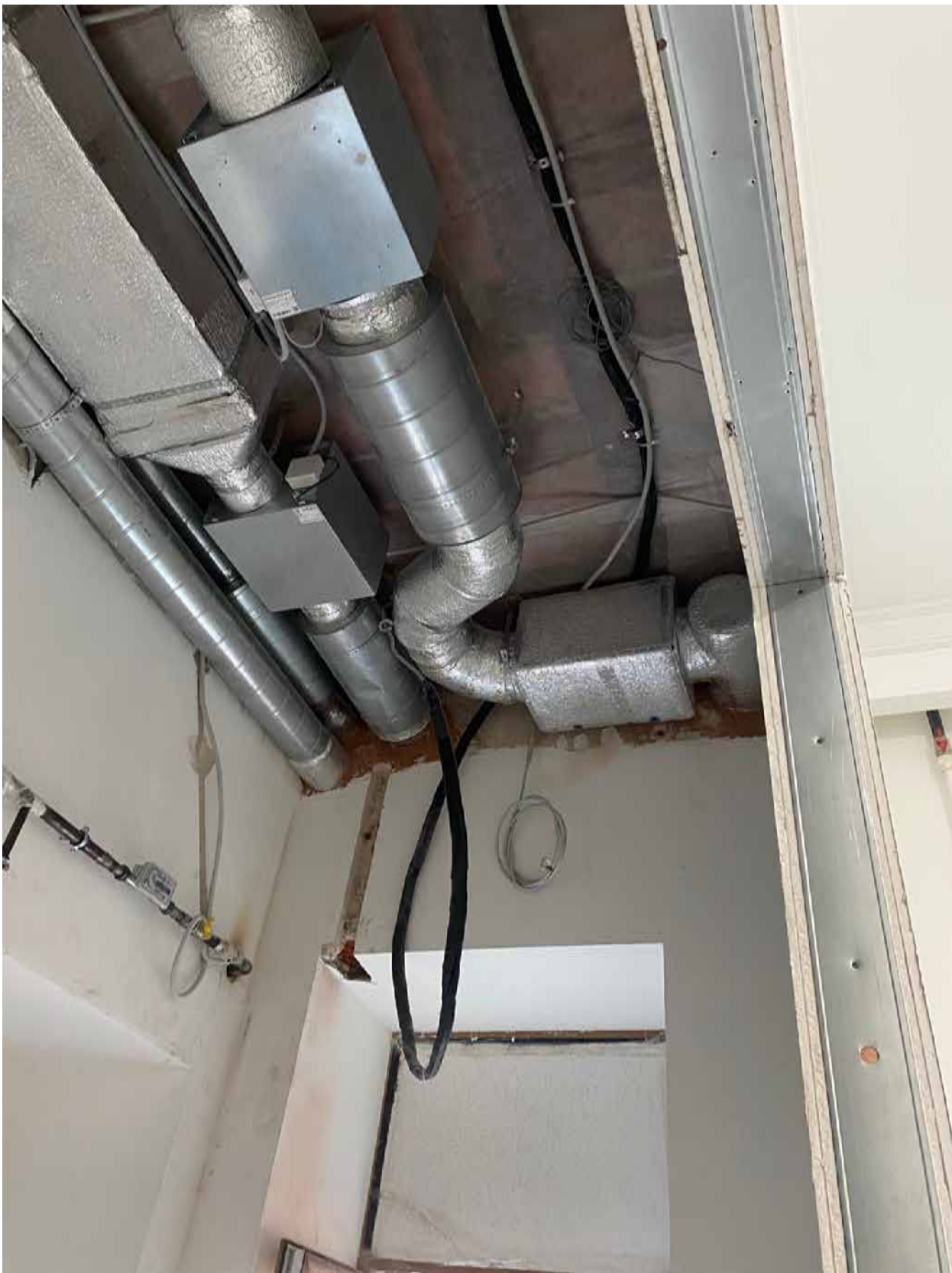
Фото 44. Вид на помещение квартиры № 45 объекта культурного наследия.
