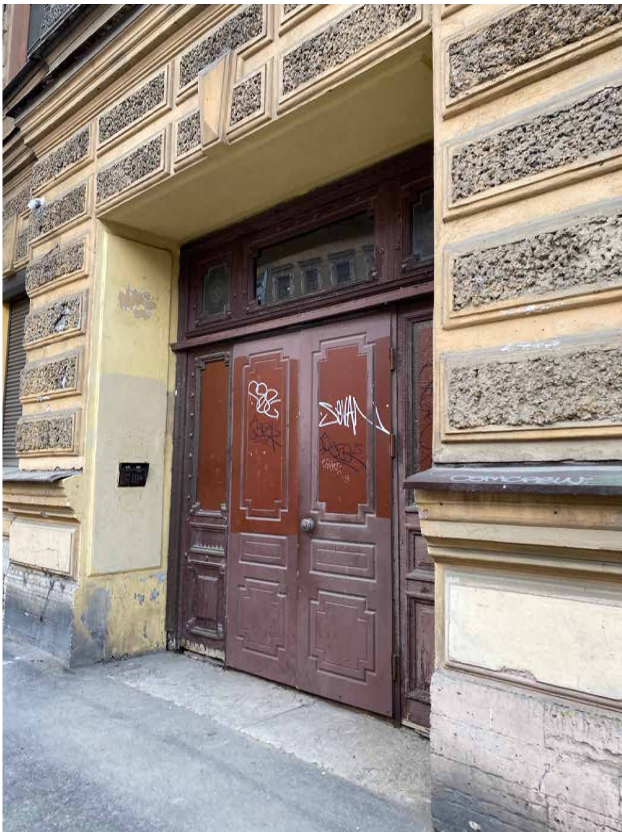
Фото 7. Вид на дверное заполнение парадной объекта культурного наследия по улице Радищева.
