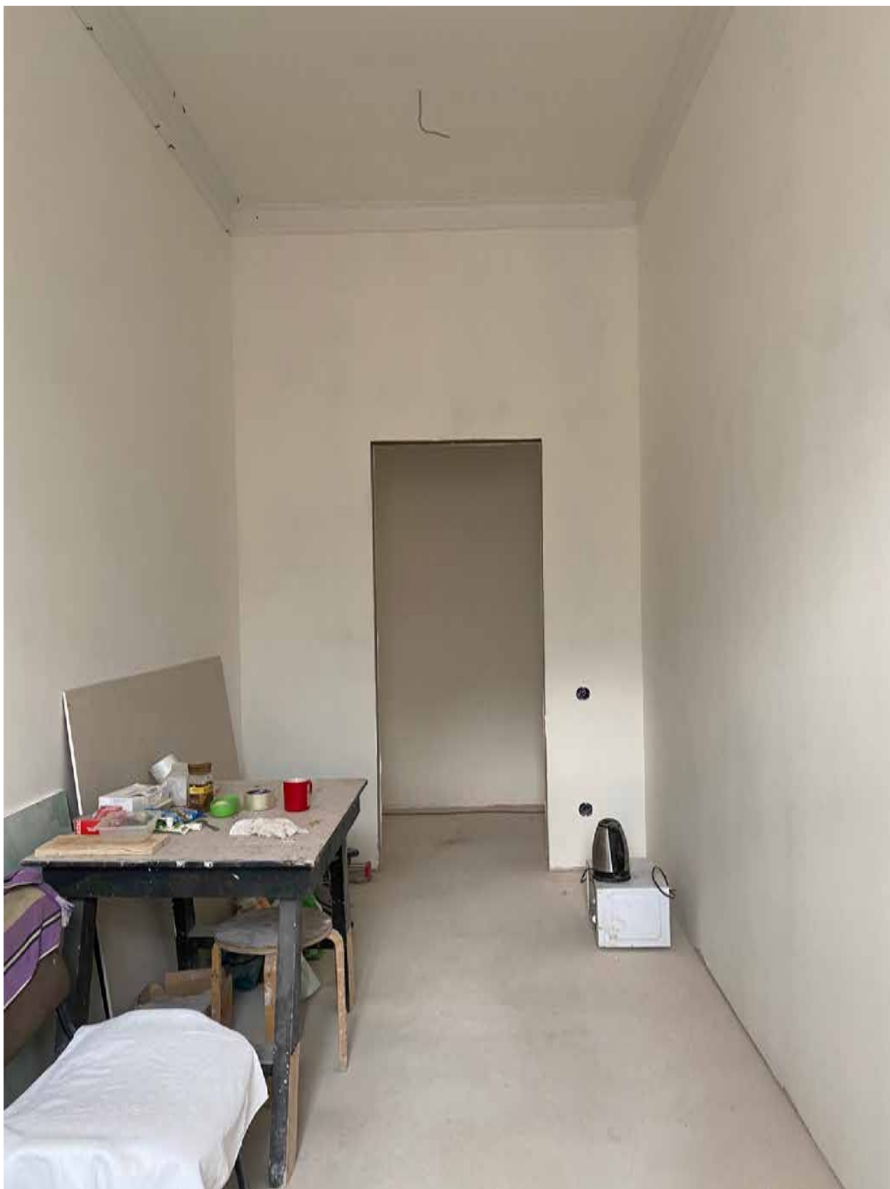
Фото 57. Вид на помещение квартиры № 45 объекта культурного наследия.
