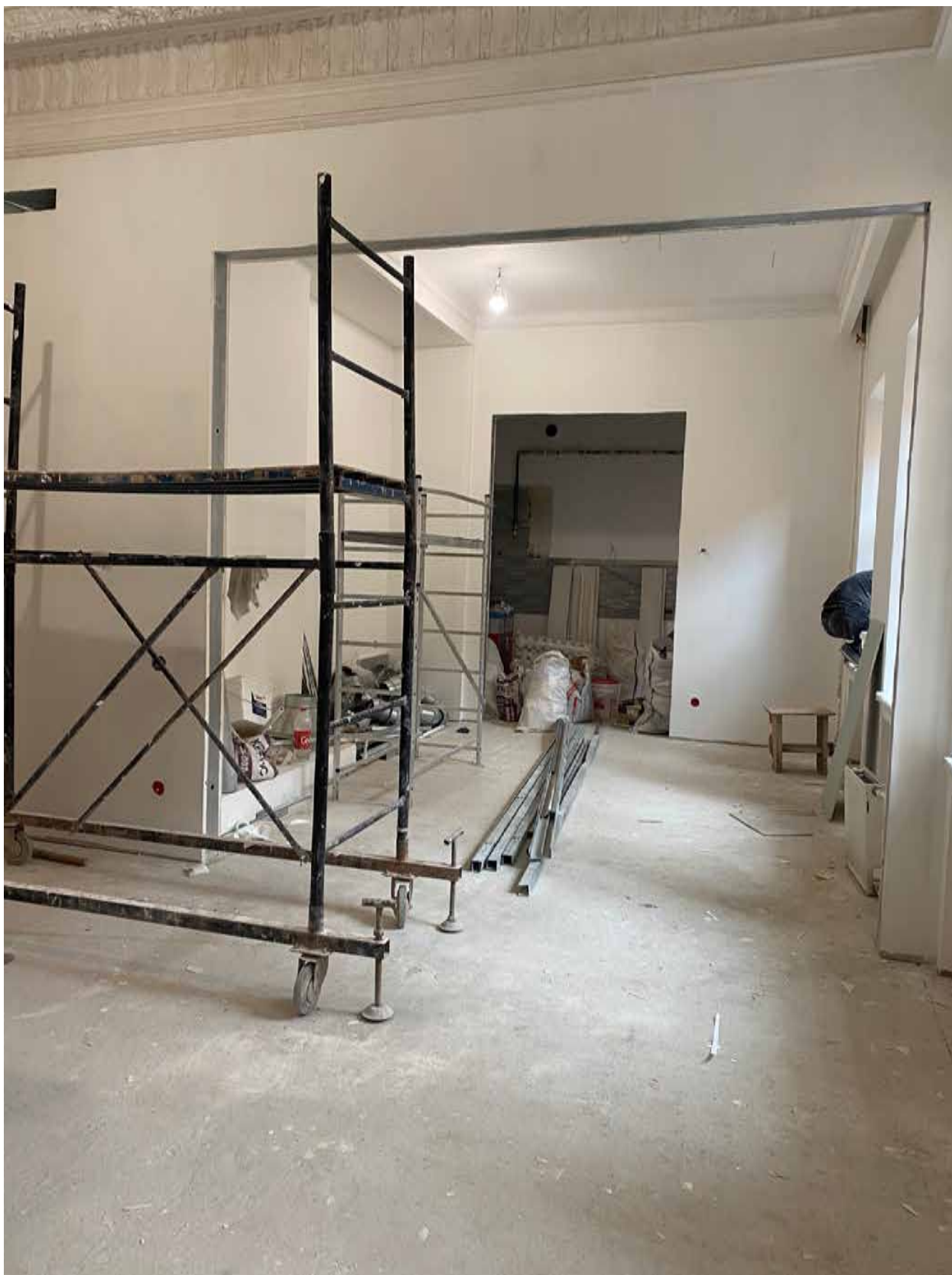
Фото 41. Вид на помещение квартиры № 45 объекта культурного наследия.
