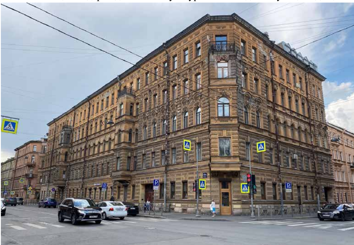
Фото 6. Общий вид объекта культурного наследия с перекрестка улицы Радищева и Виленского переулка.
