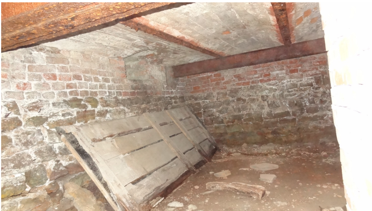
Фото 17. Западная часть подвала. Капитальные конструкции. Дата фотофиксации: 14.06.23
