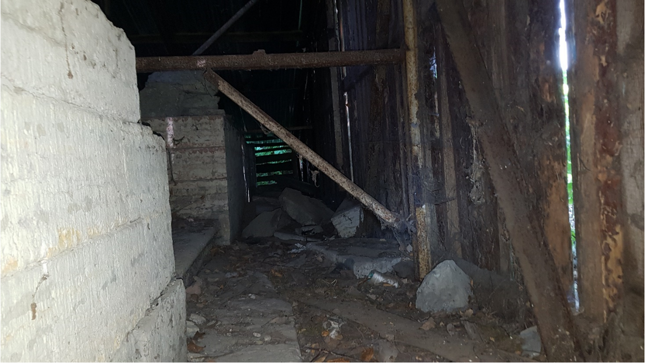
Фото 5. Вид на известняковый цоколь и устои лестницы главного фасада.
