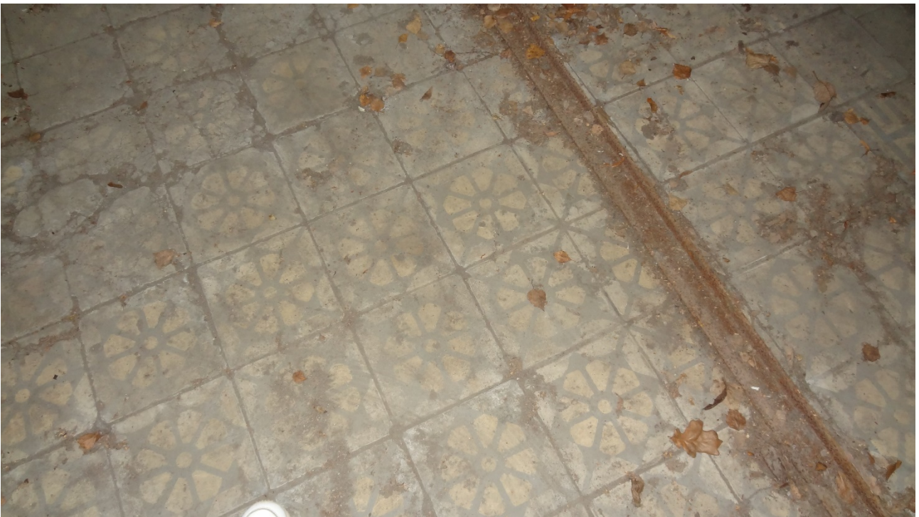
Фото 10. Фрагмент сохранившейся метлахской плитки пола в уровне первого этажа в северной части. Дата фотофиксации: 14.06.23
