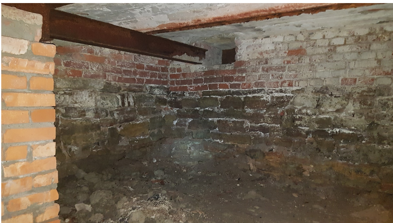
Фото 20. Юго-западный угол. Дата фотофиксации: 14.06.23
