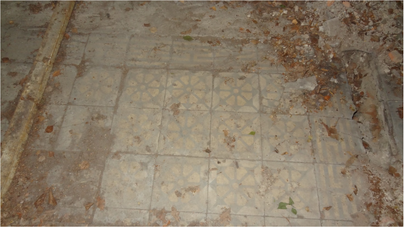
Фото 9. Фрагмент сохранившейся метлахской плитки пола в уровне первого этажа в южной части. Дата фотофиксации: 14.06.23
