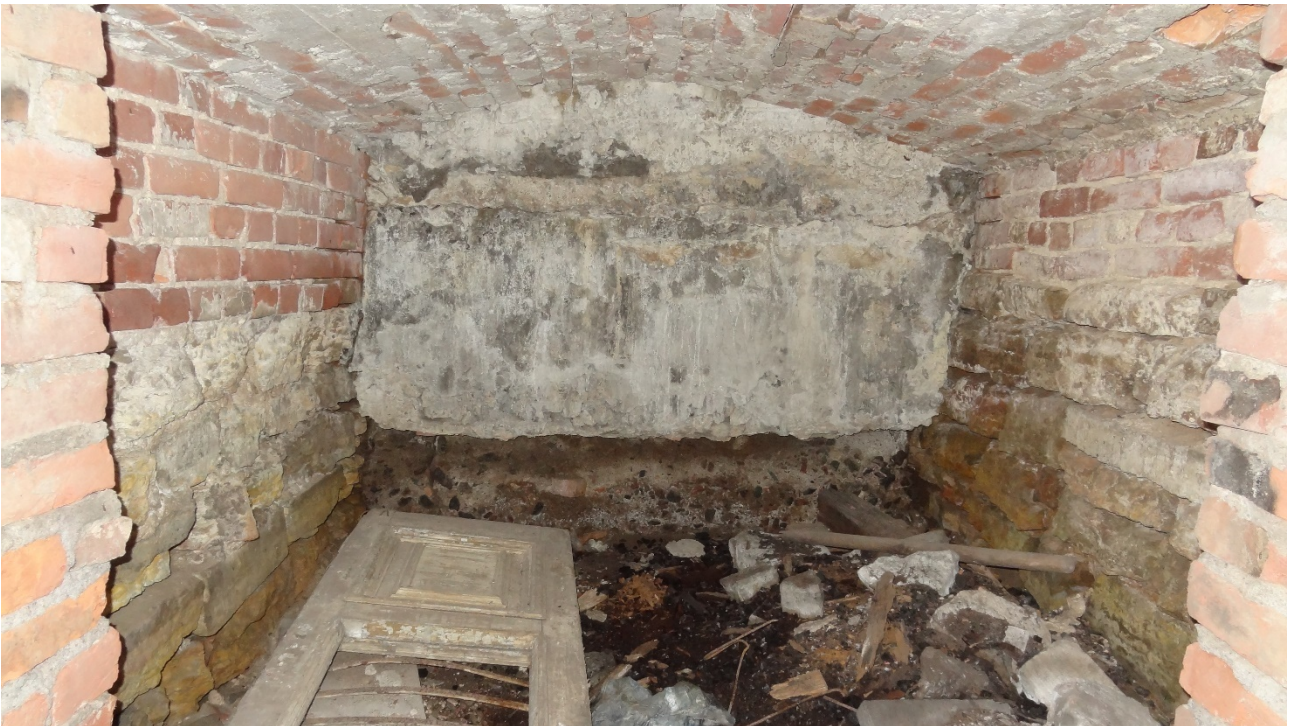
Фото 12. Фрагмент подвального помещения с пологим сводом. Дата фотофиксации: 14.06.23
