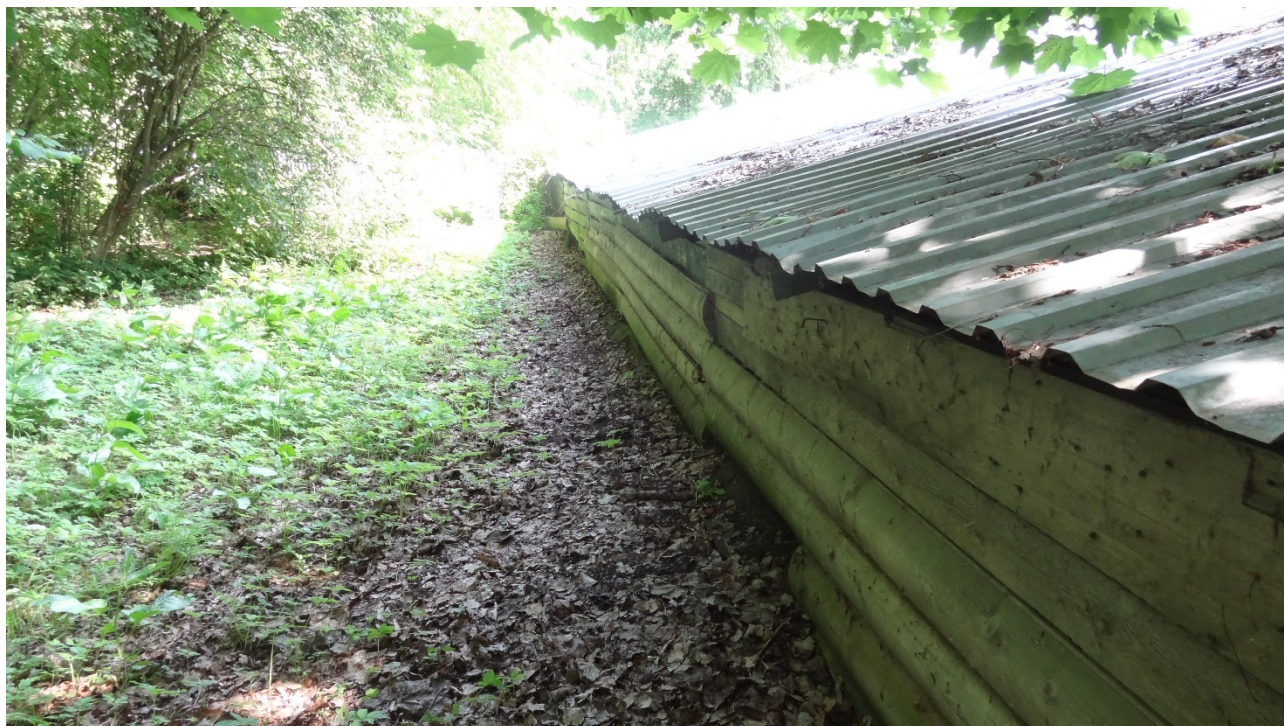
Фото 2. Цоколь Гауптвахты под временным навесом. Западный фасад.
