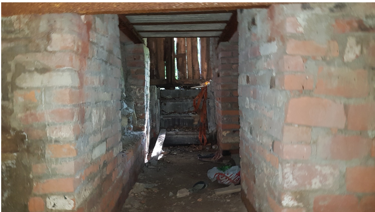
Фото 14. Вид на бетонную лестницу входа в подвал. Дата фотофиксации: 14.06.23
