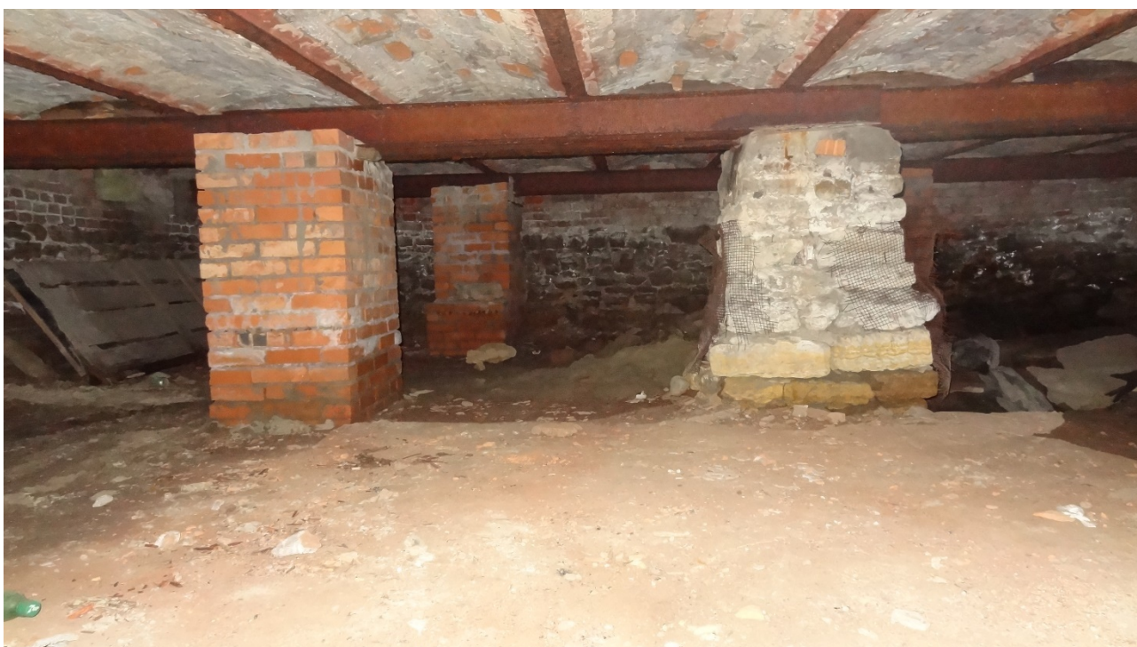
Фото 18. Северная часть подвала. Общий вид. Дата фотофиксации: 14.06.23
