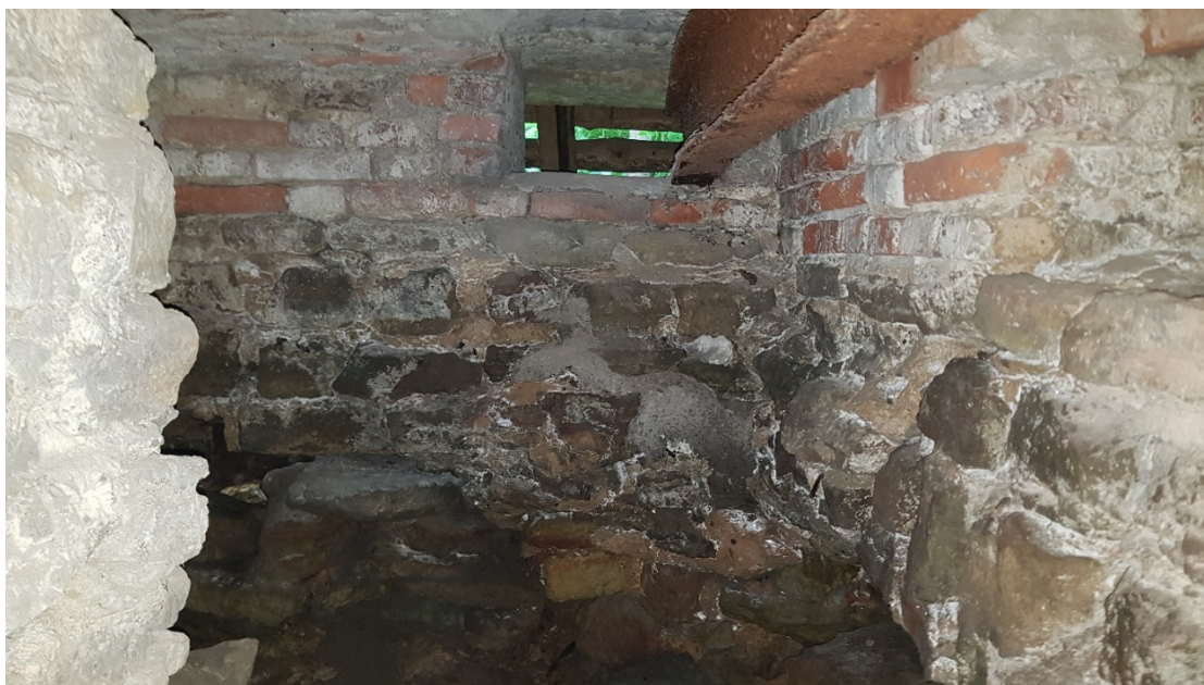
Фото 23. Конструкции фундамента. Дата фотофиксации: 14.06.23
