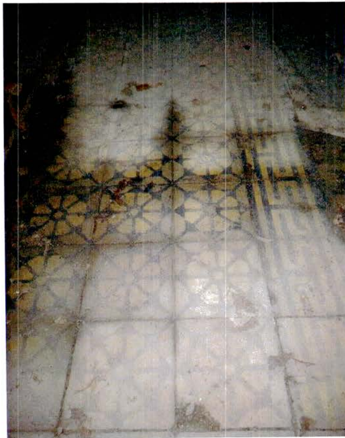
3. Фрагмент сохранившегося напольного покрытия. Метлахская плитка.
