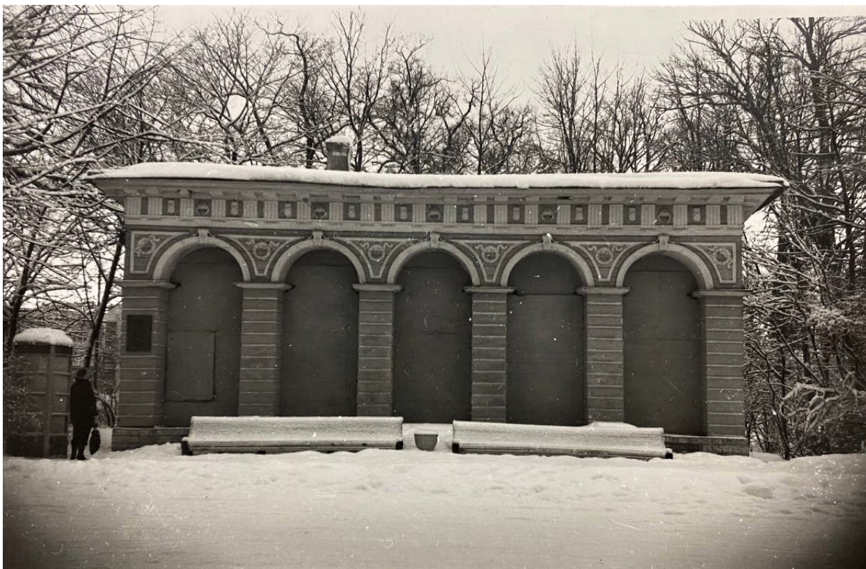
34. Общий вид елагинской Гауптвахты (лицевой фасад), 1970-е гг. ЦГАКФФД СПб Бр 69574.
