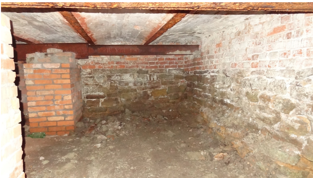
Фото 22. Северо-восточный угол подвала. Дата фотофиксации: 14.06.23
