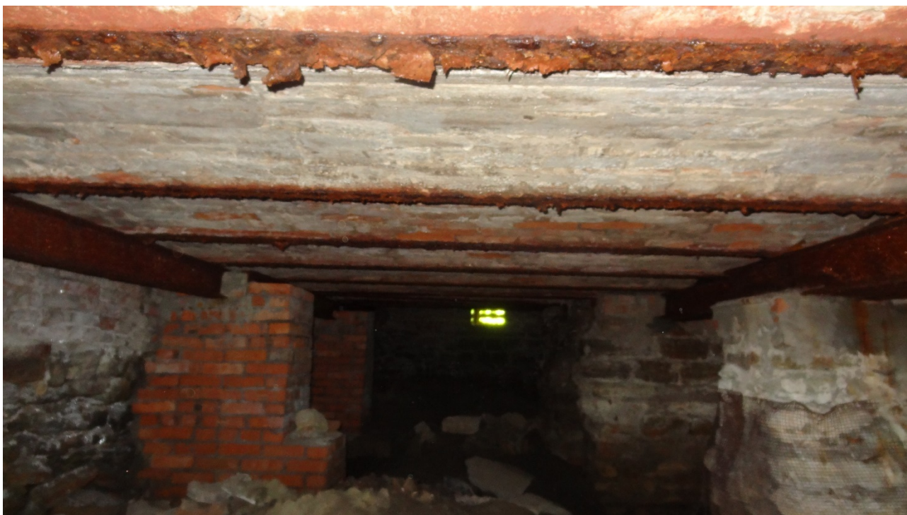
Фото 21. Общий вид на восточную часть подвала. Прусские своды.
