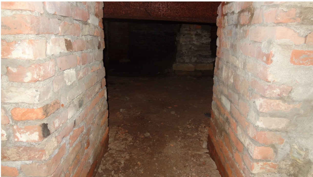
Фото 15. Фрагменты капитальных конструкций подвала. Дата фотофиксации: 14.06.23
