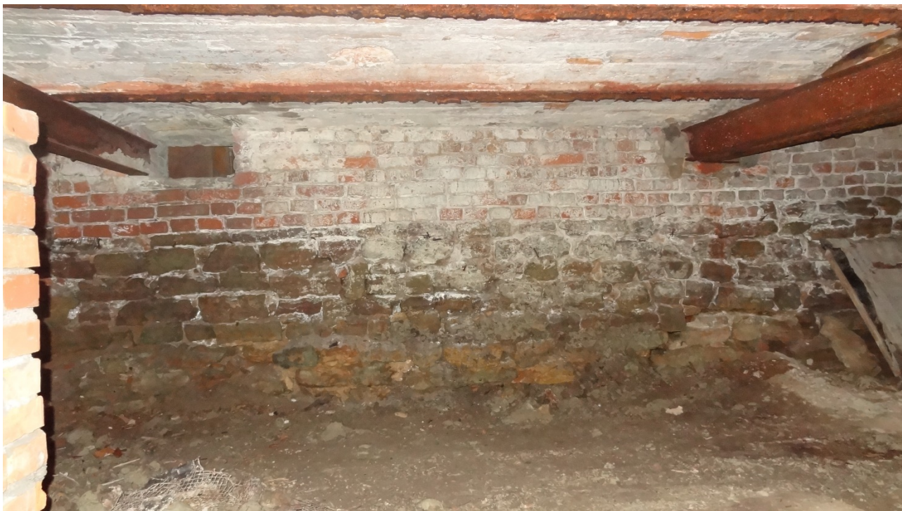
Фото 19. Фрагмент западной стены. Дата фотофиксации: 14.06.23
