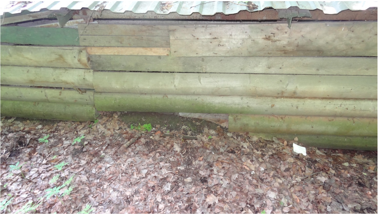
Фото 3. Западный фасад с фрагментом известнякового цоколя.
