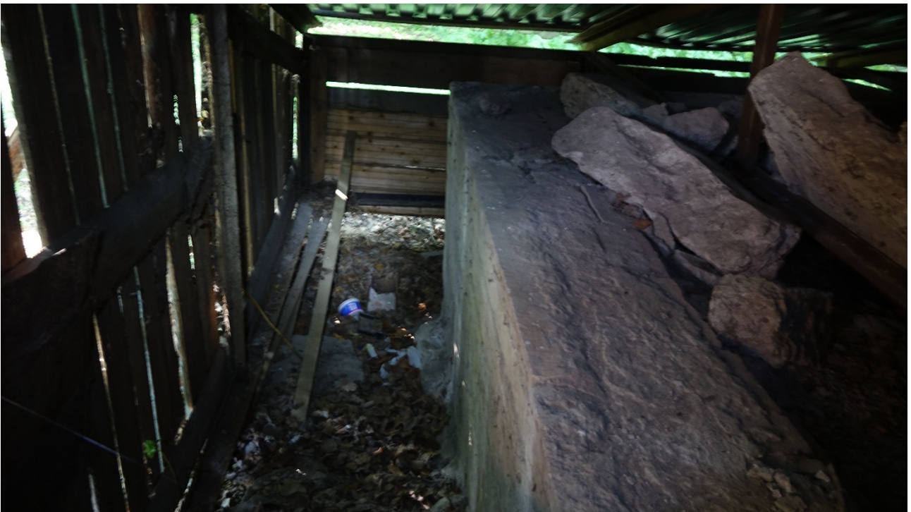
Фото 8. Фрагмент сохранившегося цоколя южного фасада.
