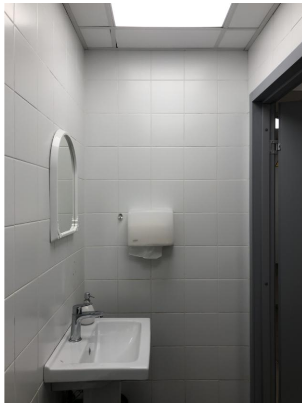
Фото 13. Вид на помещение пристройки.
