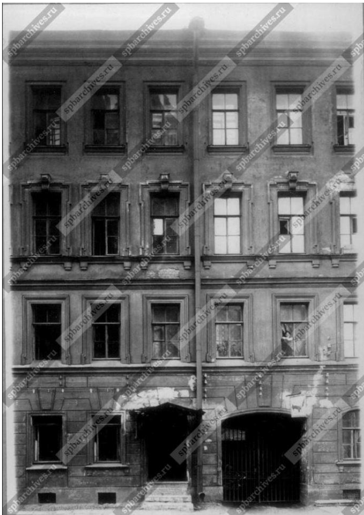
48. Вид части юго-восточного фасада дома № 40 со стороны Сенной площади. 1939 г. ЦГАКФФД Гр 77808
