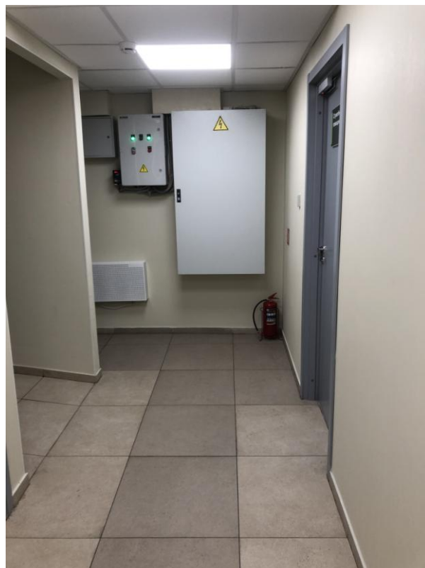
Фото 11. Вид на помещение пристройки.
