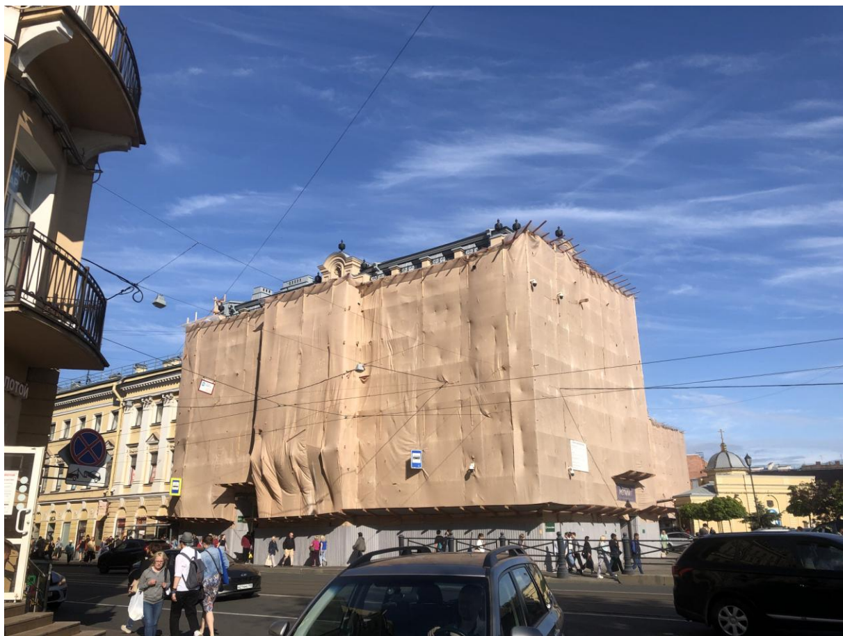
Фото 3. Вид на угол здания на пересечении Сенной площади и Садовой улицы.
