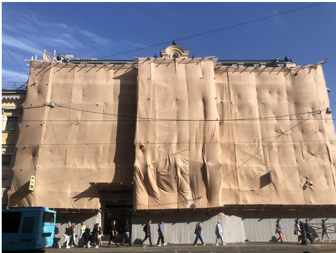
Фото 4. Вид на здание с Садовой улицы.
