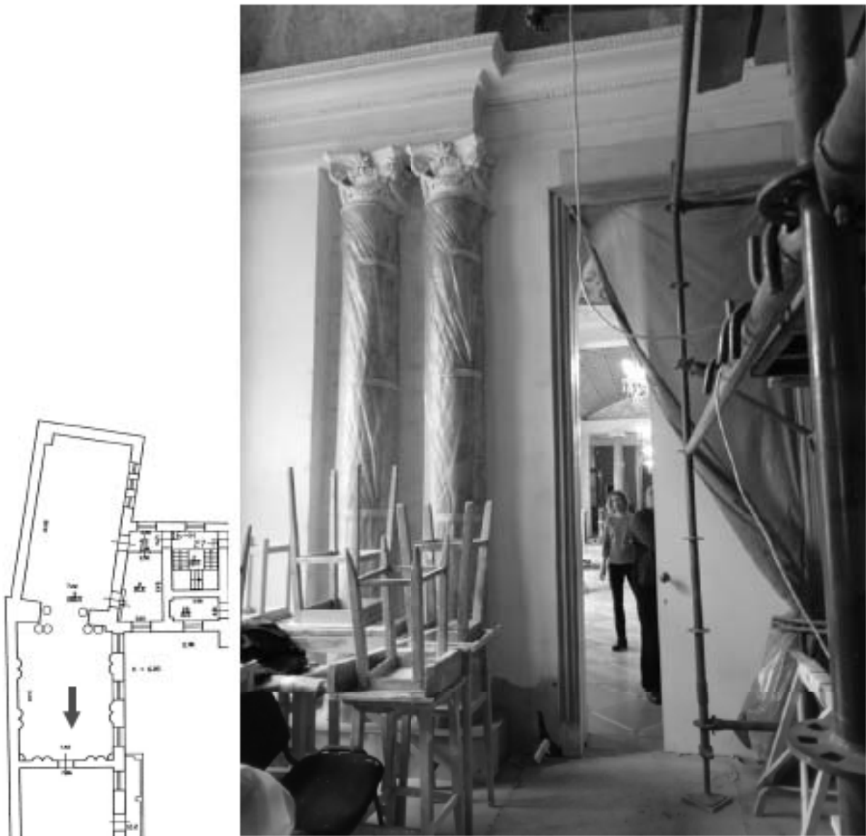
Фото 3. Объект культурного наследия федерального значения "Дворец Строгановых", по адресу: Санкт-Петербург, Невский пр. 17. Помещение 210 Библиотека (Столовая)
