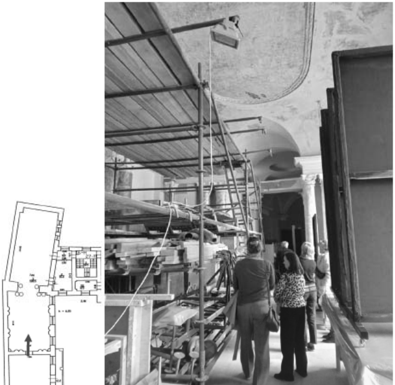
Фото 1. Объект культурного наследия федерального значения "Дворец Строгановых", по адресу: Санкт-Петербург, Невский пр. 17. Помещение 210 (Библиотека)
