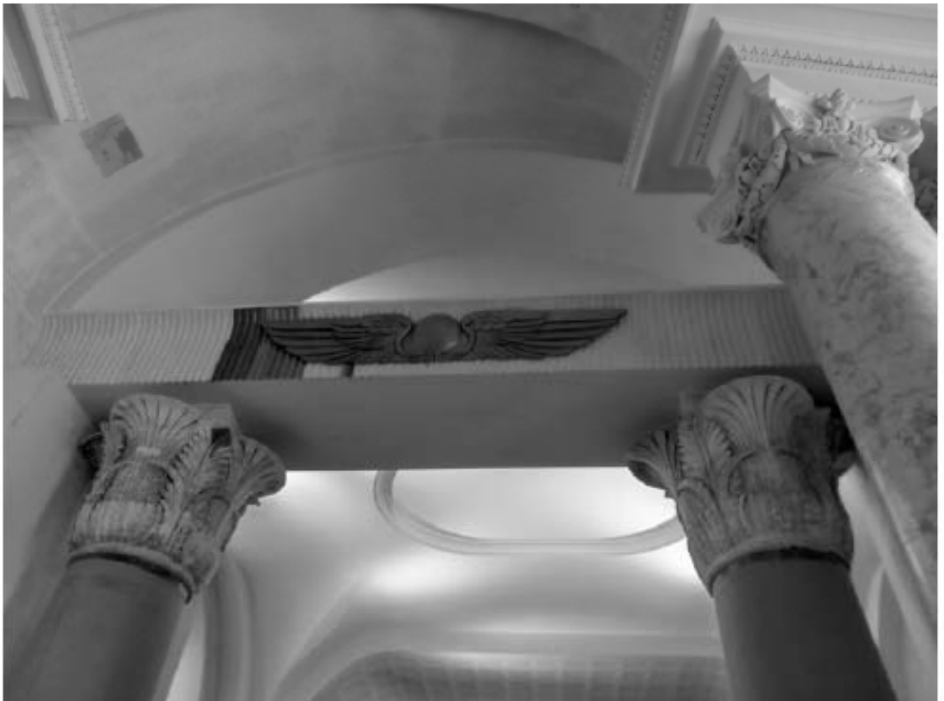
Фото 6. Объект культурного наследия федерального значения "Дворец Строгановых", по адресу: Санкт-Петербург, Невский пр. 17. Помещение 210 (Библиотека)
