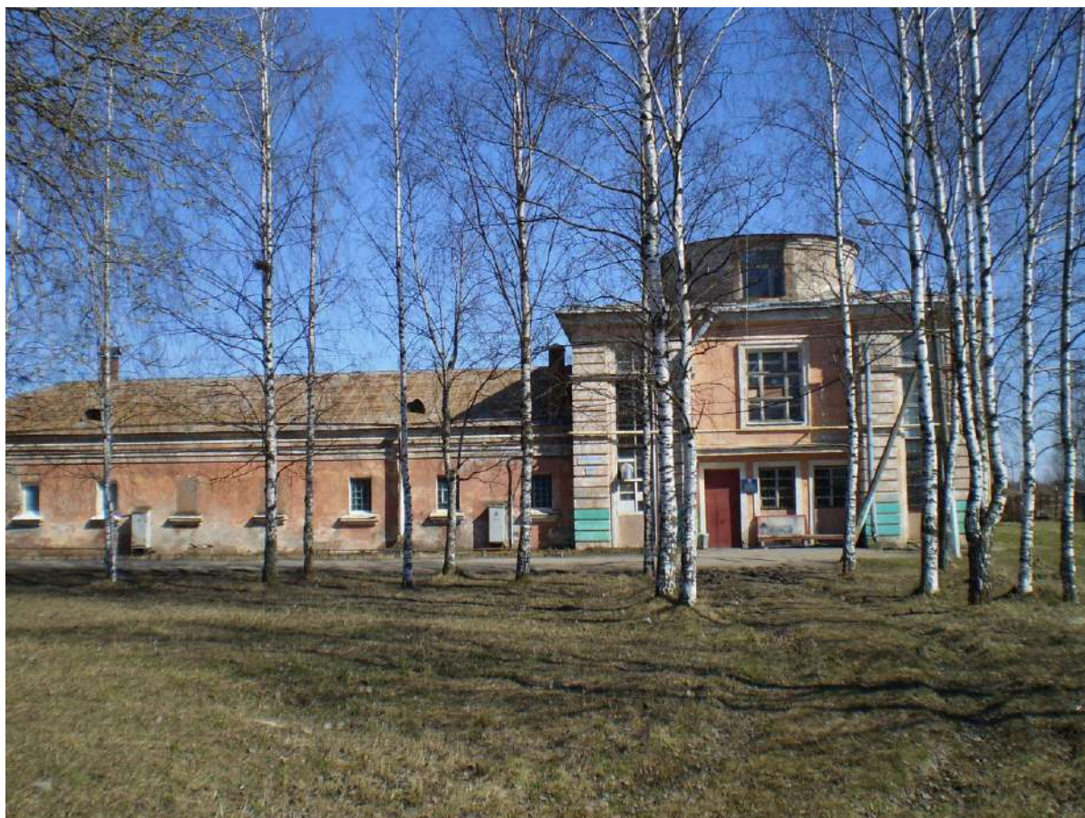
22. Общий вид на здание с запада, фото 2017 г. Фотоальбомы сообщества вконтакте «Петергоф. Суворовский городок».
