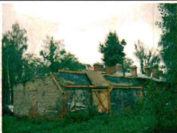
Фото 186. Западный, северный фасады. Общий вид.
