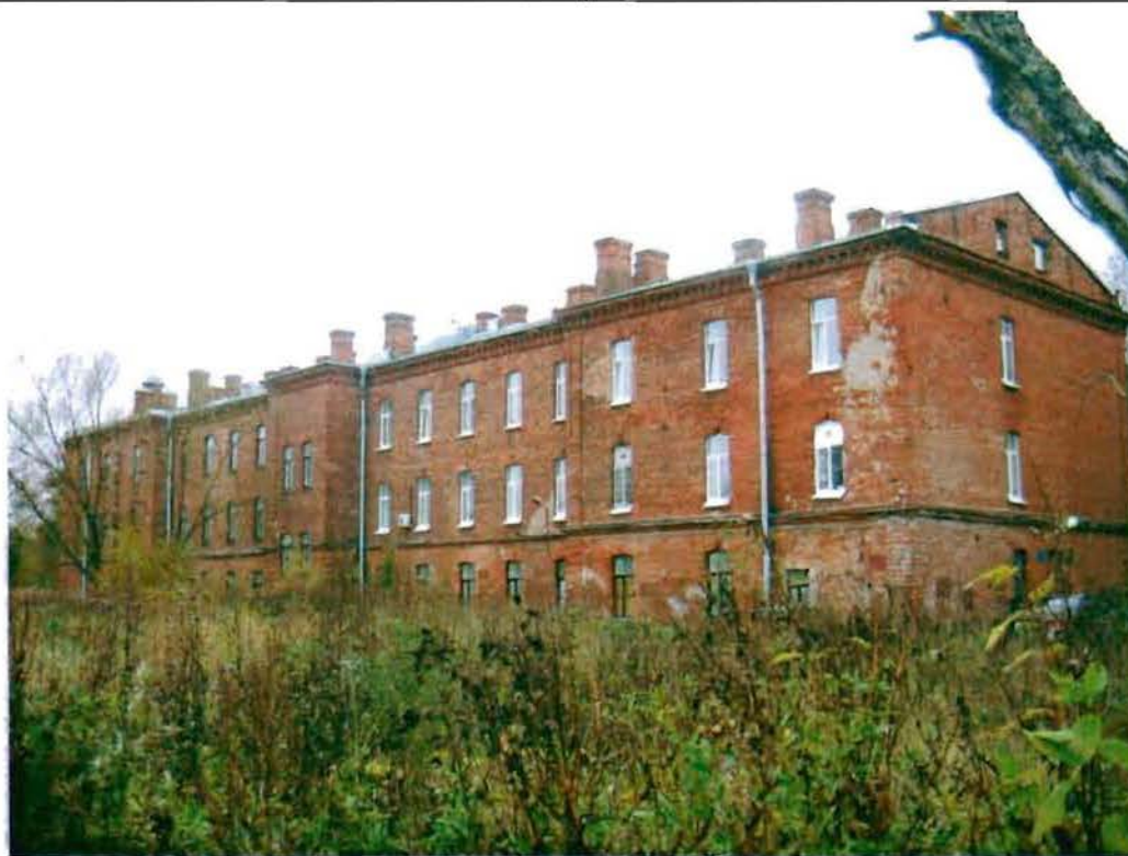
Фото 14. Восточный фасад. Общий вид.
