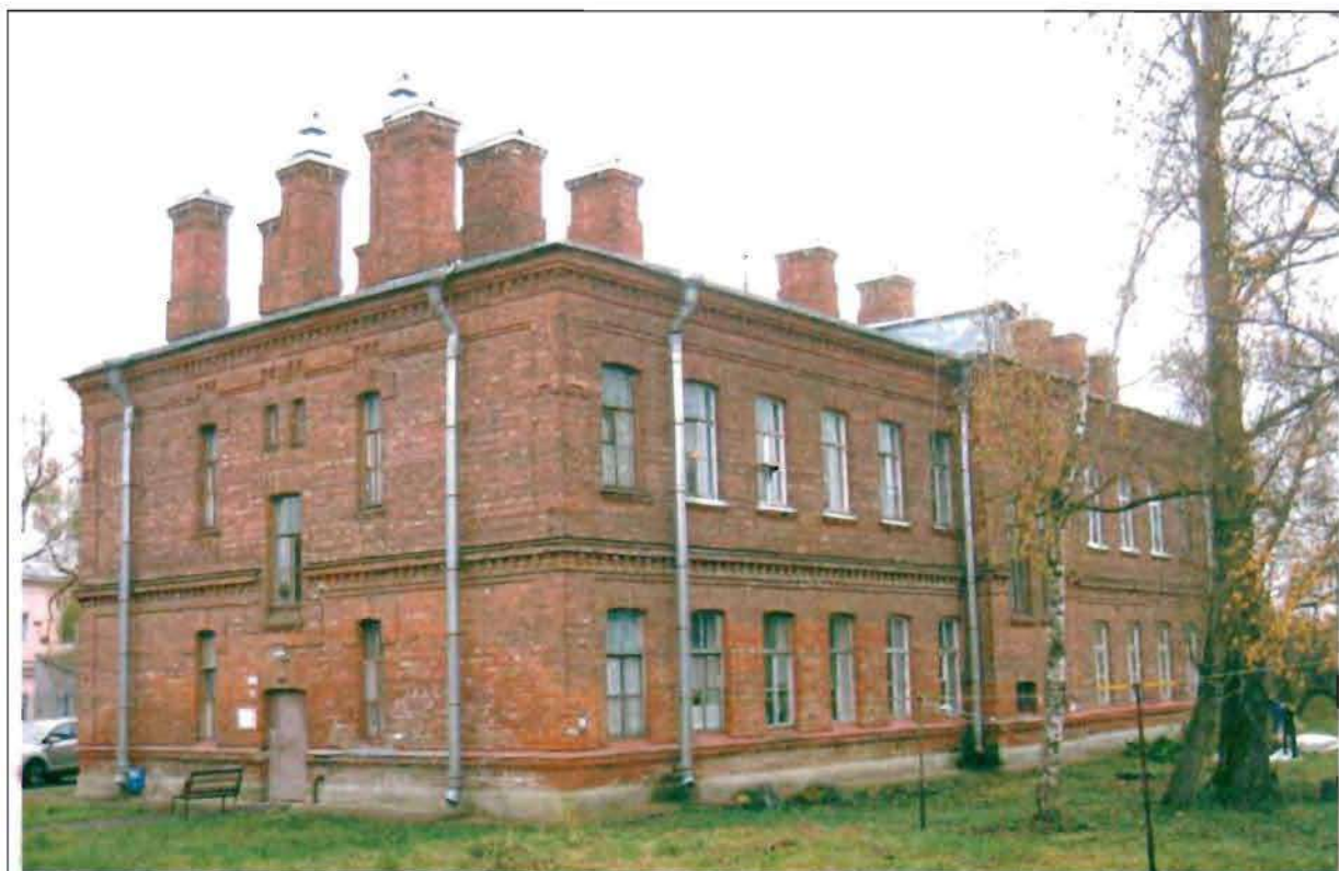
Фото 129. Западный, северный фасады. Общий вид.
