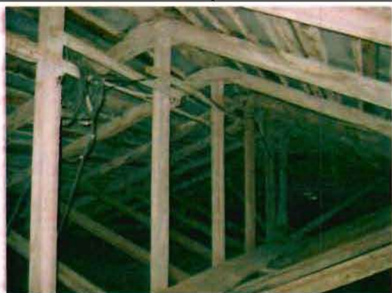
Фото 81. Конструкции крыши. Общий вид.
