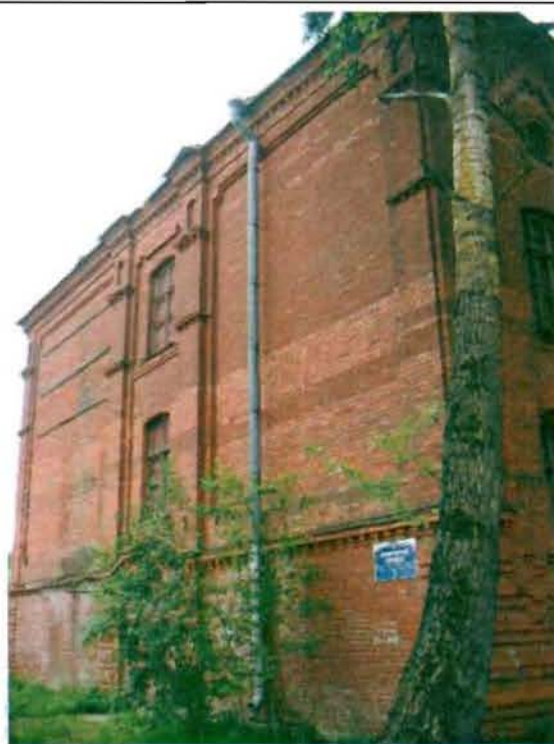
Фото 6. Северный фасад. Общий вид.
