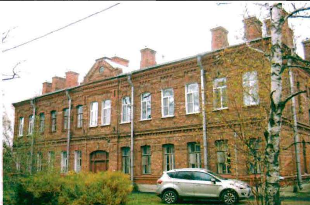
Фото 128. Восточный фасад. Общий вид.
