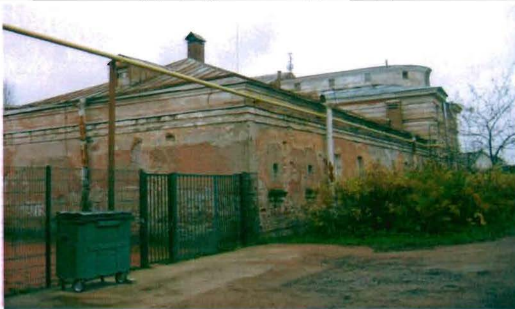
Фото 24. Западный, северный фасады. Общий вид.
