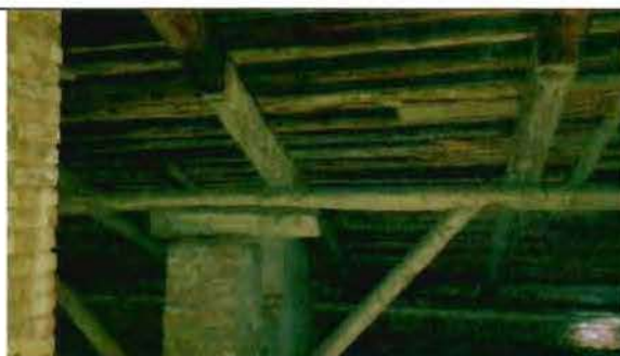
Фото 38. Конструкции крыши. Фрагмент.
