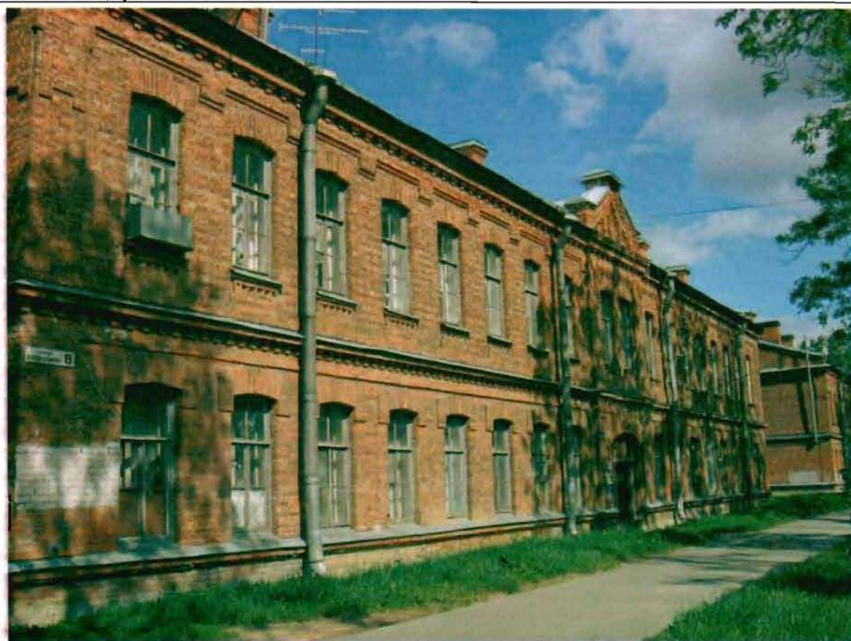
Фото 176. Восточный фасад. Общий вид.
