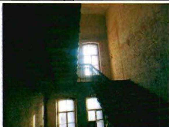
Фото 11. Интерьер. Лестница. Общий вид. 29.12.2015.
