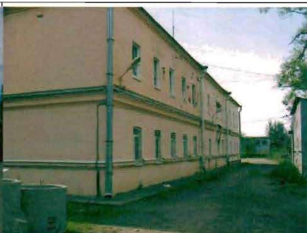
Фото 111. Западный фасад. Общий вид.
