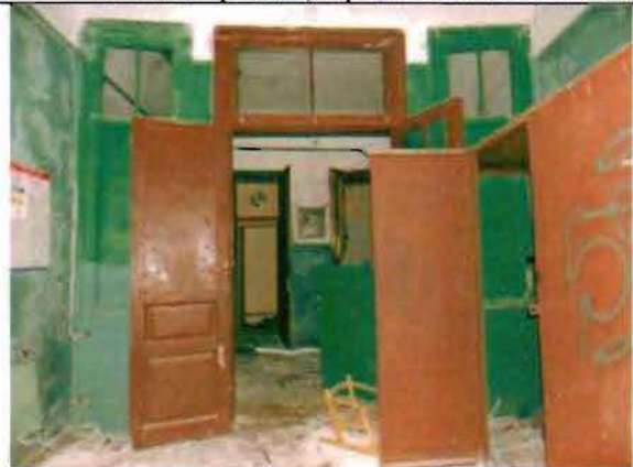
Фото 101. Дверной проем тамбура. Общий вид.
