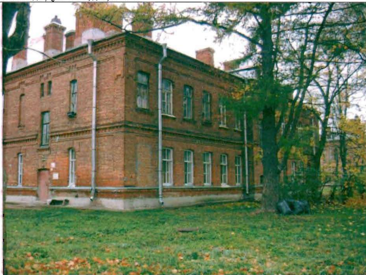
Фото 145. Восточный фасад. Общий вид.
