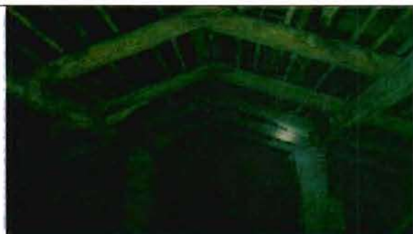
Фото 37. Конструкции крыши. Фрагмент.
