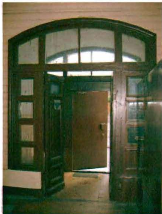
Фото 107. Дверной проем тамбура. Общий вид.
