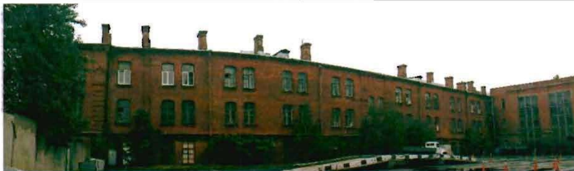
Фото 29. Западный фасад. Общий вид.
