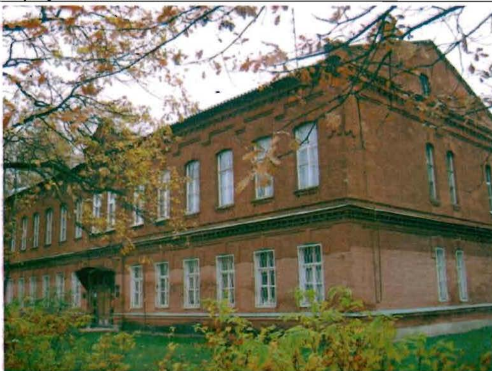
Фото 89. Западный, южный фасады. Общий вид.
