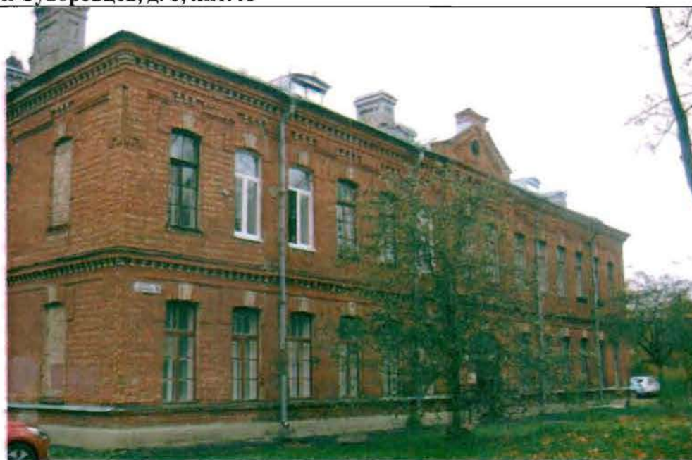
Фото 103. Восточный фасад. Общий вид.
