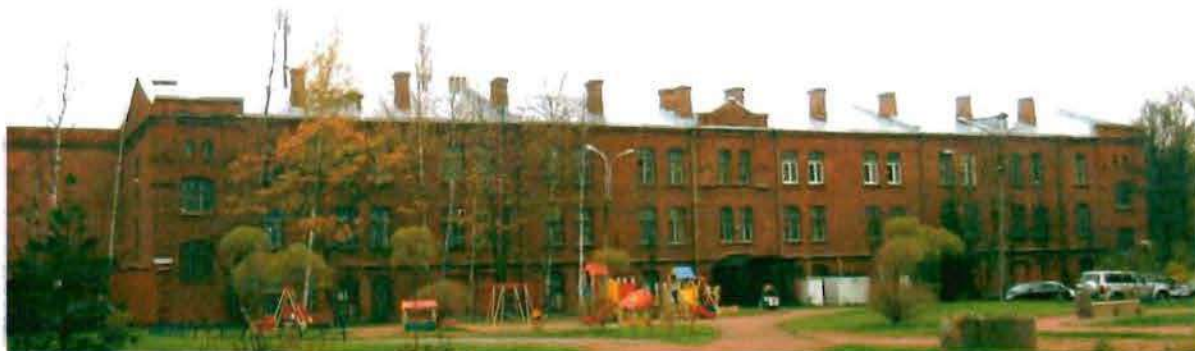
Фото 28. Восточный фасад. Общий вид.
