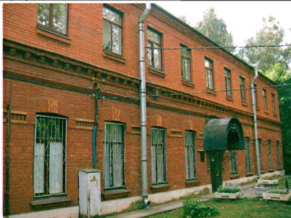
Фото 78. Западный фасад. Общий вид.
