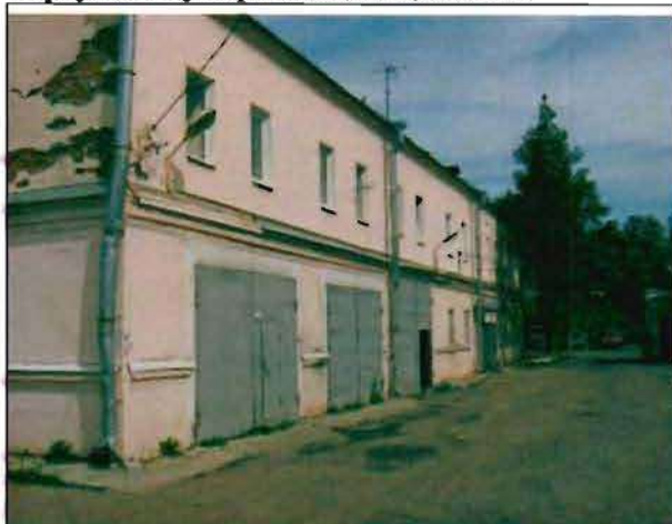
Фото 110. Восточный фасад. Общий вид.
