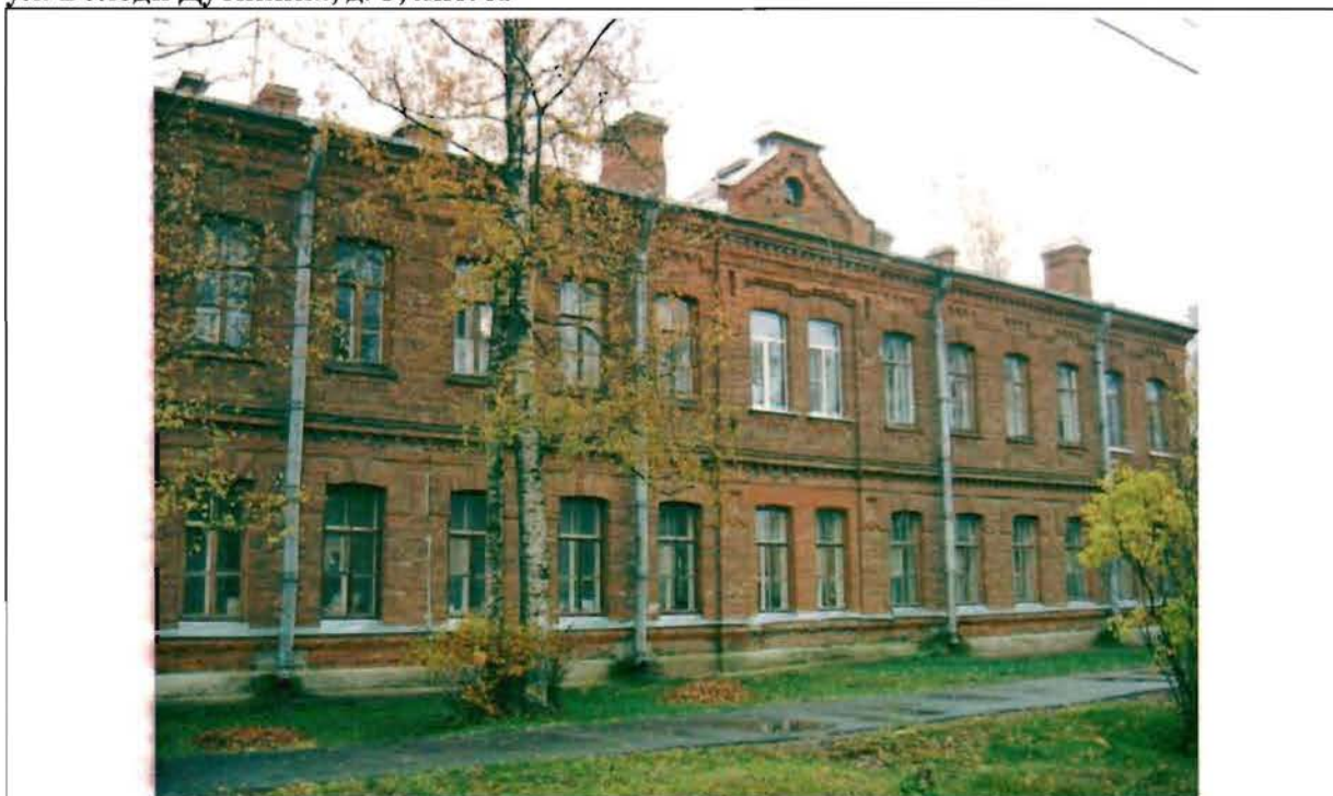
Фото 157. Западный фасад. Общий вид.
