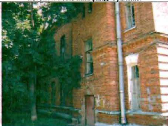
Фото 139. Западный фасад. Фрагмент.
