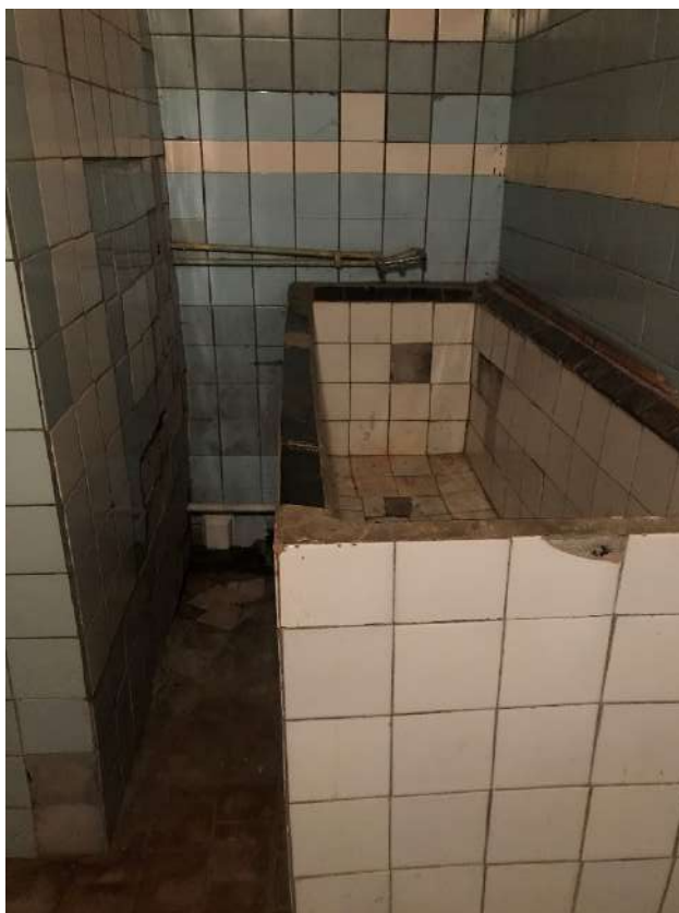
Фото 28. Общий вид помещения №8.
