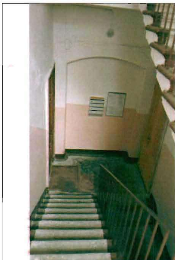
Фото 130. Лестница № 1 в южной части здания. Общий вид.
