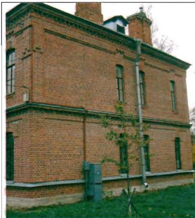
Фото 134. Южный фасад. Общий вид.
