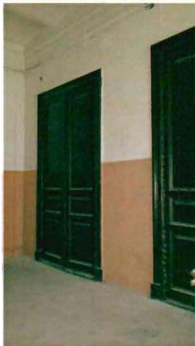
Фото 175. Дверные заполнения парадной лестницы в центральной части здания. Общий вид.
