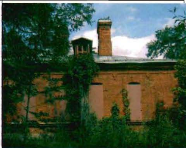
Фото 100. Южный фасад. Фрагмент.
