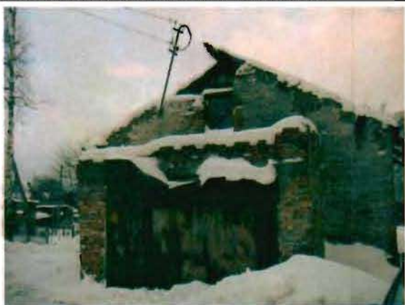
Фото 184. Восточный фасад. Общий вид. 14.01.2015.
