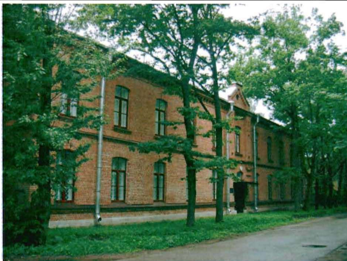
Фото 39. Восточный фасад. Общий вид.
