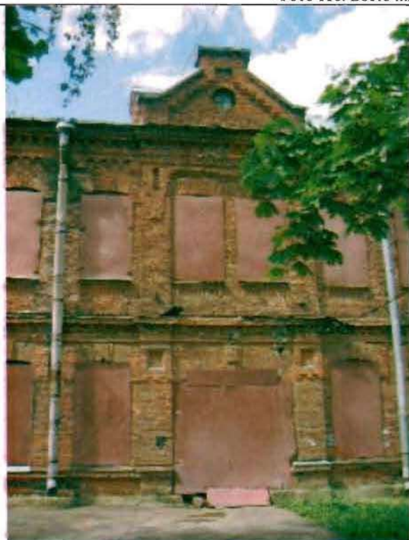
Фото 117. Восточный фасад. Фрагмент центральной части фасада.
