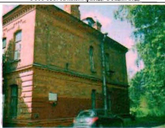
Фото 140. Северный фасад. Общий вид.
