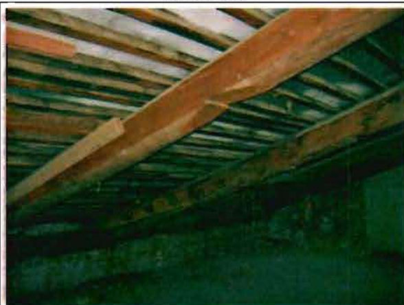
Фото 151. Конструкции крыши. Фрагмент.
