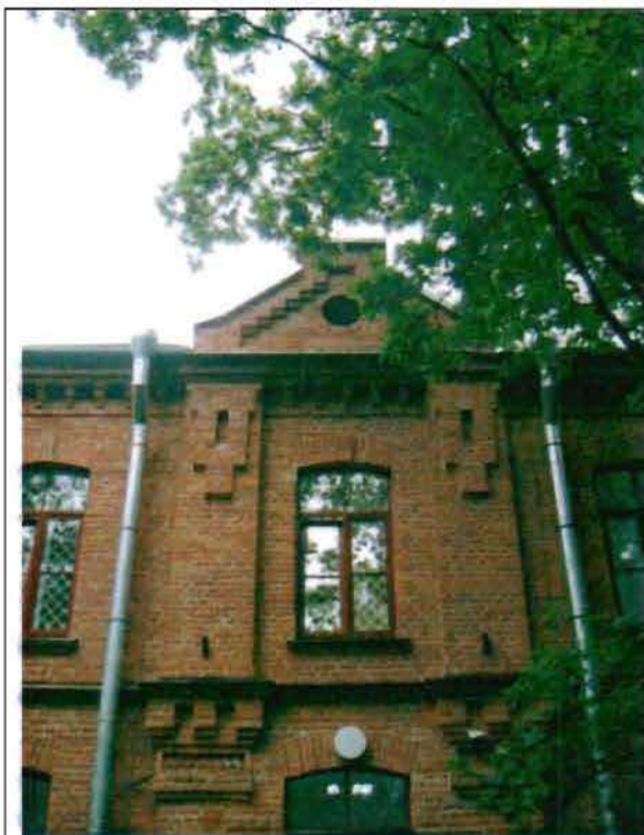
Фото 40. Восточный фасад. Фрагмент центральной части фасада.
