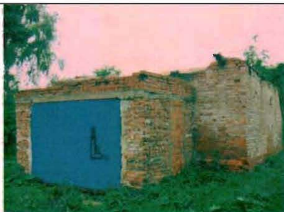
Фото 185. Восточный фасад. Общий вид.
