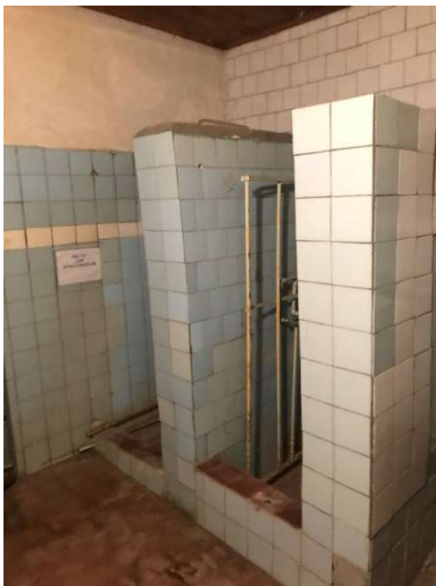
Фото 27. Общий вид помещения №8.
