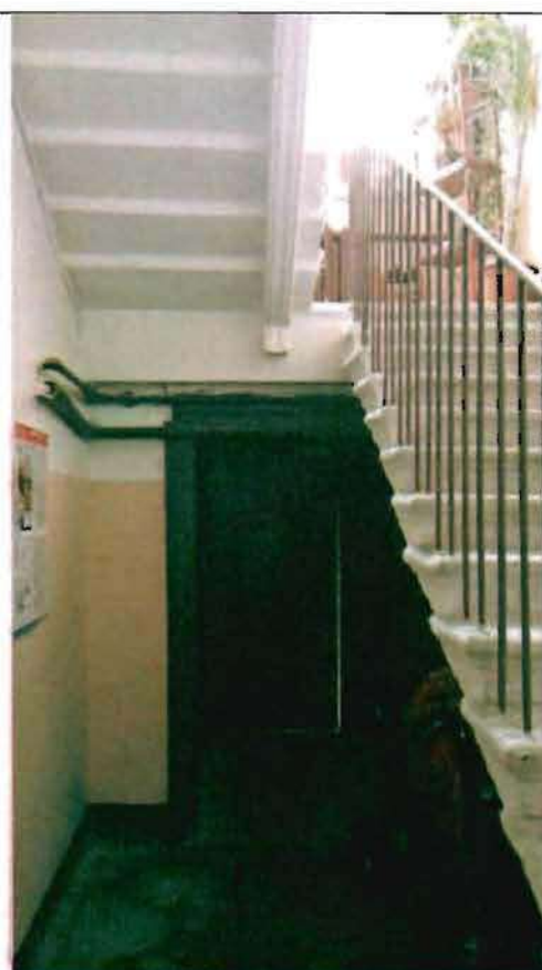
Фото 131. Лестница № 2 в северной части здания. Общий вид.
