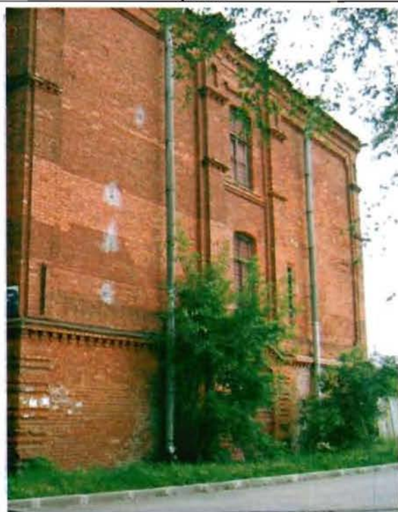
Фото 5. Южный фасад. Общий вид.
