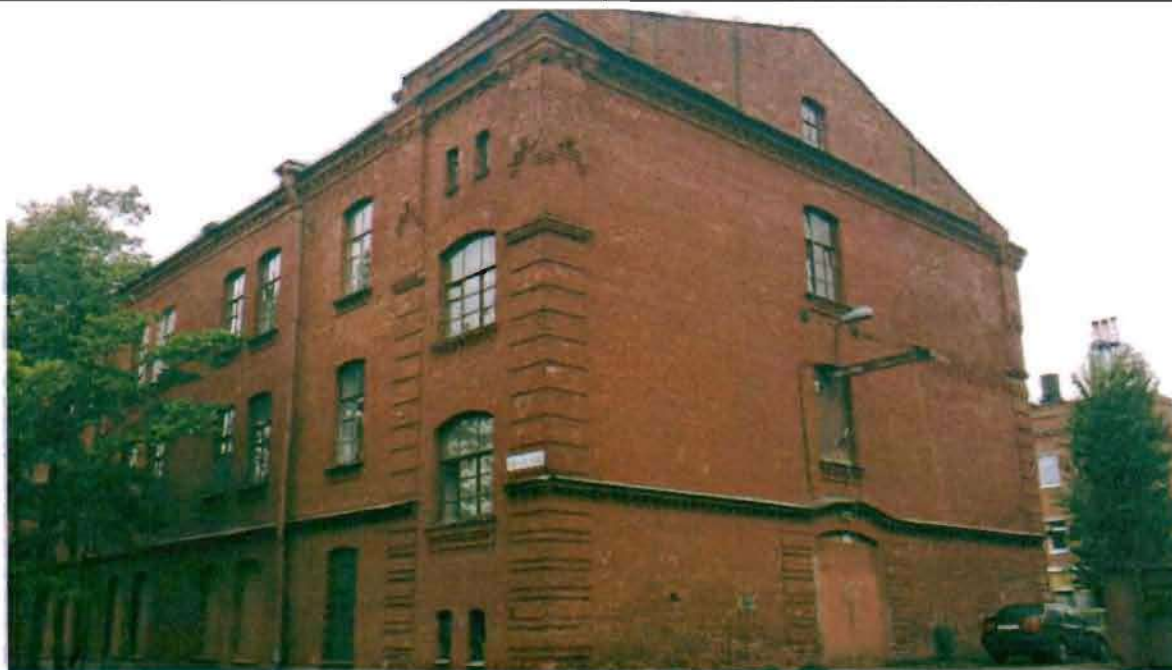
Фото 30. Северный фасад. Общий вид.
