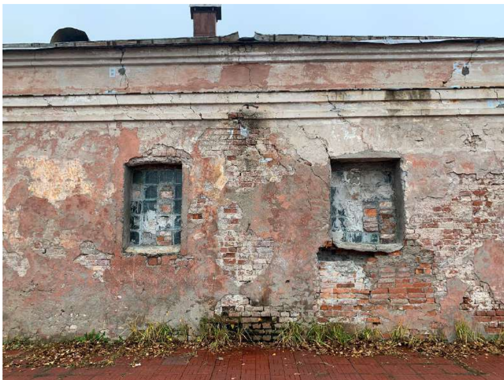
Фото 15. Вид на фрагмент фасада по оси 8.
