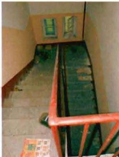
Фото 124. Лестница в южной части здания. Общий вид.
