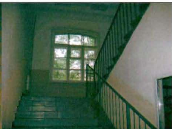
Фото 59. Интерьер. Лестница в северной части здания. Фрагмент.
