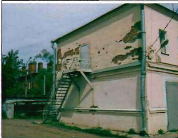
Фото 112. Южный фасад. Общий вид.
