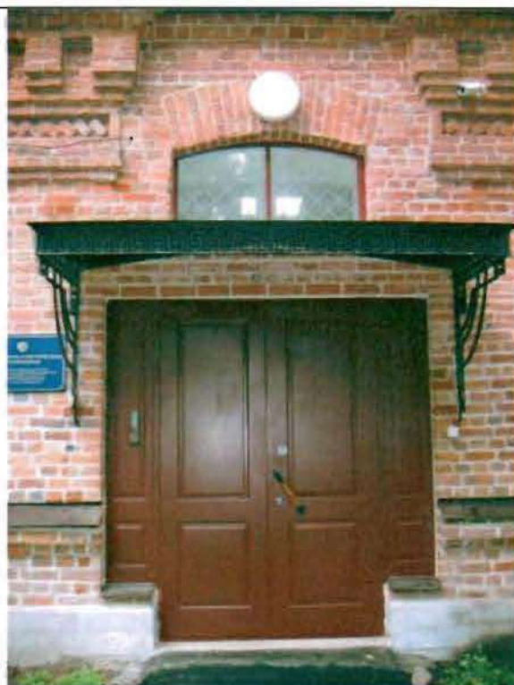
Фото 41. Дверной проем восточного фасада. Общий вид.
