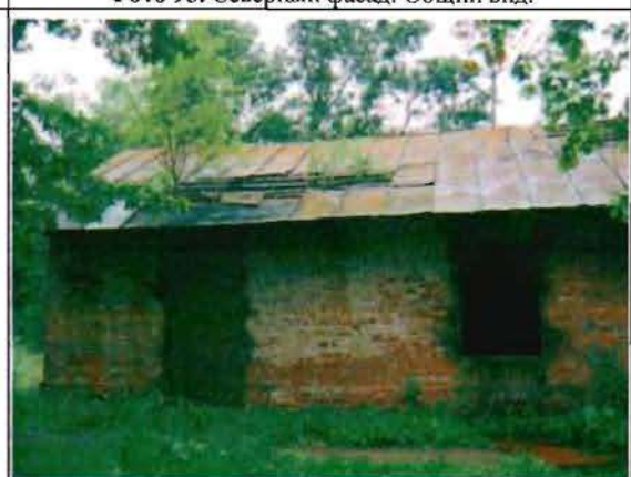
Фото 97. Южный фасад. Общий вид.
