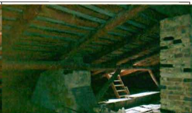
Фото 63. Конструкции крыши. Общий вид.
