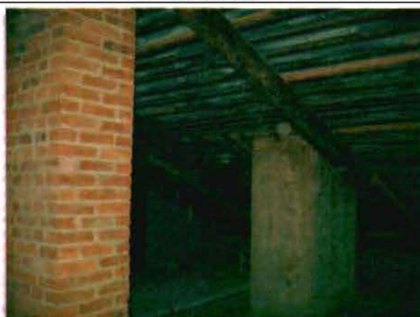
Фото 152. Конструкции крыши. Фрагмент.
