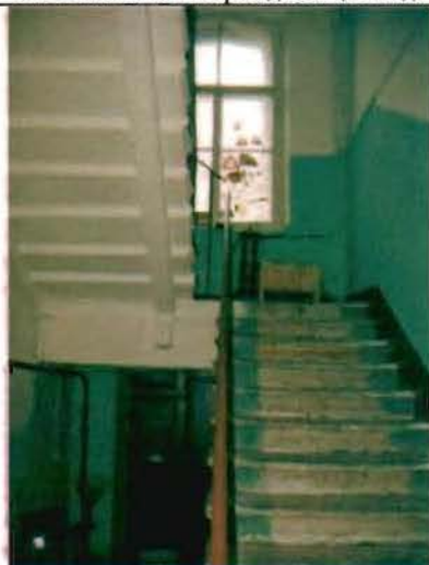
Фото 168. Лестница в южной части здания. Общий вид.
