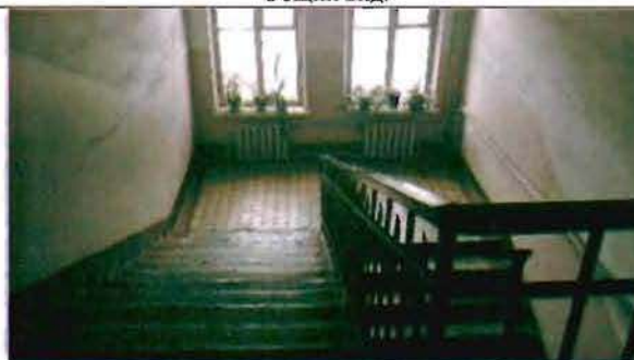
Фото 34. Интерьер. Лестница. Общий вид.
