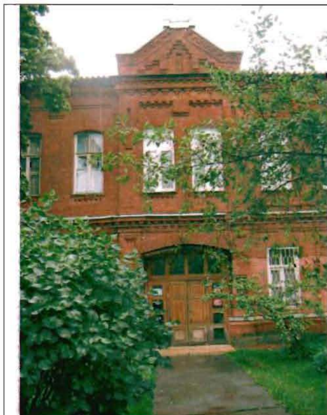
Фото 90. Восточный фасад. Центральная часть. Общий вид.
