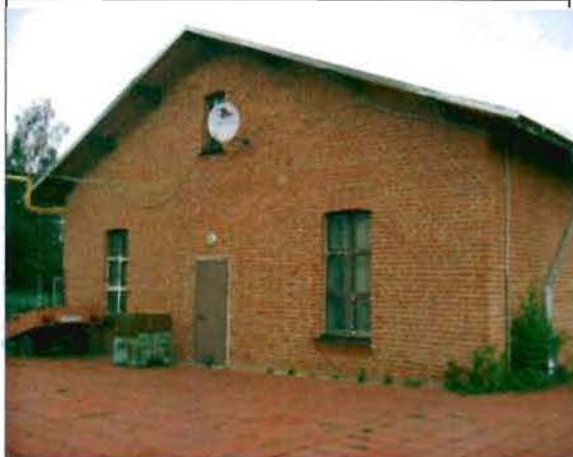
Фото 21. Южный фасад. Общий вид.
