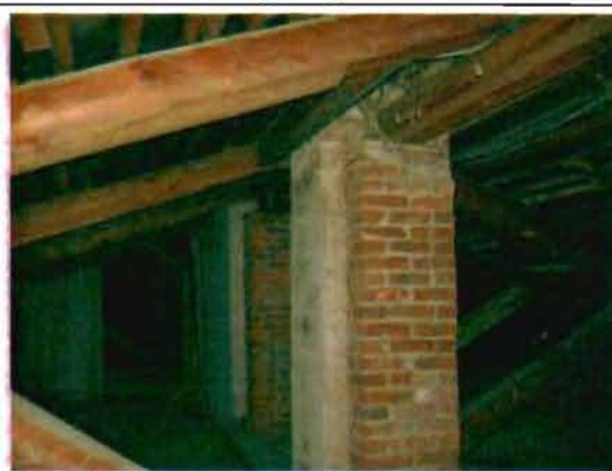
Фото 142. Конструкции крыши. Фрагмент.
