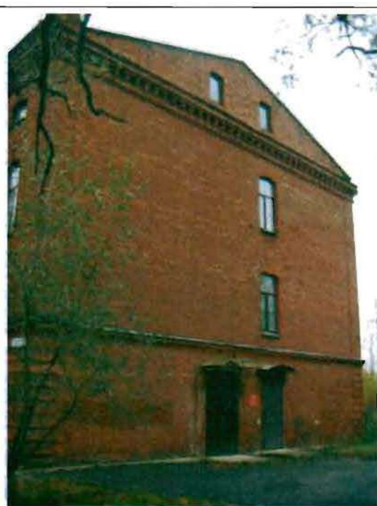
Фото 16. Южный фасад. Общий вид.
