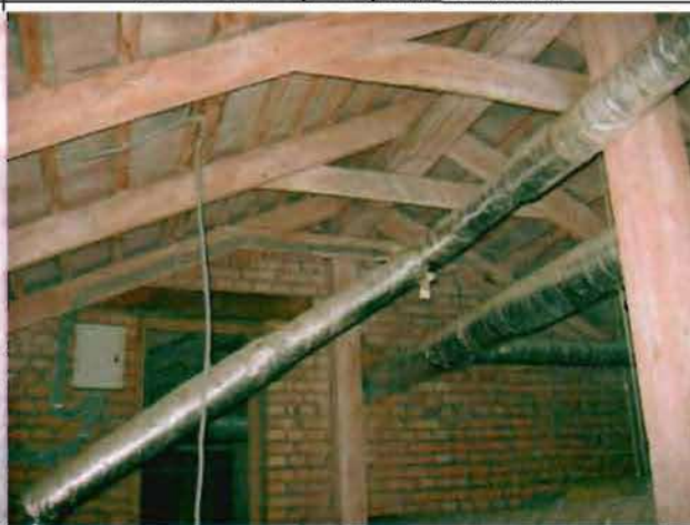
Фото 115. Конструкции крыши. Фрагмент.
