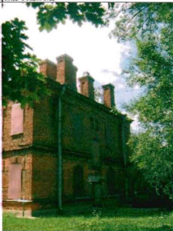
Фото 118. Северный фасад. Общий вид.
