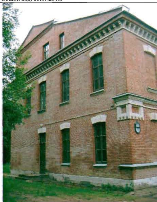
Фото 68. Восточный фасад. Общий вид.
