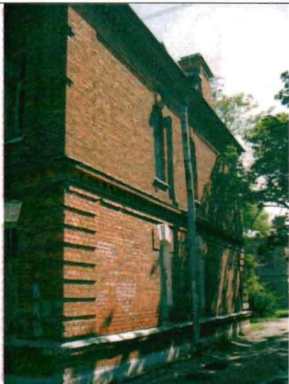
Фото 138. Южный фасад. Общий вид.
