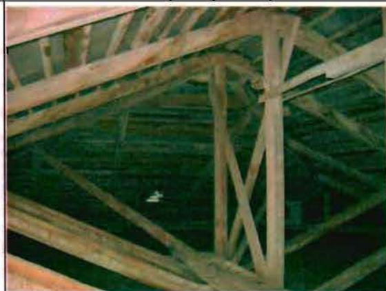
Фото 82. Конструкции крыши. Общий вид.
