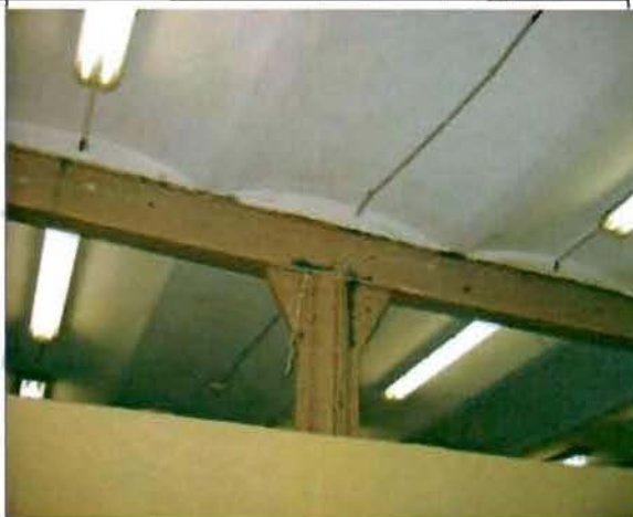
Фото 23. Интерьер. Металлические клепанные колонны и балки. Фрагмент.
