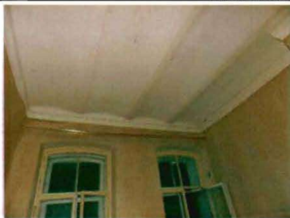
Фото 120. Помещение 1-го этажа. Общий вид.
