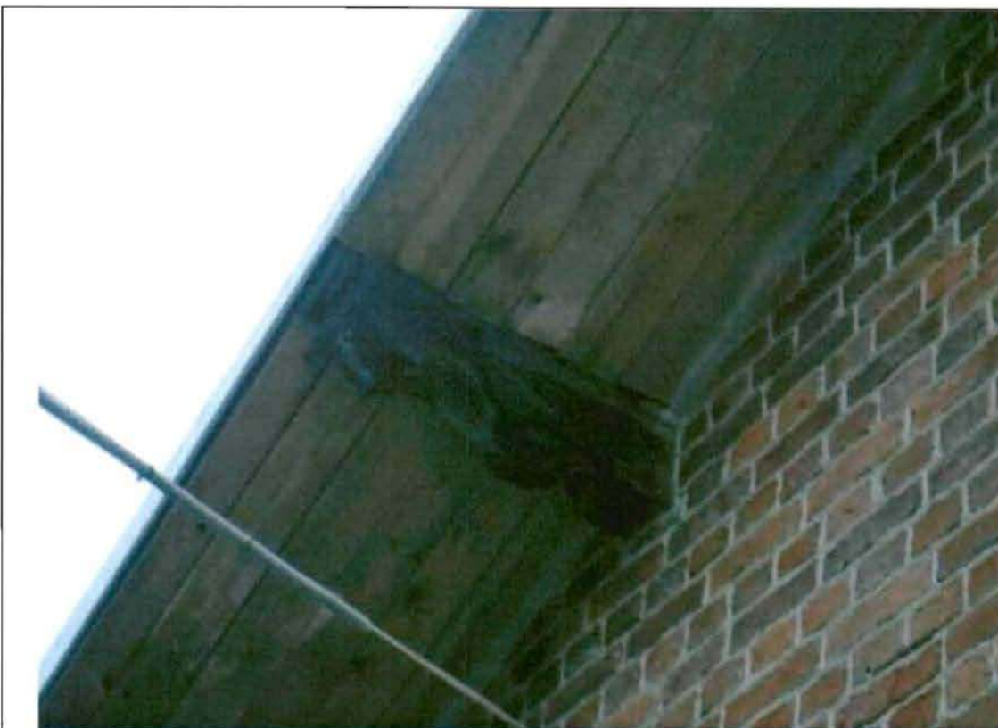
Деревянные кобылки. Съёмка 20.11.2012, Воронина Н.В.
