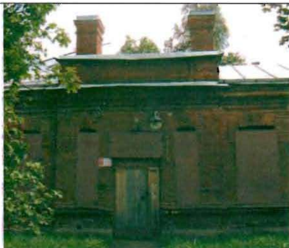
Фото 99. Западный фасад. Центральный часть. Общий вид.
