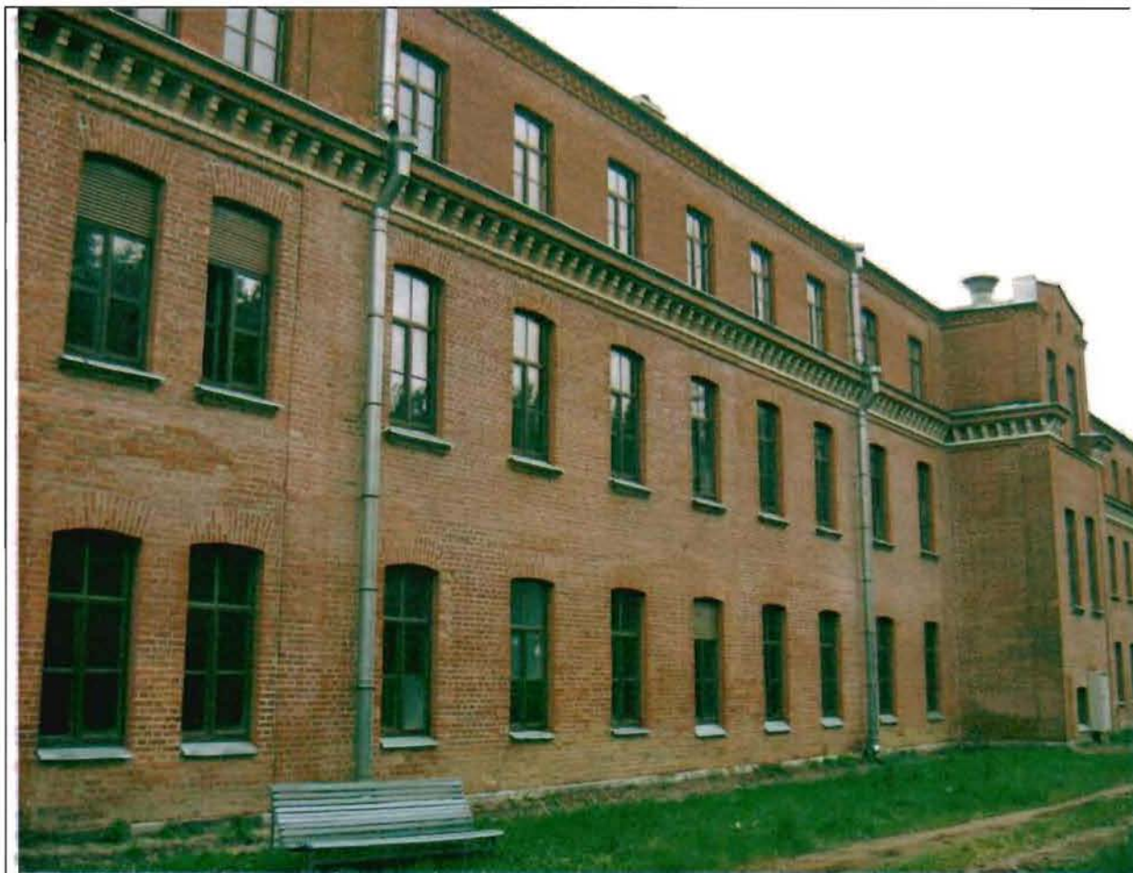
Фото 66. Южный фасад. Общий вид. 05.07.2016.
