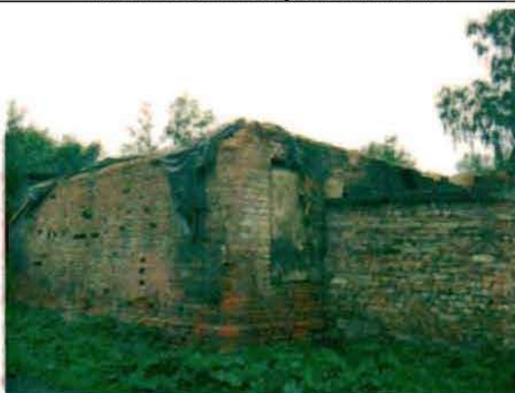
Фото 187. Северный фасад. Общий вид.
