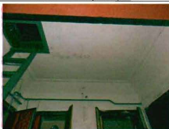
Фото 102. Отделка потолка тамбура. Общий вид.
