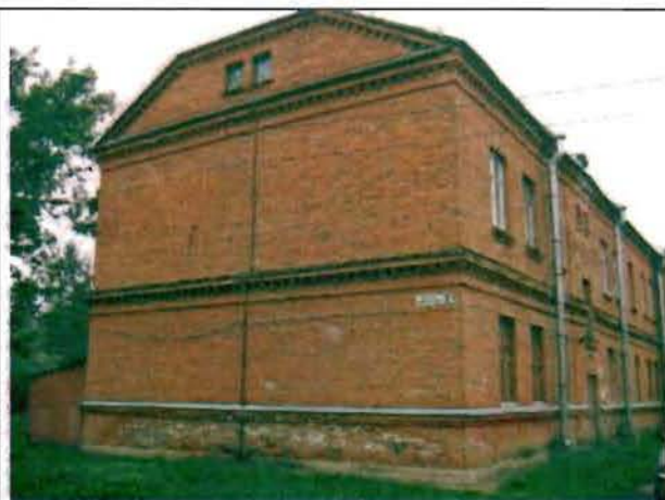
Фото 85. Восточный фасад. Общий вид.
