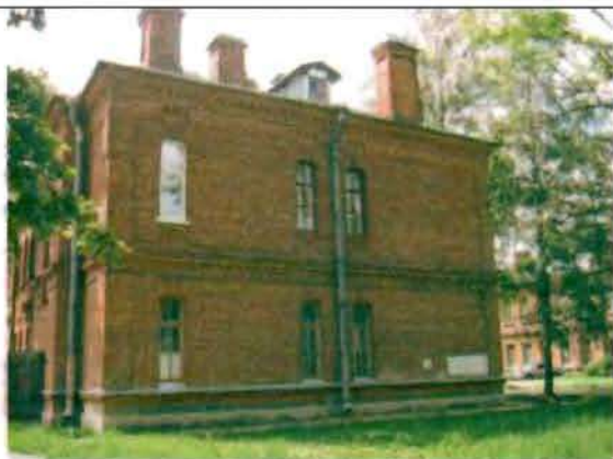
Фото 159. Северный фасад. Общий вид.
