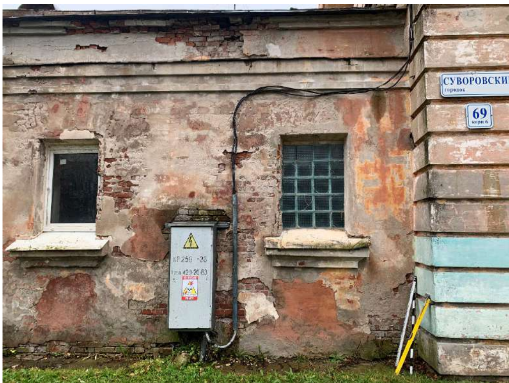
Фото 3. Вид на фрагмент фасада по оси А.
