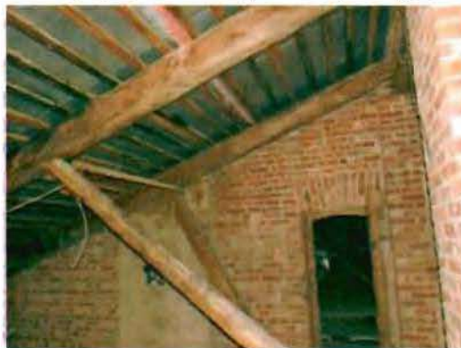
Фото 127. Конструкции крыши. Общий вид.
