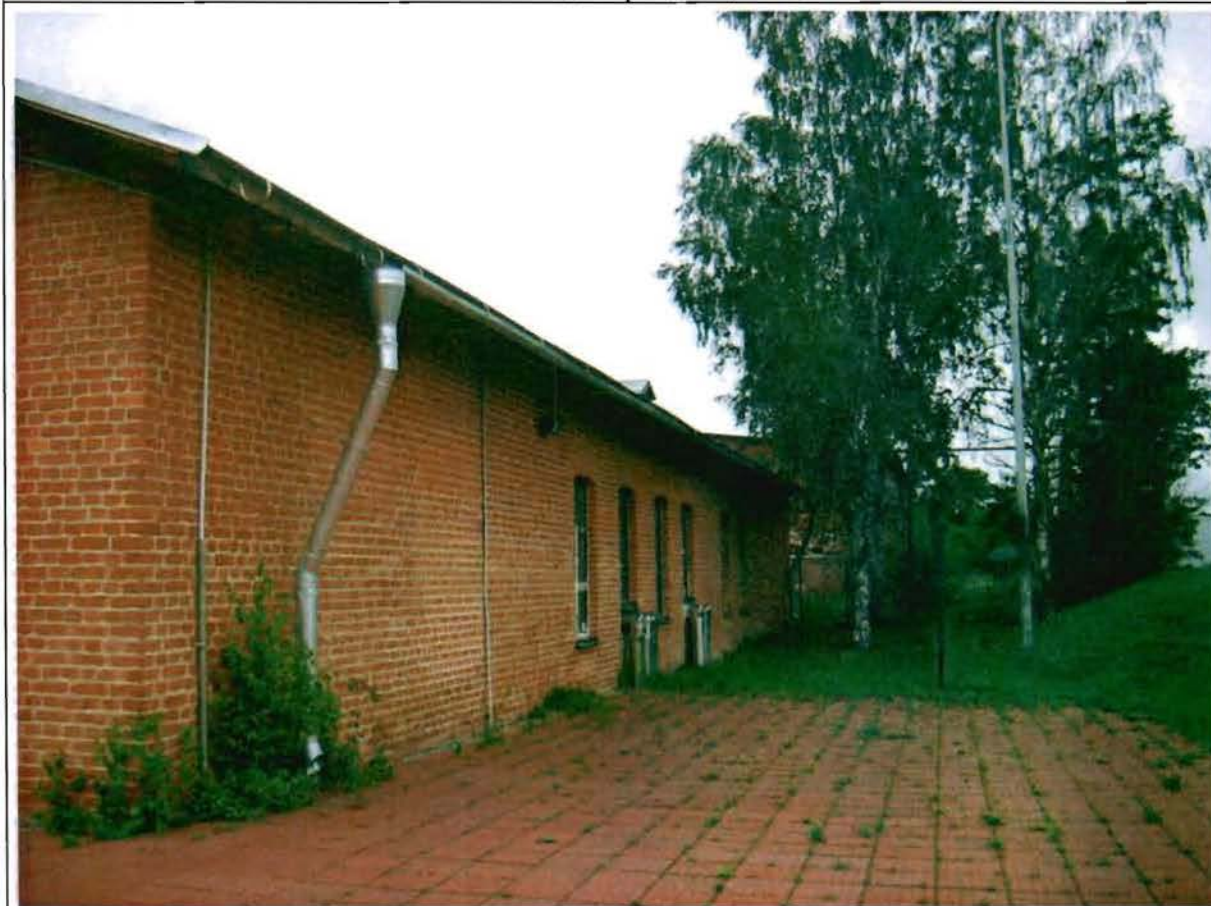
Фото 19. Восточный фасад. Общий вид.
