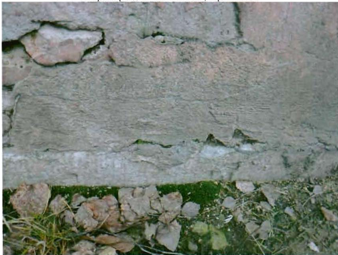
Цоколь, облицованный известняковой скобой. Съемка 27.11.2012, Воронина Н.В.
