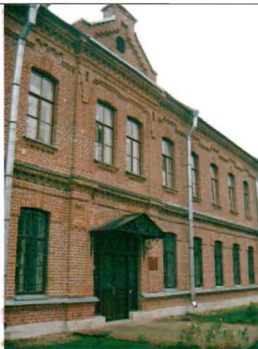
Фото 135. Западный фасад. Фрагмент центральной части фасада.
