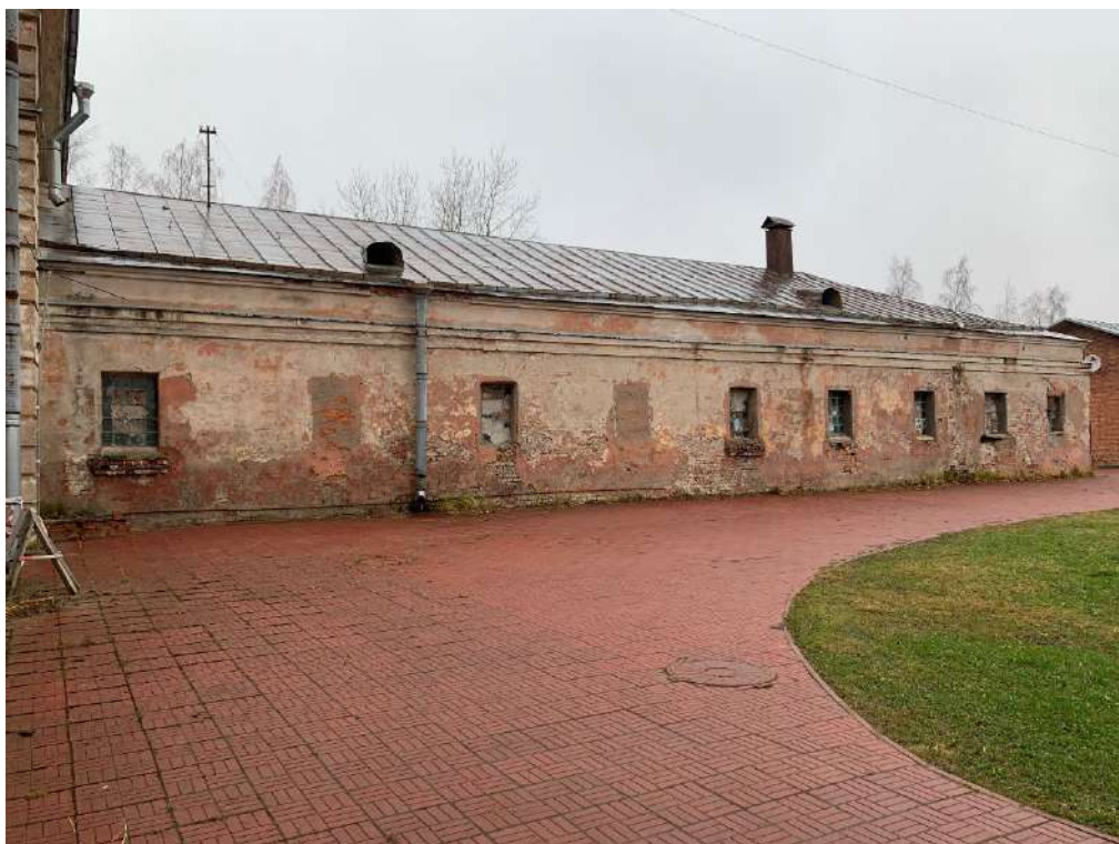
Фото 18. Вид на фрагмент фасада по оси 8.
