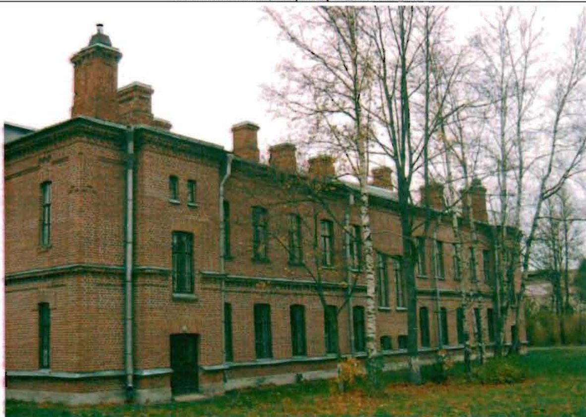
Фото 133. Восточный фасад. Общий вид.
