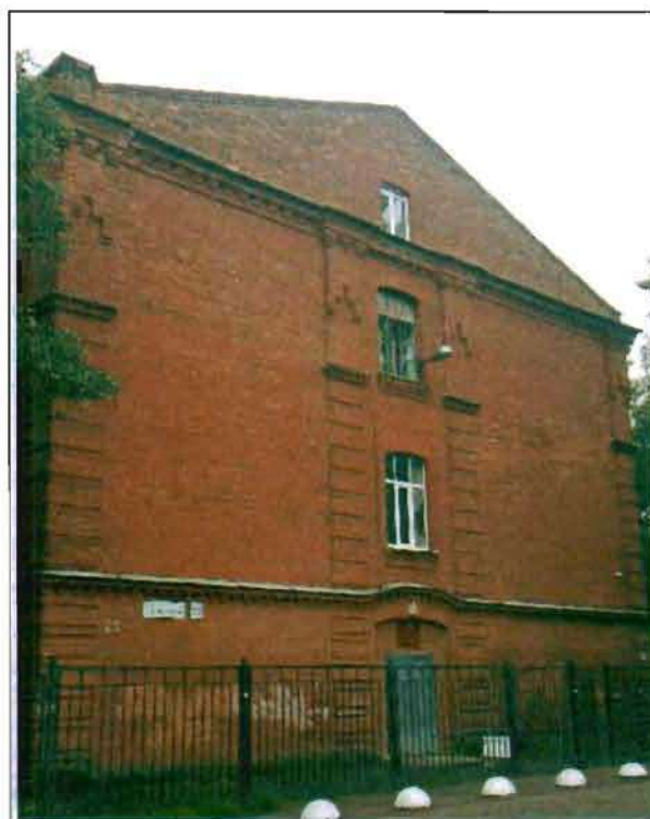
Фото 49. Северный фасад. Общий вид.
