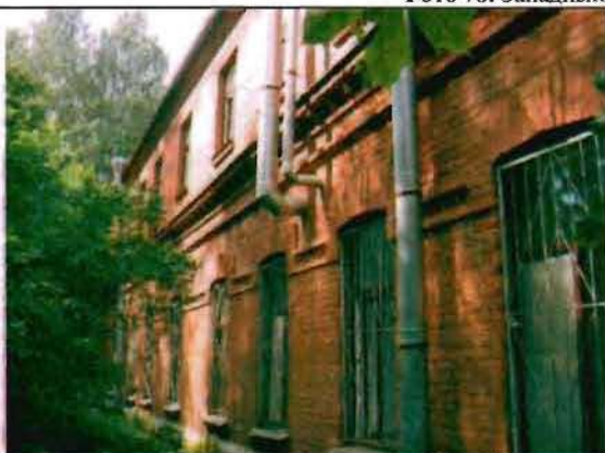
Фото 79. Восточный фасад. Общий вид.
