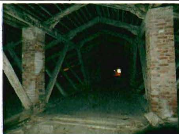
Фото 12. Конструкции крыши. Общий вид. 29.12.2015.
