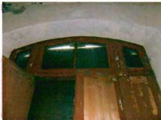
Фото 126. Дверное заполнение центральной части лестницы. Фрагмент.
