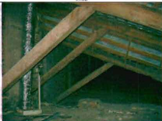
Фото 76. Конструкции крыши. Общий вид.
