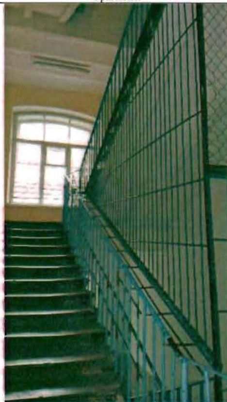
Фото 61. Интерьер. Лестница в южной части здания. Фрагмент.
