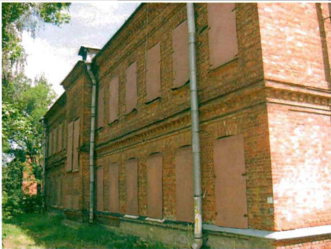
Фото 119. Западный фасад. Общий вид.
