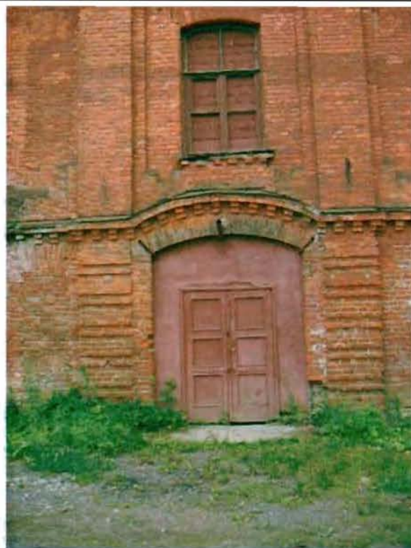
Фото 4. Западный фасад. Фрагмент центральной части фасада.
