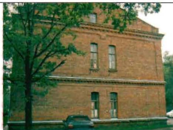
Фото 167. Северный фасад. Общий вид.
