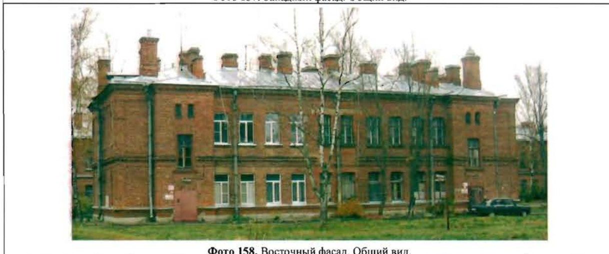
Фото 158. Восточный фасад. Общий вид.
