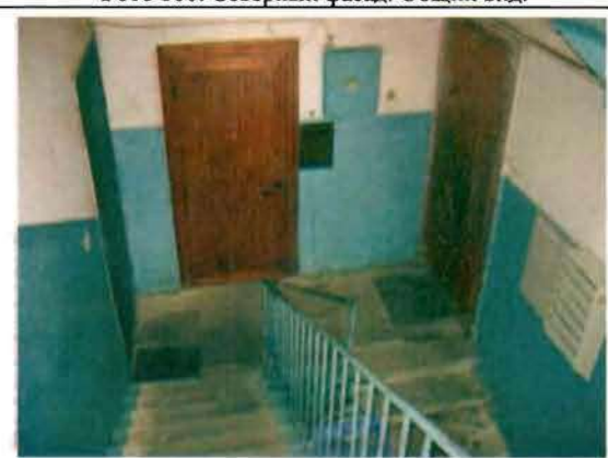
Фото 162. Лестница № 2 в северной части здания. Фрагмент.
