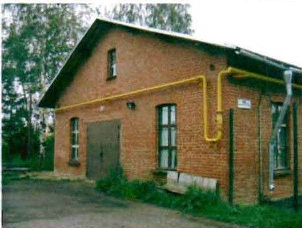
Фото 20. Северный фасад. Общий вид.
