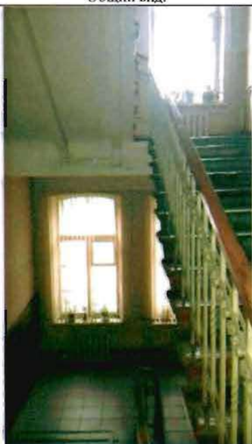
Фото 35. Интерьер. Лестница. Общий вид.
