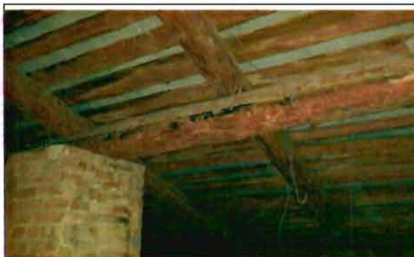
Фото 62. Конструкции крыши. Общий вид.
