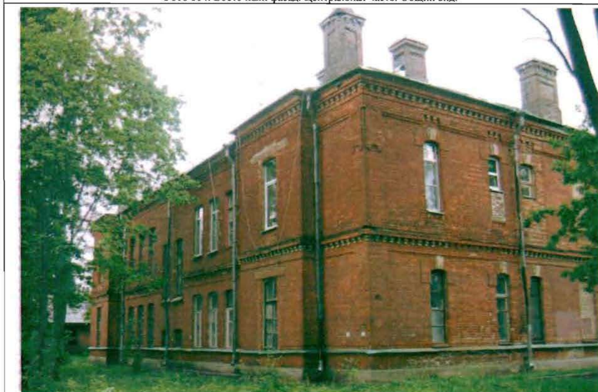
Фото 105. Западный, южный фасады. Общий вид.
