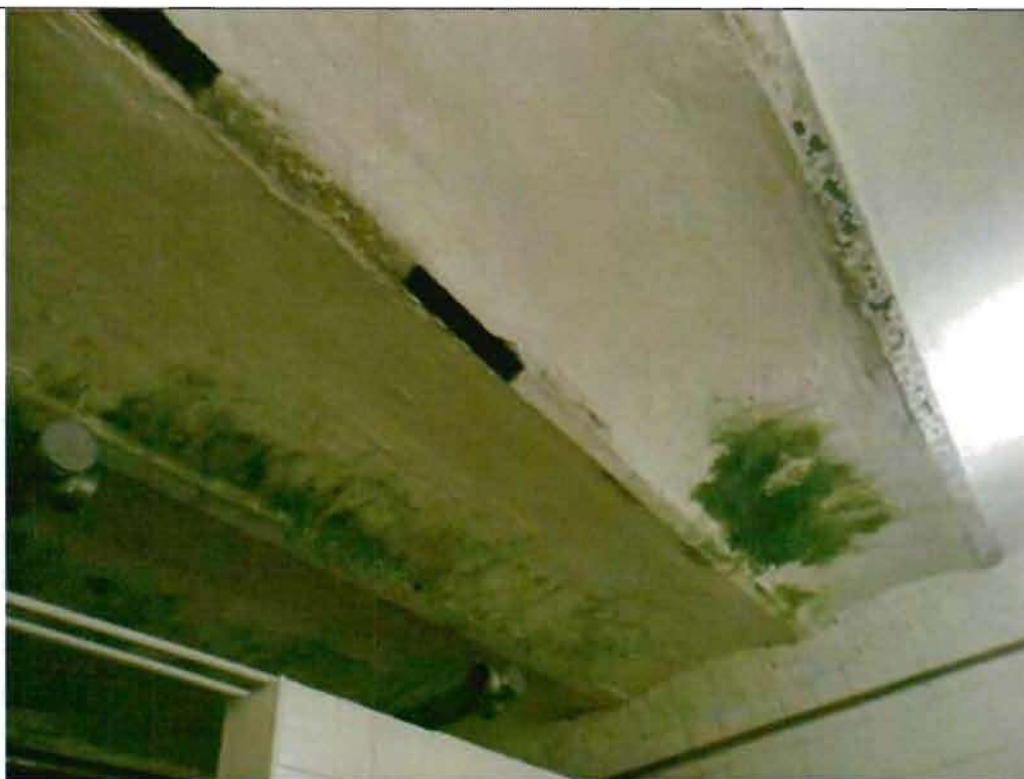
Своды по металлическим балкам. Съёмка 27.11.2012, Воронина Н.В.
