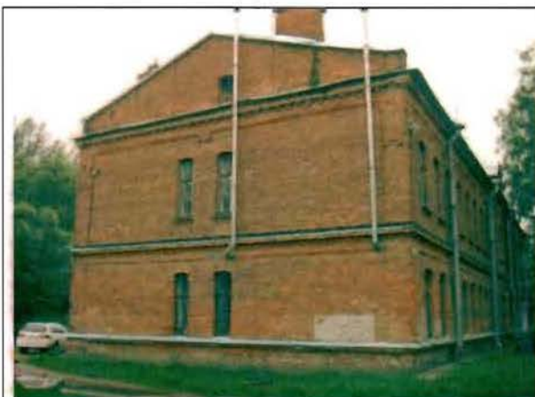
Фото 166. Южный фасад. Общий вид.
