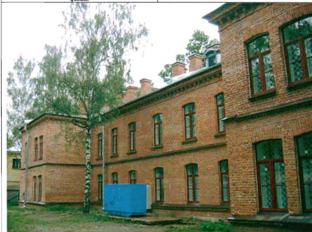
Фото 42. Западный фасад. Общий вид.
