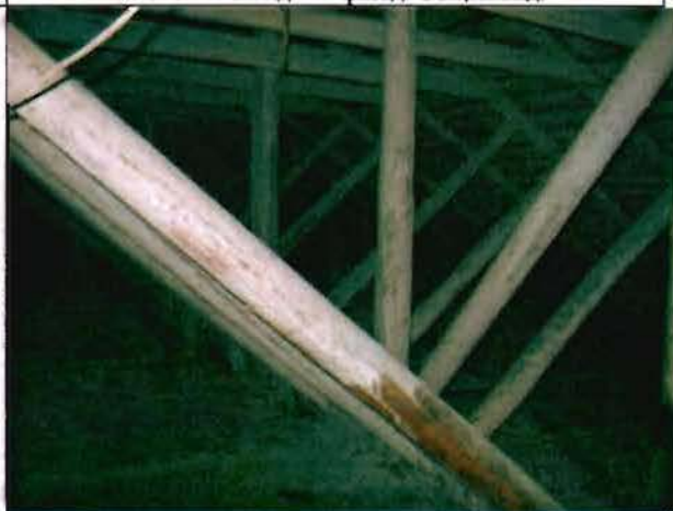
Фото 88. Конструкции крыши. Общий вид.
