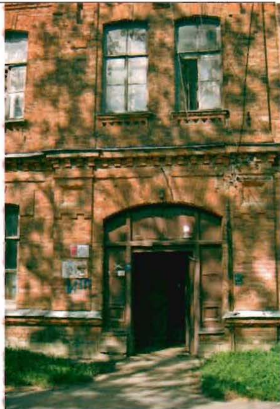
Фото 178. Восточный фасад. Центральная часть. Фрагмент.
