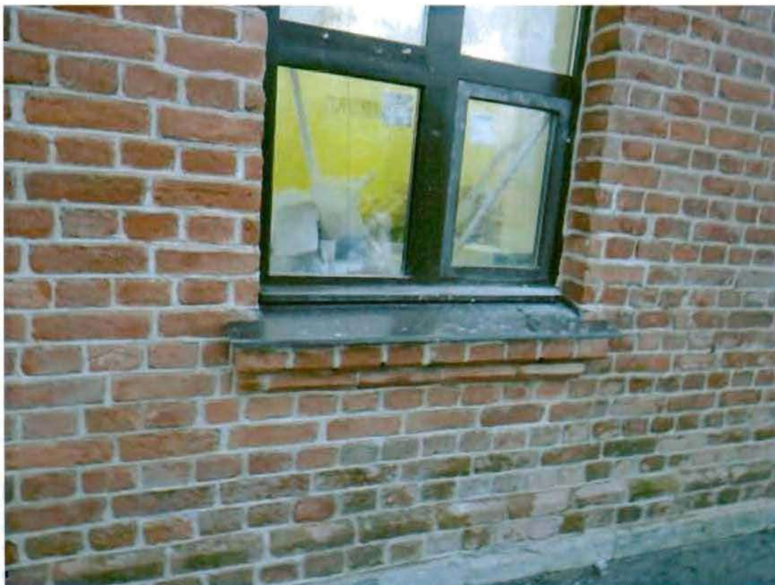
Ступенчатые подоконные доски. Съемка 20.11.2012, Воронина Н.В.
