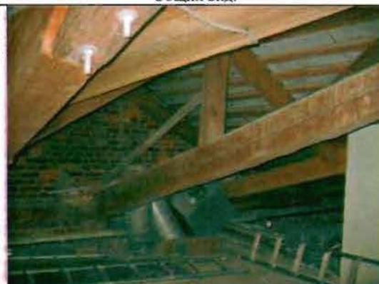
Фото 77. Конструкции крыши. Общий вид.
