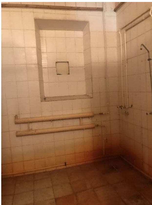
Фото 22. Общий вид помещения №13.
