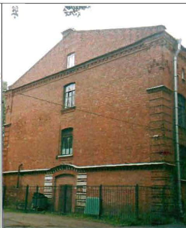
Фото 50. Южный фасад. Общий вид.
