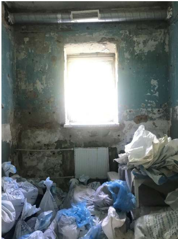
Фото 25. Общий вид помещения №3.
