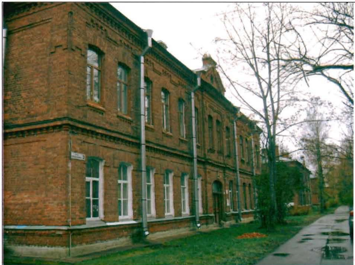
Фото 146. Западный фасад. Общий вид.
