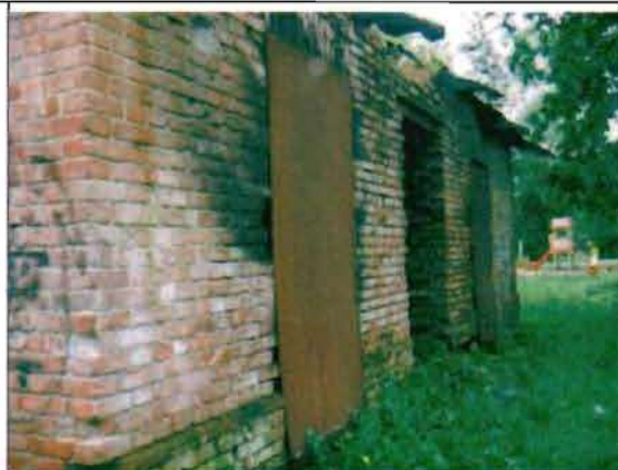
Фото 95. Северный фасад. Общий вид.
