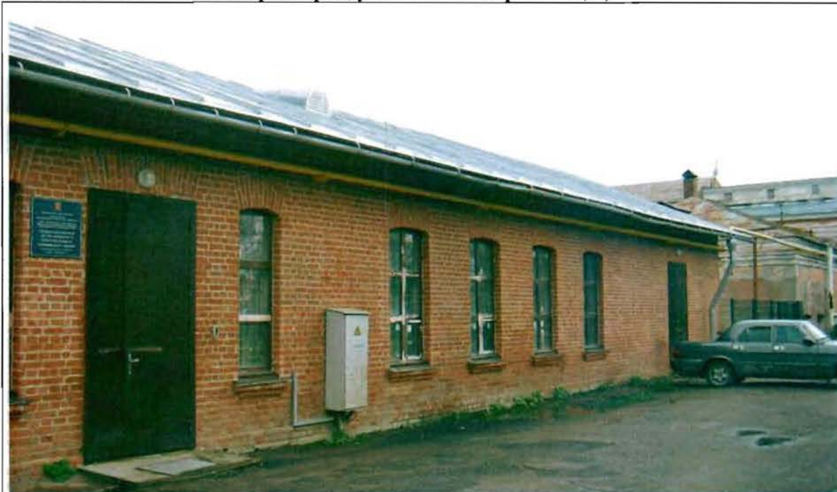
Фото 18. Западный фасад. Общий вид.
