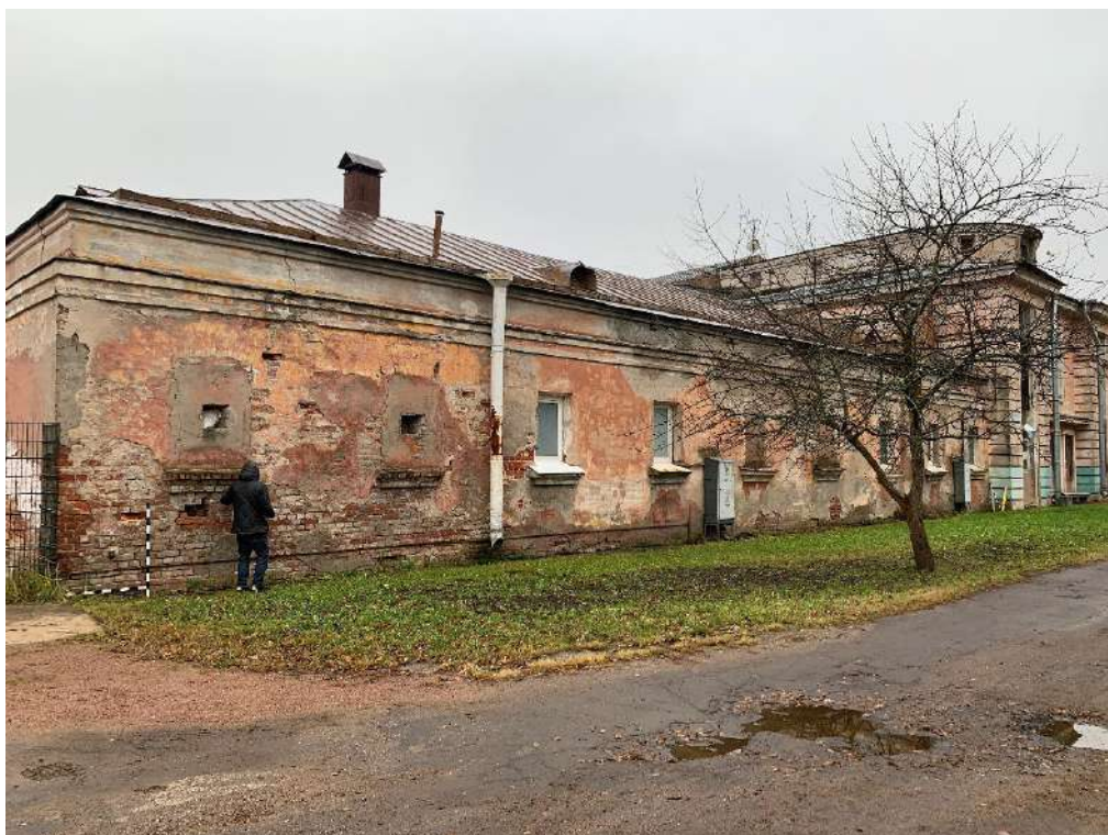
Фото 9. Общий вид фасада по оси А.
