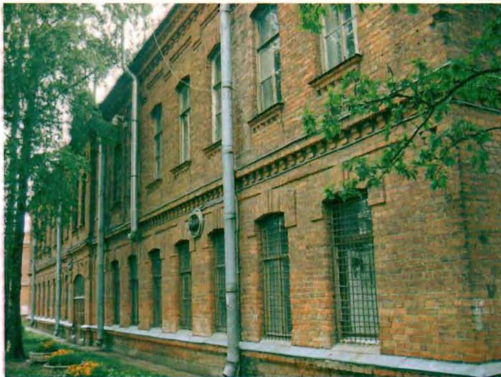
Фото 163. Восточный фасад. Общий вид.
