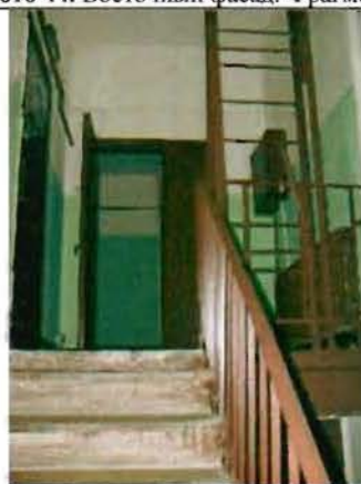
Фото 46. Интерьер. Лестница. Фрагмент.
