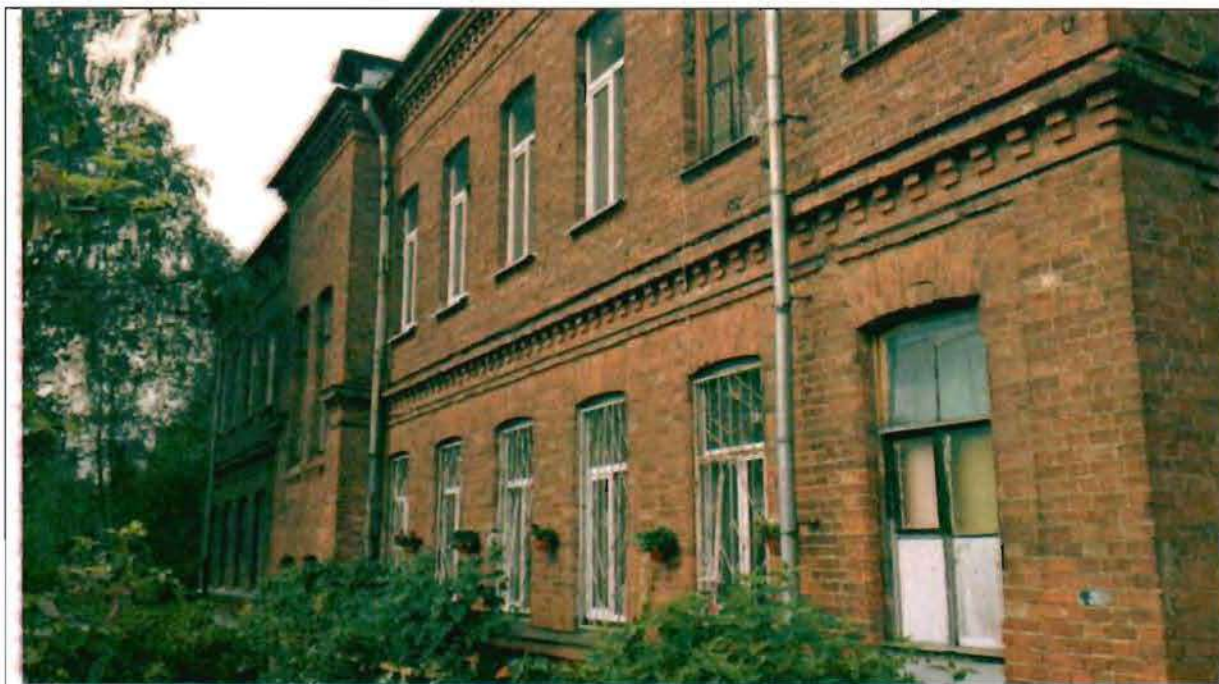
Фото 171. Восточный фасад. Общий вид.
