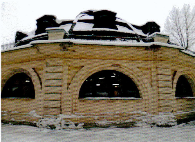
6. Фасад объекта культурного наследия регионального значения «Выводной манеж»
