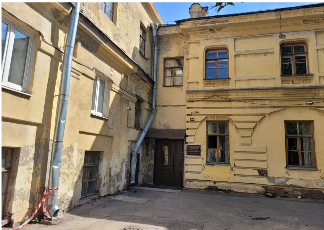
21. Объект культурного наследия регионального значения (ансамбль) «Комплекс построек Главного управления государственного коннозаводства и Санкт-Петербургской аукционной конюшни», расположенный по адресу: Санкт-Петербург, улица Маяковского, дом 15, литера А. Встроенная часть (1970-е гг.) между Служебными (восточным и северным) флигелями. Дата съемки: 28.04.2023г.
