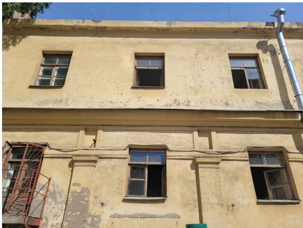
19. Объект культурного наследия регионального значения (ансамбль) «Комплекс построек Главного управления государственного коннозаводства и Санкт-Петербургской аукционной конюшни», расположенный по адресу: Санкт-Петербург, улица Маяковского, дом 15, литера А. Служебный флигель (северный), западная часть. Неисторическая дверь вместо оконного проема. Дата съемки: 28.04.2023г.
