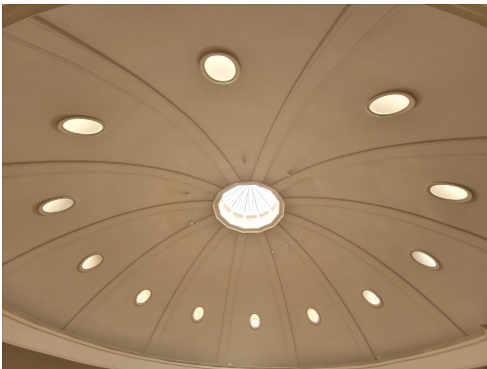
32. Объект культурного наследия регионального значения (ансамбль) «Комплекс построек Главного управления государственного коннозаводства и Санкт-Петербургской аукционной конюшни», расположенный по адресу: Санкт-Петербург, улица Маяковского, дом 15, литера А. Интерьер Выводного манежа. Световой фонарь (в виде жесткого граненого барабана с конусовидным завершением) в завершении купола. Дата съемки: 28.04.2023г.
