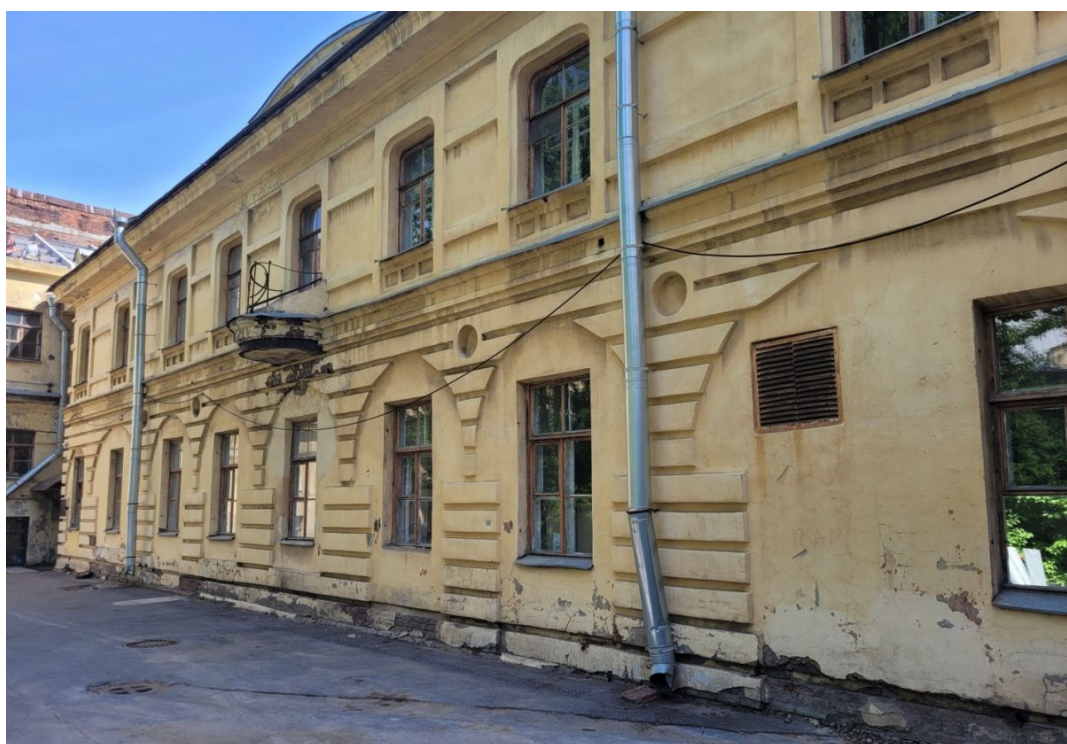
24. Объект культурного наследия регионального значения (ансамбль) «Комплекс построек Главного управления государственного коннозаводства и Санкт-Петербургской аукционной конюшни», расположенный по адресу: Санкт-Петербург, улица Маяковского, дом 15, литера А. Служебный флигель (восточный). Атик фасада по оси балкона. Дощатый руст первого этажа, образующий ложную аркаду. Дата съемки: 28.04.2023г.
