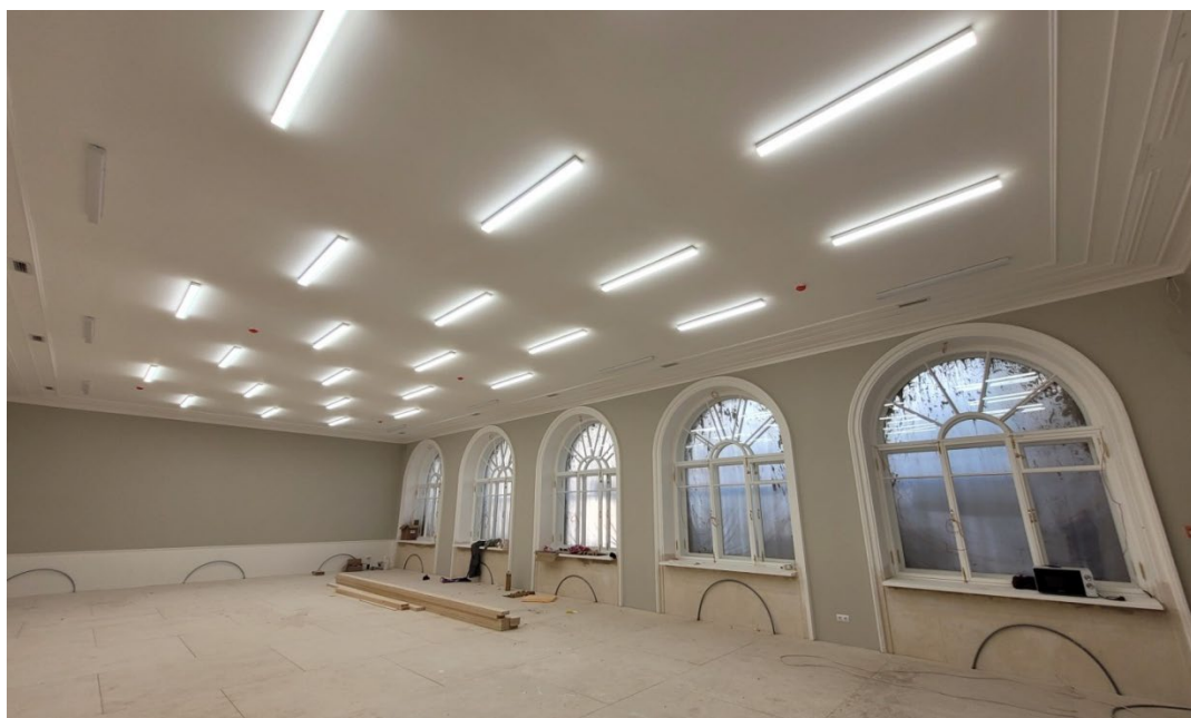
29. Объект культурного наследия регионального значения (ансамбль) «Комплекс построек Главного управления государственного коннозаводства и Санкт-Петербургской аукционной конюшни», расположенный по адресу: Санкт-Петербург, улица Маяковского, дом 15, литера А. Исторические оконные проемы по фасаду Аукционной конюшни – местоположение, полуциркульной конфигурации, габариты; материал (дерево), рисунок расстекловки. Дата съемки: 28.04.2023г.
