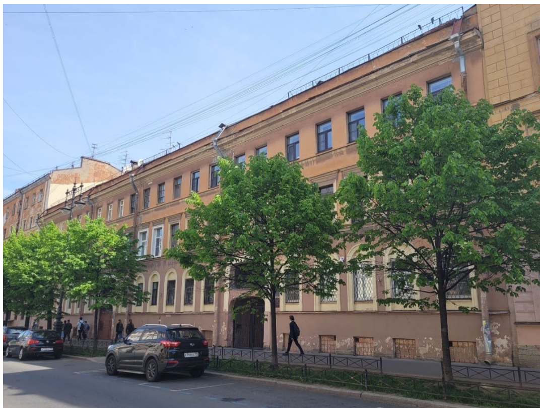
1. Объект культурного наследия регионального значения (ансамбль) «Комплекс построек Главного управления государственного коннозаводства и Санкт-Петербургской аукционной конюшни», расположенный по адресу: Санкт-Петербург, улица Маяковского, дом 15, литера А. Фасад комплекса по улице Маяковского. Дата съемки: 28.04.2023г.
