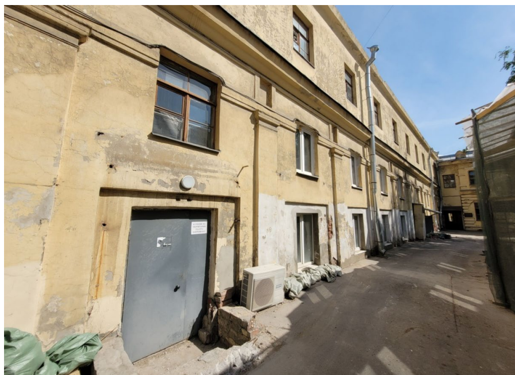
20. Объект культурного наследия регионального значения (ансамбль) «Комплекс построек Главного управления государственного коннозаводства и Санкт-Петербургской аукционной конюшни», расположенный по адресу: Санкт-Петербург, улица Маяковского, дом 15, литера А. Служебный флигель (северный), западная часть. Неисторическая дверь вместо оконного проема. Прямок перед неисторическим входом. Дата съемки: 28.04.2023г.
