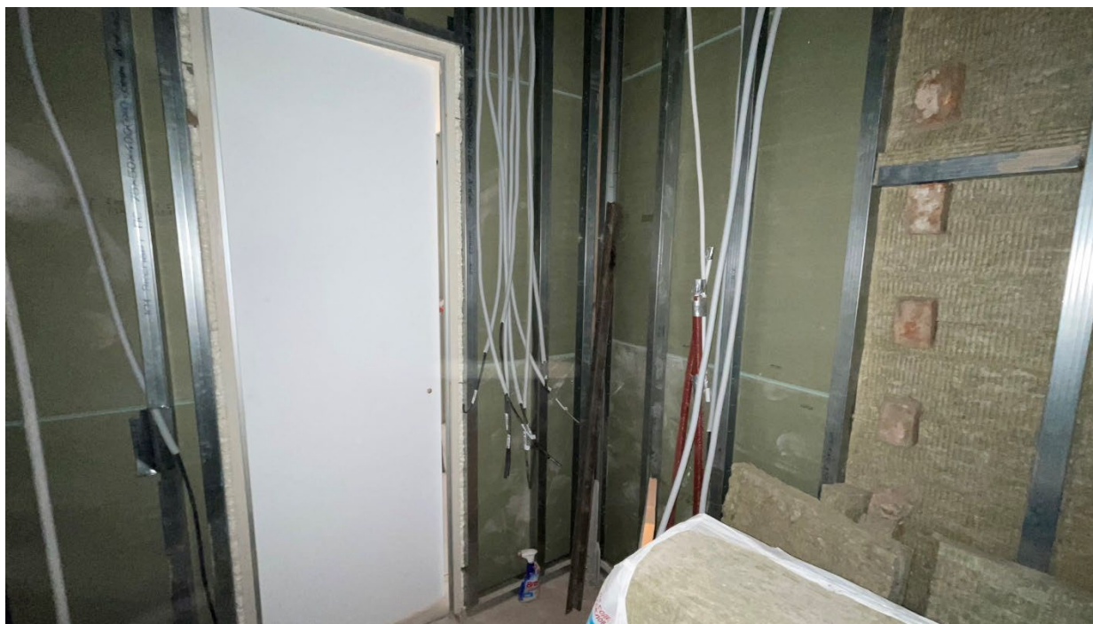
18.Фрагмент интерьера санузла (помещение №9);
