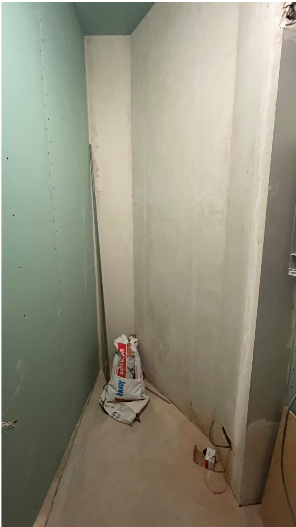
28.Фрагмент интерьера коридора (помещение №6);
