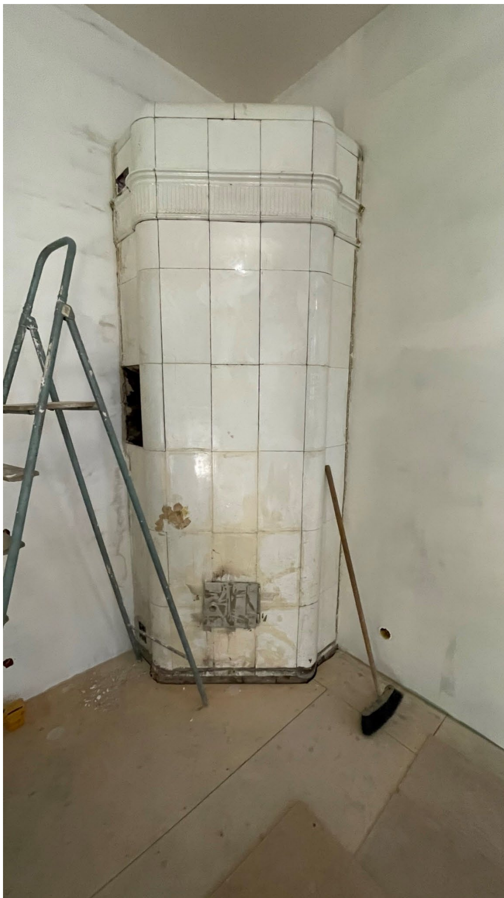
22. Вид на печь (помещение №2);
