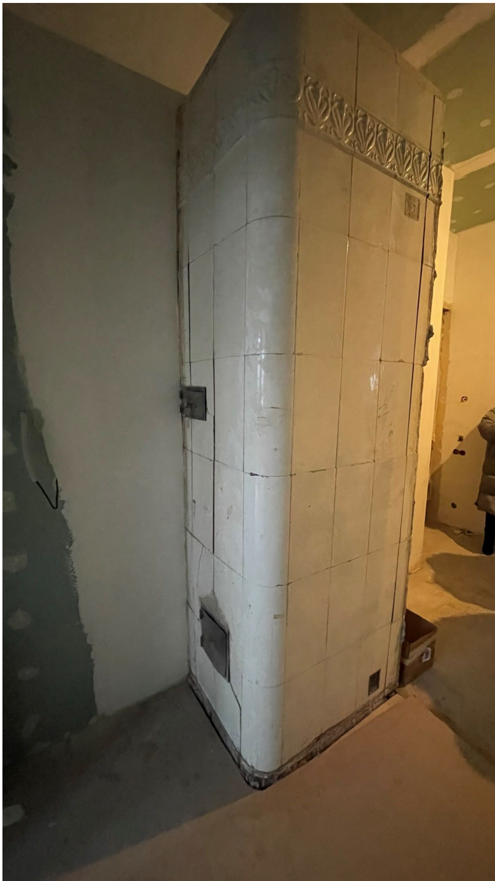
8. Вид на печь (помещение №10);
