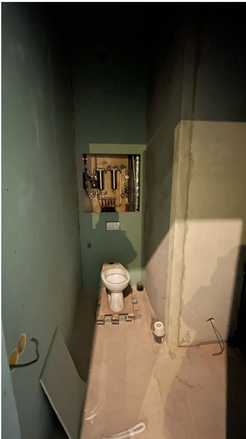
16.Фрагмент интерьера санузла (помещение №9);
