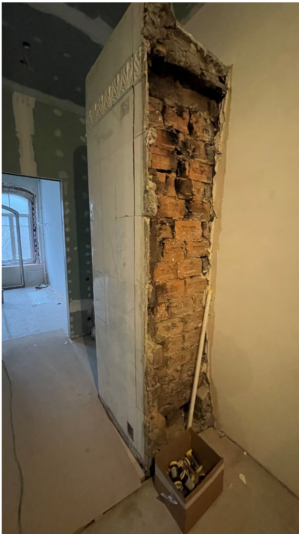
5. Вид на печь (помещение №10);
