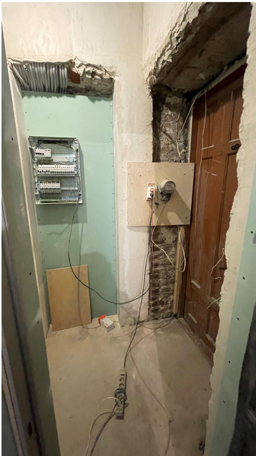
27.Фрагмент интерьера коридора (помещение №6);
