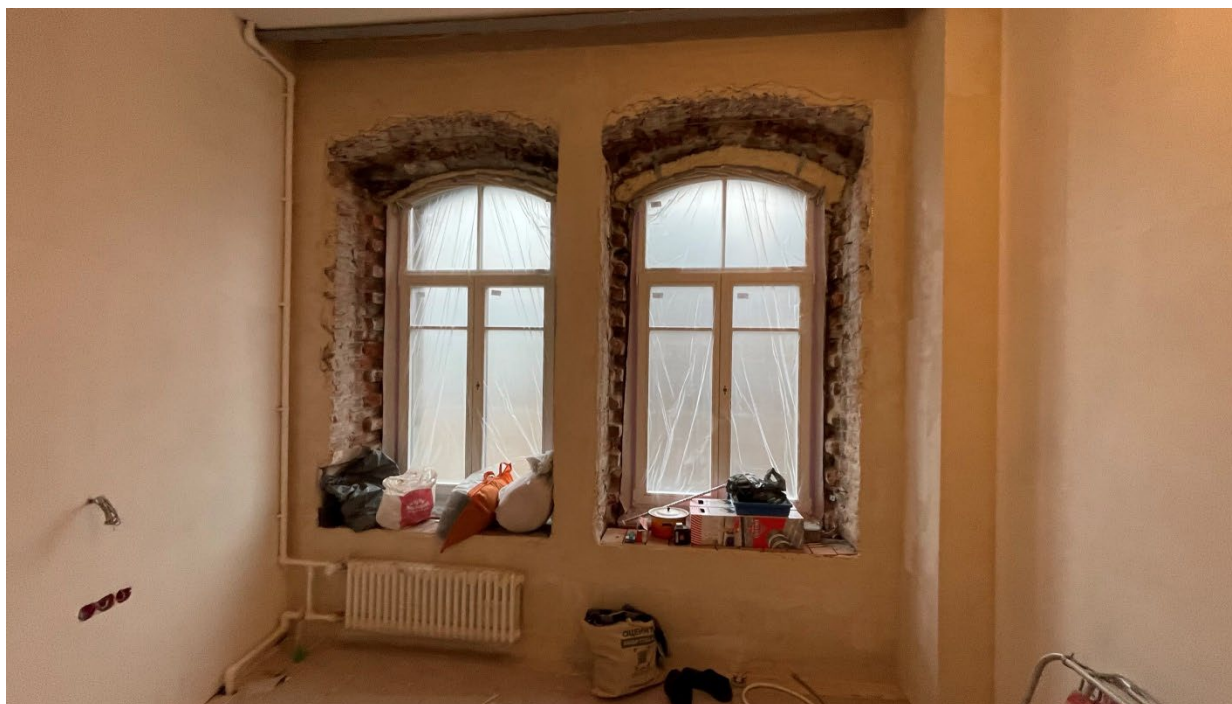
23.Фрагмент интерьера комнаты (помещение №3);
