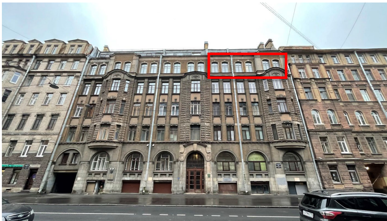
1. Вид на главный фасад здания по 10-ой Советской улице;
