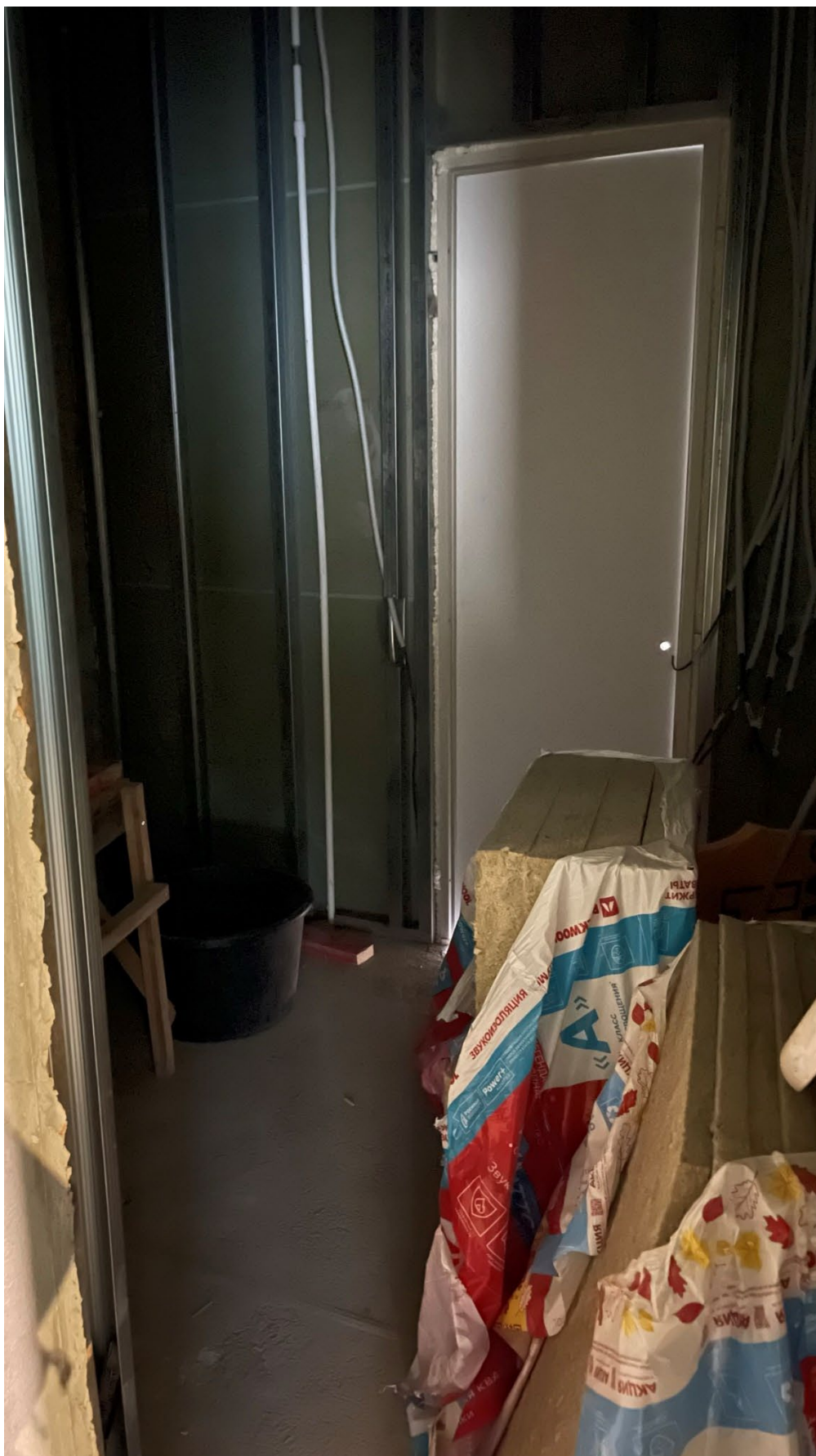
17.Фрагмент интерьера санузла (помещение №9);
