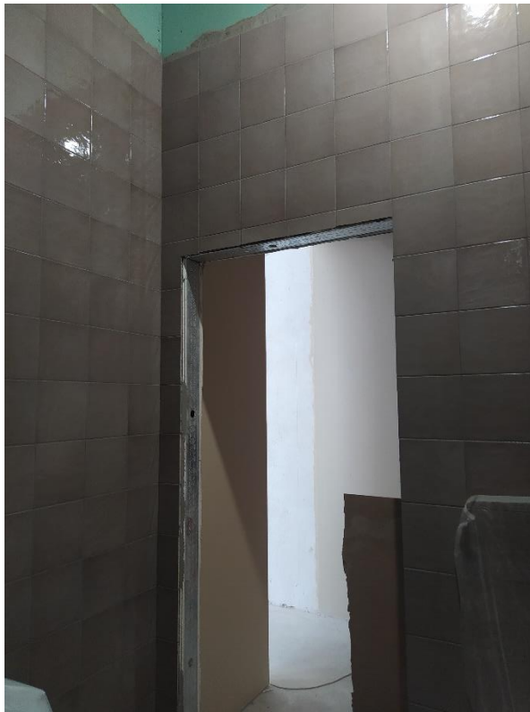
Фото 18. Вид на дверной проём санузла кв. № 33.
