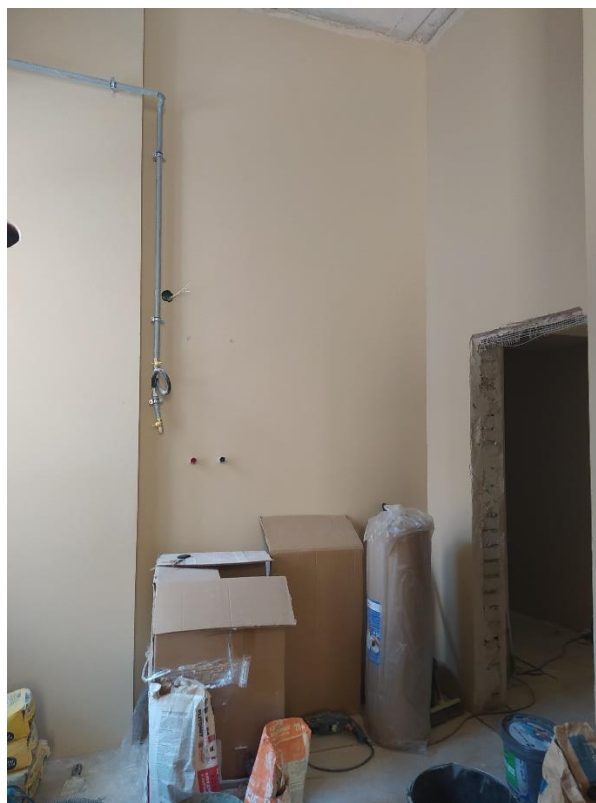
Фото 15. Дверной проём входа на кухню кв. № 33.
