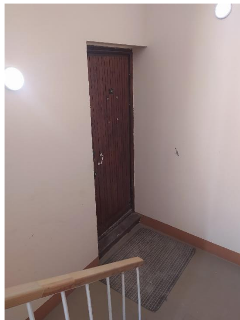
Фото 11. Вход в коридор, ведущий в кв. № 33.
