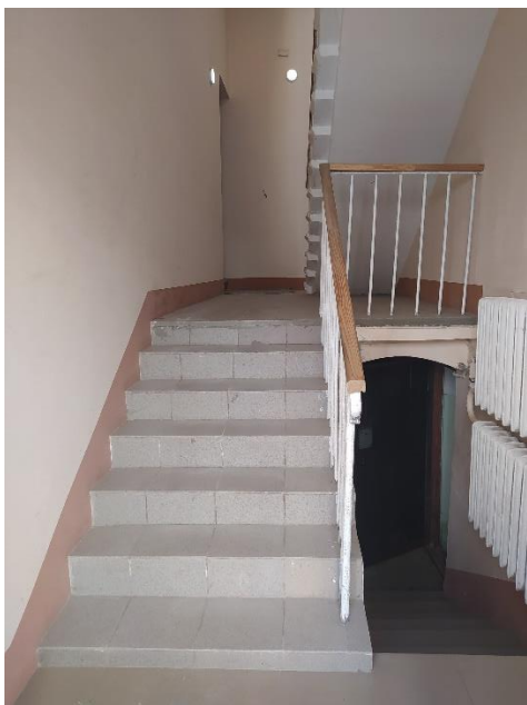
Фото 10. Лестница западного флигеля.
