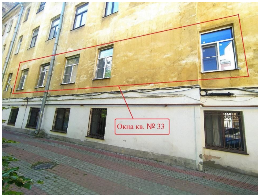
Фото 6.1, 6.2. Объект культурного наследия регионального значения «Дом, в котором в 1888 – 1889 гг. жил художник Серов Валентин Александрович». Вид на окна кв. № 33 на дворовых фасадах в юго-западном направлении.
