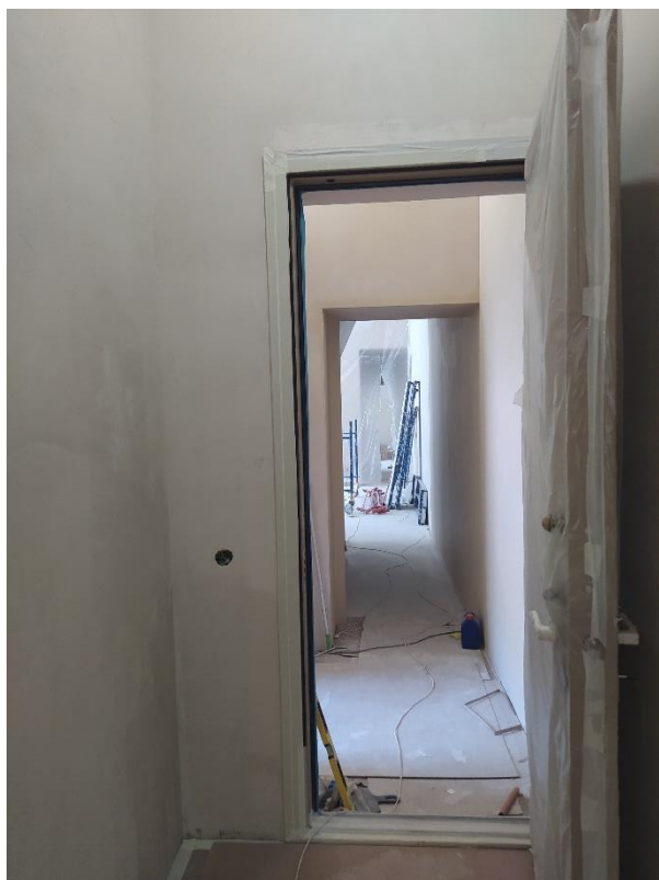
Фото 14. Вид на коридор кв. № 33 со стороны входа.
