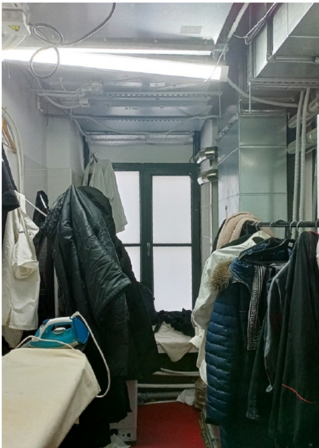
Фото 18. Помещение 11-Н. Техническое помещение.
