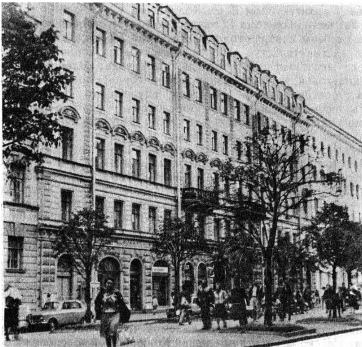
Илл.23 Фрагмент фасада дома №10 по Большой Конюшенной улице 1990-2000-гг
