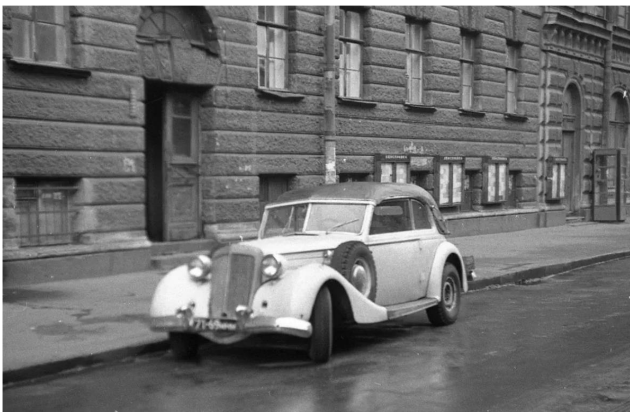
Илл.20 Фрагмент фасада дома №10 по Большой Конюшенной улице 1978– 1983 гг
