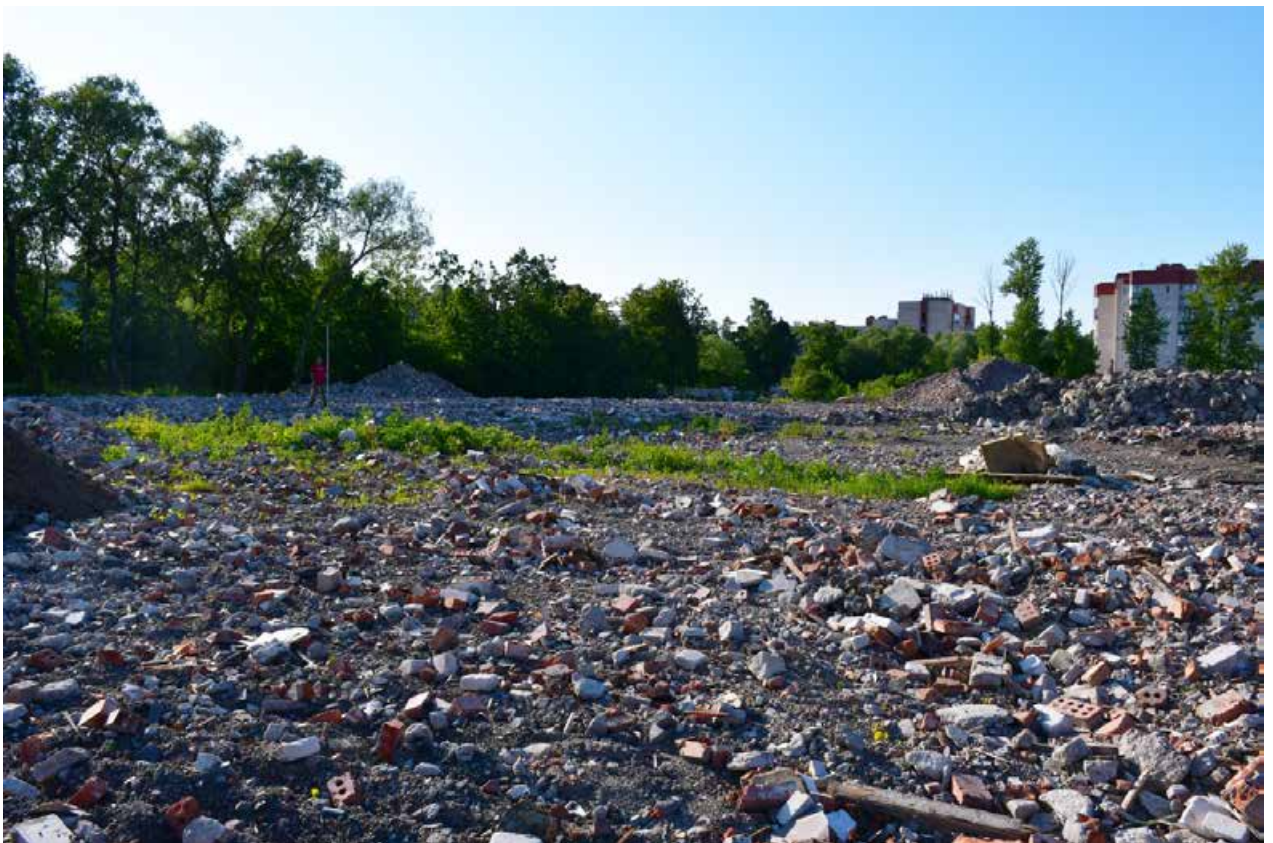
Илл. 15. г. Санкт-Петербург, ул. Тамбасова. Земельный участок с кадастровым номером 78:40:0008472:7780. Точка фото-фиксации №2. Общий вид на обследованный участок. Вид с юго-востока.
