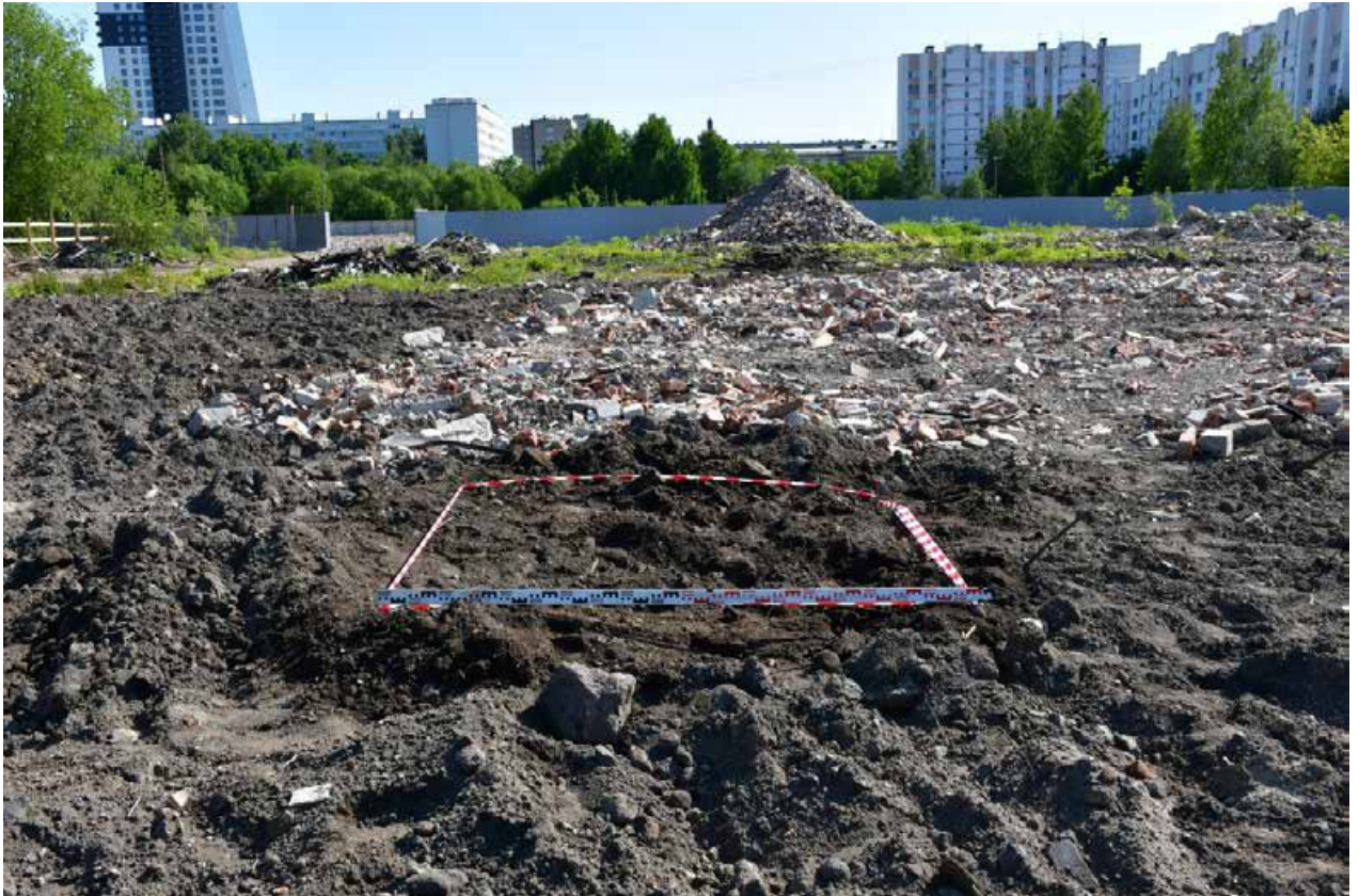
Илл. 30. г. Санкт-Петербург, ул. Тамбасова. Земельный участок с кадастровым номером 78:40:0008472:7780. Шурф №2. До начала работ. Вид с севера.
