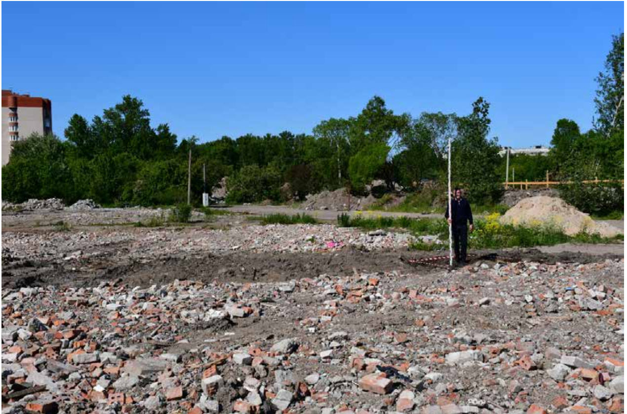
Илл. 28. г. Санкт-Петербург, ул. Тамбасова. Земельный участок с кадастровым номером 78:40:0008472:7780. Шурф №2. Месторасположение. Вид с юго-запада.
