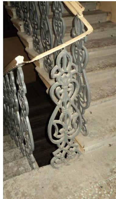
лестница № 4 дворового корпуса – местоположение, габариты, конфигурация, тип (многомаршевая), конструкция (на косоурах), материал ступеней и покрытия пола площадок (известняк).
