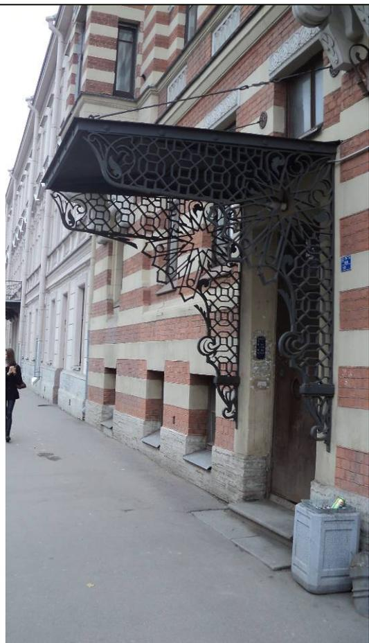
крепление козырька – количество (2 штуки), местоположение, габариты, конфигурация (в виде орнаментированных розеток), материал (металл), техника исполнения (литье, ковка), рисунок;
