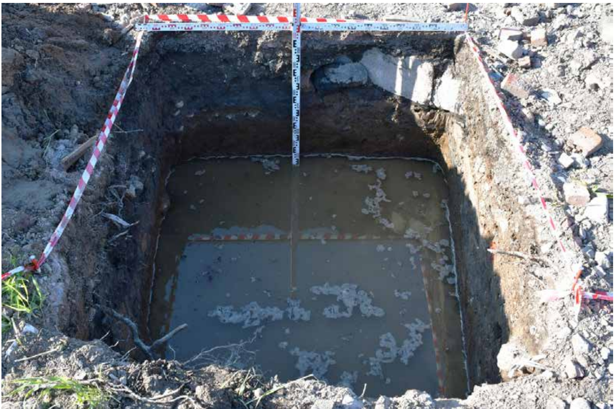
Илл. 40. г. Санкт-Петербург, ул. Тамбасова. Земельный участок с кадастровым номером 78:40:0008472:7778. Шурф №3. Уровень стояния грунтовых вод. Вид с юга.
