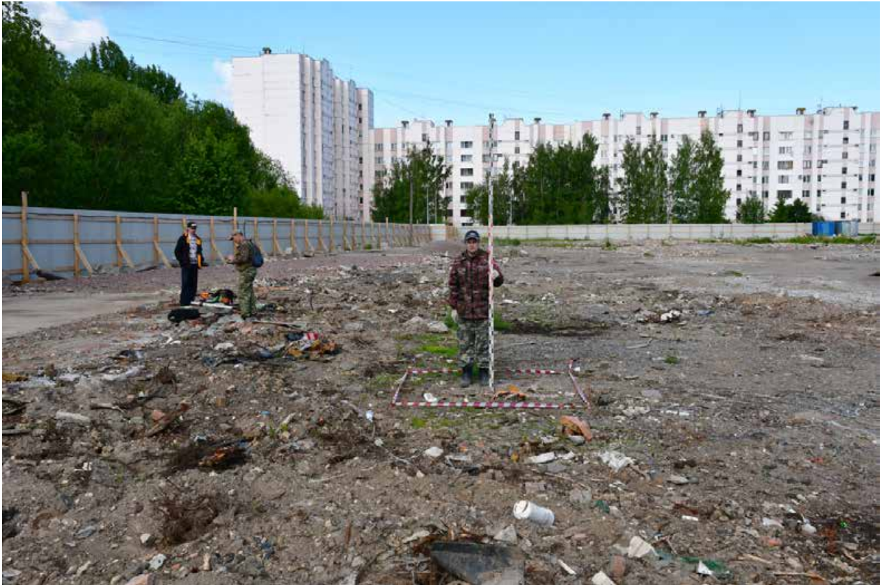
Илл. 28. г. Санкт-Петербург, ул. Тамбасова. Земельный участок с кадастровым номером 78:40:0008472:7778. Шурф №2. Месторасположение. Вид с востока.
