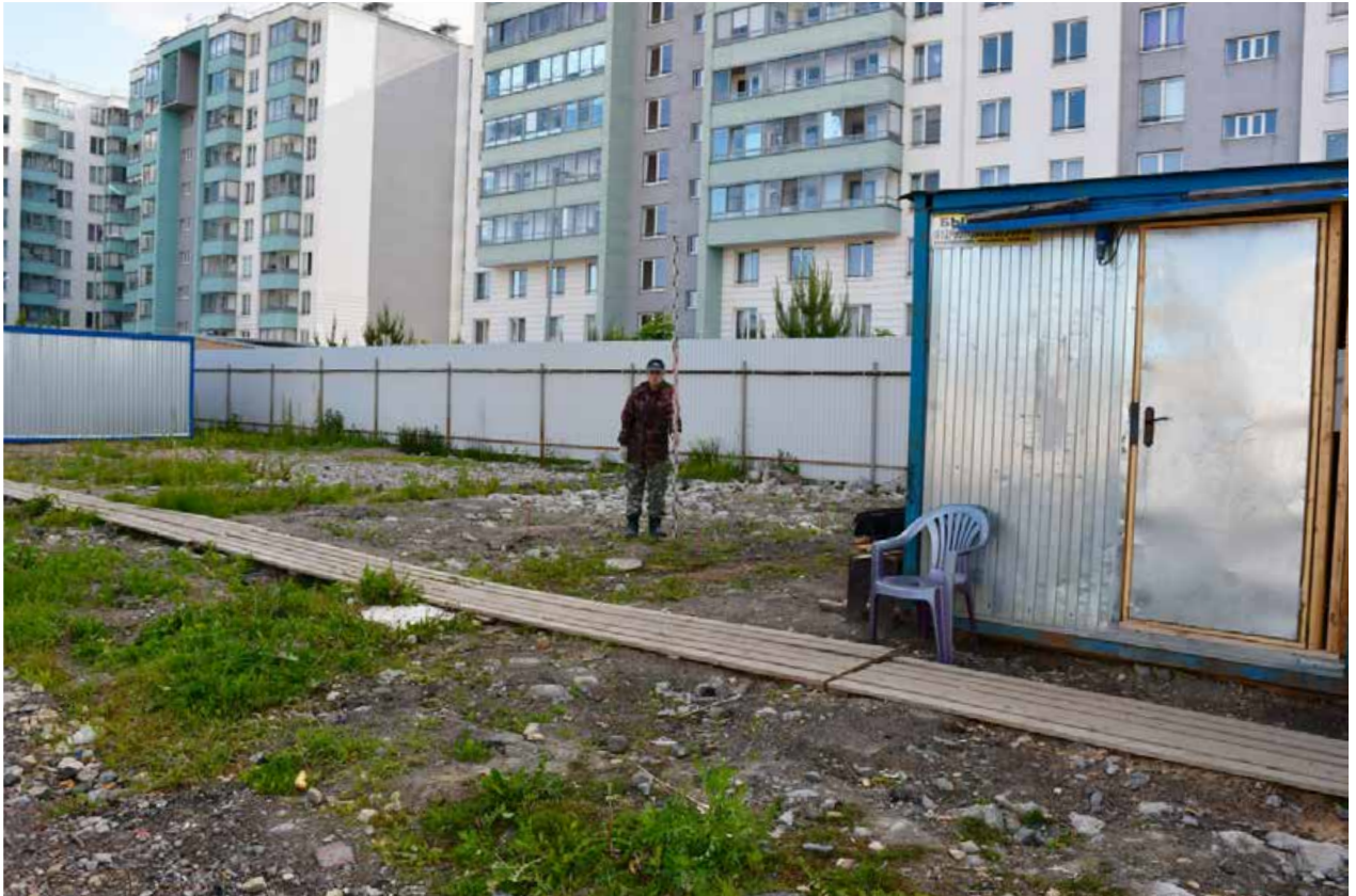
Илл. 18. г. Санкт-Петербург, ул. Тамбасова. Земельный участок с кадастровым номером 78:40:0008472:7778. Шурф №1. Месторасположение. Вид с юго-запада.
