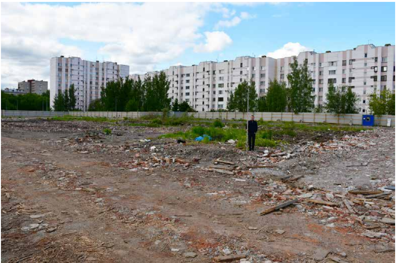
Илл. 38. г. Санкт-Петербург, ул. Тамбасова. Земельный участок с кадастровым номером 78:40:0008472:7778. Шурф №3. Месторасположение. Вид с северо-востока.
