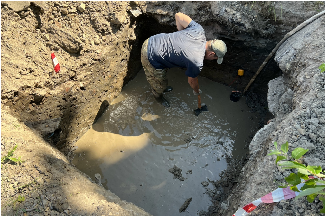
Илл. 22. г. Санкт-Петербург, ул. Тамбасова. Земельный участок с кадастровым номером 78:40:0008472:7777. Шурф №1. Поступление грунтовых вод во время разборки слоя шурфа. Вид с северо-востока.
