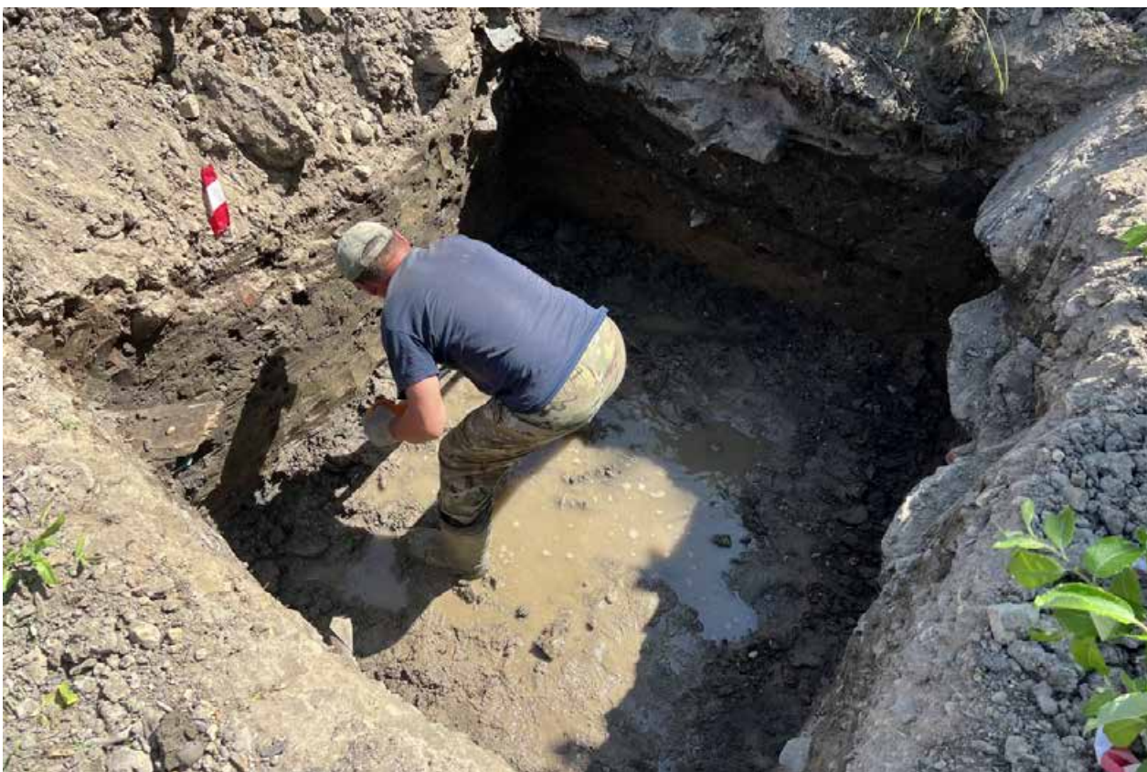
Илл. 21. г. Санкт-Петербург, ул. Тамбасова. Земельный участок с кадастровым номером 78:40:0008472:7777. Шурф №1. Поступление грунтовых вод во время разборки слоя шурфа. Вид с северо-востока.
