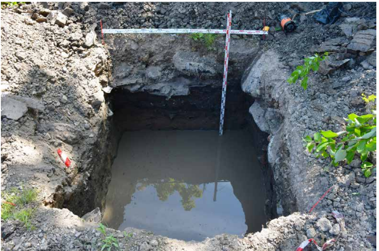
Илл. 23. г. Санкт-Петербург, ул. Тамбасова. Земельный участок с кадастровым номером 78:40:0008472:7777. Шурф №1. Уровень стояния грунтовых вод. Вид с севера.
