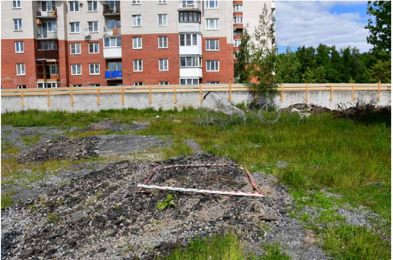
Илл. 30. г. Санкт-Петербург, ул. Тамбасова. Земельный участок с кадастровым номером 78:40:0008472:7777. Шурф №2. До начала работ. Вид с юга.
