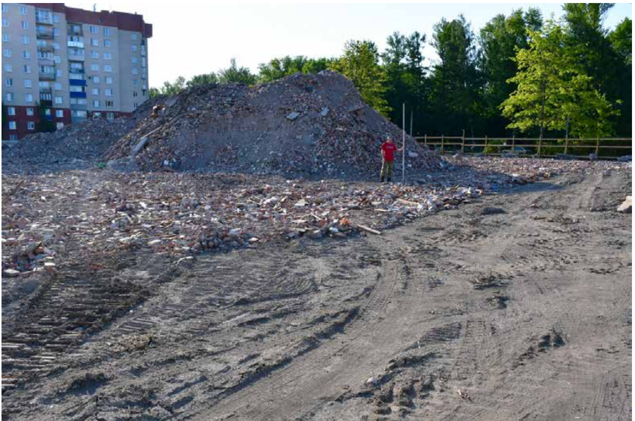
Илл. 15. г. Санкт-Петербург. ул. Тамбасова. Земельный участок с кадастровым номером 78:40:0008472:7776. Точка фото-фиксации №2. Общий вид на обследованный участок. Вид с юго-востока.
