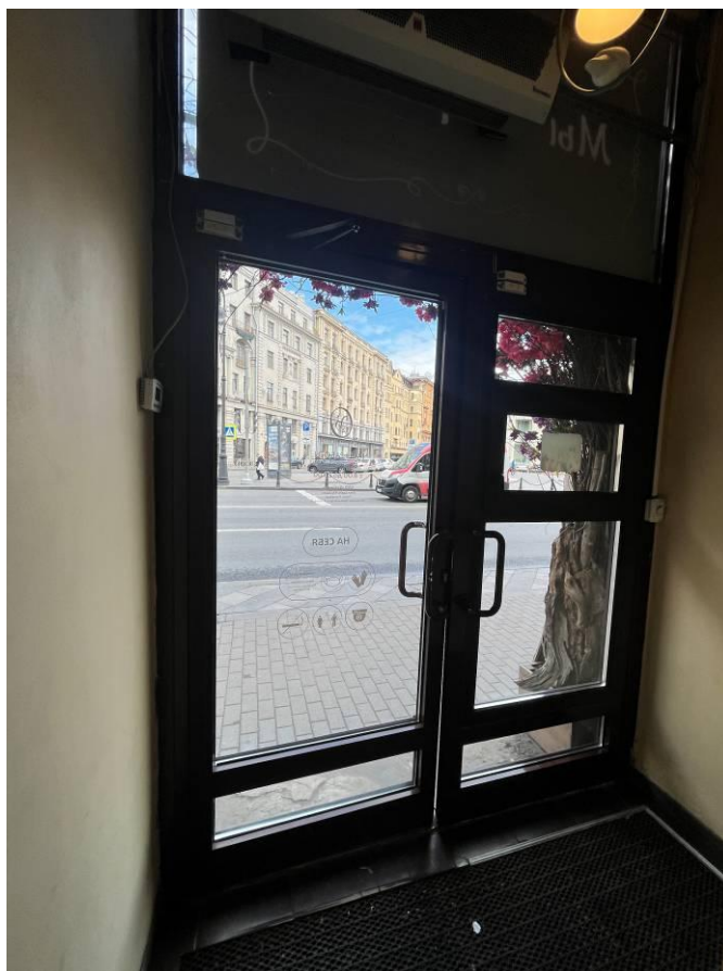
Фото 59. Интерьер помещения 2-Н выявленного объекта культурного наследия «Дом А.И. Цеховой»
