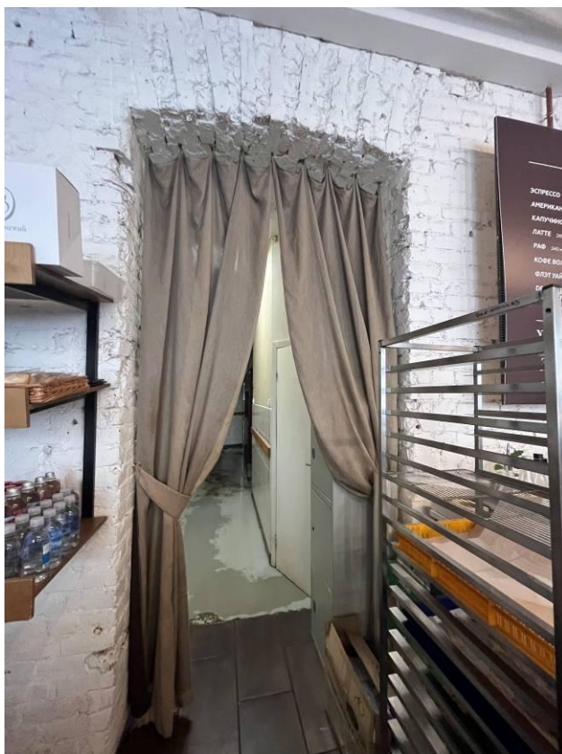
Фото 53. Интерьер помещения 2-Н выявленного объекта культурного наследия «Дом А.И. Цеховой»
