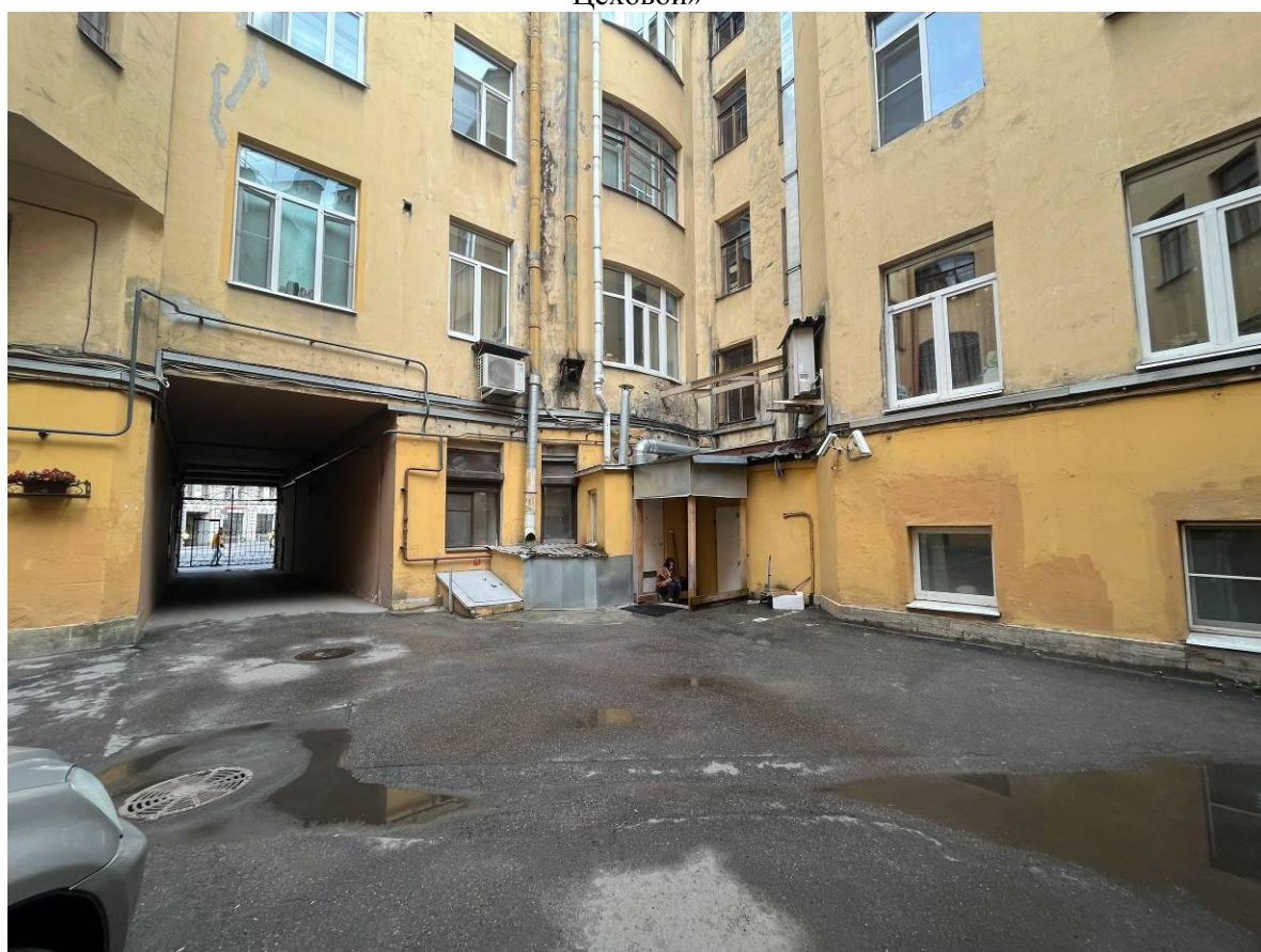
Фото 8. Фрагмент дворового фасада выявленного объекта культурного наследия «Дом А.И. Цеховой»
