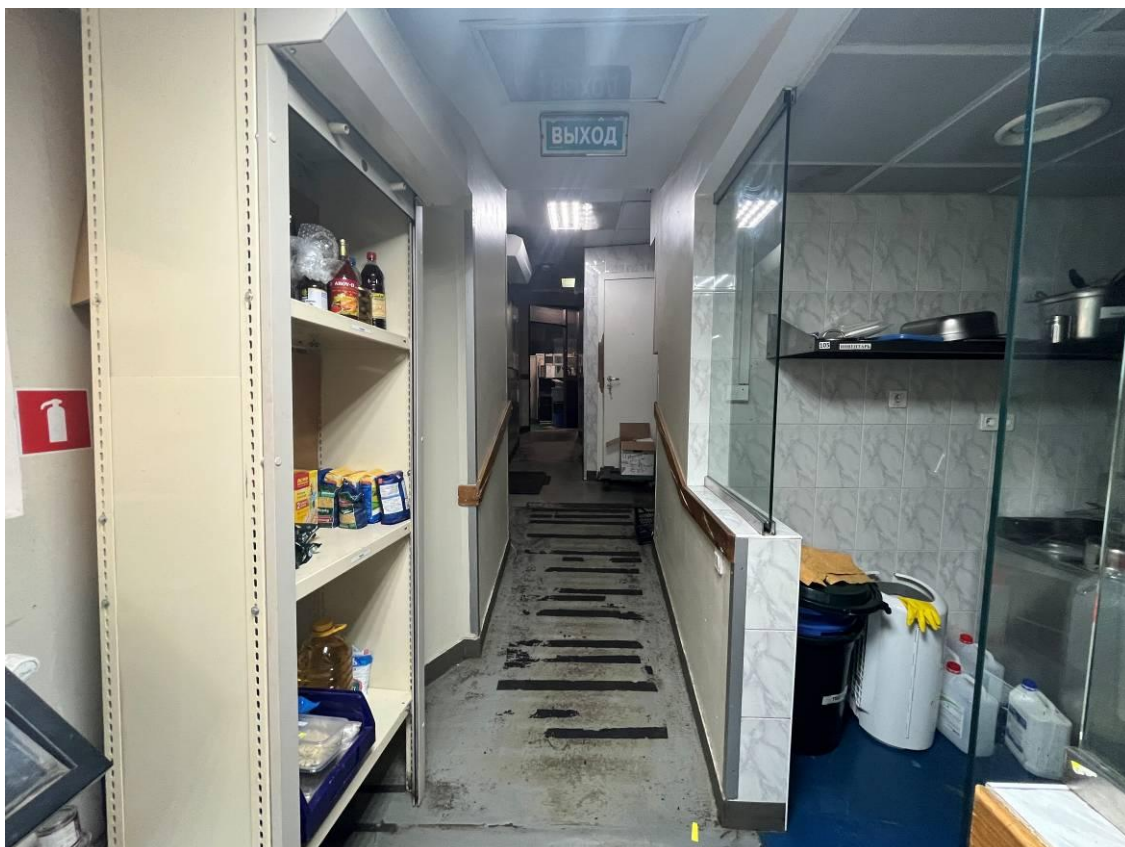
Фото 37. Интерьер помещения 2-Н выявленного объекта культурного наследия «Дом А.И. Цеховой»
