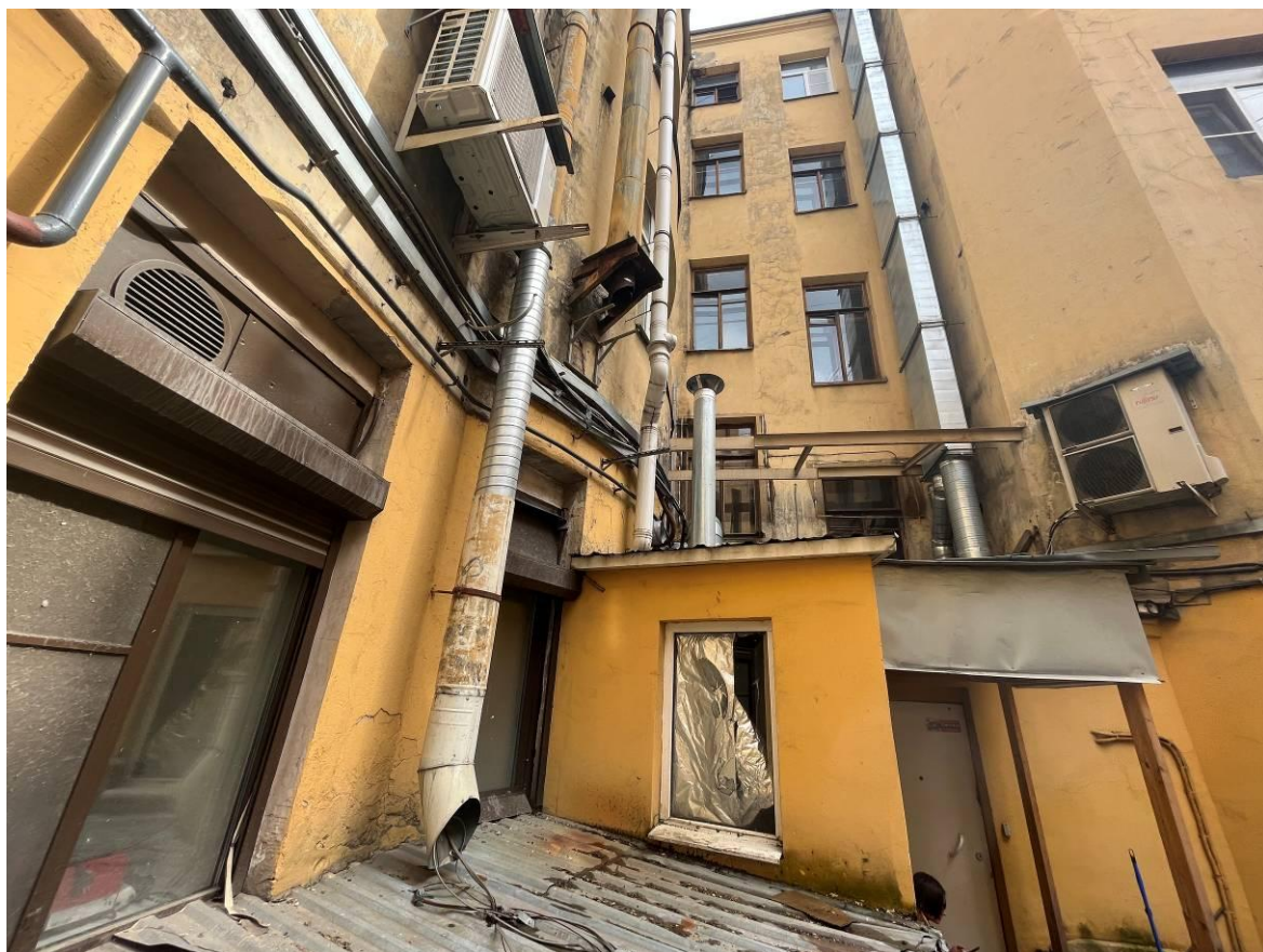
Фото 7. Фрагмент дворового фасада выявленного объекта культурного наследия «Дом А.И. Цеховой»
