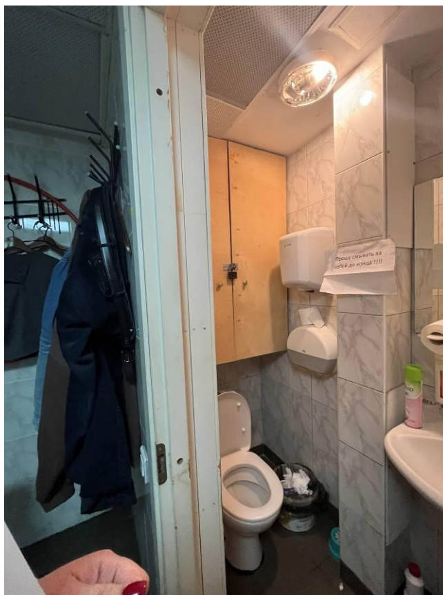
Фото 17. Интерьер помещения 2-Н выявленного объекта культурного наследия «Дом А.И. Цеховой»
