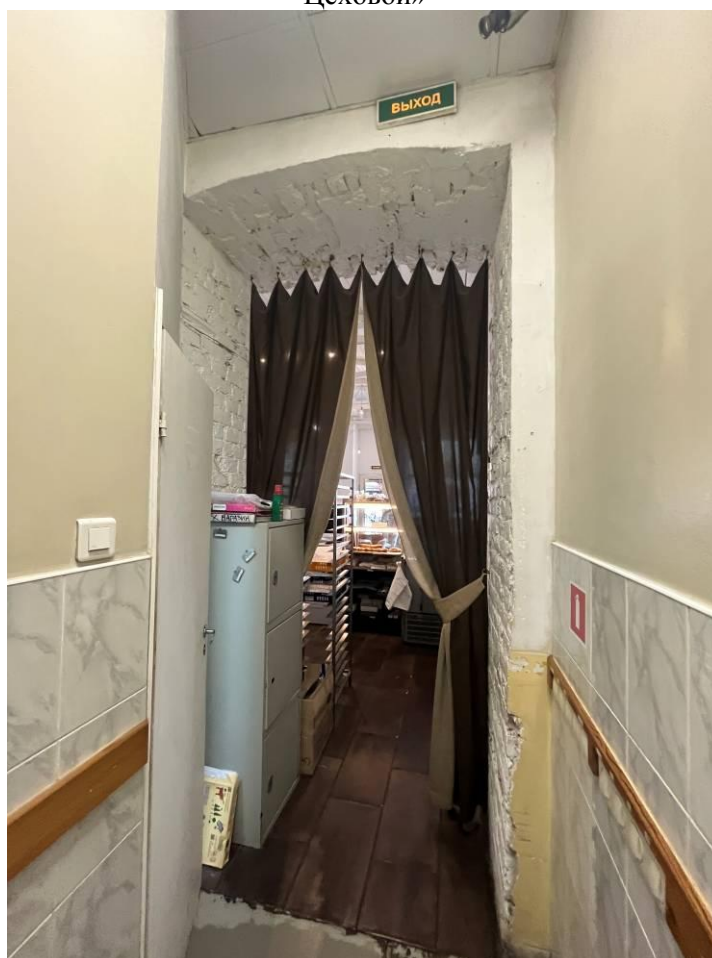
Фото 52. Интерьер помещения 2-Н выявленного объекта культурного наследия «Дом А.И. Цеховой»
