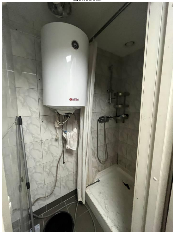
Фото 18. Интерьер помещения 2-Н выявленного объекта культурного наследия «Дом А.И. Цеховой»
