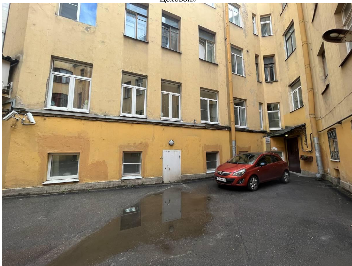
Фото 10. Фрагмент дворового фасада выявленного объекта культурного наследия «Дом А.И. Цеховой»
