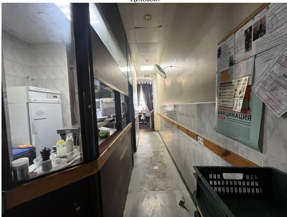
Фото 44. Интерьер помещения 2-Н выявленного объекта культурного наследия «Дом А.И. Цеховой»
