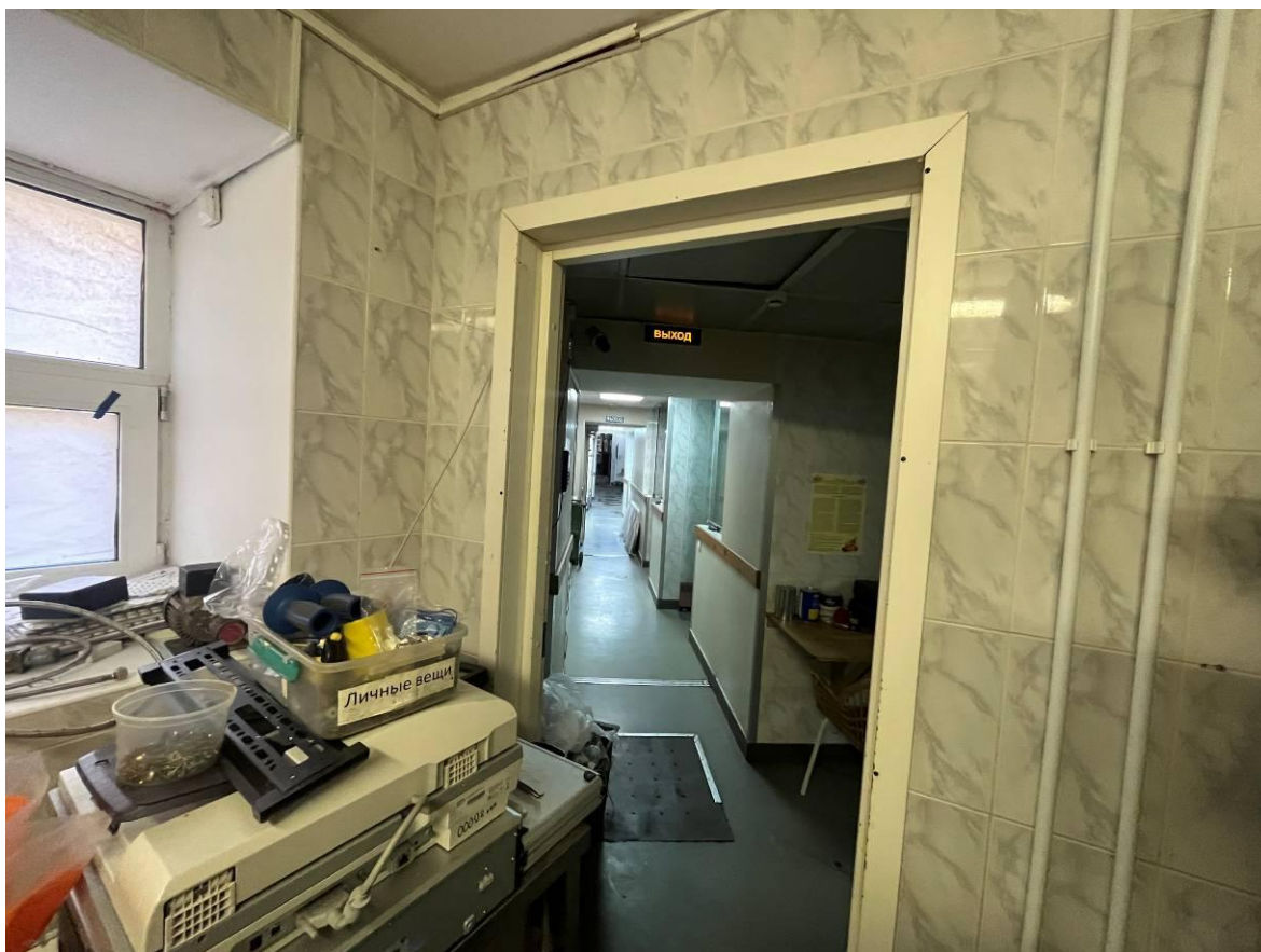
Фото 13. Интерьер помещения 2-Н выявленного объекта культурного наследия «Дом А.И. Цеховой»
