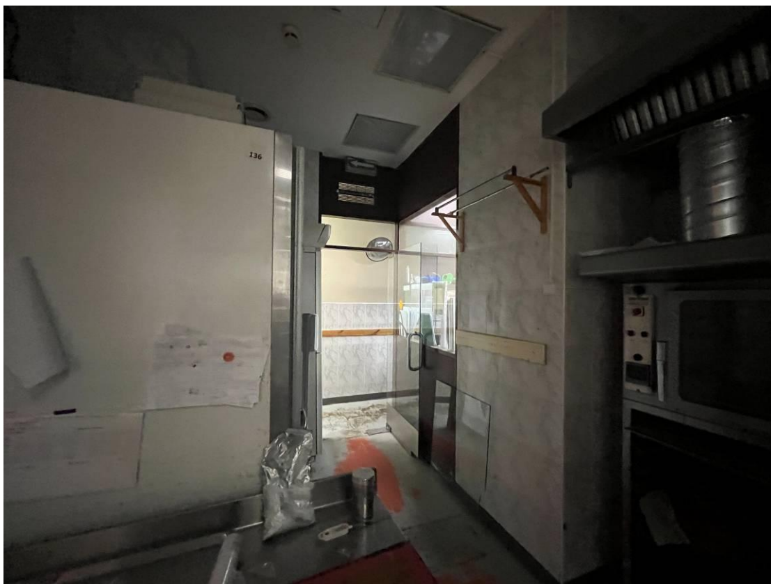
Фото 51. Интерьер помещения 2-Н выявленного объекта культурного наследия «Дом А.И. Цеховой»
