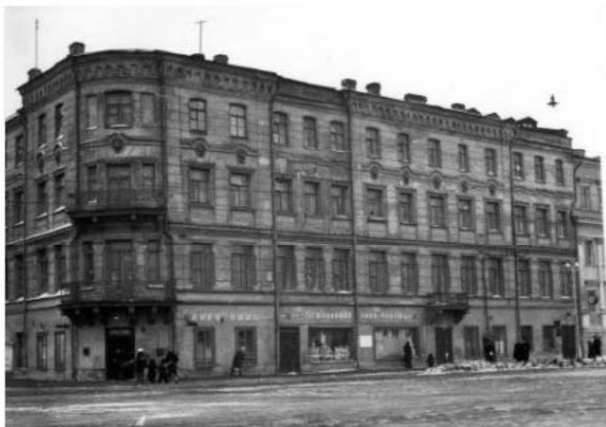
Илл. 86. Вид дома № 25 в 1953 г. // Источник: https://www.citywalls.ru/house7913.html
