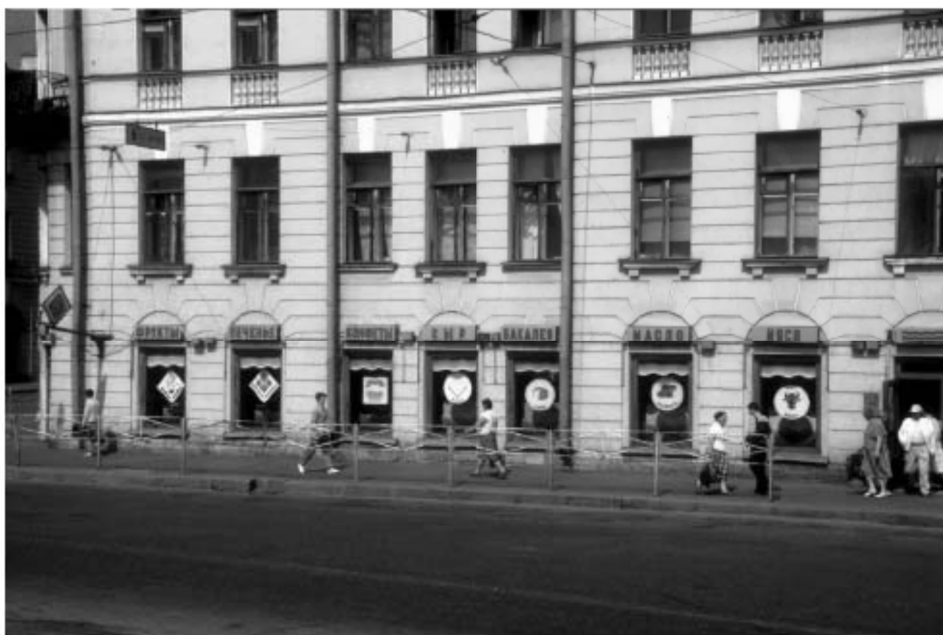
Илл. 100. Магазины СЗРП на Университетской набережной. 1991 г. // Источник: https://pastvu.com/p/147043
