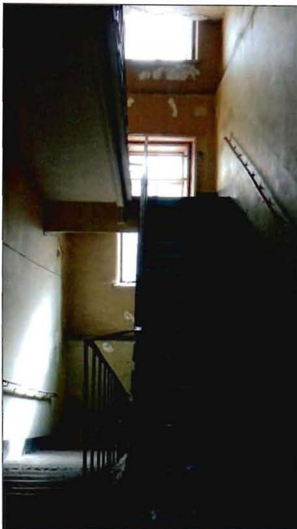
13. Лестница в западной части южного корпуса по ул. Почтамтской.
