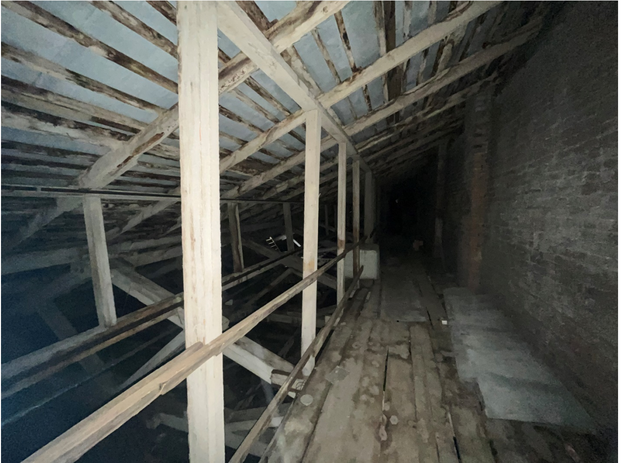
Фото №18. Чердачное пространство, фрагмент стропильной системы.
