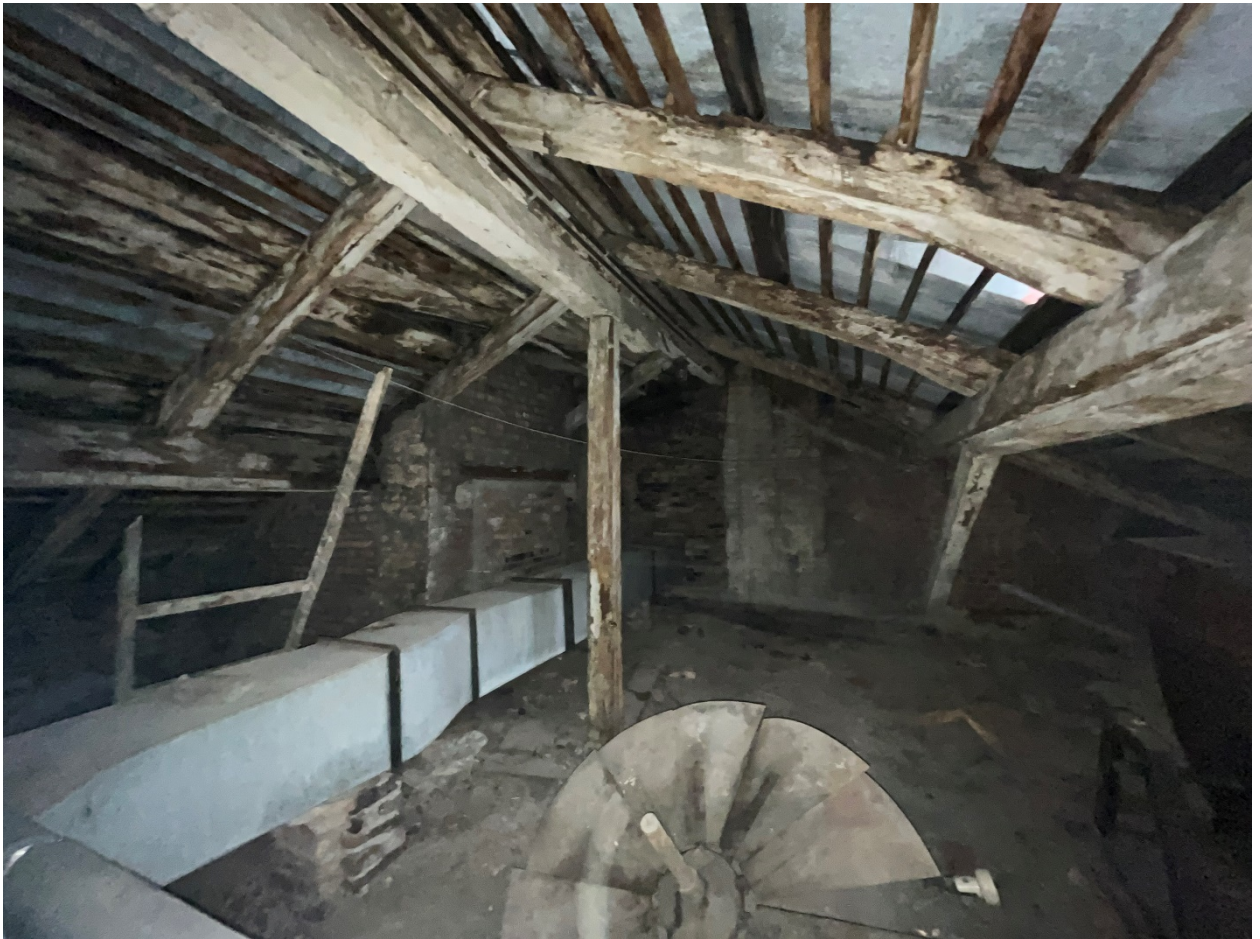
Фото №10. Чердачное пространство, фрагмент стропильной системы.
