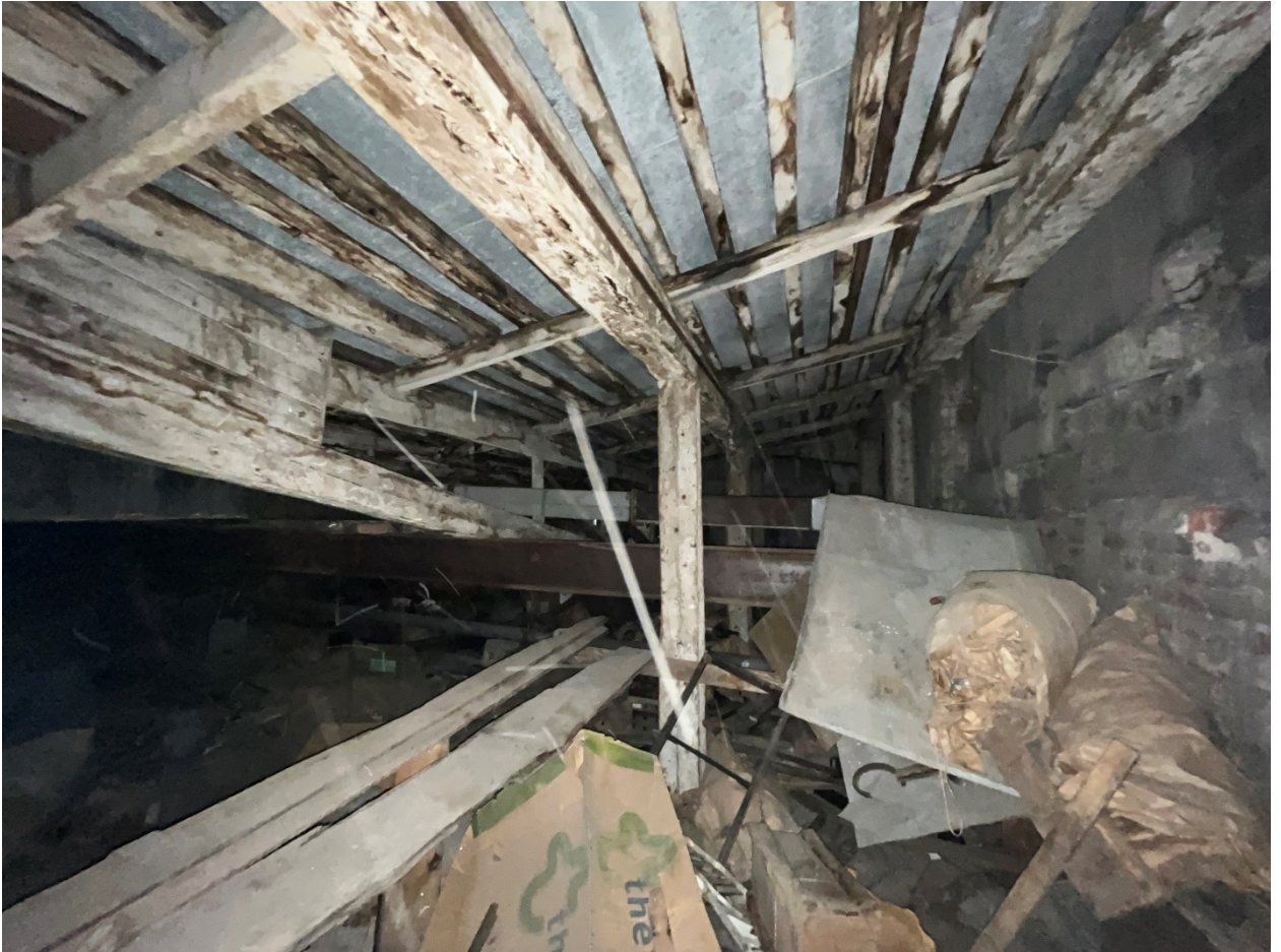
Фото №19. Чердачное пространство, фрагмент стропильной системы.
