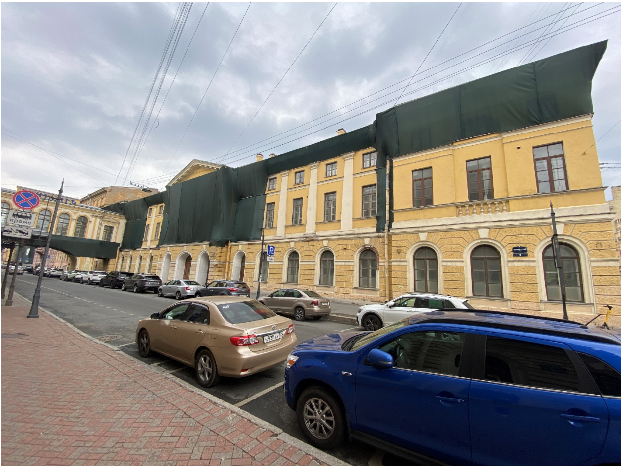
Фото №1. Угол северо-восточного и юго-восточного фасадов.
