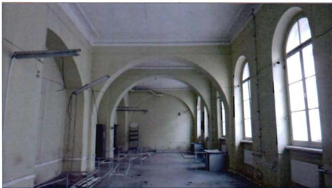
10. Перекрытие на арках. Первый этаж.
