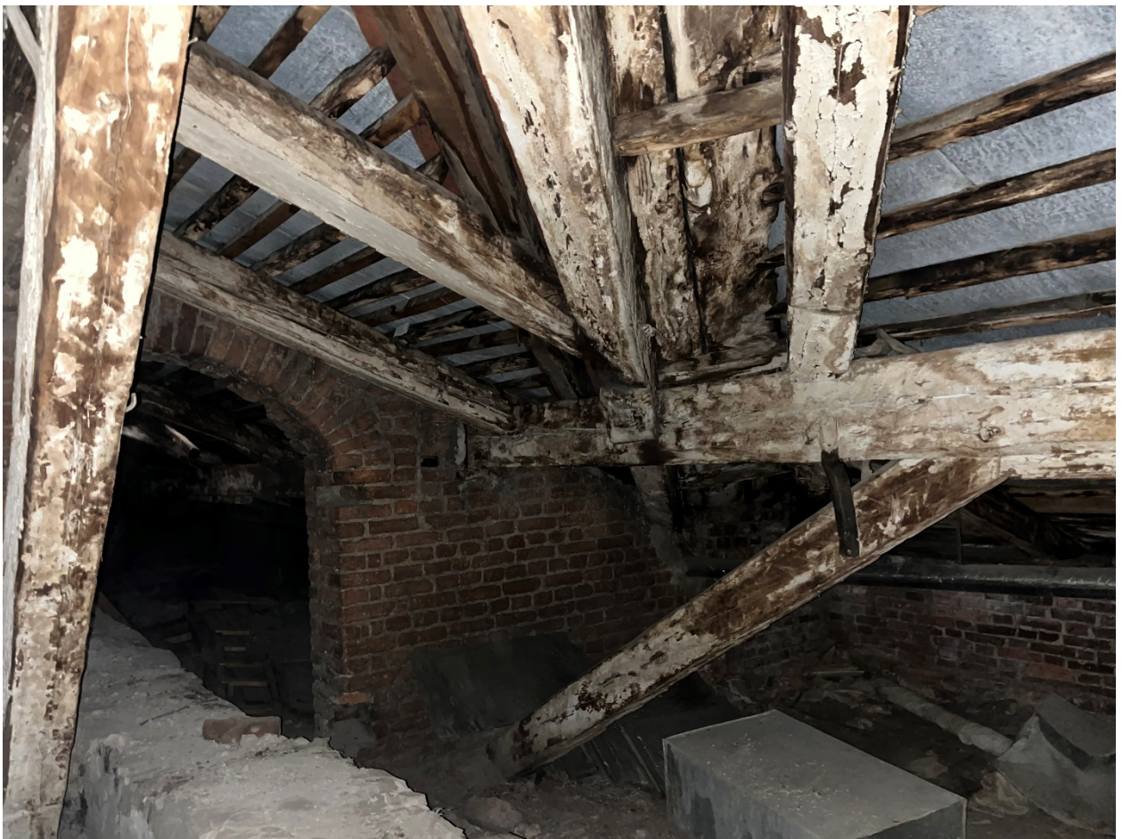
Фото №6. Чердачное пространство, фрагмент стропильной системы.
