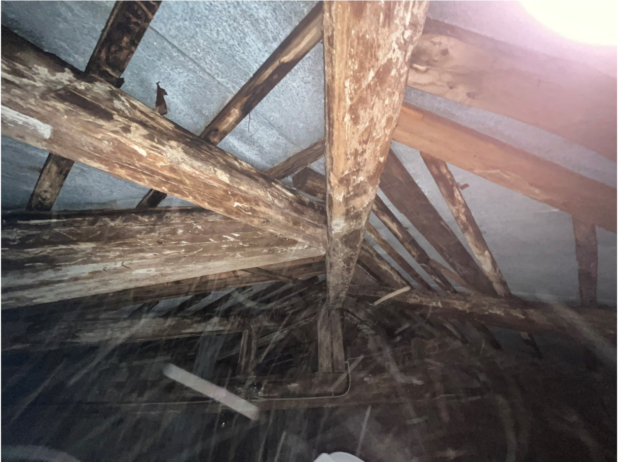
Фото №9. Чердачное пространство, фрагмент стропильной системы.
