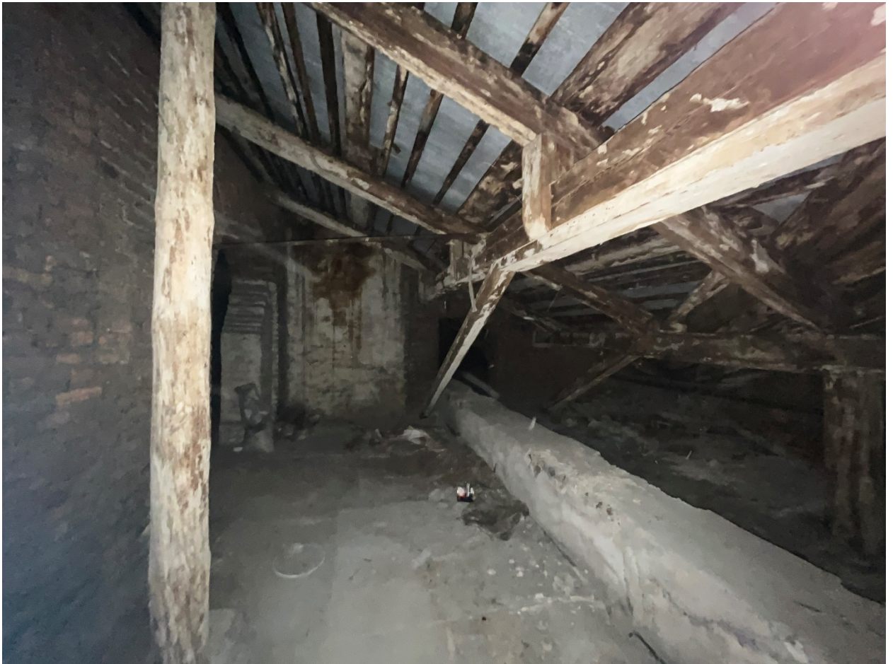
Фото №7. Чердачное пространство, фрагмент стропильной системы.
