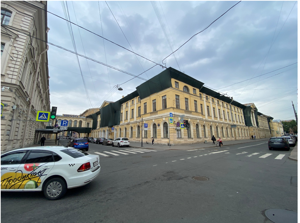
Фото №4. Фрагмент юго-восточного фасада.
