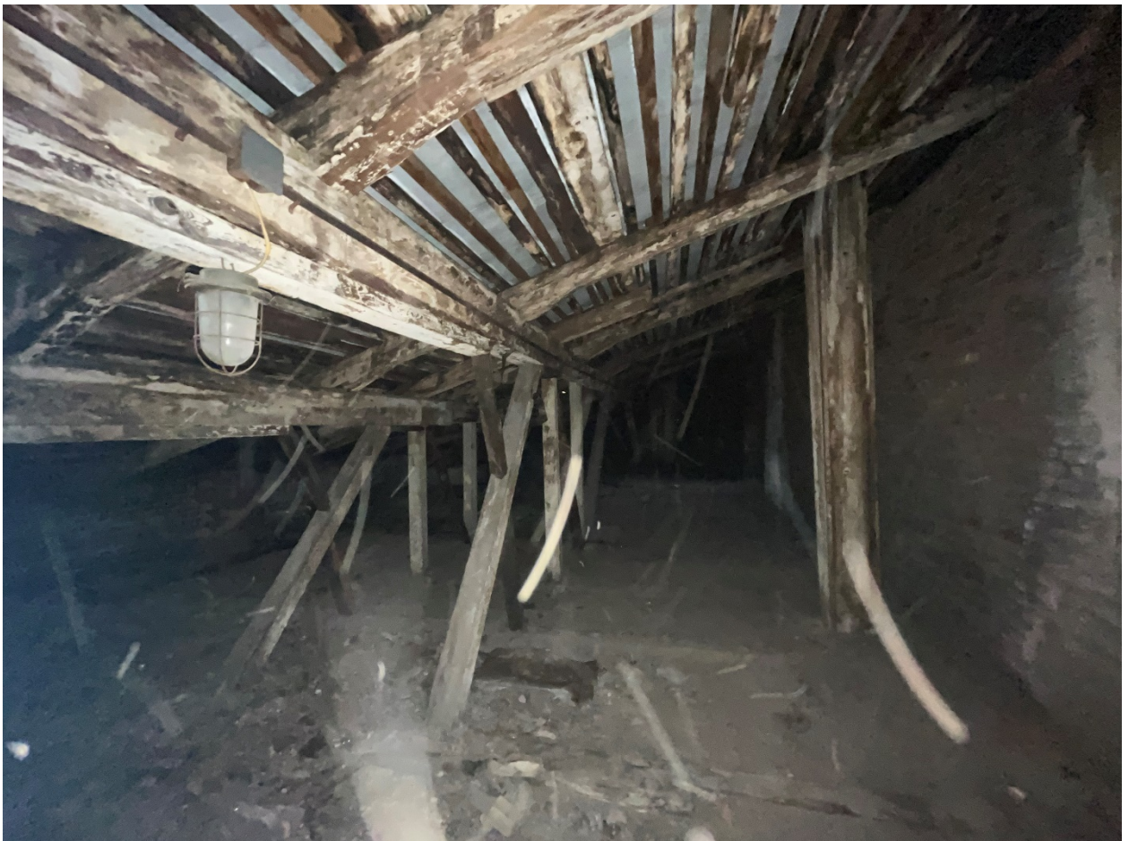
Фото №8. Чердачное пространство, фрагмент стропильной системы.
