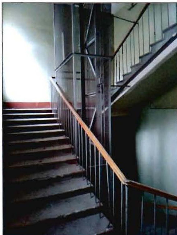
14. Лестница в западном корпусе по ул. Якубовича.
