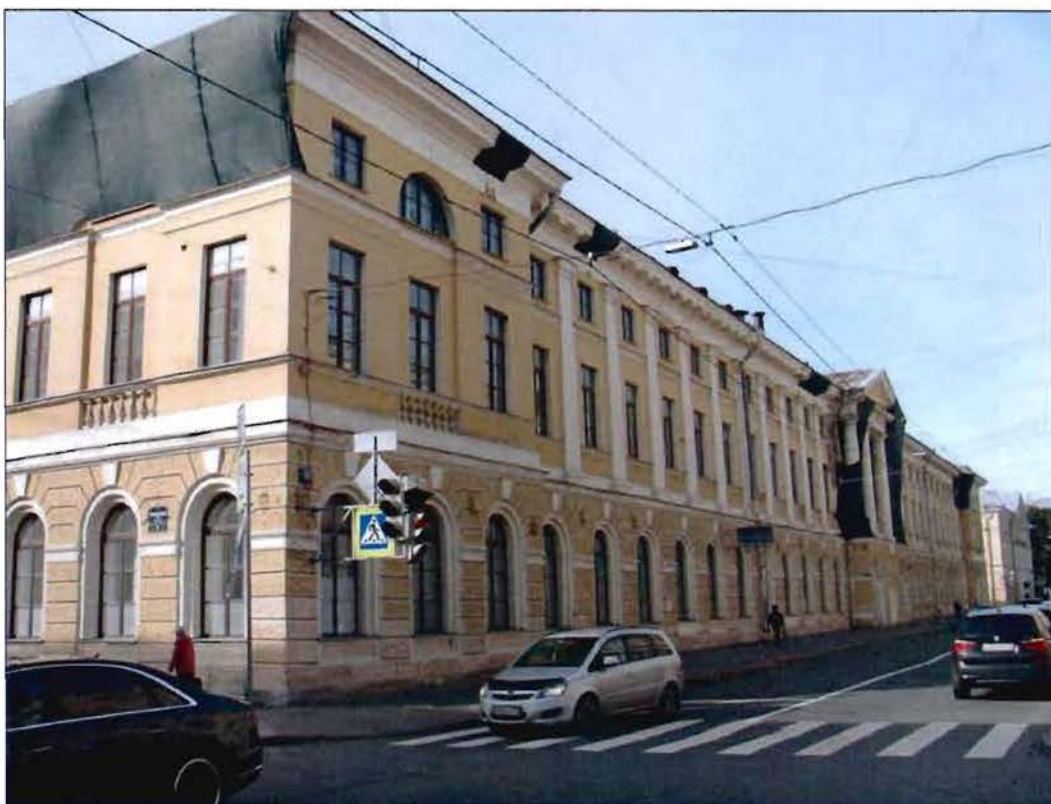
2. Восточный лицевой фасад. Вид с юго-востока.
