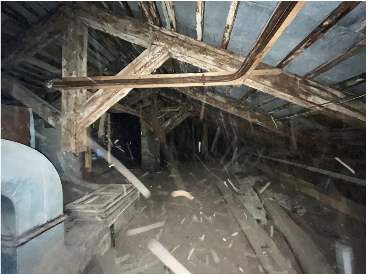
Фото №23. Чердачное пространство, фрагмент стропильной системы.
