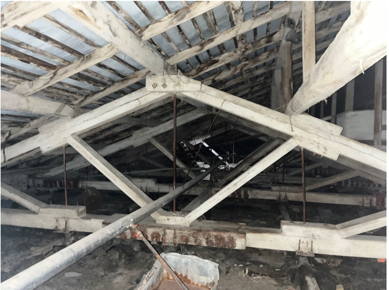
Фото №17. Чердачное пространство, фрагмент стропильной системы.
