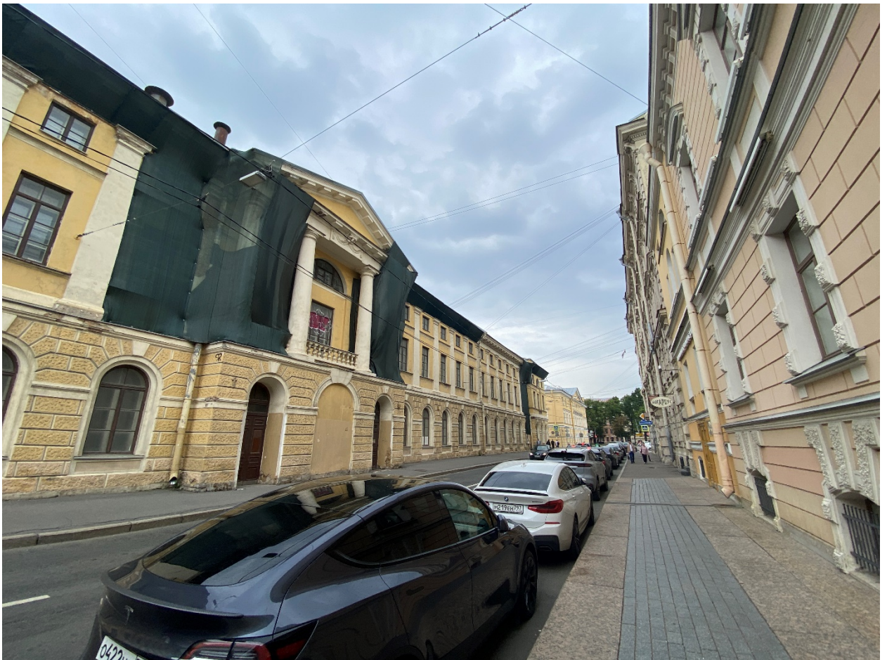
Фото №2. Фрагмент северо-восточного фасада.
