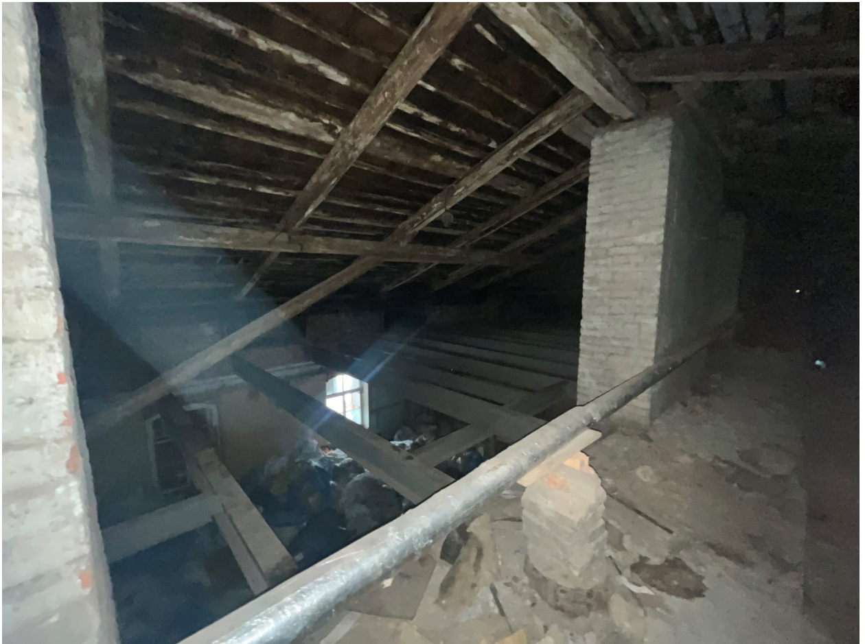
Фото №21. Чердачное пространство, фрагмент стропильной системы.
