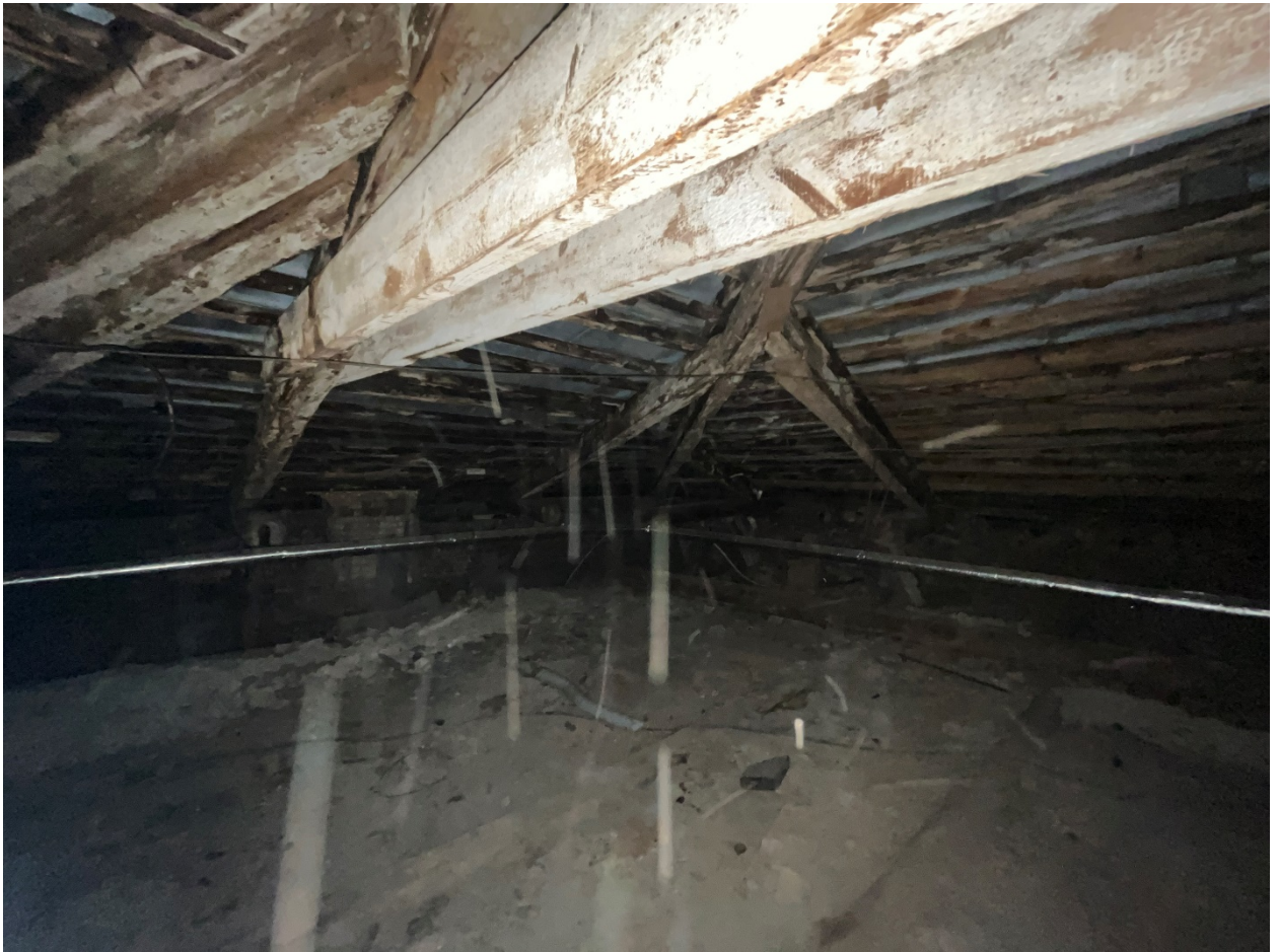
Фото №24. Чердачное пространство, фрагмент стропильной системы.
