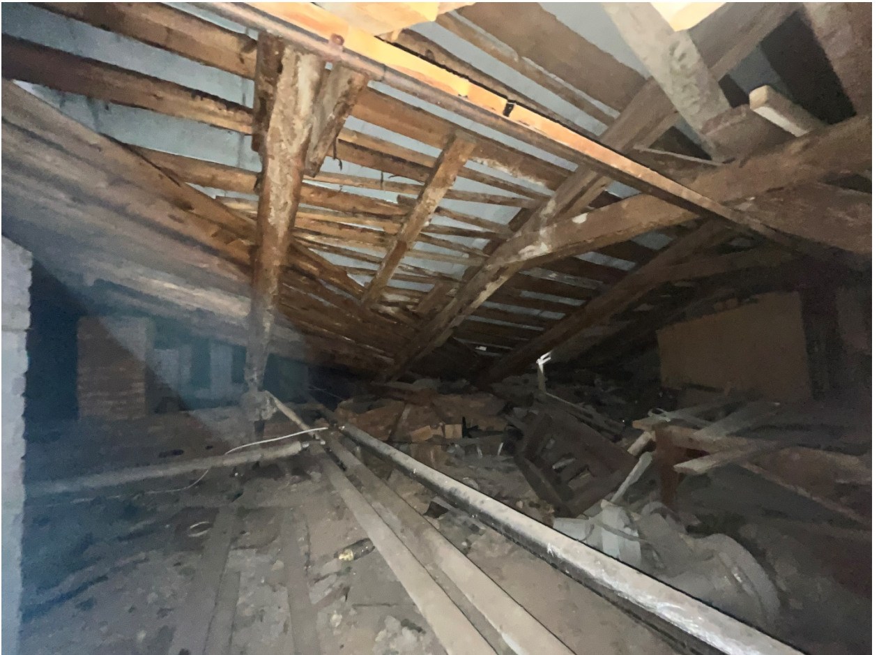
Фото №22. Чердачное пространство, фрагмент стропильной системы.
