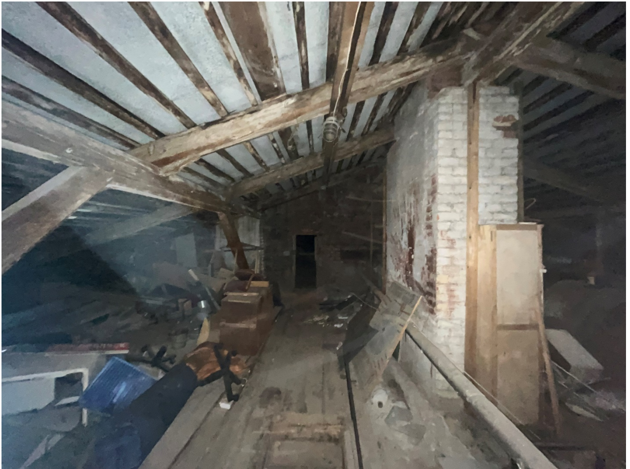
Фото №20. Чердачное пространство, фрагмент стропильной системы.
