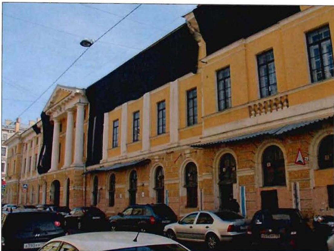
3. Северный лицевой фасад. Вид с запада.
