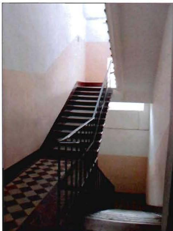
12. Лестница в южном корпусе по ул. Почтамтской.
