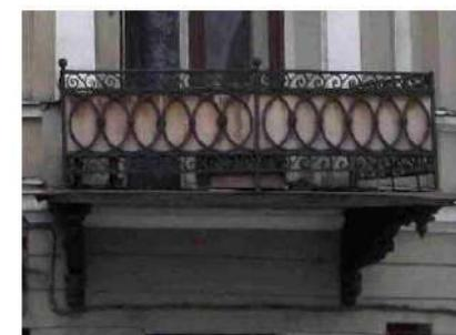
балкон в уровне 3-го этажа юго-восточного угла на металлических кронштейнах – габариты и конфигурация; ограждение – материал (металл), техника исполнения (ковка), рисунок (геометрический); профилированные междуэтажные карнизы и тяги, в т.ч. с дентикулами (ризалит восточного фасада);
