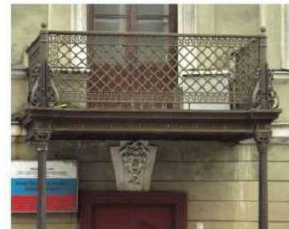
балкон в уровне 2-го этажа юго-восточного угла на чугунных кронштейнах – габариты и конфигурация; ограждение – материал (металл), техника исполнения (ковка), рисунок ограждения (широкий фриз из овалов, обрамленный фризами из волнообразного меандра);
