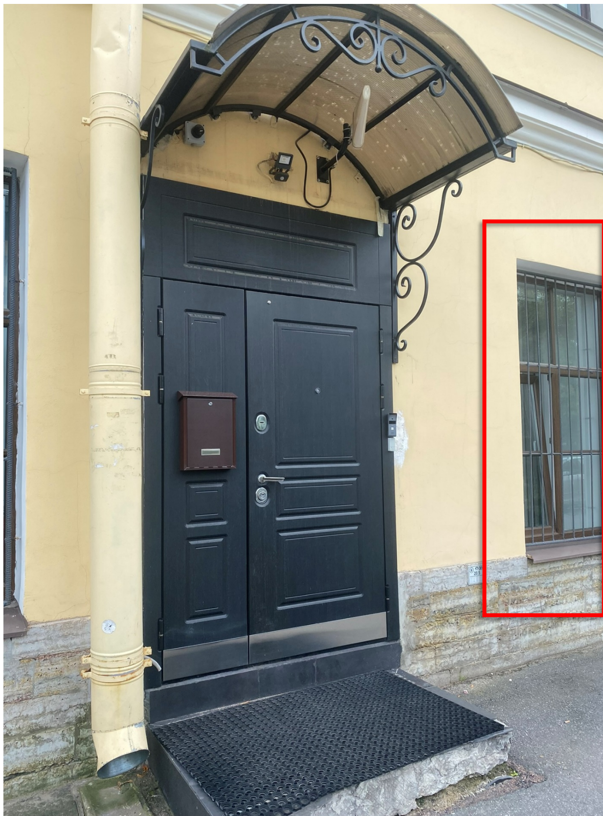
1. Вид на входную дверь в помещение 1-Н, с Большого проспекта В.О.;
