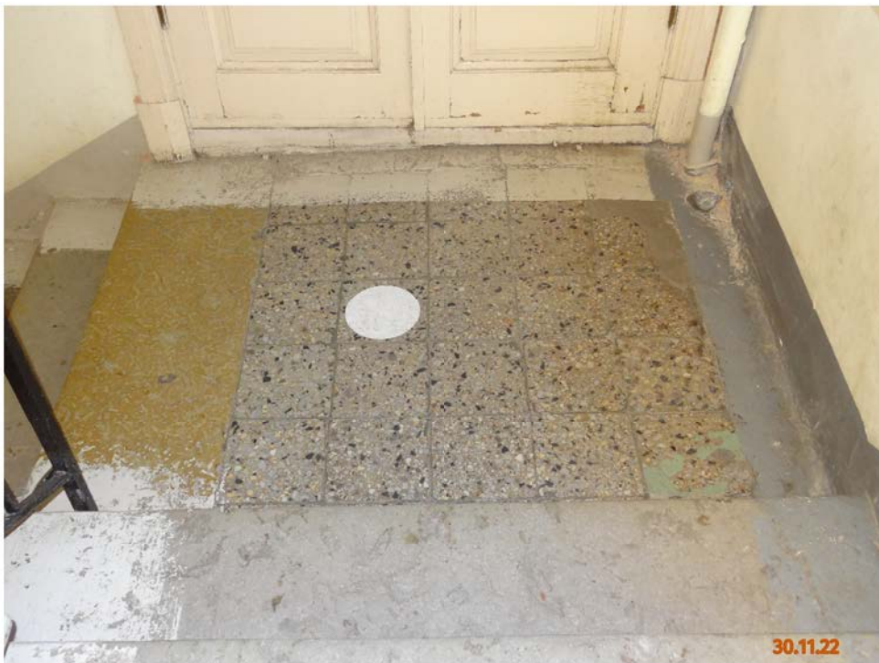
Фото № 10. Общий вид. Покрытие пола террасо. 2 этаж. Дата фотофиксации: 30.11.22 г.
