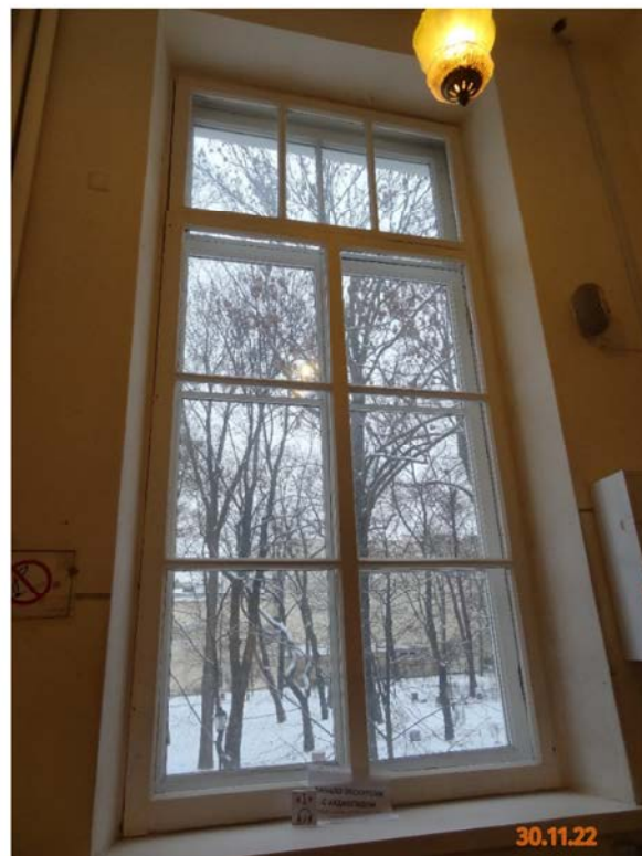
Фото № 8. Общий вид. Оконный проём. Площадка 2-го этажа.
