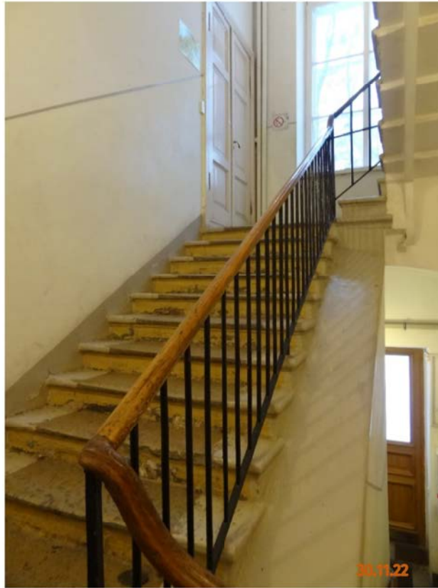
Фото № 7. Общий вид с лестничного пролета на площадку второго этажа.
