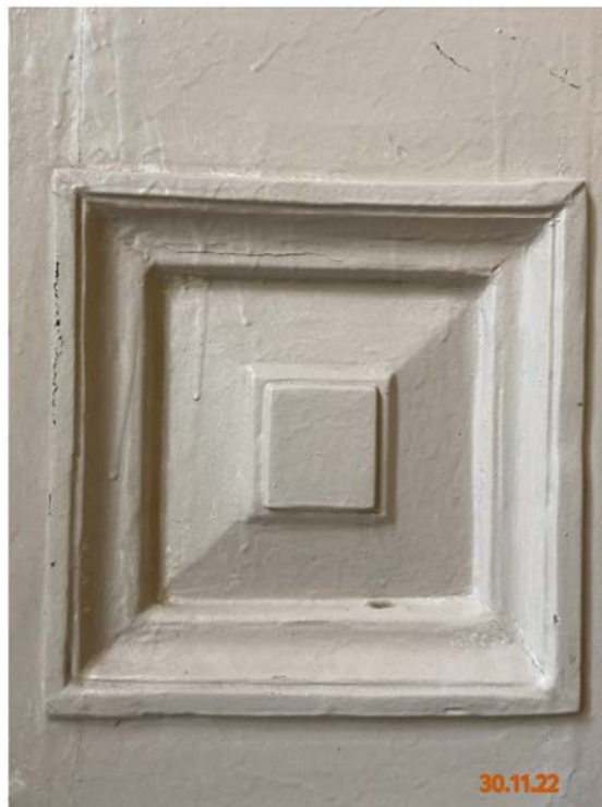
Фото № 14. Фрагмент филёнчатого дверного полотна. 2 этаж.
