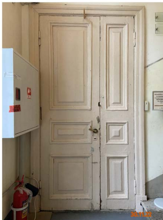
Фото № 12. Полуторостворная филёнчатая дверь. 2 этаж. Дата фотофиксации: 30.11.22 г.
