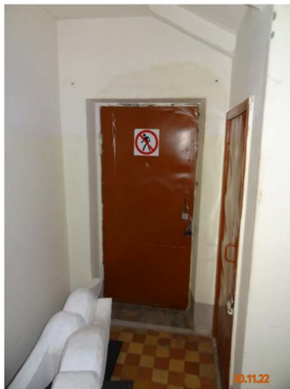
Фото № 34. Общий вид. Двери в технические помещения.
