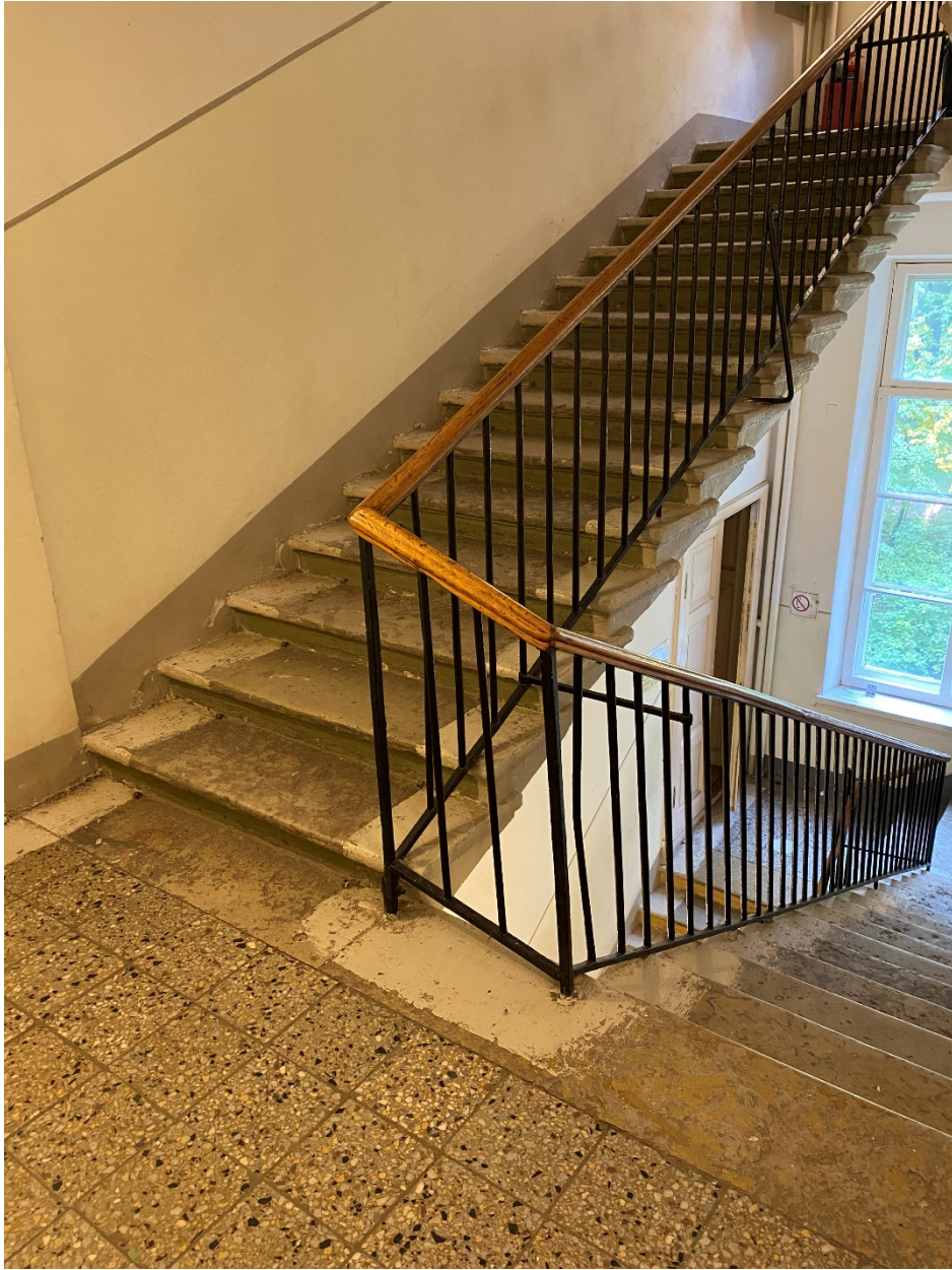
17. Лестничная площадка и лестничные марши (между 2-м и 3-м этажом) музея Анны Ахматовой в Фонтанном Доме, сентябрь 2022 г.
