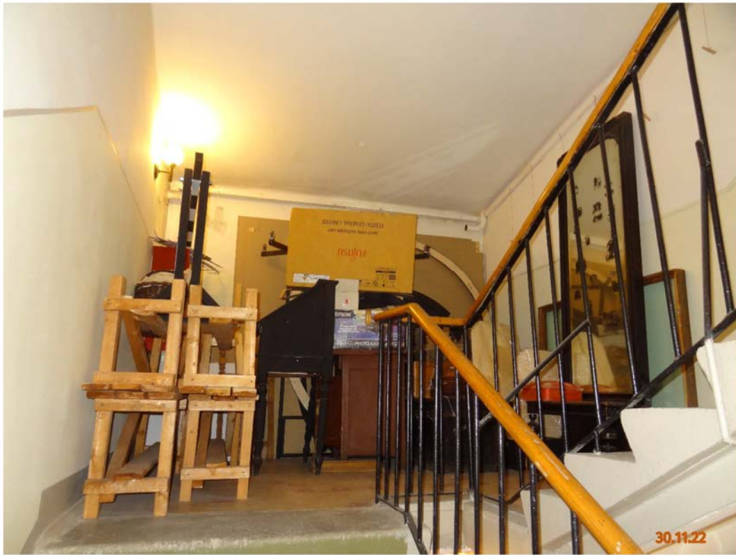
Фото № 27. Вид со стороны лестницы на площадку четвёртого этажа.
