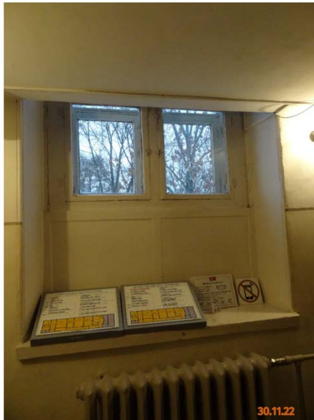
Фото № 30. Фрагмент оконного заполнения. 3 этаж. Дата фотофиксации: 30.11.22 г.
