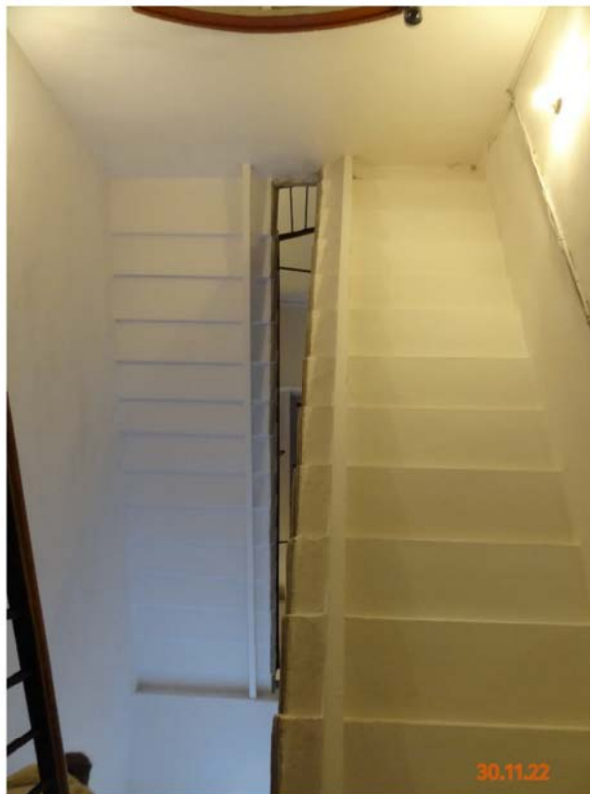
Фото № 5. Лестничные марши на косоурах. Вид со стороны межэтажной площадки.
