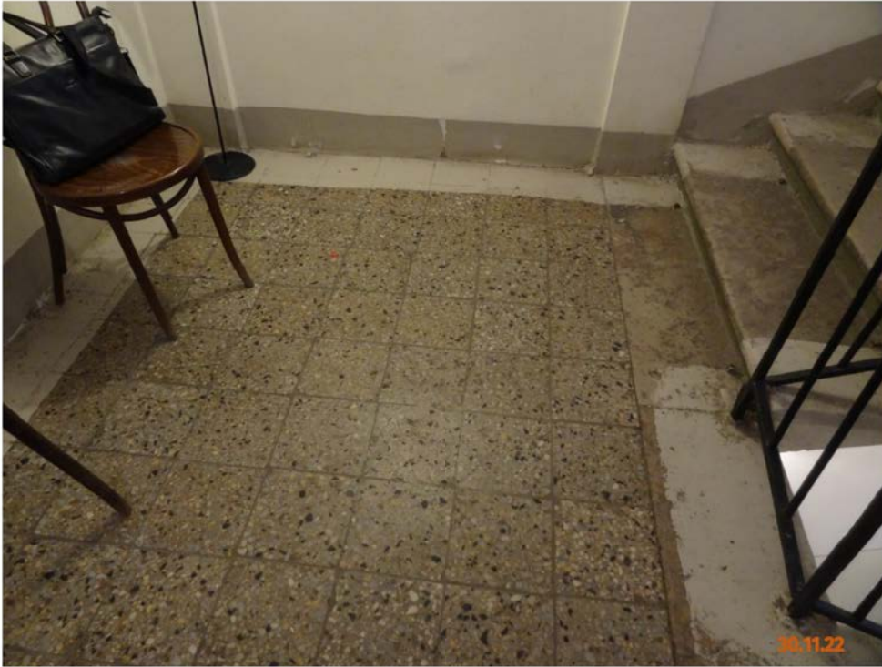
Фото № 19. Общий вид. Покрытие пола террасы. Межэтажная площадка между вторым и третьим этажами. Дата фотофиксации: 30.11.22 г.
