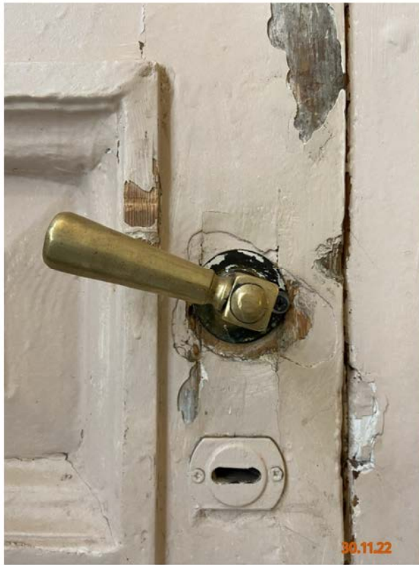
Фото № 13. Фрагмент дверного полотна. Латунная ручка-фаль, дверной замок.
