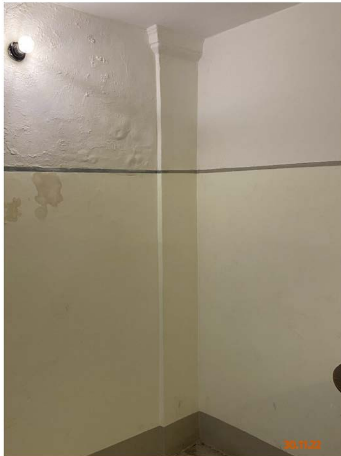
Фото № 20. Общий вид. Пилястра. Межэтажная площадка между вторым и третьим этажами. Дата фотофиксации: 30.11.22 г.
