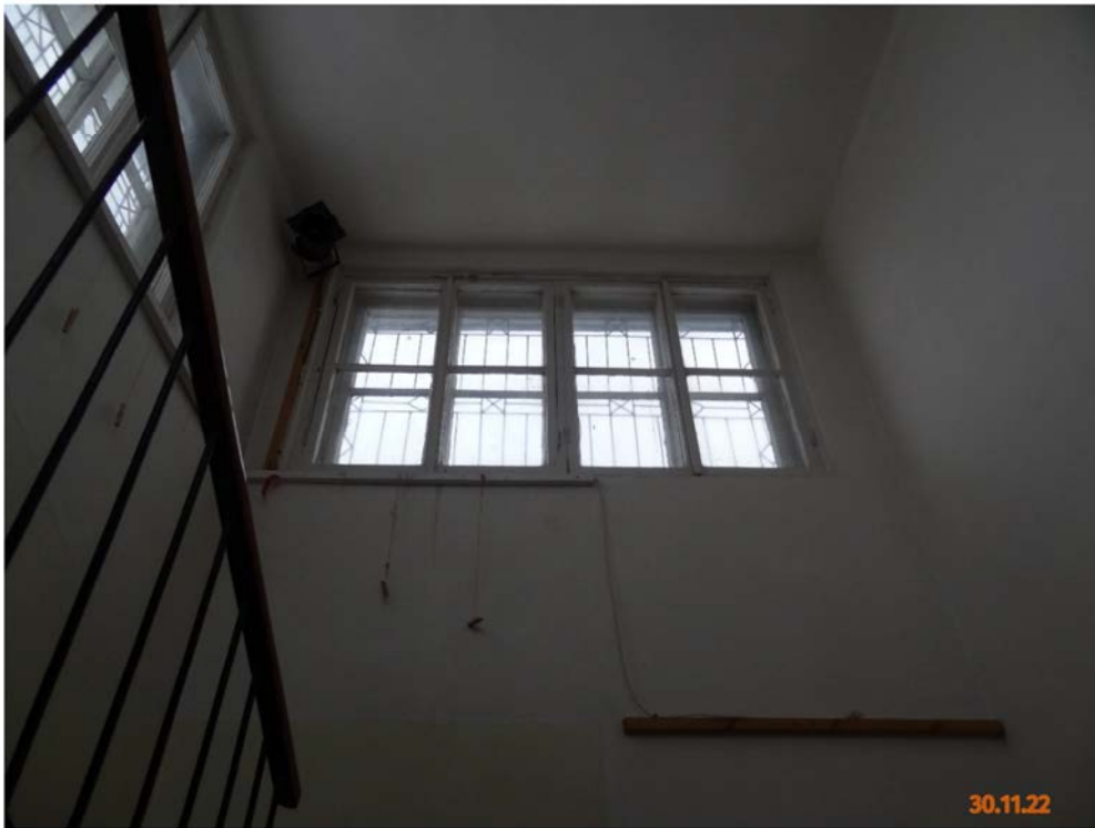
Фото № 35. Оконные проемы над площадкой пятого этажа. Окно.
