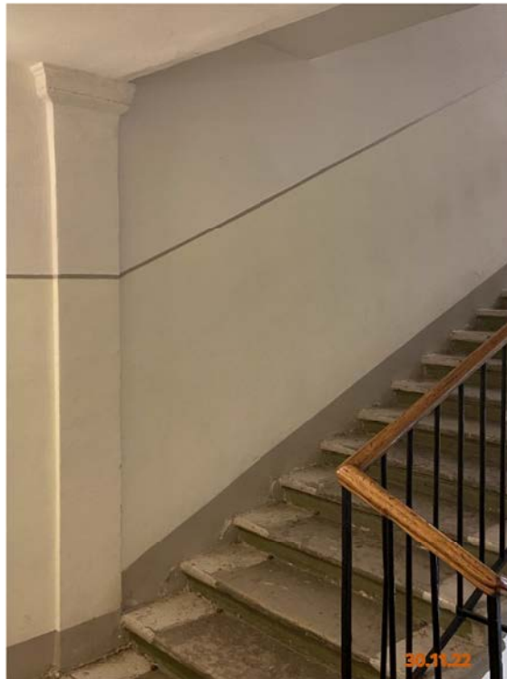
Фото № 22. Общий вид с межэтажной площадки между вторым и третьим этажами.
