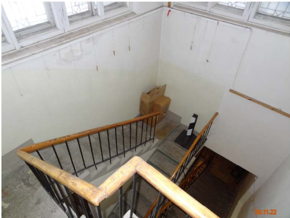
Фото № 38. Вид с площадки перед дверью на чердак. Дата фотофиксации: 30.11.22 г.
