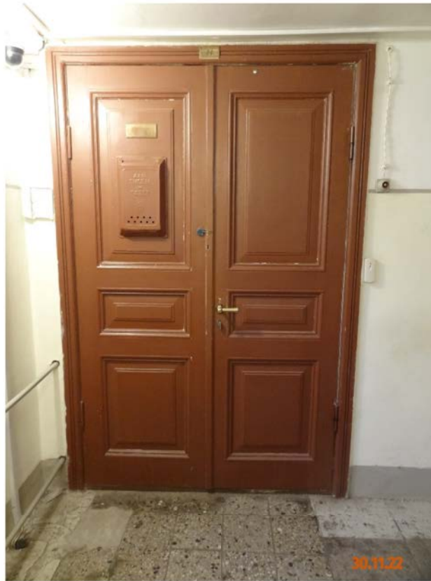
Фото № 25. Двустворчатая филёнчатая дверь. 3 этаж. Дата фотофиксации: 30.11.22 г.
