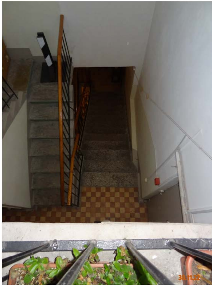
Фото № 39. Общий вид. Площадка пятого этажа и лестница на четвёртый этаж.
