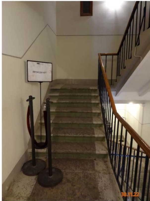
Фото № 31. Общий вид с лестничной площадки третьего этажа.
