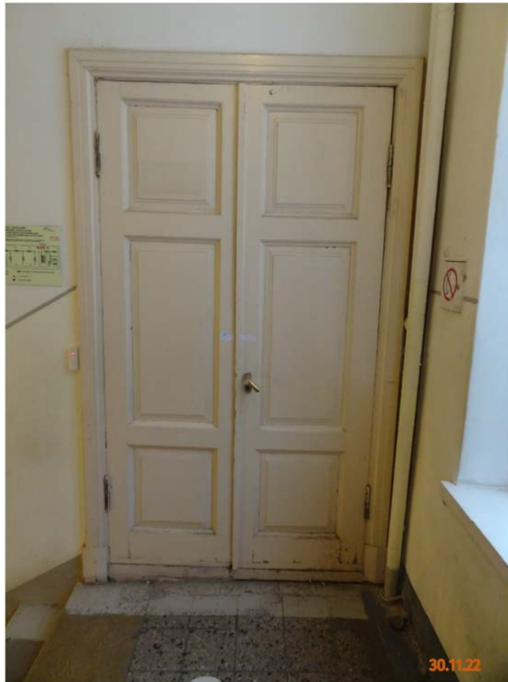
Фото № 9. Двустворчатая филёнчатая дверь. 2 этаж. Дата фотофиксации: 30.11.22 г.
