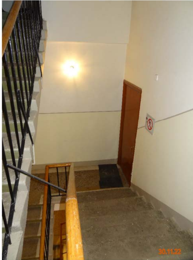
Фото № 29. Дверь на межэтажной площадке между третьим и четвёртым этажами.
