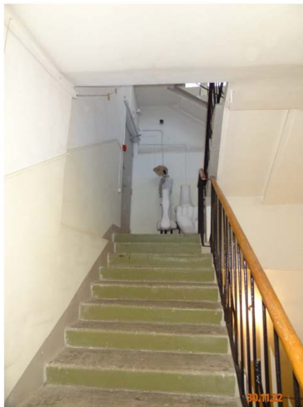
Фото № 32. Общий вид с лестничной площадки четвертого этажа.
