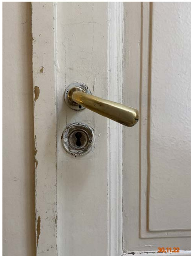
Фото № 11. Фрагмент дверного полотна. Латунная ручка-фаль и замок.
