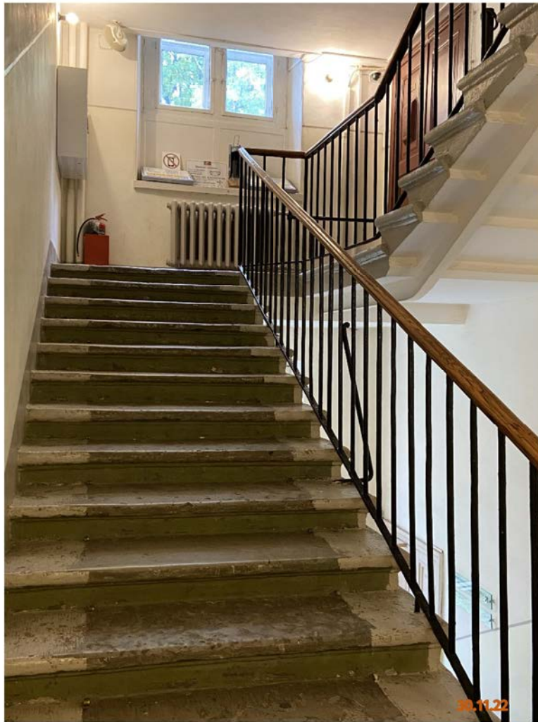
Фото № 23. Общий вид с межэтажной площадки на третий этаж.
