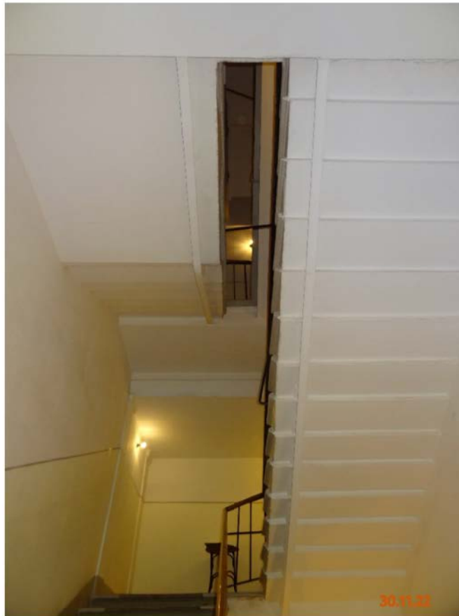
Фото № 17. Лестничные марши на косоурах. Вид со второго этажа.
