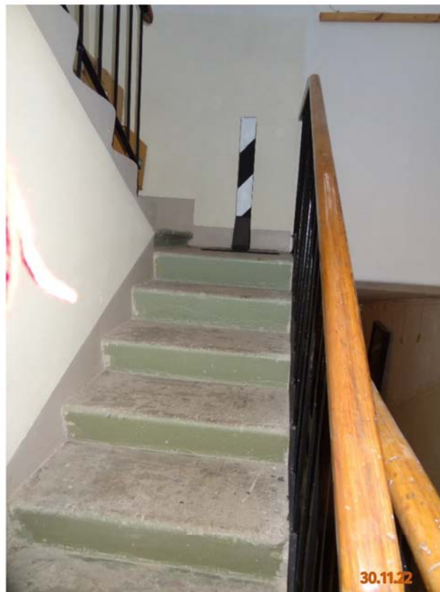
Фото № 36. Общий вид. Межэтажная площадка пятого этажа.
