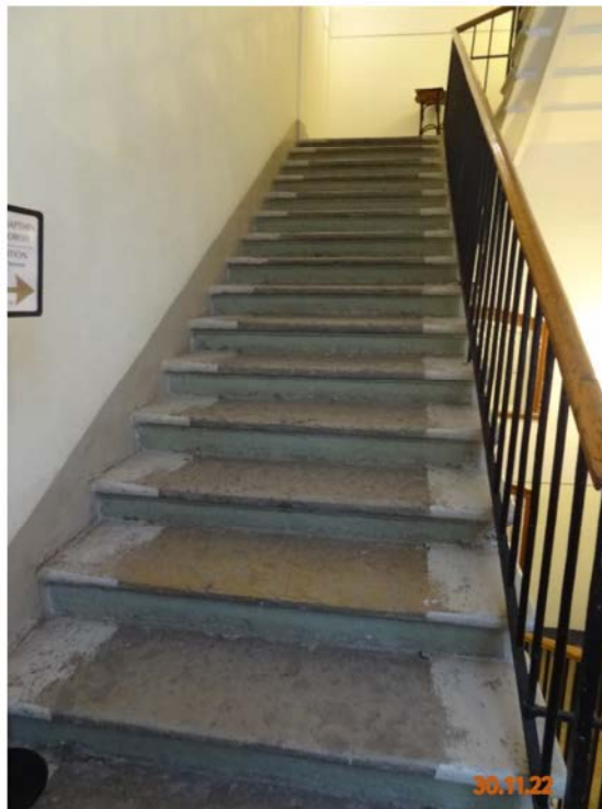
Фото № 18. Общий вид на лестничный пролет со второго этажа.
