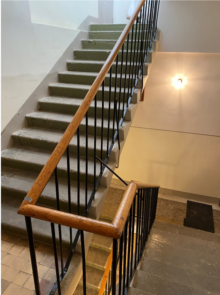
20. Лестничные марши, ведущие на чердачное пространство музея Анны Ахматовой в Фонтанном Доме, сентябрь 2022 г.
