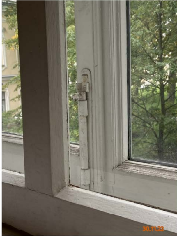
Фото № 15. Фрагмент оконного заполнения. Фурнитура. 2 этаж.
