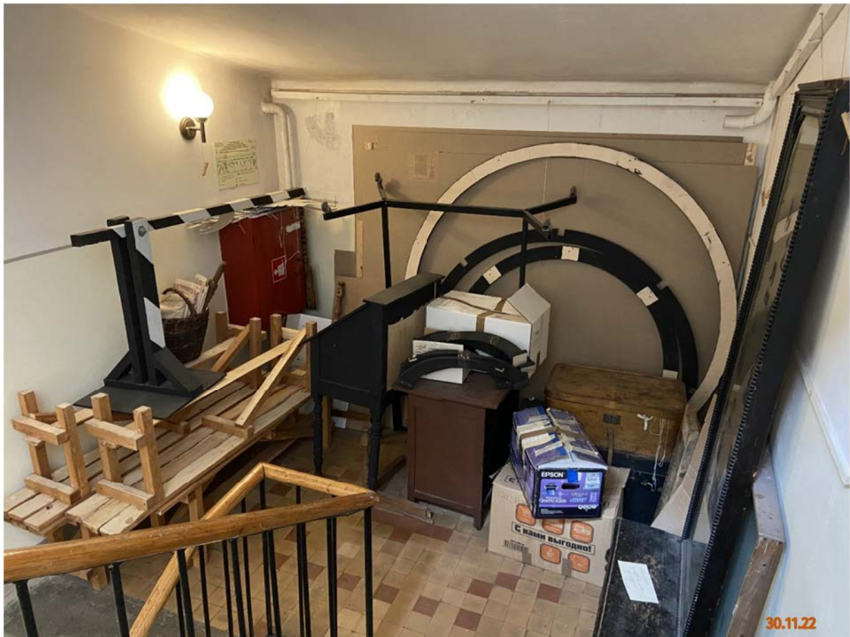
Фото № 28. Общий вид. Площадка четвёртого этажа. Дата фотофиксации: 30.11.22 г.
