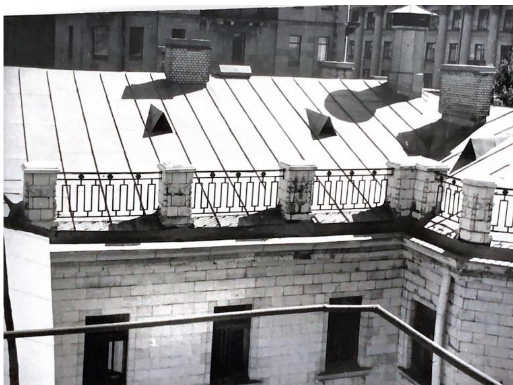
Илл. 66. Особняк Бранта. Парапетные столбы ПС-1 – ПС-5. Парапетные решетки ПР-1 – ПР-4. Вид со стороны фасада. Фотофиксация состояния 1994 г. Проектно-производственная реставрационная фирма «Традиция».
