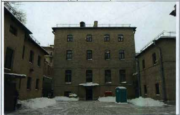
80 Хозяйственный двор. Северный фасад главного здания.
