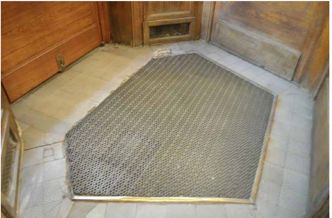
Фото 37. ОКН федерального значения «Особняк Бранта В. Э.» (ул. Куйбышева, дом 2-4, лит. А). Тамбур парадного входа. Фрагмент. Съёмка 01.07.2021 г.
