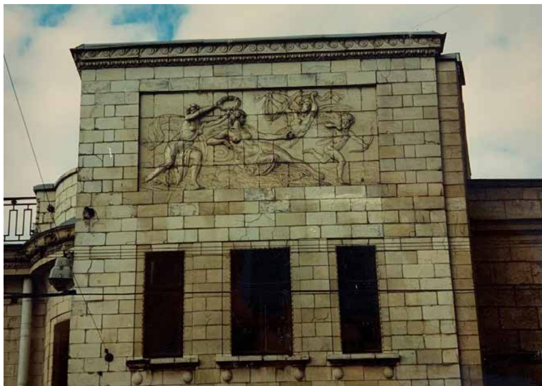
Илл. 46. Фотофиксация до начала производства реставрационных работ в 2003 г.
