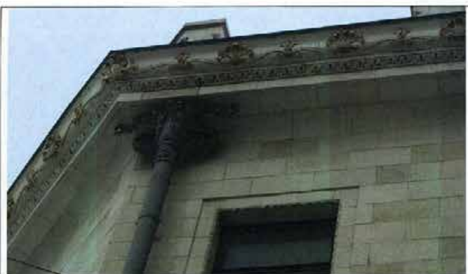
13 Южный фасад. Венчающий карниз и декор водосточной трубы.
