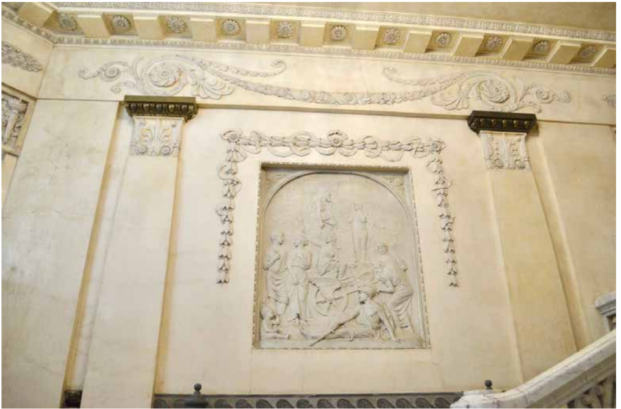
Фото 45. ОКН федерального значения «Особняк Бранта В. Э.» (ул. Куйбышева, дом 2-4, лит. А). Главный вестибюль. Неглубокая ниша в простенке между пилястрами с рельефной композицией. Над рельефной композицией лепной фриз. Общий вид. Съёмка 01.07.2021 г.
