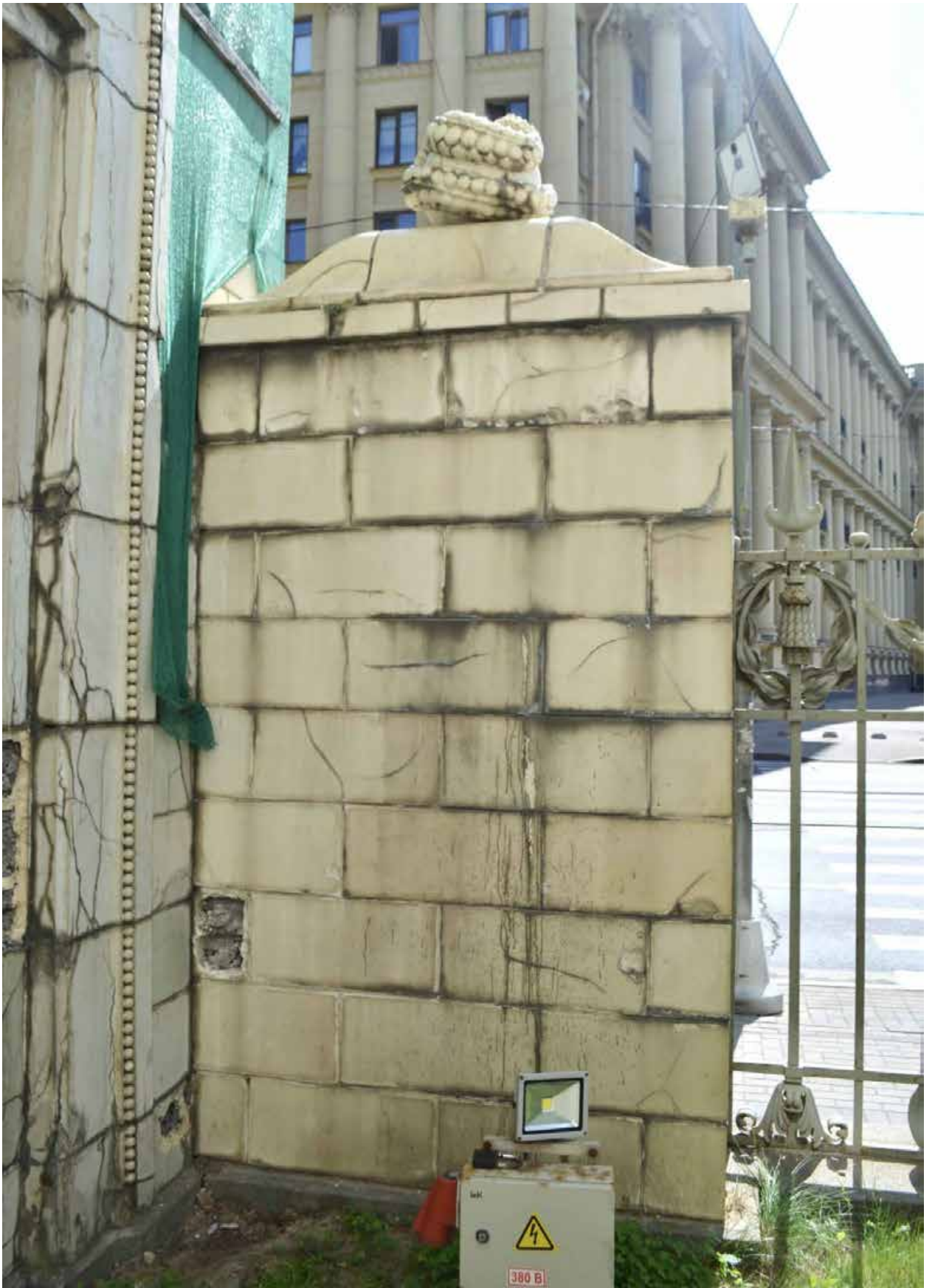
Фото 19. ОКН федерального значения «Особняк Бранта В. Э.» (ул. Куйбышева, дом 2-4, лит. А). Парапетный столб, увенчанный воссозданным шаром, обвитым змеями. Вид со стороны сада. Фрагмент. Съёмка 01.07.2021 г.
