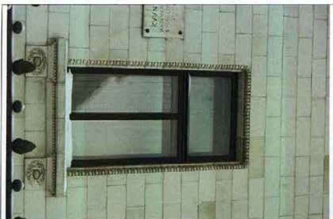
9 Южный фасад. 2-й этаж
