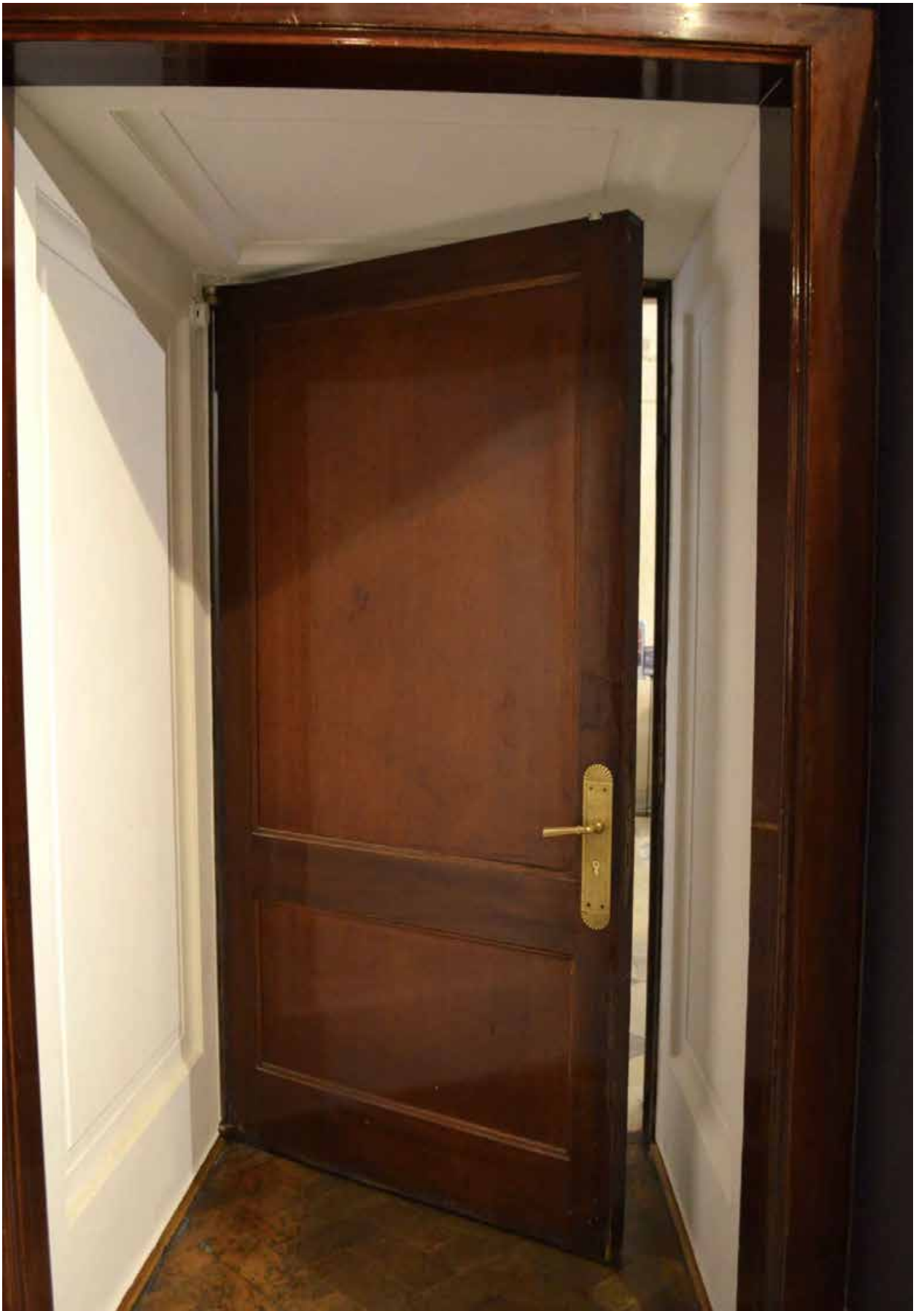
Фото 56. ОКН федерального значения «Особняк Бранта В. Э.» (ул. Куйбышева, дом 2-4, лит. А). Помещение 126. Заполнение дверного проема. Фрагмент. Съемка 01.07.2021 г.
