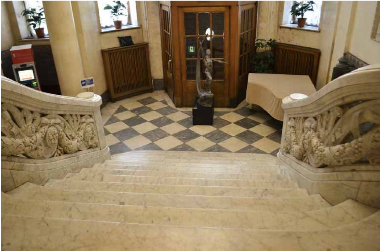
Фото 38. ОКН федерального значения «Особняк Бранта В. Э.» (ул. Куйбышева, дом 2-4, лит. А). Главный вестибюль. Общий вид. Съёмка 01.07.2021 г.
