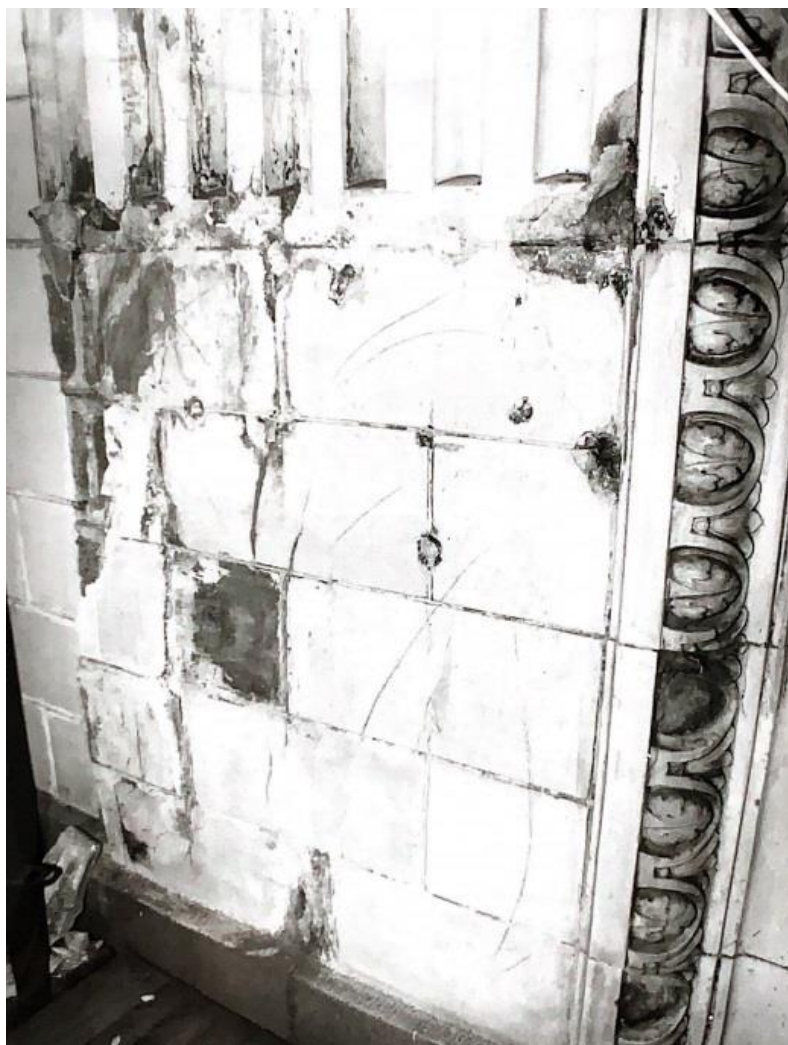
Илл. 78. Фотофиксация портала до начала производства работ (после установки лесов). РПНЦ «Специалист», 2003 г. Юго-западный угол Место примыкания к отреставрированной ограде.
