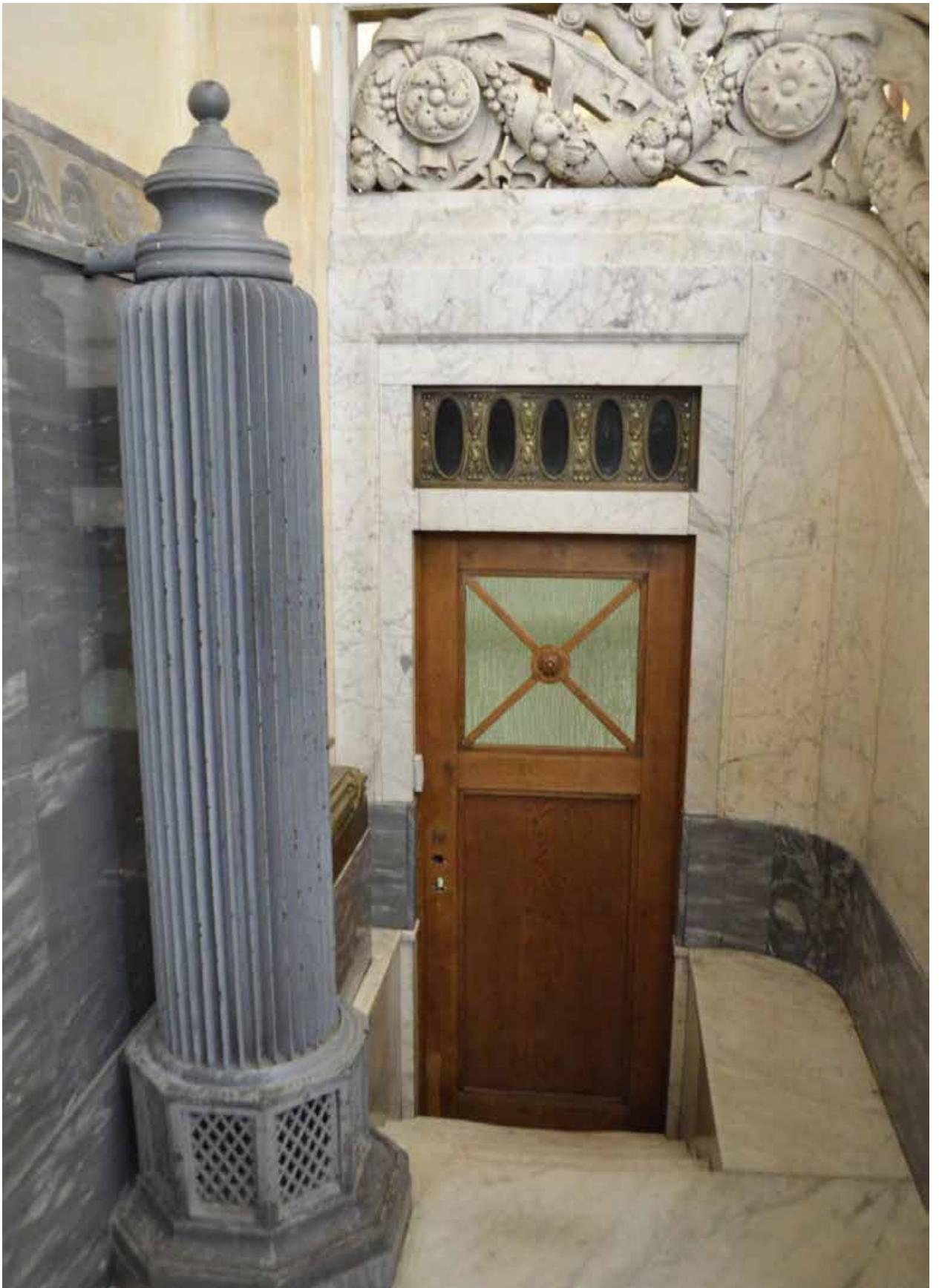
Фото 44. ОКН федерального значения «Особняк Бранта В. Э.» (ул. Куйбышева, дом 2-4, лит. А). Главный вестибюль. Облицовка нижней части стен вестибюля серым со светлыми прожилками натуральным мрамором. Дверной проем, ведущий с помещения цокольного этажа. Радиатор парового отопления. Фрагмент. Съёмка 01.07.2021 г.
