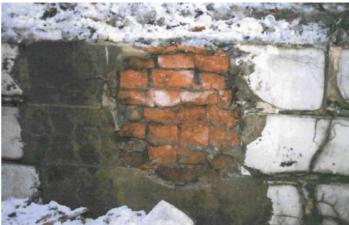
Илл. 58. Инженерное обследование состояния стен, фундаментов, каменной ограды и террасы особняка В.Э. Бранта, 2000 г.
