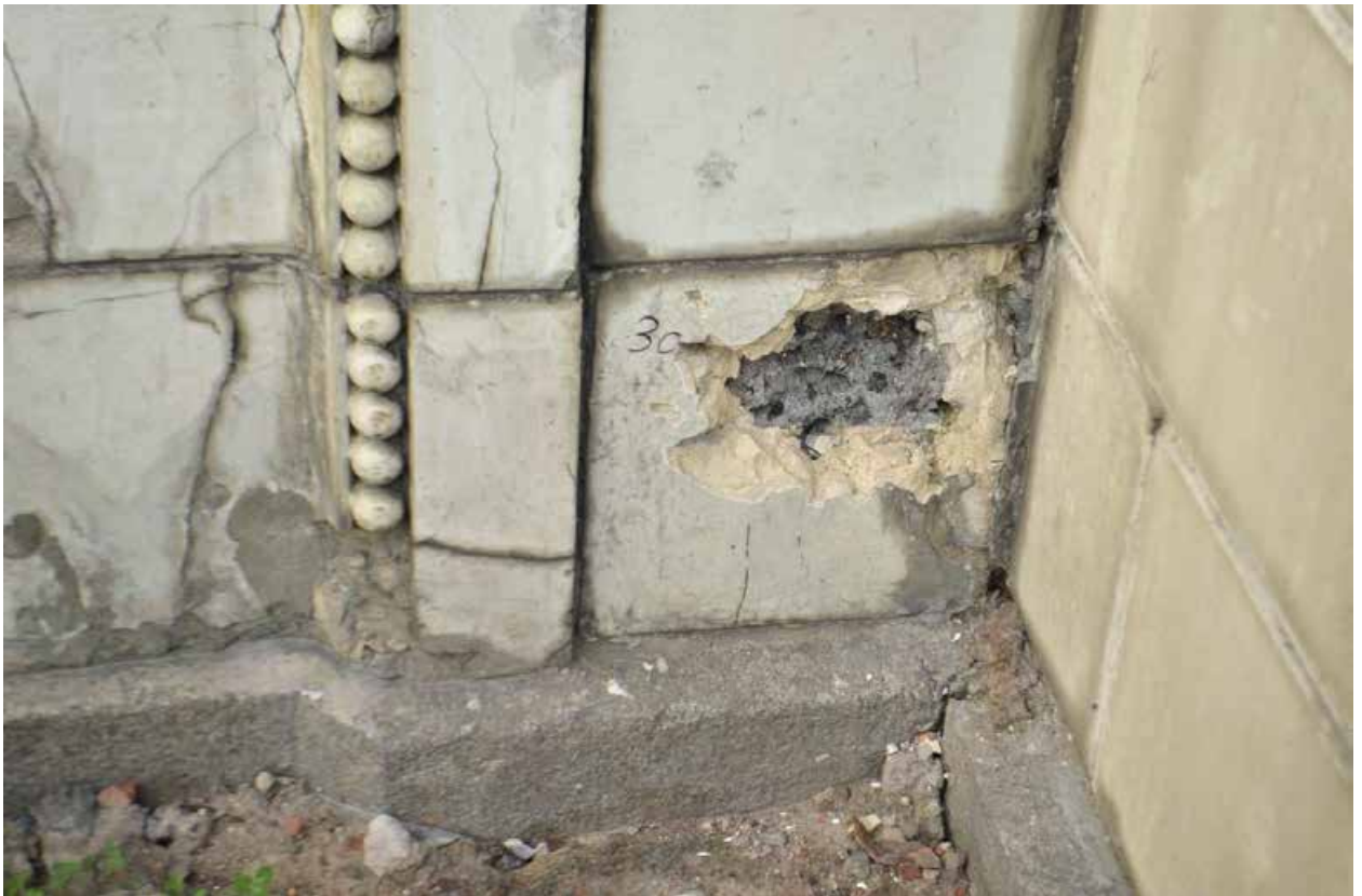
Фото 33. ОКН федерального значения «Особняк Бранта В. Э.» (ул. Куйбышева, дом 2-4, лит. А). Облицовка стен внутри сада. Фрагмент. Съёмка 01.07.2021 г.
