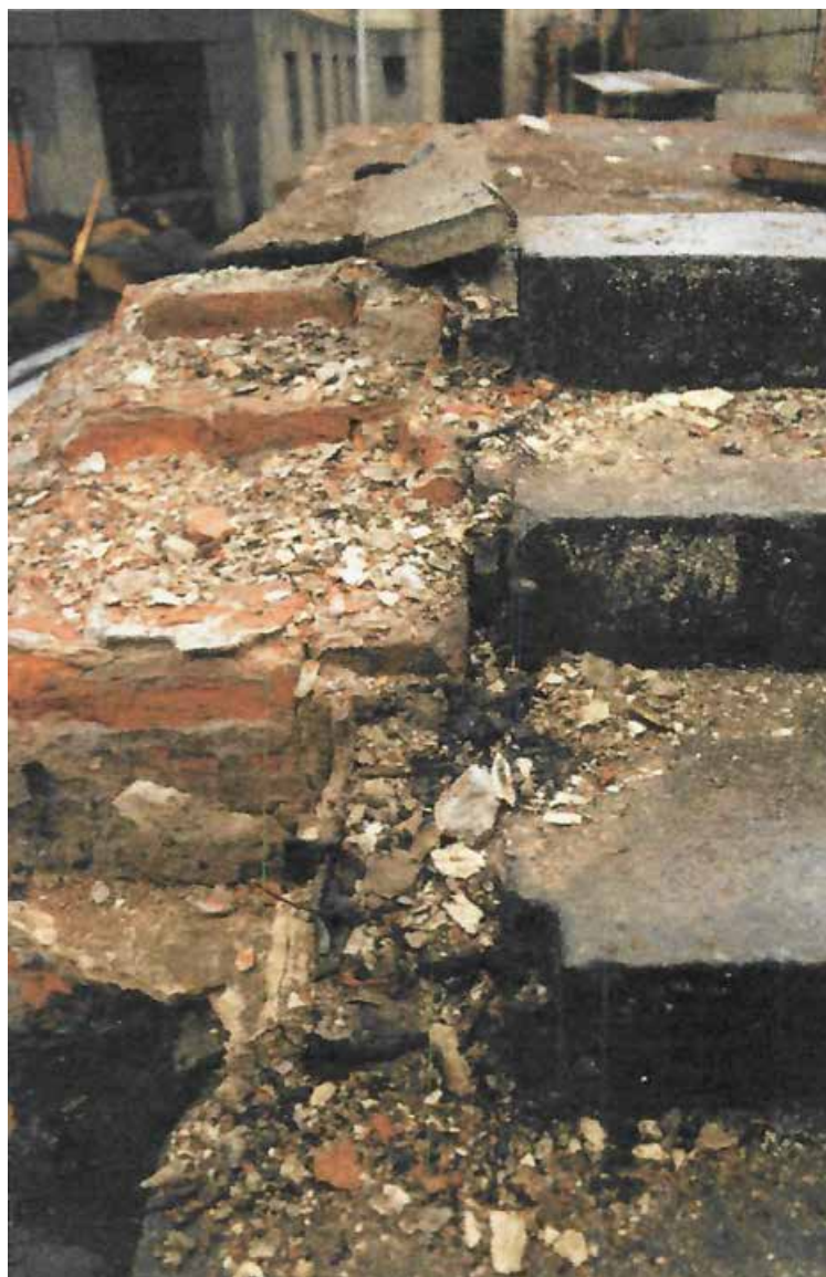
Илл. 61. Инженерное обследование состояния стен, фундаментов, каменной ограды и террасы особняка В.Э. Бранта, 2000 г.
