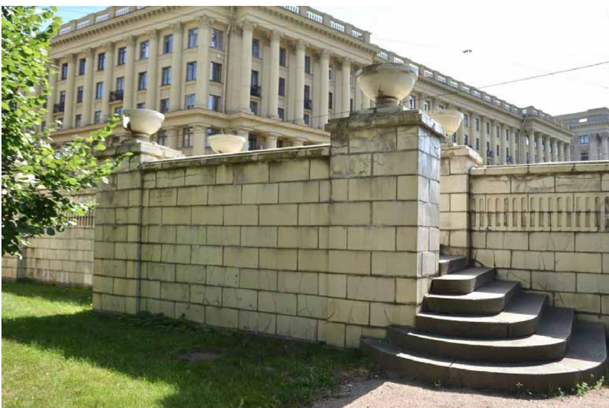
Фото 09. ОКН федерального значения «Особняк Бранта В. Э.» (ул. Куйбышева, дом 2-4, лит. А). Центральная часть глухой ограды со стороны сада. Терраса-смотровая площадка с лестницей, столбы-пилоны по четырем сторонам, увенчанные вазонами-цветочницами. Общий вид. Съёмка 01.07.2021 г.
