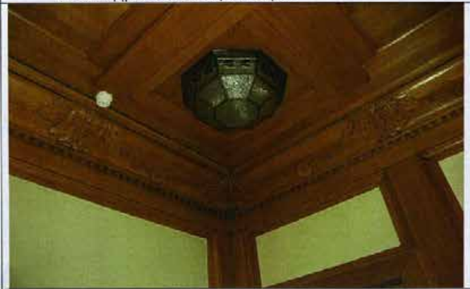
66 Зал с Дубовой лестницей. Фрагмент плафона со светильником.
