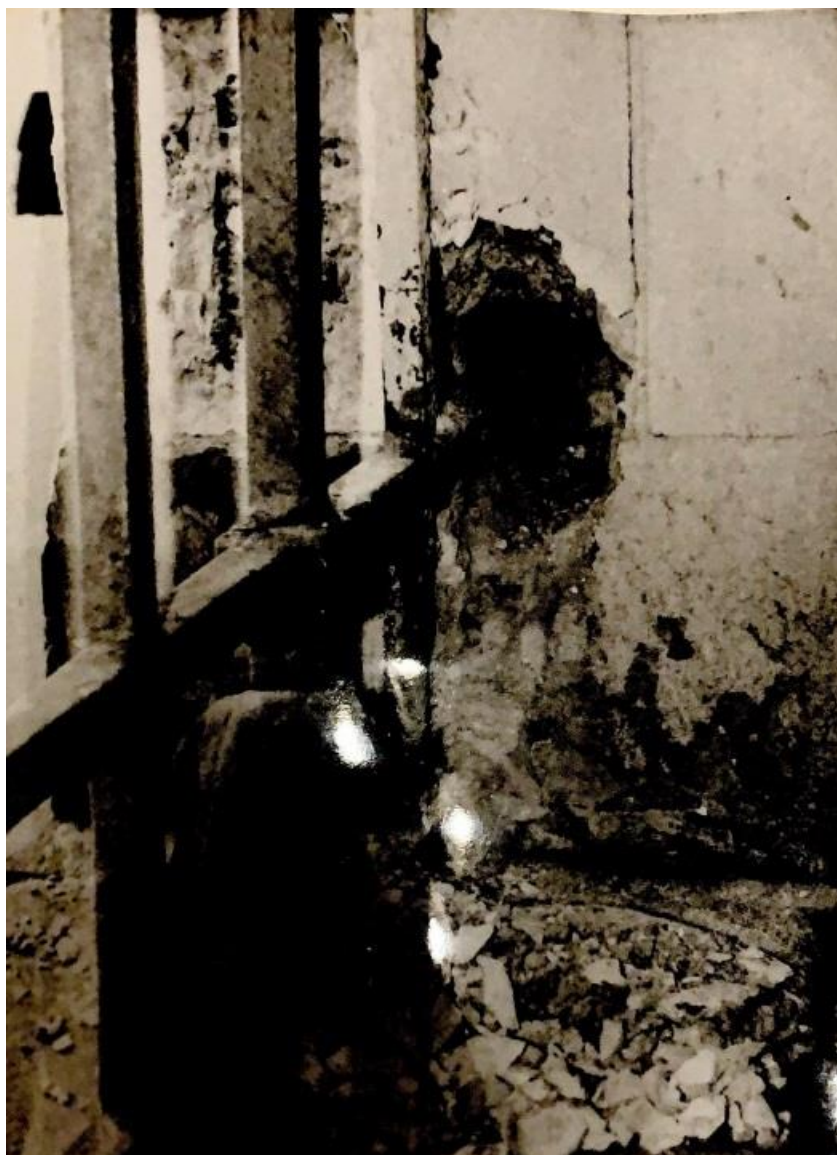
Илл. 74. Проект реставрации оград, беседки и крыльца особняка Ксешинской; ограды и террасы особняка Бранта, 1995 г. Зондаж 6. Примыкание центрального звена решетки к столбу металлической ограды особняка Бранта.
