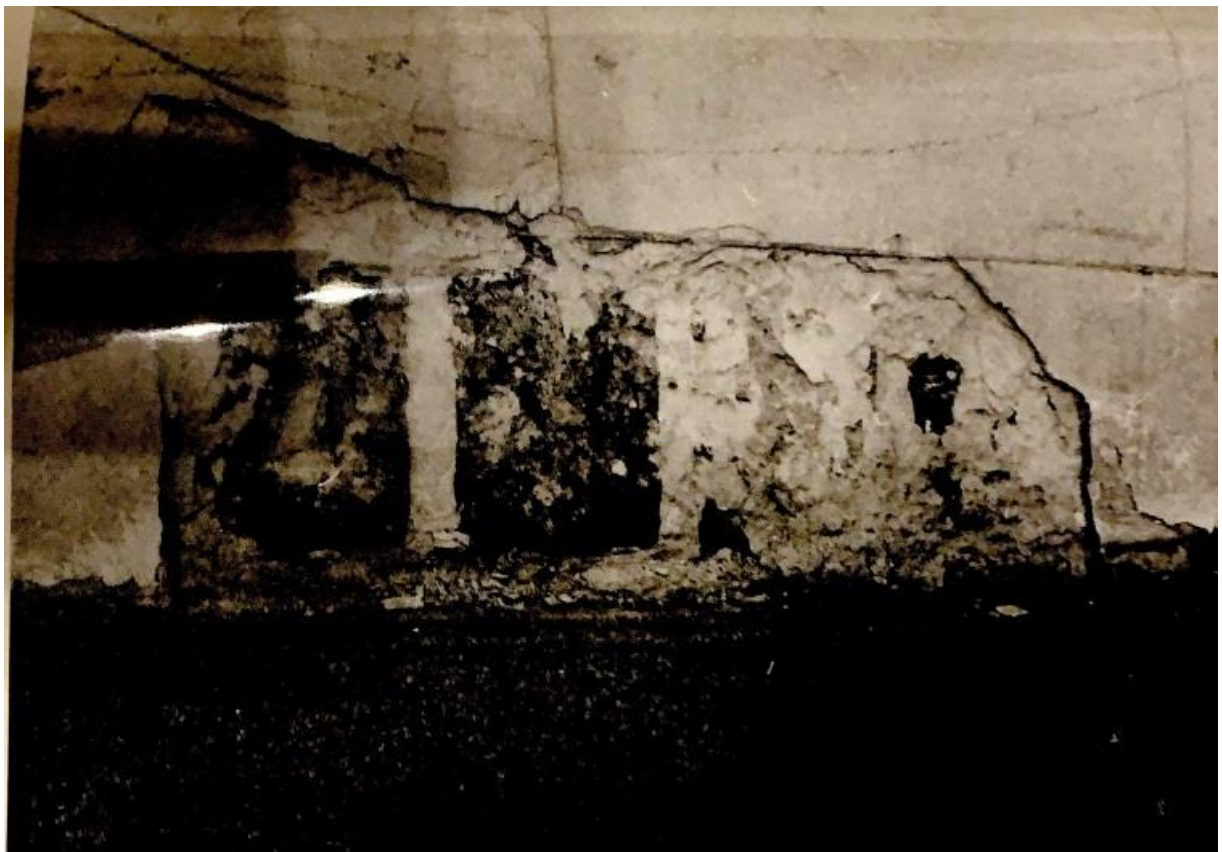
Илл. 75. Проект реставрации оград, беседки и крыльца особняка Ксешинской; ограды и террасы особняка Бранта, 1995 г. Зондаж 8. Каменная ограда ос. Бранта со стороны Б. Дворянской ул.
