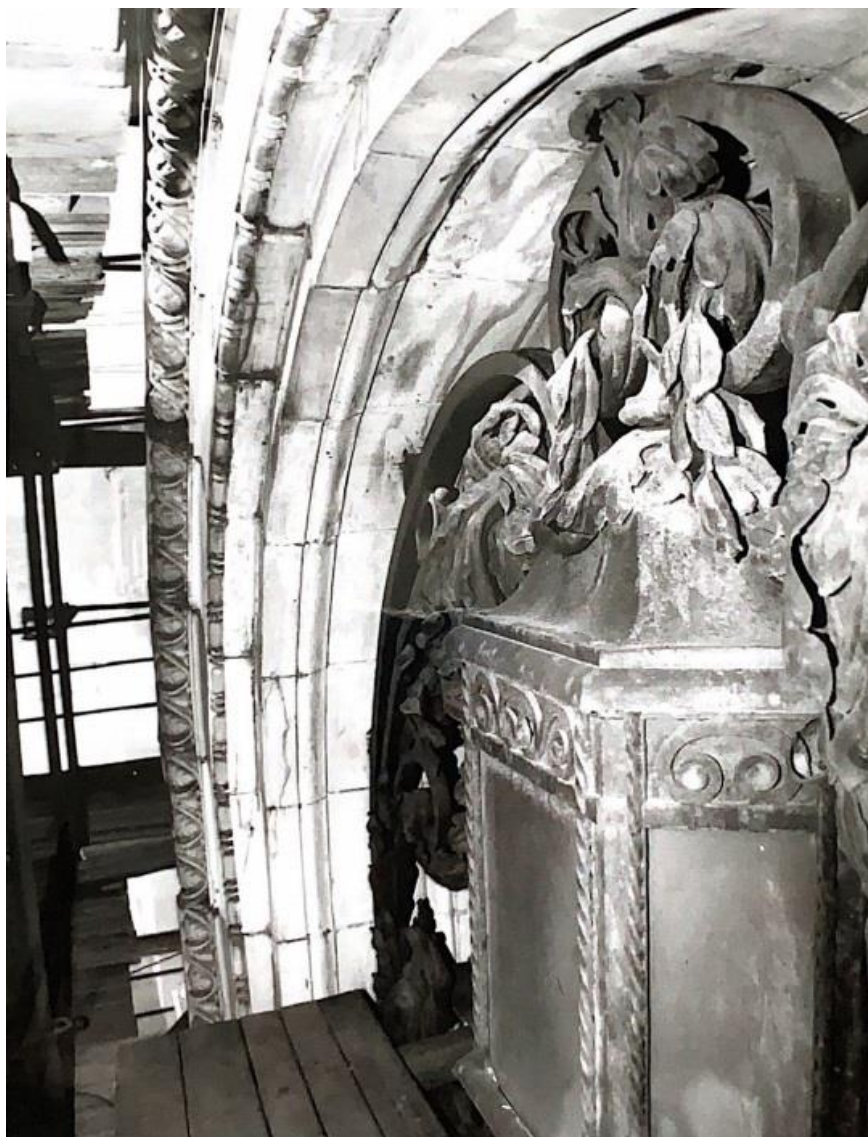
Илл. 80. Фотофиксация портала до начала производства работ (после установки лесов). РПНЦ «Специалист», 2003 г. Вид на западную сторону верха арки.
