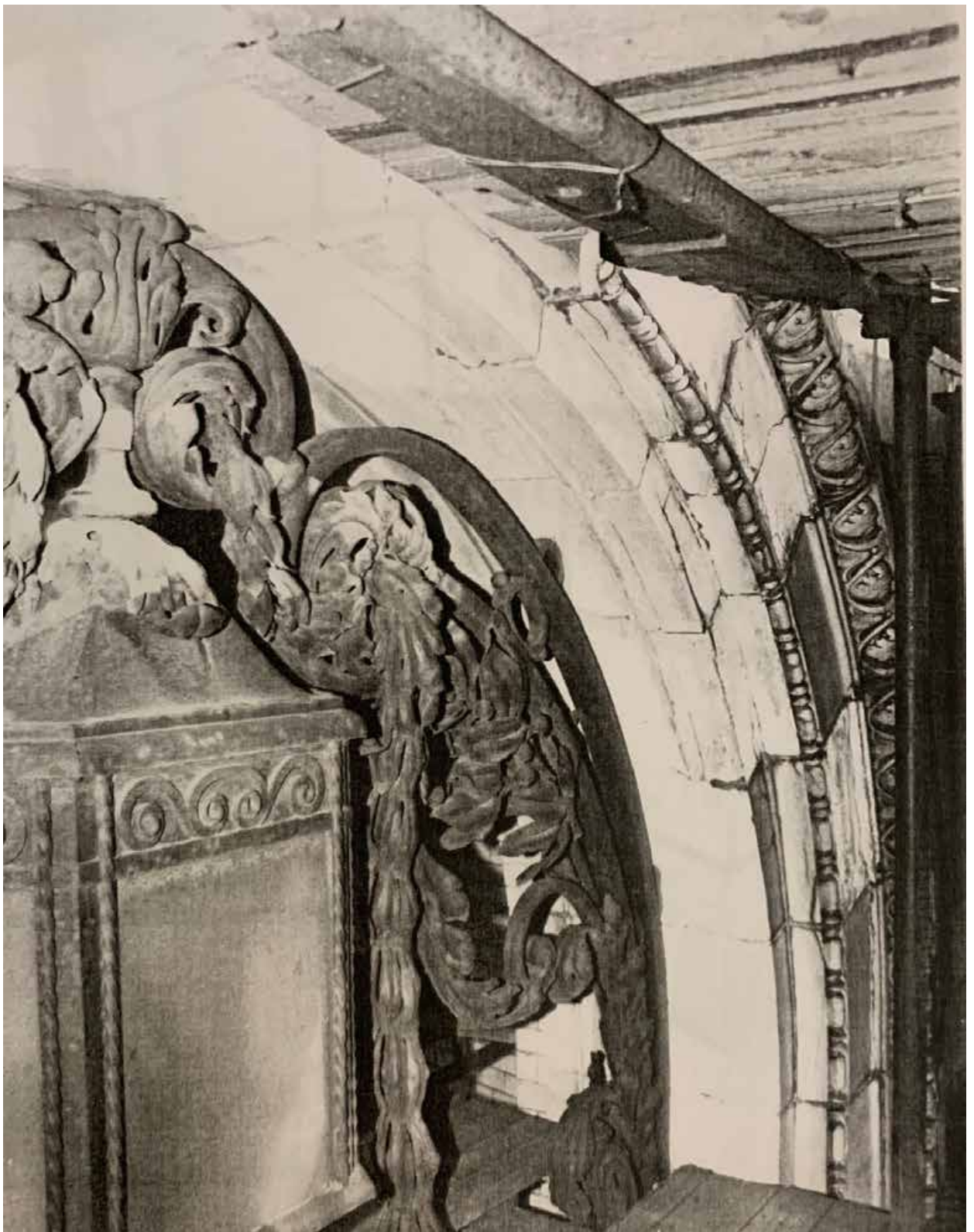
Илл. 53. Фотофиксация до начала производства реставрационных работ (после установки лесов на портале) в 2003 г.
