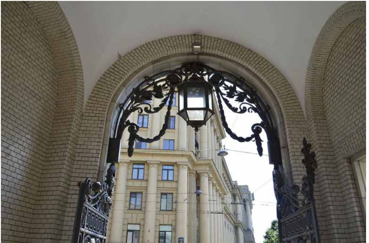
Фото 28. ОКН федерального значения «Особняк Бранта В. Э.» (ул. Куйбышева, дом 2-4, лит. А). Воротный проезд. Облицовка стен и шестигранный фонарь. Фрагмент. Съёмка 01.07.2021 г.
