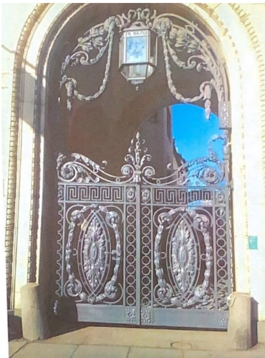
Илл. 93. Научно-реставрационный отчет по объекту. Выполнение первоочередных противоаварийных работ по реставрации кованых ворот с навершием, фонарем Музея политической истории России особняка В.Э. Бранта. 2015 г. Воротная группа после реставрации (вид с ул. Куйбышева)
