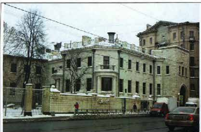
1 Вид с юго-запада
