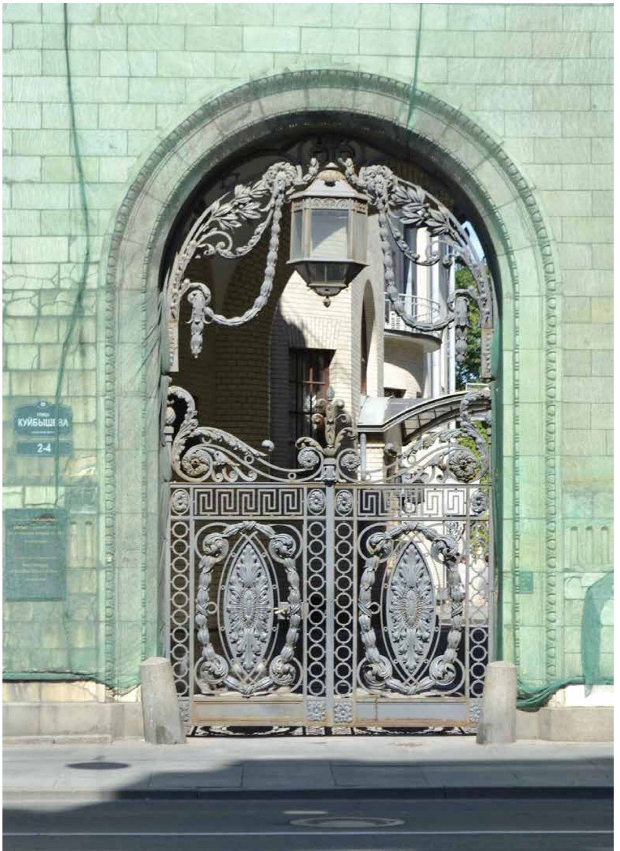
Фото 24. ОКН федерального значения «Особняк Бранта В. Э.» (ул. Куйбышева, дом 2-4, лит. А). Воротный проезд со стороны ул. Куйбышева. Общий вид. Съёмка 01.07.2021 г.
