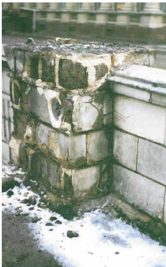
Илл. 57. Инженерное обследование состояния стен, фундаментов, каменной ограды и террасы особняка В.Э. Бранта, 2000 г.
