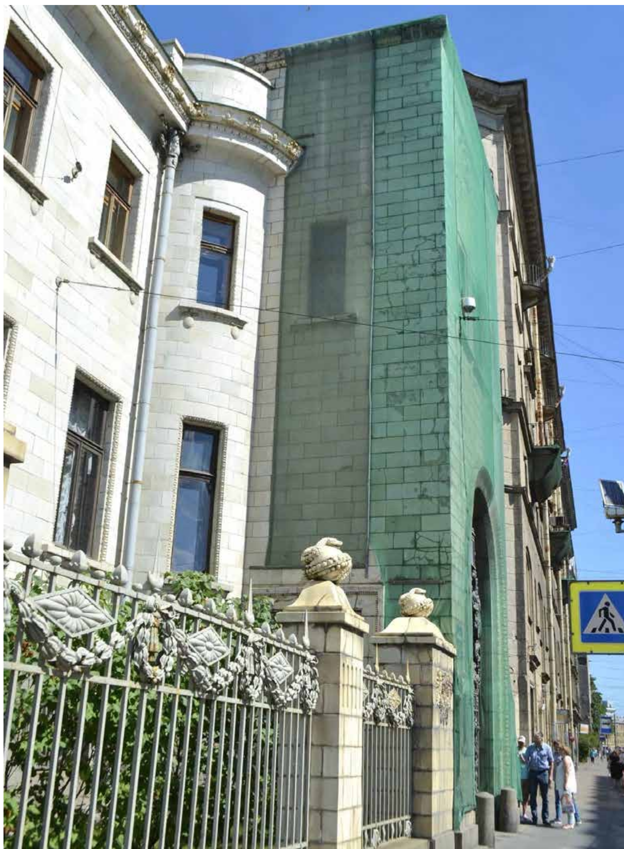
Фото 07. ОКН федерального значения «Особняк Бранта В. Э.» (ул. Куйбышева, дом 2-4, лит. А). Историческая сквозная часть ограды и парапетные столбы, увенчанные воссозданными шарами, обвитыми змеями. Ризалит, вид с юго-запада. Фрагмент. Съёмка 01.07.2021 г.
