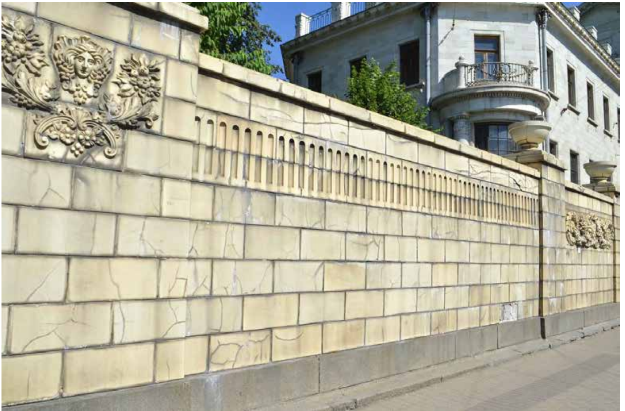
Фото 03. ОКН федерального значения «Особняк Бранта В. Э.» (ул. Куйбышева, дом 2-4, лит. А). Глухая ограда со стороны ул. Куйбышева, облицованная керамическими плитками под мрамор. Фрагмент. Съёмка 01.07.2021 г.
