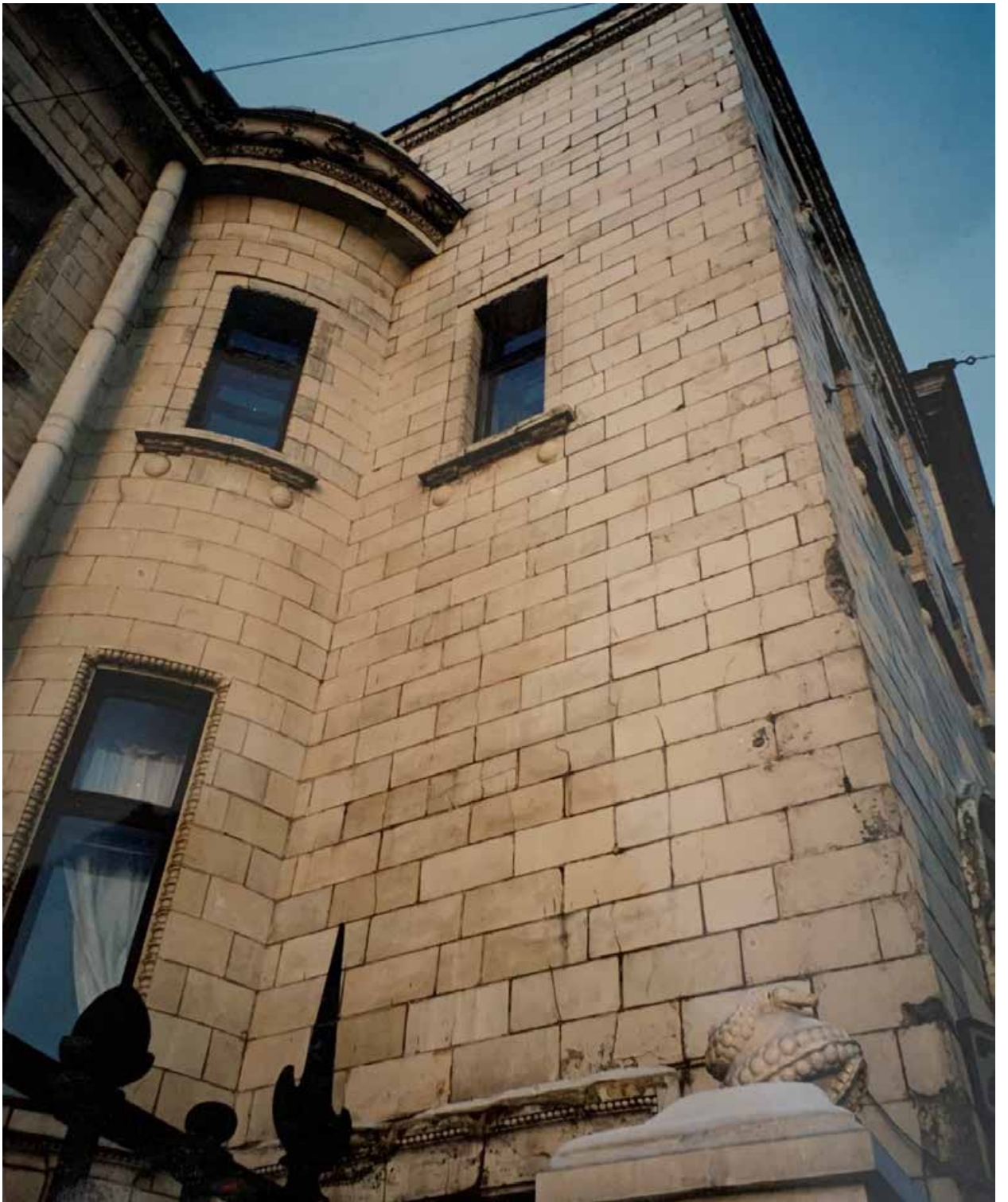
Илл. 48. Фотофиксация до начала производства реставрационных работ в 2003 г.
