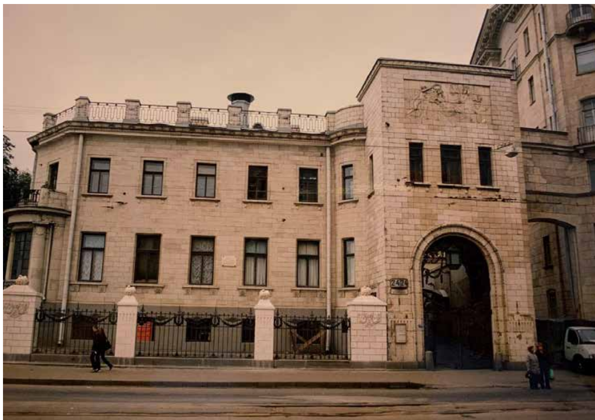
Илл. 45. Фотофиксация до начала производства реставрационных работ в 2003 г.
