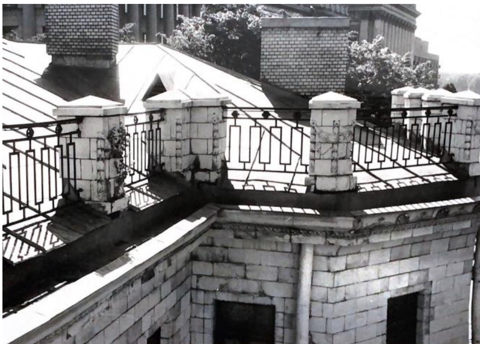
Илл. 65. Особняк Бранта. Парапетные столбы ПС-3 – ПС-9. Парапетные решетки ПР-2 – ПР-5. Вид со стороны фасада. Фотофиксация состояния 1994 г. Проектно-производственная реставрационная фирма «Традиция».
