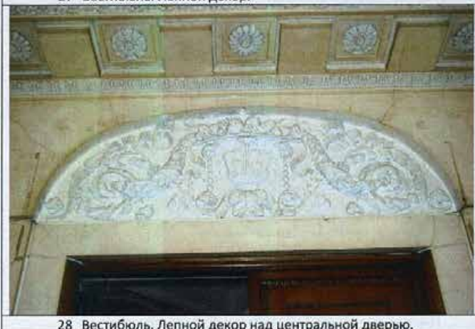
28 Вестибюль. Лепной декор над центральной дверью.
