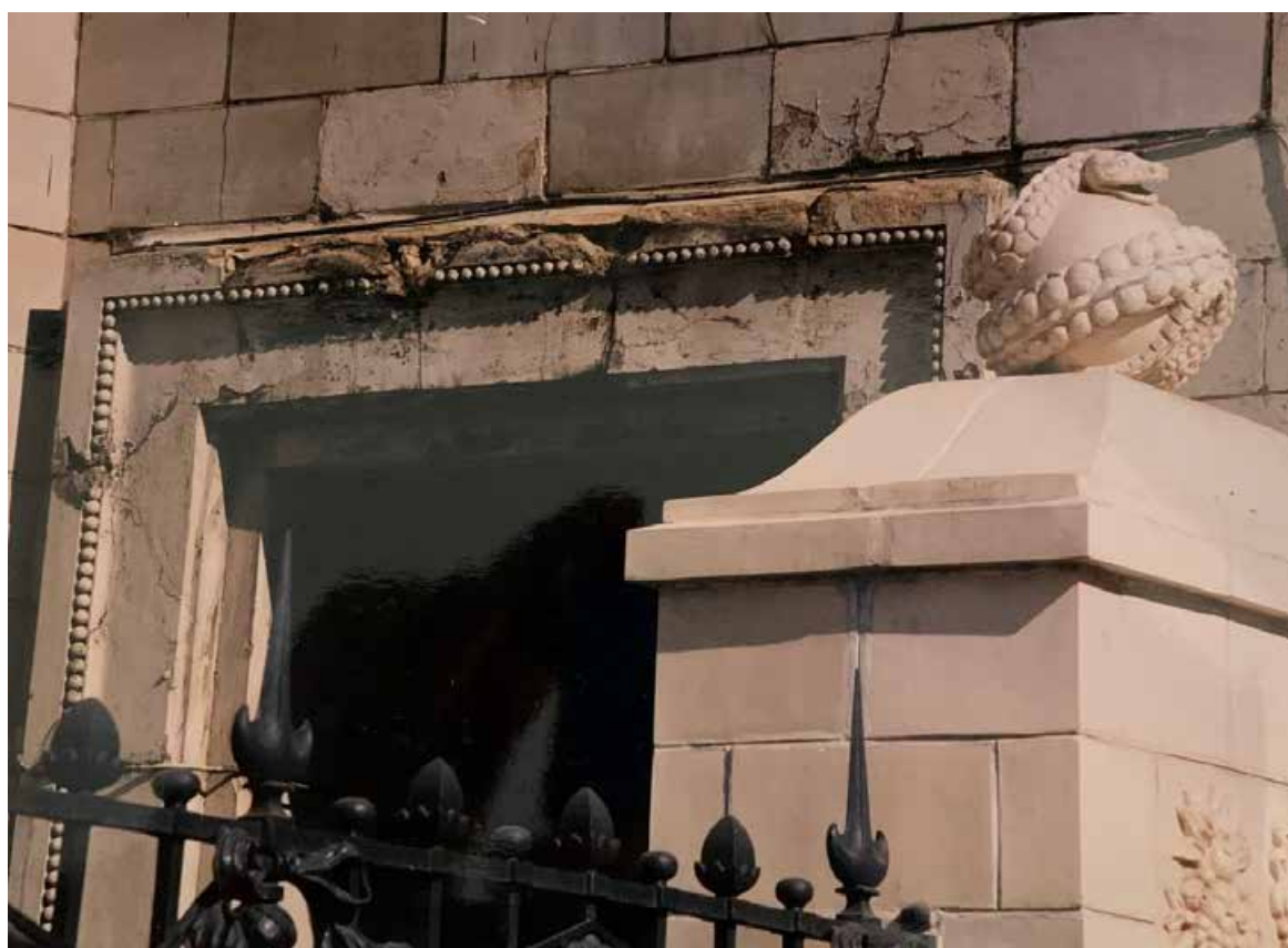
Илл. 51. Фотофиксация до начала производства реставрационных работ в 2003 г.
