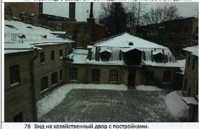
78 Вид на хозяйственный двор с постройками.
