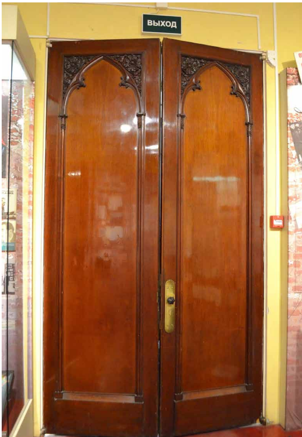
Фото 60. ОКН федерального значения «Особняк Бранта В. Э.» (ул. Куйбышева, дом 2-4, лит. А). Помещение 130. Центральный дверной проем с историческим заполнением. Фрагмент. Съёмка 01.07.2021 г.
