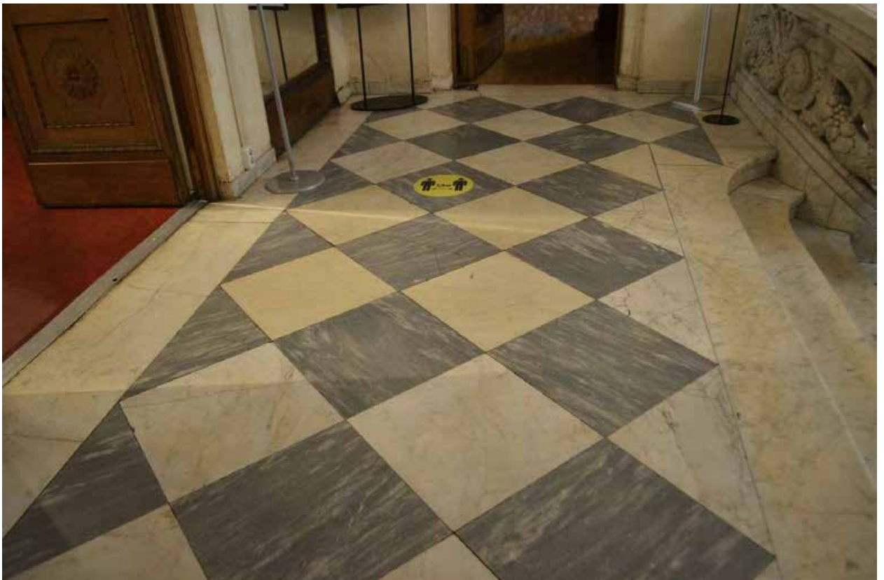
Фото 53. ОКН федерального значения «Особняк Бранта В. Э.» (ул. Куйбышева, дом 2-4, лит. А). Помещение 125. Верхняя площадка парадной лестницы облицована белым и серым с прожилками мрамором шахматного рисунка. Фрагмент. Съёмка 01.07.2021 г.
