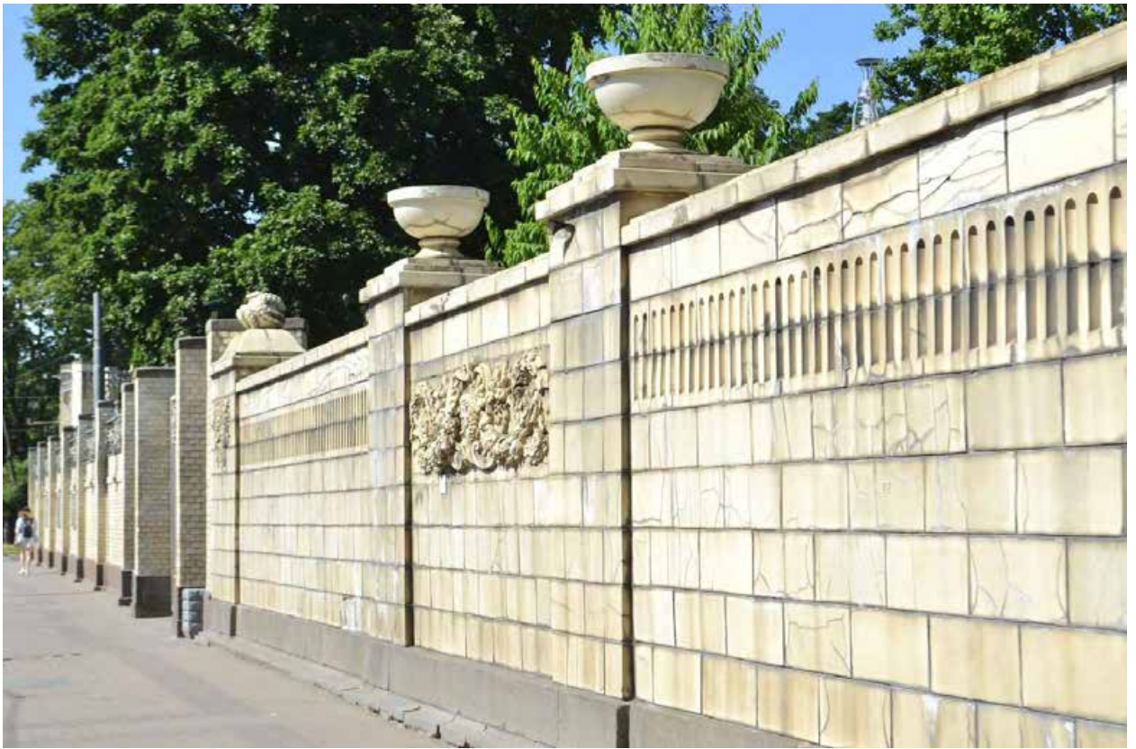
Фото 01. ОКН федерального значения «Особняк Бранта В. Э.» (ул. Куйбышева, дом 2-4, лит. А). Ограда со стороны ул. Куйбышева. Общий вид. Съёмка 01.07.2021 г.
