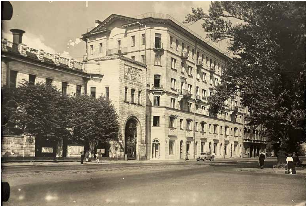
Илл. 26. «Жилой дом на улице Куйбышева», Жуков М.П., 1951 г. ЦГАКФФД СПб. Гр- 87013.
