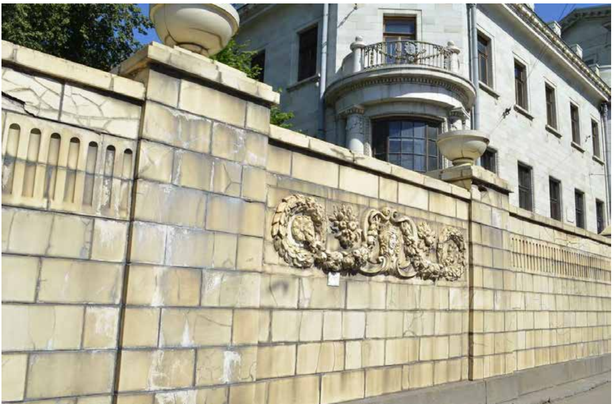
Фото 04. ОКН федерального значения «Особняк Бранта В. Э.» (ул. Куйбышева, дом 2-4, лит. А). Центральная часть глухой ограды со стороны ул. Куйбышева, облицованная керамическими плитками под мрамор, увенчанная вазами. Фрагмент. Съёмка 01.07.2021 г.
