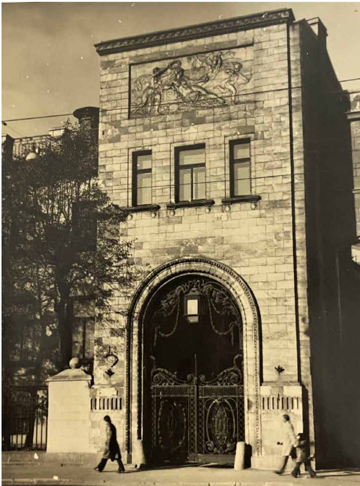
Илл. 32. «Вид части здания Музея революции со стороны улицы Куйбышева», Овчинников К.В., 17 октября 1976 г. ЦГАКФФД СПб. Бр-72823.
