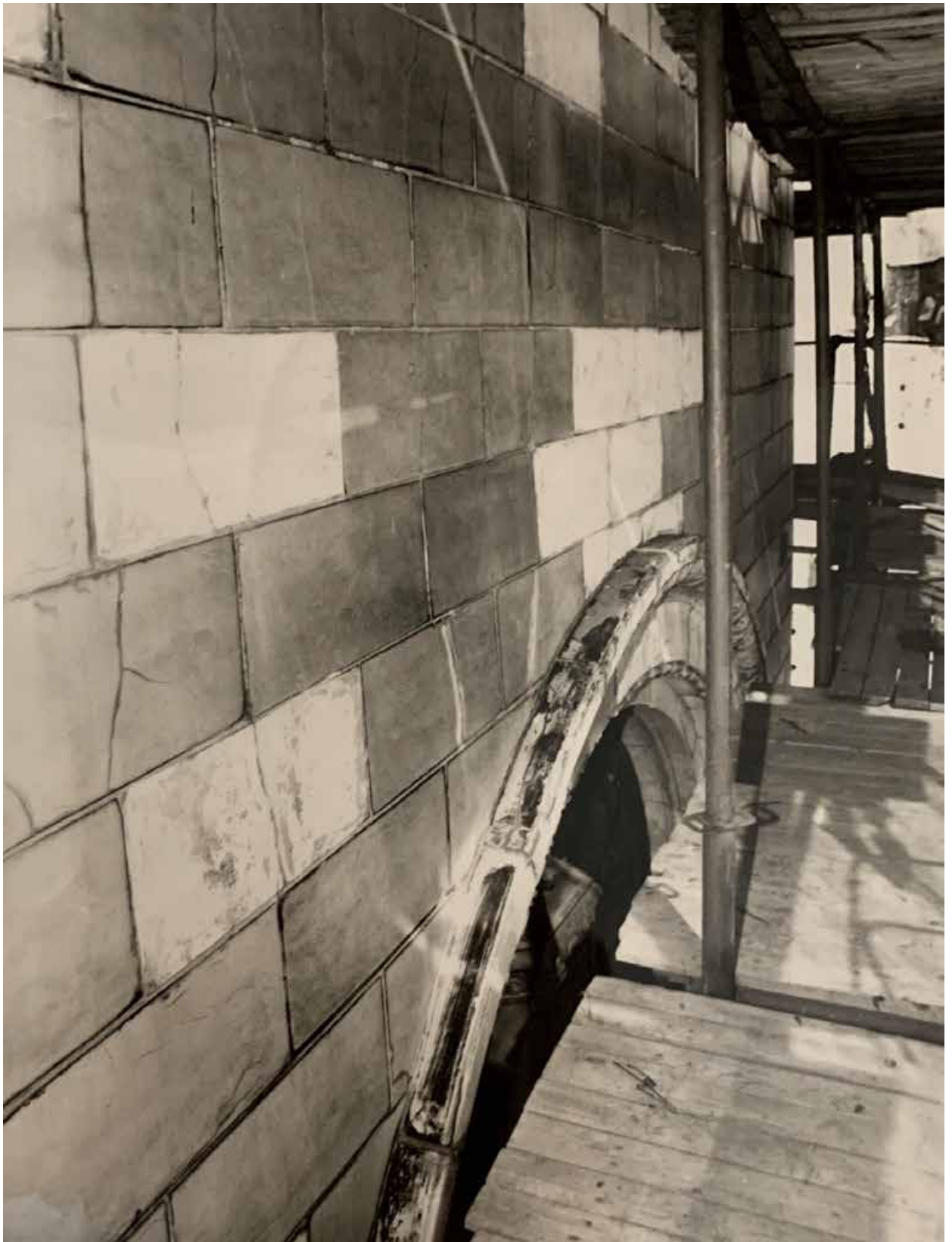
Илл. 54. Фотофиксация до начала производства реставрационных работ (после установки лесов на портале) в 2003 г.
