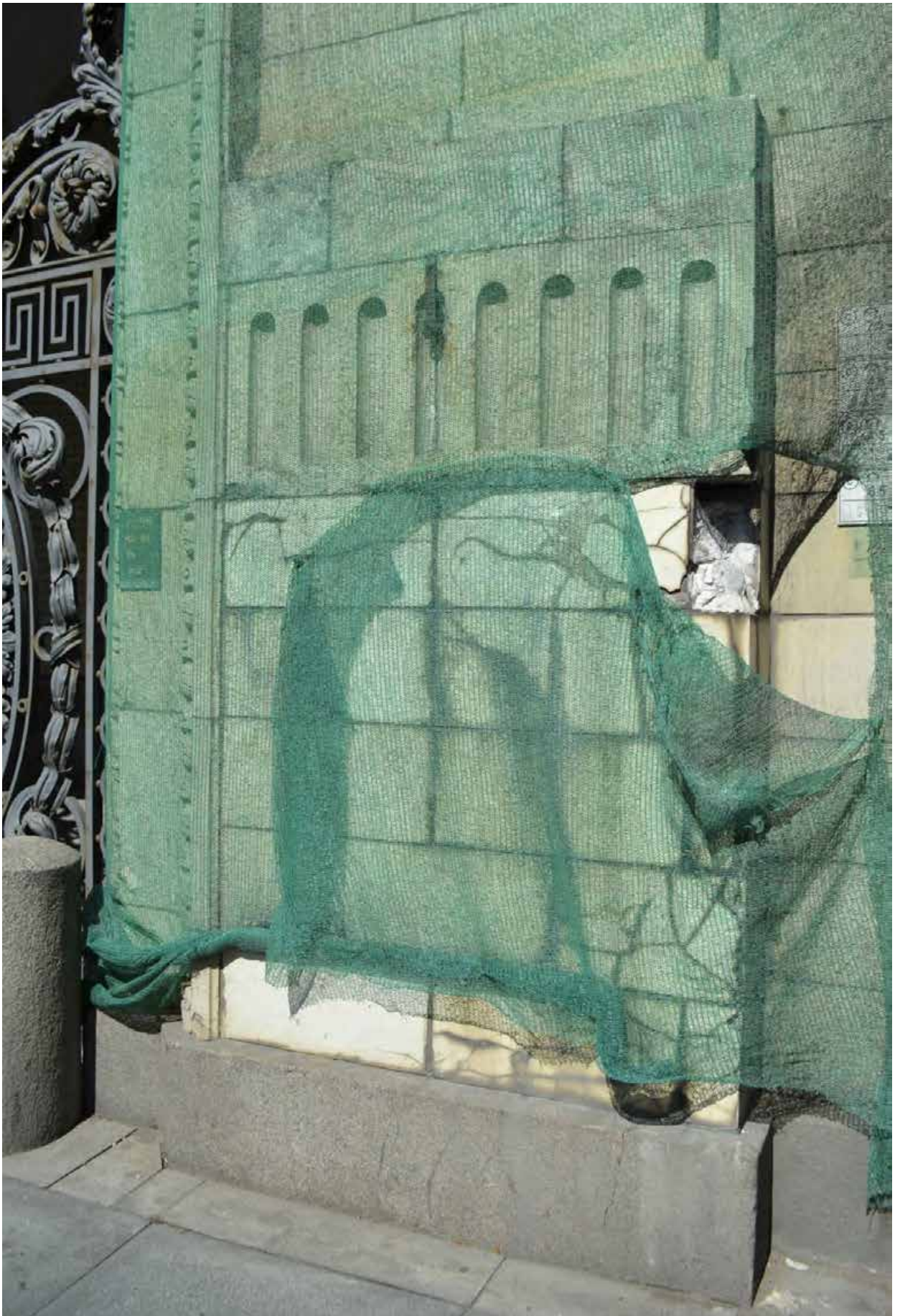
Фото 26. ОКН федерального значения «Особняк Бранта В. Э.» (ул. Куйбышева, дом 2-4, лит. А). Ризалит со стороны ул. Куйбышева. Фрагмент. Съёмка 01.07.2021 г.
