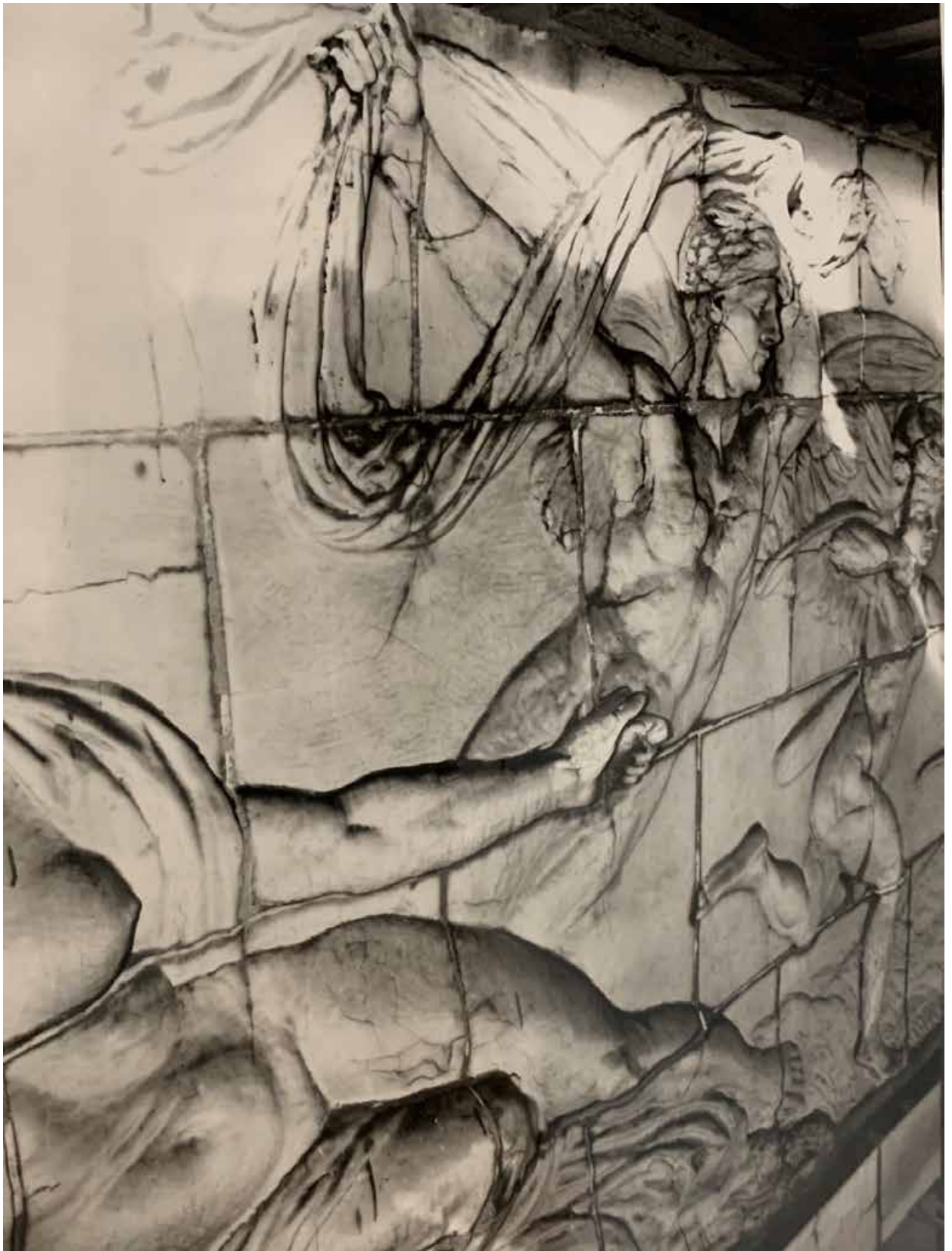
Илл. 56. Фотофиксация до начала производства реставрационных работ (после установки лесов на портале) в 2003 г.
