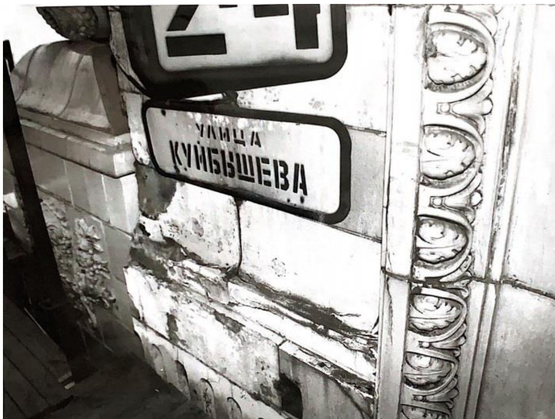
Илл. 79. Фотофиксация портала до начала производства работ (после установки лесов). РПНЦ «Специалист», 2003 г. Юго-западный угол Место примыкания к отреставрированной ограде.
