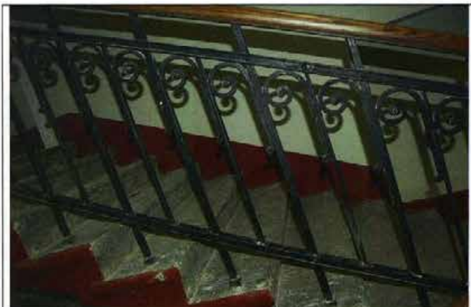
77 Лестница в северной части здания. Перильное ограждение.
