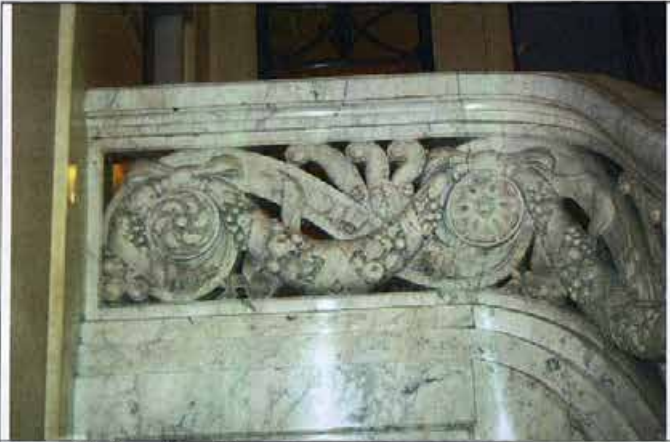
29 Вестибюль. Перильное ограждение лестницы.
