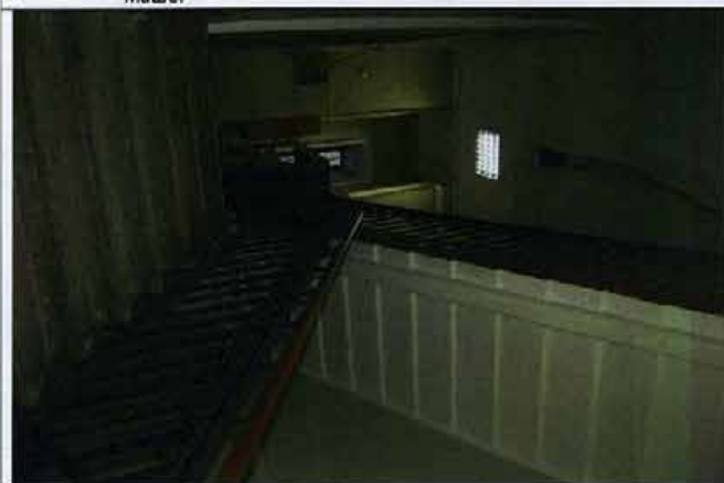
76 Лестница в северной части здания.
