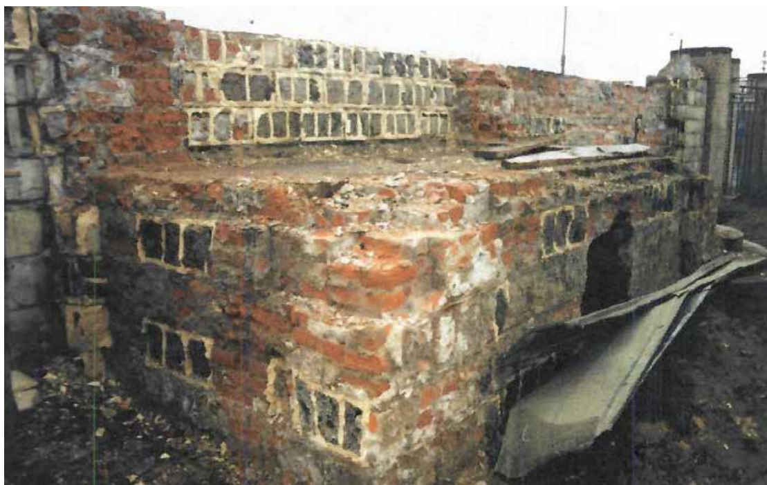
Илл. 60. Инженерное обследование состояния стен, фундаментов, каменной ограды и террасы особняка В.Э. Бранта, 2000 г.
