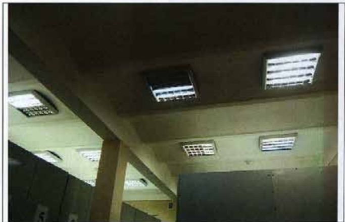
83 Хозяйственный двор. Западный флигель. Перекрытие.
