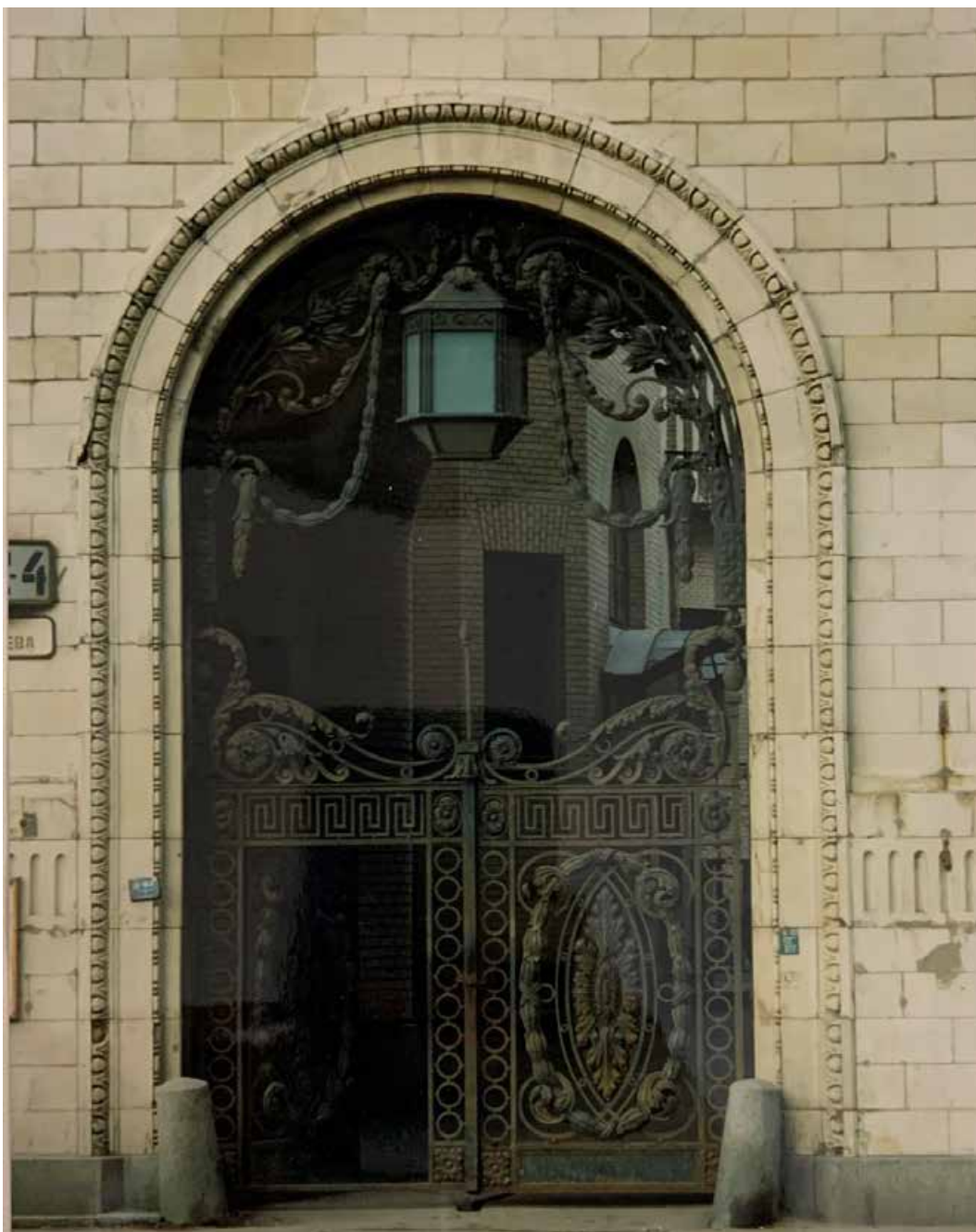
Илл. 49. Фотофиксация до начала производства реставрационных работ в 2003 г.
