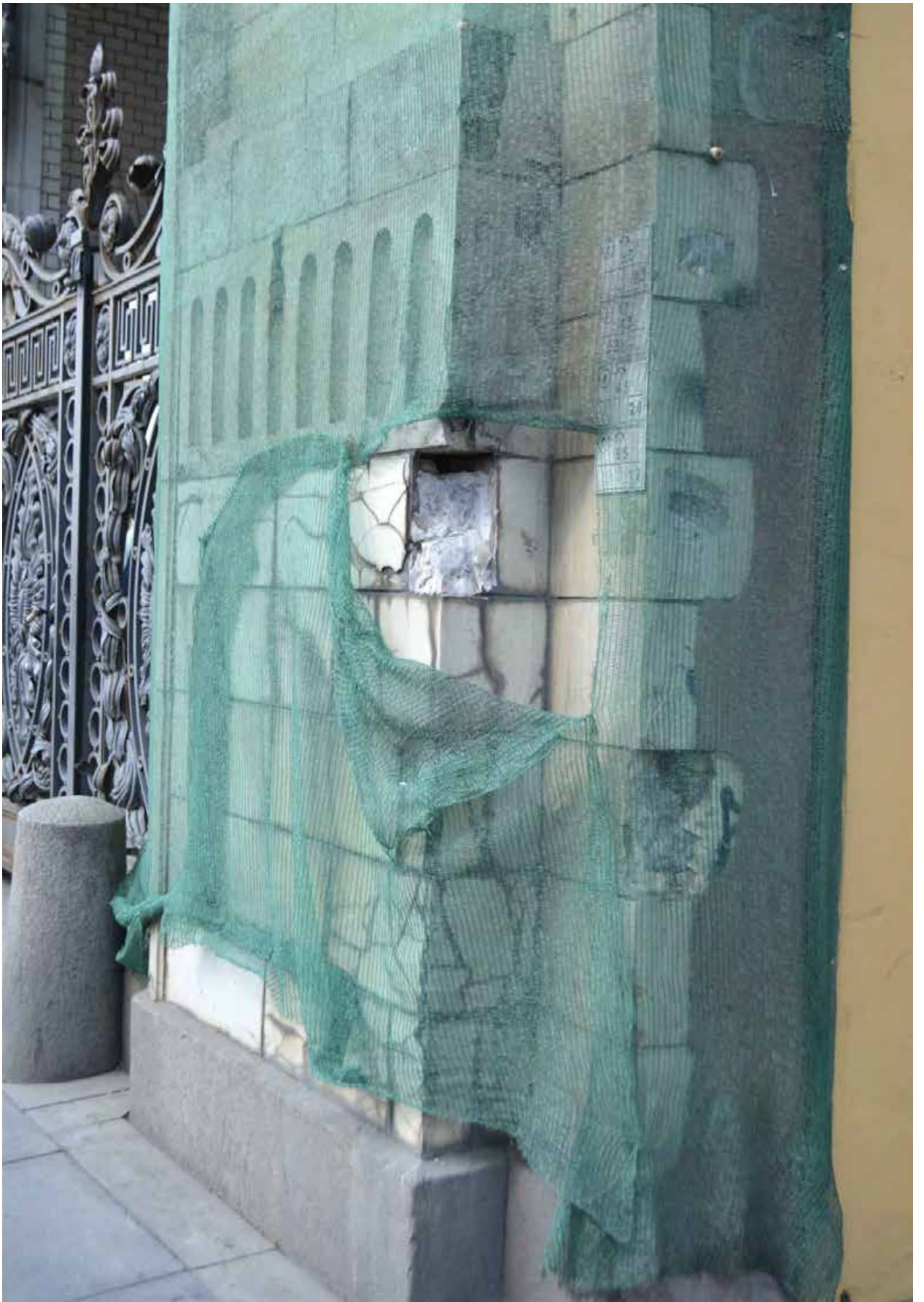
Фото 27. ОКН федерального значения «Особняк Бранта В. Э.» (ул. Куйбышева, дом 2-4, лит. А). Ризалит со стороны ул. Куйбышева. Вид с юго-востока. Фрагмент. Съёмка 01.07.2021 г.
