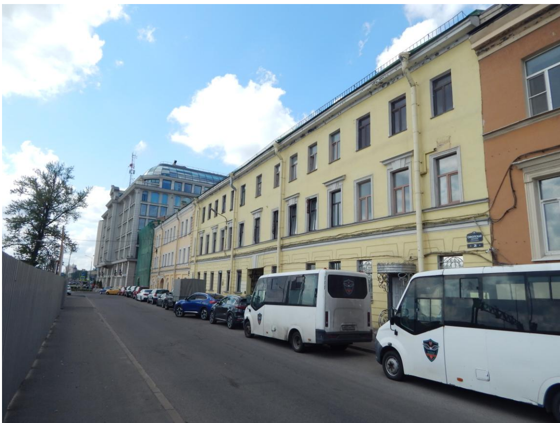
Фото 5. Лицевой фасад выявленного объекта культурного наследия «Дом Трофимовых»
