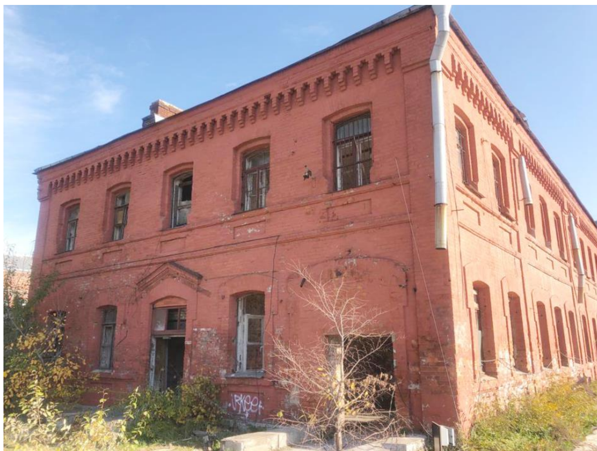
Фото 1. Объект культурного наследия регионального значения «Товарная контора Варшавского вокзала». Общий вид западного фасада.
