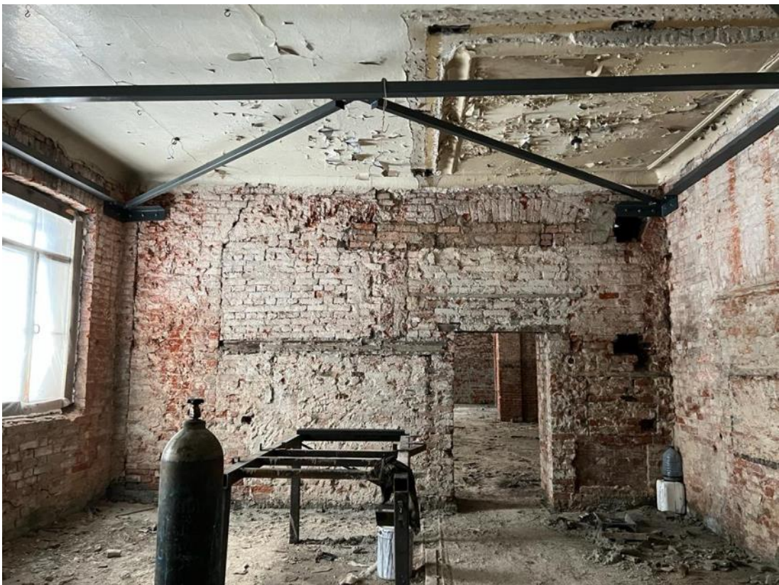
Фото 31. Стена по оси 10 в осях Б – В. Справа видна граница пристройки. Следы перекладок. Вид с восточной стороны.
