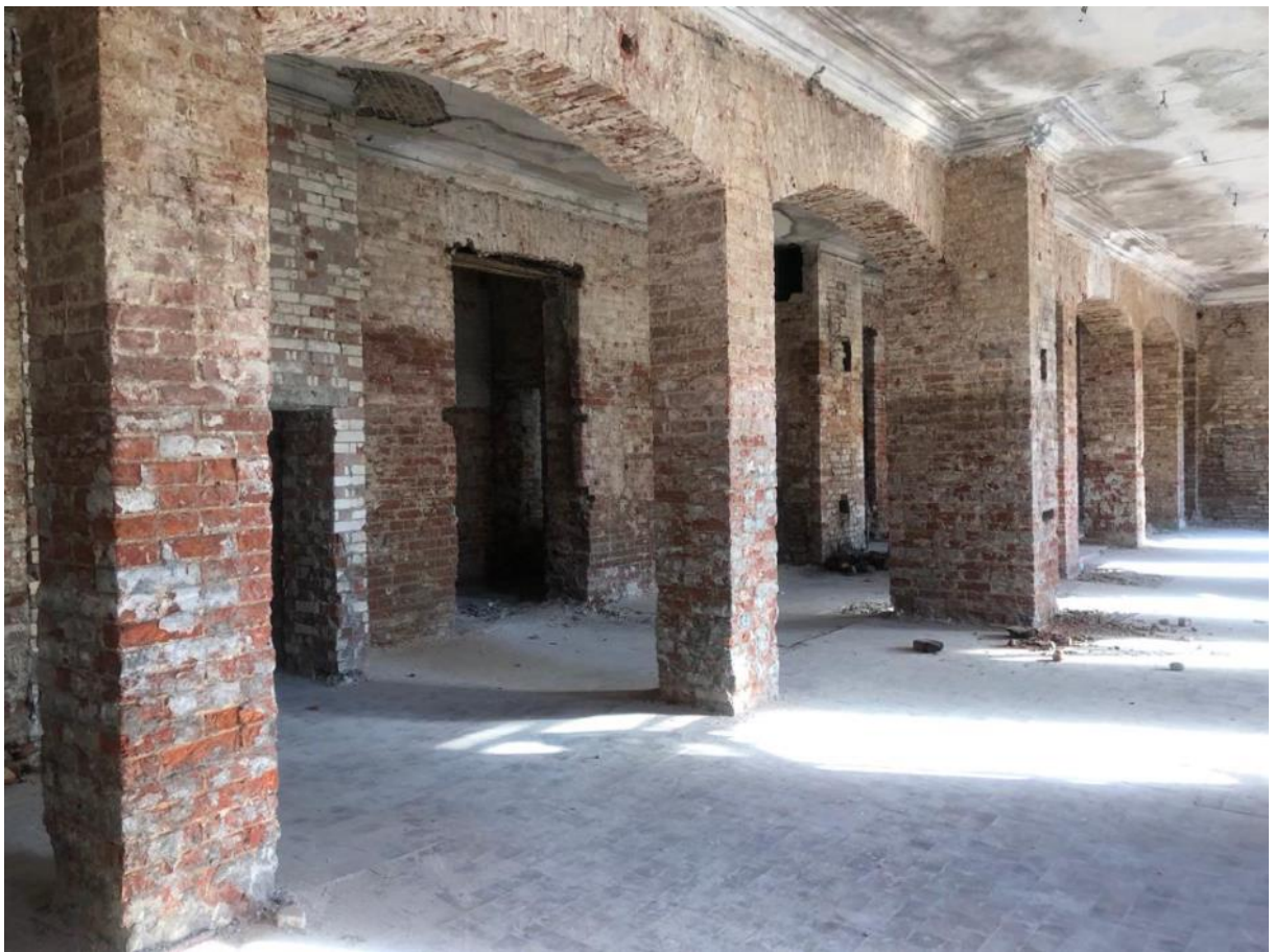
Фото 25. Зальное помещение 1-го этажа в осях 3 – 10/Б – Г. Вид в сторону северо-востока.
