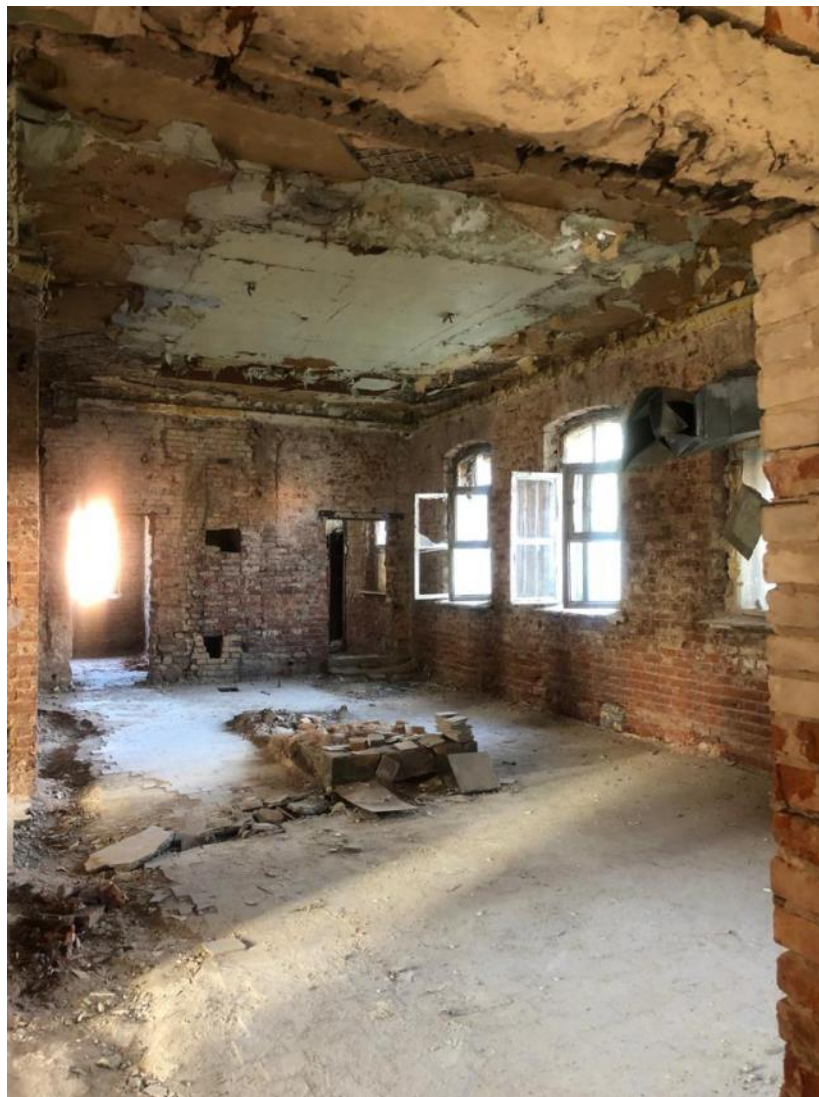
Фото 27. Помещение 1-го этажа в осях 2 – 6/Г – Ж. Вид на северную наружную стену.
