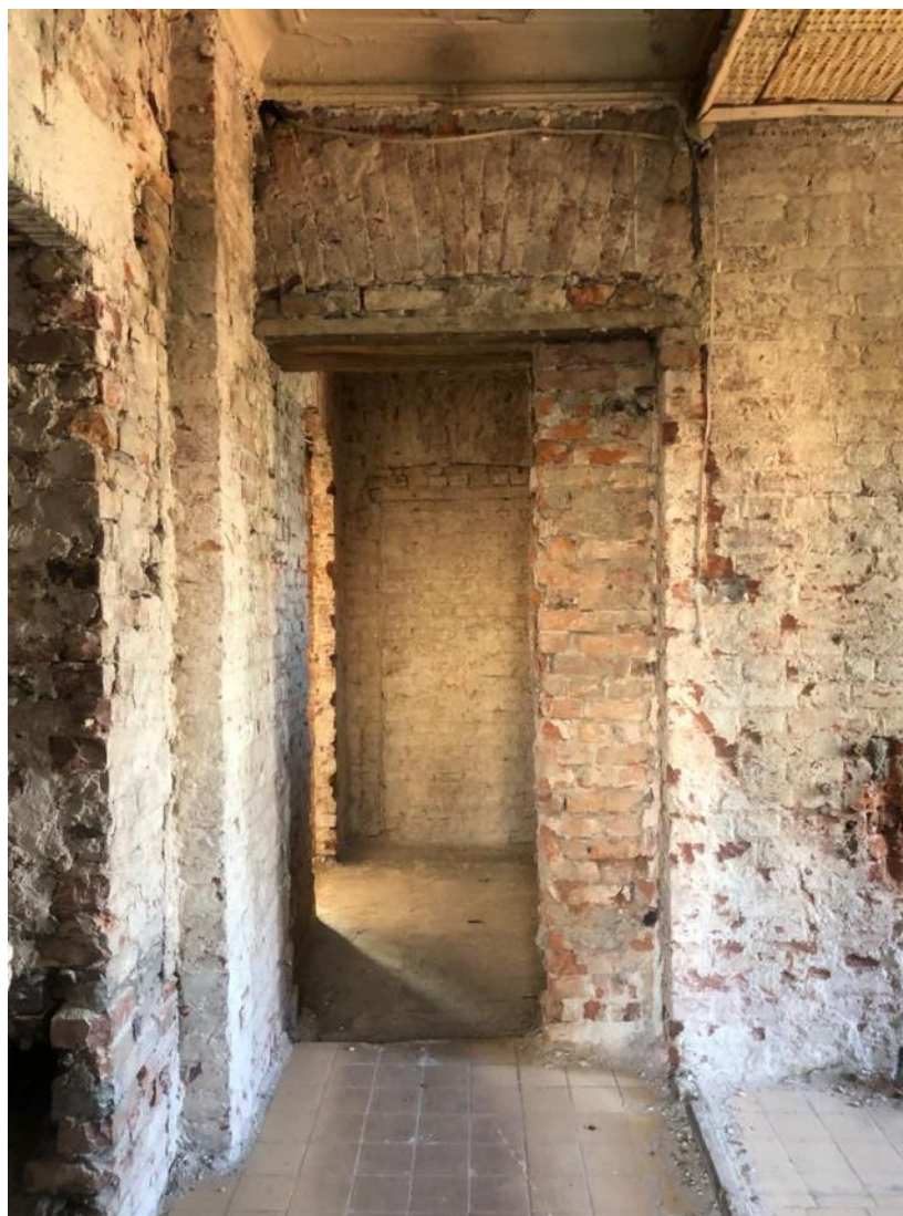
Фото 23. Помещение 2-го этажа в осях 1 – 2/Е – Г. Вид в сторону юга.
