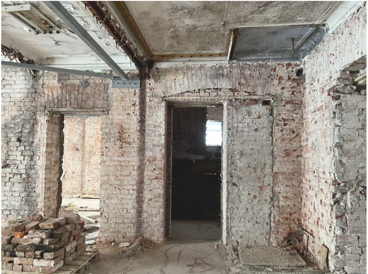
Фото 20. Помещение 2-го этажа . Вид на стену по оси 2- выход на западную лестницу. Вид с востока.
