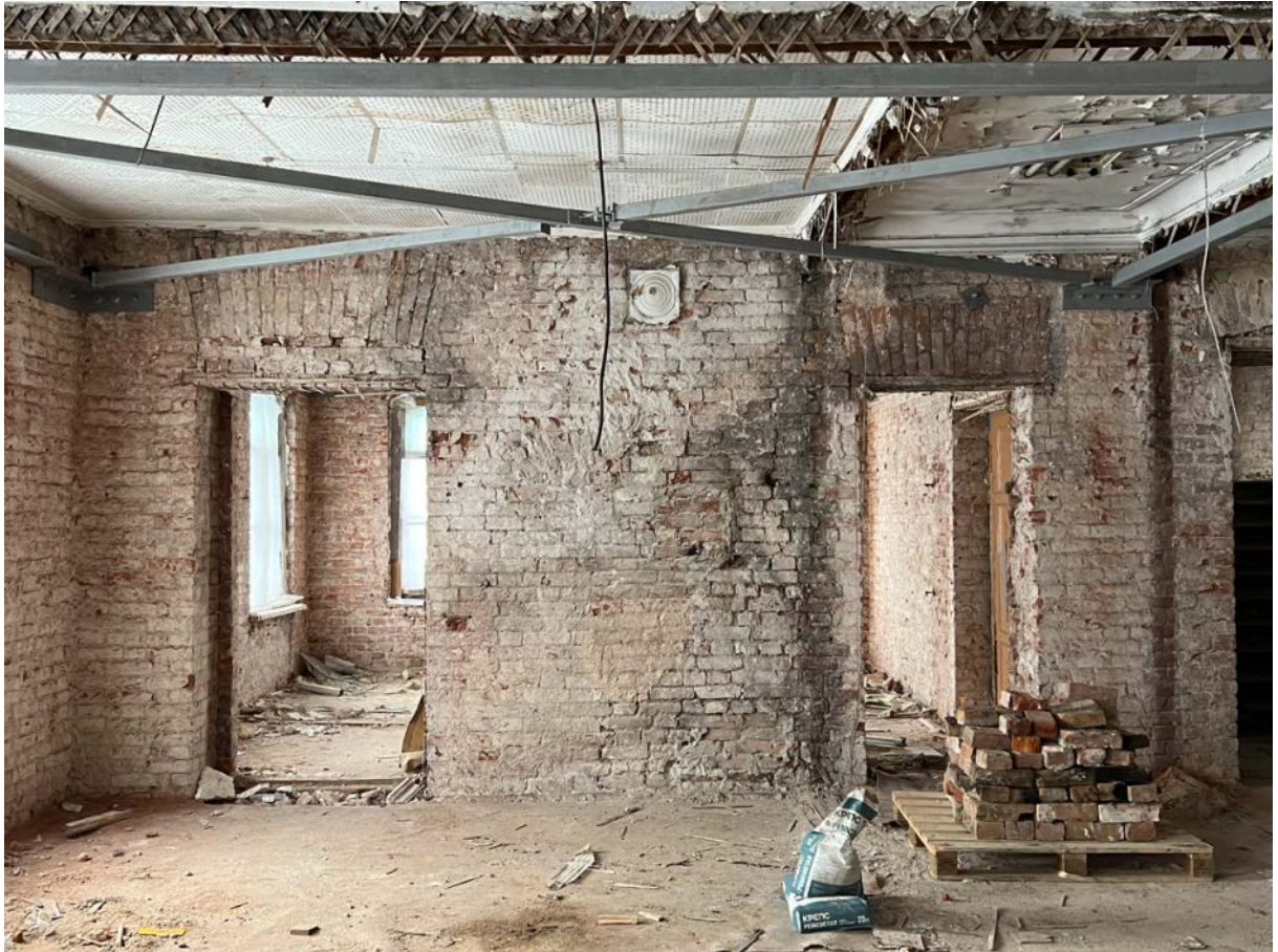
Фото 21. Помещение 2-го этажа. Вид на стену по оси 2 между осями А – В с востока.
