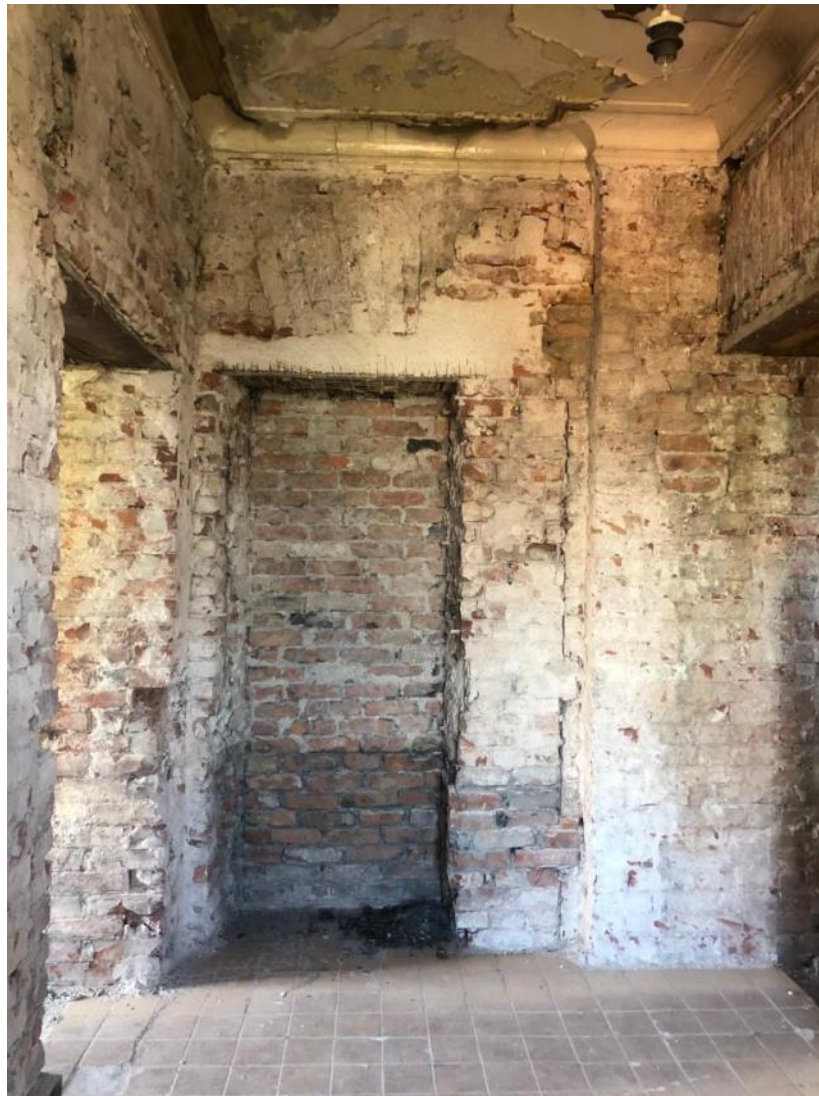
Фото 22. Помещение 2-го этажа в осях 1 – 2/Г – Е. Вид на стену по оси 2 с запада.
