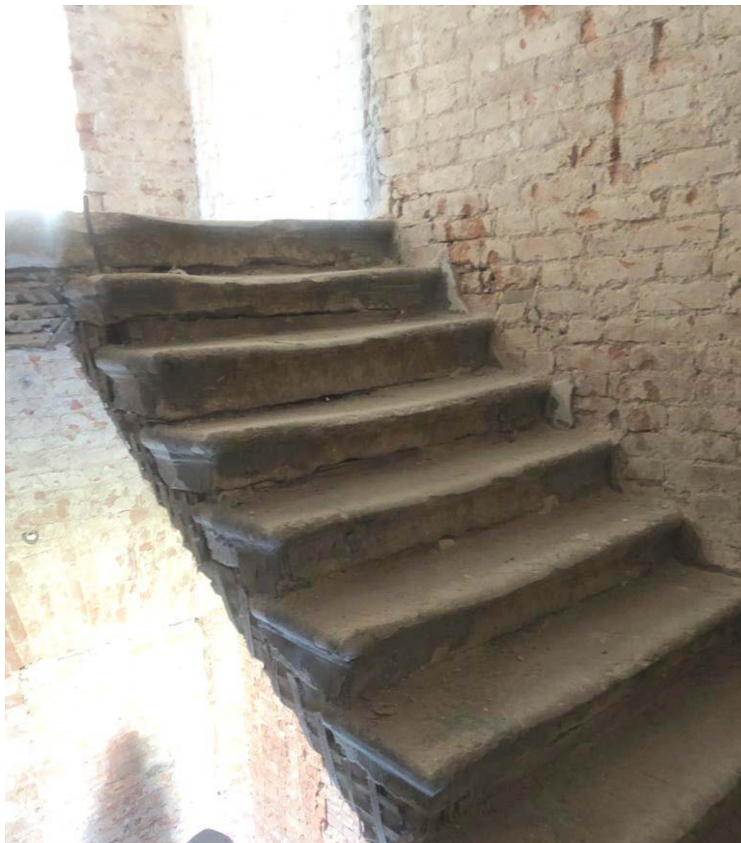
Фото 14. Западная лестница. Вид на площадку 2-го этажа с междуэтажной площадки.
