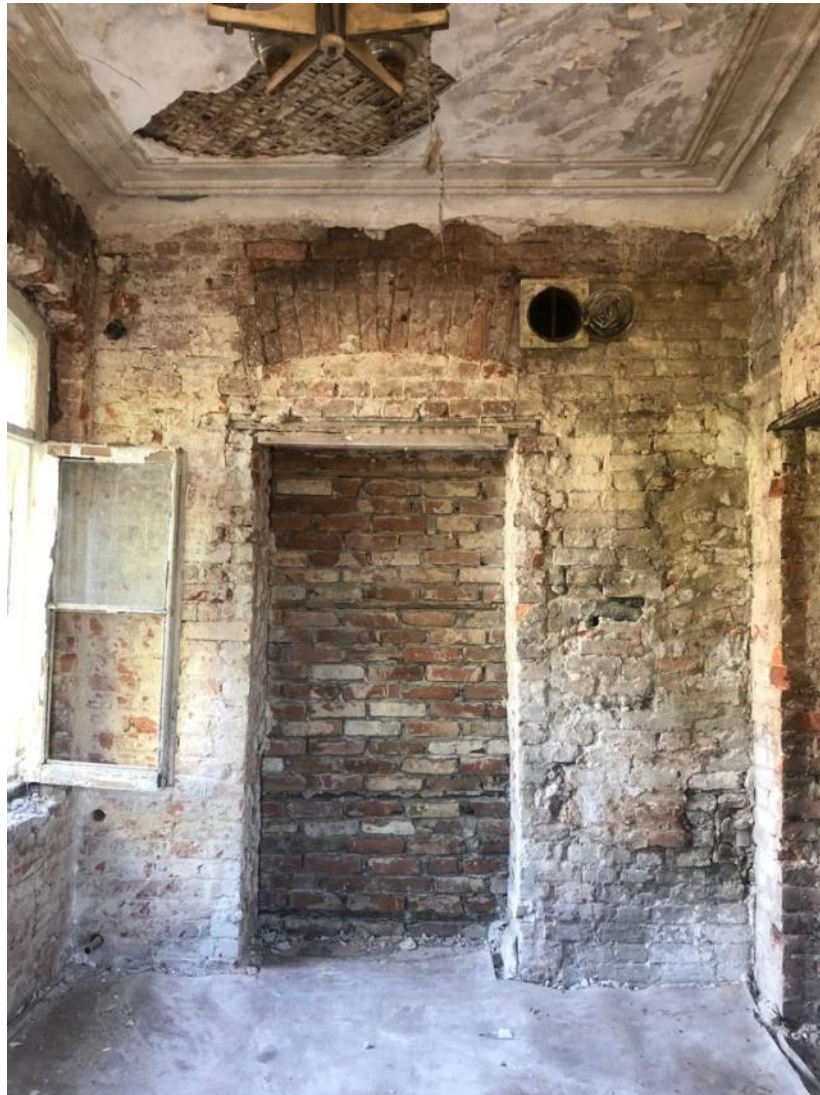
Фото 18. Помещение 2-го этажа в осях 1 – 2/Е – Ж. Вид от западной стены по оси 2.
