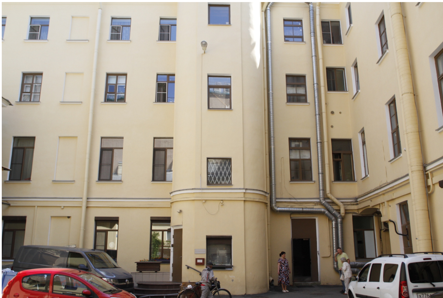
15. “Дом Яковлевой В.А. (Серебряковой О.В.)”. СПб, Итальянская ул., д.10/5, литера А. Фрагмент дворового фасада. Фото: 14.06.2023 г.
