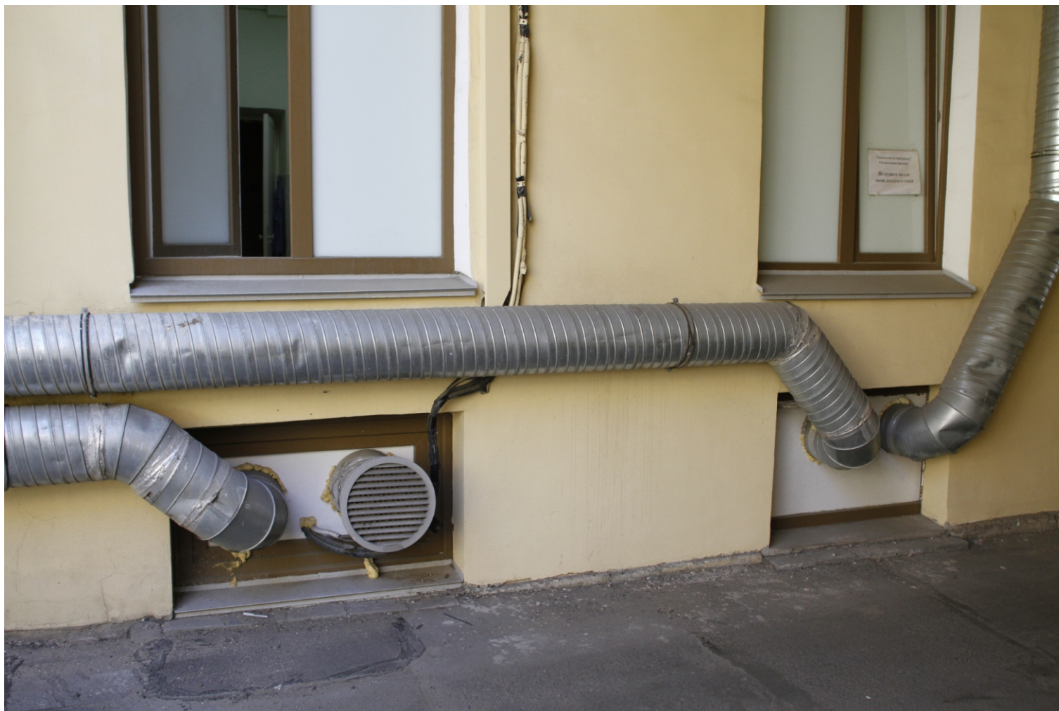
14. “Дом Яковлевой В.А. (Серебряковой О.В.)”. СПб, Итальянская ул., д.10/5, литера А. Фрагмент дворового фасада. Фото: 14.06.2023 г.
