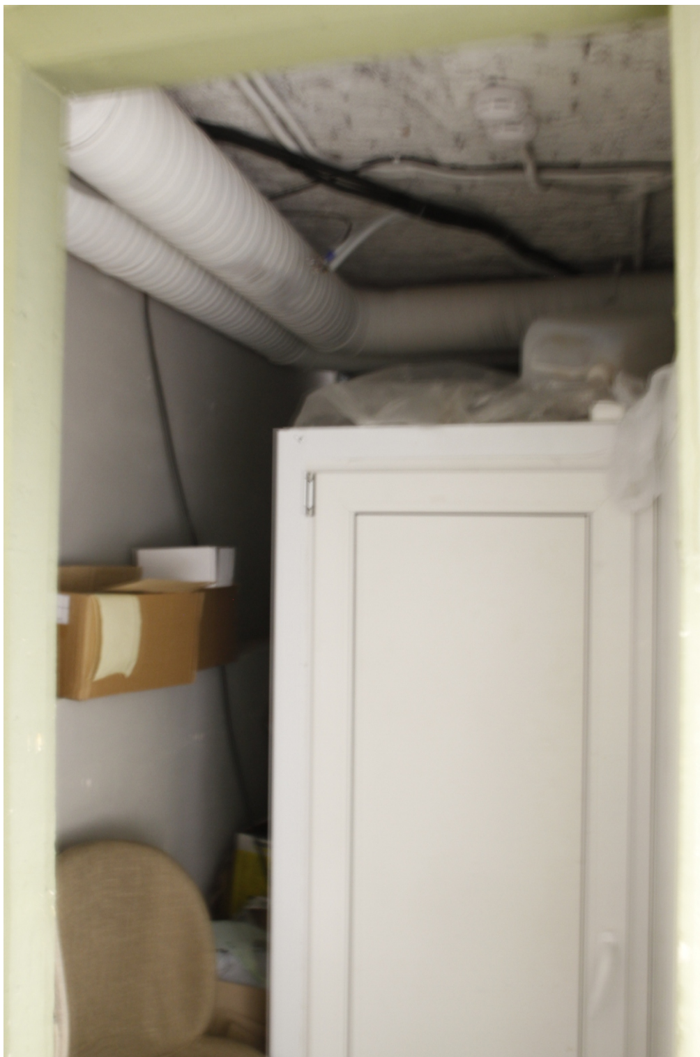
17. “Дом Яковлевой В.А. (Серебряковой О.В.)”. СПб, Итальянская ул., д.10/5, литера А. Фрагмент интерьера пом. 4-Н. Фото: 14.06.2023 г.
