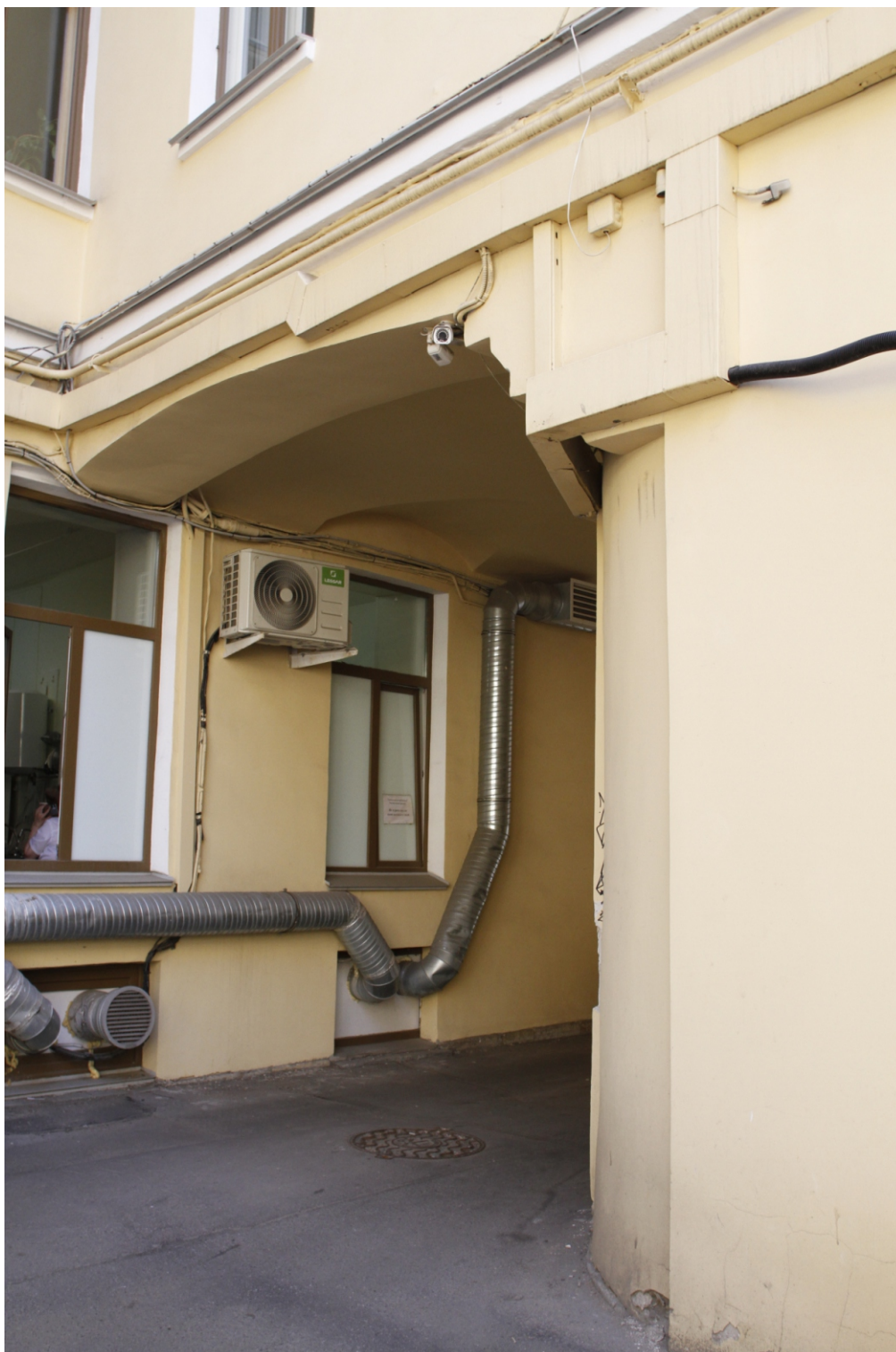
12. “Дом Яковлевой В.А. (Серебряковой О.В.)”. СПб, Итальянская ул., д.10/5, литера А. Фрагмент дворового фасада. Фото: 14.06.2023 г.
