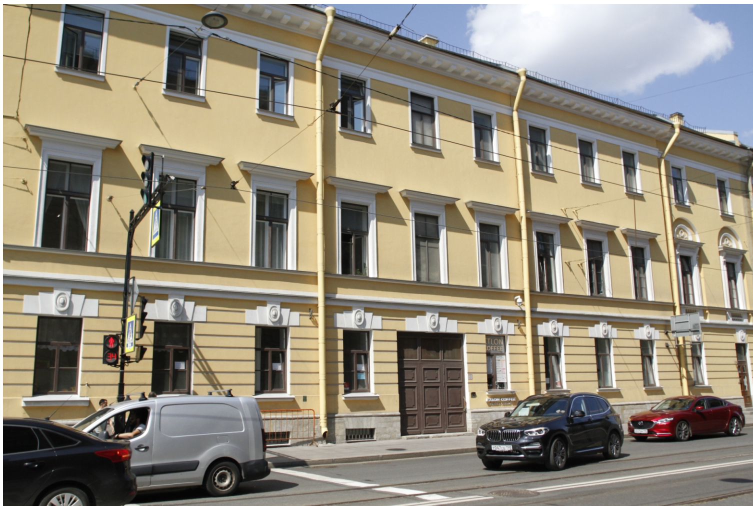
3. “Дом Яковлевой В.А. (Серебряковой О.В.)”. СПб, Итальянская ул., д.10/5, литера А. Фрагмент лицевого фасада по Садовой ул. Фото: 14.06.2023 г.
