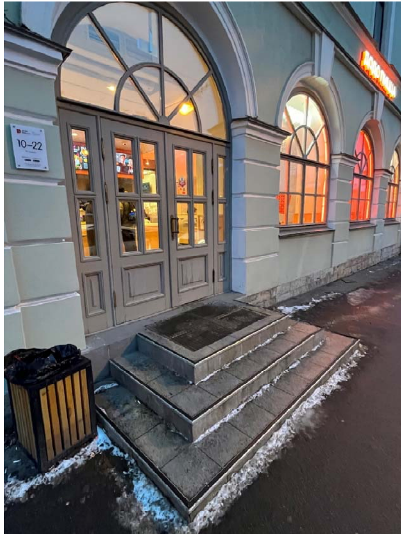
Фото №3. Лицевой юго-восточный фасад, главный вход, крыльцо.
