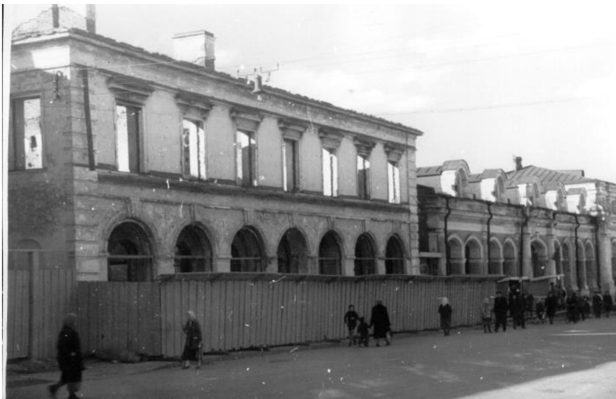
Илл. 20. Разрушенный дом № 20 по улице Коминтерна (Оранжерейной). Фото: Лаптев Сергей Дмитриевич. 1946–1948 гг. ЦГАКФФД СПб. Фотодокумент Ар 202524.
