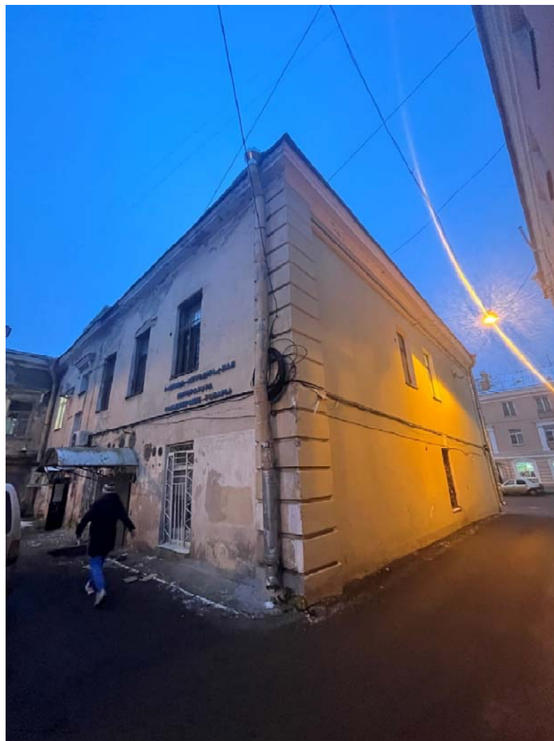
Фото №4. Дворовый северо-западный и торцевой юго-западный фасады.
