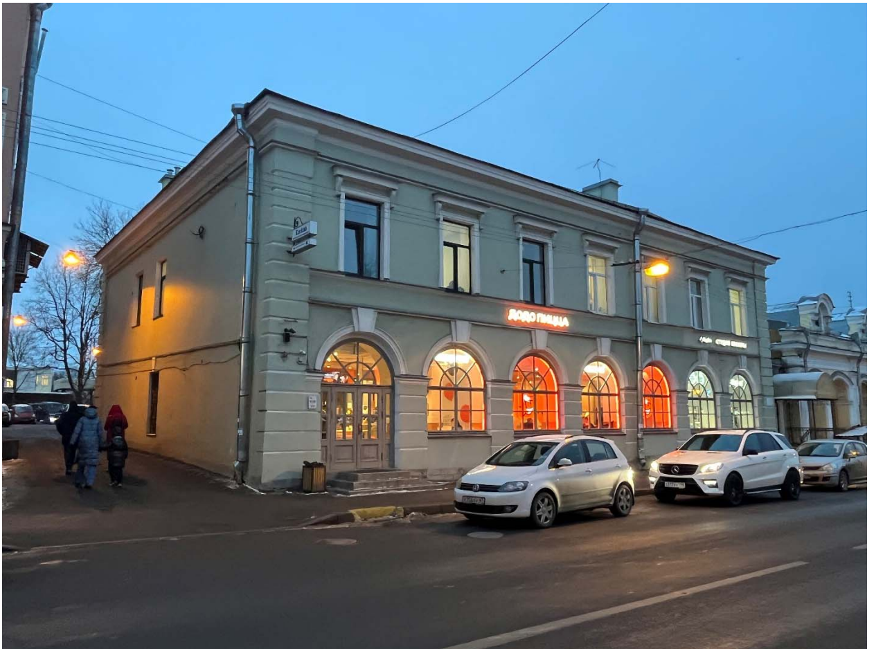
Фото №1. Лицевой юго-восточный фасад.
