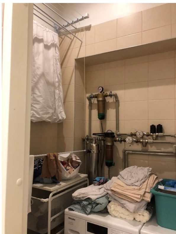
Фото 26. Вид на помещение № 12.
