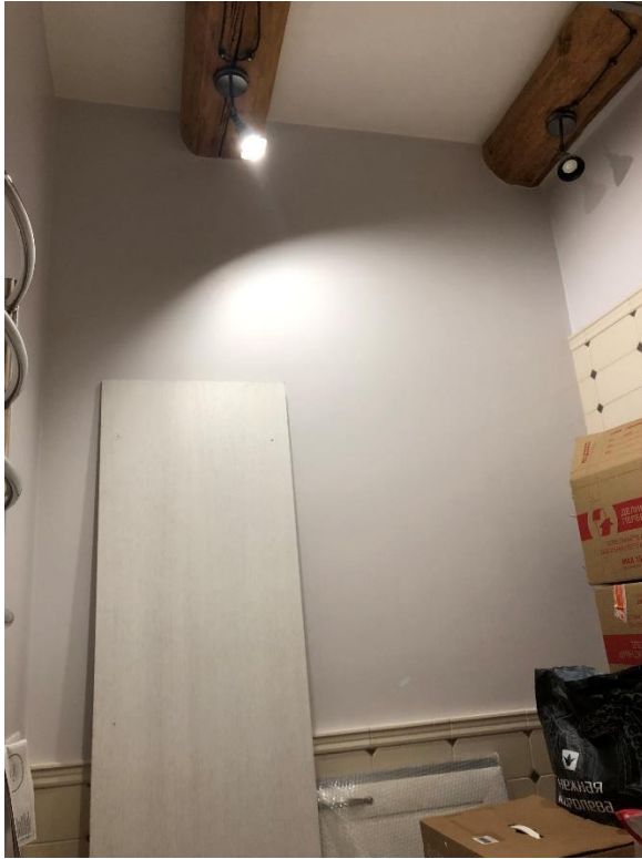
Фото 28. Вид на помещение № 7.
