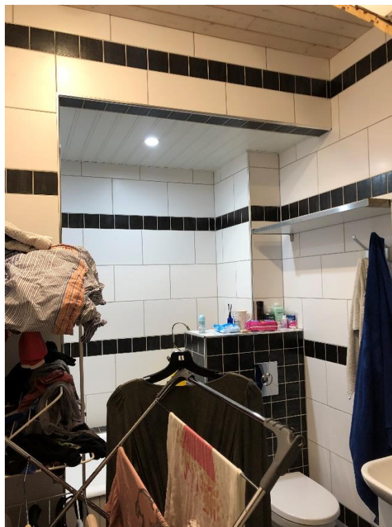
Фото 8. Вид на помещение № 3.
