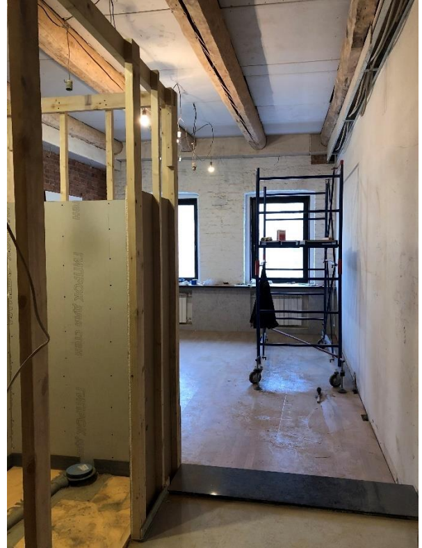
Фото 14. Вид на помещение № 18.
