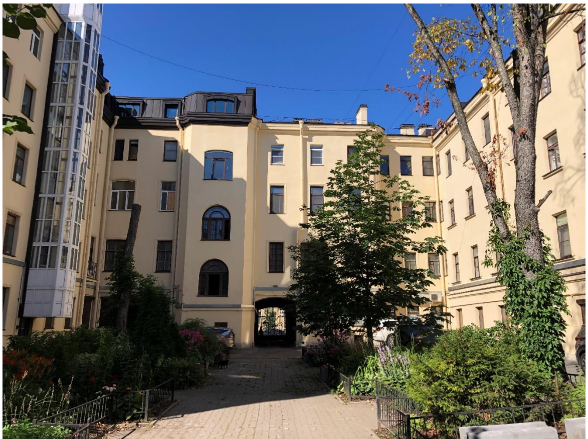
Фото 6. Вид на северный дворовый фасад.
