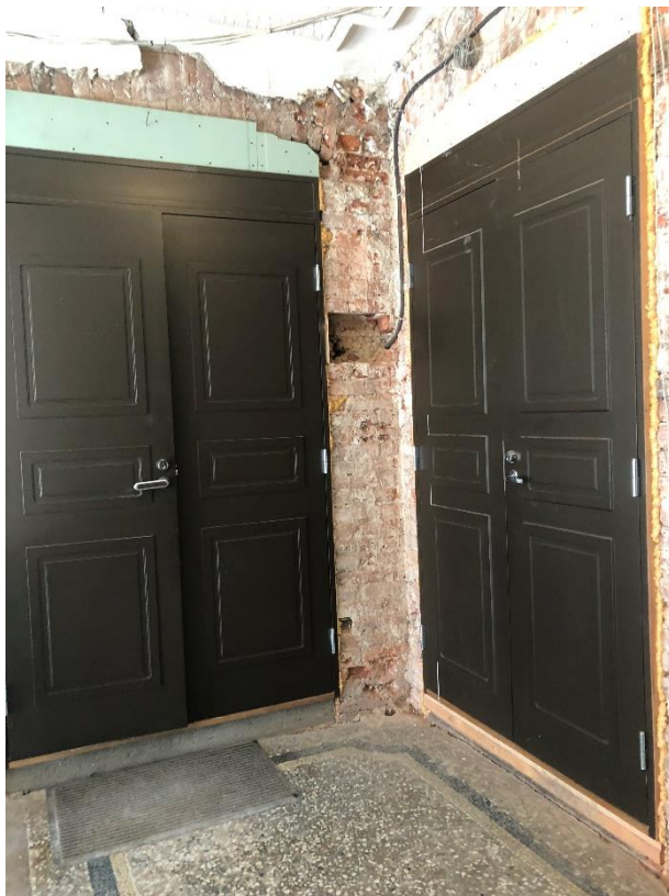
Фото 1. Вид на входные двери в квартиру № 6 с парадной лестницы.
