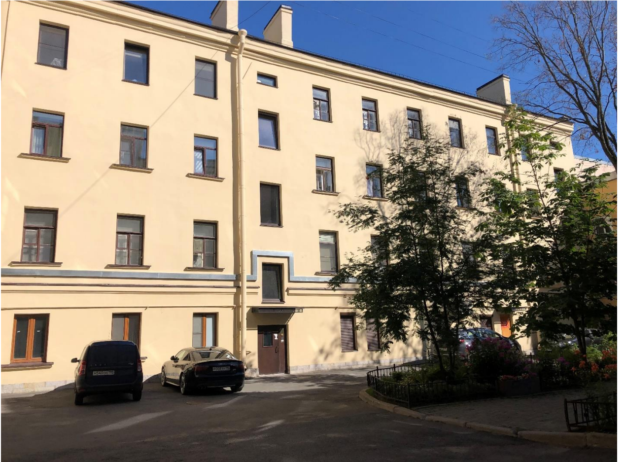
Фото 7. Вид на восточный дворовый фасад.
