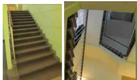
парадная лестница – местоположение (помещение 12-Н(1, 5, 12, 38), северная часть корпуса по Думской ул.), габариты, тип (распашная сложной конфигурации), конструкция (марши на металлических косоурах, на оштукатуренных кронштейнах), вид материала ступеней (известняк), орнаментированные подступенки; поручень – габариты, конфигурация, материал (дерево), цвет (цвет натурального дерева);
