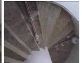
лестница – местоположение (юго-западная часть башни, между ярусами), габариты, тип (маршевая), конструкция (марши на металлических косоурах), вид материала ступеней (известняк);
