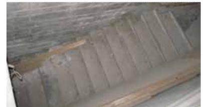
межэтажная лестница – местоположение (башня), габариты, тип (винтовая), вид материала ступеней (известняк);
