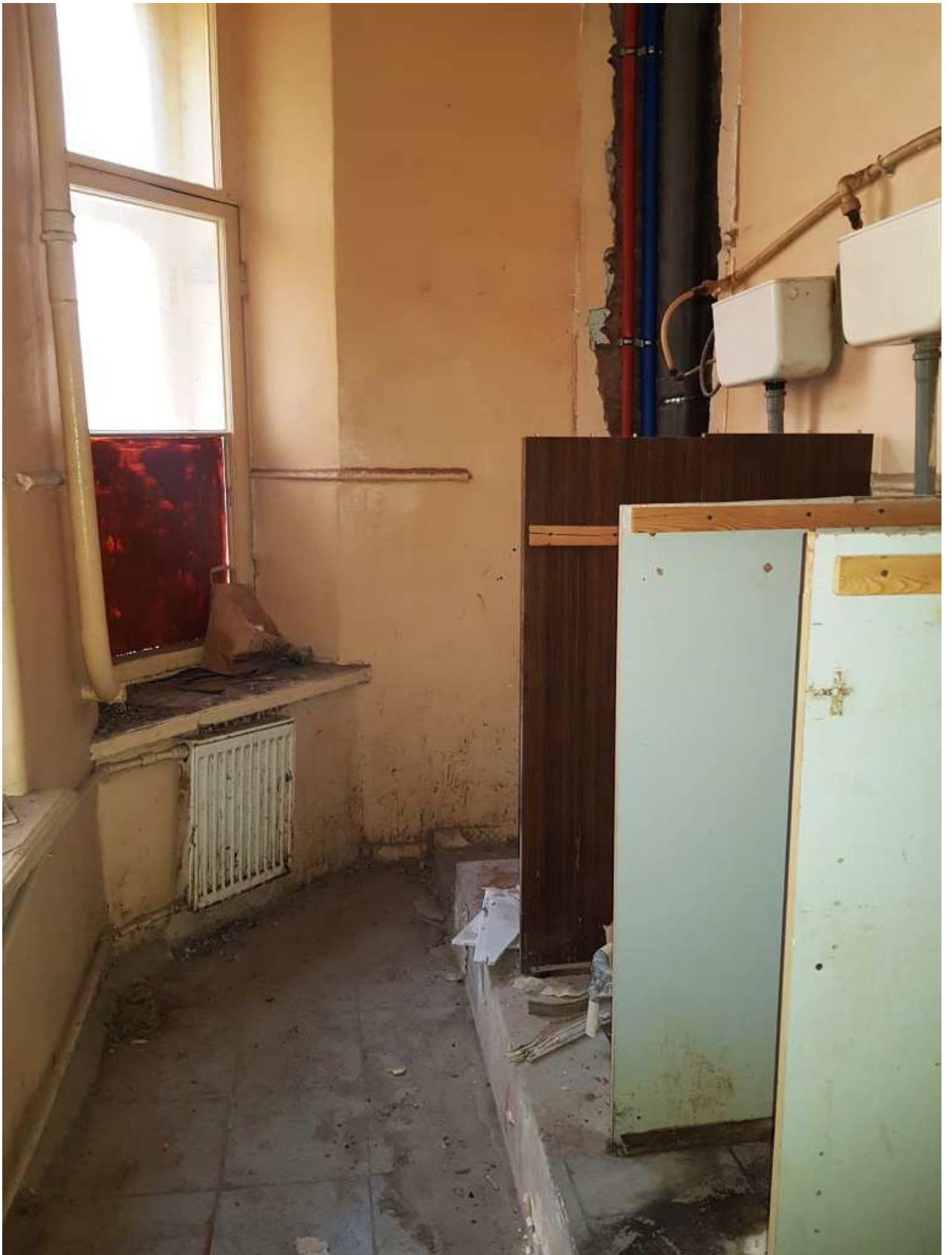
11. Пом. 6. Общий вид.
