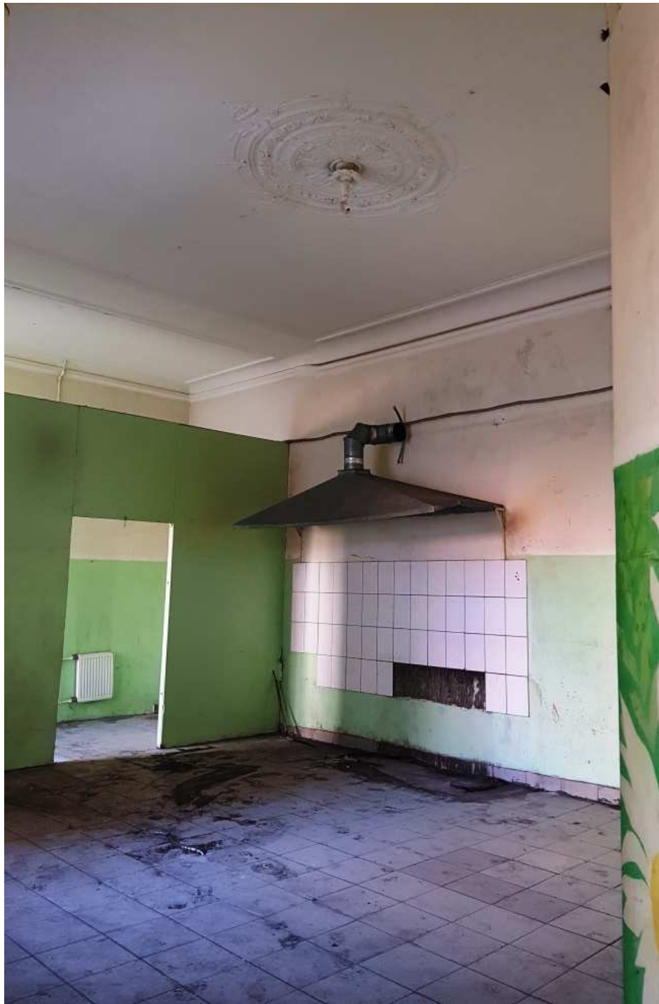
22. Пом.18. Общий вид.
