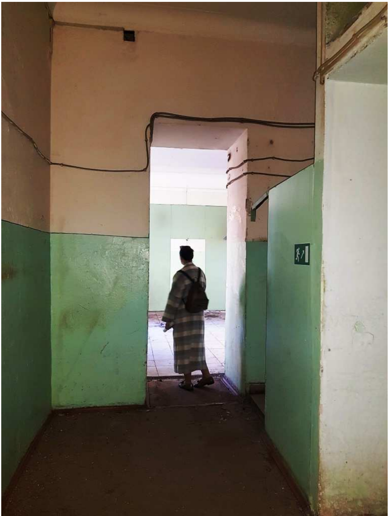
23. Пом.16. Общий вид.
