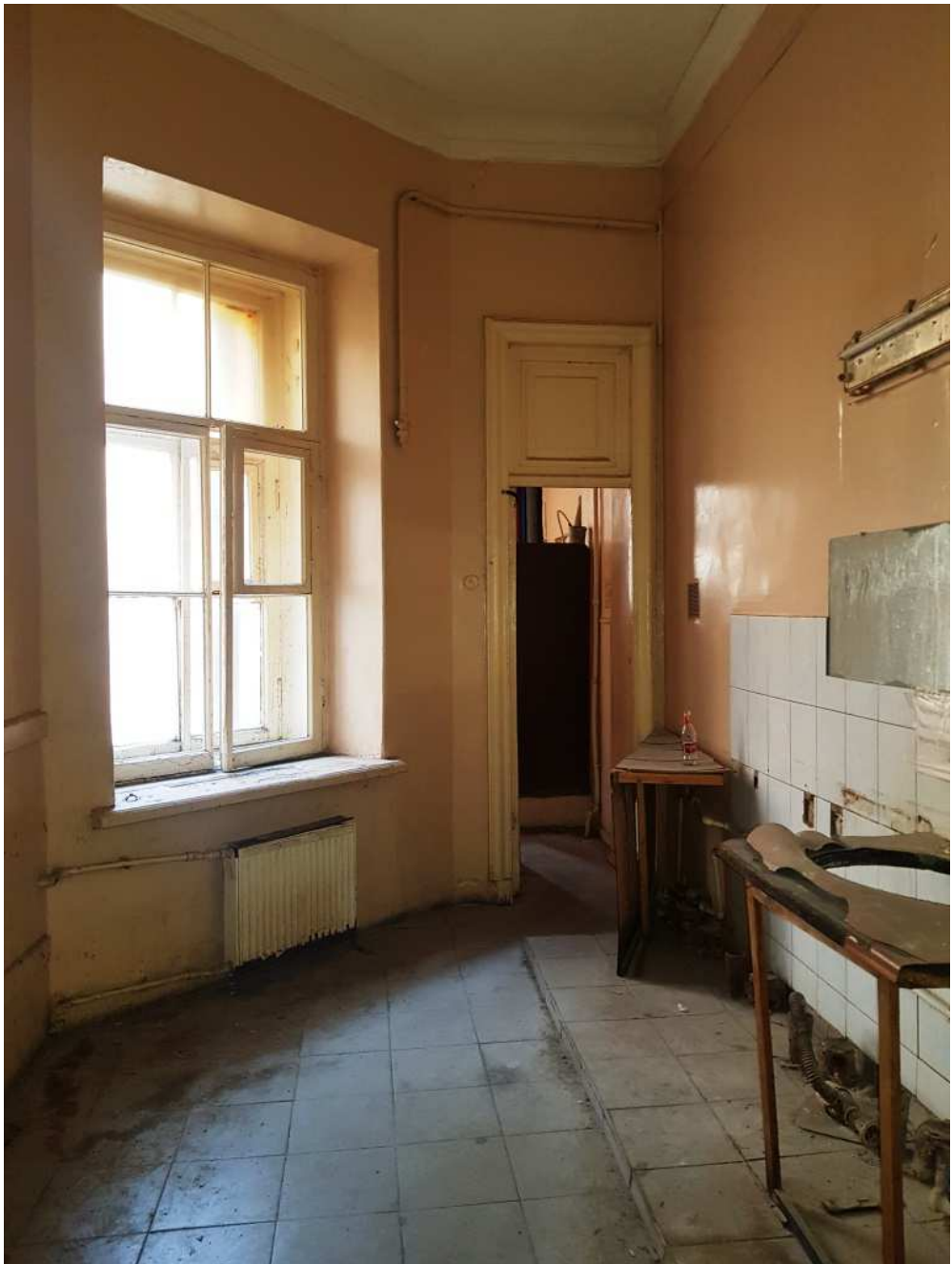
9. Пом.5. Общий вид.
