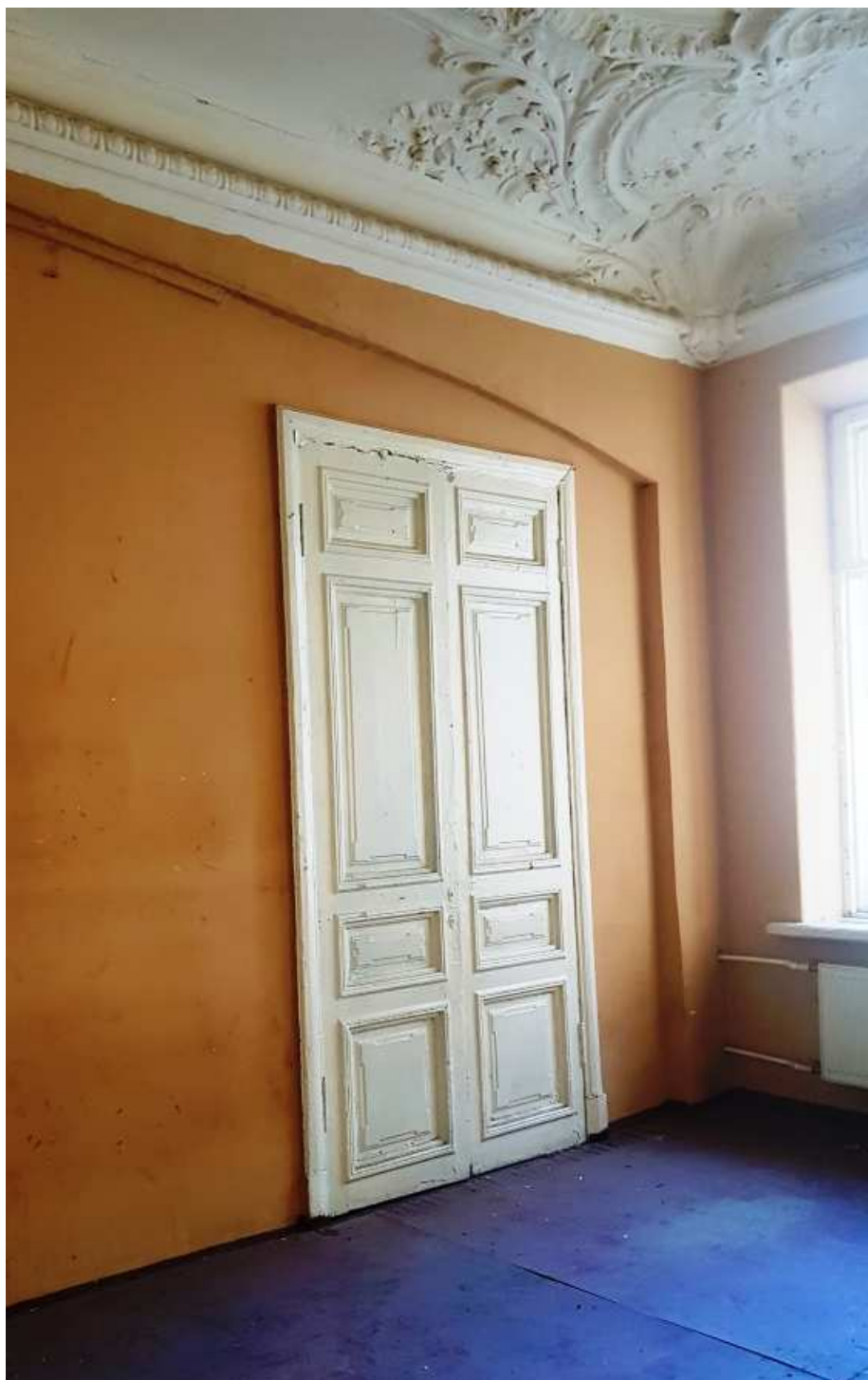
25. Пом. 3. Вид дверного проема (северная стена).
