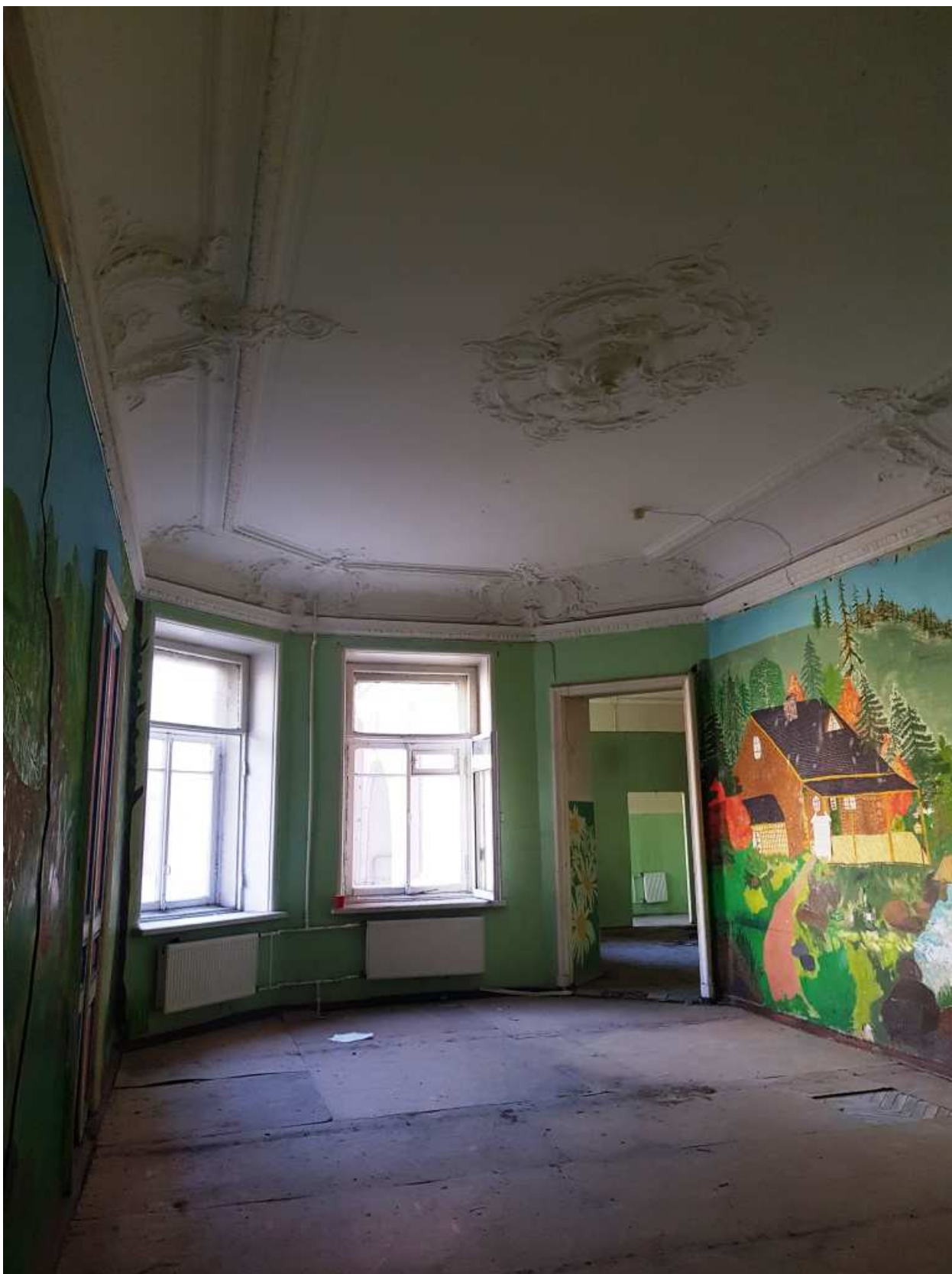
19. Пом. 4. Общий вид.
