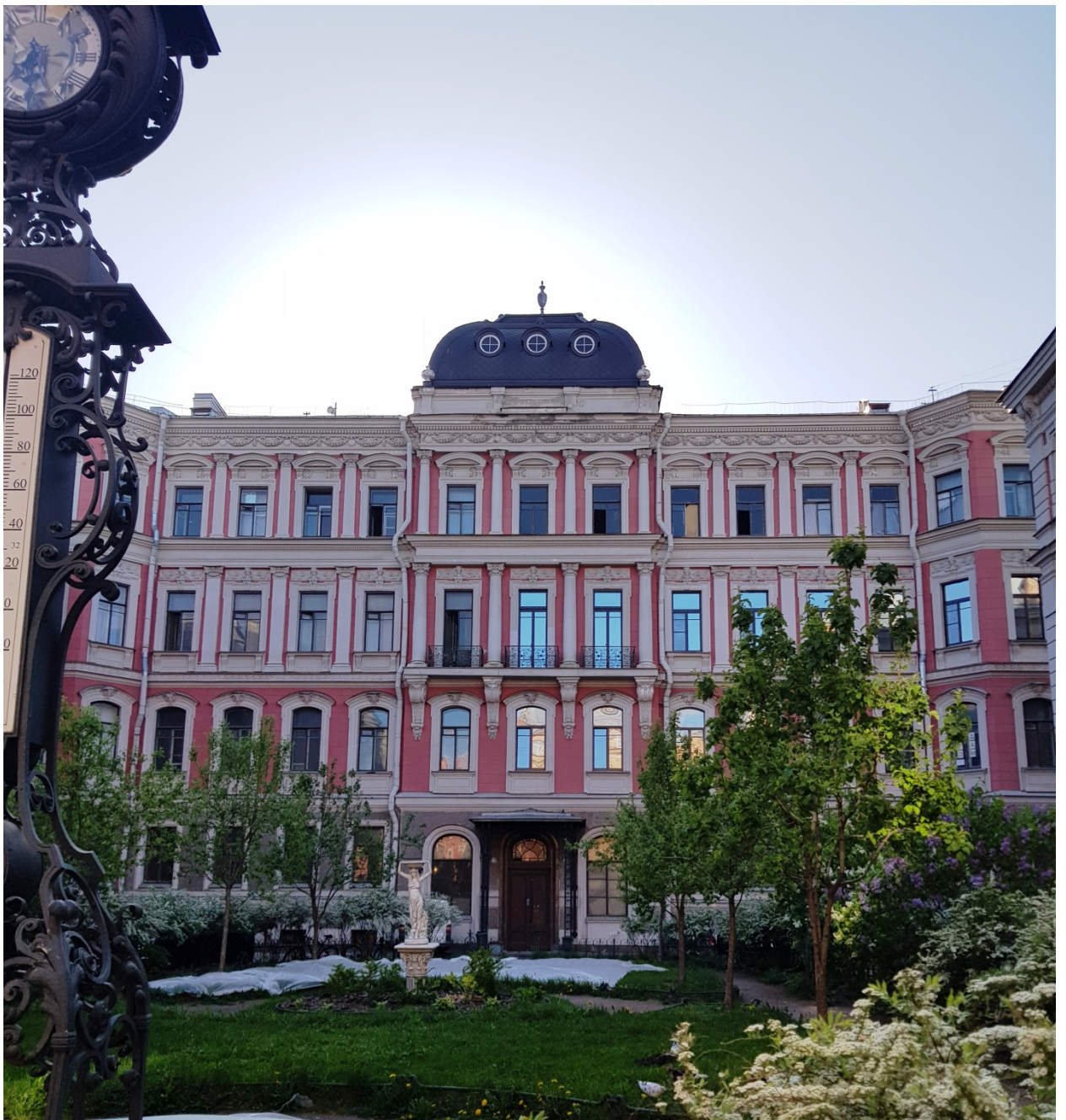
1. Лицевой фасад. Общий вид.
