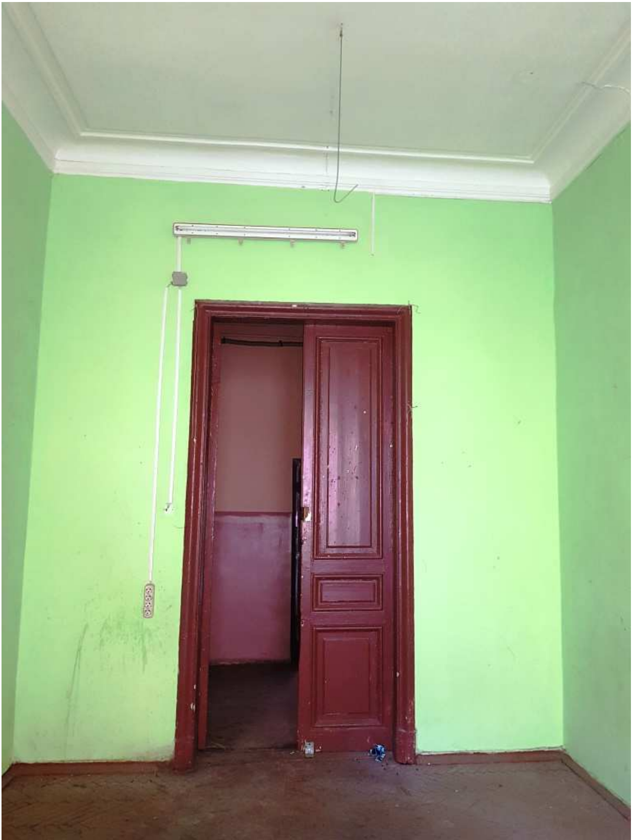
16. Пом.10. Вид дверного проема.
