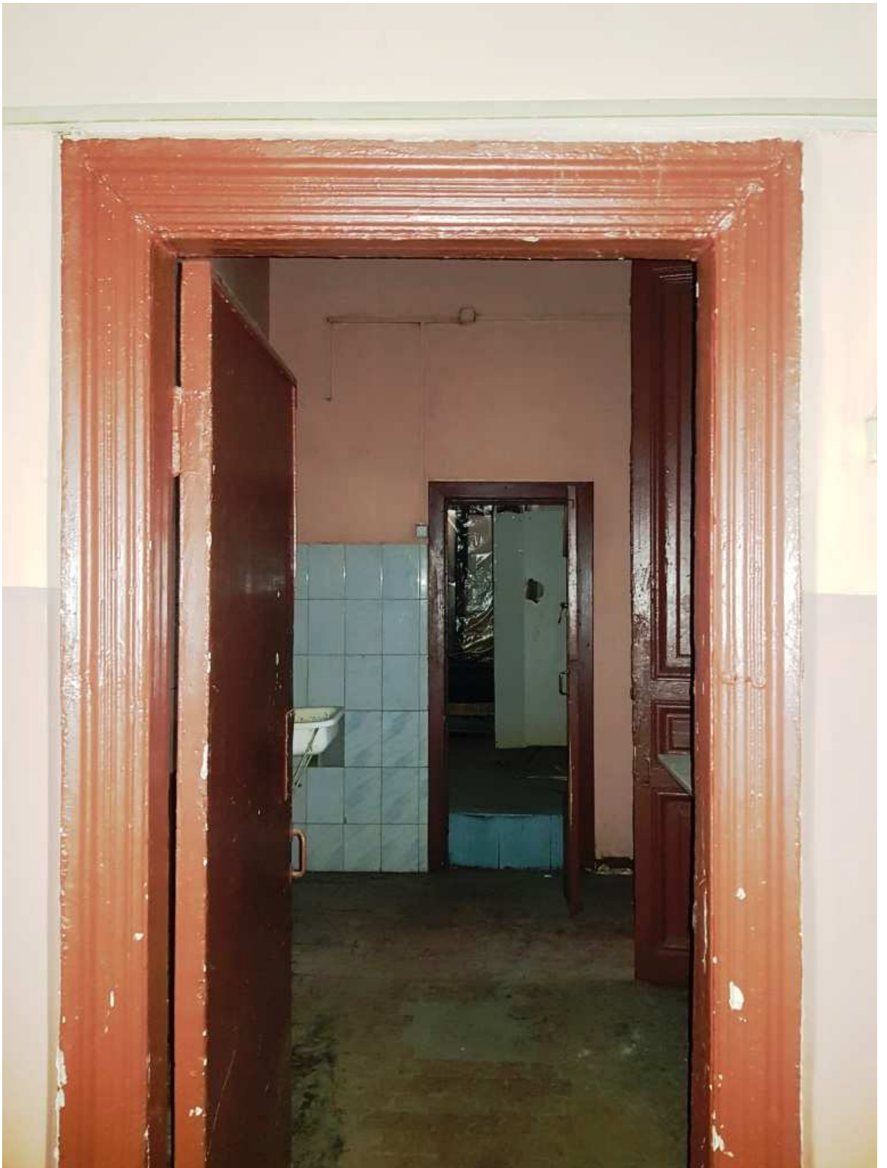
17. Пом.12. Общий вид.
