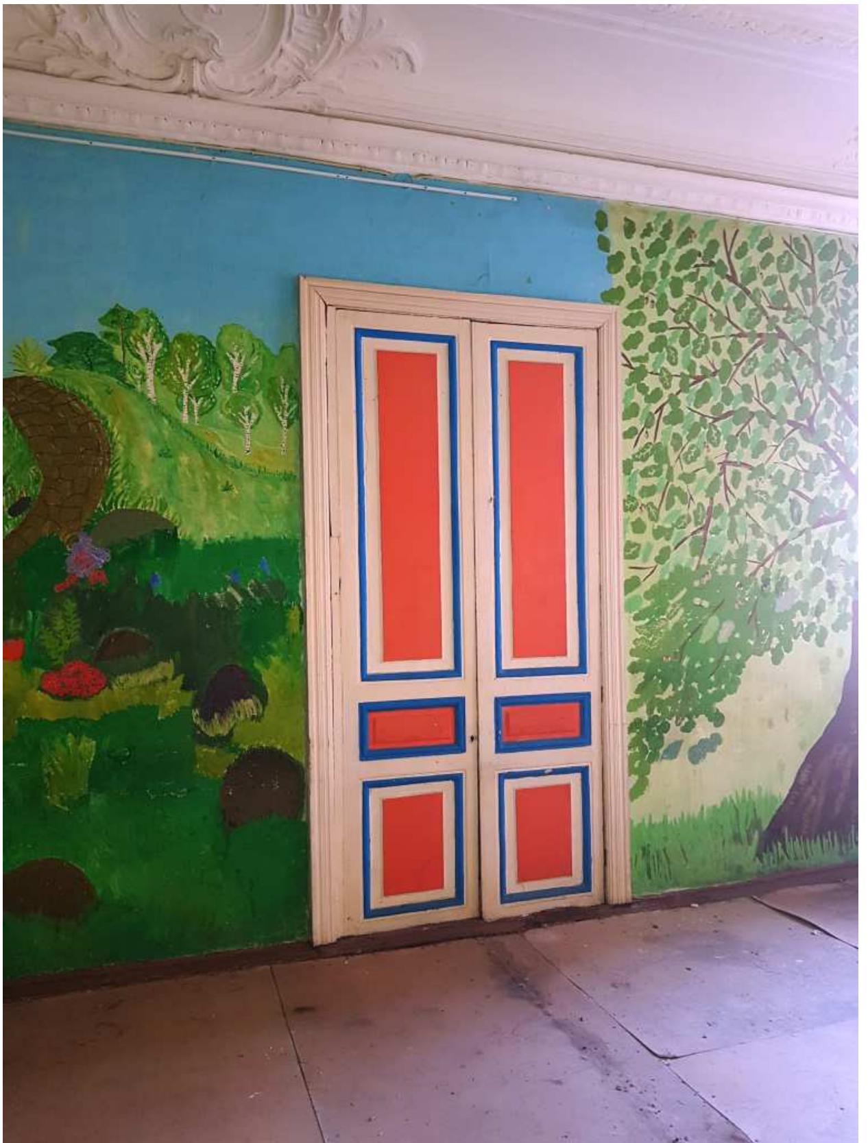
21. Пом.4. Дверной проем.
