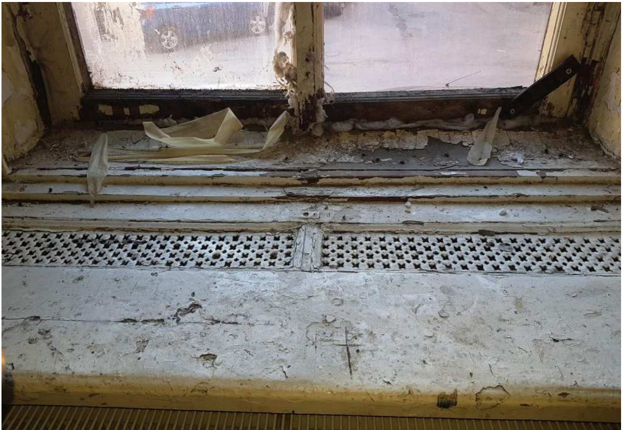
30. Пом. 2. Вид подоконников.
