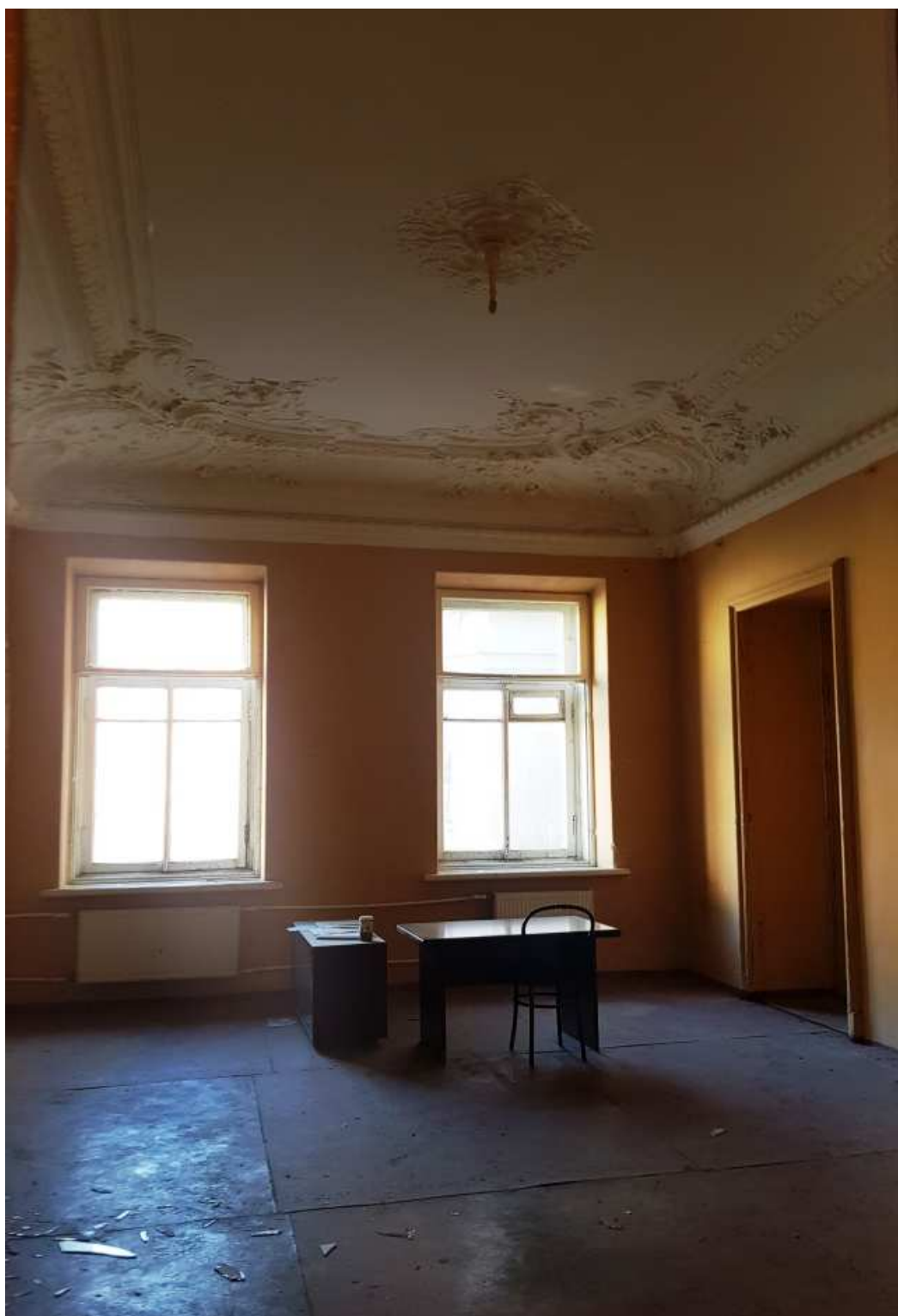
24. Пом.3. Общий вид.
