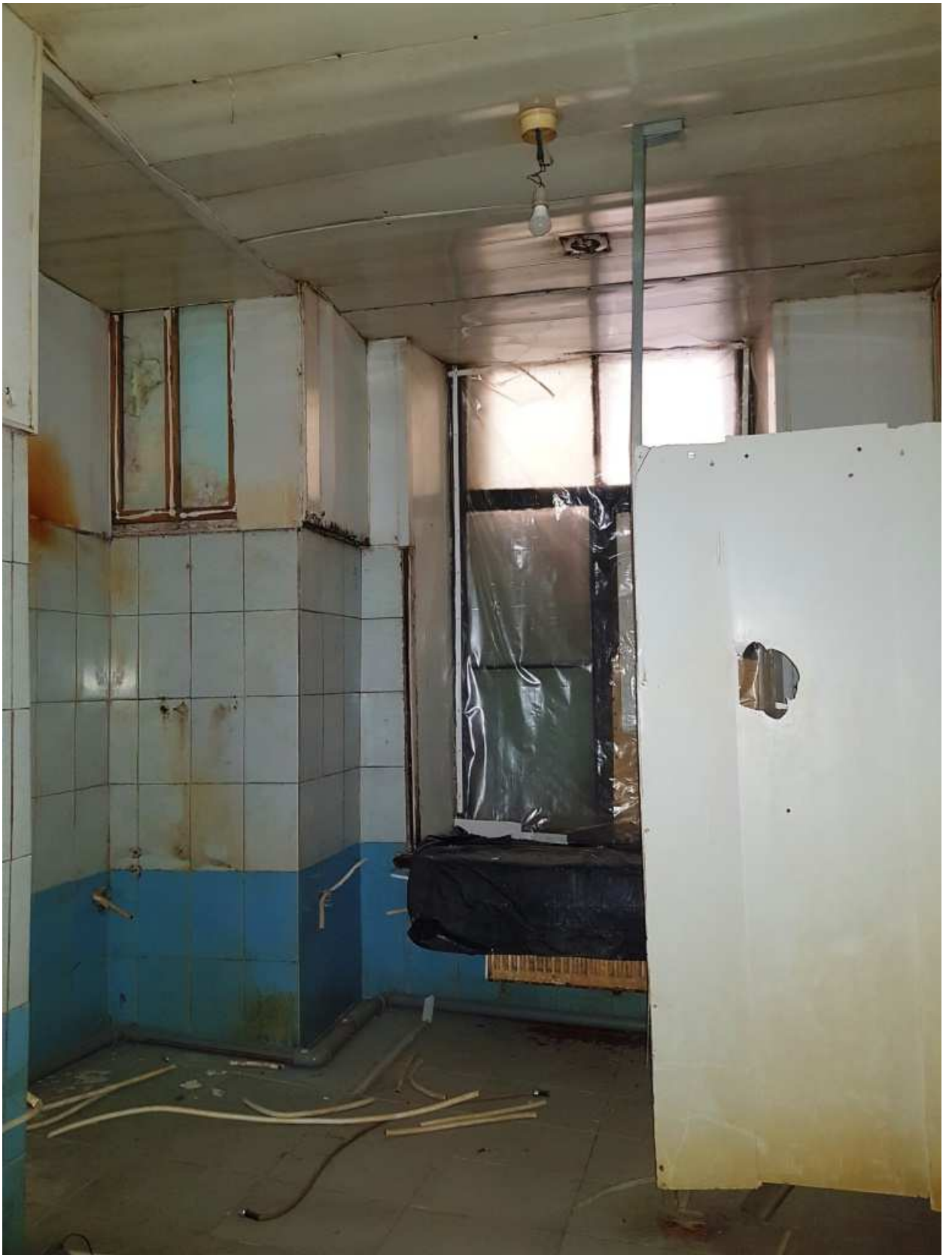
18. Пом. 11. Общий вид.
