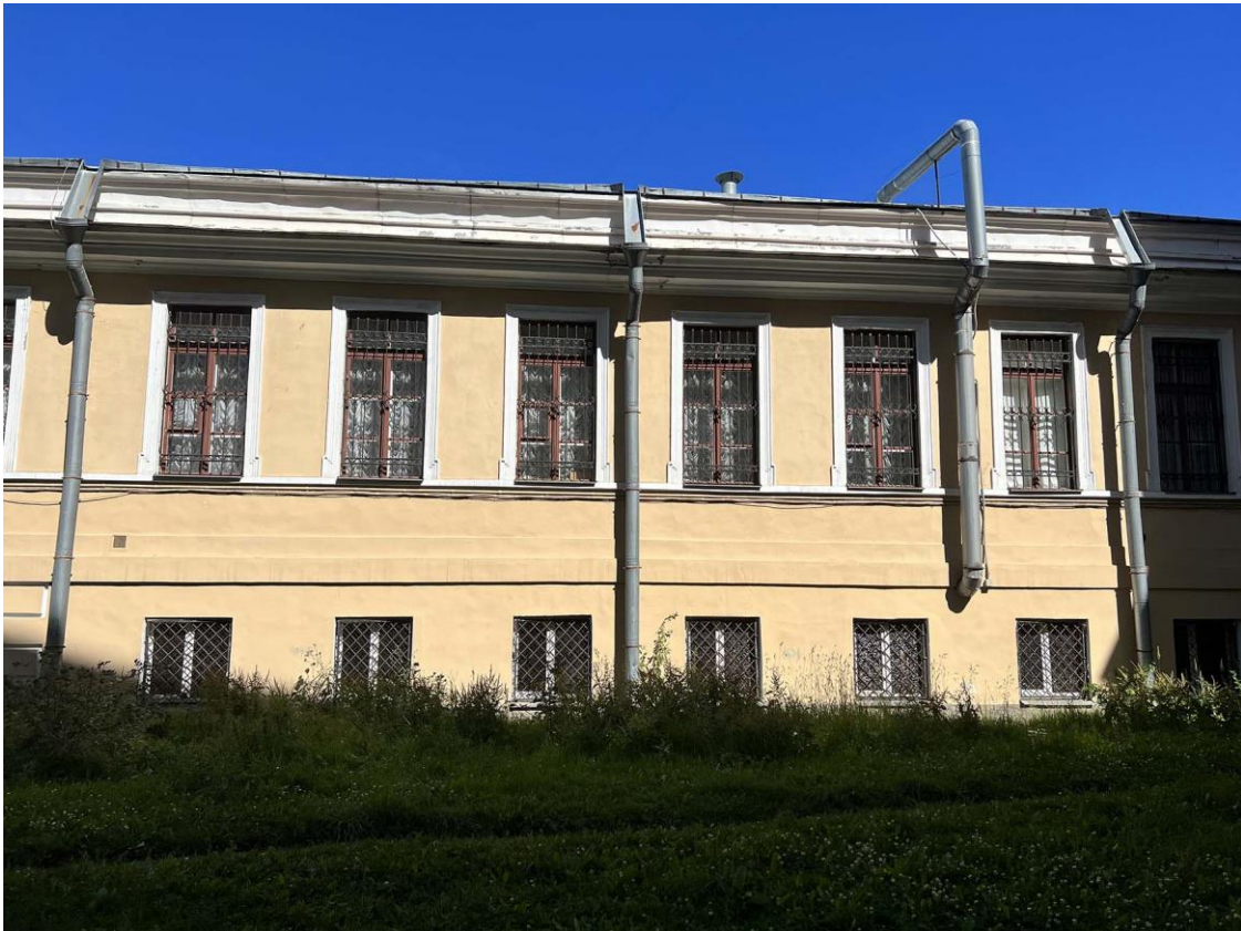
Фото 69. «Дворец Юсуповых», входящий в состав объекта культурного наследия федерального значения «Дворец с флигелями», Московский пр., д. 9, литера В. Фрагмент юго-западного фасада западной пристройки. Дата съемки: 26.07.2022 г. Автор съемки: Куваева Ю.П.
