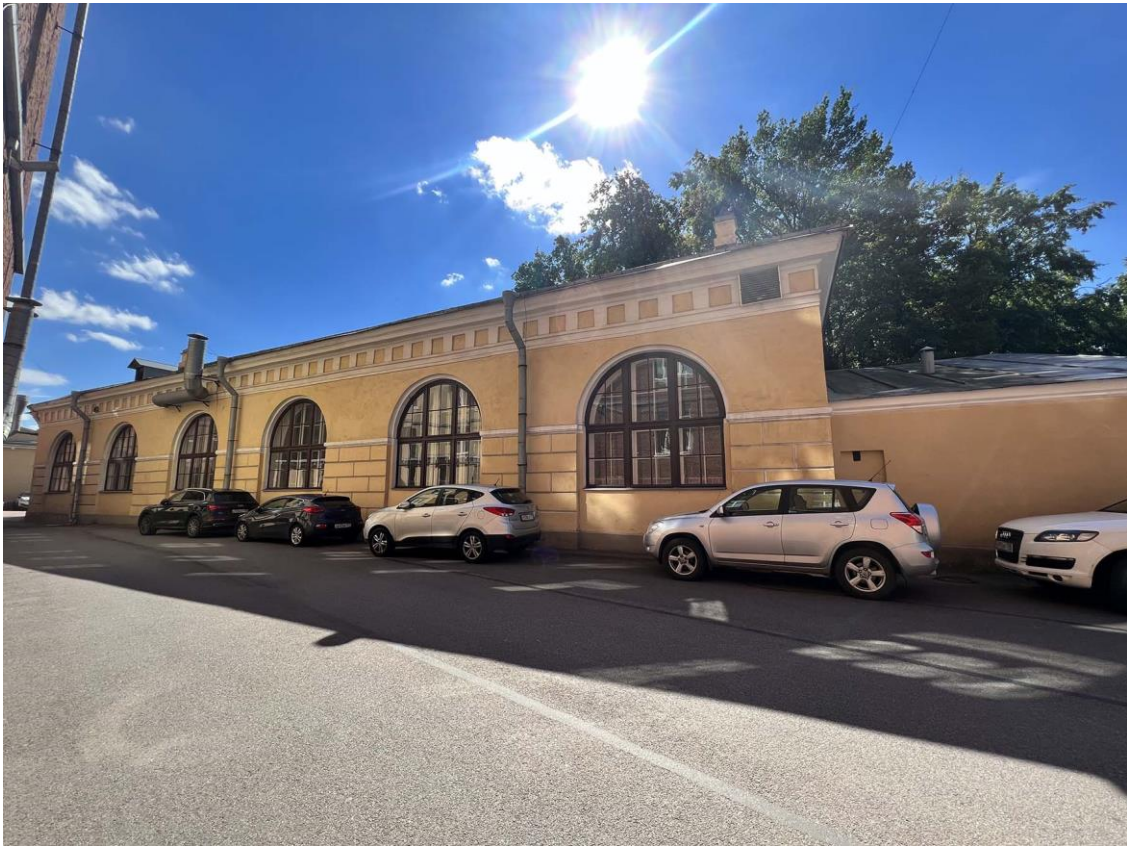
Фото 40. «Дворец Юсуповых», входящий в состав объекта культурного наследия федерального значения «Дворец с флигелями», Московский пр., д. 9, литера В. Общий вид северо-восточного фасада северного флигеля дворца с севера. Дата съемки: 26.07.2022 г. Автор съемки: Куваева Ю.П.
