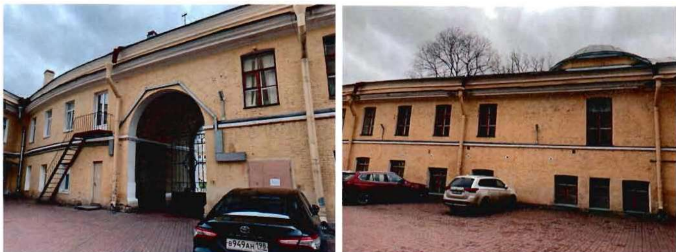
6. Общий вид северного флигеля.
