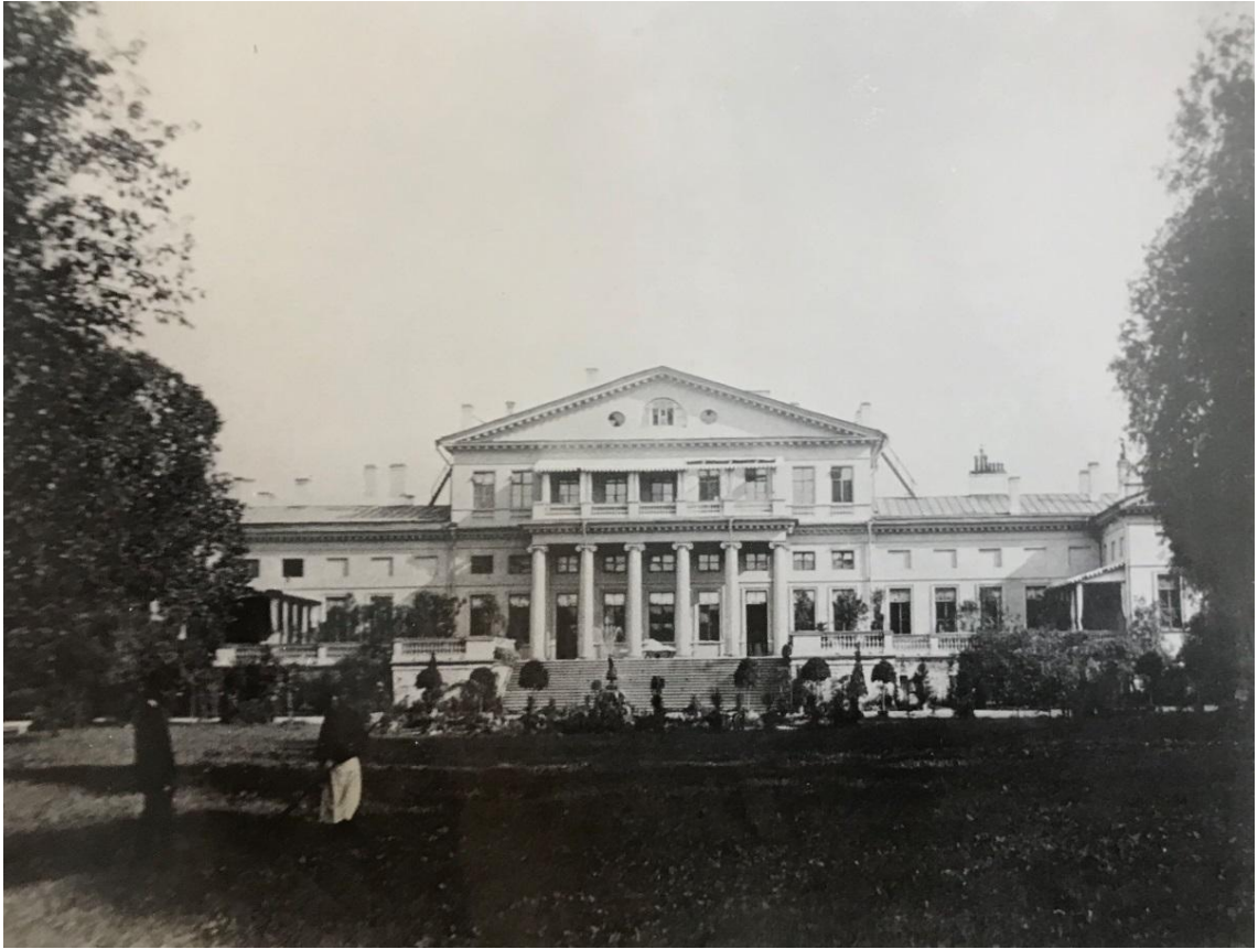
Илл. 15. Фасад со стороны сада. Фото XIX в. Архив КГИОП.
