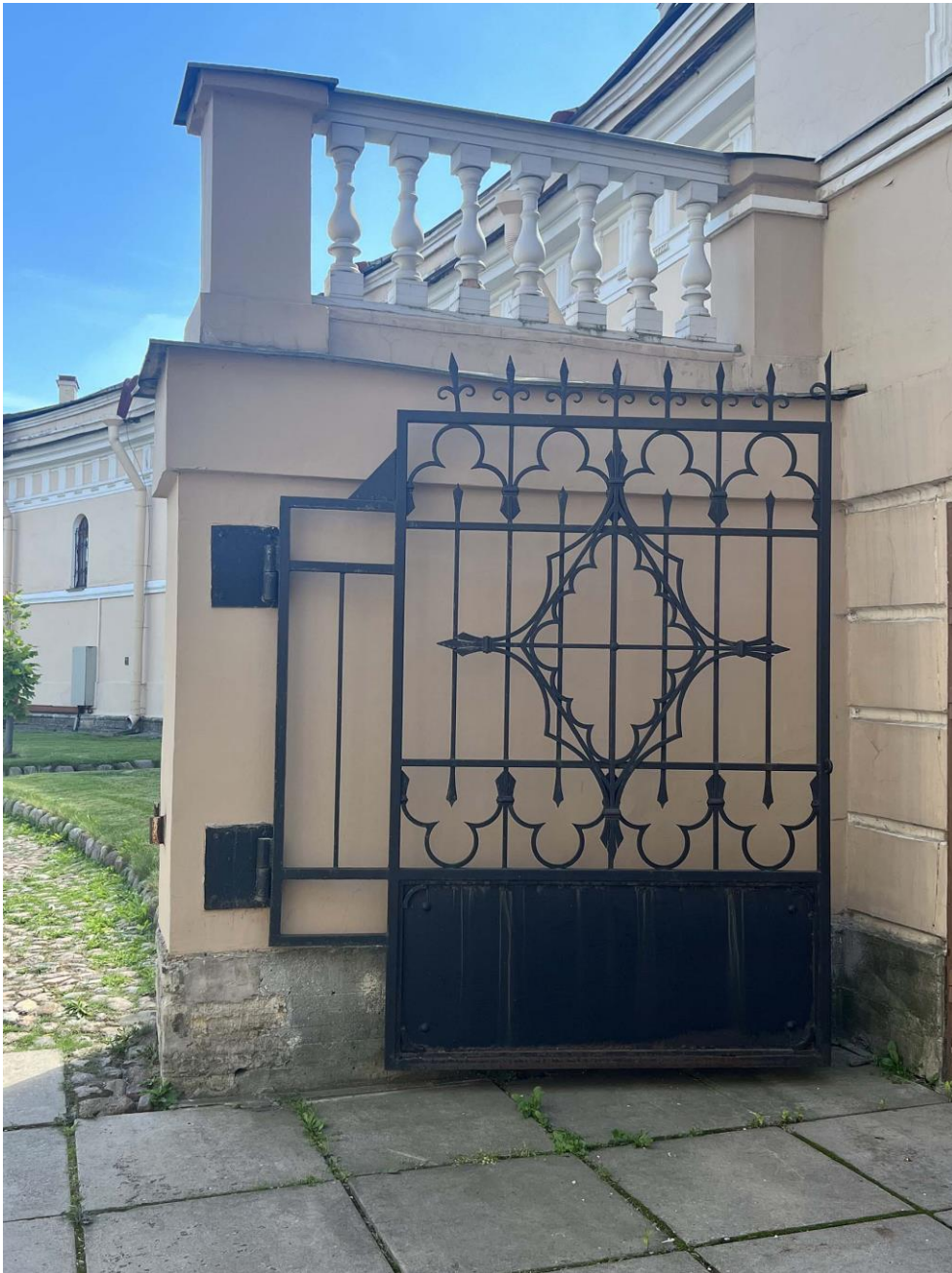
Фото 16. «Дворец Юсуповых», входящий в состав объекта культурного наследия федерального значения «Дворец с флигелями», Московский пр., д. 9, литера В. Общий вид створки металлических ворот пристройки между юго-западным крылом и главным зданием дворца. Фото с севера. Дата съемки: 26.07.2022 г. Автор съемки: Куваева Ю.П.
