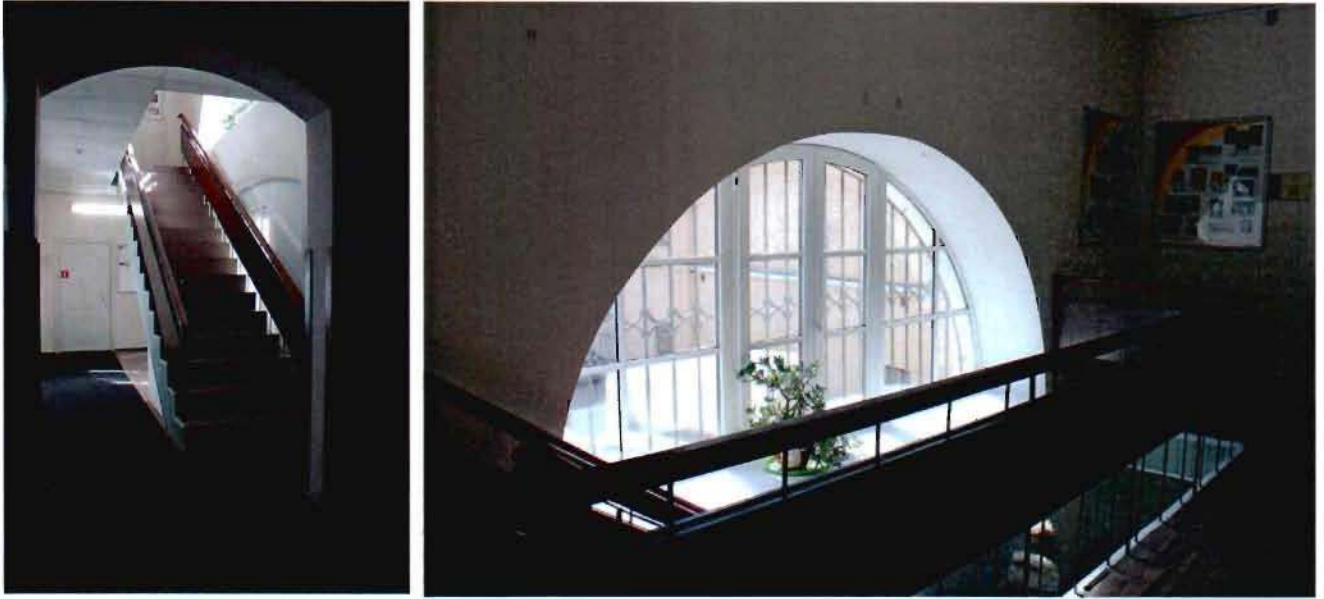
36, 37. Интерьеры помещений северного флигеля (спортзал).
