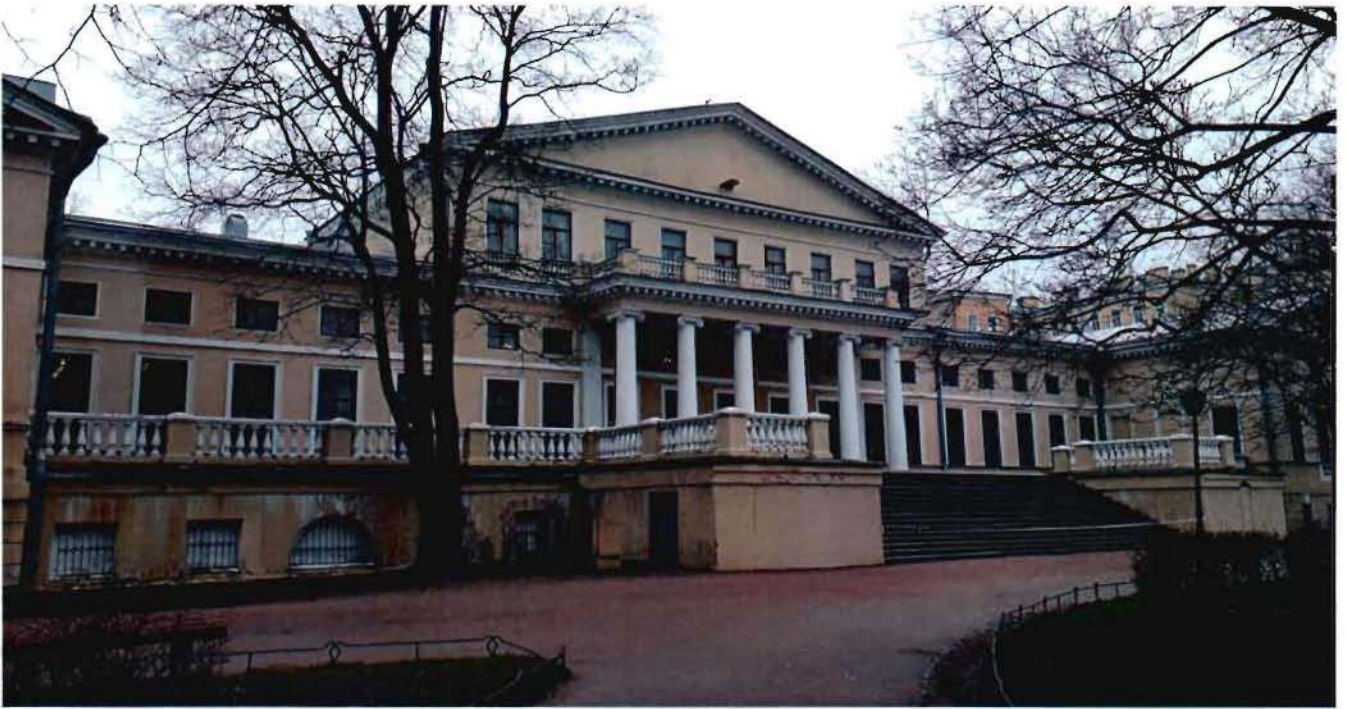
9. Общий вид северного фасада.
