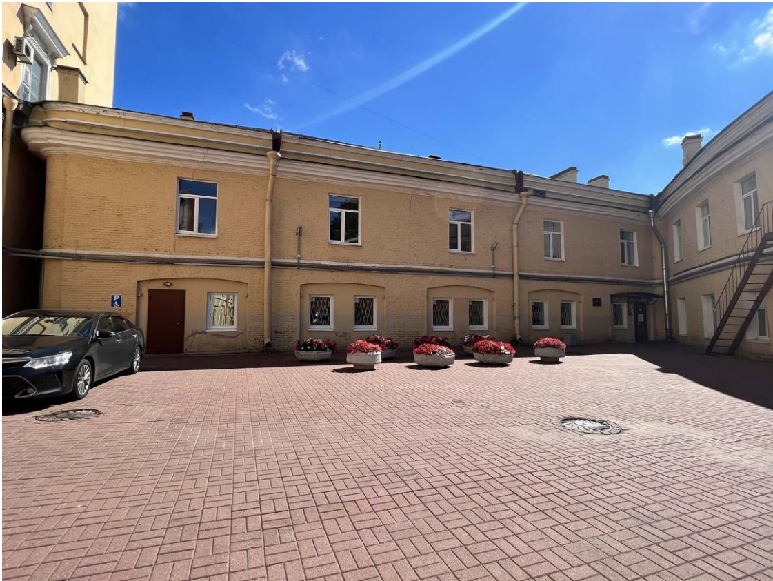
Фото 36. «Дворец Юсуповых», входящий в состав объекта культурного наследия федерального значения «Дворец с флигелями», Московский пр., д. 9, литера В. Общий вид уличной пристройки к восточному крылу дворца. Фото с северо-запада. Дата съемки: 26.07.2022 г. Автор съемки: Куваева Ю.П.
