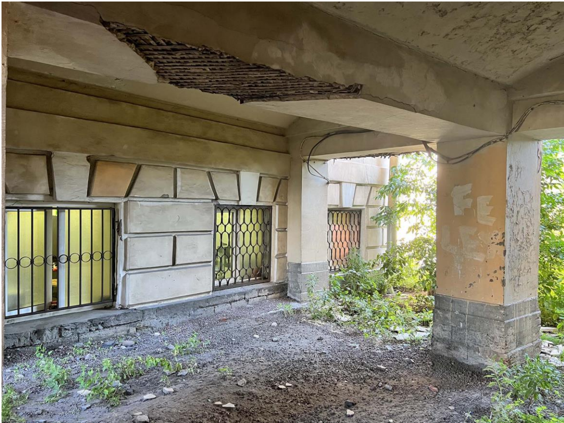
Фото 72. «Дворец Юсуповых», входящий в состав объекта культурного наследия федерального значения «Дворец с флигелями», Московский пр., д. 9, литера В. Общий вид перекрытия южной пристройки к юго-западному крылу здания дворца. Фото с запада. Дата съемки: 26.07.2022 г. Автор съемки: Куваева Ю.П.
