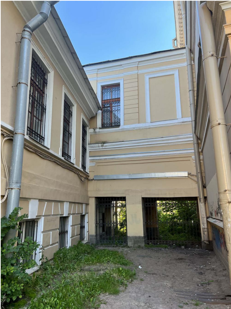
Фото 71. «Дворец Юсуповых», входящий в состав объекта культурного наследия федерального значения «Дворец с флигелями», Московский пр., д. 9, литера В. Северо-западный фасад южной пристройки к юго-западному крылу здания дворца. Дата съемки: 26.07.2022 г. Автор съемки: Куваева Ю.П.
