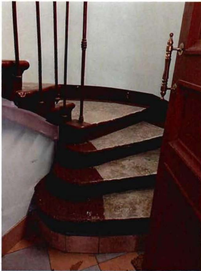
40, 41. Лестница западного флигеля.
