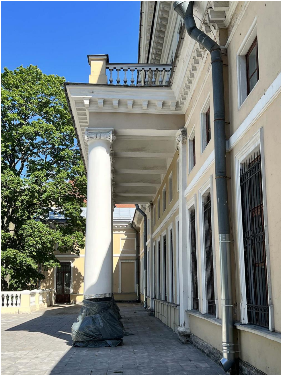
Фото 57. «Дворец Юсуповых», входящий в состав объекта культурного наследия федерального значения «Дворец с флигелями», Московский пр., д. 9, литера В. Общий вид портика северо-западного фасада главного здания дворца. Фото с юго-запада. Дата съемки: 26.07.2022 г. Автор съемки: Куваева Ю.П.
