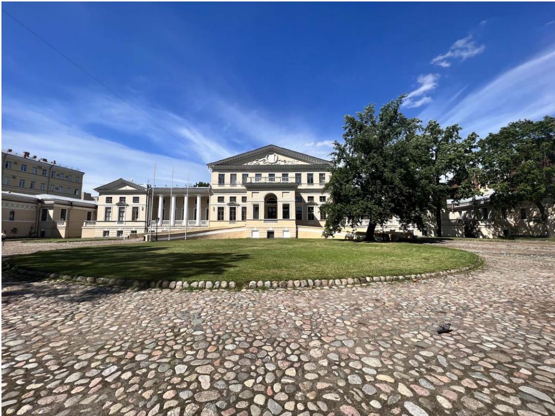
Фото 9. «Дворец Юсуповых», входящий в состав объекта культурного наследия федерального значения «Дворец с флигелями», Московский пр., д. 9, литера В. Общий вид здания дворца со стороны парадного двора. Фото с юго-востока. Дата съемки: 26.07.2022 г. Автор съемки: Куваева Ю.П.
