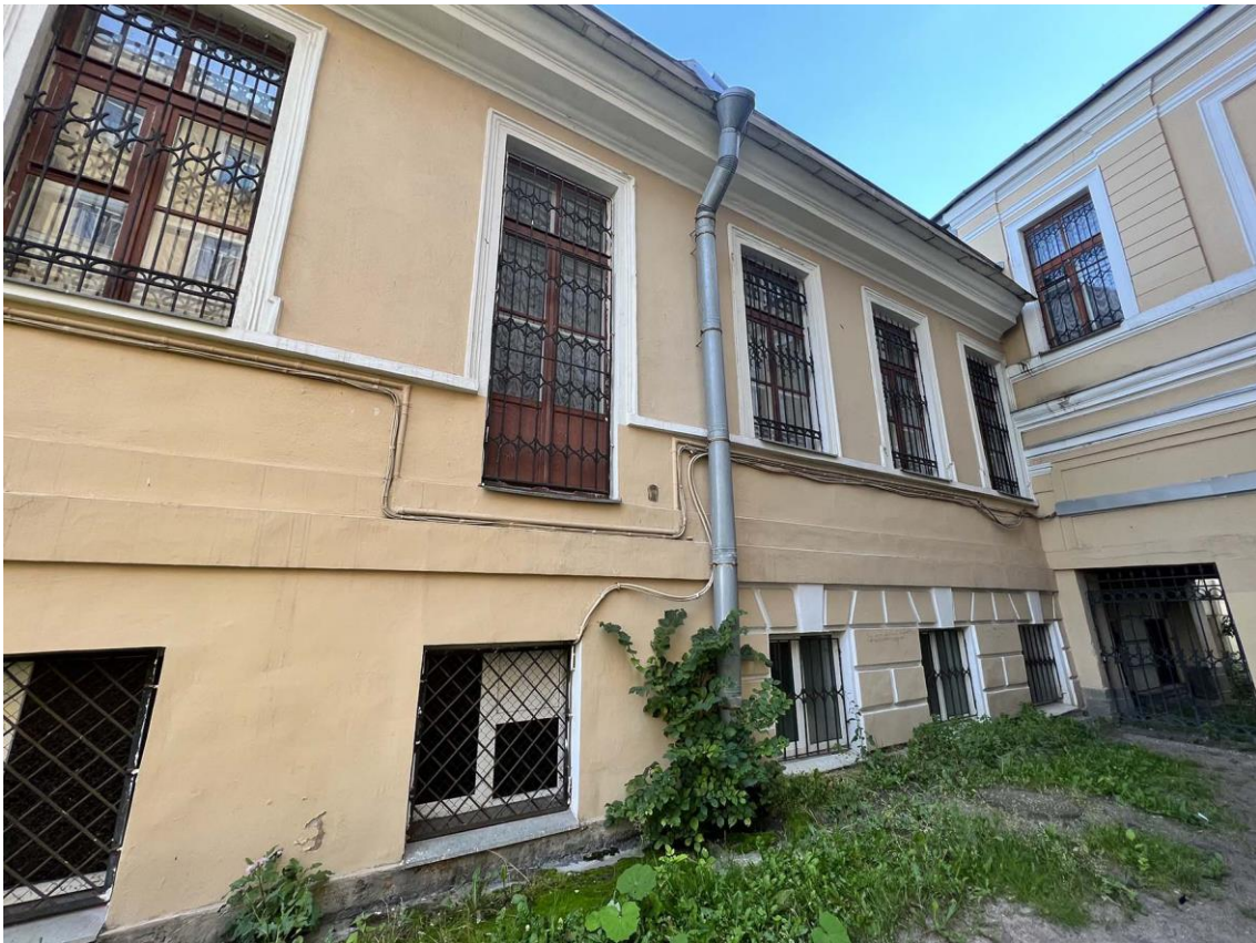
Фото 70. «Дворец Юсуповых», входящий в состав объекта культурного наследия федерального значения «Дворец с флигелями», Московский пр., д. 9, литера В. Фрагмент юго-западного фасада западной пристройки. Дата съемки: 26.07.2022 г. Автор съемки: Куваева Ю.П.
