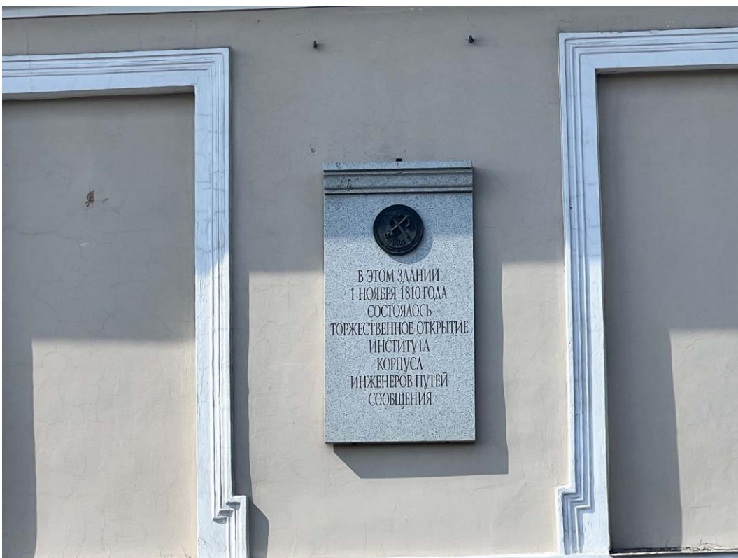
Фото 6. «Дворец Юсуповых», входящий в состав объекта культурного наследия федерального значения «Дворец с флигелями», Московский пр., д. 9, литера В. Фрагмент лицевого юго-восточного фасада юго-западного крыла здания. Фото с юго-востока. Гранитная мемориальная плита с надписью: «В ЭТОМ ЗДАНИИ 1 НОЯБРЯ 1810 ГОДА СОСТОЯЛОСЬ ТОРЖЕСТВЕННОЕ ОТКРЫТИЕ ИНСТИТУТА КОРПУСА ИНЖЕНЕРОВ ПУТЕЙ СООБЩЕНИЯ». Дата съемки: 26.07.2022 г. Автор съемки: Куваева Ю.П.
