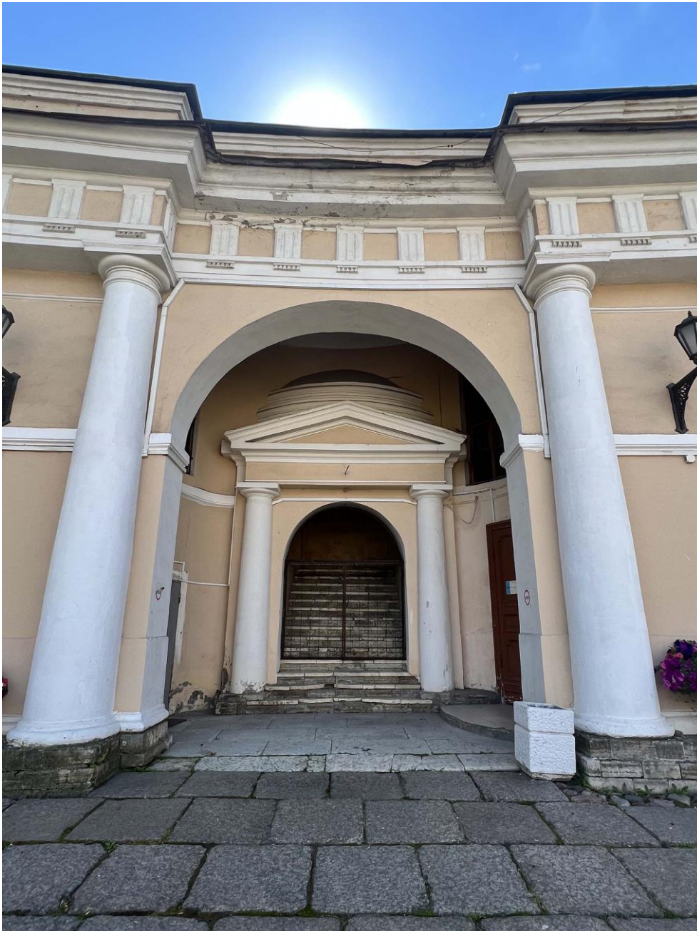
Фото 28. «Дворец Юсуповых», входящий в состав объекта культурного наследия федерального значения «Дворец с флигелями», Московский пр., д. 9, литера В. Фрагмент дворового фасада юго-западного крыла. Дата съемки: 26.07.2022 г. Автор съемки: Куваева Ю.П.
