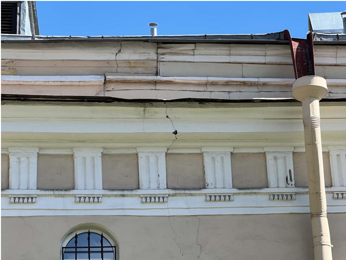
Фото 27. «Дворец Юсуповых», входящий в состав объекта культурного наследия федерального значения «Дворец с флигелями», Московский пр., д. 9, литера В. Фрагмент дворового фасада юго-западного крыла дворца. Дата съемки: 26.07.2022 г. Автор съемки: Куваева Ю.П.
