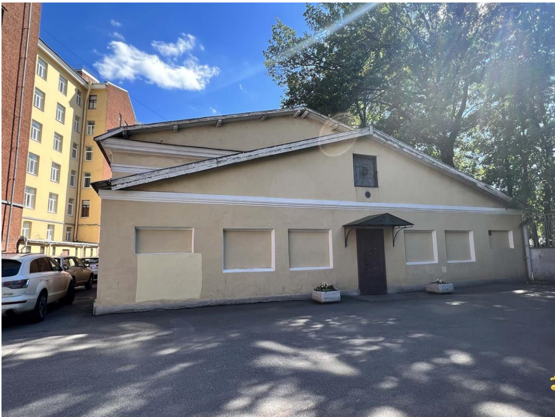
Фото 43. «Дворец Юсуповых», входящий в состав объекта культурного наследия федерального значения «Дворец с флигелями», Московский пр., д. 9, литера В. Северо-западные фасады северного флигеля дворца и пристройки. Дата съемки: 26.07.2022 г. Автор съемки: Куваева Ю.П.
