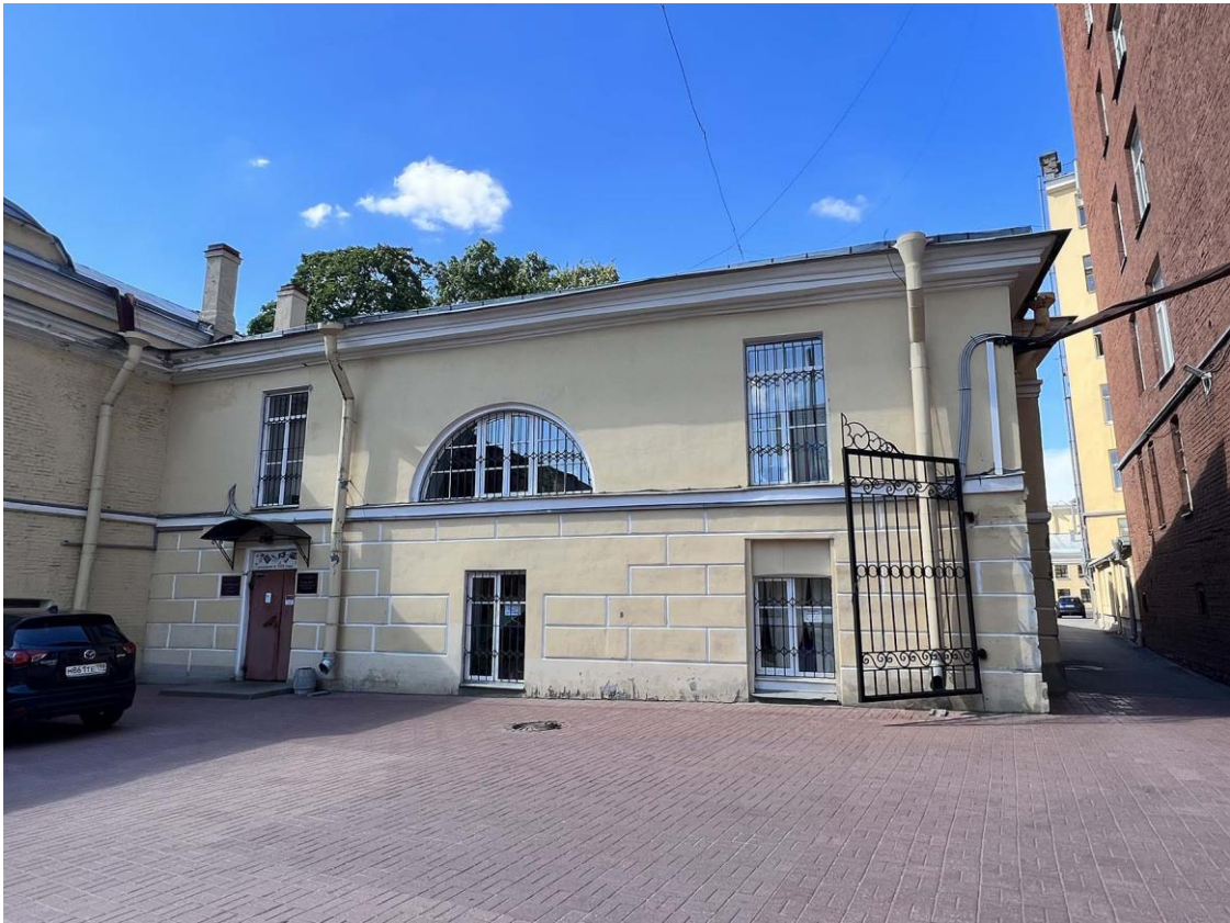
Фото 38. «Дворец Юсуповых», входящий в состав объекта культурного наследия федерального значения «Дворец с флигелями», Московский пр., д. 9, литера В. Общий вид юго-восточного фасада северного флигеля дворца. Фото с юго-востока. Дата съемки: 26.07.2022 г. Автор съемки: Куваева Ю.П.
