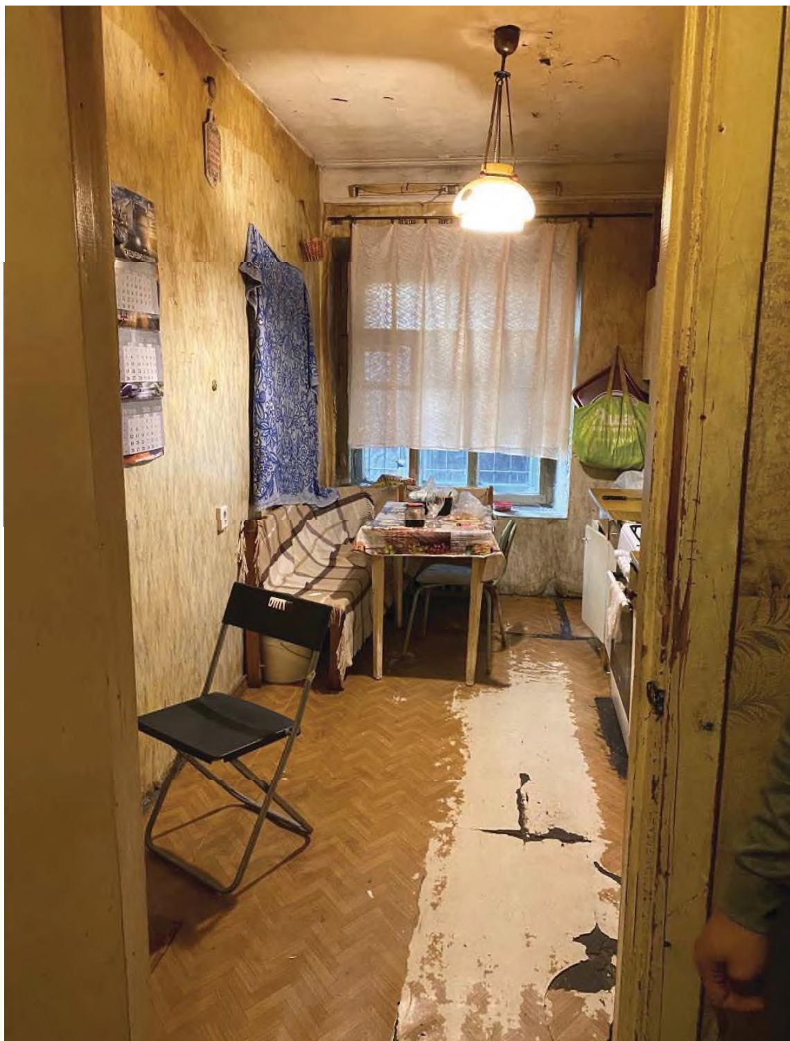
3. Дом Т.П. Павловой. Конная ул., 8, литера А. Интерьер помещения кв. №53. Фото:10.05.2023.
