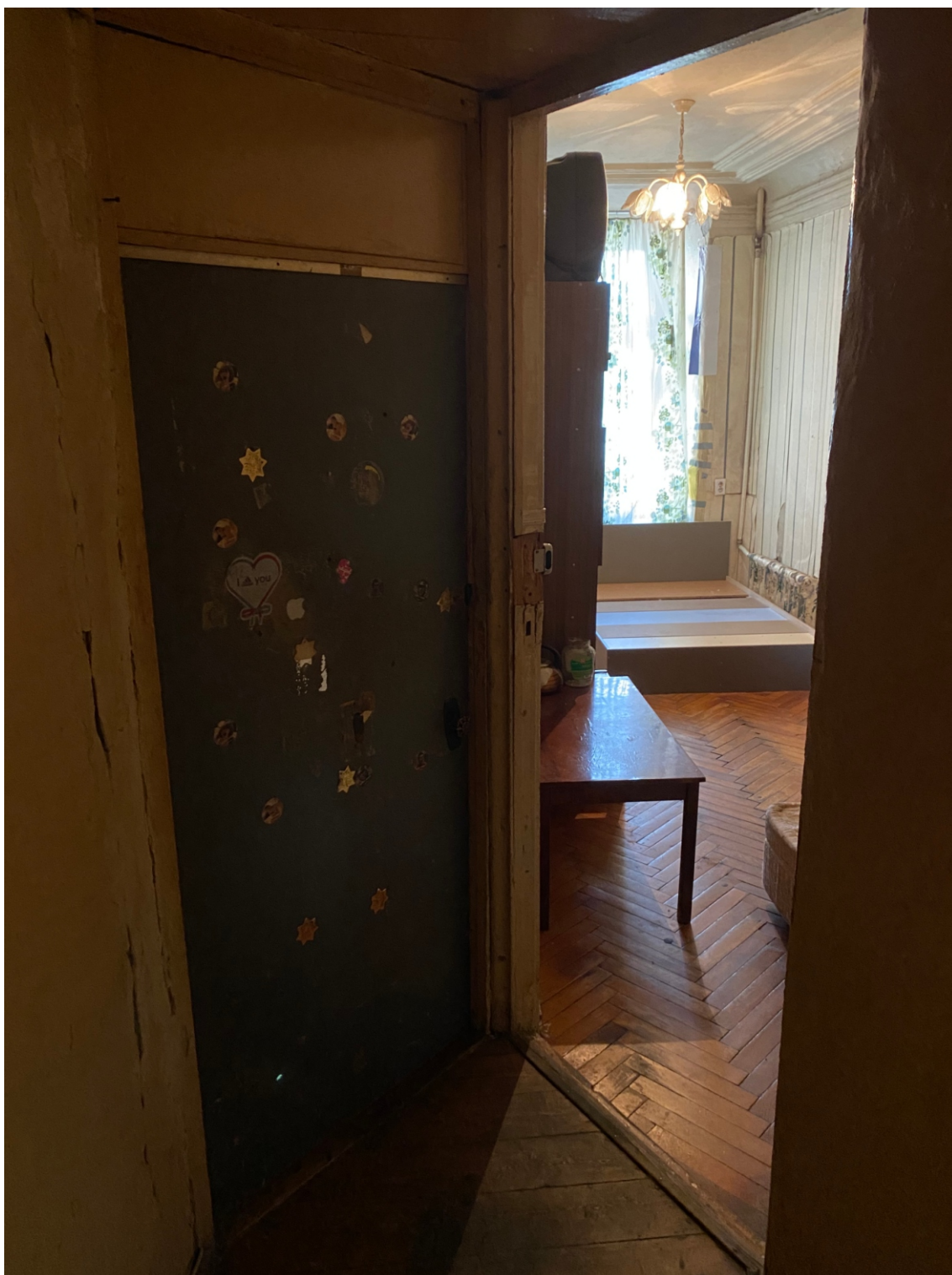
5. Дом Т.П. Павловой. Конная ул., 8, литера А. Интерьер помещения кв. №53. Фото:10.05.2023.
