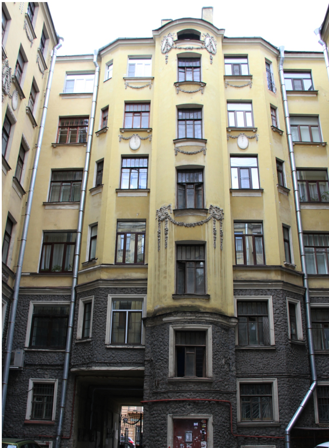
9. Дом Т.П. Павловой. Конная ул., 8, литера А. Фасад со стороны двора. Фото: 10.05.2023.
