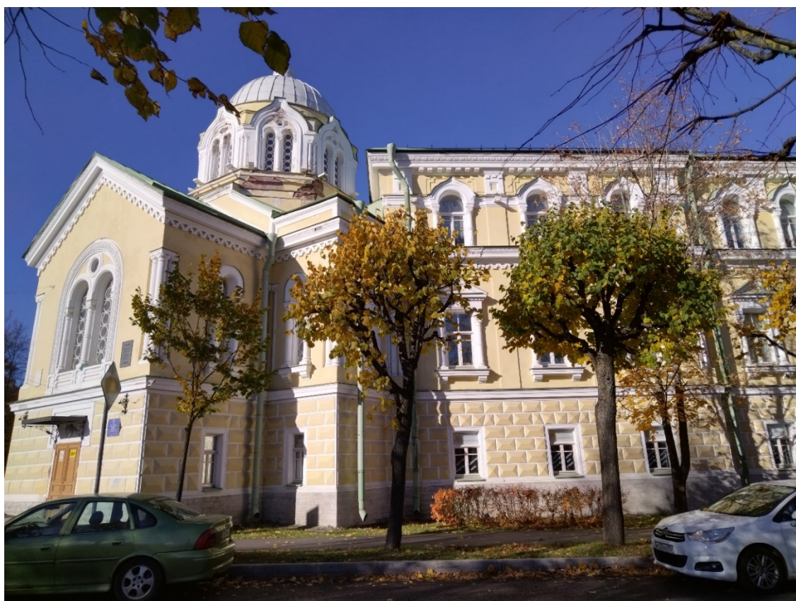
2. Фрагмент лицевого фасада по Набережной улице. Дата съемки: 09.10.2022
