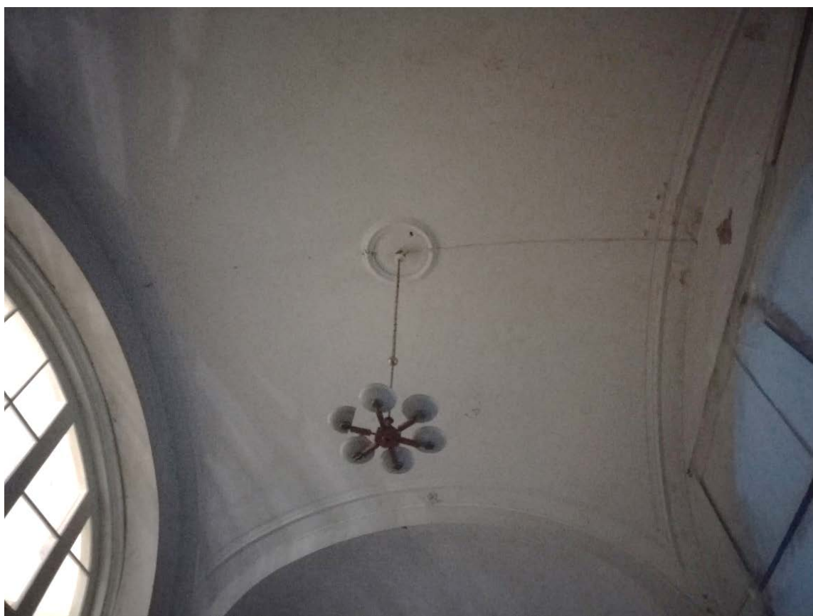
11. Церковный зал. Притвор. Розетка и профилированные элементы свода. Дата съемки: 03.10.2022
