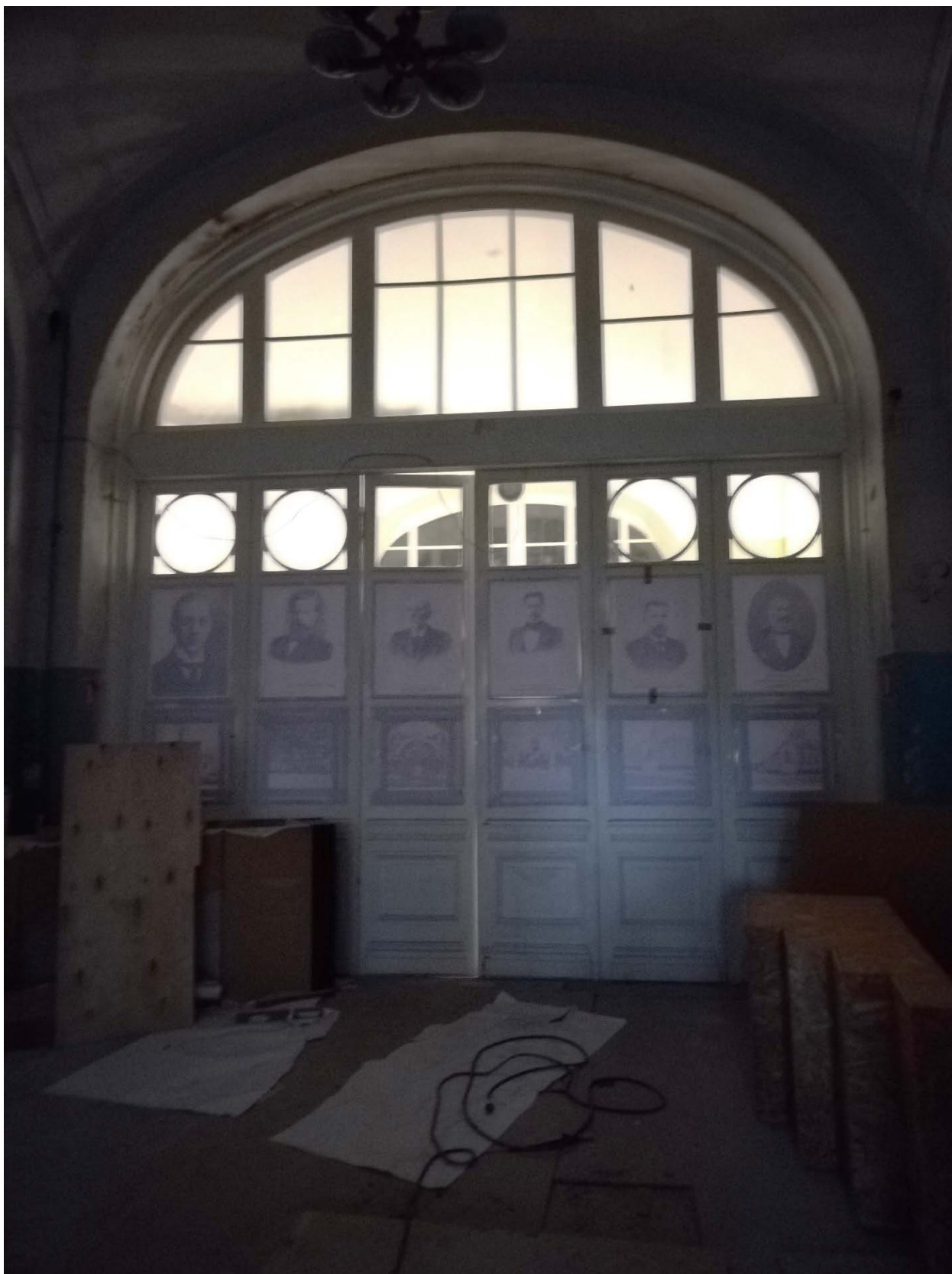
9. Церковный зал. Притвор. Вид на дверное заполнение. Дата съемки: 03.10.2022
