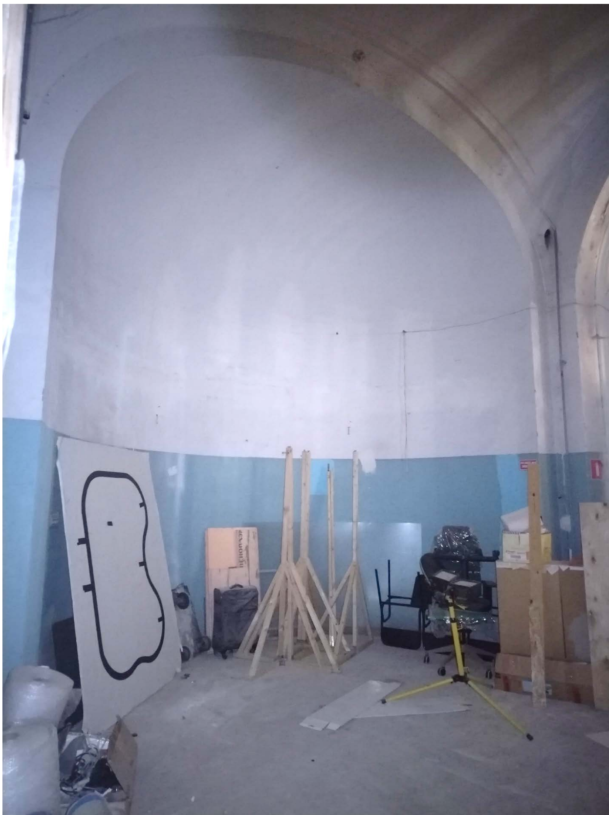
13. Церковный зал. Притвор. Дата съемки: 03.10.2022
