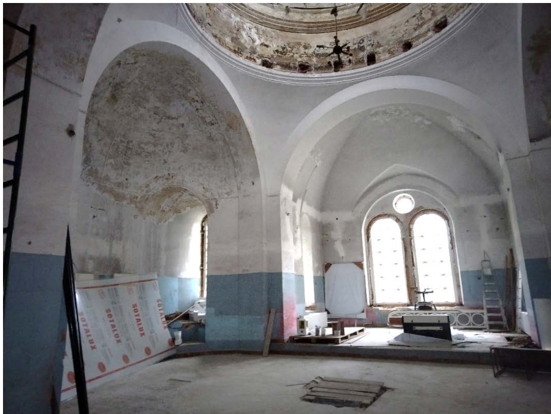
4. Церковный зал. Вид на алтарную часть и среднюю часть. Дата съемки: 03.10.2022
