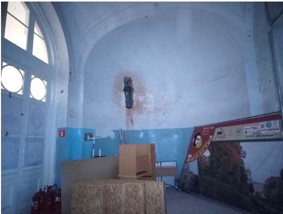
10. Церковный зал. Притвор. Дата съемки: 03.10.2022
