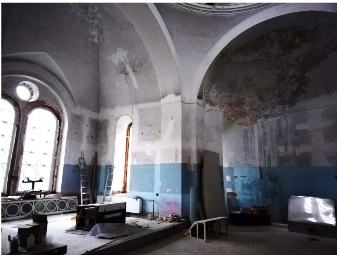
3. Церковный зал. Вид на алтарную часть и среднюю часть. Дата съемки: 03.10.2022
