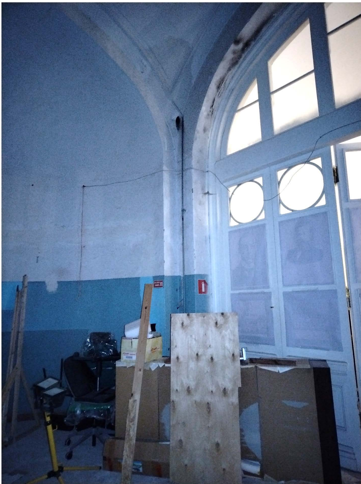
14. Церковный зал. Притвор. Дата съемки: 03.10.2022
